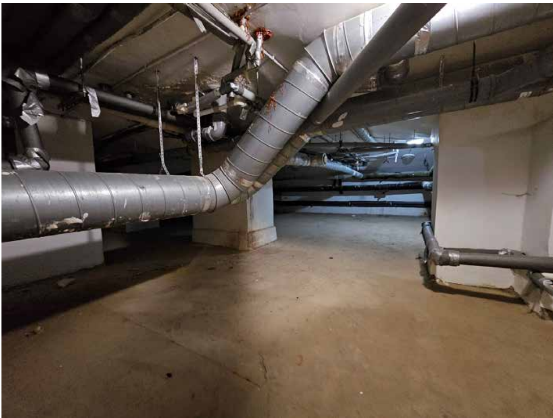
21. Выявленный объект культурного наследия «Здание женской гимназии Э.П. Шаффе», по адресу: г. Санкт-Петербург, 5-я линия, 16, (правая часть). Фрагмент пом. 2-Н (26) в уровне подвала.
