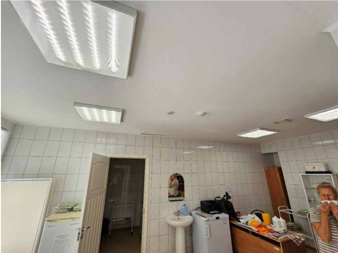
82. Выявленный объект культурного наследия «Дом А.А. Куракиной (Э.П. Шаффе)», по адресу: г. Санкт-Петербург, Большой пр. В.О., 17; 5-я линия, 16 (левая часть). Общий вид пом. 2-Н (82) в уровне 1-го этажа.
