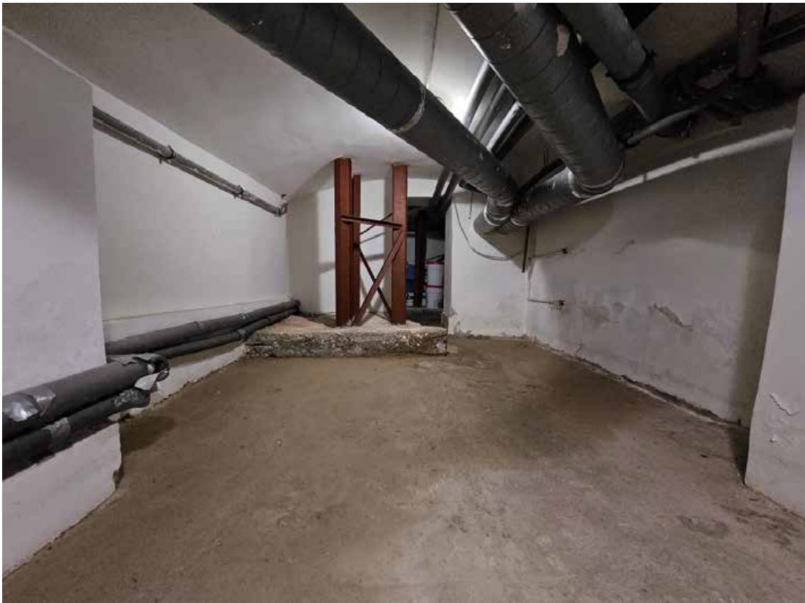
22. Выявленный объект культурного наследия «Здание женской гимназии Э.П. Шаффе», по адресу: г. Санкт-Петербург, 5-я линия, 16, (правая часть). Фрагмент пом. 2-Н (26) в уровне подвала.
