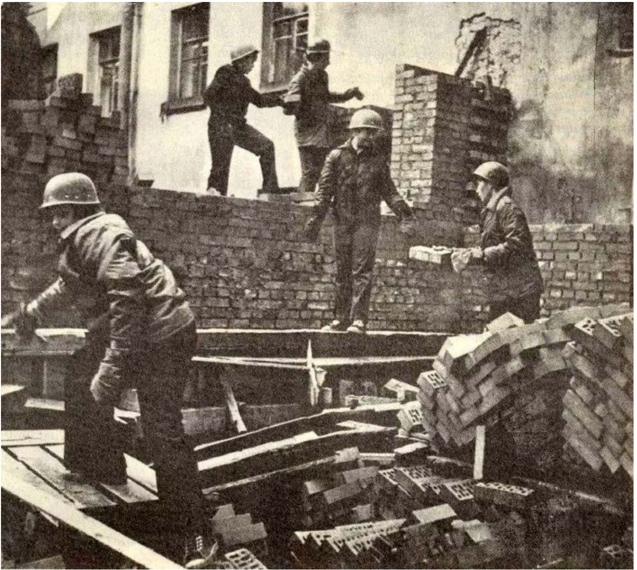
18. Строительство бассейна школы № 21. Фото 1975 г. Автор: И. Колтун. Журнал «Костёр» № 1, 1976 г. С. 31.
