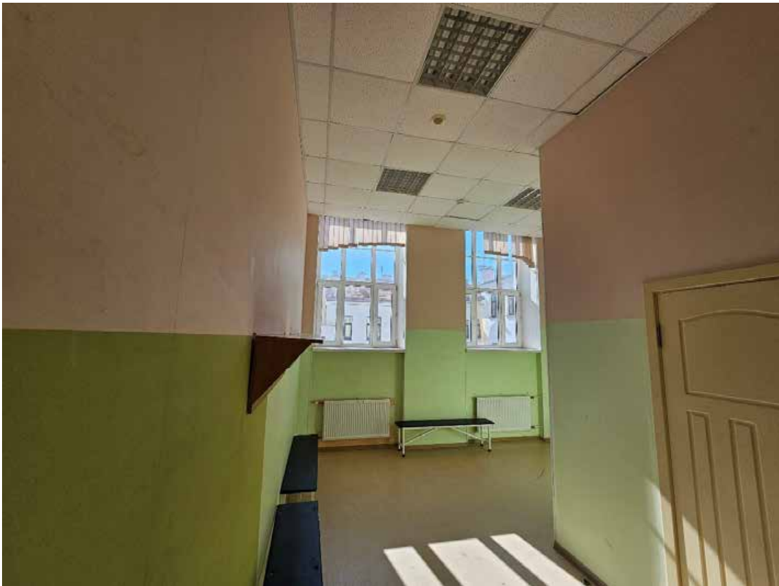
116. Выявленный объект культурного наследия «Здание женской гимназии Э.П. Шаффе», по адресу: г. Санкт-Петербург, 5-я линия, 16, (правая часть). Общий вид пом. 2-Н (114) в уровне 3-го этажа.
