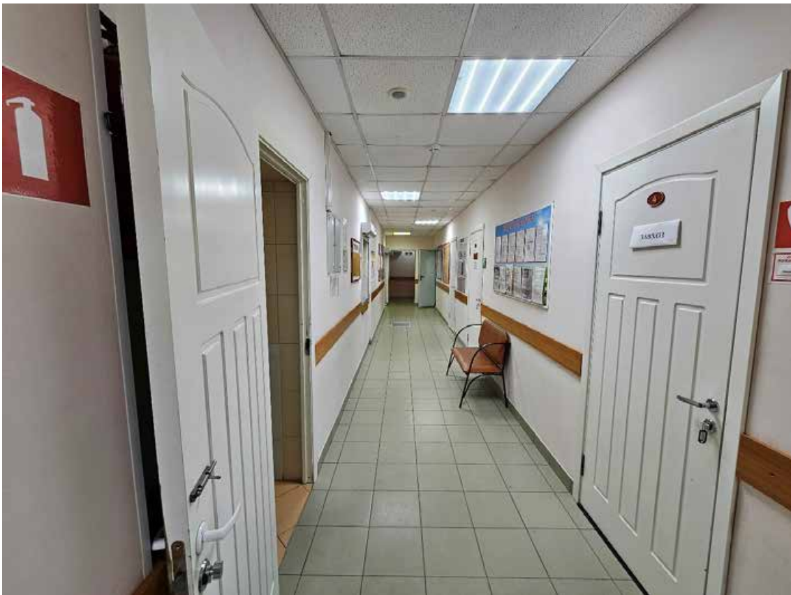
63. Выявленный объект культурного наследия «Дом А.А. Куракиной (Э.П. Шаффе)», по адресу: г. Санкт-Петербург, Большой пр. В.О., 17; 5-я линия, 16 (левая часть). Общий вид пом. 1-Н (9) в уровне 1-го этажа.
