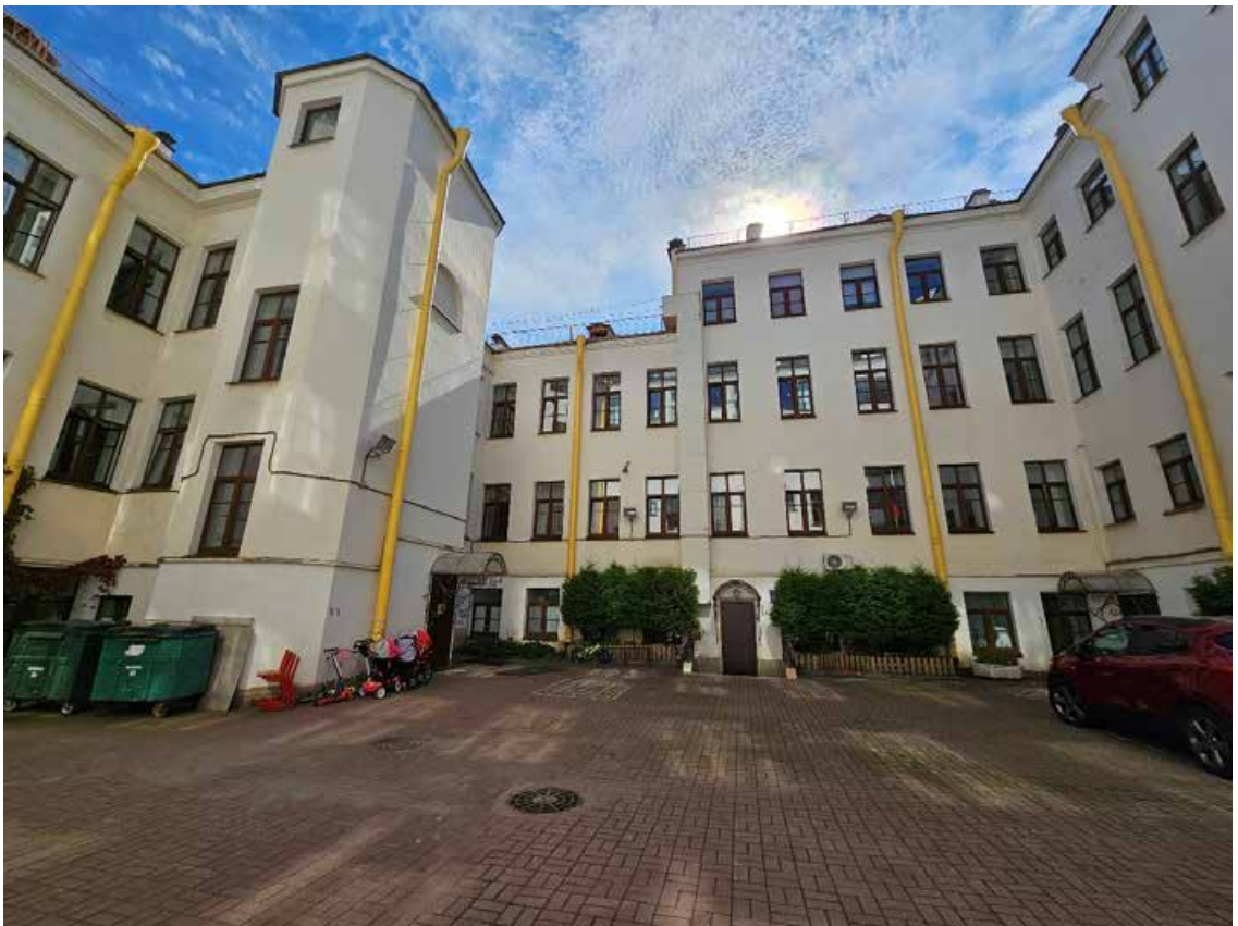
10. Выявленный объект культурного наследия «Дом А.А. Куракиной (Э.П. Шаффе)», по адресу: г. Санкт-Петербург, Большой пр. В.О., 17; 5-я линия, 16 (левая часть). Общий вид северо-западного дворового фасада.
