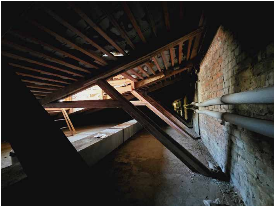
148. Выявленный объект культурного наследия «Дом А.А. Куракиной (Э.П. Шаффе)», по адресу: г. Санкт-Петербург, Большой пр. В.О., 17; 5-я линия, 16 (левая часть). Общий вид стропильной системы крыши в юго-западной части чердака.
