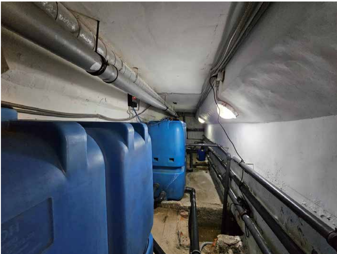
25. Выявленный объект культурного наследия «Здание женской гимназии Э.П. Шаффе», по адресу: г. Санкт-Петербург, 5-я линия, 16, (правая часть). Фрагмент пом. 2-Н (28) в уровне подвала.
