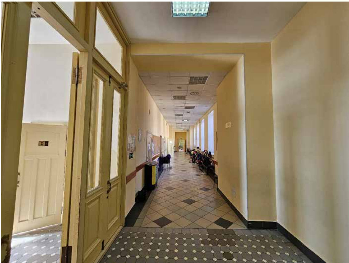
113. Выявленный объект культурного наследия «Здание женской гимназии Э.П. Шаффе», по адресу: г. Санкт-Петербург, 5-я линия, 16, (правая часть). Общий вид пом. 2-Н (109) в уровне 3-го этажа.
