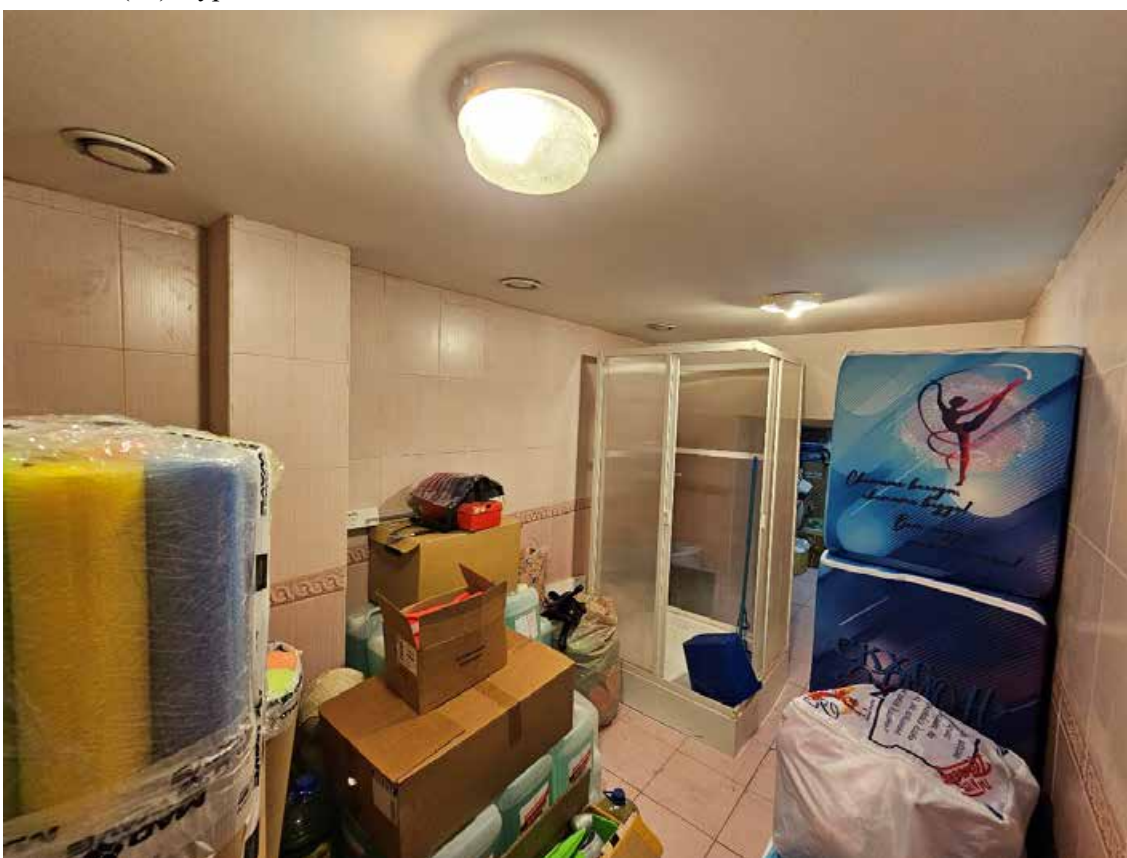
49. Выявленный объект культурного наследия «Дом А.А. Куракиной (Э.П. Шаффе)», по адресу: г. Санкт-Петербург, Большой пр. В.О., 17; 5-я линия, 16 (левая часть). Общий вид пом. 2-Н (59) в уровне 1-го этажа.
