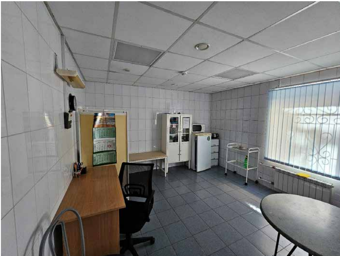
45. Выявленный объект культурного наследия «Здание женской гимназии Э.П. Шаффе», по адресу: г. Санкт-Петербург, 5-я линия, 16, (правая часть). Общий вид пом. 2-Н (50) в уровне 1-го этажа.
