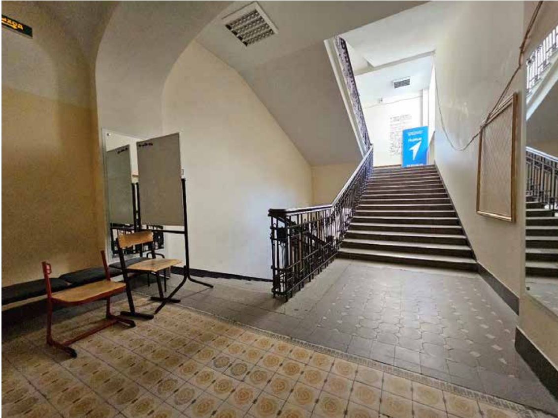
30. Выявленный объект культурного наследия «Здание женской гимназии Э.П. Шаффе», по адресу: г. Санкт-Петербург, 5-я линия, 16, (правая часть). Общий вид парадной лестницы Л-3 (пом. 2-Н (8)) в уровне 1-го этажа.
