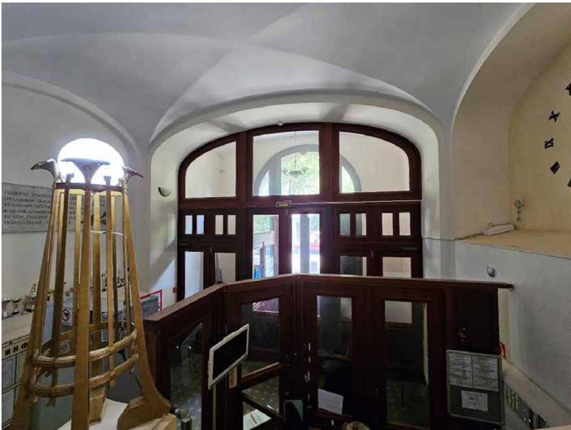
27. Выявленный объект культурного наследия «Здание женской гимназии Э.П. Шаффе», по адресу: г. Санкт-Петербург, 5-я линия, 16, (правая часть). Фрагмент пом. 2-Н (4) в уровне 1-го этажа.
