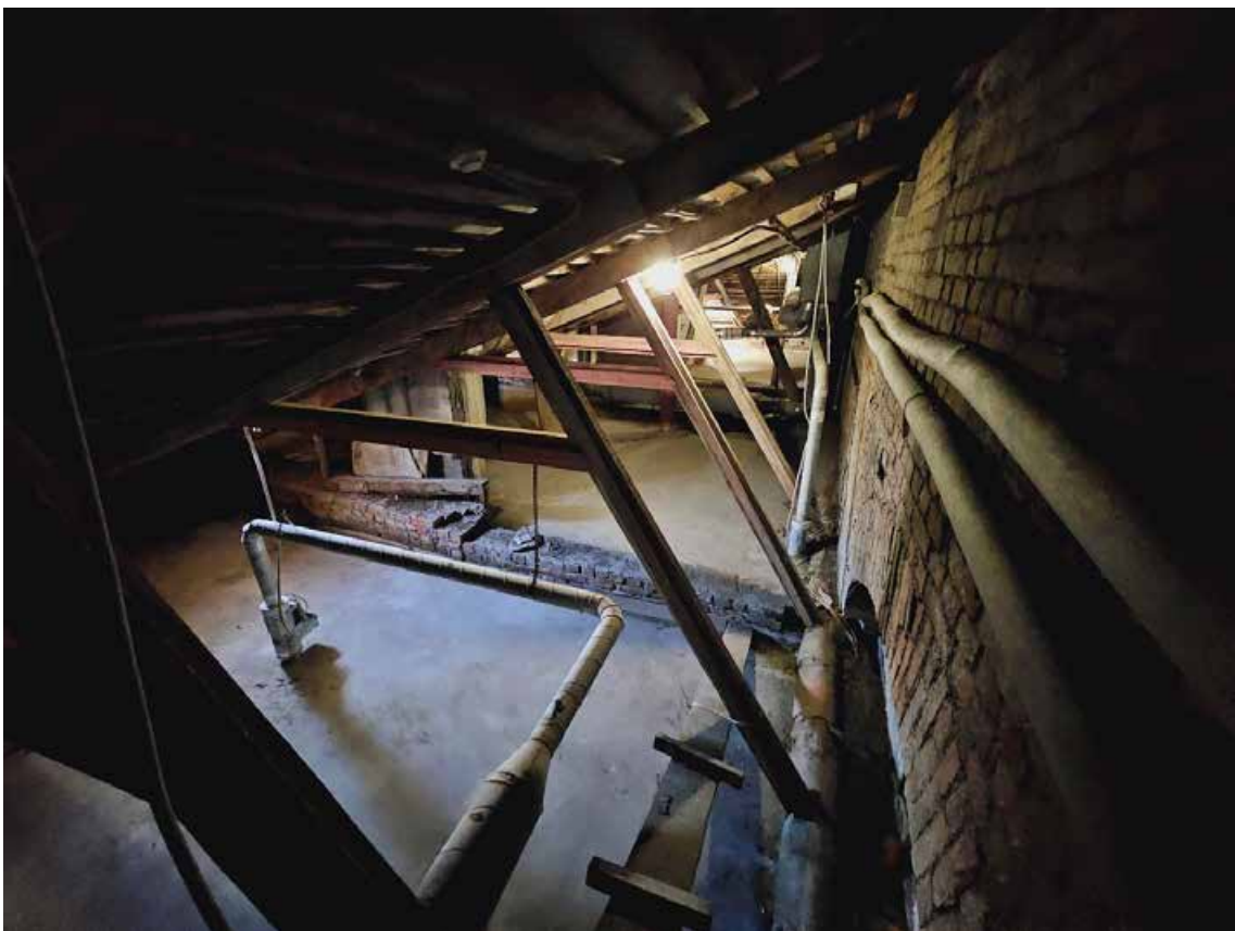
149. Выявленный объект культурного наследия «Дом А.А. Куракиной (Э.П. Шаффе)», по адресу: г. Санкт-Петербург, Большой пр. В.О., 17; 5-я линия, 16 (левая часть). Общий вид стропильной системы крыши в юго-западной части чердака.
