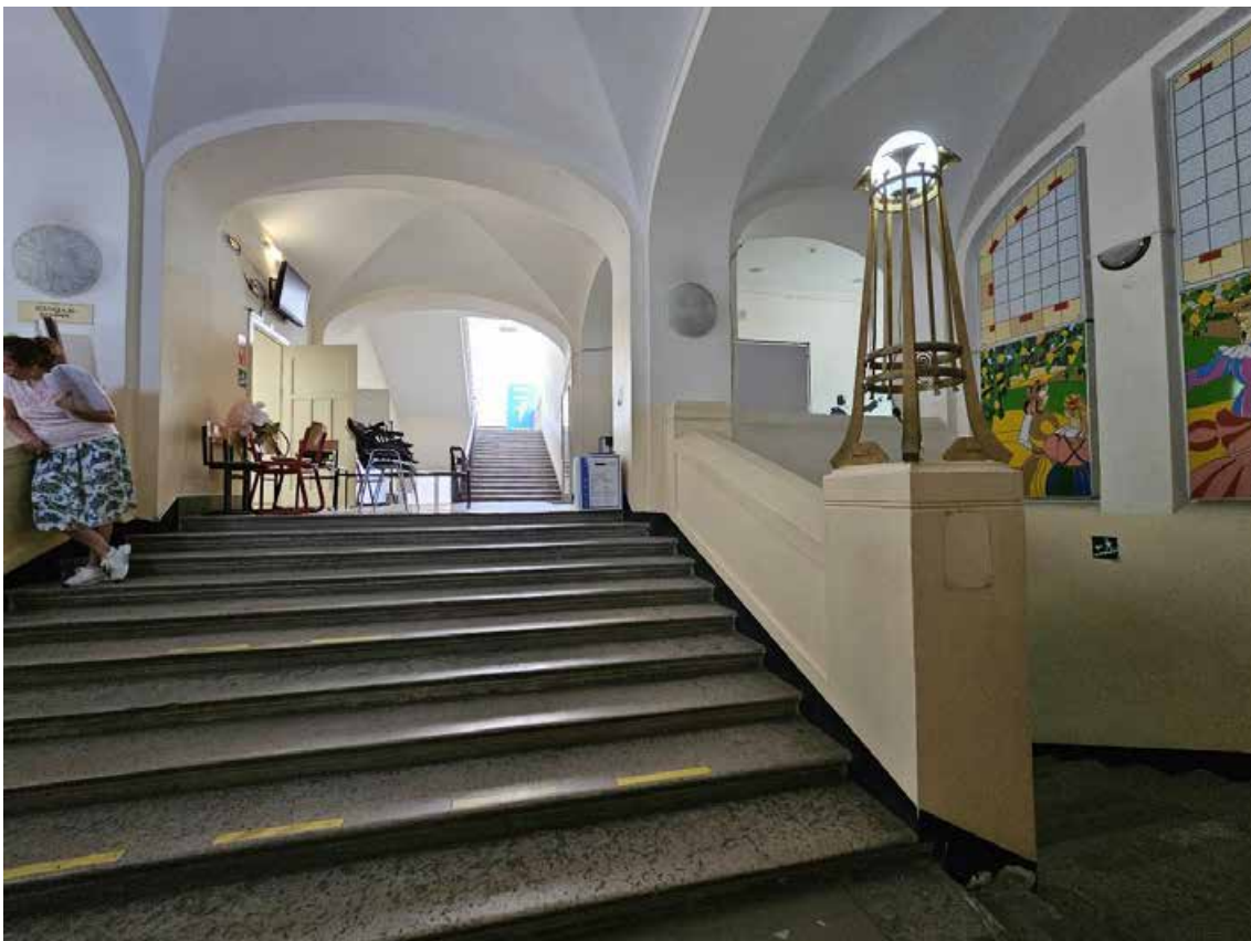
28. Выявленный объект культурного наследия «Здание женской гимназии Э.П. Шаффе», по адресу: г. Санкт-Петербург, 5-я линия, 16, (правая часть). Фрагмент пом. 2-Н (4) в уровне 1-го этажа (лестница Л-1).
