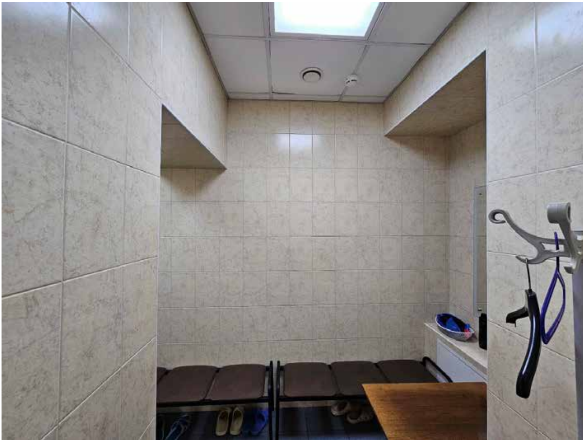
46. Выявленный объект культурного наследия «Здание женской гимназии Э.П. Шаффе», по адресу: г. Санкт-Петербург, 5-я линия, 16, (правая часть). Общий вид пом. 2-Н (49) в уровне 1-го этажа.
