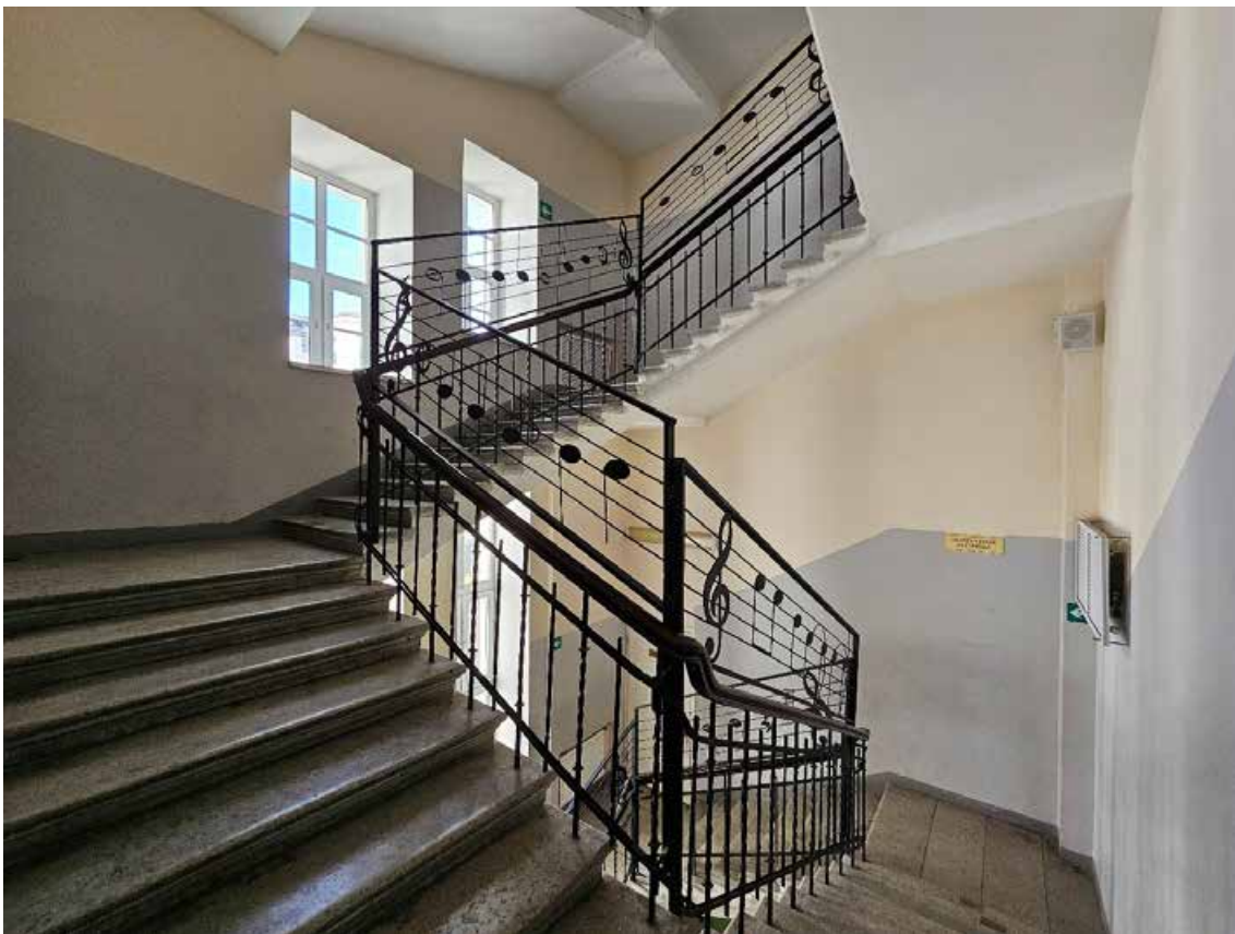
96. Выявленный объект культурного наследия «Здание женской гимназии Э.П. Шаффе», по адресу: г. Санкт-Петербург, 5-я линия, 16, (правая часть). Общий вид служебной лестницы Л-4 (пом. 2-Н (102)) в уровне 2-го этажа.
