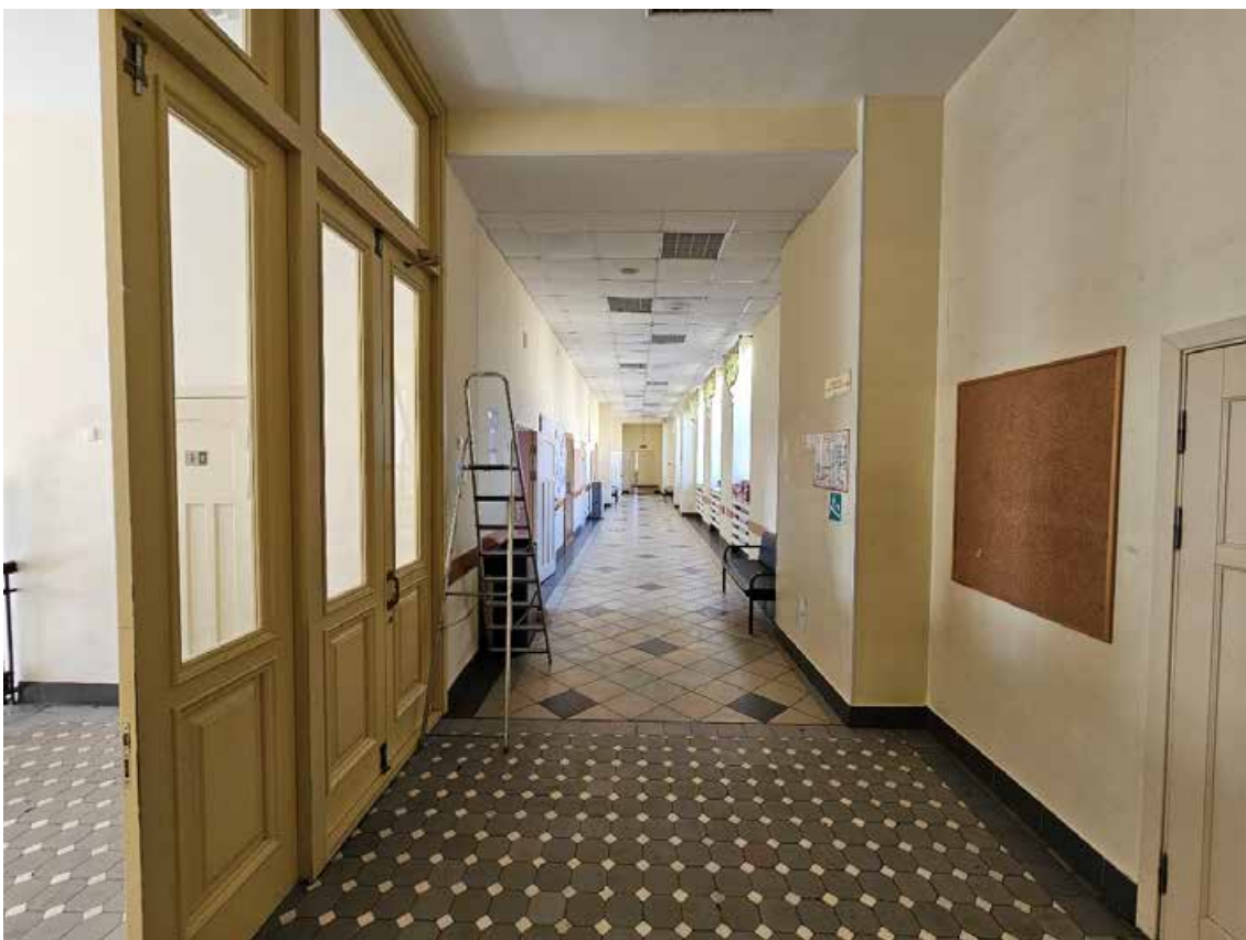
138. Выявленный объект культурного наследия «Здание женской гимназии Э.П. Шаффе», по адресу: г. Санкт-Петербург, 5-я линия, 16, (правая часть). Общий вид пом. 2-Н (129) в уровне 4-го этажа.
