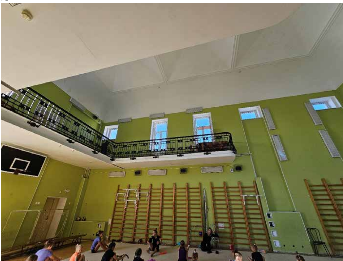
119. Выявленный объект культурного наследия «Здание женской гимназии Э.П. Шаффе», по адресу: г. Санкт-Петербург, 5-я линия, 16, (правая часть). Общий вид пом. 2-Н (120) в уровне 3-го этажа.
