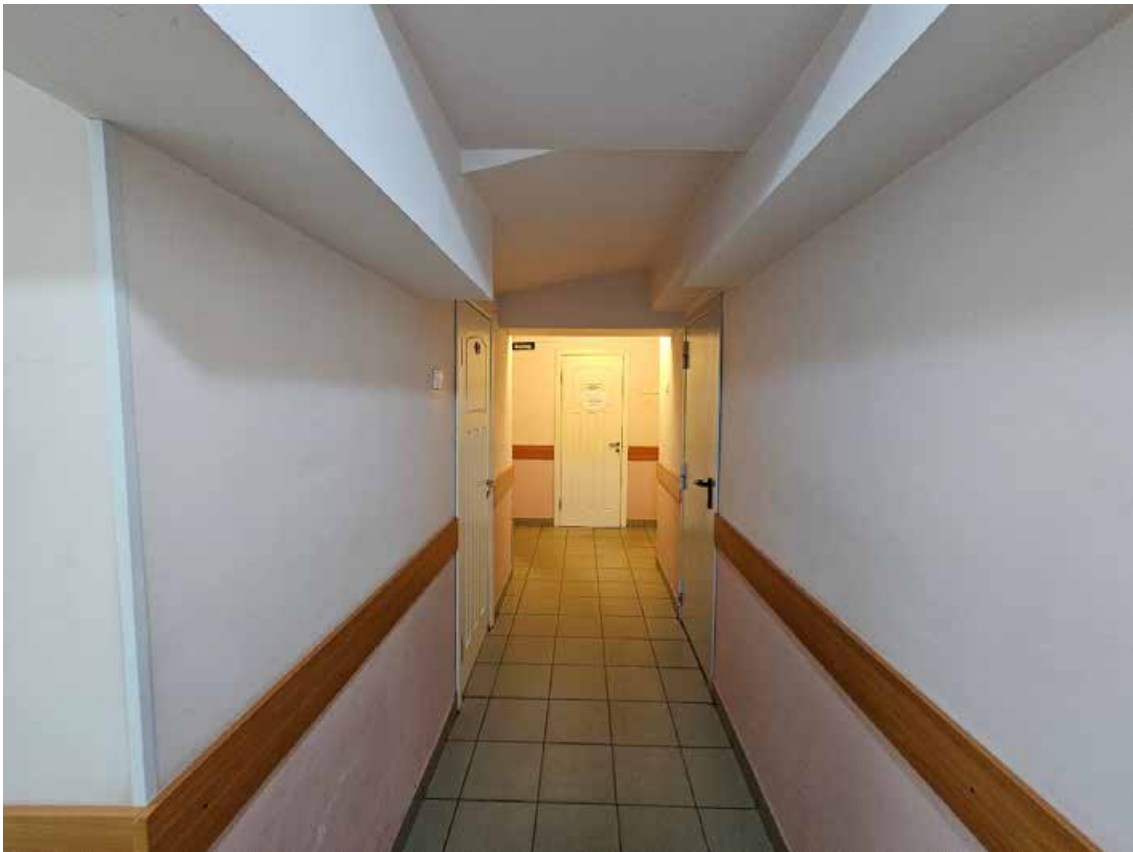
70. Выявленный объект культурного наследия «Дом А.А. Куракиной (Э.П. Шаффе)», по адресу: г. Санкт-Петербург, Большой пр. В.О., 17; 5-я линия, 16 (левая часть). Общий вид пом. 1-Н (3) в уровне 1-го этажа.
