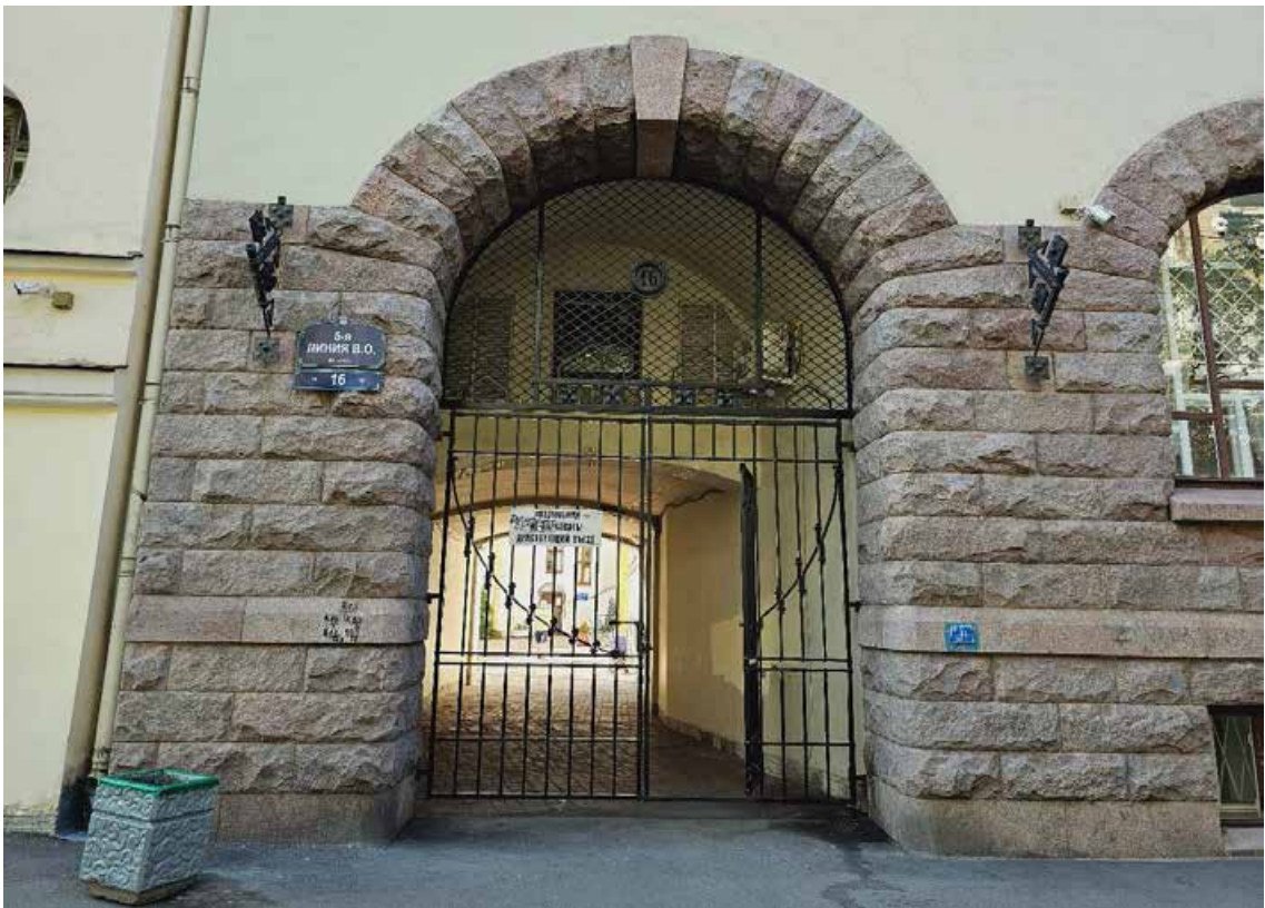
8. Выявленный объект культурного наследия «Здание женской гимназии Э.П. Шаффе», по адресу: г. Санкт-Петербург, 5-я линия, 16, (правая часть). Общий вид на воротный проезд со стороны северо-восточного лицевого фасада по 5-й линии В.О.
