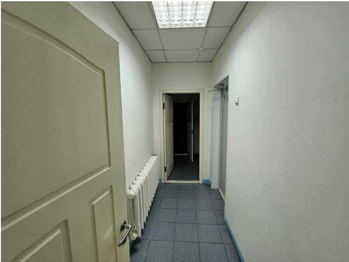
42. Выявленный объект культурного наследия «Здание женской гимназии Э.П. Шаффе», по адресу: г. Санкт-Петербург, 5-я линия, 16, (правая часть). Общий вид пом. 2-Н (38) в уровне 1-го этажа.
