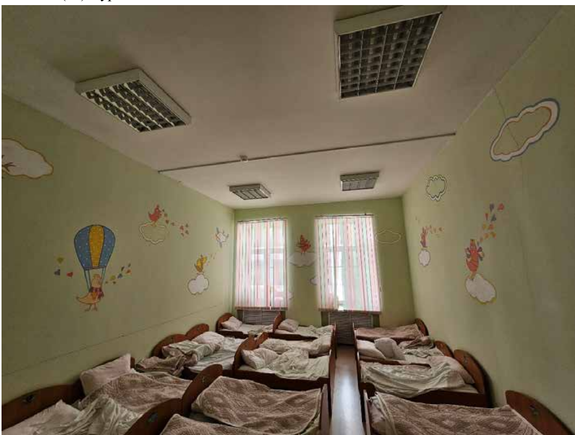
108. Выявленный объект культурного наследия «Дом А.А. Куракиной (Э.П. Шаффе)», по адресу: г. Санкт-Петербург, Большой пр. В.О., 17; 5-я линия, 16 (левая часть). Общий вид пом. 1-Н (54) в уровне 2-го этажа.
