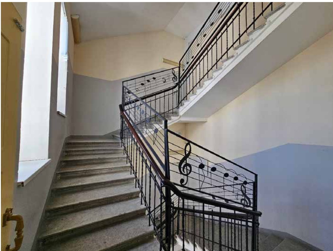
145. Выявленный объект культурного наследия «Здание женской гимназии Э.П. Шаффе», по адресу: г. Санкт-Петербург, 5-я линия, 16, (правая часть). Общий вид служебной лестницы Л-4 (пом. 2-Н (136)) в уровне 4-го этажа.
