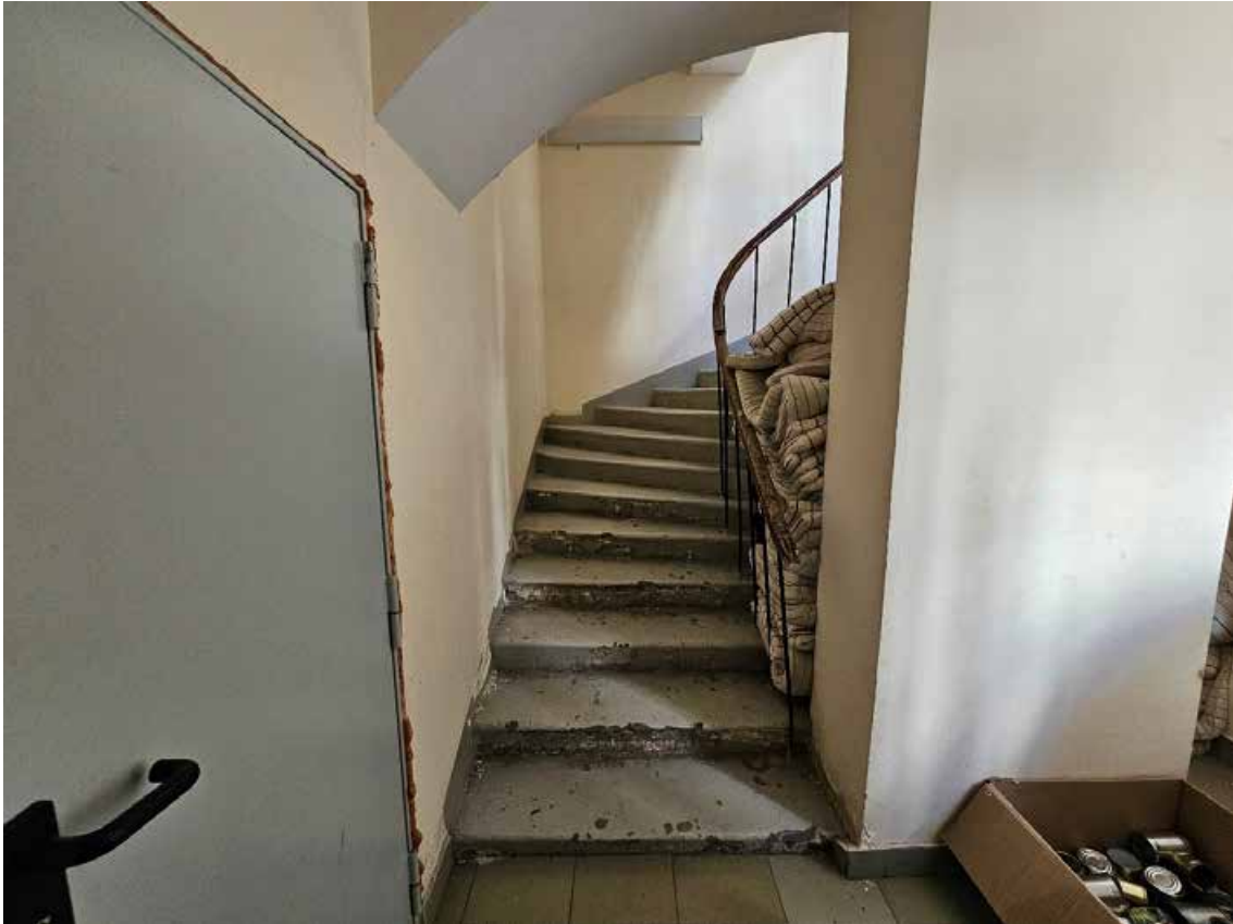
62. Выявленный объект культурного наследия «Дом А.А. Куракиной (Э.П. Шаффе)», по адресу: г. Санкт-Петербург, Большой пр. В.О., 17; 5-я линия, 16 (левая часть). Общий вид лестницы Л-2 в уровне 1-го этажа.
