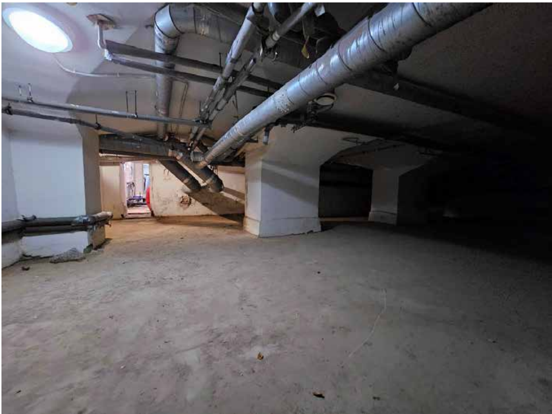
23. Выявленный объект культурного наследия «Здание женской гимназии Э.П. Шаффе», по адресу: г. Санкт-Петербург, 5-я линия, 16, (правая часть). Фрагмент пом. 2-Н (26) в уровне подвала.
