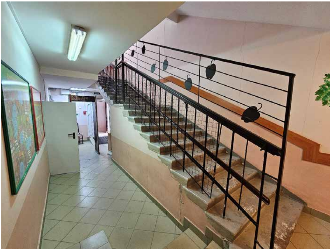
73. Выявленный объект культурного наследия «Дом А.А. Куракиной (Э.П. Шаффе)», по адресу: г. Санкт-Петербург, Большой пр. В.О., 17; 5-я линия, 16 (левая часть). Общий вид лестницы Л-3 в уровне 1-го этажа.
