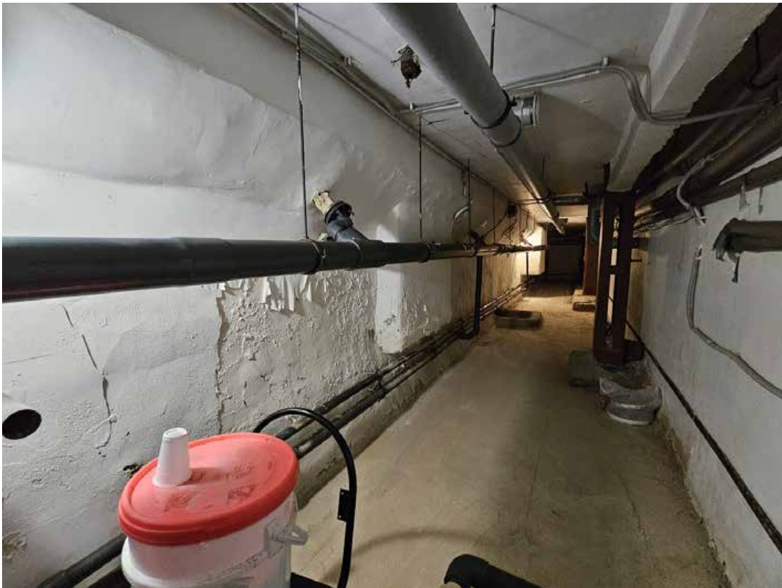
24. Выявленный объект культурного наследия «Здание женской гимназии Э.П. Шаффе», по адресу: г. Санкт-Петербург, 5-я линия, 16, (правая часть). Фрагмент пом. 2-Н (28) в уровне подвала.
