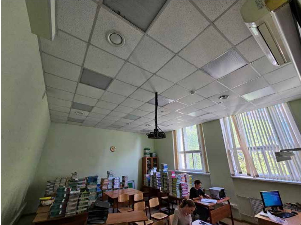
87. Выявленный объект культурного наследия «Здание женской гимназии Э.П. Шаффе», по адресу: г. Санкт-Петербург, 5-я линия, 16, (правая часть). Общий вид пом. 2-Н (89) в уровне 2-го этажа.
