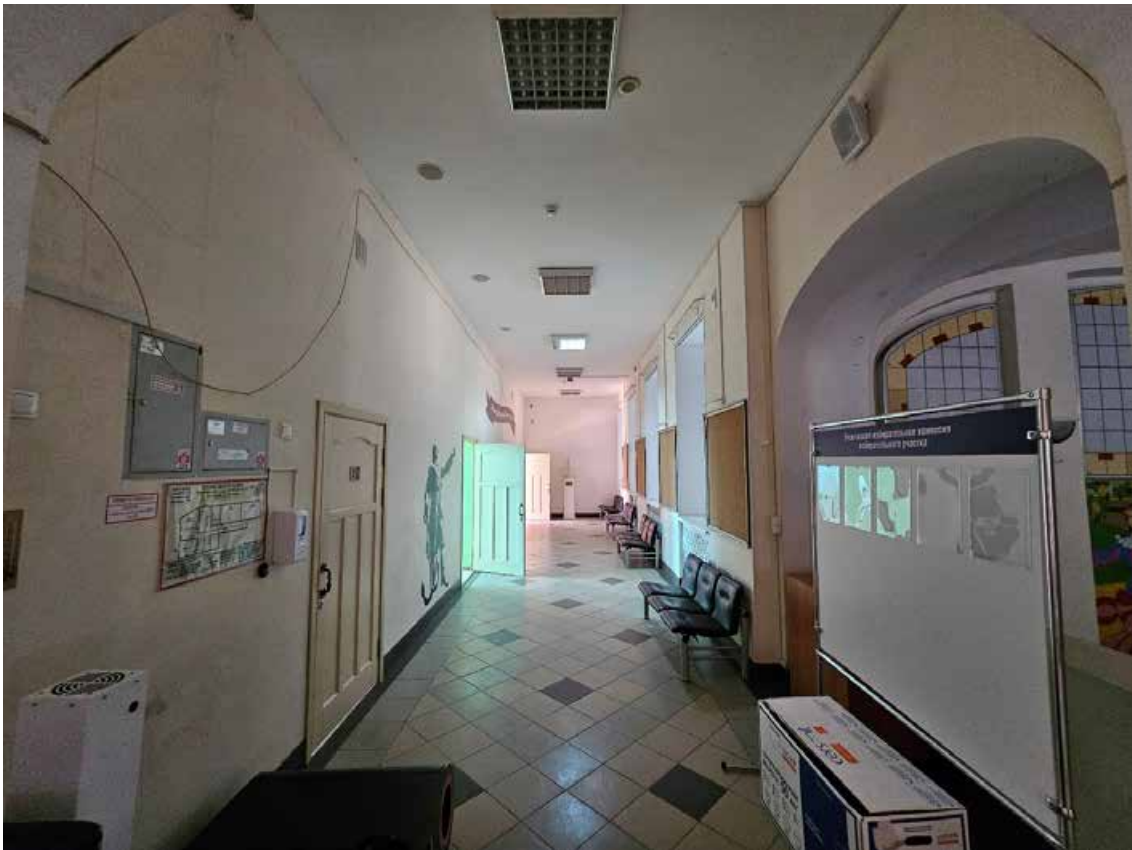
32. Выявленный объект культурного наследия «Здание женской гимназии Э.П. Шаффе», по адресу: г. Санкт-Петербург, 5-я линия, 16, (правая часть). Общий вид пом. 2-Н (9) в уровне 1-го этажа.
