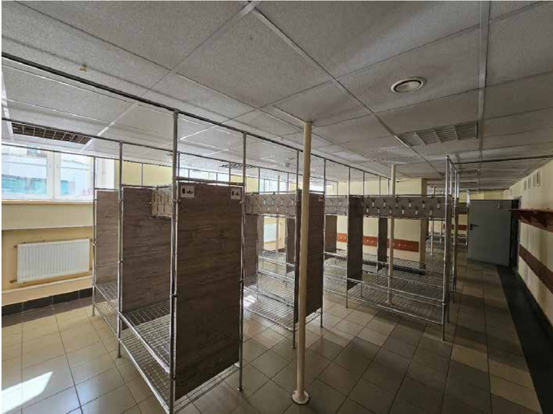
16. Выявленный объект культурного наследия «Здание женской гимназии Э.П. Шаффе», по адресу: г. Санкт-Петербург, 5-я линия, 16, (правая часть). Фрагмент пом. 2-Н (19) в уровне подвала.
