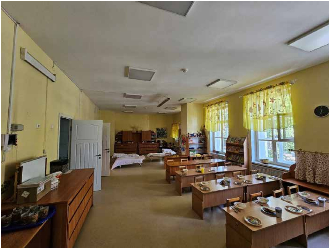
99. Выявленный объект культурного наследия «Дом А.А. Куракиной (Э.П. Шаффе)», по адресу: г. Санкт-Петербург, Большой пр. В.О., 17; 5-я линия, 16 (левая часть). Общий вид пом. 1-Н (70) в уровне 2-го этажа.
