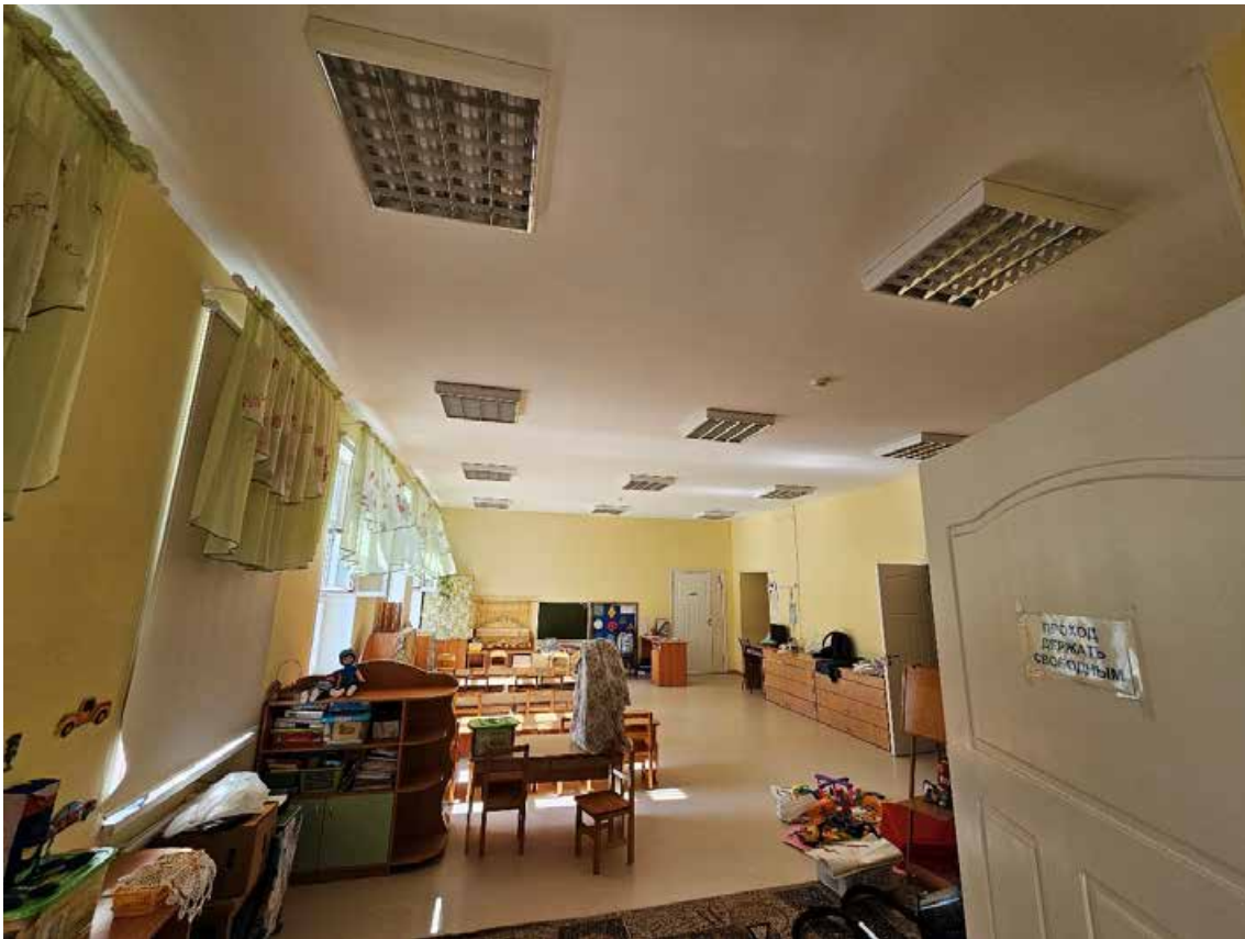
105. Выявленный объект культурного наследия «Дом А.А. Куракиной (Э.П. Шаффе)», по адресу: г. Санкт-Петербург, Большой пр. В.О., 17; 5-я линия, 16 (левая часть). Общий вид пом. 1-Н (56) в уровне 2-го этажа.
