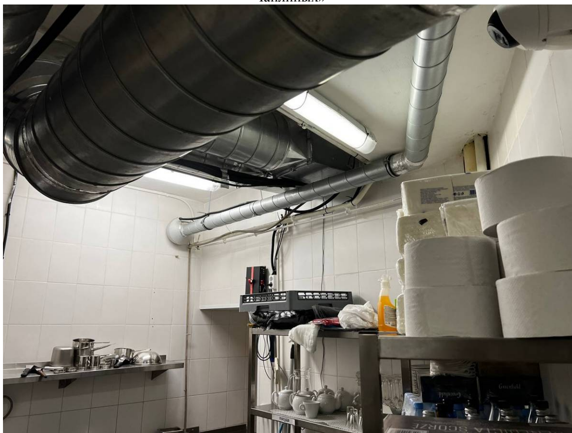
Фото 44. Интерьер пом. 10-Н объекта культурного наследия федерального значения «Дом Чаплиных»
