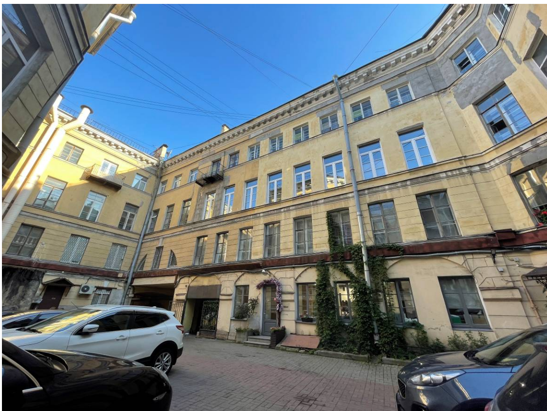
Фото 13. Фрагмент дворового фасада объекта культурного наследия федерального значения «Дом Чаплиных»
