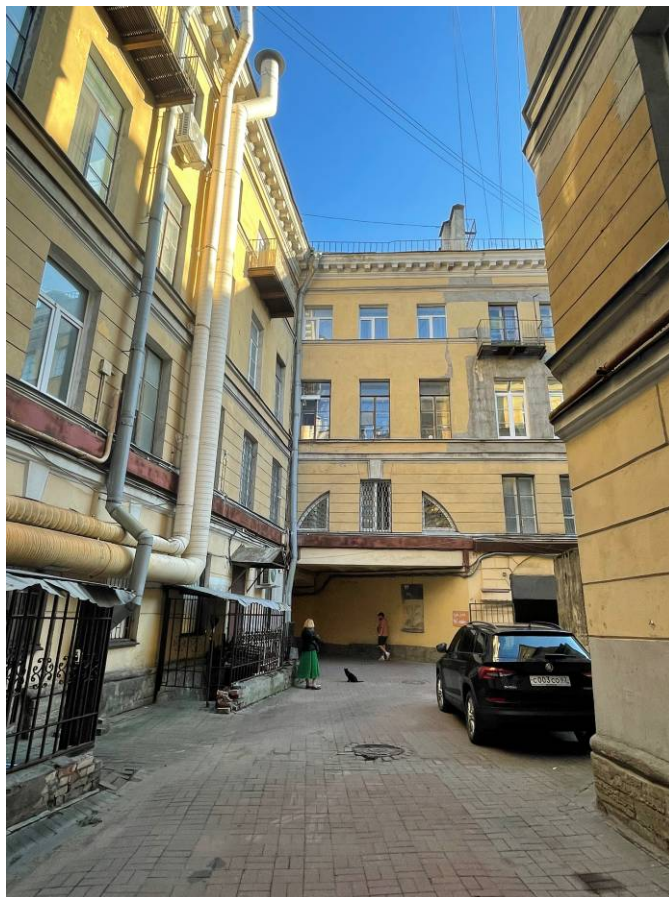
Фото 9. Фрагмент дворового фасада объекта культурного наследия федерального значения «Дом Чаплиных»
