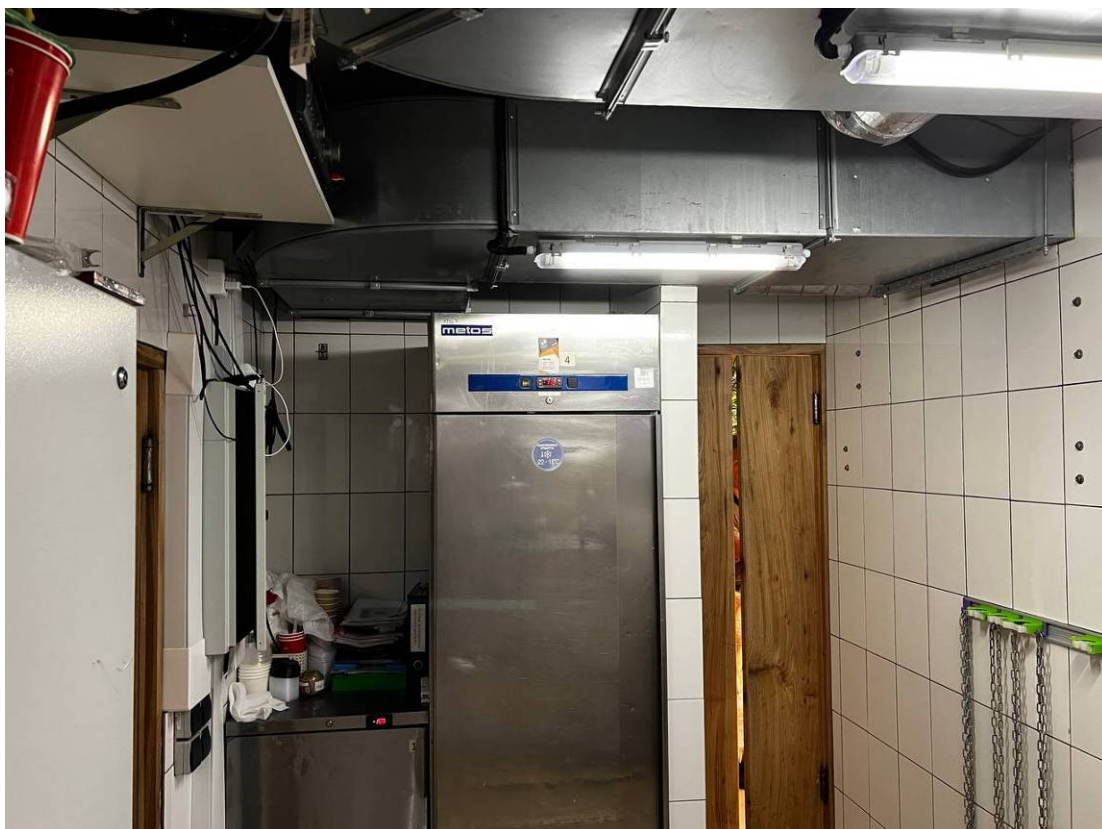
Фото 37. Интерьер пом. 10-Н объекта культурного наследия федерального значения «Дом Чаплиных»
