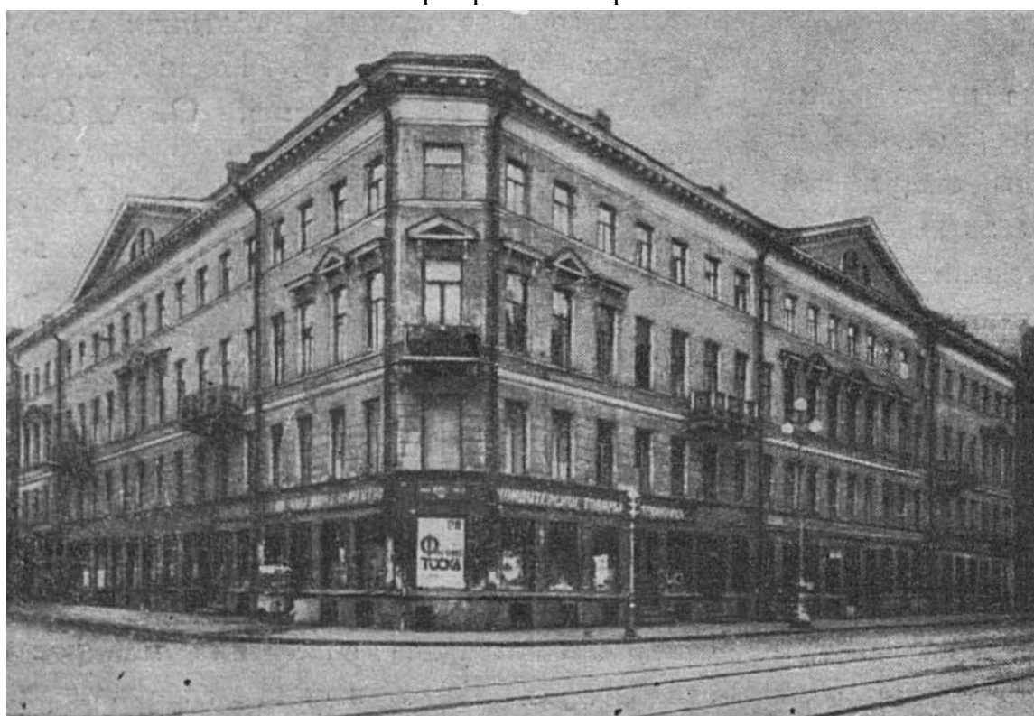
17. Дом №13 по Невскому проспекту до реконструкции. 1950 г. — «PastVu» – ретро-фотографии стран и городов [Электронный ресурс]. URL: https://pastvu.com/p/311898 .
