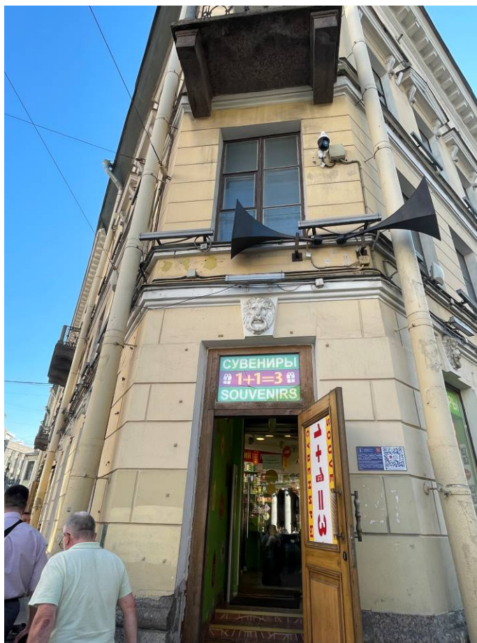
Фото 3. Лицевой фасад объекта культурного наследия федерального значения «Дом Чаплиных» (по Невскому пр., вход в пом. 1-Н)
