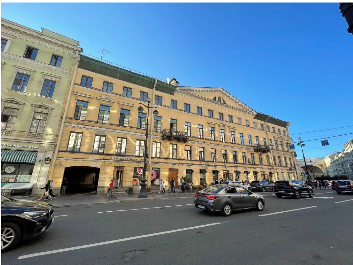
Фото 5. Лицевой фасад объекта культурного наследия федерального значения «Дом Чаплиных» (по Большой Морской ул.)
