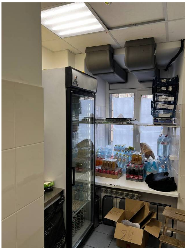
Фото 57. Интерьер пом. 10-Н объекта культурного наследия федерального значения «Дом Чаплиных»
