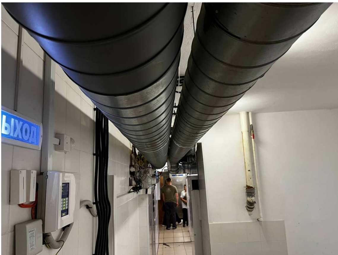
Фото 45. Интерьер пом. 10-Н объекта культурного наследия федерального значения «Дом Чаплиных»
