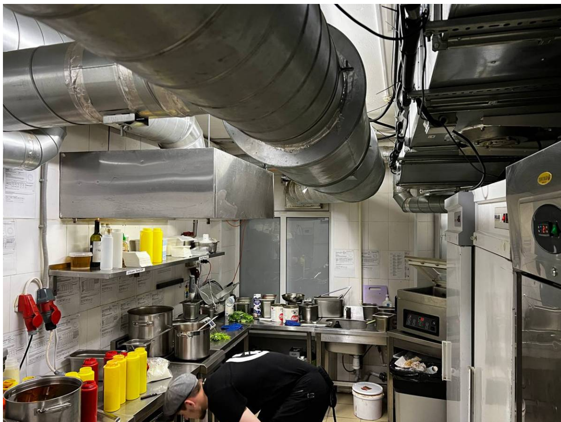
Фото 41. Интерьер пом. 10-Н объекта культурного наследия федерального значения «Дом Чаплиных»
