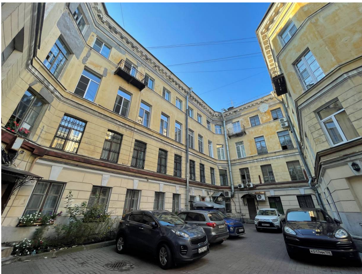
Фото 11. Фрагмент дворового фасада объекта культурного наследия федерального значения «Дом Чаплиных»
