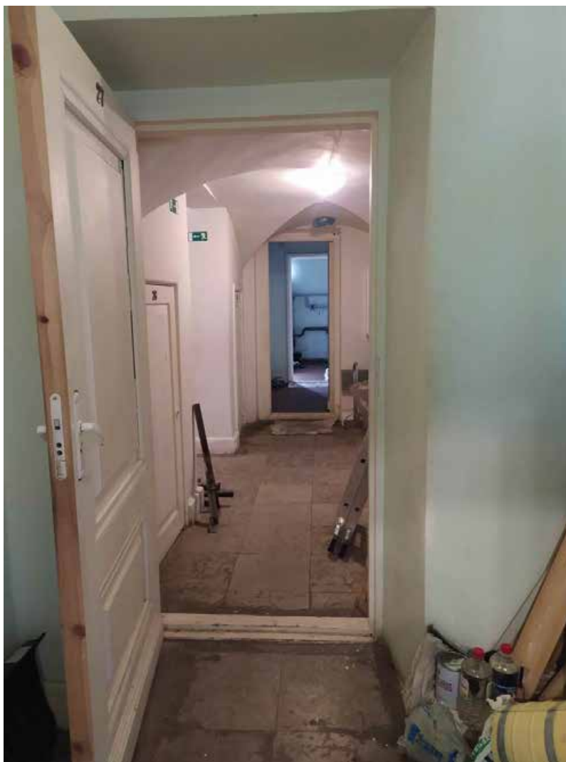
36. Вид в помещении 1-Н. Фотофиксация от 05.08.2024 г.
