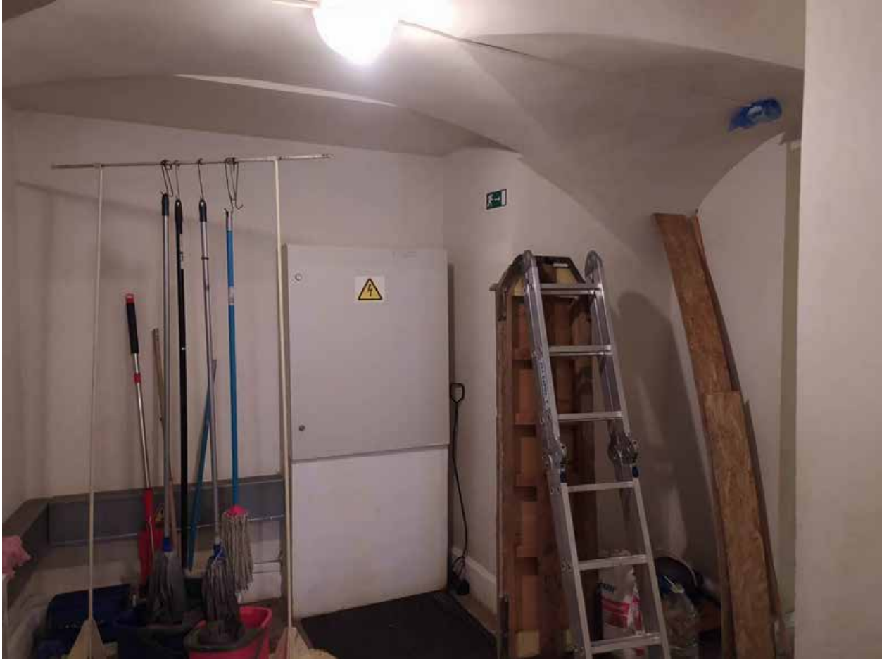
30. Вид в помещении 1-Н. Фотофиксация от 05.08.2024 г.
