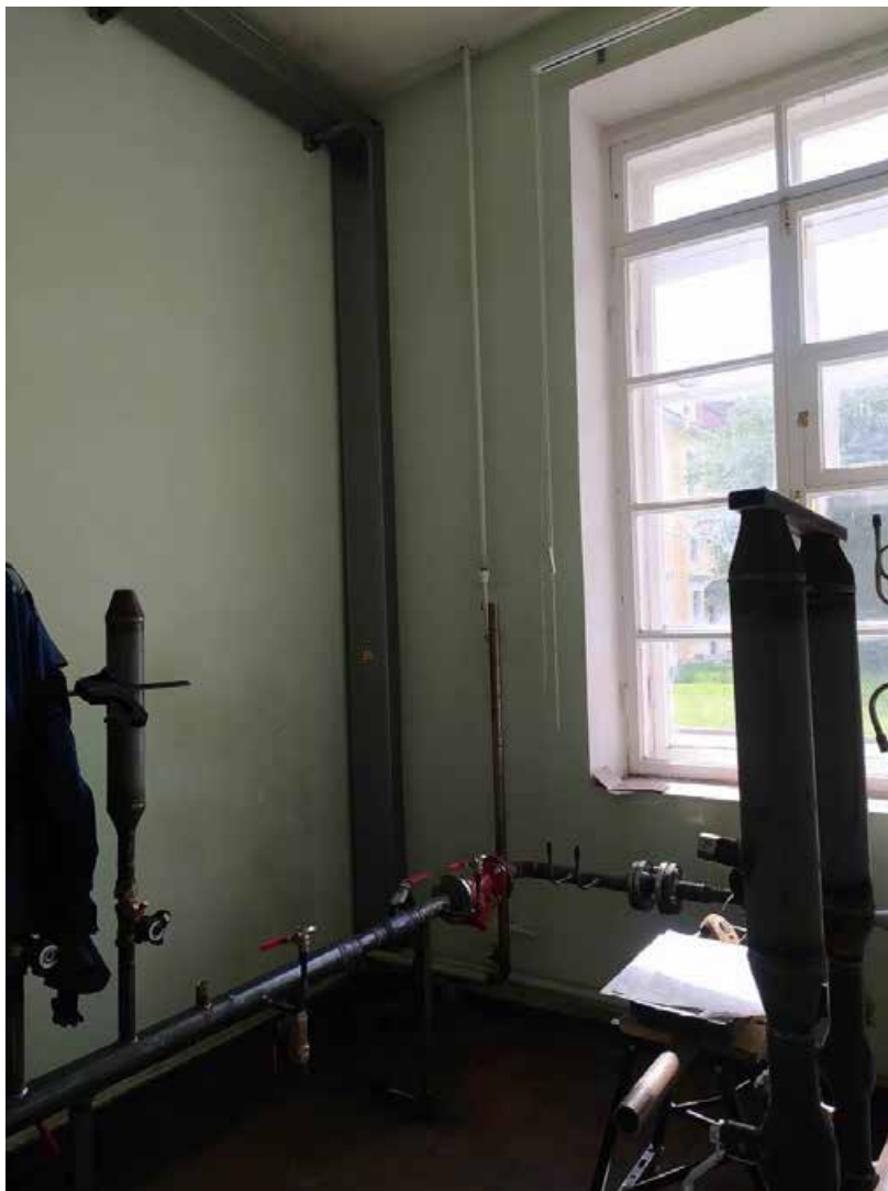
37. Вид в помещении 1-Н. Фотофиксация от 05.08.2024 г.
