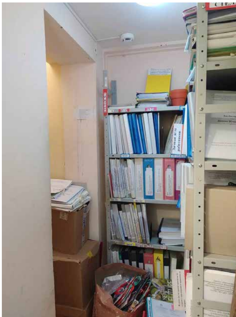
33. Вид в помещении 1-Н. Фотофиксация от 05.08.2024 г.
