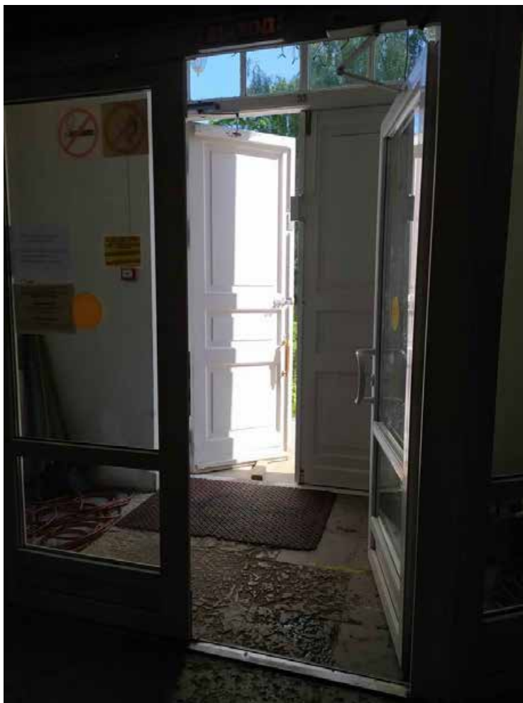
66. Вид в помещении 1-Н. Фотофиксация от 05.08.2024 г.
