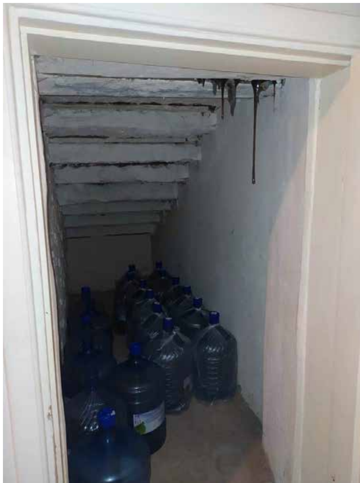
39. Вид в помещении 1-Н. Фотофиксация от 05.08.2024 г.
