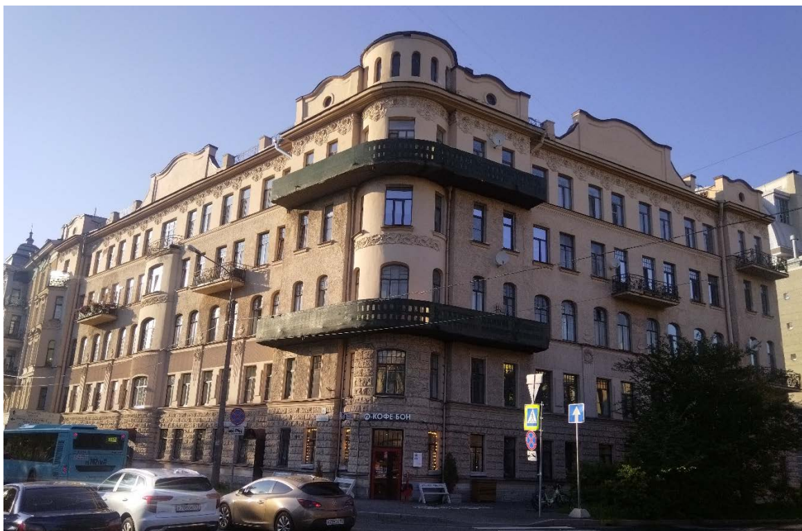
1. Объект культурного наследия регионального значения «Дом П.И. Поршневой» (г. Санкт-Петербург, наб. Черной речки, д. 49, литера А). Лицевой фасад. Дата съемки: 01.09.2024
