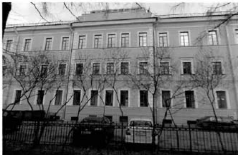
Фото №3. Дворовой фасад. Вид со стороны сада Театра юных зрителей.
