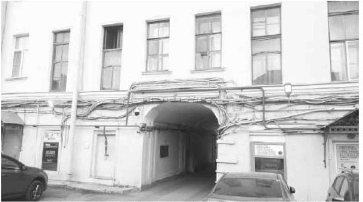
69. Дом Яковлева С.Я. (Гороховая ул., д. 45, лит. А). Дворовый фасад. Фото мест установки оборудования и кабельных трасс. Штиглиц М.С. 07.05.2024.
