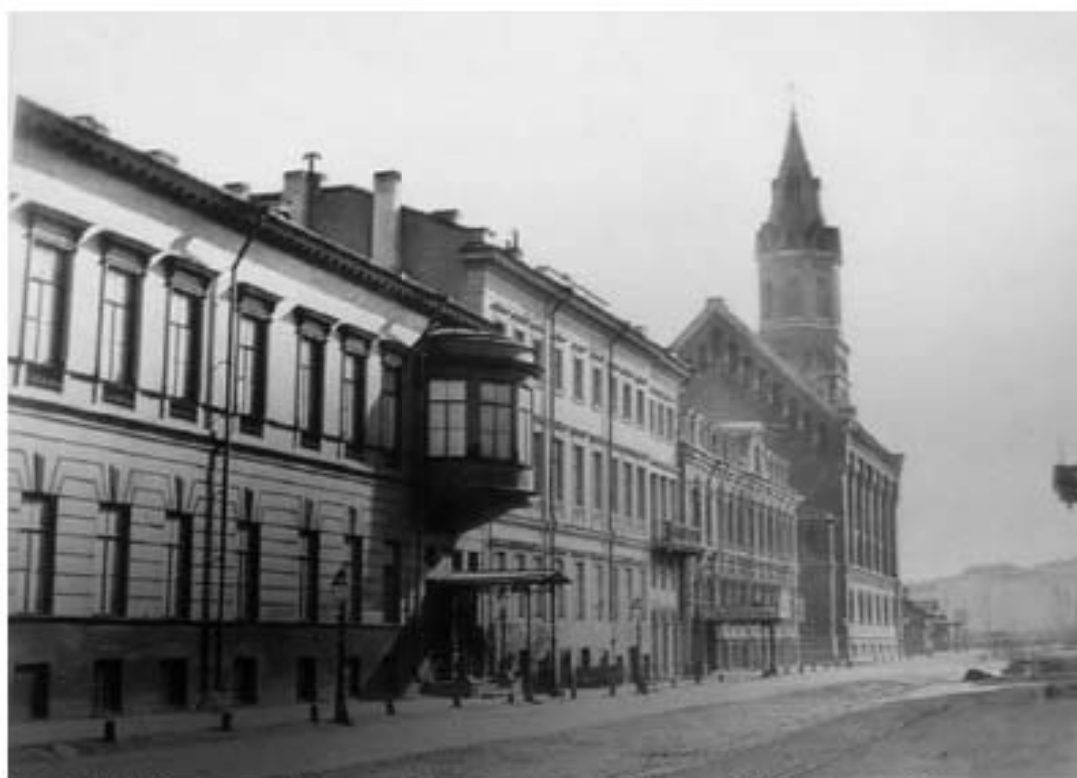
21. «Дом А.П. Козлова» (Большая Морская ул., д. 56, лит. А). Большая Морская ул. Дома 52, 54, 56. Фото - 1865 г. (дом №56 ещё строится) (30).
