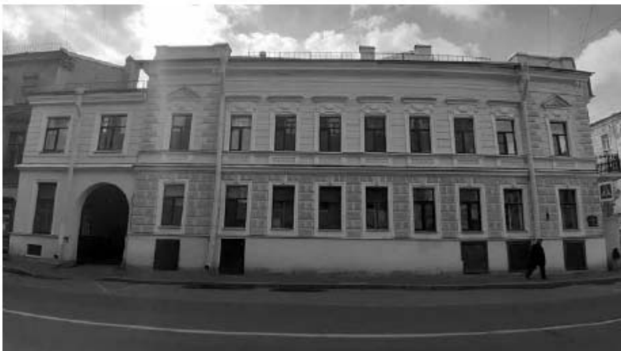
25. Особняк и доходный дом Н.Г. Кудрявцева. (4-я Красноармейская улица, д. 12/11, лит. А). Лицевой фасад по ул. Егорова. Штиглиц М.С. 07.05.2024.
