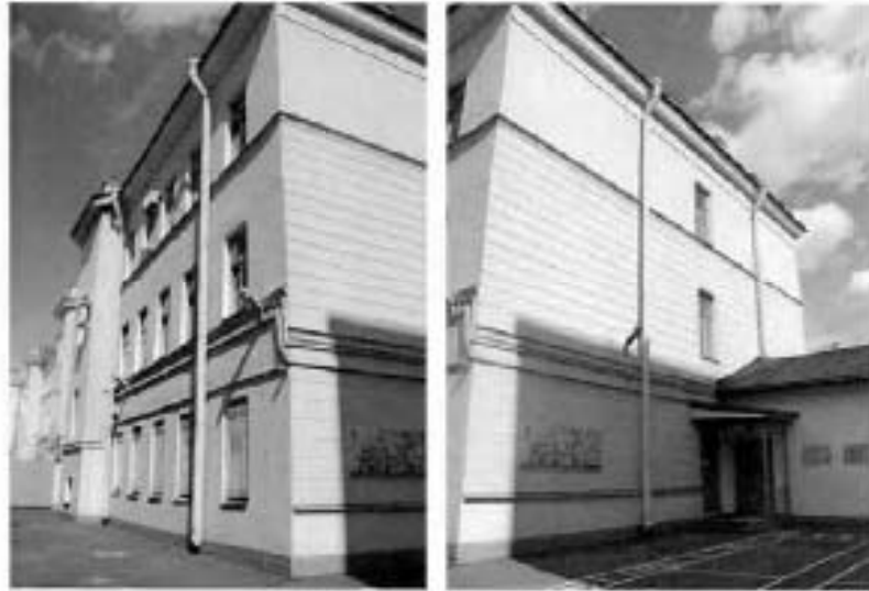
Фото №17. 18. Дворовые фасады.
