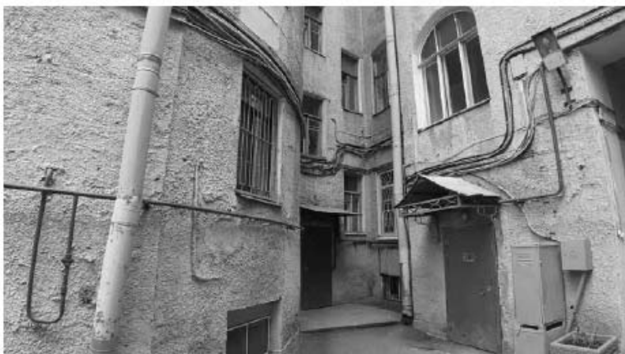
12. Дом Паулуччи А.Ф. Здесь в декабре 1905 - январе 1906 гг. проходили заседания ЦК и ПК РСДРП (Большая Морская ул., д. 36, лит. А). Дворовые фасады. Фото мест установки оборудования и кабельных трасс. Штиглиц М.С. 07.05.2024.
