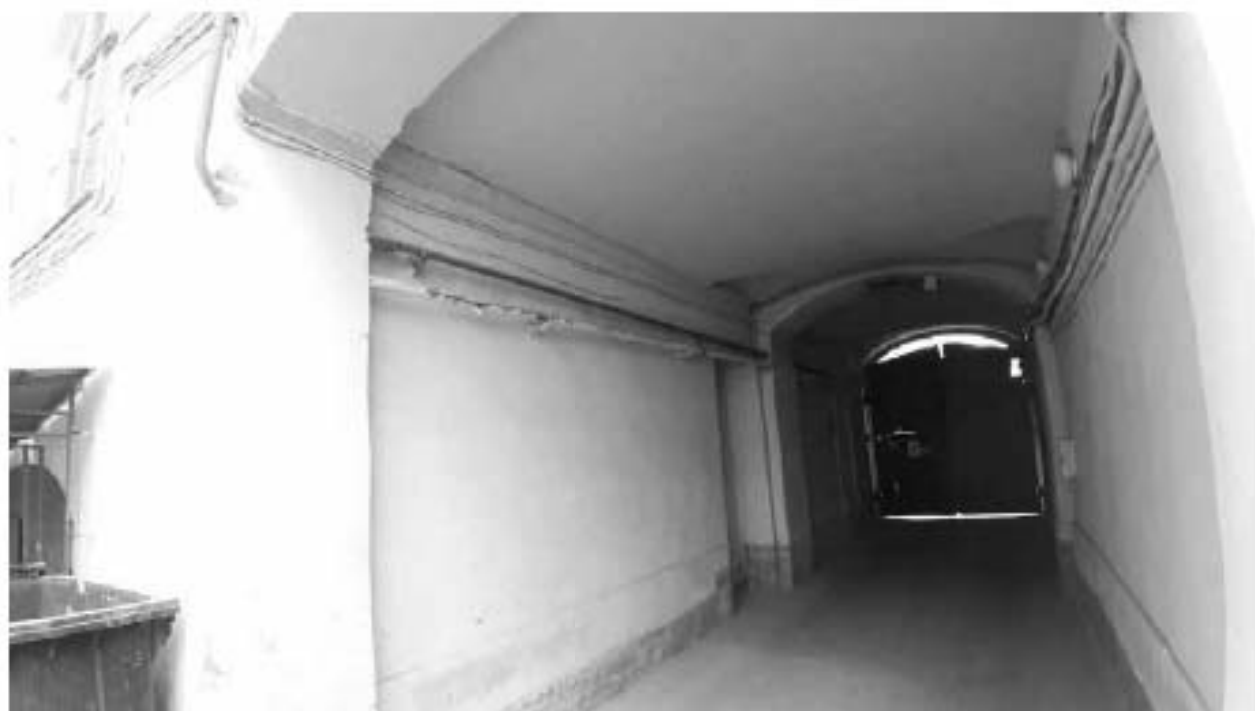
61. Дом Разевиха (Вознесенский пр., д. 28, лит. А). Арочный проезд. Фото мест установки оборудования и кабельных трасс. Штиглиц М.С. 07.05.2024.
