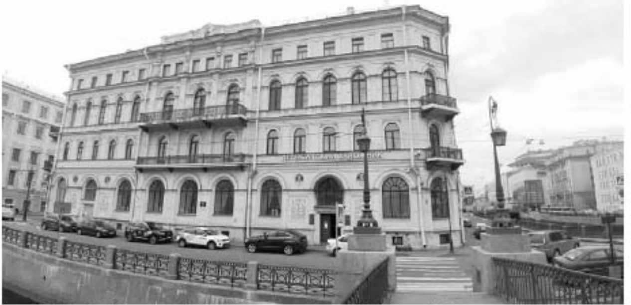
19. Дом А.Б.Фитингофа. (ул. Глинки, д. 1, лит. А). Лицевой фасад по наб. реки Мойки. Штиглиц М.С. 07.05.2024.
