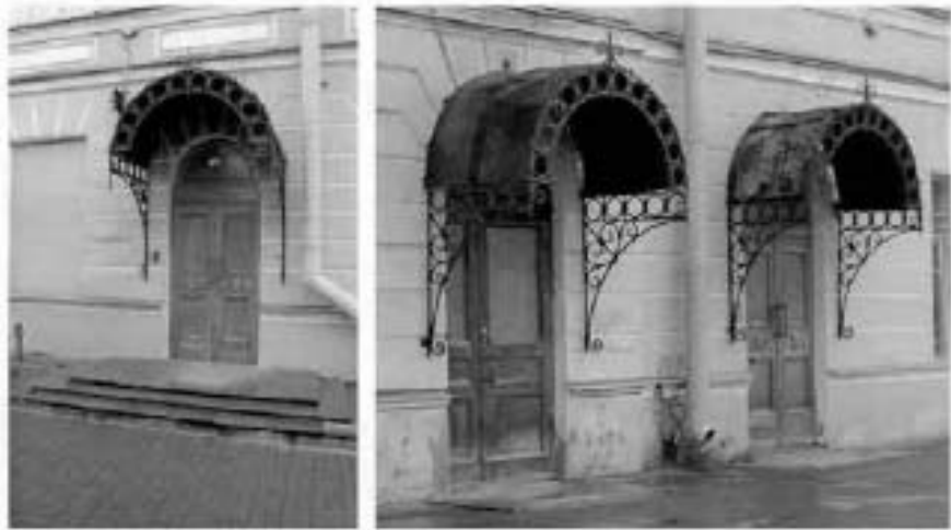
Фото №7, 8. Входные группы жилых фасадов.
