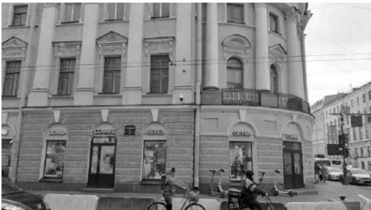
67. Дом Яковлева С.Я. (Гороховая ул., д. 45, лит. А). Лицевой фасад по Гороховой ул. Фото мест установки оборудования и кабельных трасс. Штиглиц М.С. 07.05.2024.
