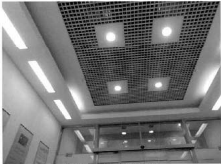
Фото №12. Перекрытие тамбура 1-го этажа.
