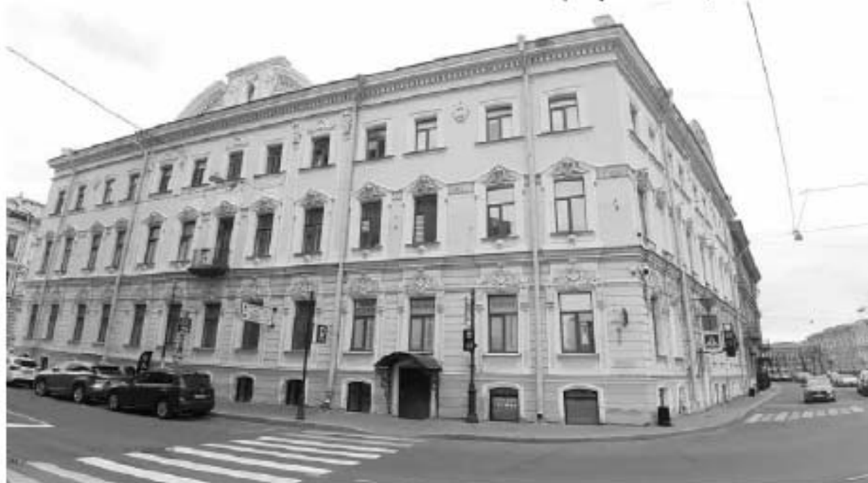
4. Дом А.П. Козлова (Большая Морская ул., д. 56, лит. А). Лицевой фасад по Большой Морской ул. Фото мест установки оборудования и кабельных трасс. Штиглиц М.С. 07.05.2024.
