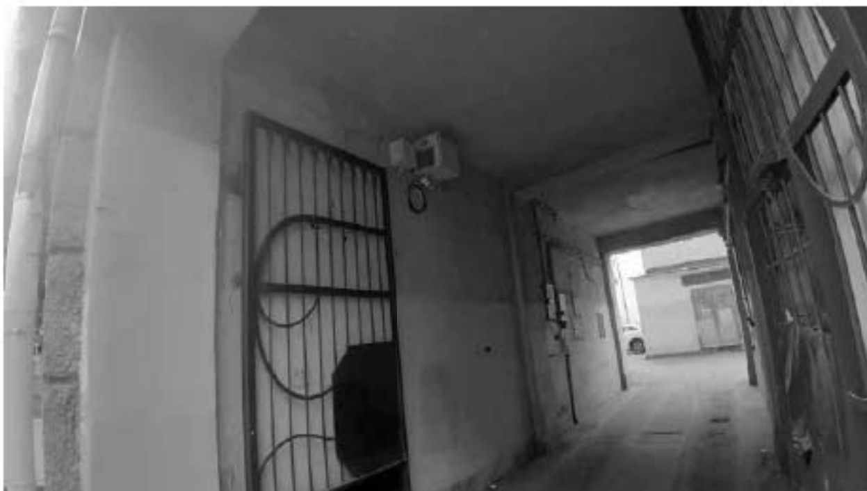
55. Ансамбль жилых домов площади Стачек (3 здания) (Перекопская ул., д. 1, лит. А). Арочный проезд. Фото мест установки оборудования и кабельных трасс. Штиглиц М.С. 07.05.2024.
