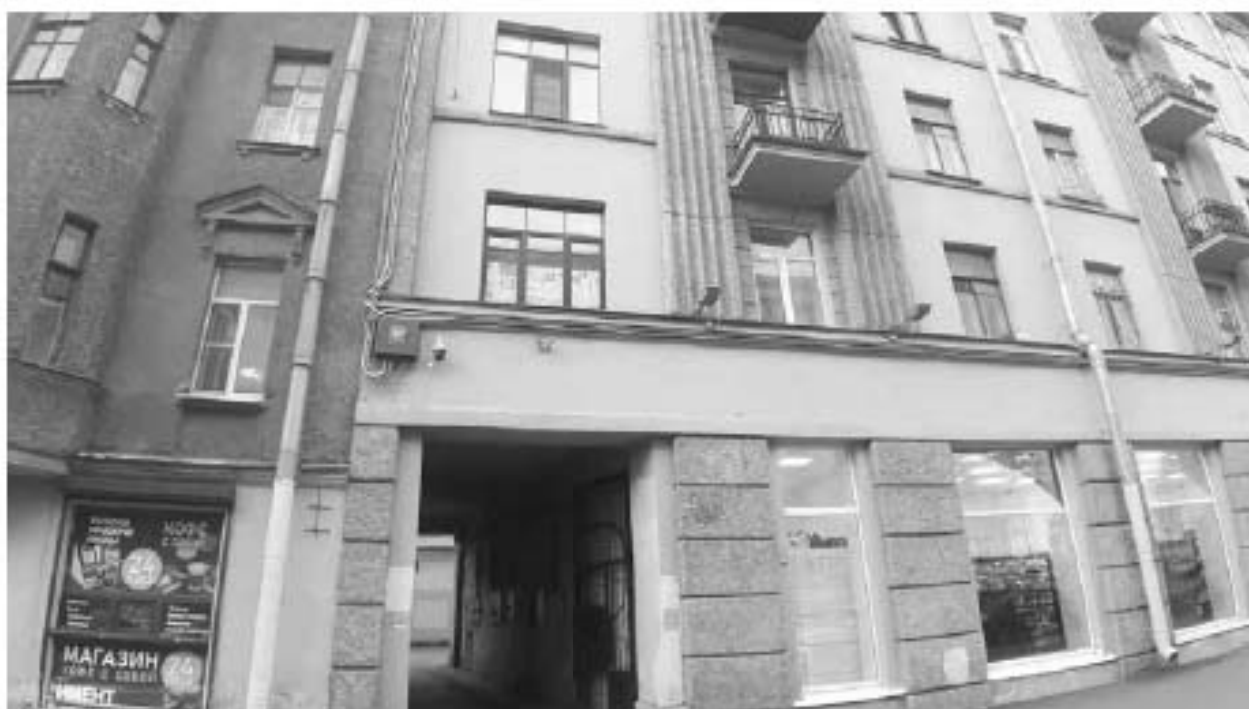
53. Ансамбль жилых домов площади Стачек (3 здания) (Перекопская ул., д. 1, лит. А). Лицевой фасад (фрагмент). Фото мест установки оборудования и кабельных трасс. Штиглиц М.С. 07.05.2024.
