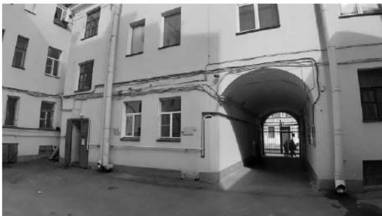
29. Особняк и доходный дом Н.Г. Кудрявцева. (4-я Красноармейская улица, д. 12/11, лит. А). Дворовые фасады. Фото мест установки оборудования и кабельных трасс. Штиглиц М.С. 07.05.2024.
