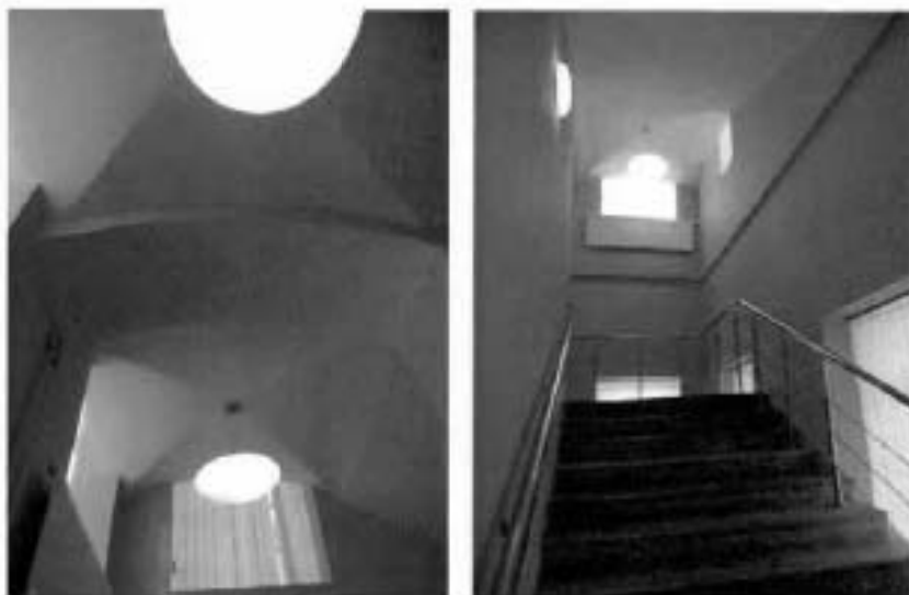
Фото №7, 8. Сводчатые перекрытия лестниц и лестничной марши.
