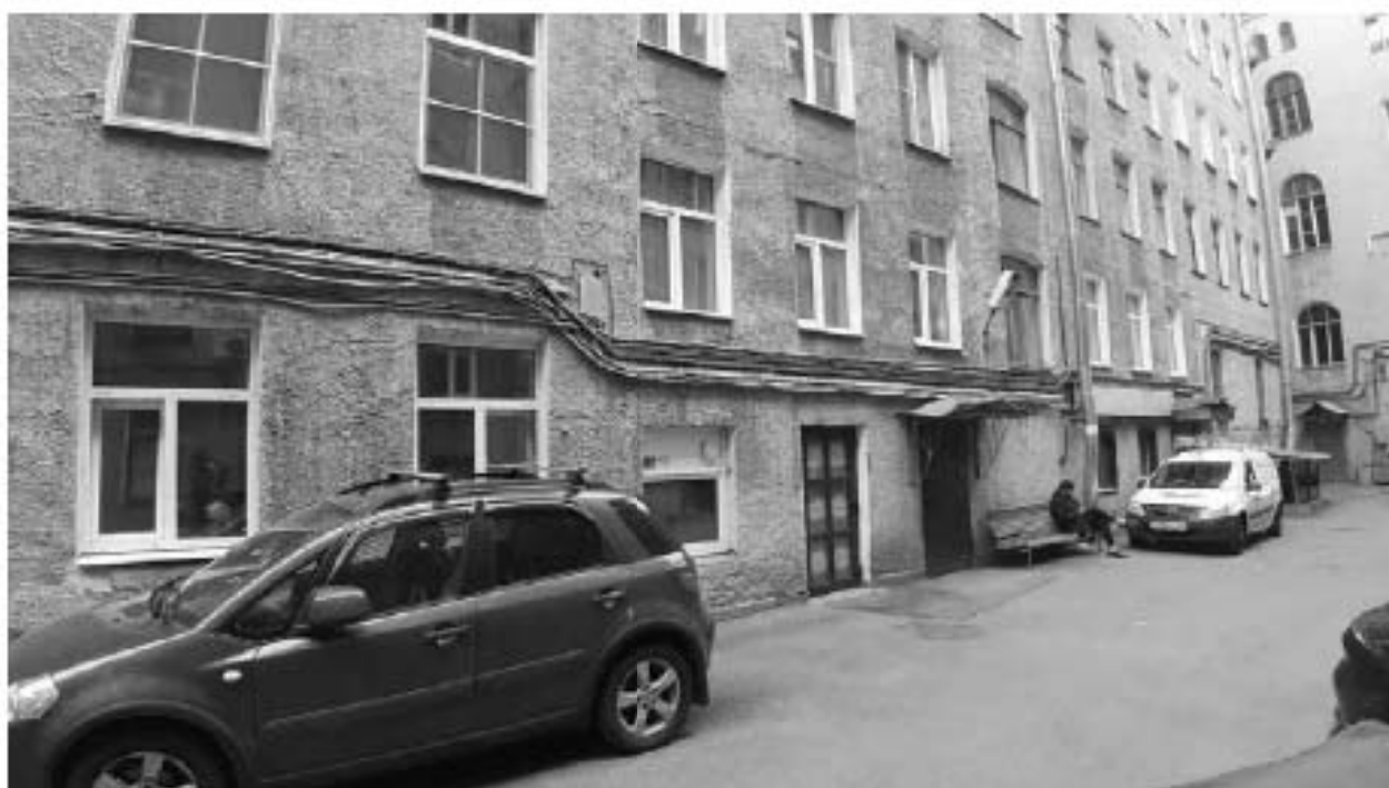
11. Дом Паулуччи А.Ф. Здесь в декабре 1905 - январе 1906 гг. проходили заседания ЦК и ПК РСДРП (Большая Морская ул., д. 36, лит. А). Дворовые фасады. Фото мест установки оборудования и кабельных трасс. Штиглиц М.С. 07.05.2024.
