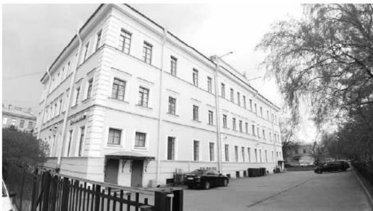
44. Солдатская казарма (в составе «Комплекса казарм Семеновского и Егерского полков»). (Звенигородская ул., д. 3, лит. А). Лицевой фасад. Штиглиц М.С. 07.05.2024.
