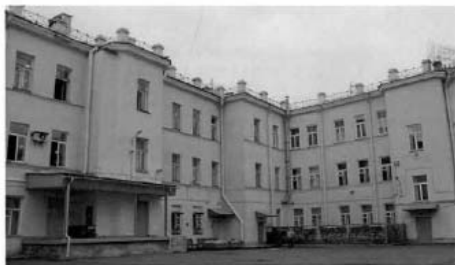
Фото №3. Дворовые фасады.
