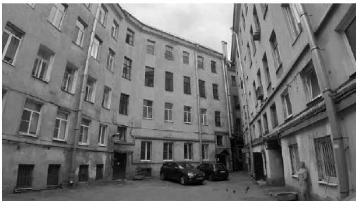
18. Дом Ф. Моровица (Никольская пл., д. 6, лит. А). Дворовые фасады. Фото мест установки оборудования и кабельных трасс. Штиглиц М.С. 07.05.2024.
