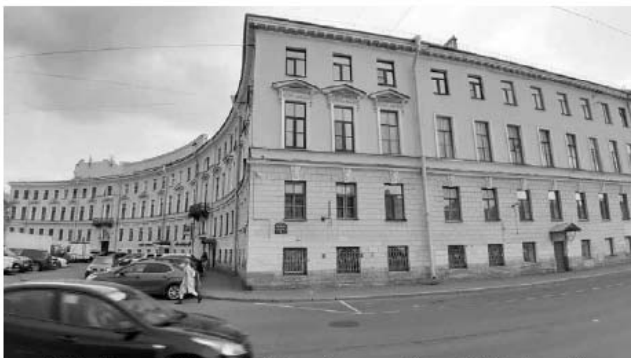
38. Дом Устинова К. (Петровых). (наб. реки Фонтанки, д. 92, лит. А). Общий вид. Штиглиц М.С. 07.05.2024.
