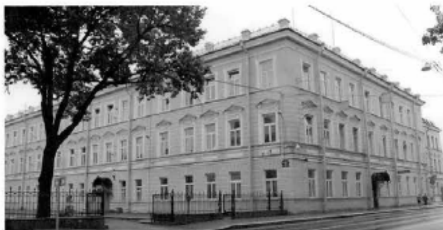
Фото №1. Лицевые фасады. Вид со стороны ул. Рузовской.
