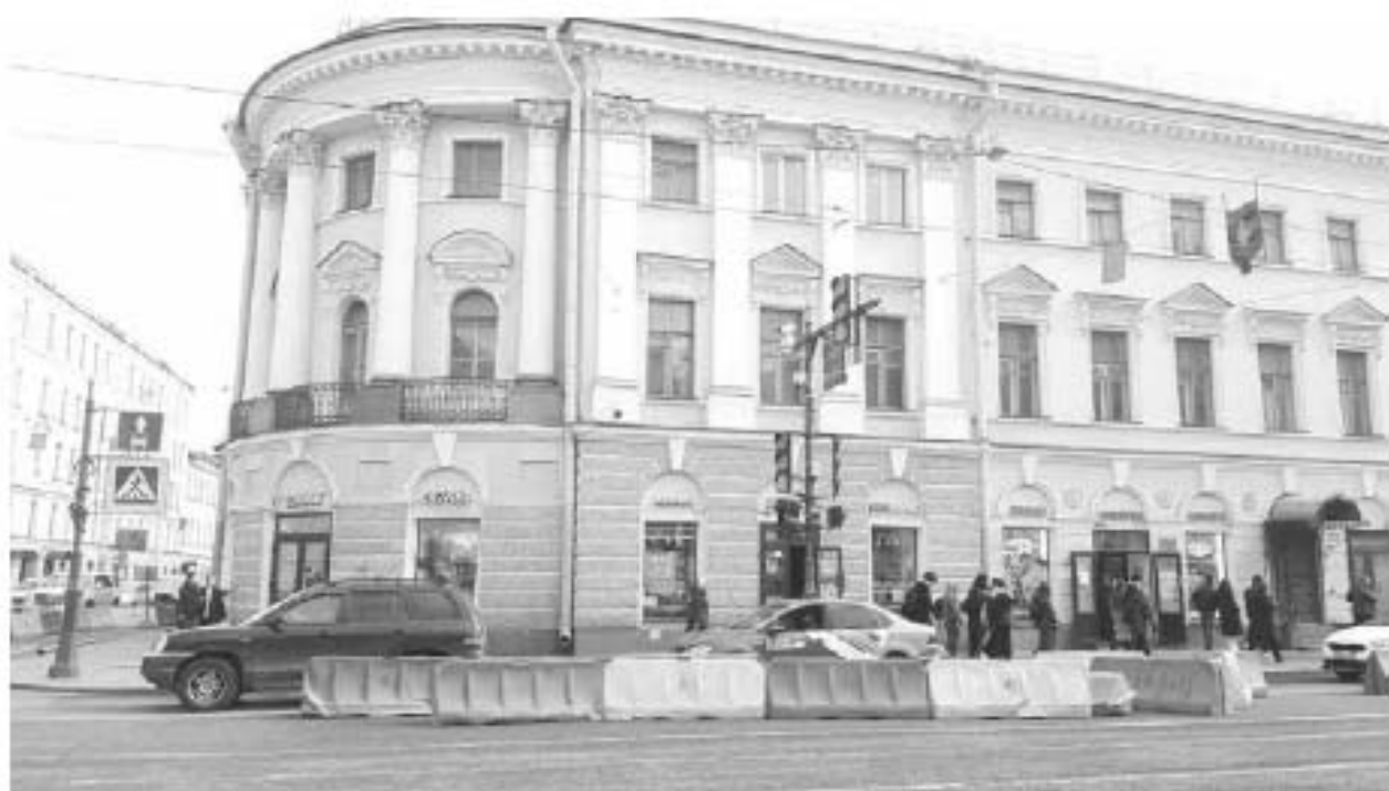
65. Дом Яковлева С.Я. (Гороховая ул., д. 45, лит. А). Лицевой фасад по Садовой ул. Фото мест установки оборудования и кабельных трасс. Штиглиц М.С. 07.05.2024.
