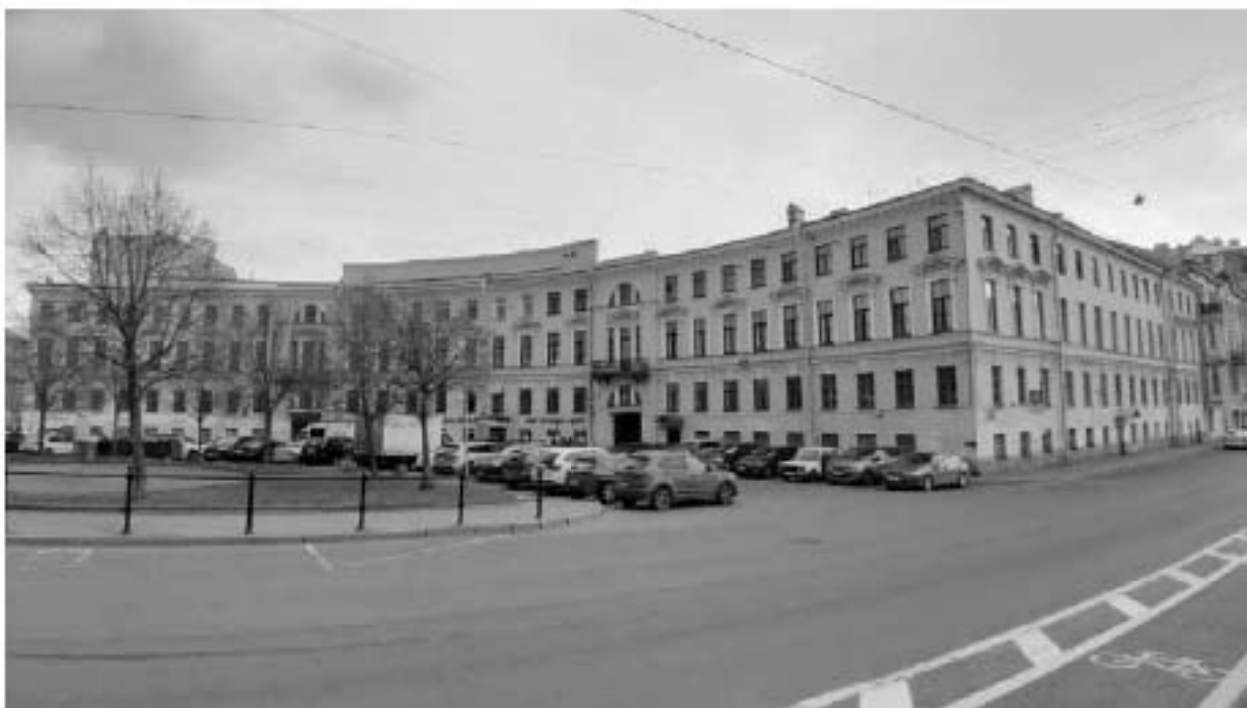
39. Дом Устинова К. (Петровых). (наб. реки Фонтанки, д. 92, лит. А). Общий вид. Штиглиц М.С. 07.05.2024.
