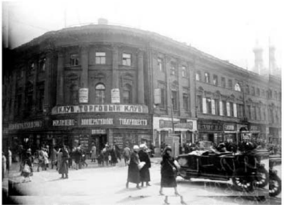
30. «Дом Яковлева С.Я.» (Гороховая ул., д. 45, лит. А). Фото 1925 г. (30).
