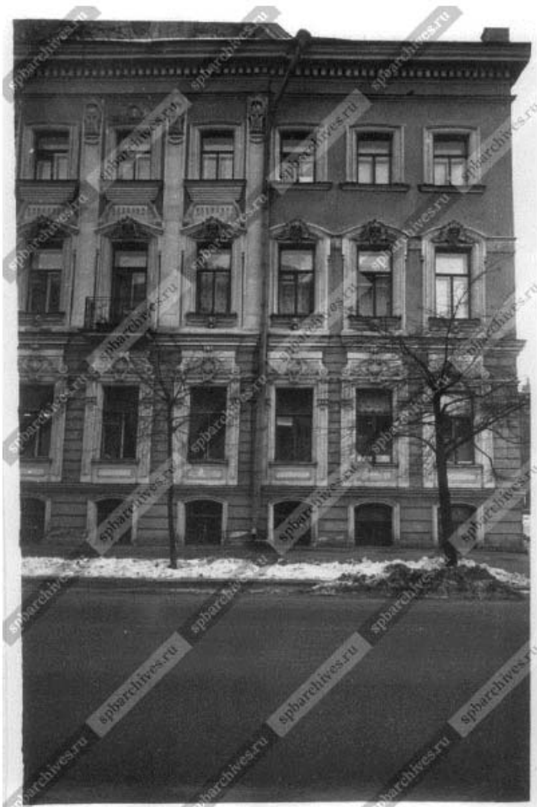
25. «Дом А.П. Козлова» (Большая Морская ул., д. 56, лит. А). 1970-е гг. Фасад дома №56 на ул.Герцена. ЦГАКФФД СПб Гр 189827
