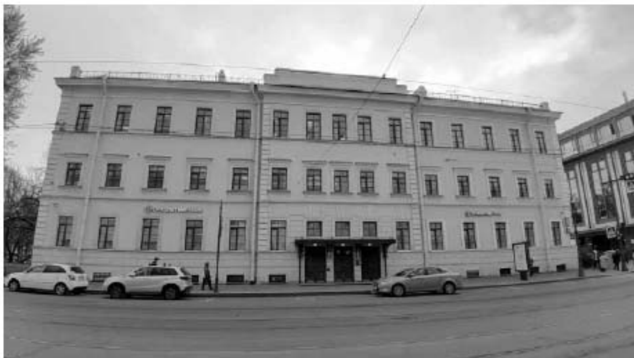
41. Солдатская казарма (в составе «Комплекса казарм Семеновского и Егерского полков»). (Звенигородская ул., д. 3, лит. А). Лицевой фасад по Звенигородской ул. Штиглиц М.С. 07.05.2024.
