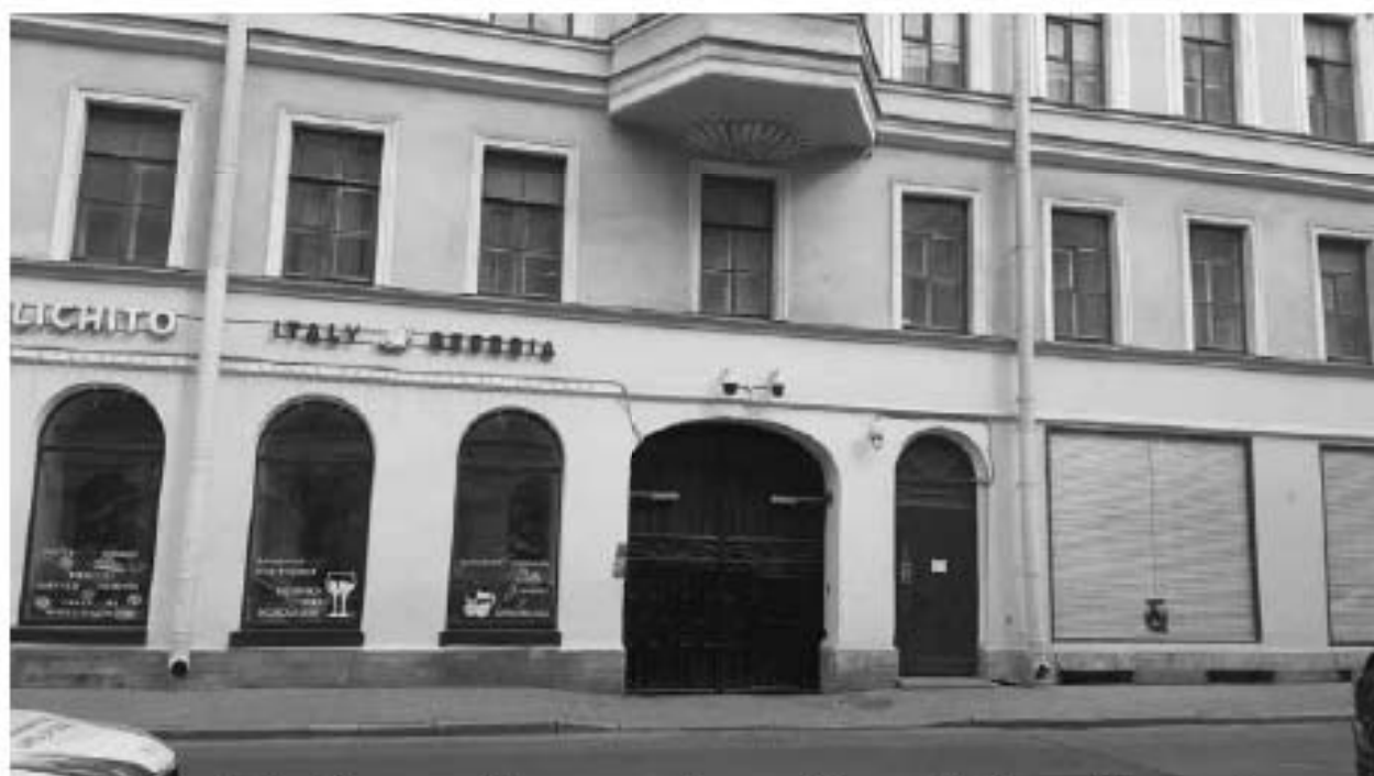
60. Дом Разевиха (Вознесенский пр., д. 28, лит. А). Лицевой фасад. Фото мест установки оборудования и кабельных трасс. Штиглиц М.С. 07.05.2024.
