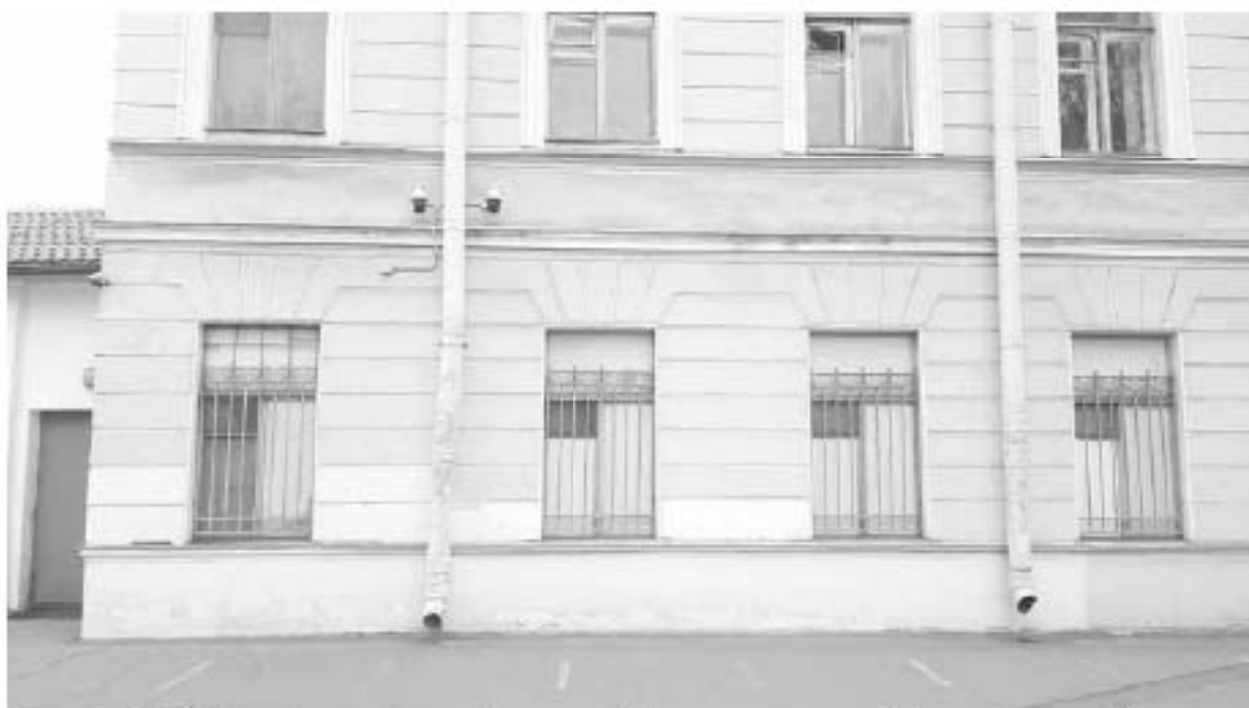
48. Офицерская казарма (в составе «Комплекса казарм Семеновского и Егерского полков»). (Загородный пр., д. 54, лит. А). Лицевой фасад (фрагмент). Фото мест установки оборудования и кабельных трасс. Штиглиц М.С. 07.05.2024.
