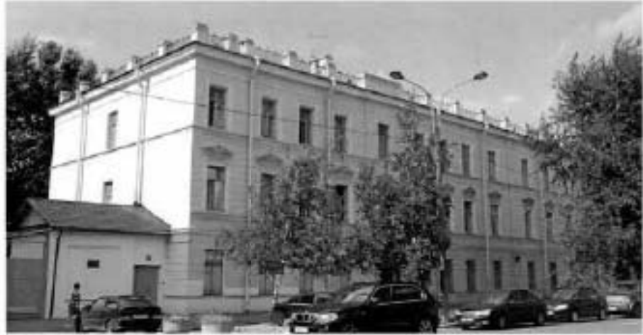
Фото №16. Лицевой фасад. Вид со стороны Введенского канала.
