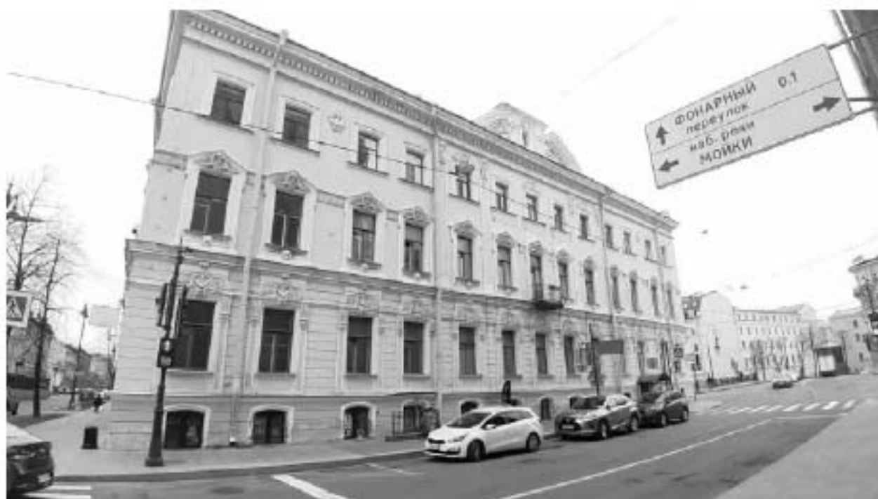
3. Дом А.П. Козлова (Большая Морская ул., д. 56, лит. А). Лицевой фасад по Почтамтскому пер. Штиглиц М.С. 07.05.2024.
