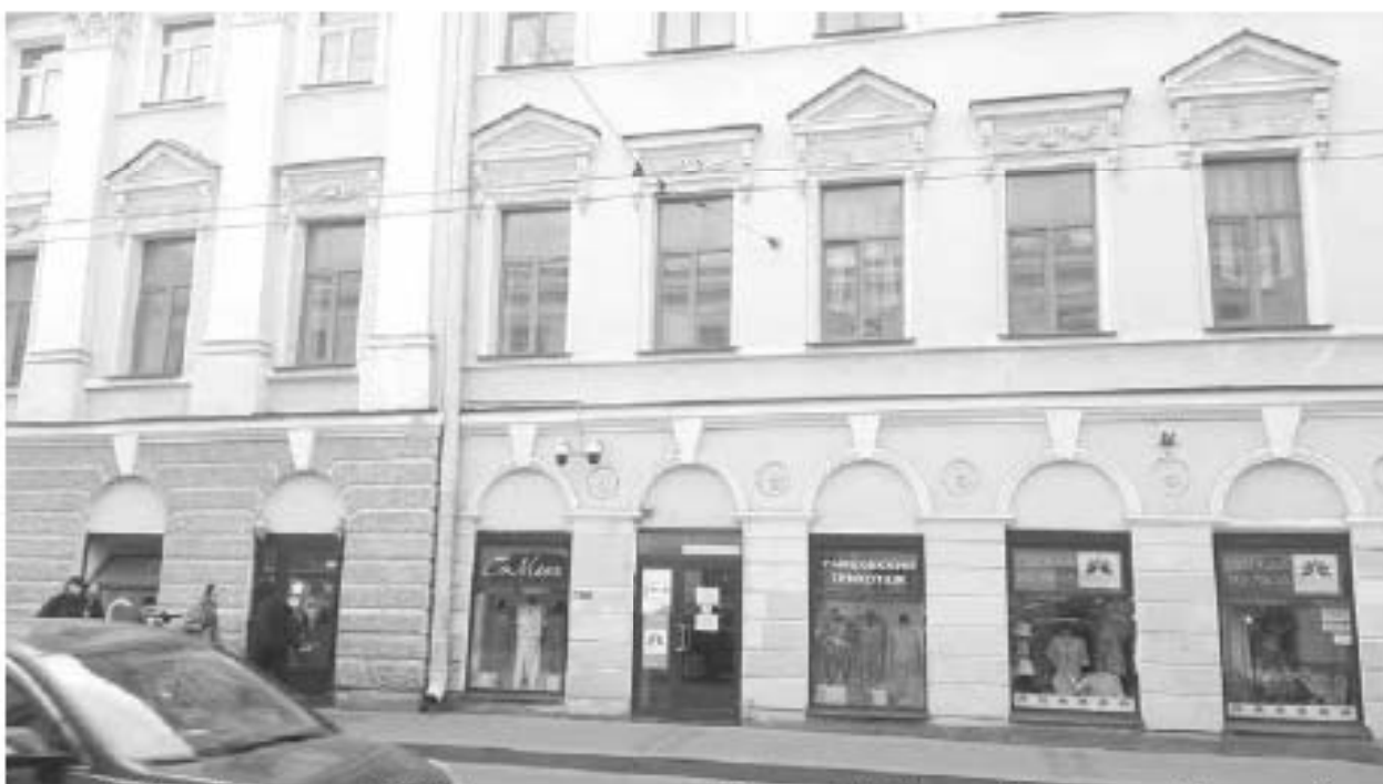
68. Дом Яковлева С.Я. (Гороховая ул., д. 45, лит. А). Лицевой фасад по Гороховой ул. Фото мест установки оборудования и кабельных трасс. Штиглиц М.С. 07.05.2024.
