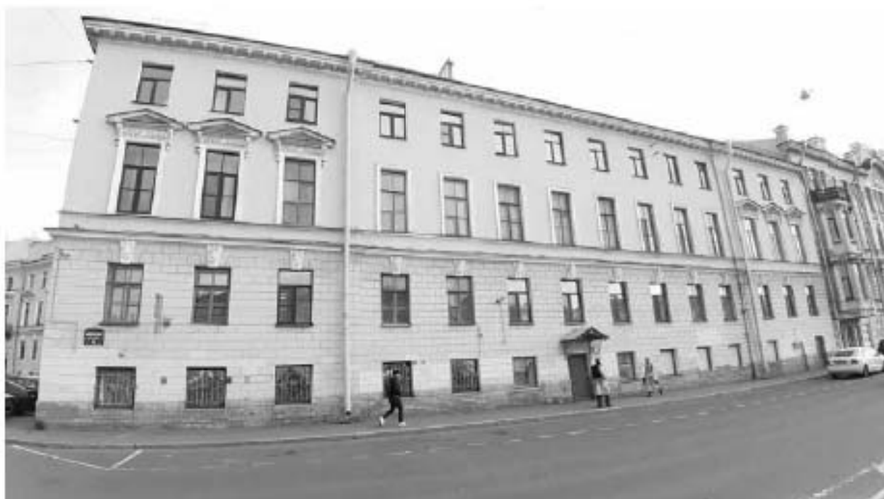
37. Дом Устинова К. (Петровых). (наб. реки Фонтанки, д. 92, лит. А). Лицевой фасад по наб. реки Фонтанки. Штиглиц М.С. 07.05.2024.
