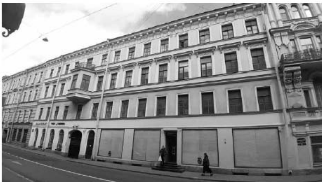
59. Дом Разевиха (Вознесенский пр., д. 28, лит. А). Лицевой фасад. Штиглиц М.С. 07.05.2024.
