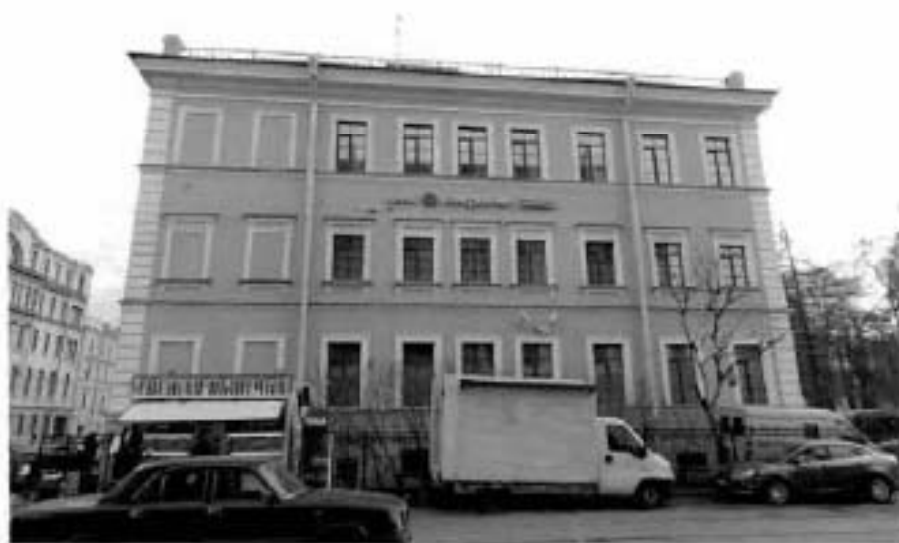
Фото №4. Торжевой (северо-западный) фасад.
