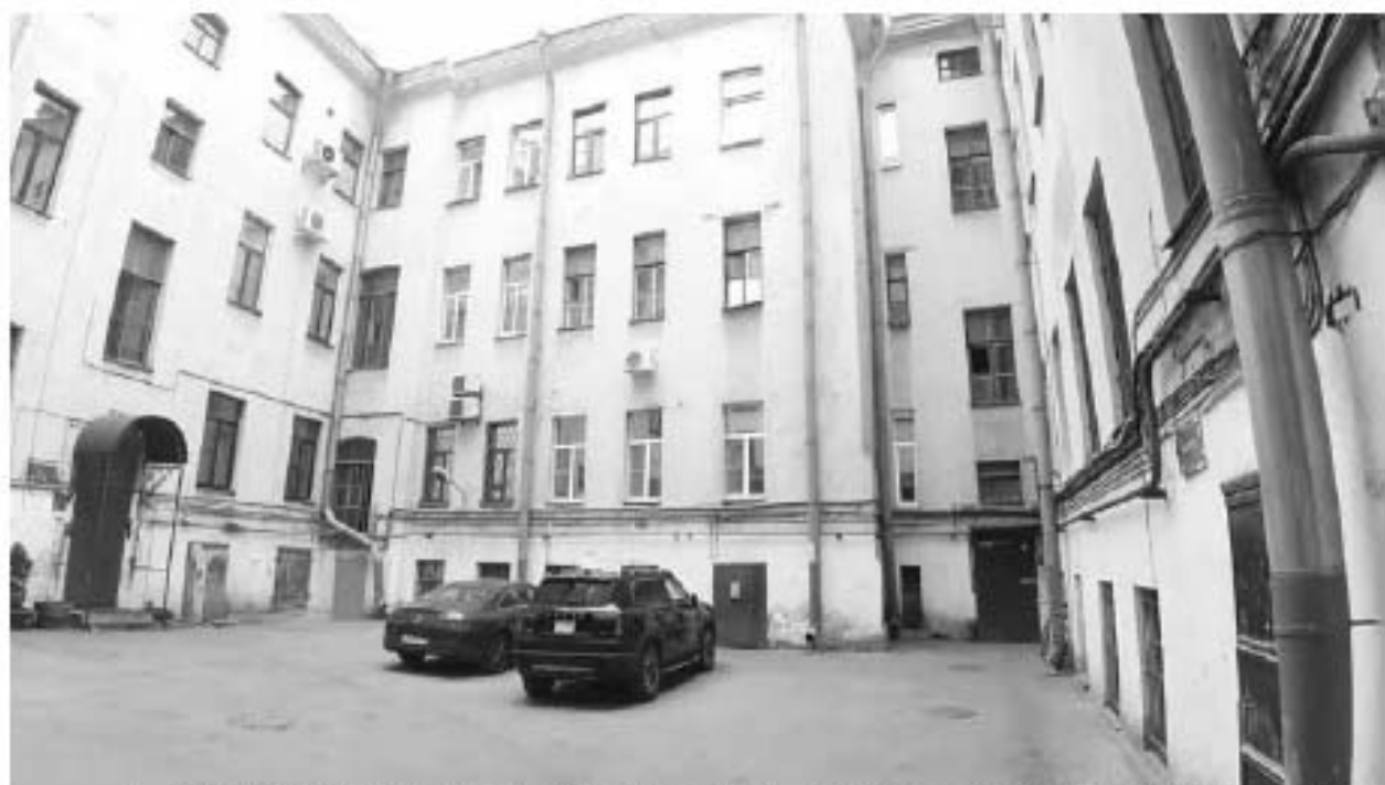
6. Дом А.П. Козлова (Большая Морская ул., д. 56, лит. А). Дворовые фасады. Фото мест установки оборудования и кабельных трасс. Штиглиц М.С. 07.05.2024.
