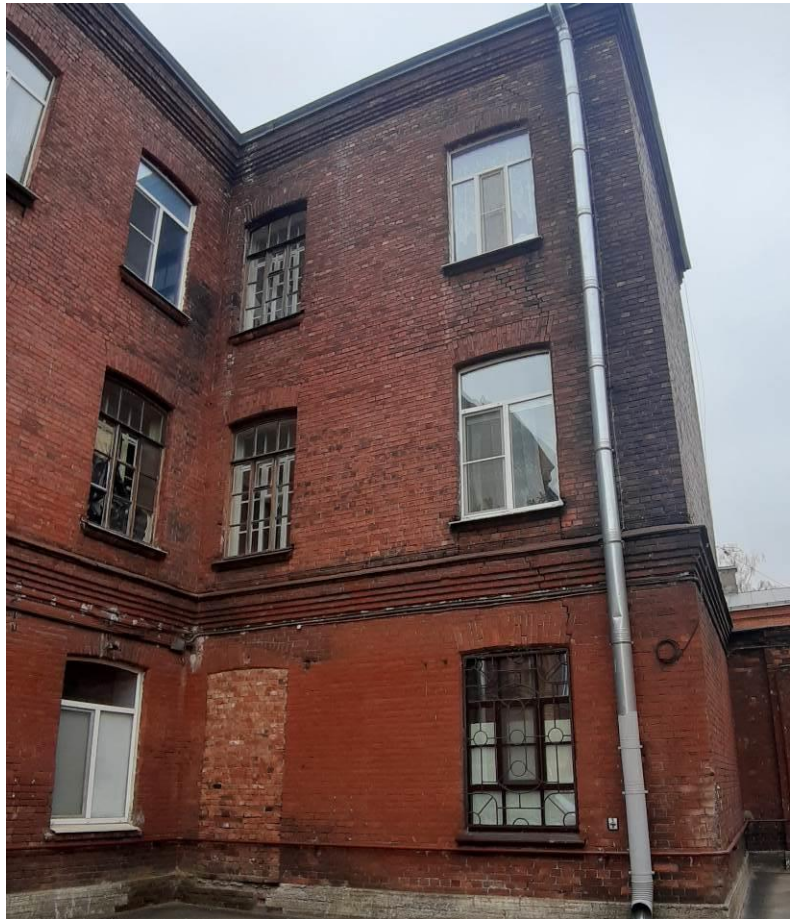
5. Казармы со службой (Академика Лебедева ул., д. 20, лит. А). Дворовые фасады. Фото мест установки оборудования и кабельных трасс. Штиглиц М.С. 18.04.2024.
