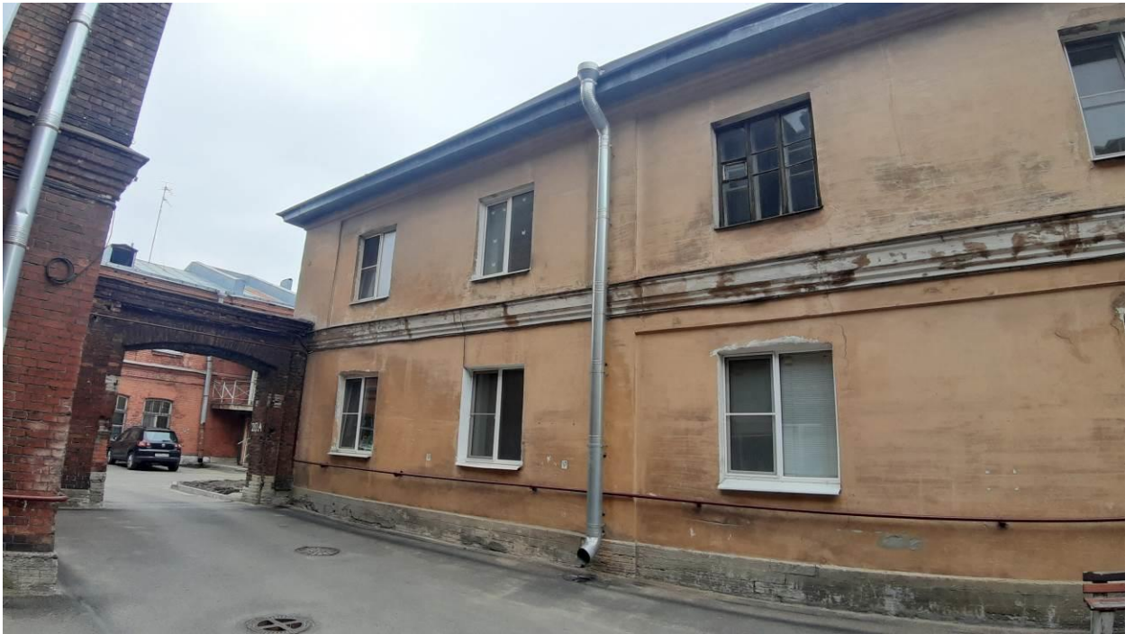
7. Казармы со службой. Фото мест установки оборудования и кабельных трасс. (Академика Лебедева ул., д. 20а, лит. Б). Штиглиц М.С. 18.04.2024.
