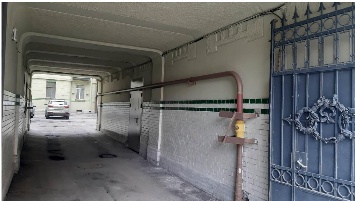
25. Доходный дом Российского общества страхования капиталов и доходов «Жизнь» (Академика Лебедева ул., д.12, лит. А). Фото мест установки оборудования и кабельных трасс. Штиглиц М.С. 18.04.2024.
