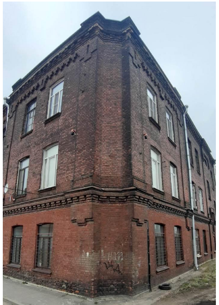
2. Казармы со службой (Академика Лебедева ул., д. 20, лит. А). Фото мест установки оборудования и кабельных трасс. Штиглиц М.С. 18.04.2024.
