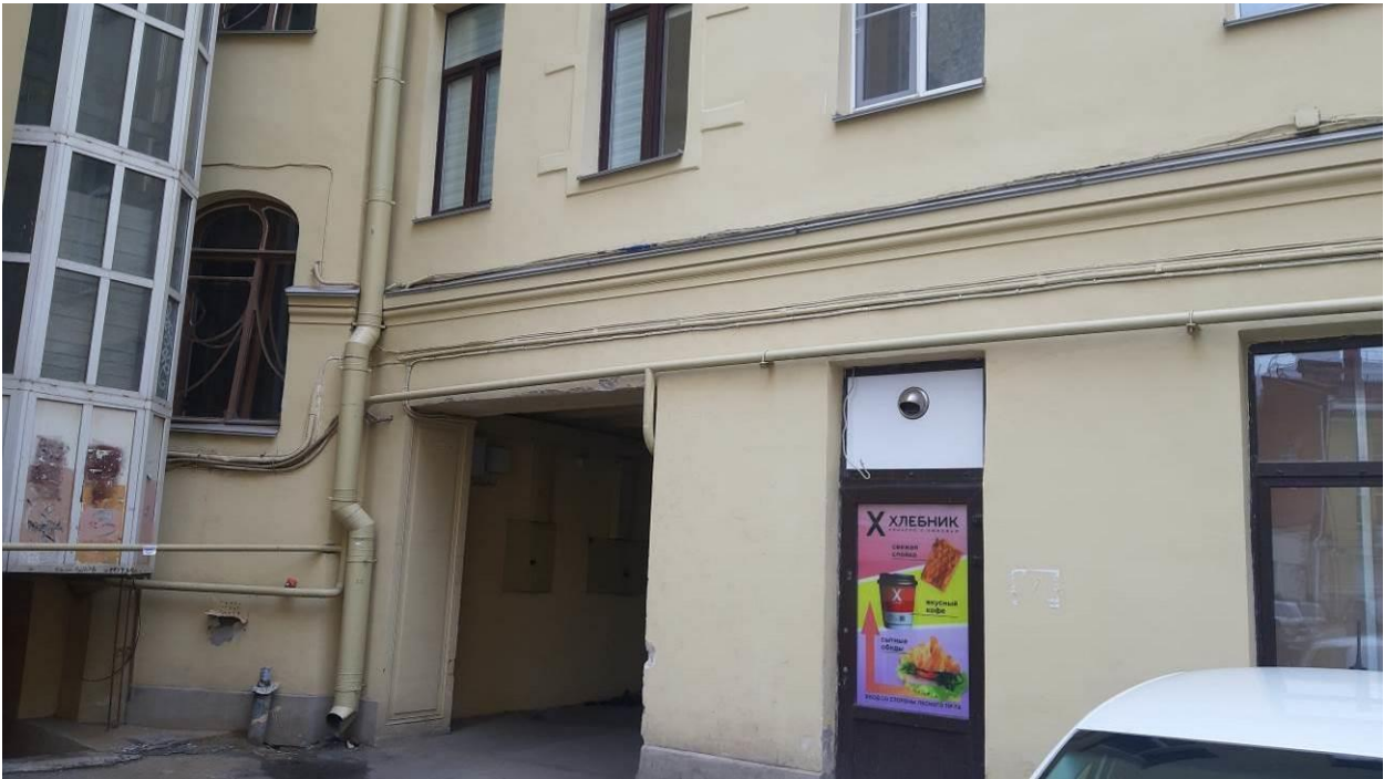
31. Дом В.Н. Зеленина. Вид со двора. Фото мест установки оборудования и кабельных трасс. (Лесной пр., д. 3, лит. А). Штиглиц М.С. 18.04.2024.
