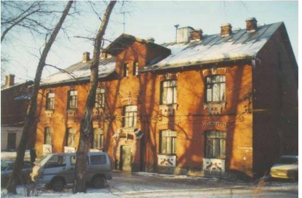
26. Комплекс построек железнодорожной станции «Кушелевка» (4 здания)». Фото 1999 г. (19).
