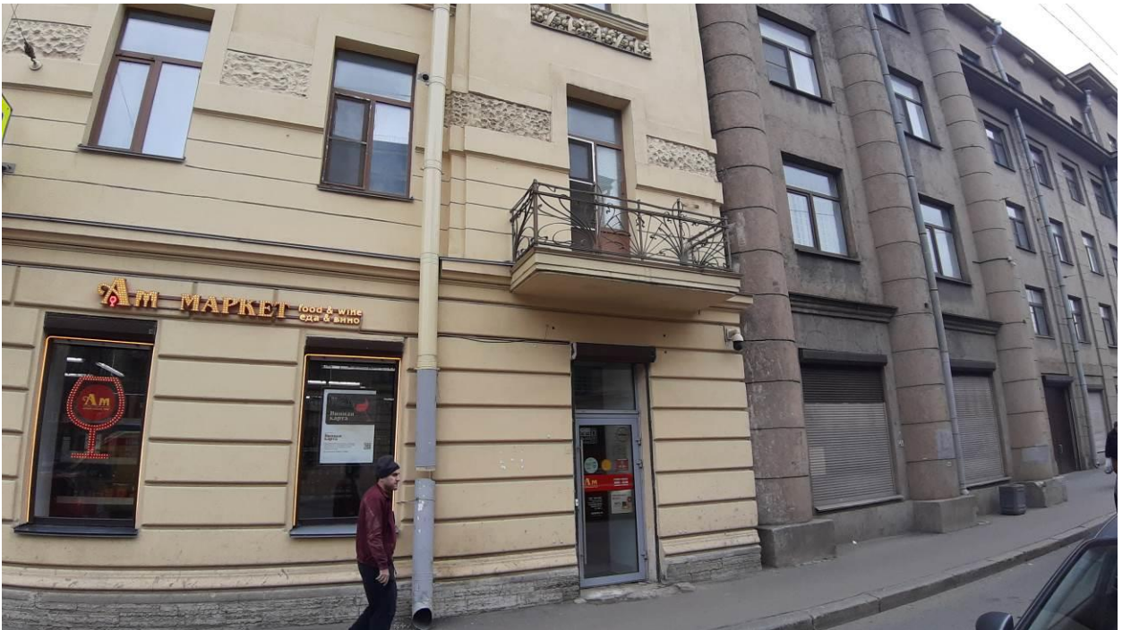
34. Дом В.Н. Зеленина (Лесной пр., д. 3, лит. А). Фрагмент лицевого фасада. Фото мест установки оборудования и кабельных трасс. Штиглиц М.С. 18.04.2024.
