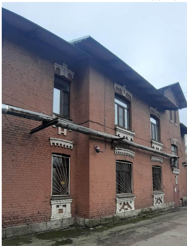
38. Комплекс построек железнодорожной станции «Кушелевка» (4 здания)) (Политехническая ул., д. 1, корп. 3, лит. Б). Северный фасад. Фрагмент лицевого фасада. Фото мест установки оборудования и кабельных трасс. Штиглиц М.С. 18.04.2024.
