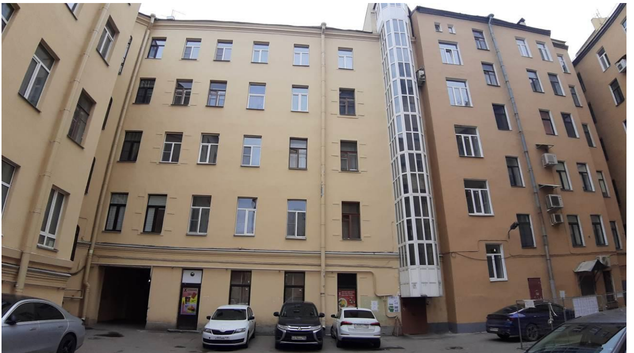
28. Дом В.Н. Зеленина (Лесной пр., д. 3, лит. А). Фото мест установки оборудования и кабельных трасс. Штиглиц М.С. 18.04.2024.
