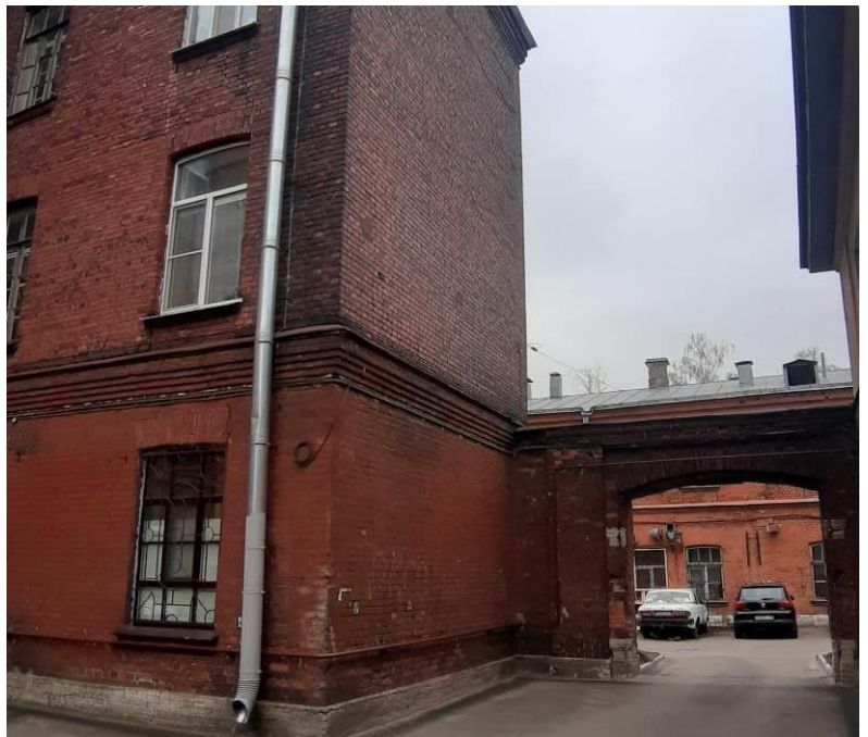
6. Казармы со службой (Академика Лебедева ул., д. 20, лит. А). Дворовые фасады. Фото мест установки оборудования и кабельных трасс. Штиглиц М.С. 18.04.2024.
