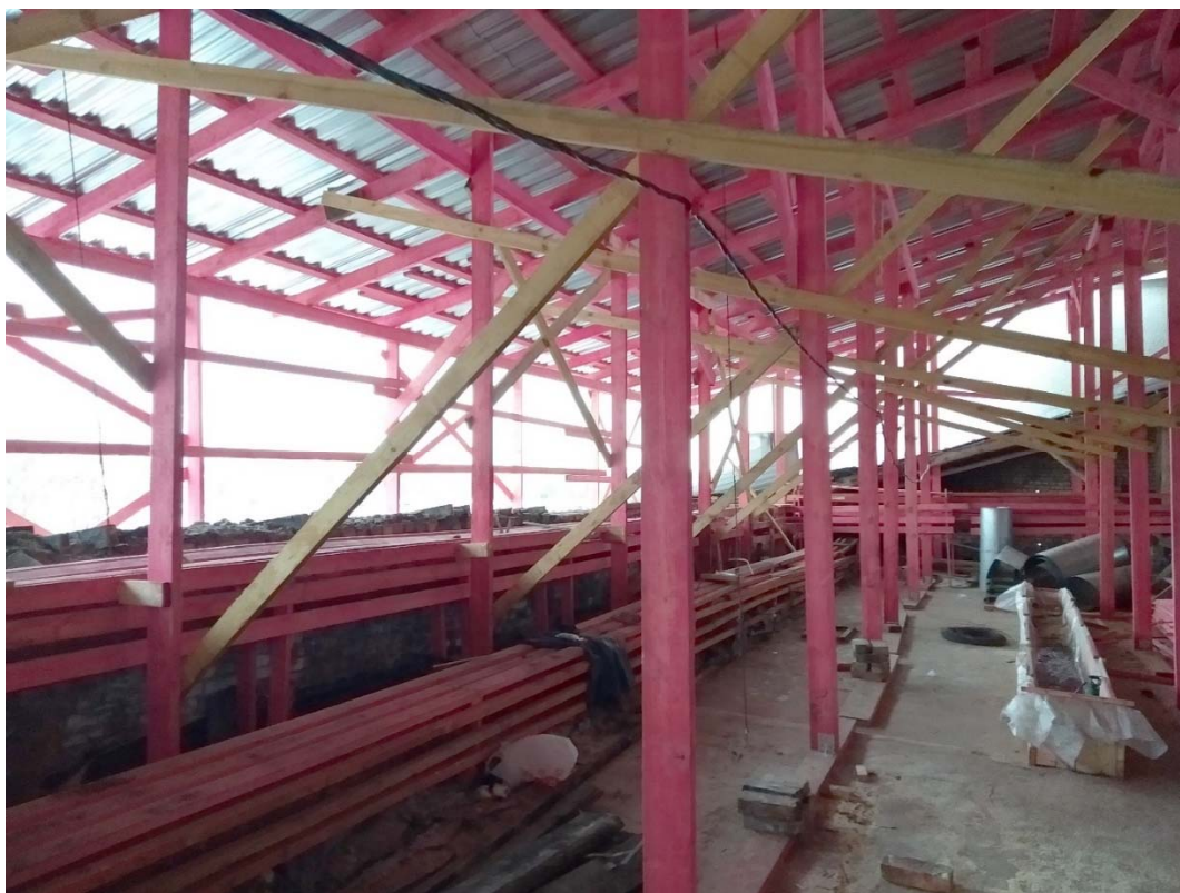
Фото 63. Чердачное пространство в осях В-Е/3 (6.36, 6.40, 6.44).
