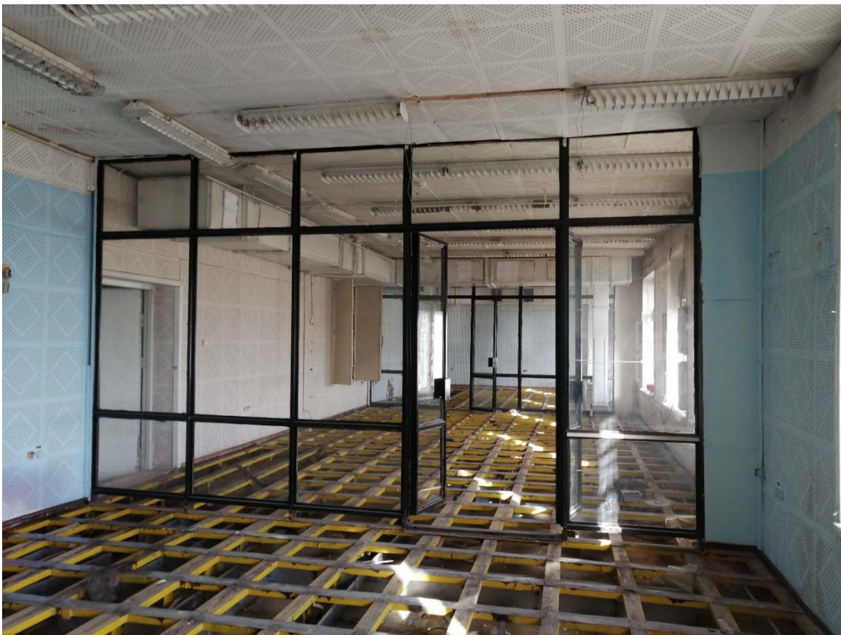
Фото 23. Помещения 5.126, 5.125. Общий вид.
