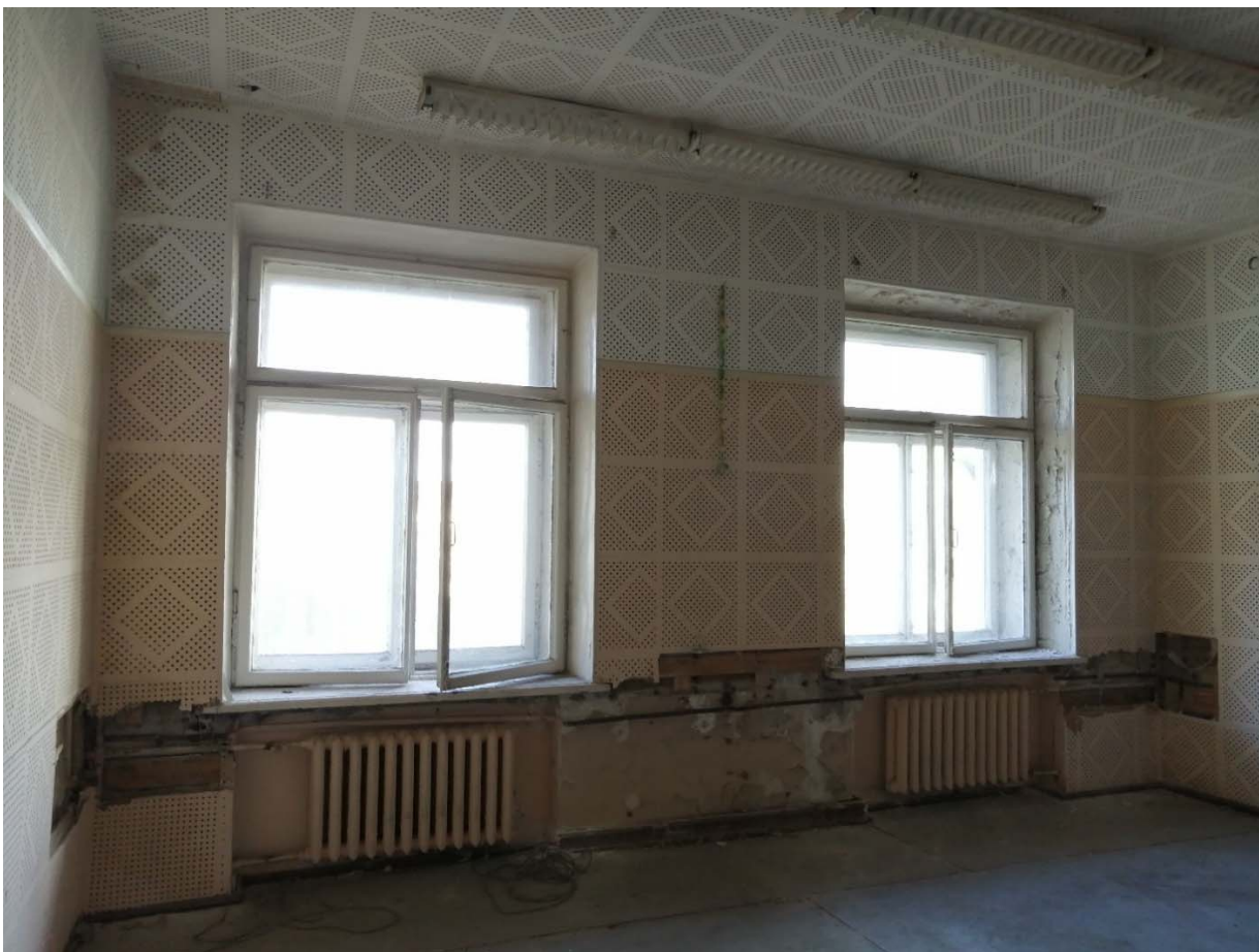
Фото 28. Помещение 5.161. Общий вид.
