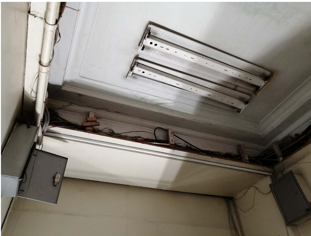
Фото 4. Помещение 5.05: потолок с тягами по периметру.
