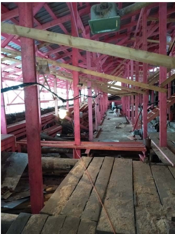
Фото 61. Чердачное пространство в осях В-Е/3 (6.36, 6.40, 6.44).
