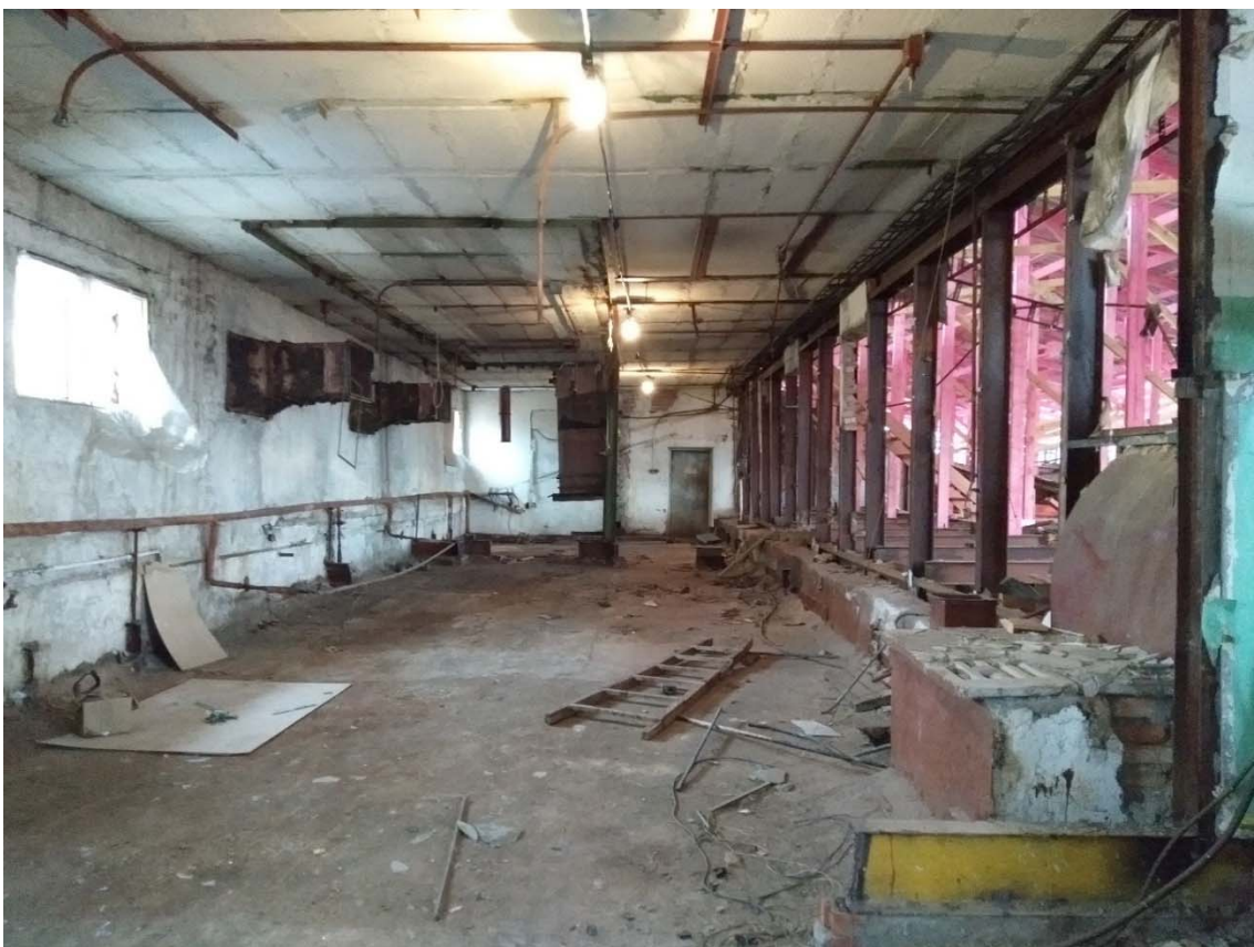
Фото 65. Чердачное пространство в осях В-Е/3 (6.36, 6.40, 6.44).
