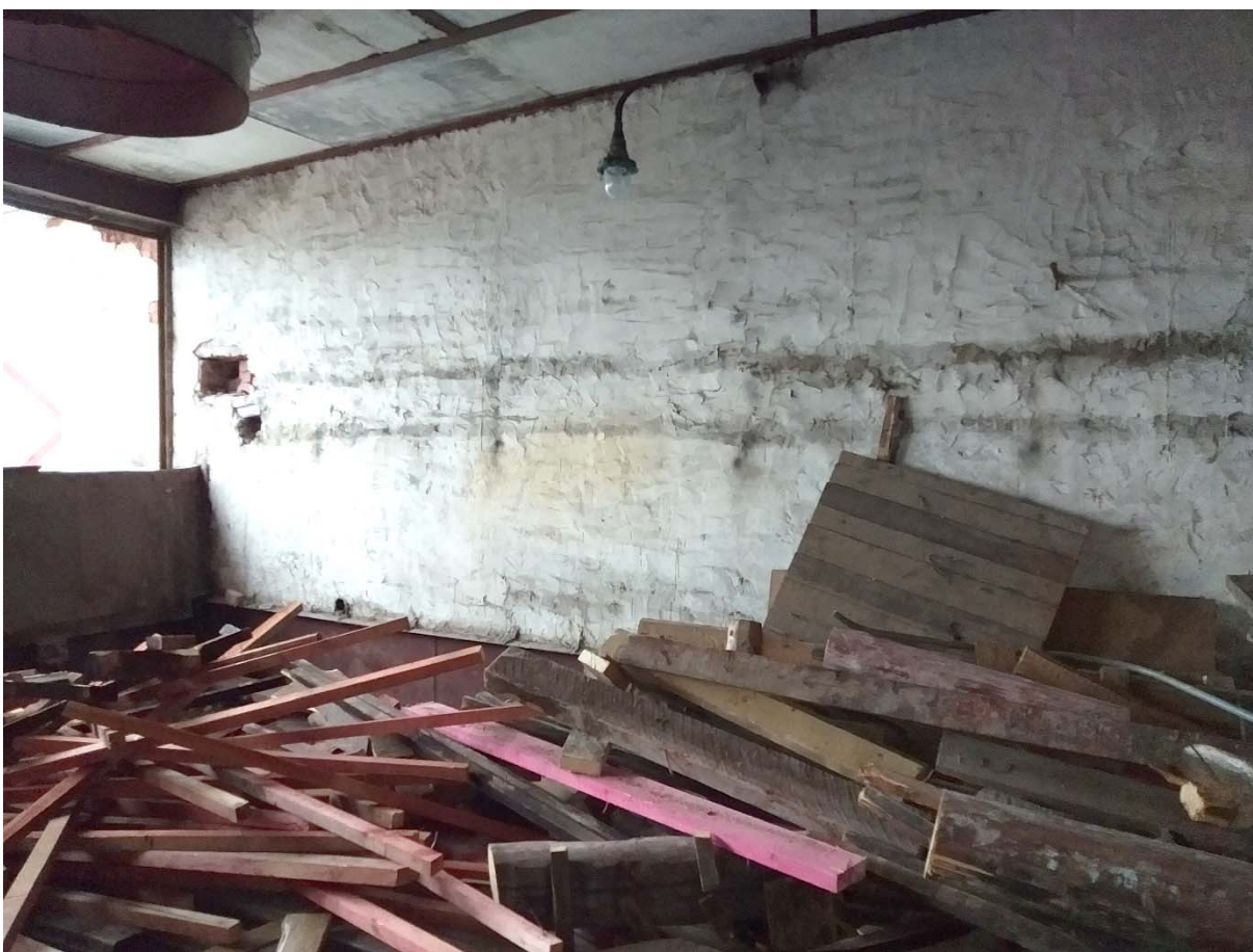
Фото 59. Чердачное помещение в осях В-Е/3 (6.25, 6.42).
