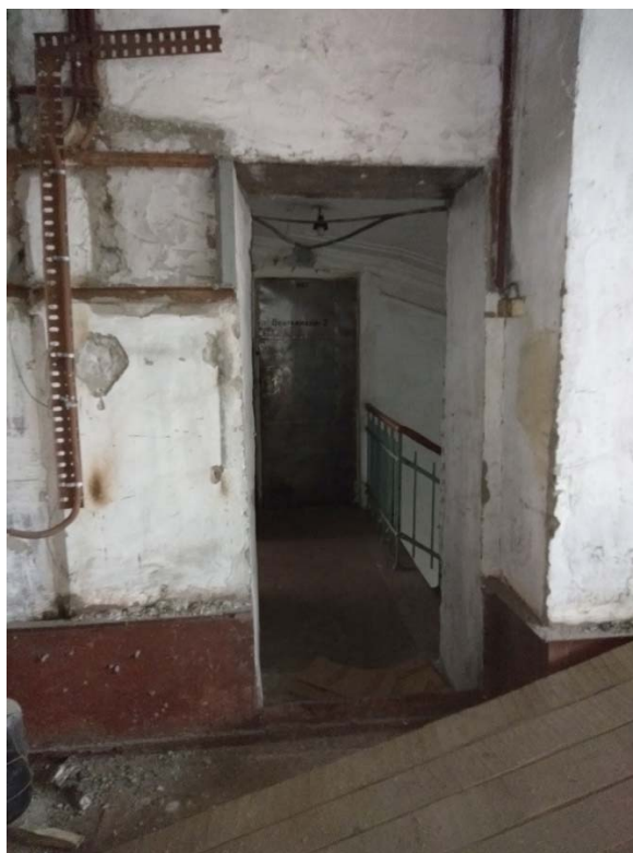
Фото 58. Помещение в уровне чердака, в осях В-Е/3 (6.25, 6.42).
