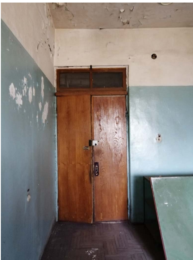
Фото 14. Помещение 5.132. Дверь в помещение из коридора (вид со стороны помещения)
