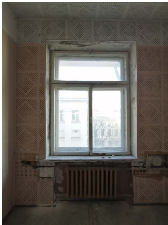
Фото 27. Помещение 5.162. Общий вид.
