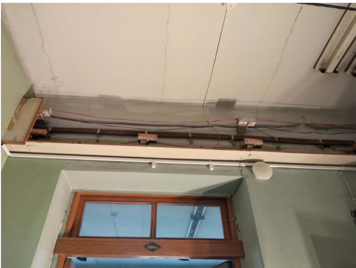
Фото 37. Помещение 5.176. Состояние помещения на момент начала работ.
