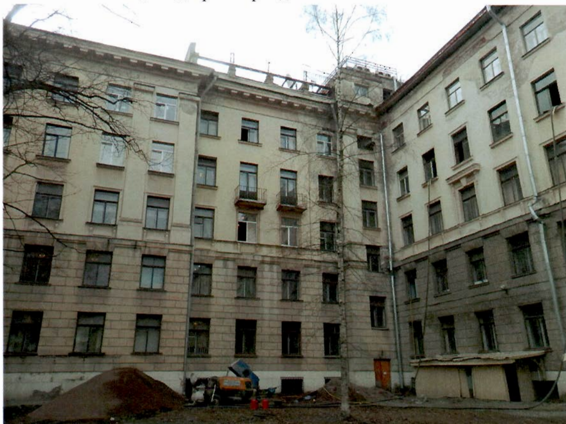
4. Юго-западный дворовый фасад
