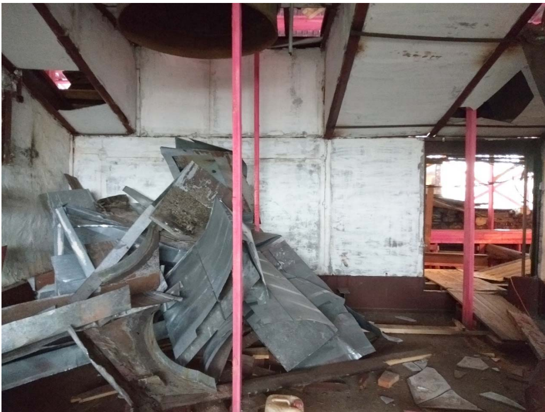
Фото 60. Чердачное помещение в осях В-Е/3 (6.25, 6.42).
