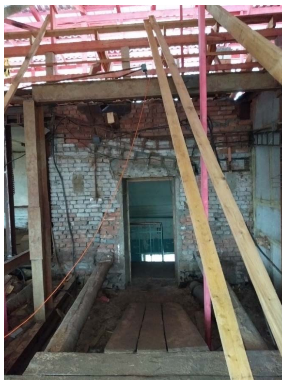
Фото 62. Чердачное пространство в осях В-Е/3 (6.36, 6.40, 6.44).
