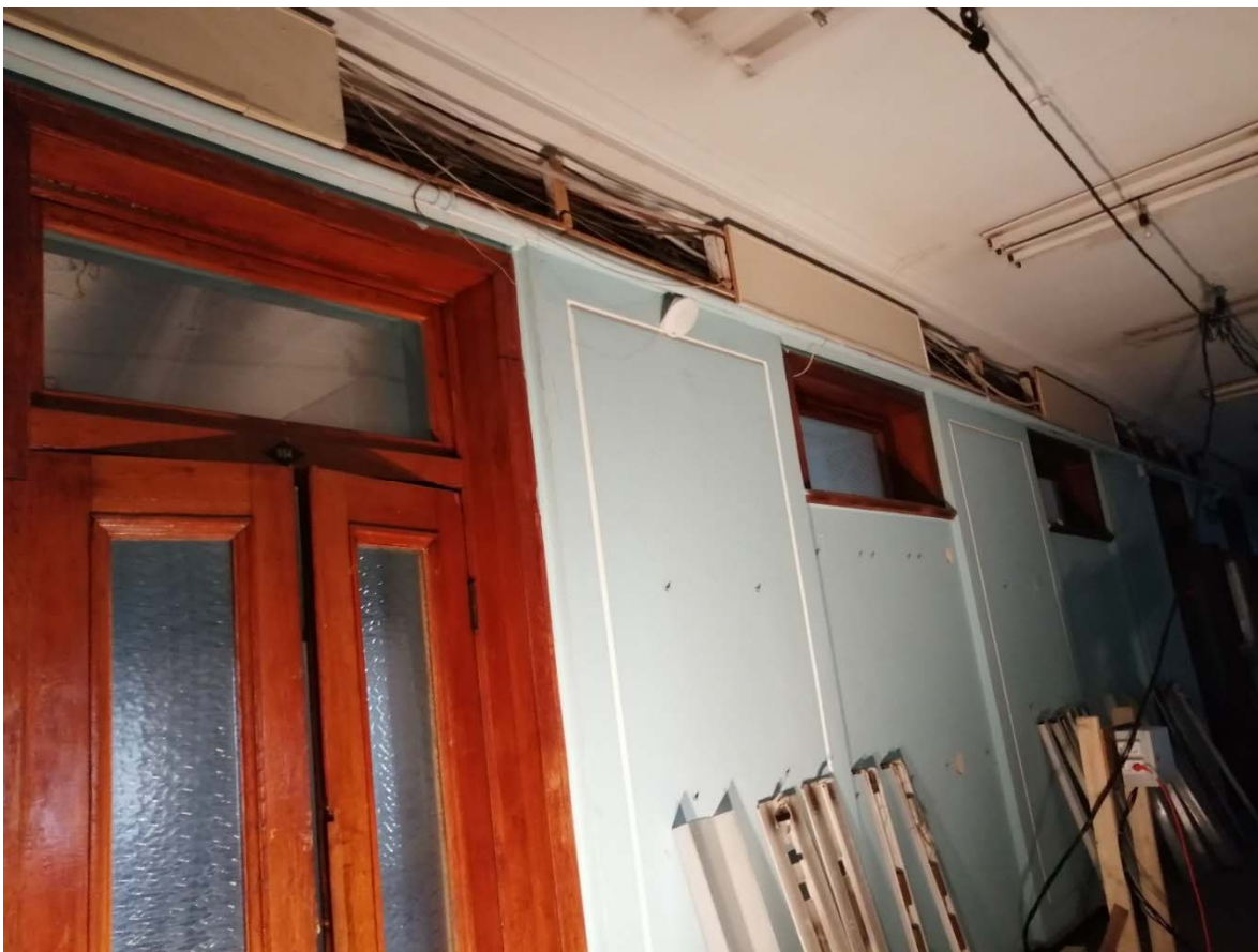
Фото 11. Помещение 5.175. Стена коридора 5 этажа (восточный корпус) с сохранившимися дверными и оконными проёмами, штукатурными зеркалами стен.
