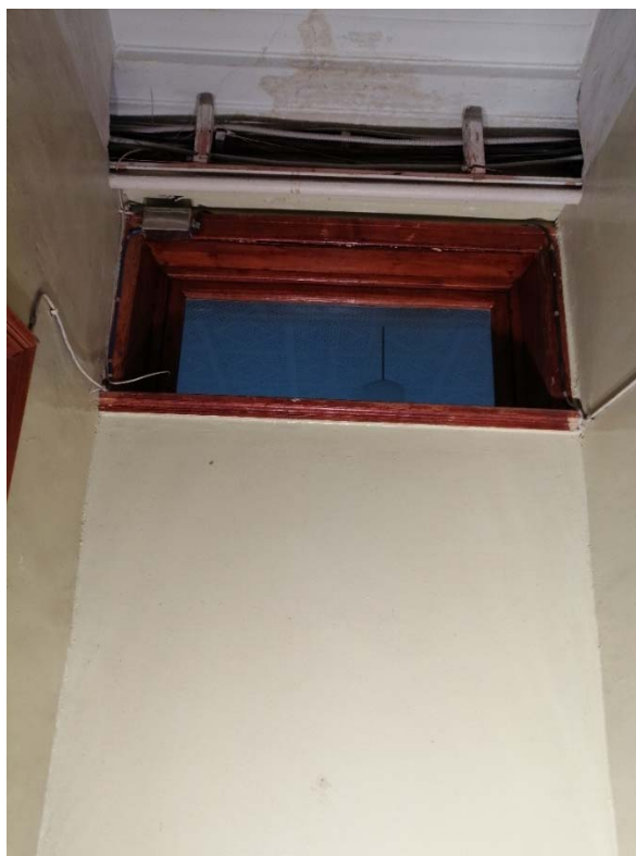
Фото 7. Помещение 5.175. Оконный проём в стене коридора.
