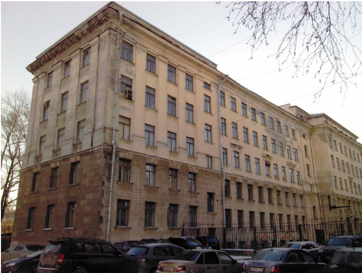
Фото 3. Торцевой северный и дворовой западный фасад корпуса.
