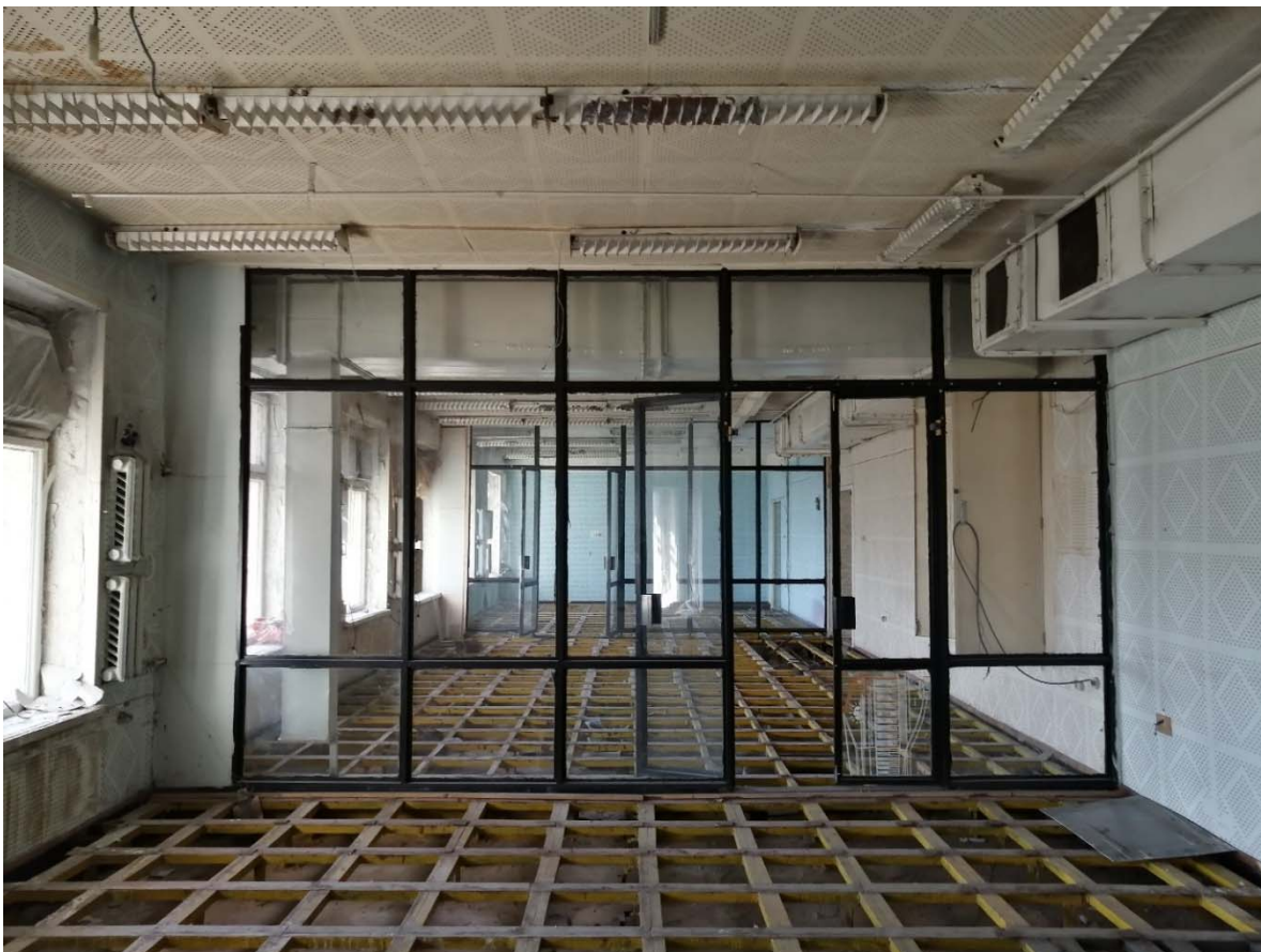
Фото 22. Помещение 5.129. Общий вид.
