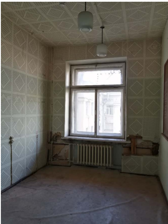
Фото 26. Помещение 5.165, 5.164. Общий вид.
