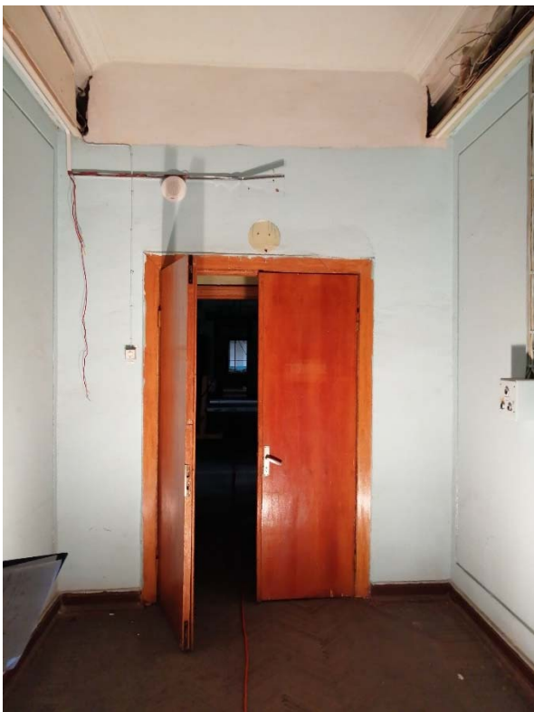
Фото 6. Помещение 5.175: перегородка с дверным проёмом в объёме коридора.
