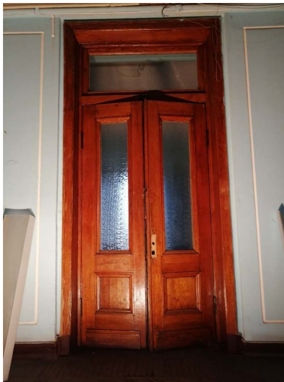
Фото 9. Помещение 5.175. Дверь из коридора 5.163.
