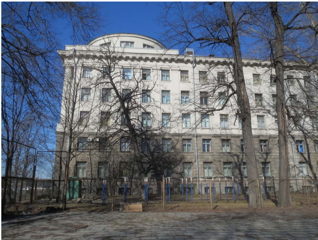
Фото 1. Восточный фасад здания.
