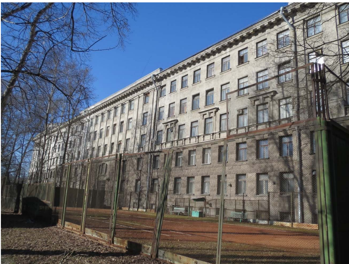
Фото 2. Восточный фасад здания.
