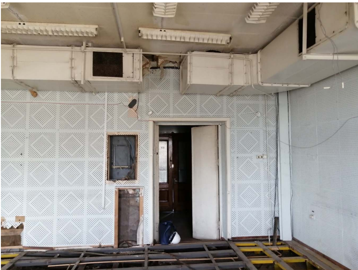
Фото 20. Помещение 5.129. Дверной проём – вход из коридора.
