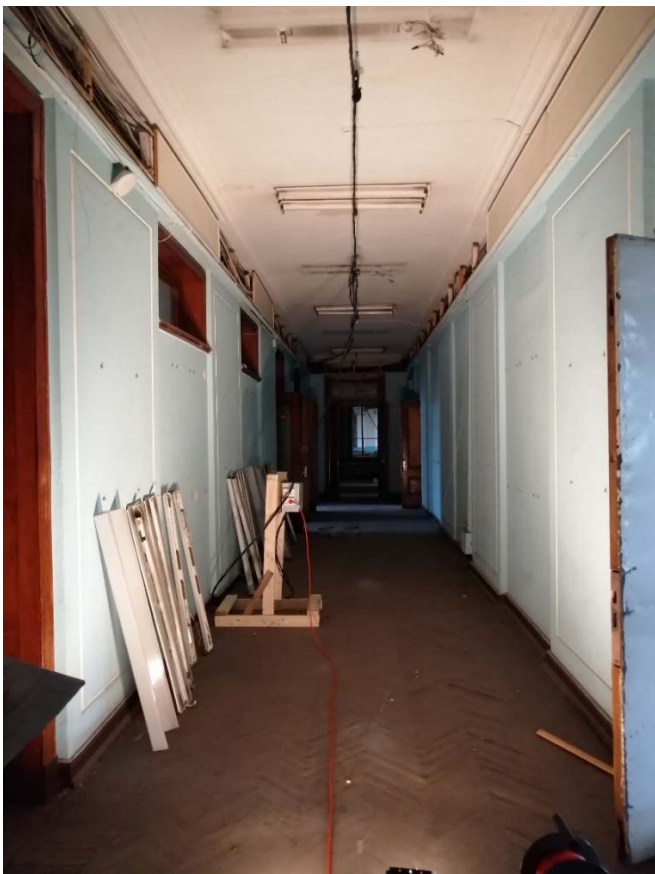
Фото 10. Помещение 5.175. Общий вид части коридора 5 этажа (восточный корпус).
