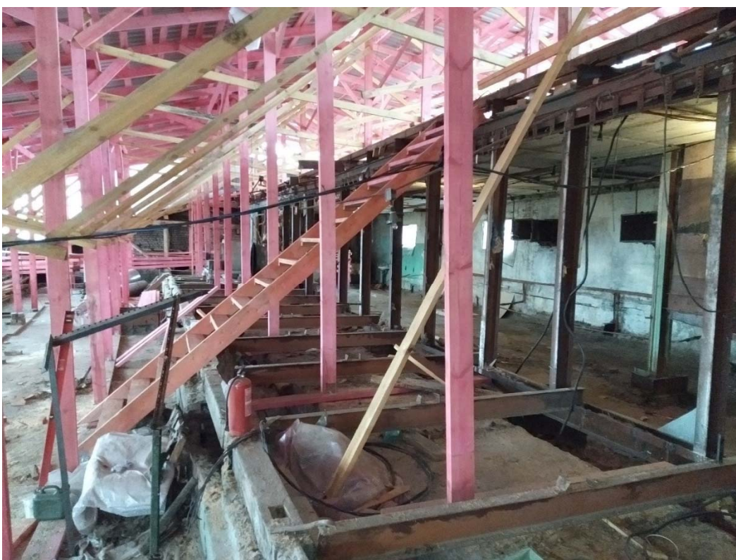
Фото 66. Чердачное пространство в осях В-Е/3 (6.36, 6.40, 6.44).
