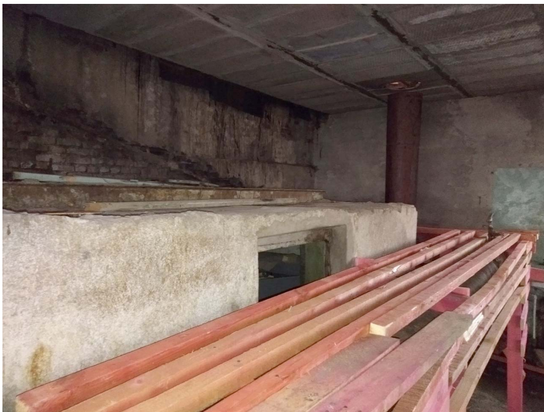
Фото 64. Чердачное пространство в осях В-Е/3 (6.36, 6.40, 6.44).
