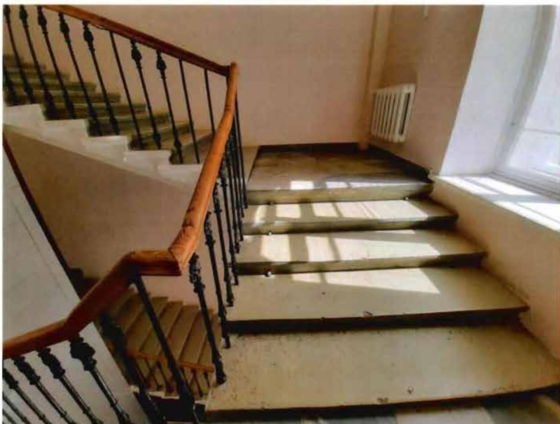
18. Лестница ЗЛК объекта культурного наследия (20.05.2022)
