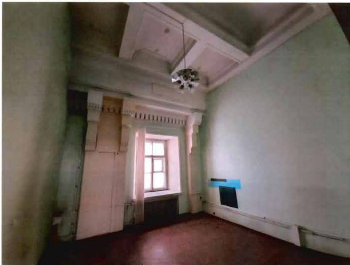
14. Интерьеры 4 этажа объекта культурного наследия, пом. 28-Н (15) (20.05.2022)
