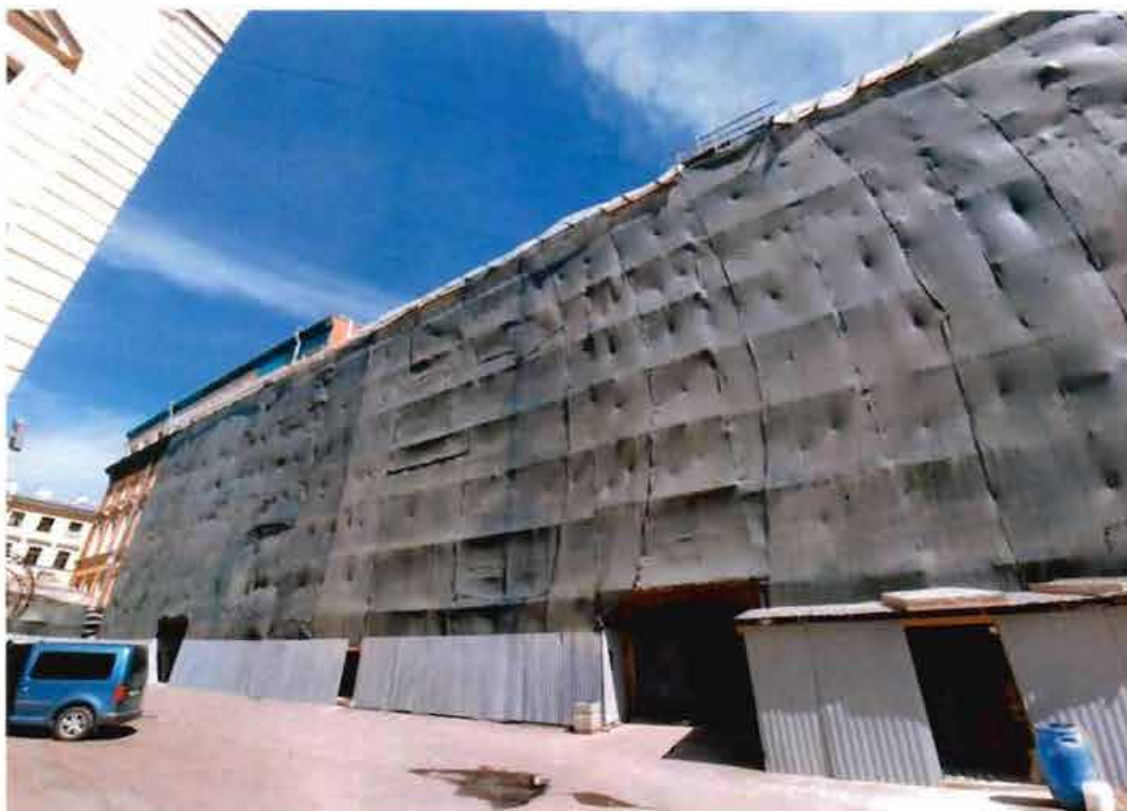
4. Общий вид на юго-западный фасад объекта культурного наследия (20.05.2022)
