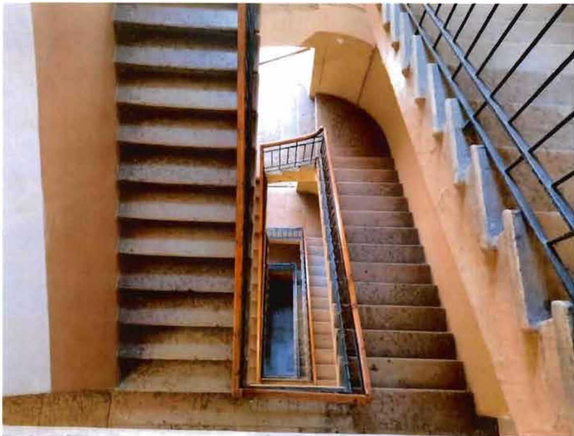
16. Восточная лестница 2ЛК объекта культурного наследия (20.05.2022)
