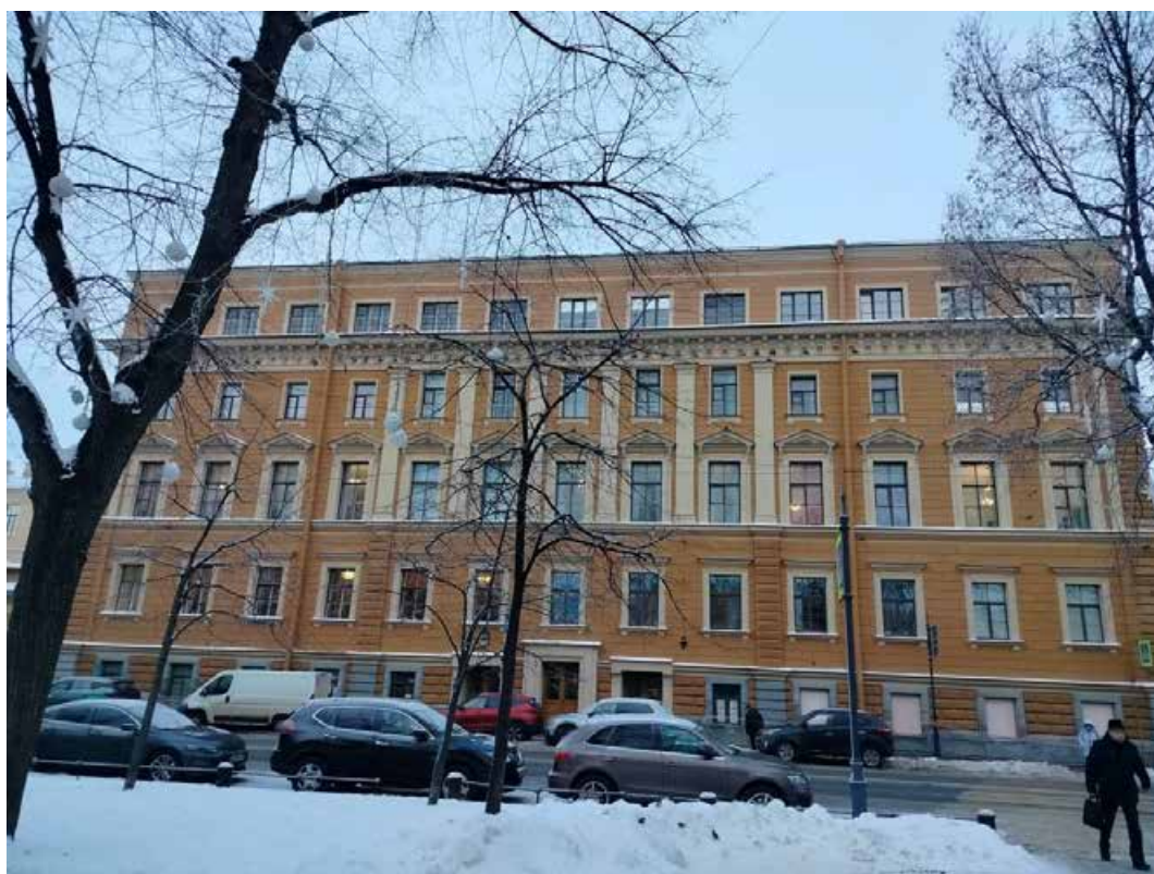
Фото 2. Лицевой фасад объекта культурного наследия федерального значения «Корпус для прислуги», входящего в состав объекта культурного наследия федерального значения «Дворец Великого князя Николая Николаевича (Ксенинский институт)» (со стороны Конногвардейского бульвара)
