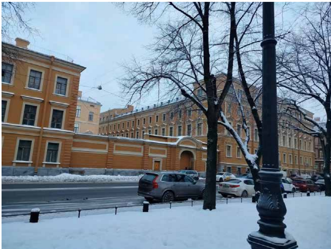
Фото 3. Лицевой фасад объекта культурного наследия федерального значения «Корпус для прислуги», входящего в состав объекта культурного наследия федерального значения «Дворец Великого князя Николая Николаевича (Ксенинский институт)» (со стороны Конногвардейского бульвара)
