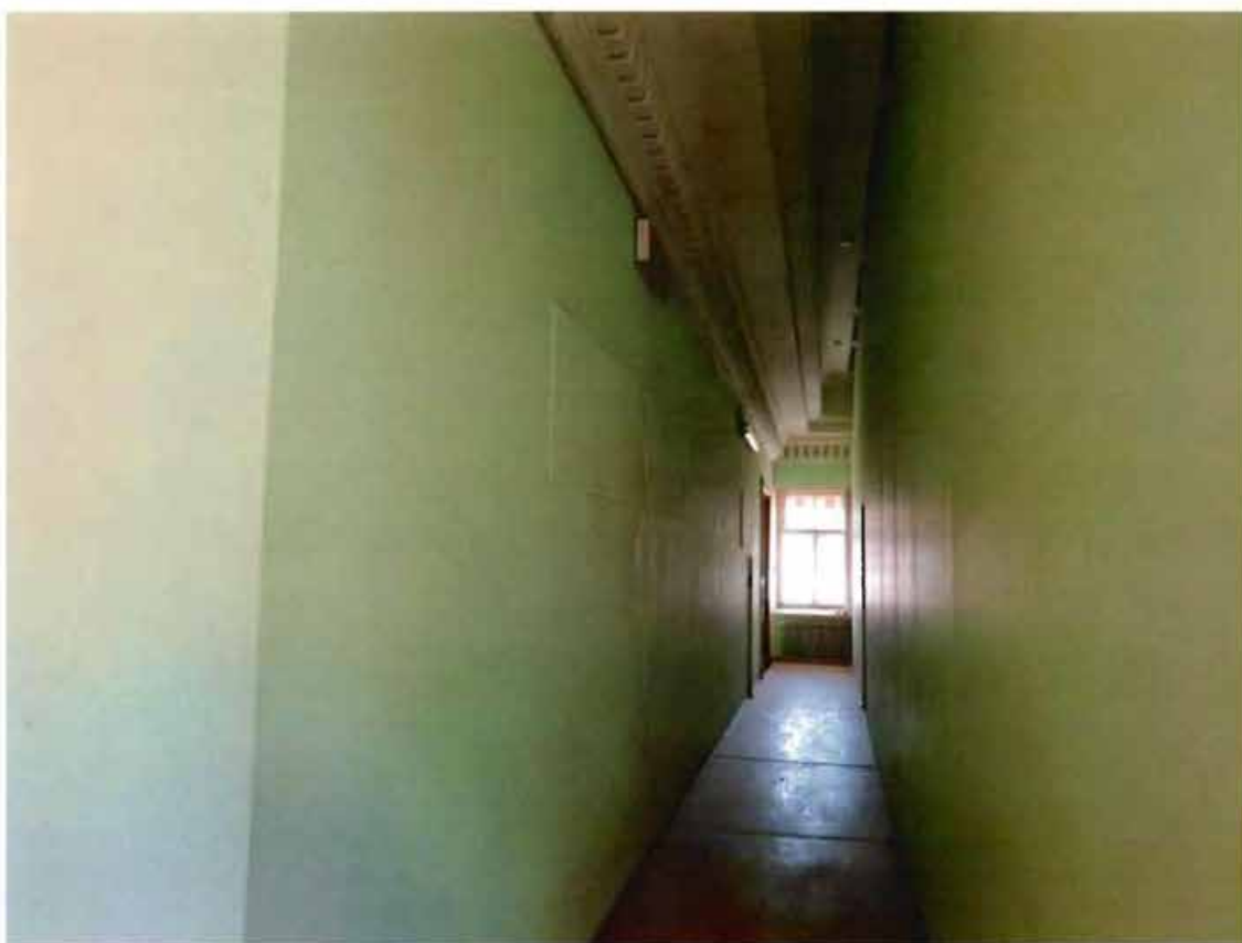
13. Интерьеры 4 этажа объекта культурного наследия, пом. 28-Н (13) (20.05.2022)
