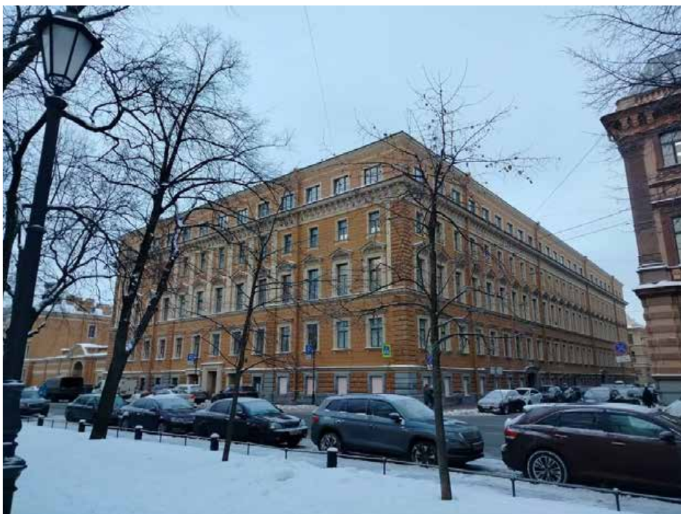
Фото 1. Лицевой фасад объекта культурного наследия федерального значения «Корпус для прислуги», входящего в состав объекта культурного наследия федерального значения «Дворец Великого князя Николая Николаевича (Ксенинский институт)» (пересечение Конногвардейского бульвара и Замятина переулка)
