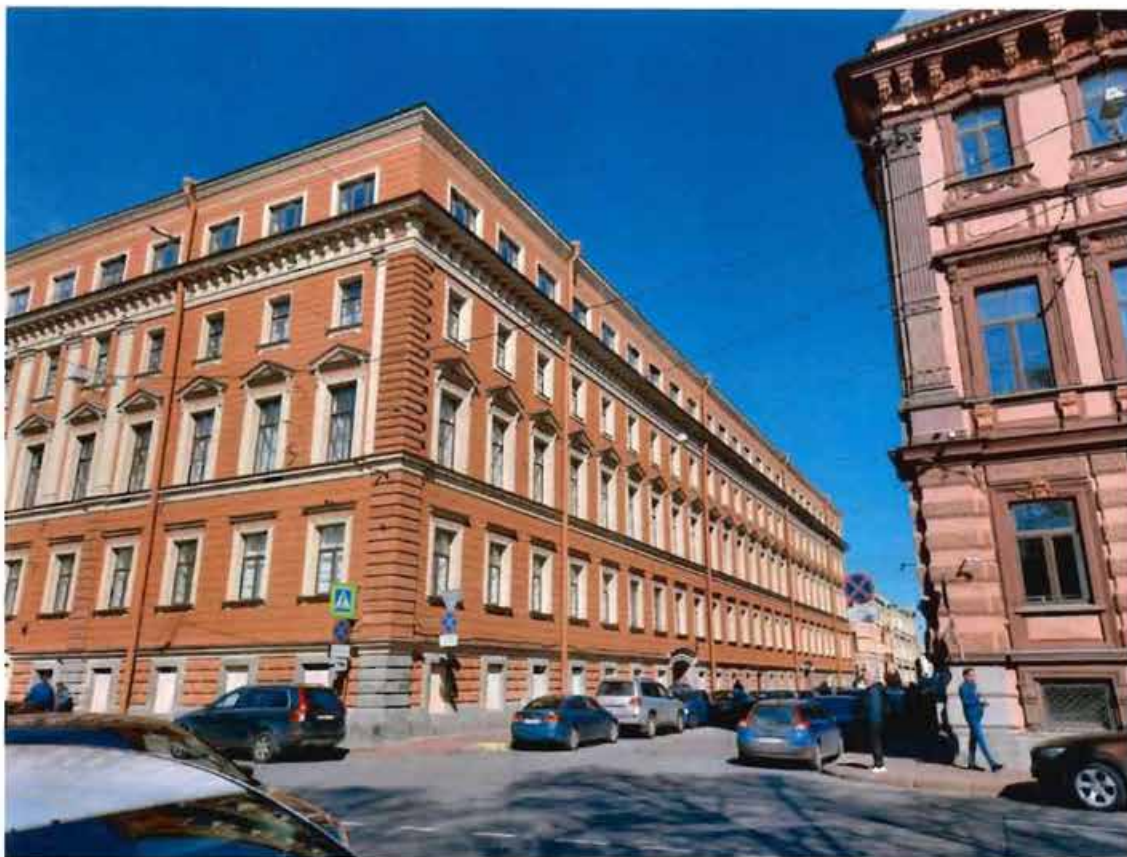
2. Общий вид на северо-восточный фасад объекта культурного наследия (20.05.2022)
