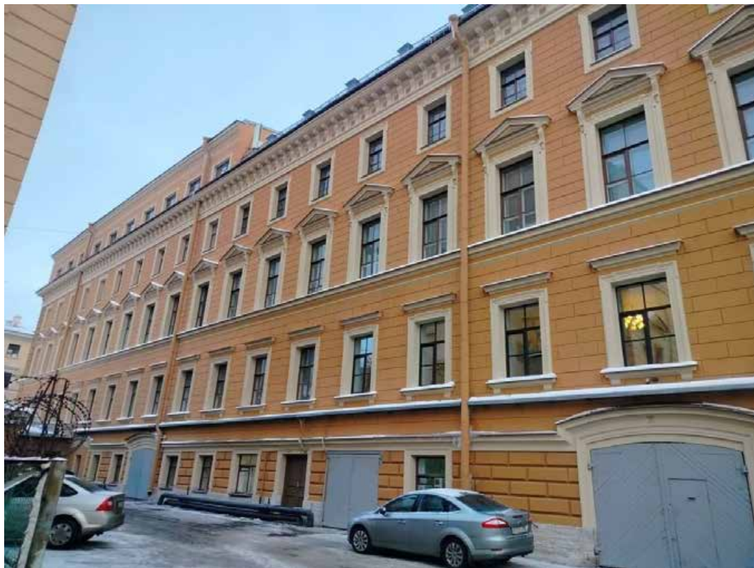
Фото 9. Фрагмент дворового фасада объекта культурного наследия федерального значения «Корпус для прислуги», входящего в состав объекта культурного наследия федерального значения «Дворец Великого князя Николая Николаевича (Ксенинский институт)»
