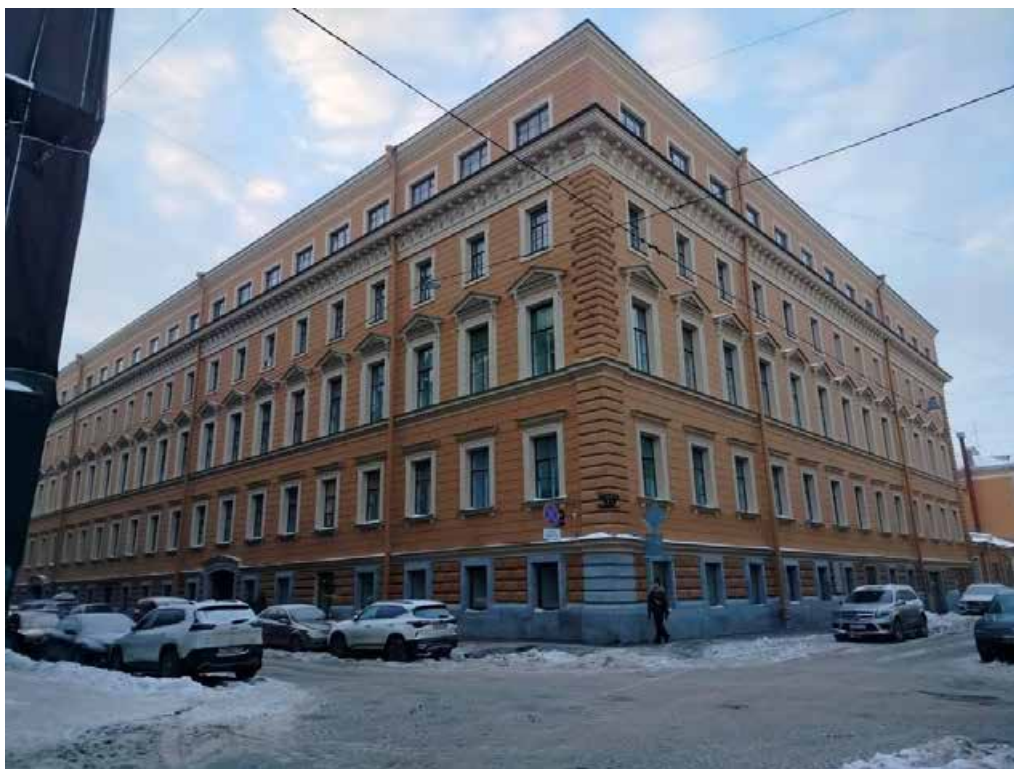
Фото 7. Лицевой фасад объекта культурного наследия федерального значения «Корпус для прислуги», входящего в состав объекта культурного наследия федерального значения «Дворец Великого князя Николая Николаевича (Ксенинский институт)» (пересечение Замятина переулка и Галерной улицы)
