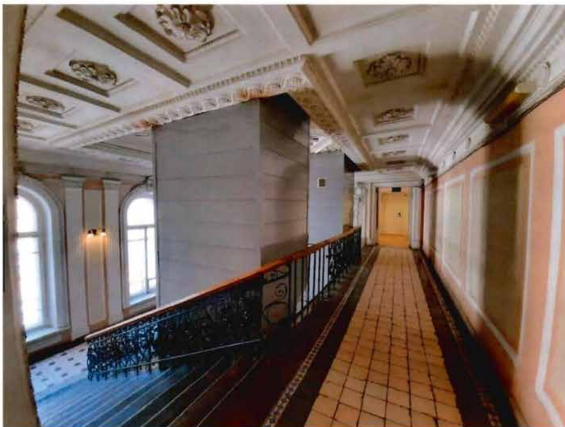
15. Лестница 1ЛК объекта культурного наследия (20.05.2022)
