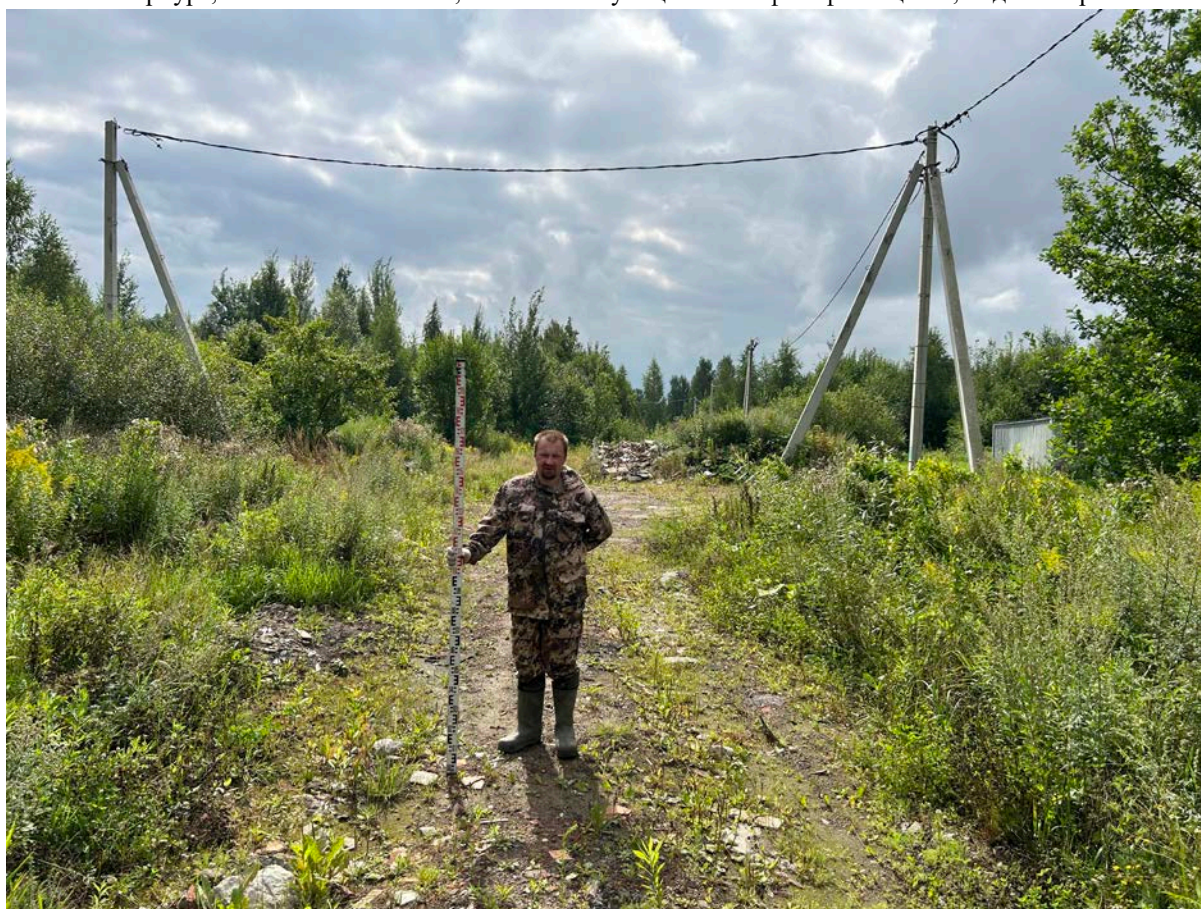
Рис. 144 Земельный участок проектируемого строительства внутриквартальных проездов по адресу город Санкт-Петербург, поселок Понтонный, Колпинская улица. Точка фотофиксации 2, вид с северо-запада.
