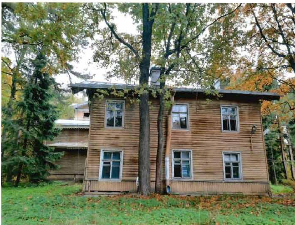
4. Вид на южный фасад объекта культурного наследия
