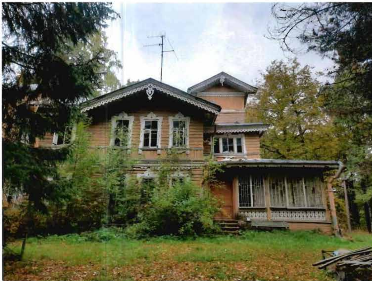
1. Вид на восточный фасад объекта культурного наследия
