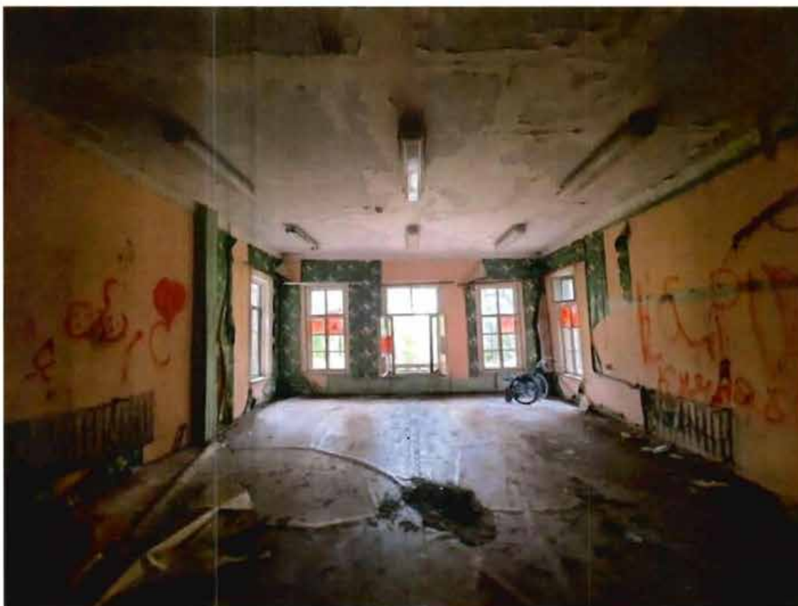
5. Интерьеры объекта культурного наследия, 1 этаж
