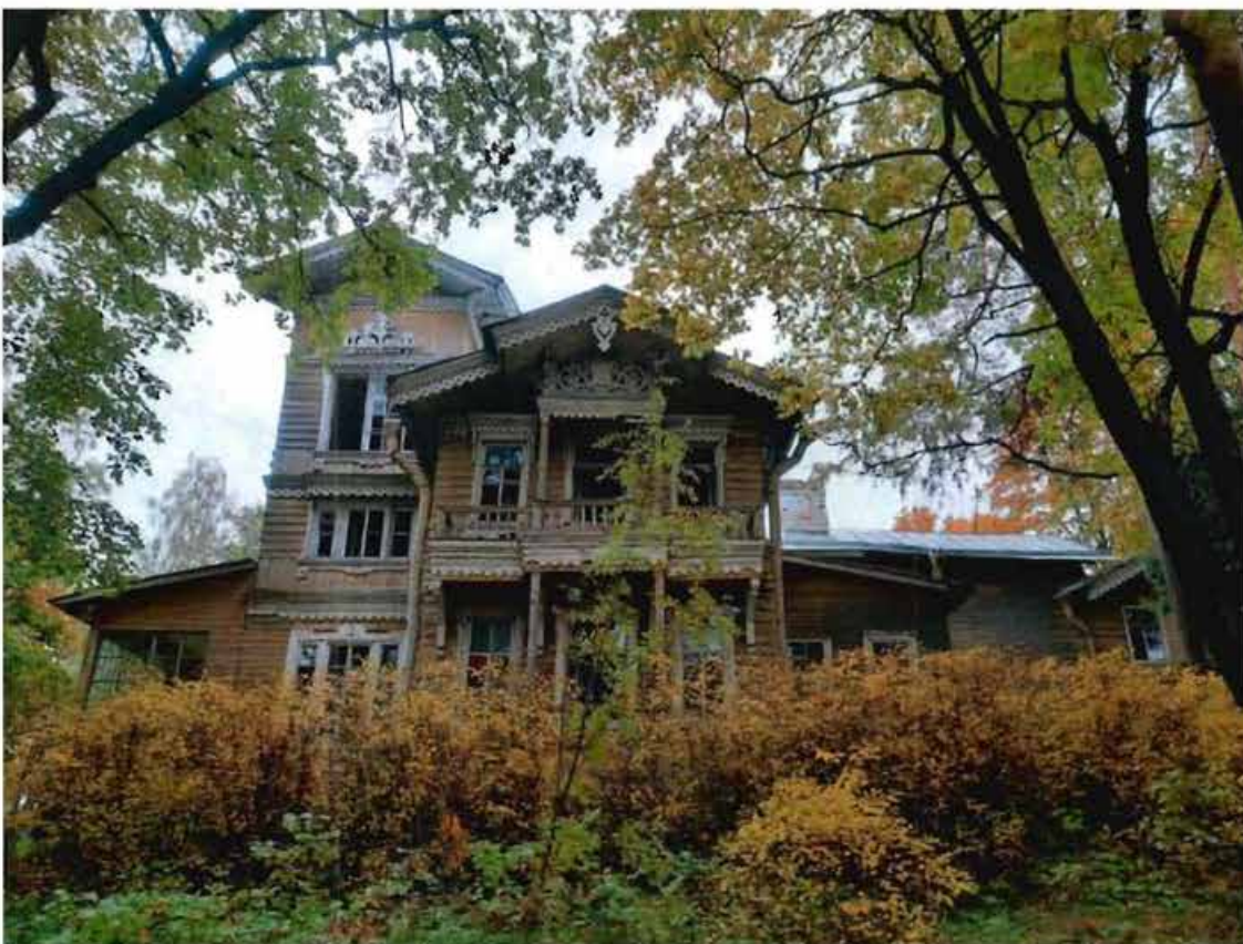
3. Вид на западный фасад объекта культурного наследия
