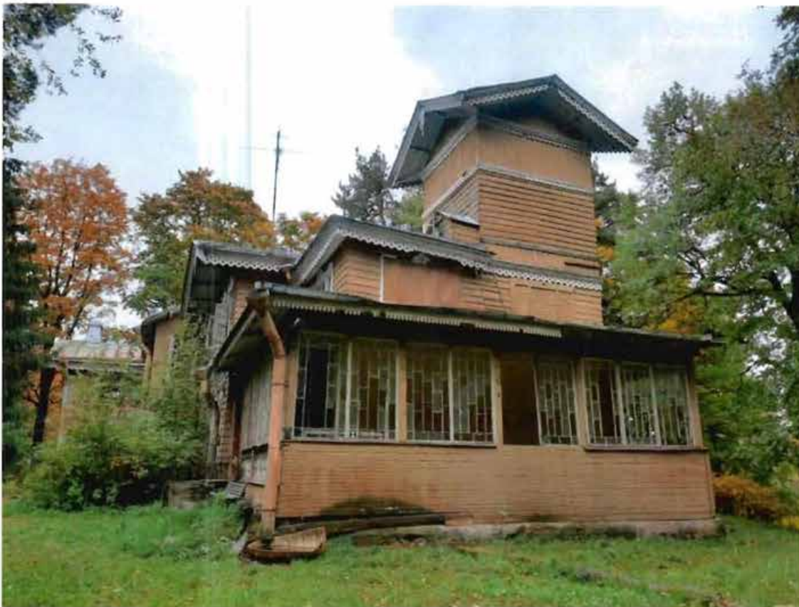
2. Вид на северный фасад объекта культурного наследия
