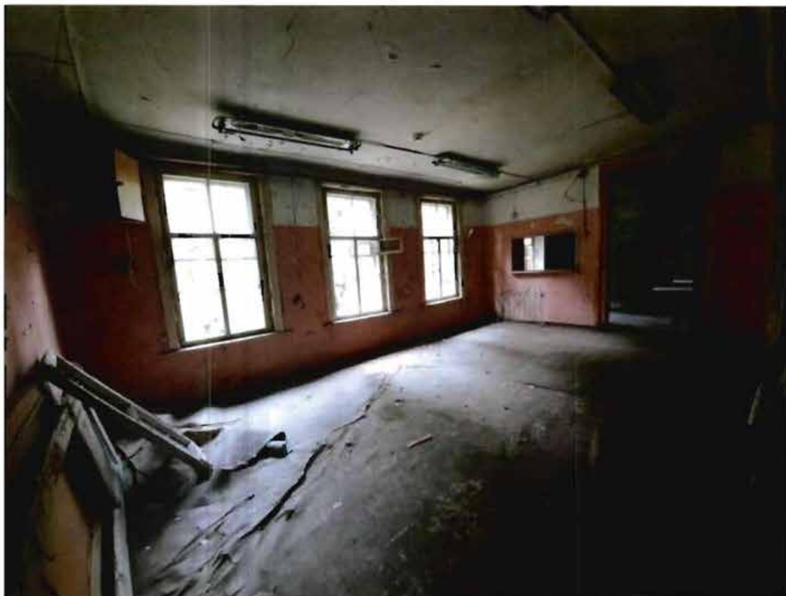
6. Интерьеры объекта культурного наследия, 2 этаж
