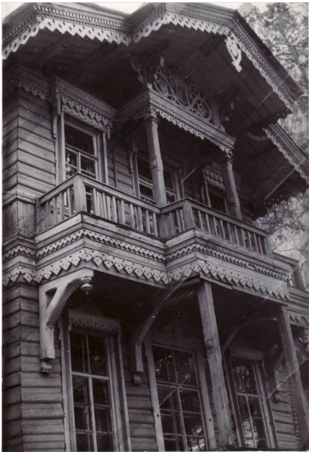
14. Вид балкона второго этажа деревянной дачи Густава Лесснера на Варваринской улице, 12, украшенного накладной резьбой (1890-е гг.). Фотография. Автор фото – Овчинников Кирилл Владимирович. 1987 г. // Источник: ЦГАКФФД СПб. Фотодокументы. Оп.1АР-157. Ед.хр.224491.
