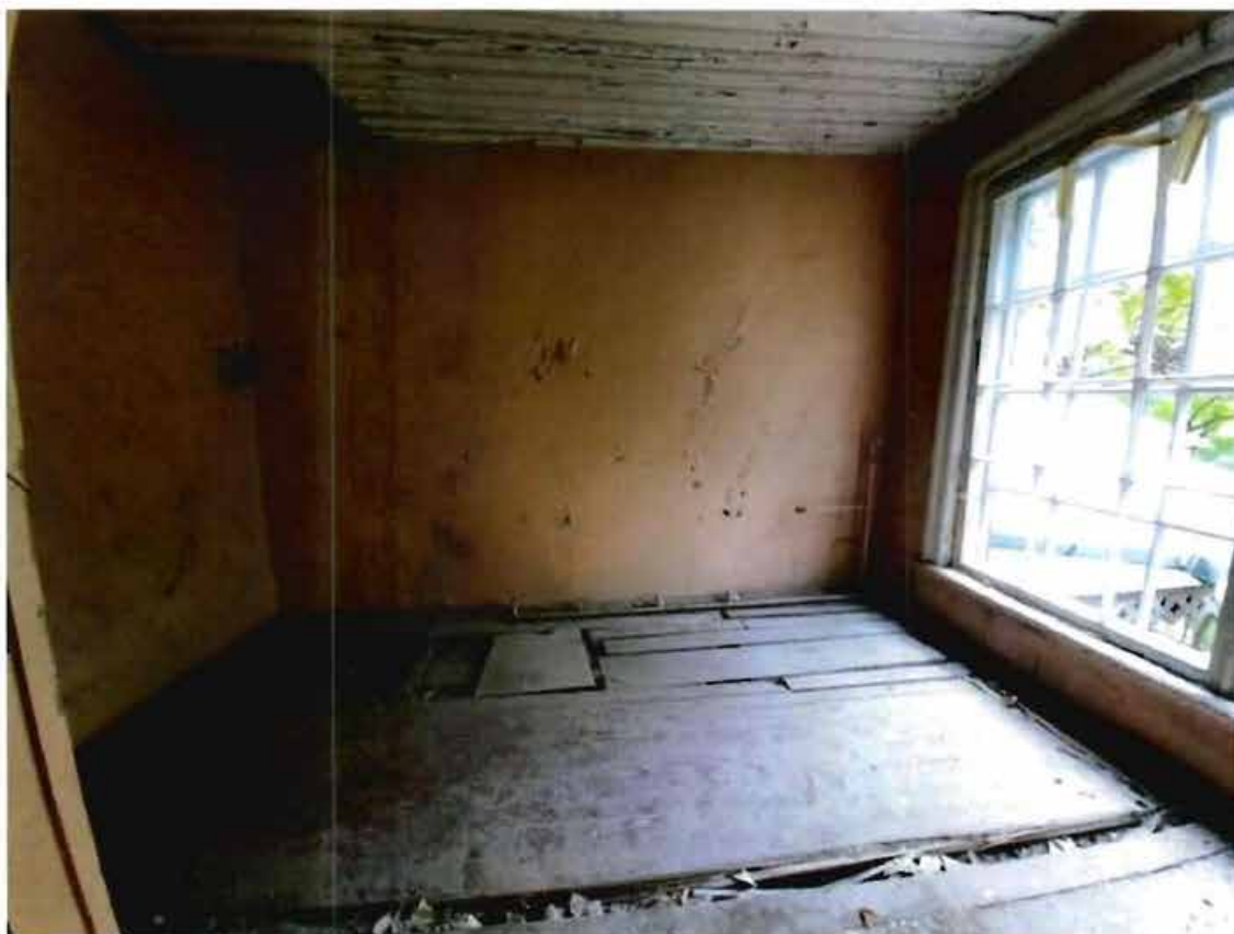
7. Интерьеры объекта культурного наследия, мансарда
