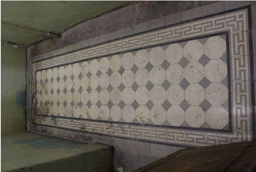
13. 1-й этаж. Покрытие пола метлахской плиткой в помещении 3Н(3). Фотофиксация: январь 2022 г.
