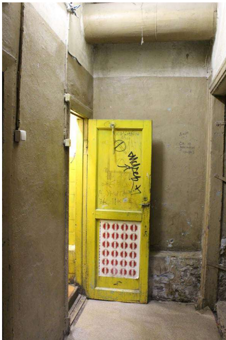
12. 1-й этаж. Общий вид пом. 2-Н(1) в историческом объеме бывшей лестничной клетки. Фотофиксация: февраль 2022 г.
