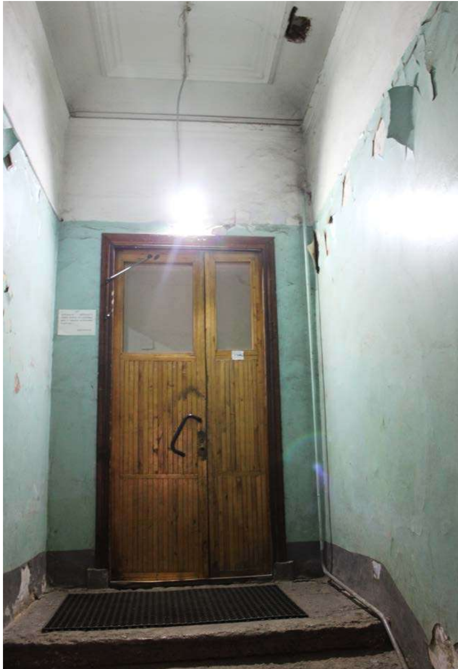
3. 1-й этаж. Вид лестницы в помещении 1-Н(13). Фотофиксация: 26 апреля 2024 г.
