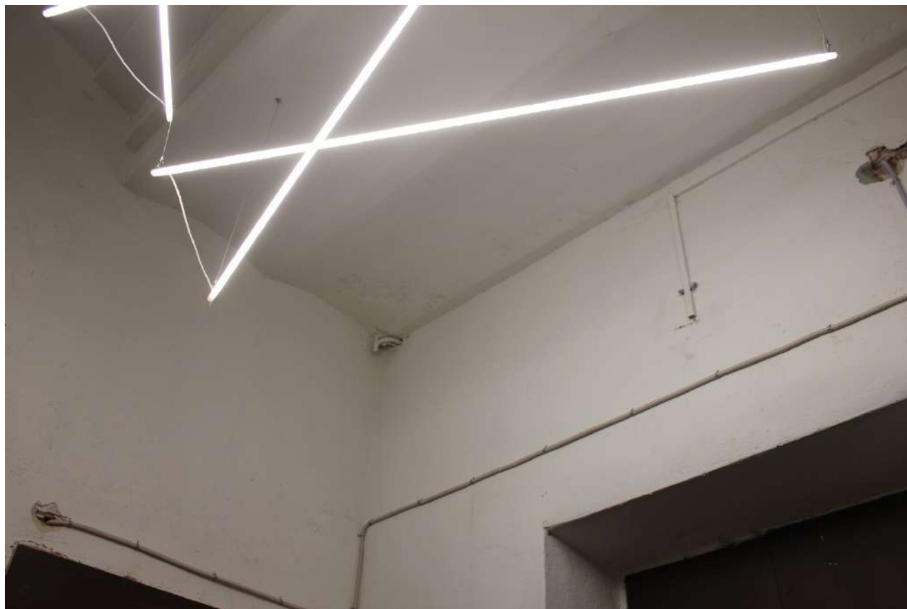
17. 2-й этаж. Вид сводчатого перекрытия лестничной площадки. Фотофиксация: 26 апреля 2024 г.
