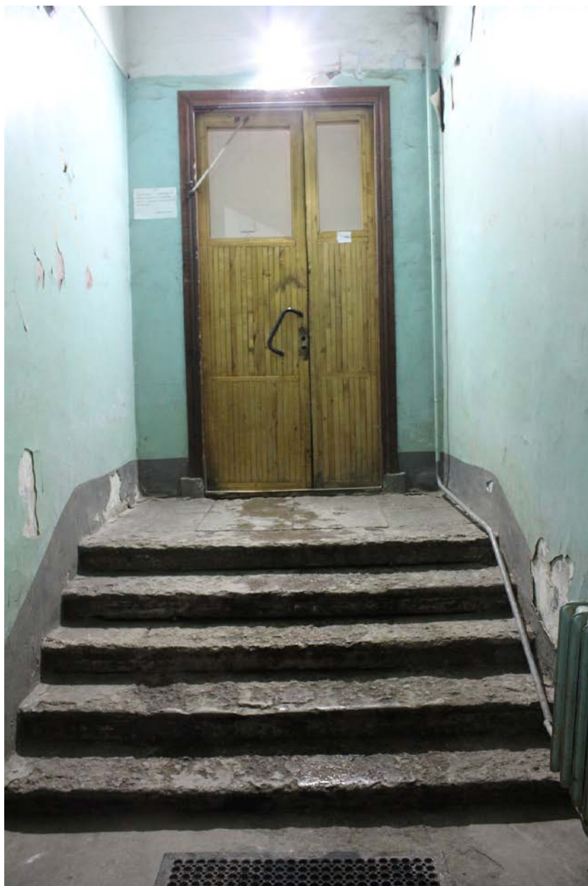
3. 1-й этаж. Лестница в помещении 1-Н(13). Фотофиксация: январь 2022 г.
