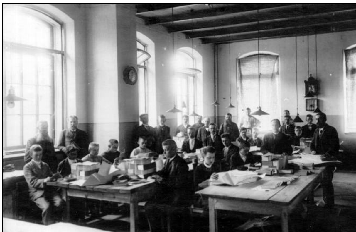
64. Цех фабрики «Отто Кирхнер» (современный корпус лит. В). 1909 г. // ЦГА КФФД СПб. Шифр: Д 14309.
