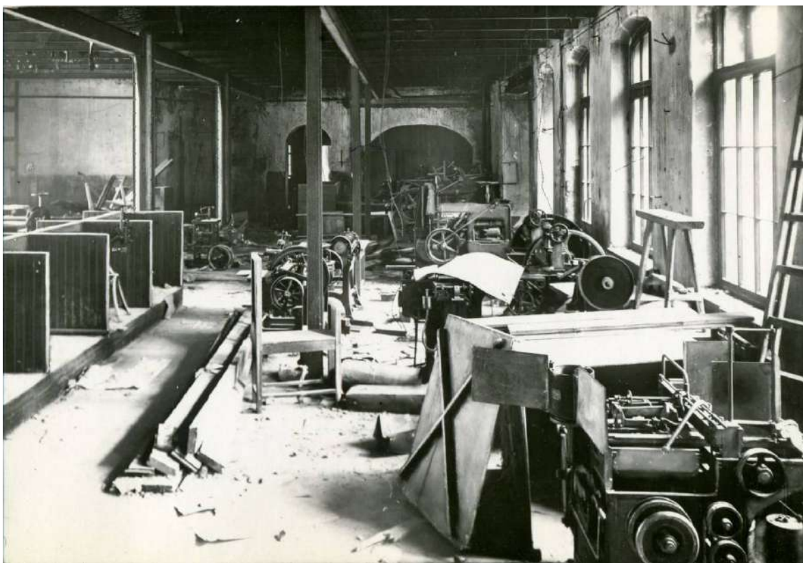
104. Внутренний вид цеха до восстановления (современный корпус лит. В). До 1924 г. // Музей фабрики «Светоч».
