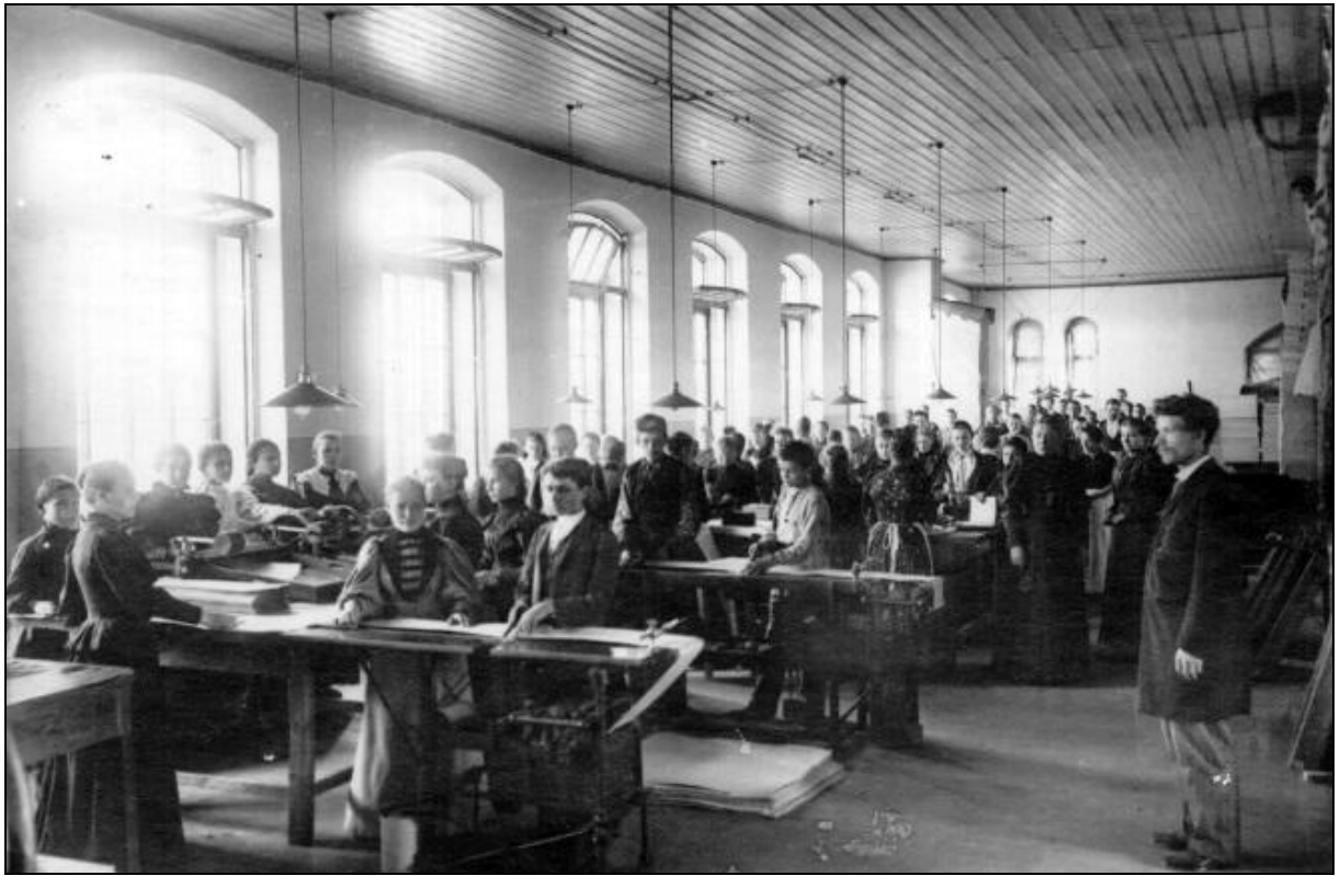
65. Цех фабрики «Отто Кирхнер» (современный корпус лит. В). 1909 г. // ЦГА КФФД СПб. Шифр: Д 14310.
