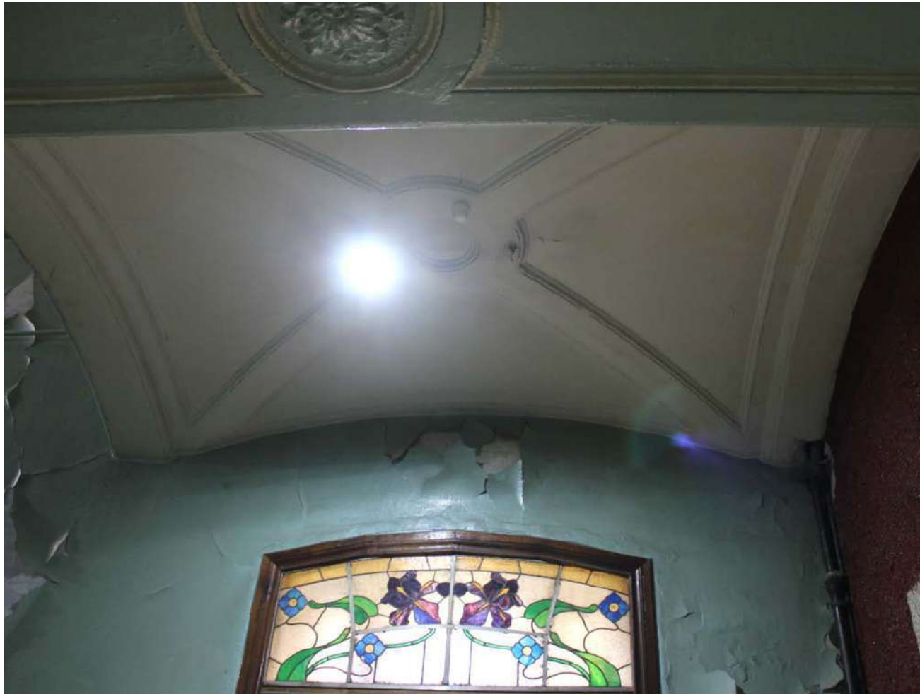
б. 1-й этаж. Сводчатое перекрытие потолка в помещении 1-Н(26). Фотофиксация: 26 апреля 2024 г.
