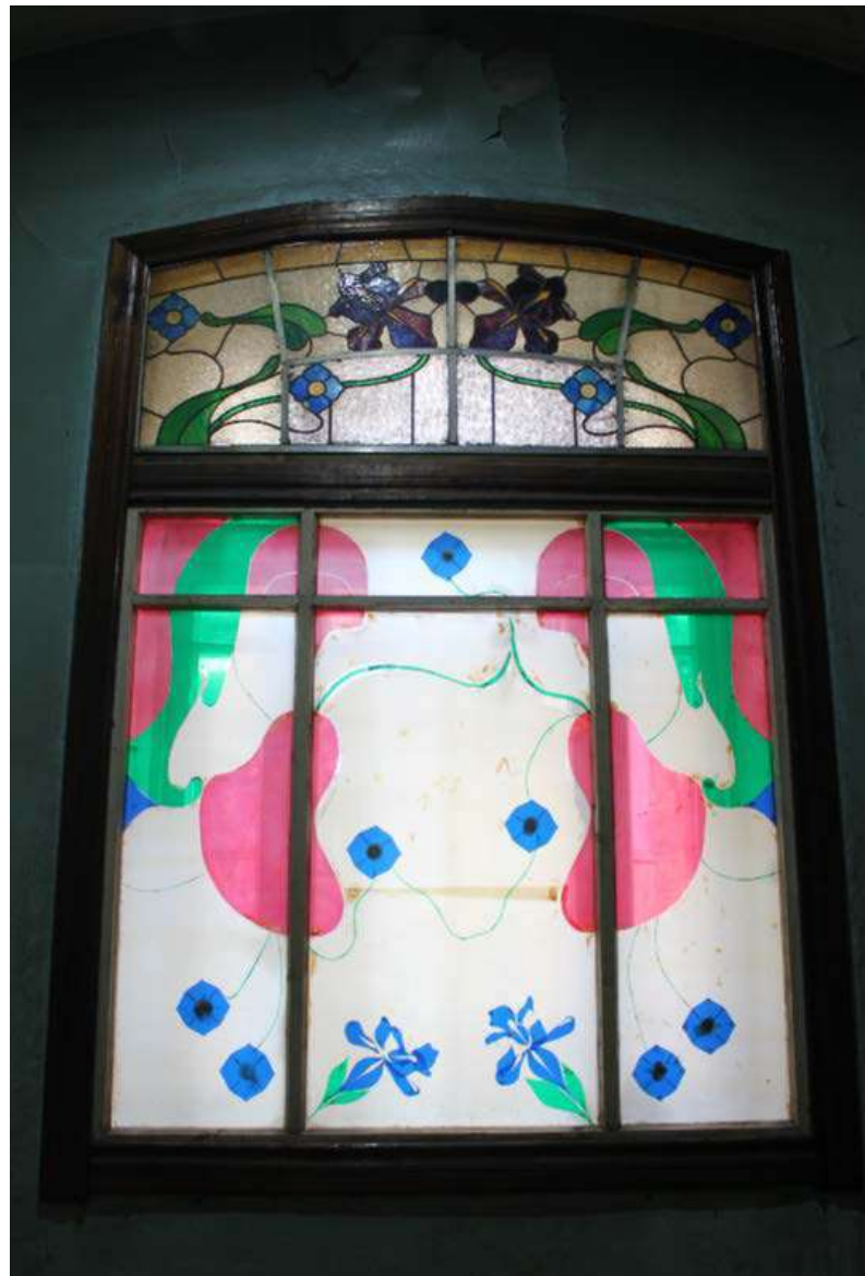
4. 1-й этаж. Витражное полихромное заполнение фрамуги оконного проема в помещении 1-Н(26). Фотофиксация: 26 апреля 2024 г.
