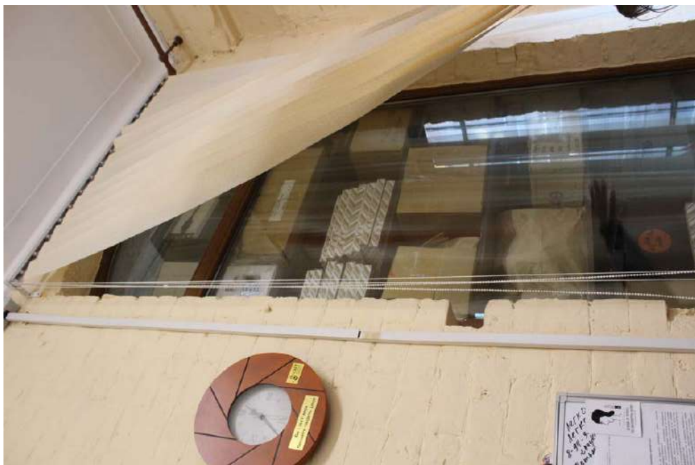
6. 1-й этаж. Помещение 5-Н(9). Вид оконного проема южного фасада (в настоящее время – на внутренней капитальной стене). Фотофиксация: январь 2022 г.
