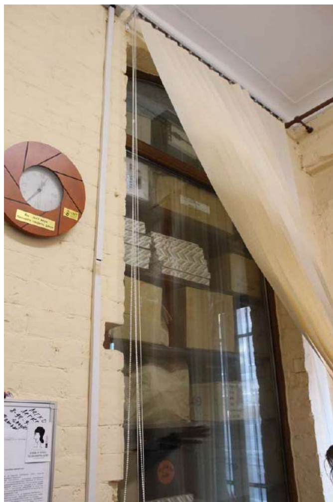
6. 1-й этаж. Помещение 5-Н(9). Вид оконного проема южного фасада (в настоящее время – на внутренней капитальной стене). Фотофиксация: 26 апреля 2024 г.
