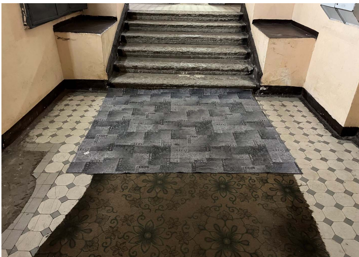
Фото №6. Вестибюль лестничной клетки 1ЛК, покрытие пола в виде метлахской плитки, ступени лестничного марша.
