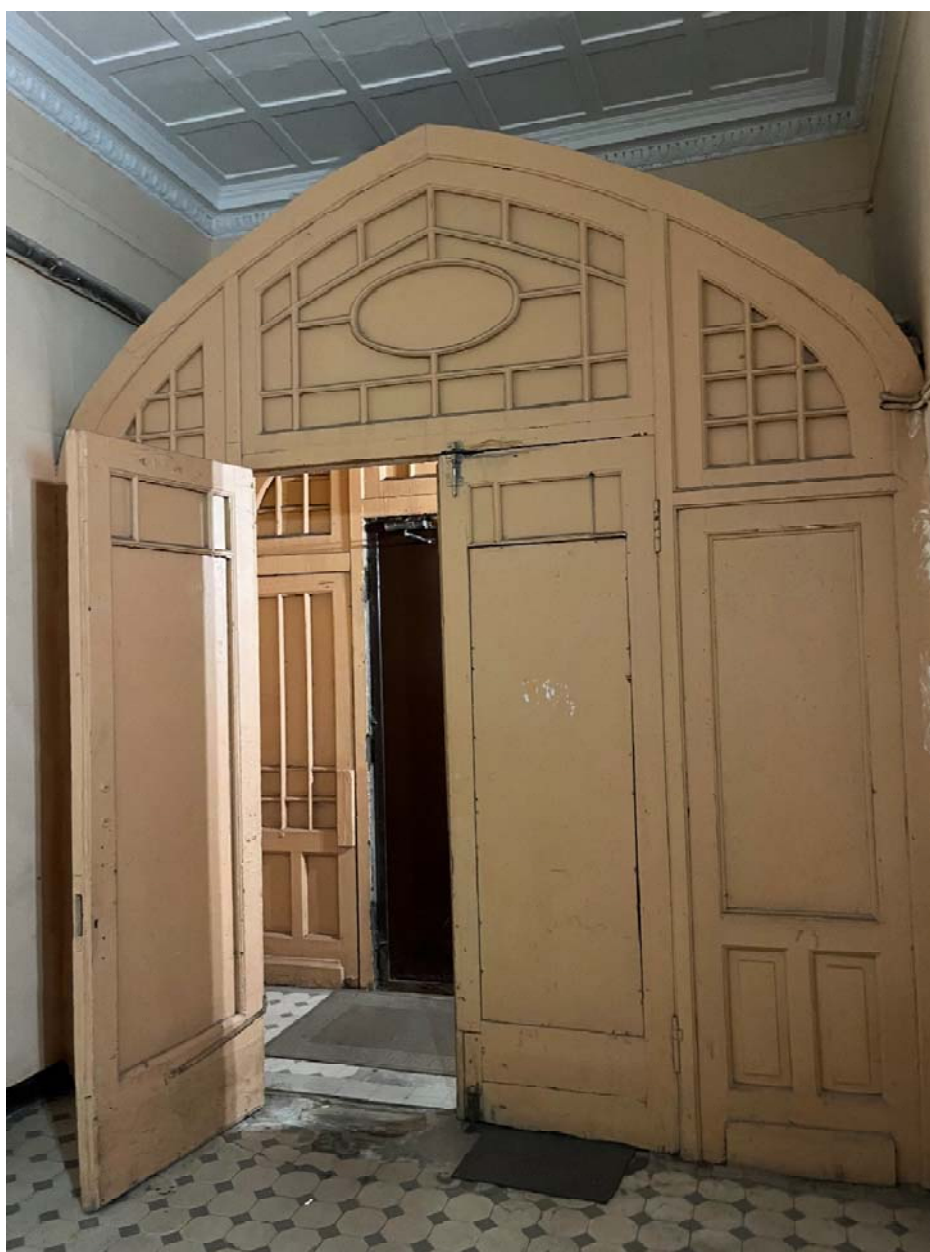
Фото №5. Вестибюль лестничной клетки 1JK, деревянный тамбур.
