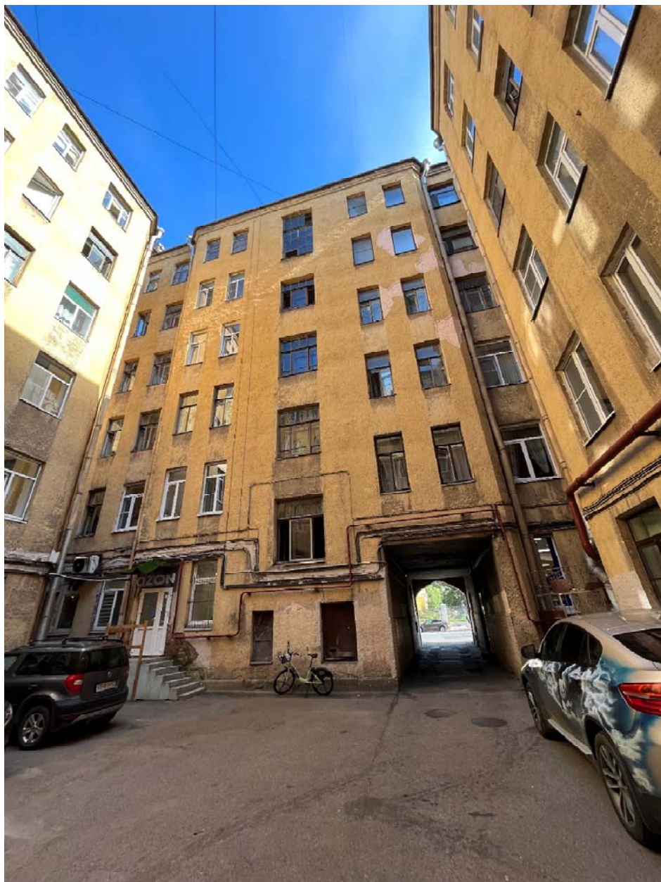
Фото №3. Общий вид дворового фасада лицевого корпуса по 9-ой линии В.О.
