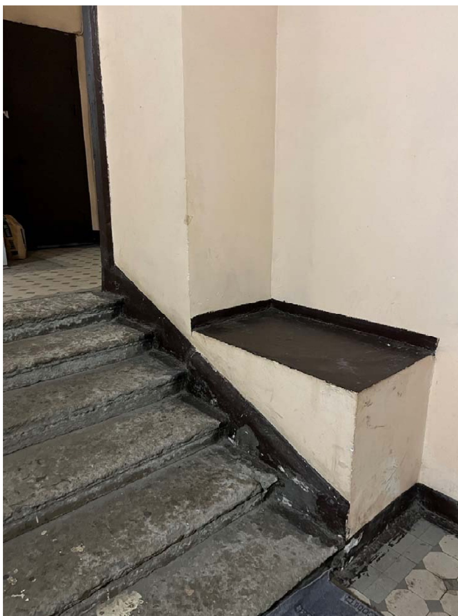
Фото №8. Вестибюль лестничной клетки 1ЛК, ступени лестничного марша, поле стены.
