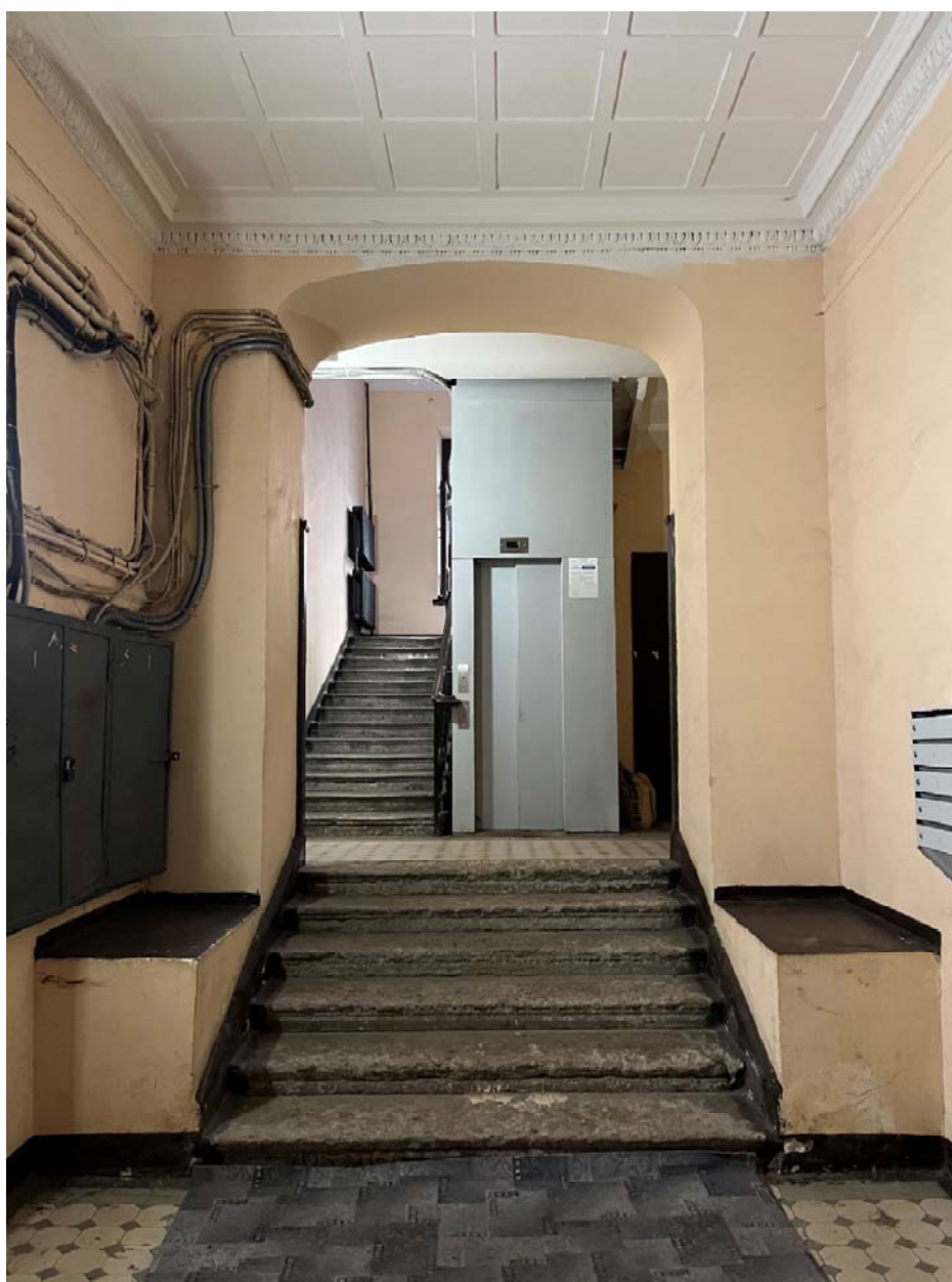
Фото №4. Вестибюль лестничной клетки 1ЛК, общий вид.
