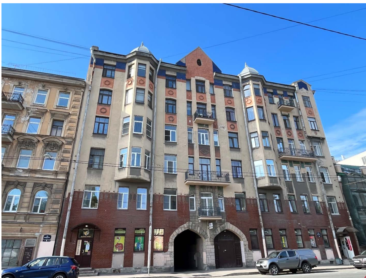
Фото №1. Общий вид лицевого фасада по 9-ой линии В.О.
