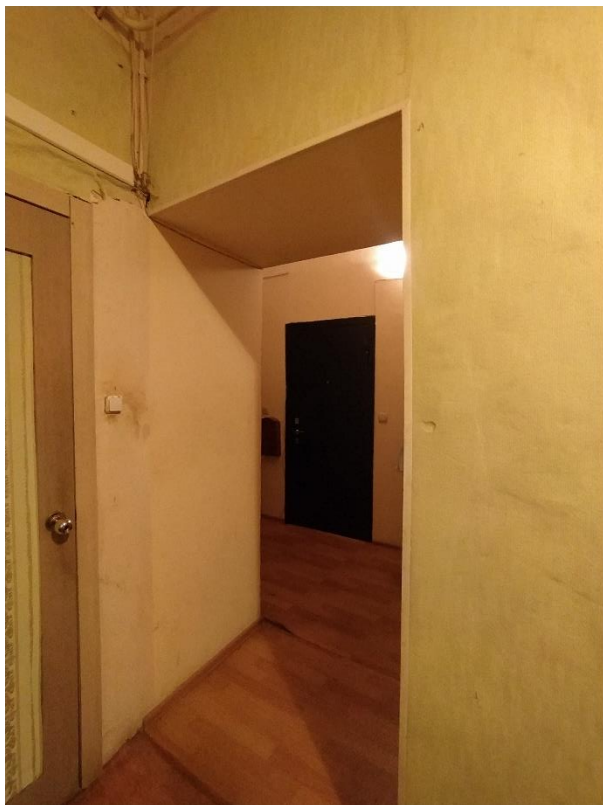
Фото 13. Вид на входной проём в коридор - пом. 3.
