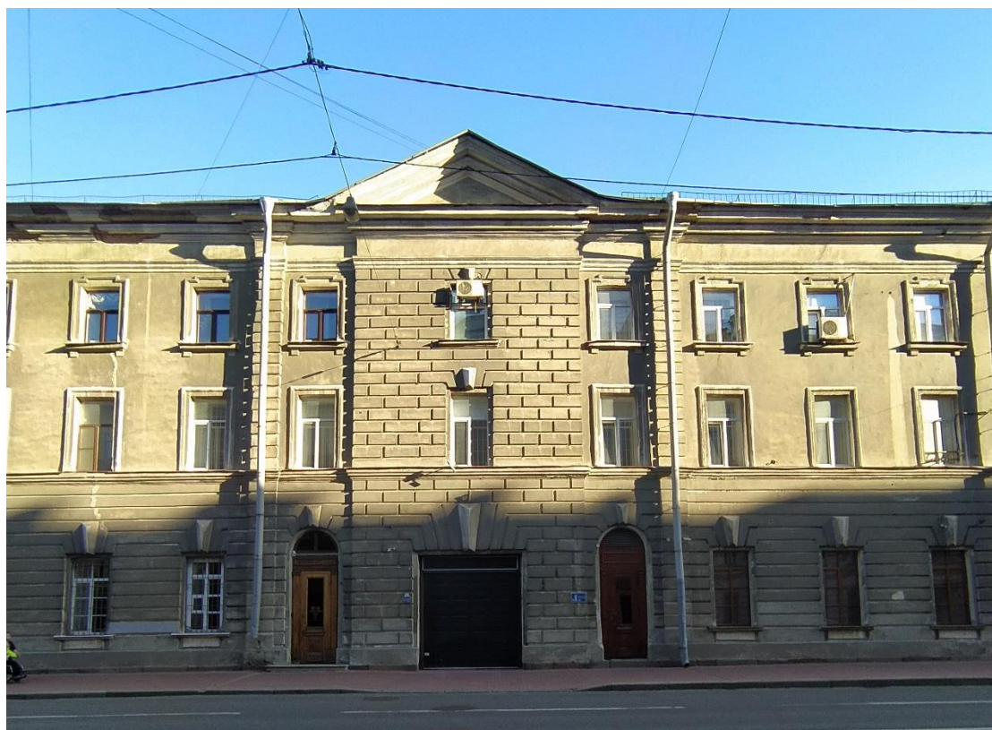
Фото 3. Выявленный объект культурного наследия «Конторский дом» (в составе «Комплекс зданий Конторского двора Гоф-интендантской конторы») Вид на центральную часть лицевого фасада здания по Шпалерной улице.
