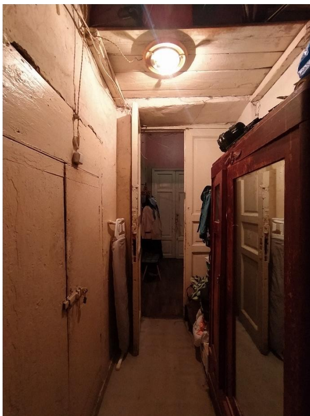
Фото 25. Вид на коридор – пом. 13
