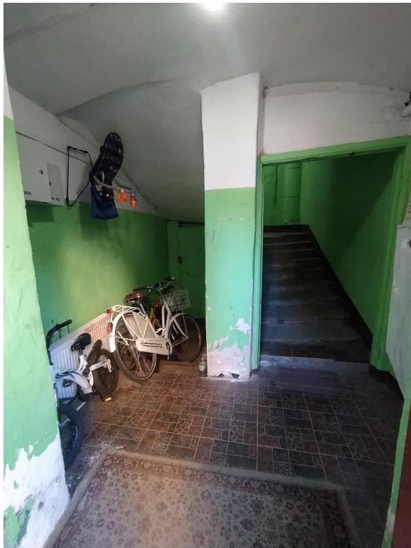
Фото 6. Вид на дворовую лестницу № 4 со стороны входа.
