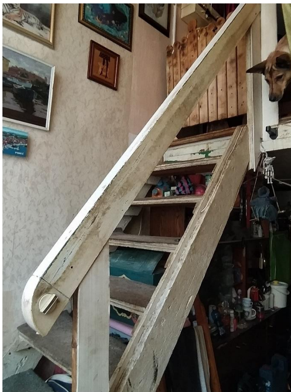
Фото 28. Вид от окна на лестницу хоз полки в пом.12.
