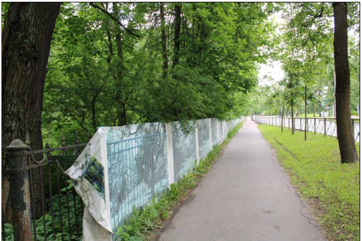
53. Ограда с западной стороны выявленного объекта культурного наследия «Офицерское собрание лейб-гвардии 1-го Стрелкового полка (с садом)». Вид с северо-запада от Павловского шоссе. 12.06.2024 г.
