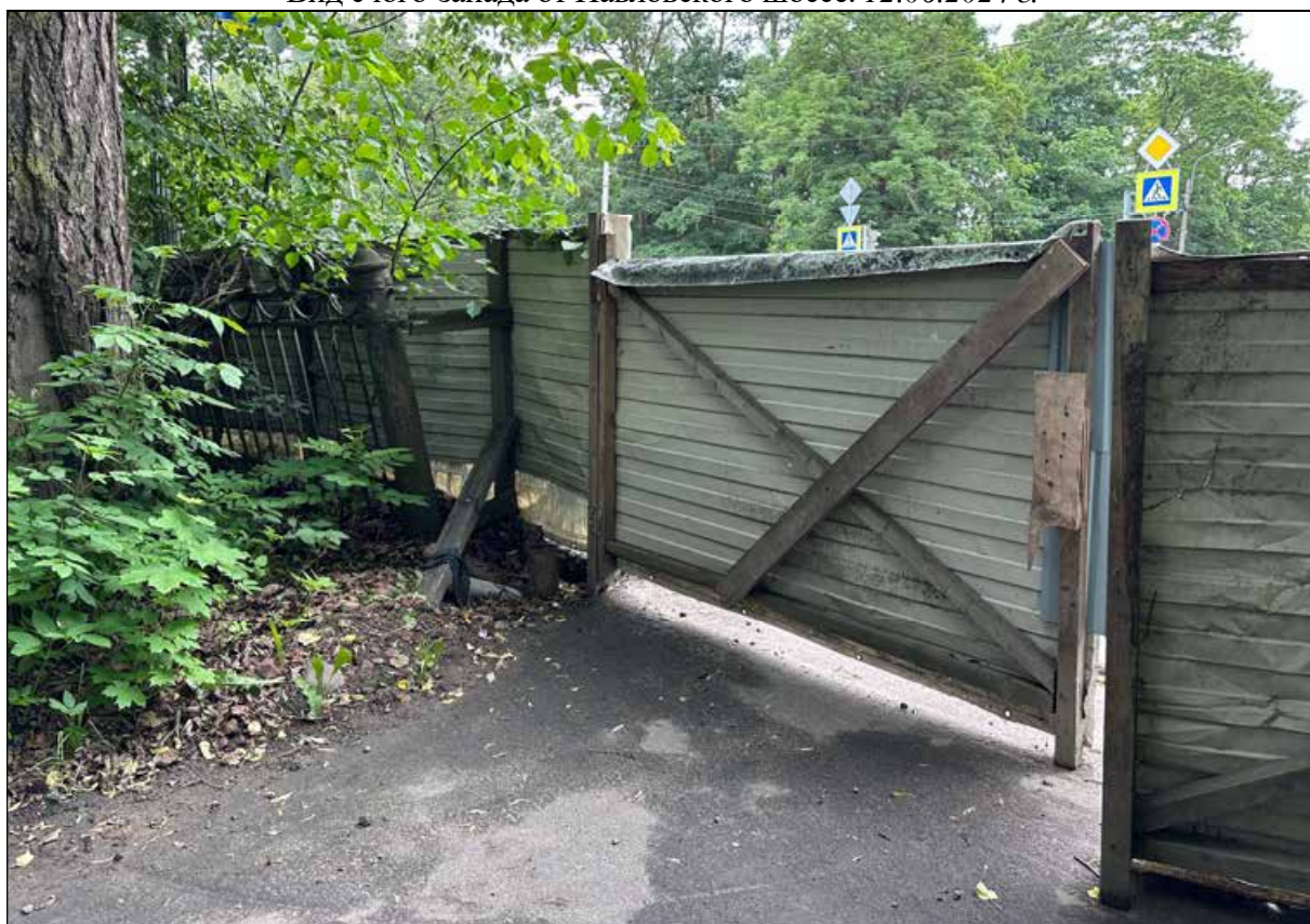
51. Фрагмент ограды с западной стороны выявленного объекта культурного наследия «Офицерское собрание лейб-гвардии 1-го Стрелкового полка (с садом)». Вид с северо-востока. 12.06.2024 г.
