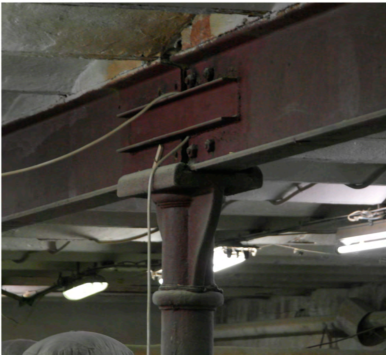
Фотография 59. Выявленный объект культурного наследия «Комплекс построек Кожевенного завода Товарищества "И. А. Осипов и Ко"». Адрес: Санкт-Петербург, переулок Декабристов, дом 7, литера Т. Вид на колонну, 2-ой этаж. Дата фотофиксации 18.04.2024 г.
