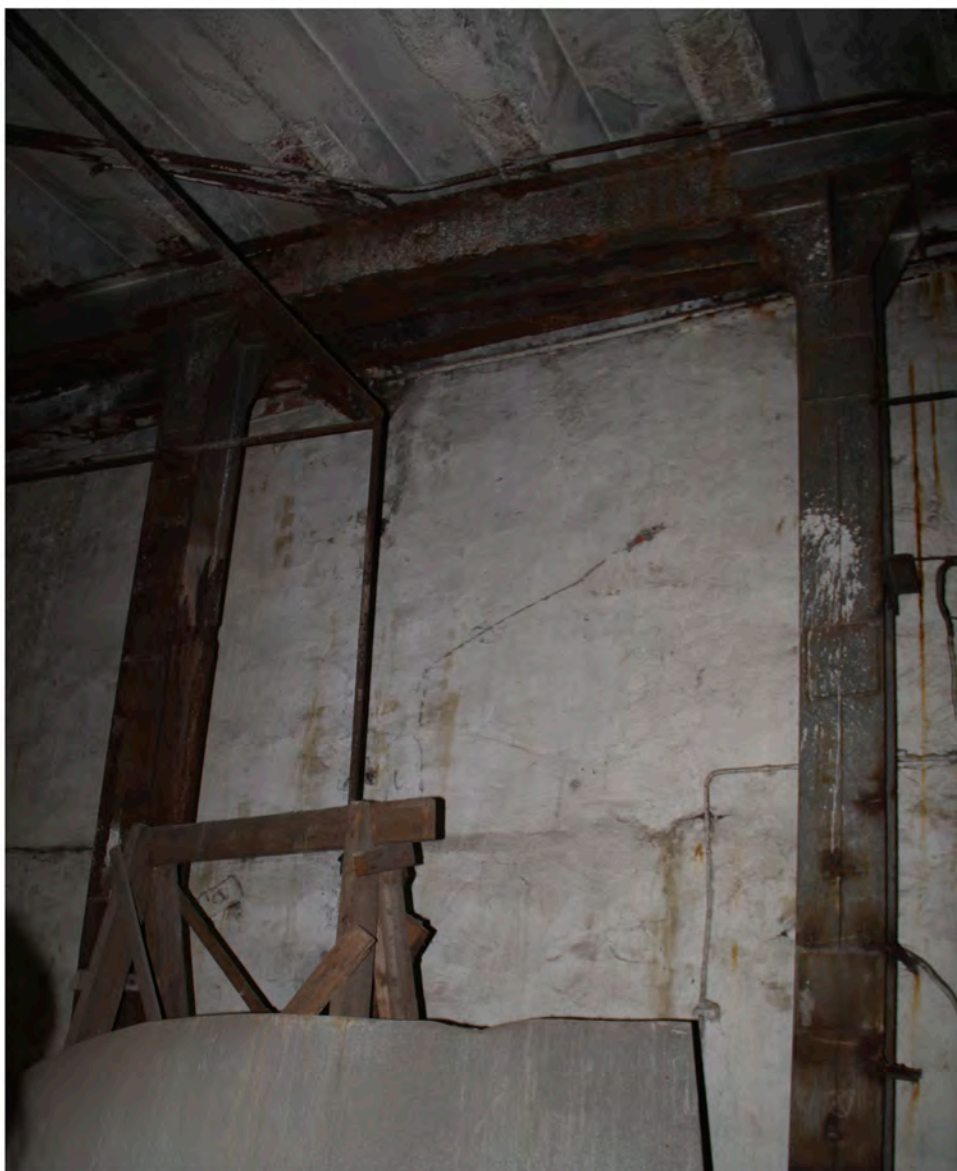
Фотография 65. Выявленный объект культурного наследия «Комплекс построек Кожевенного завода Товарищества "И. А. Осипов и Ко"». Адрес: Санкт-Петербург, переулок Декабристов, дом 7, литера Т. Вид на колонны, 2-ой этаж. Дата фотофиксации 18.04.2024 г.
