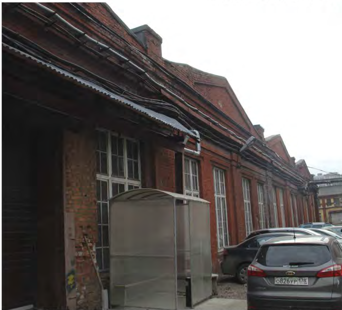
Фотография 8. Выявленный объект культурного наследия «Комплекс построек Кожевенного завода Товарищества “И. А. Осипов и Ко”». Адрес: Санкт-Петербург, переулок Декабристов, дом 7, литера Т. Фрагмент фасада с западной стороны. Дата фотофиксации 18.04.2024 г.
