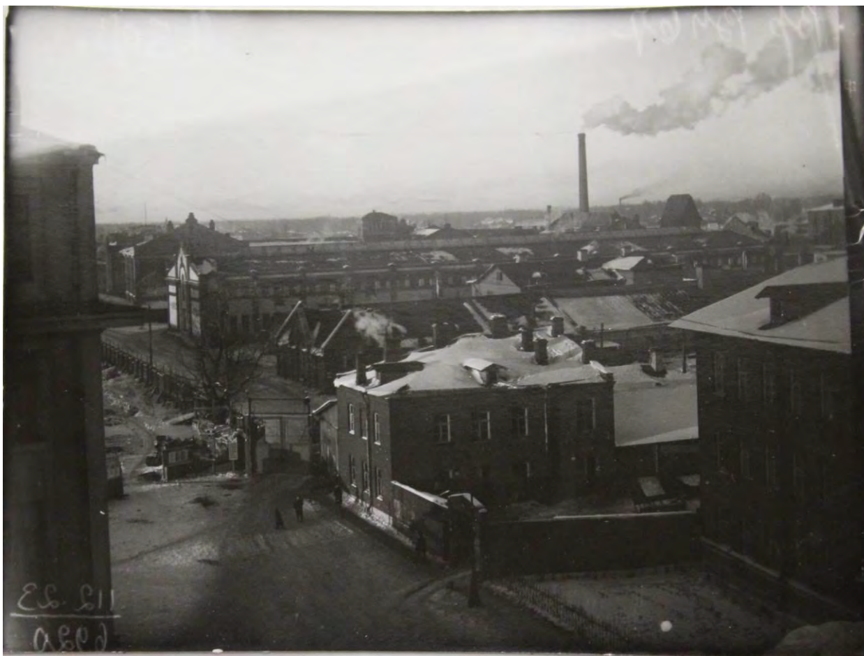
225.Общий вид завода. 9 марта 1933 г. // Источник: ЦГАКФФД. Вр 13467.
