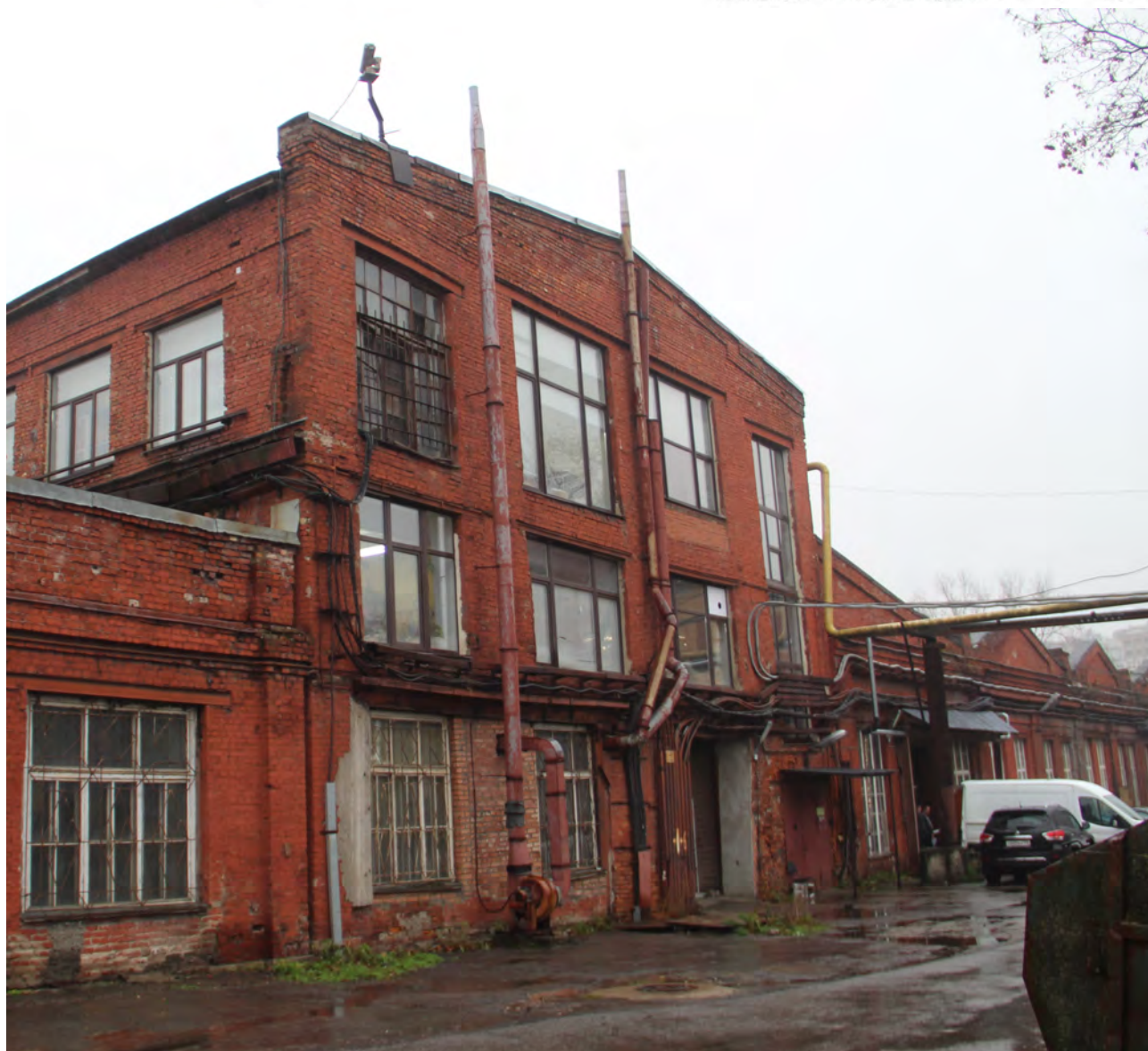
Фотография 7. Выявленный объект культурного наследия «Комплекс построек Кожевенного завода Товарищества "И. А. Осипов и Ко"». Адрес: Санкт-Петербург, переулок Декабристов, дом 7, литера Т. Фрагмент фасада с западной стороны. Дата фотофиксации 18.04.2024 г.
