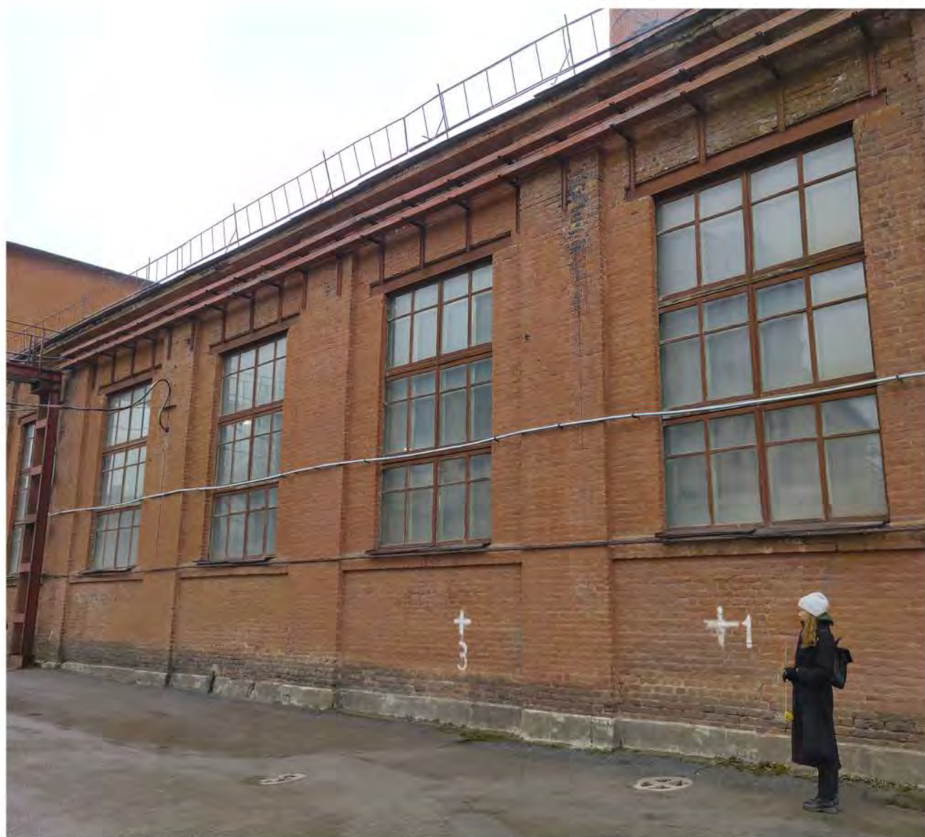
Фотография 19. Выявленный объект культурного наследия «Комплекс построек Кожевенного завода Товарищества "И. А. Осипов и Ко"». Адрес: Санкт-Петербург, переулок Декабристов, дом 7, литера С. Фрагмент фасада с восточной стороны. Дата фотофиксации 18.04.2024 г.
