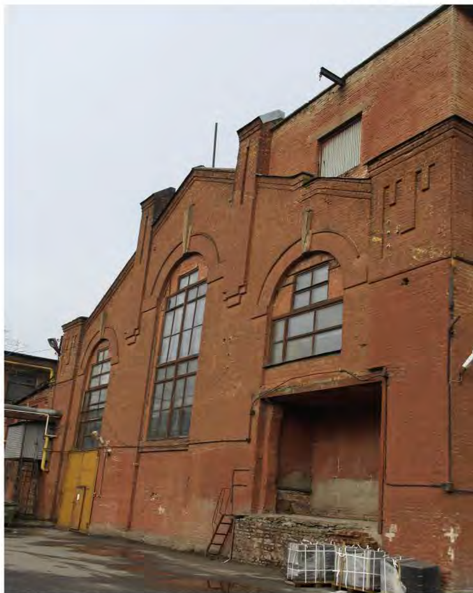
Фотография 20. Выявленный объект культурного наследия «Комплекс построек Кожевенного завода Товарищества "И. А. Осипов и Ко"». Адрес: Санкт-Петербург, переулок Декабристов, дом 7, литера С. Общий вид фасада с южной стороны. Дата фотофиксации 18.04.2024 г.
