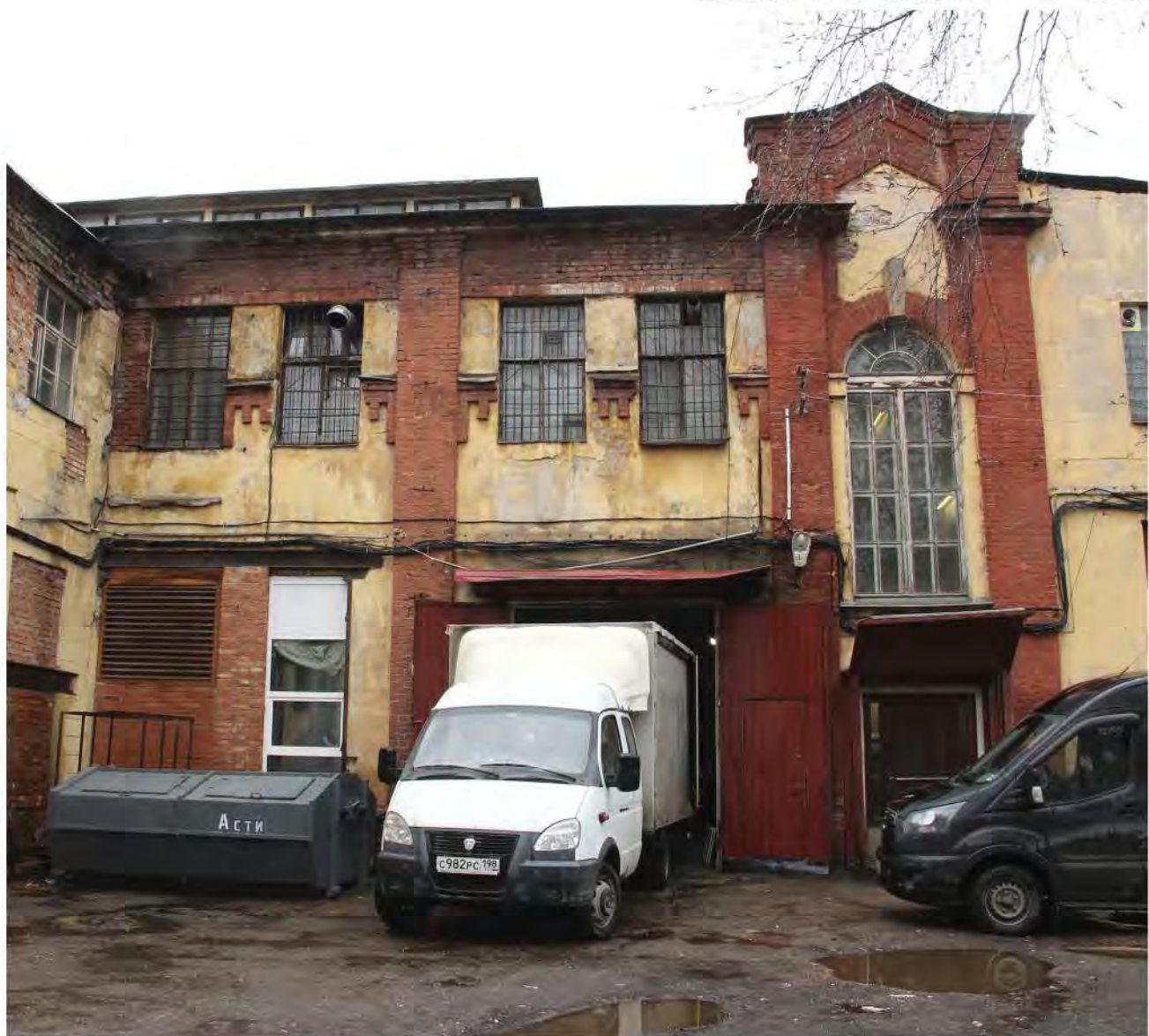
Фотография 33. Выявленный объект культурного наследия «Комплекс построек Кожевенного завода Товарищества "И. А. Осипов и Ко"». Адрес: Санкт-Петербург, переулок Декабристов, дом 7, литера К. Фрагмент дворового фасада с южной стороны. Дата фотофиксации 18.04.2024 г.
