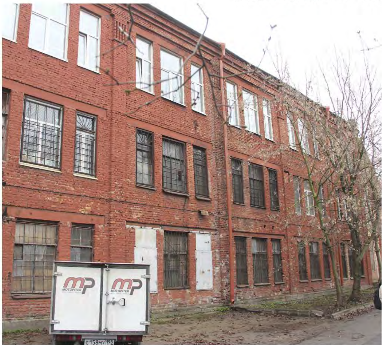
Фотография 29. Выявленный объект культурного наследия «Комплекс построек Кожевенного завода Товарищества "И. А. Осипов и Ко"». Адрес: Санкт-Петербург, переулок Декабристов, дом 7, литера К. Фрагмент фасада с западной стороны. Дата фотофиксации 18.04.2024 г.
