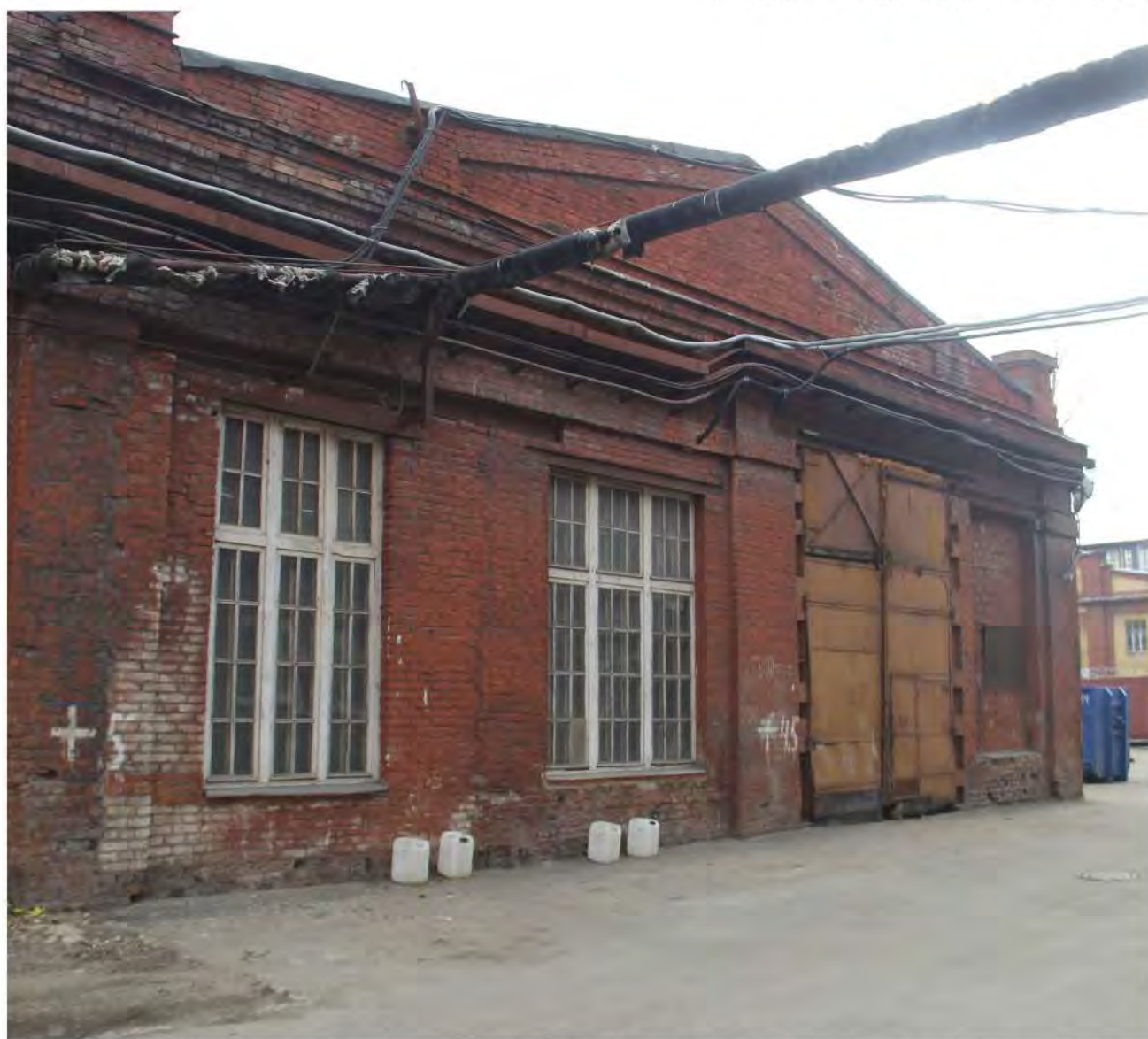
Фотография 9. Выявленный объект культурного наследия «Комплекс построек Кожевенного завода Товарищества "И. А. Осипов и Ко"». Адрес: Санкт-Петербург, переулок Декабристов, дом 7, литера Т. Фрагмент фасада с западной стороны. Дата фотофиксации 18.04.2024 г.
