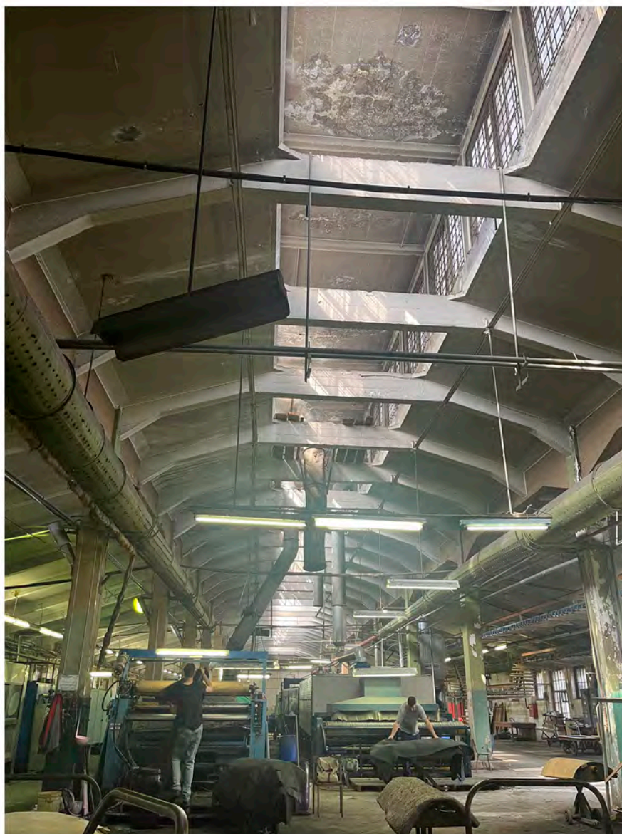
Фотография 79. Выявленный объект культурного наследия «Комплекс построек Кожевенного завода Товарищества "И. А. Осипов и Ко"». Адрес: Санкт-Петербург, переулок Декабристов, дом 7, литера К. Вид на световой фонарь Дата фотофиксации 18.04.2024 г.
