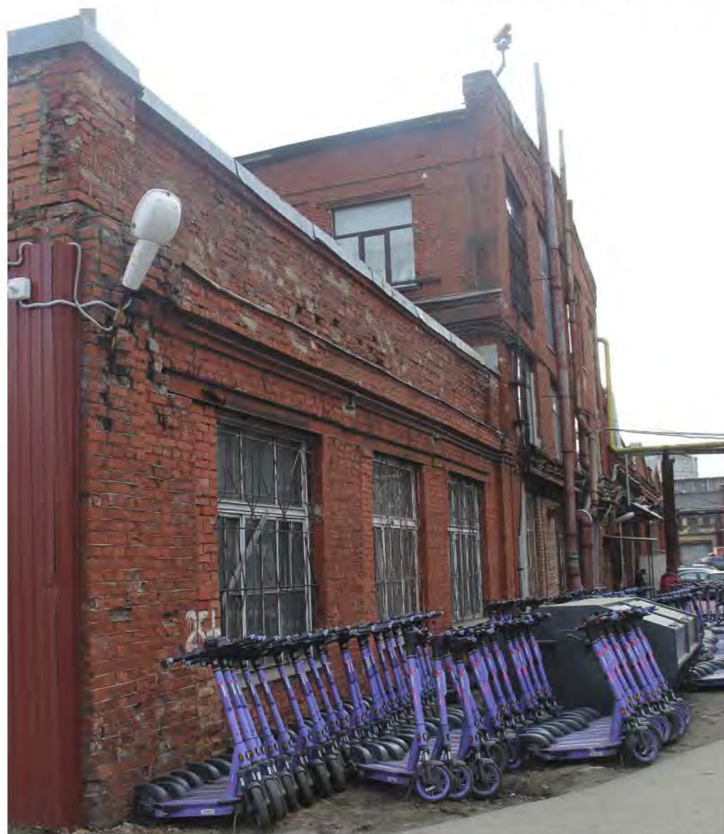
Фотография 6. Выявленный объект культурного наследия «Комплекс построек Кожевенного завода Товарищества "И. А. Осипов и Ко"». Адрес: Санкт-Петербург, переулок Декабристов, дом 7, литера Т. Фрагмент фасада с западной стороны. Дата фотофиксации 18.04.2024 г.
