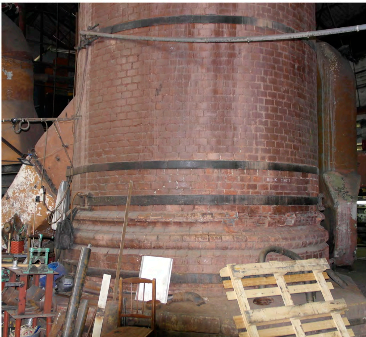
Фотография 86. Выявленный объект культурного наследия «Комплекс построек Кожевенного завода Товарищества "И. А. Осипов и Ко"». Адрес: Санкт-Петербург, переулок Декабристов, дом 7, литера С. Вид на трубу. Дата фотофиксации 18.04.2024 г.
