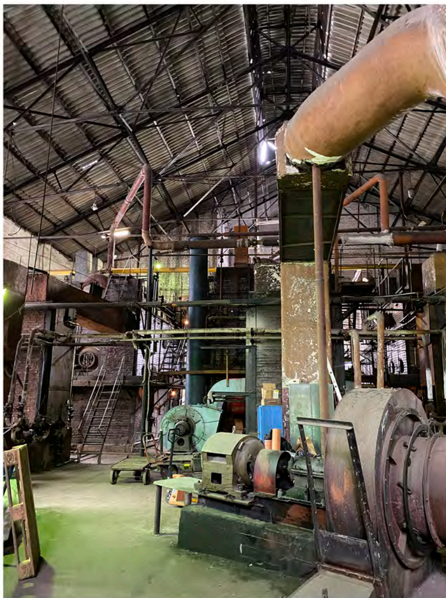
Фотография 83. Выявленный объект культурного наследия «Комплекс построек Кожевенного завода Товарищества "И. А. Осипов и Ко"». Адрес: Санкт-Петербург, переулок Декабристов, дом 7, литера С. Вид на конструкции кровли. Дата фотофиксации 18.04.2024 г.
