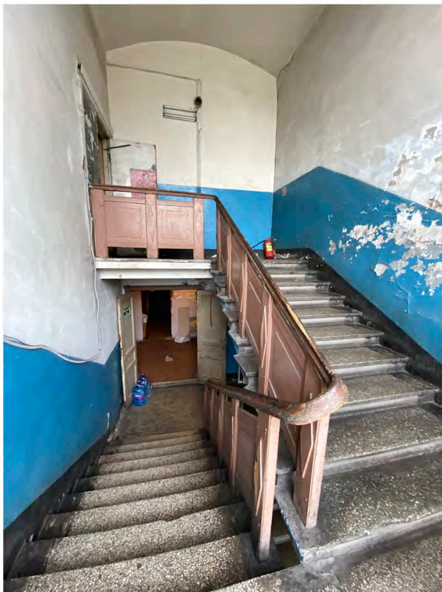
Фотография 53. Выявленный объект культурного наследия «Комплекс построек Кожевенного завода Товарищества "И. А. Осипов и Ко"». Адрес: Санкт-Петербург, переулок Декабристов, дом 7, литера Т. Вид на лестничный пролет, 3-ий этаж. Дата фотофиксации 18.04.2024 г.
