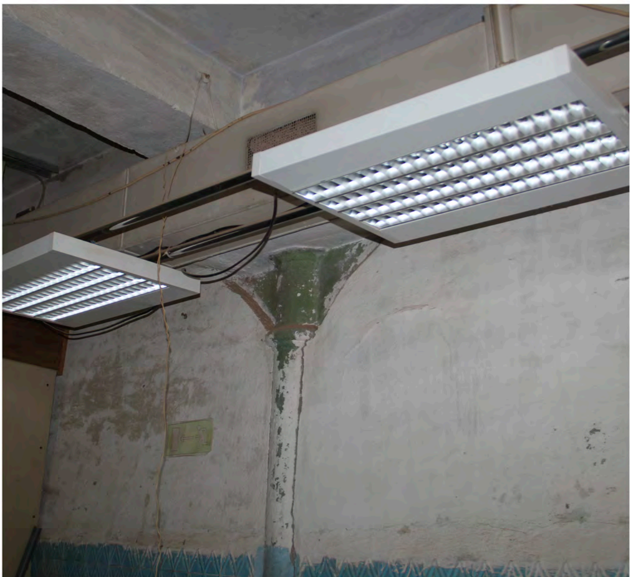
Фотография 71. Выявленный объект культурного наследия «Комплекс построек Кожевенного завода Товарищества "И. А. Осипов и Ко"». Адрес: Санкт-Петербург, переулок Декабристов, дом 7, литера Т. Вид на металлическую колонну, 3-ий этаж. Дата фотофиксации 18.04.2024 г.
