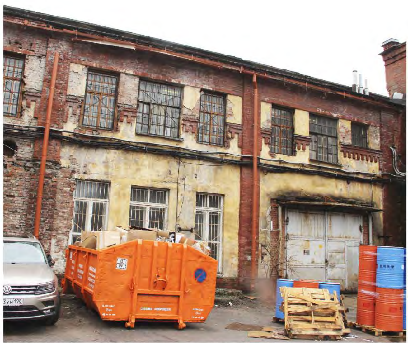
Фотография 38. Выявленный объект культурного наследия «Комплекс построек Кожевенного завода Товарищества "И. А. Осипов и Ко"». Адрес: Санкт-Петербург, переулок Декабристов, дом 7, литера К. Фрагмент фасада с северной стороны. Дата фотофиксации 18.04.2024 г.
