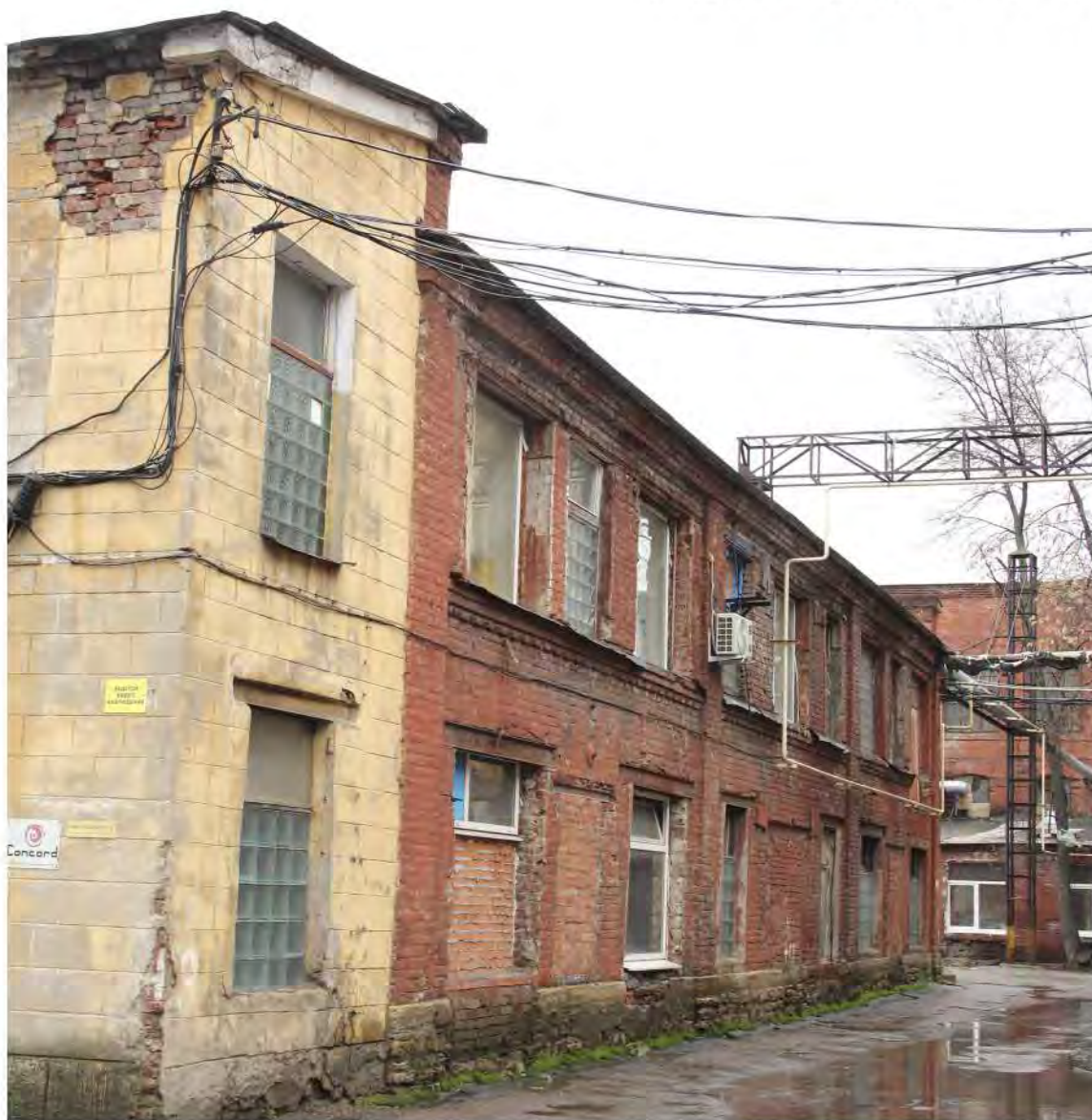
Фотография 34. Выявленный объект культурного наследия «Комплекс построек Кожевенного завода Товарищества "И. А. Осипов и Ко"». Адрес: Санкт-Петербург, переулок Декабристов, дом 7, литера К. Фрагмент дворового фасада с восточной стороны. Дата фотофиксации 18.04.2024 г.
