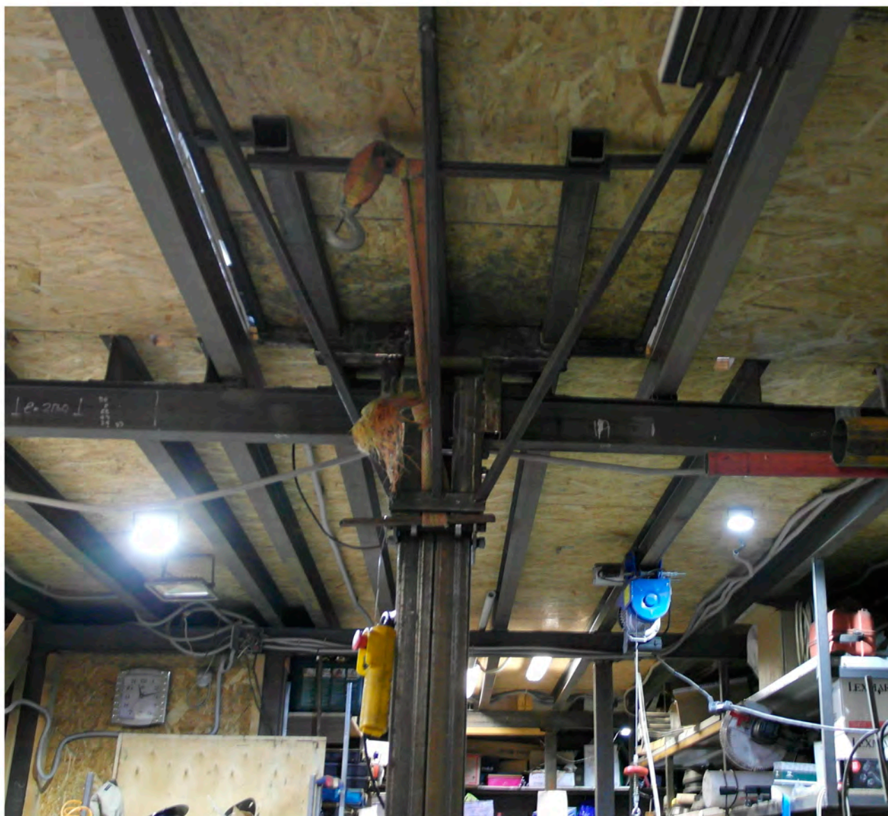
Фотография 48. Выявленный объект культурного наследия «Комплекс построек Кожевенного завода Товарищества «И. А. Осипов и Ко»». Адрес: Санкт-Петербург, переулок Декабристов, дом 7, литера Т. Вид на металлический каркас. Дата фотофиксации 18.04.2024 г.
