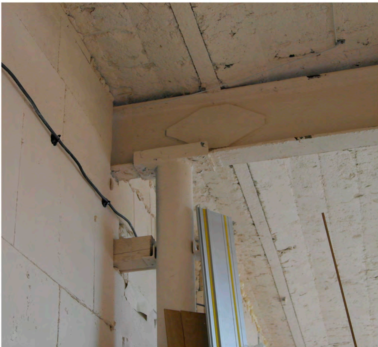
Фотография 67. Выявленный объект культурного наследия «Комплекс построек Кожевенного завода Товарищества "И. А. Осипов и Ко"». Адрес: Санкт-Петербург, переулок Декабристов, дом 7, литера Т. Вид на колонну, 2-ой этаж. Дата фотофиксации 18.04.2024 г.
