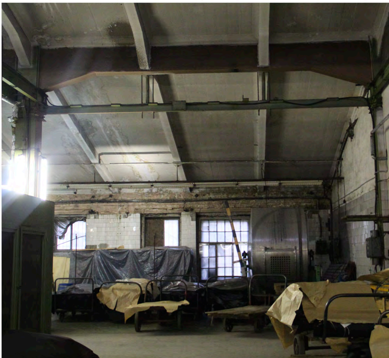
Фотография 80. Выявленный объект культурного наследия «Комплекс построек Кожевенного завода Товарищества «И. А. Осипов и Ко»». Адрес: Санкт-Петербург, переулок Декабристов, дом 7, литера К. Вид на конструкции кровли. Дата фотофиксации 18.04.2024 г.
