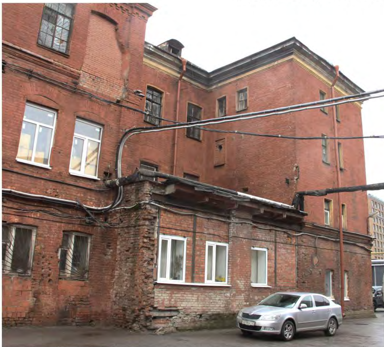
Фотография 43. Выявленный объект культурного наследия «Комплекс построек Кожевенного завода Товарищества "И. А. Осипов и Ко"». Адрес: Санкт-Петербург, переулок Декабристов, дом 7, литера К. Фрагмент фасада с восточной стороны. Дата фотофиксации 18.04.2024 г.
