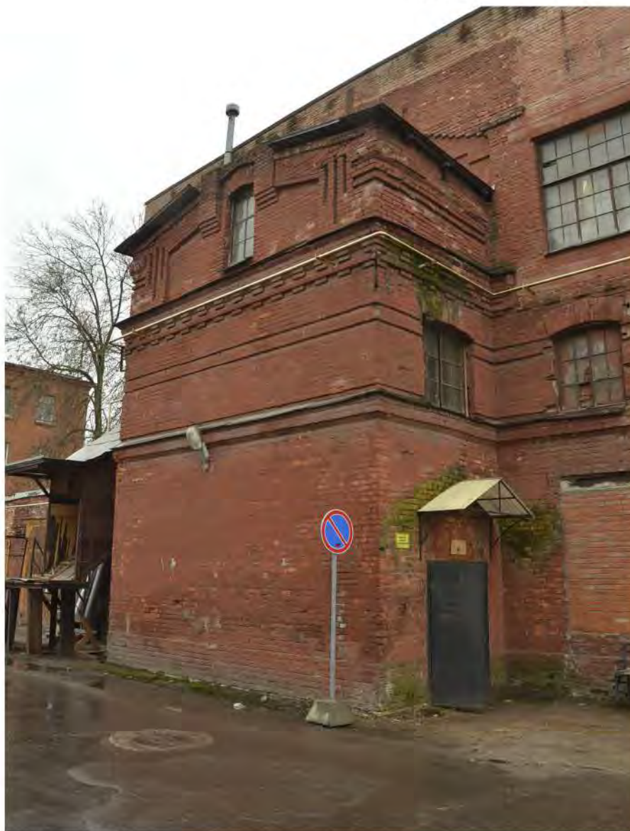
Фотография 15. Выявленный объект культурного наследия «Комплекс построек Кожевенного завода Товарищества "И. А. Осипов и Ко"». Адрес: Санкт-Петербург, переулок Декабристов, дом 7, литера Т. Фрагмент фасада с восточной стороны. Дата фотофиксации 18.04.2024 г.
