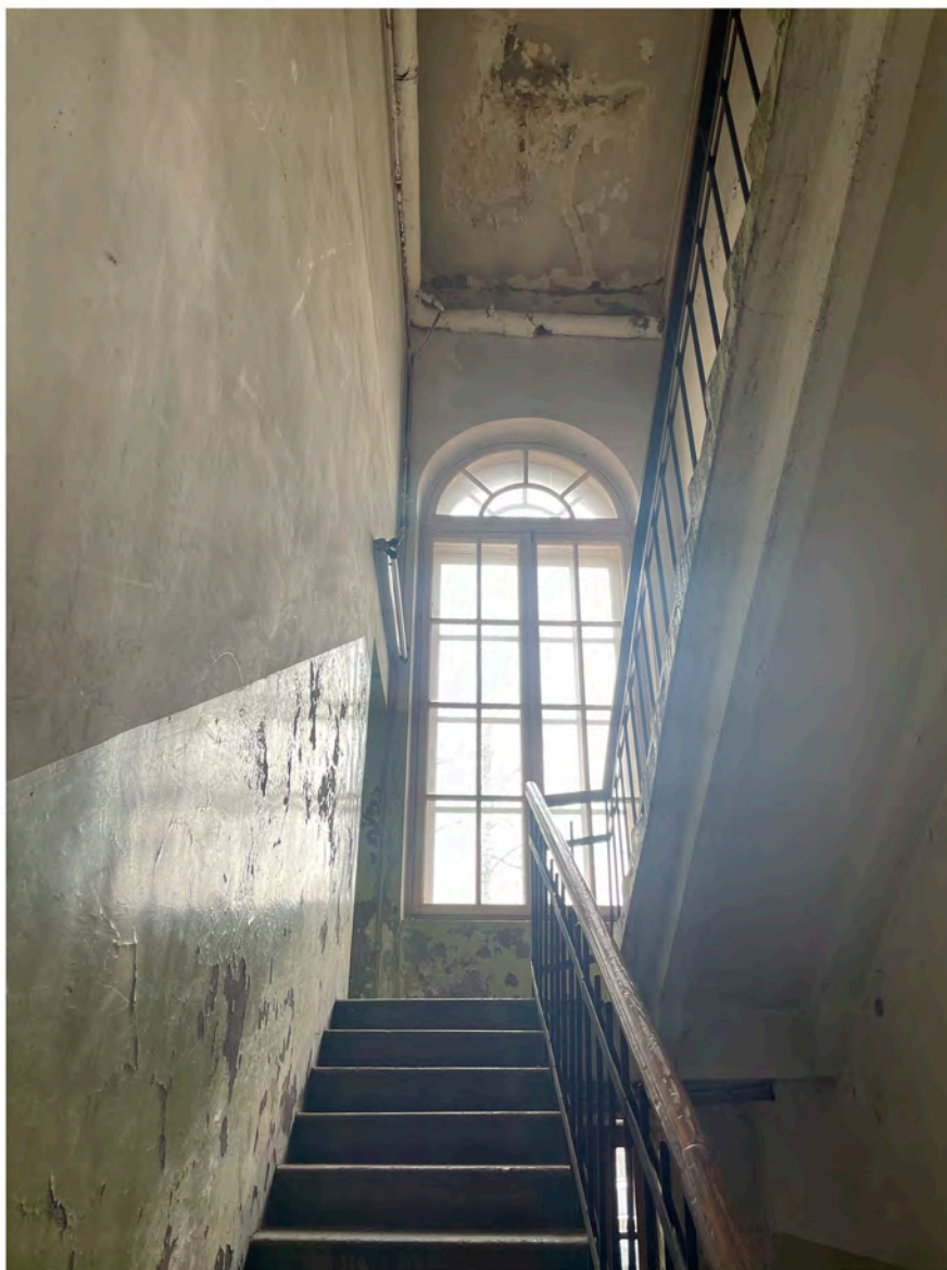
Фотография 81. Выявленный объект культурного наследия «Комплекс построек Кожевенного завода Товарищества "И. А. Осипов и Ко"». Адрес: Санкт-Петербург, переулок Декабристов, дом 7, литера К. Вид на лестничный пролет. Дата фотофиксации 18.04.2024 г.
