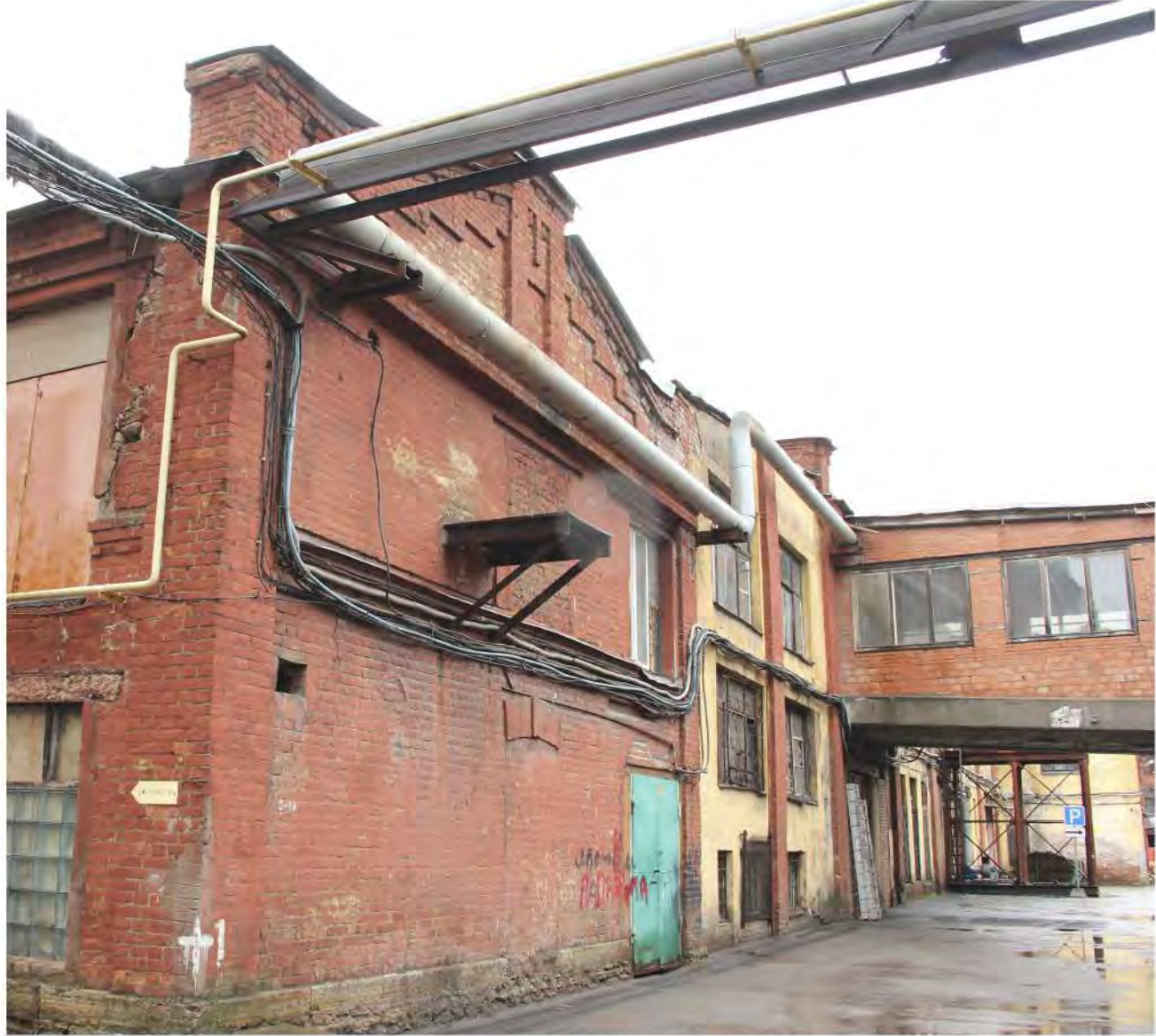
Фотография 35. Выявленный объект культурного наследия «Комплекс построек Кожевенного завода Товарищества "И. А. Осипов и Ко"». Адрес: Санкт-Петербург, переулок Декабристов, дом 7, литера К. Фрагмент фасада с северной стороны. Дата фотофиксации 18.04.2024 г.
