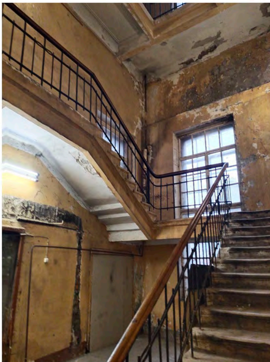
Фотография 76. Выявленный объект культурного наследия «Комплекс построек Кожевенного завода Товарищества “И. А. Осипов и Ко”». Адрес: Санкт-Петербург, переулок Декабристов, дом 7, литера К. Вид на лестничный пролет. Дата фотофиксации 18.04.2024 г.
