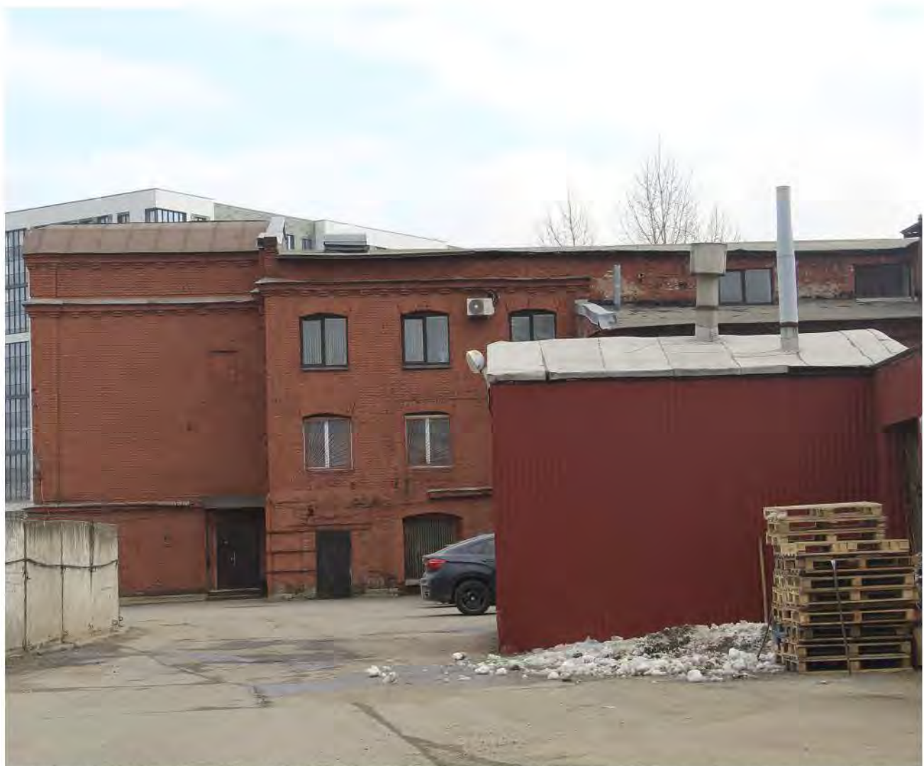
Фотография 5. Выявленный объект культурного наследия «Комплекс построек Кожевенного завода Товарищества «И. А. Осипов и Ко»». Адрес: Санкт-Петербург, переулок Декабристов, дом 7, литера Т. Фрагмент фасада с западной стороны. Дата фотофиксации 18.04.2024 г.
