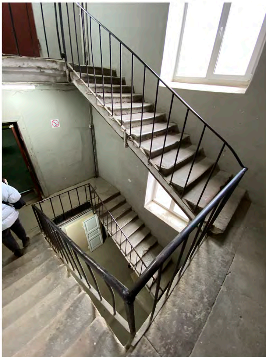
Фотография 66. Выявленный объект культурного наследия «Комплекс построек Кожевенного завода Товарищества "И. А. Осипов и Ко"». Адрес: Санкт-Петербург, переулок Декабристов, дом 7, литера Т. Вид на лестничный пролет, 3-ий этаж. Дата фотофиксации 18.04.2024 г.
