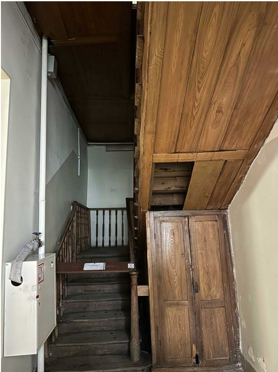
Фото 2. Деревянная лестница. 1 марш
