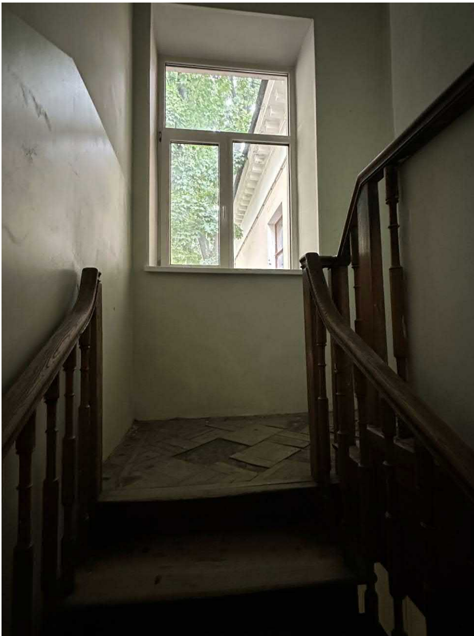
Фото 5. Деревянная лестница. Площадка 2-ого этажа
