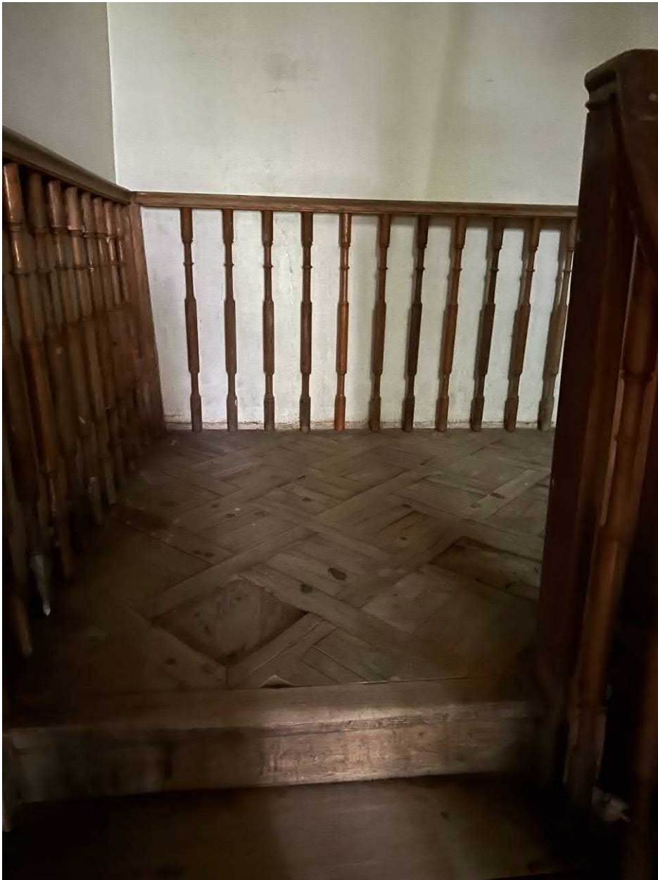
Фото 3. Деревянная лестница. Площадка между 1 и 2 этажом
