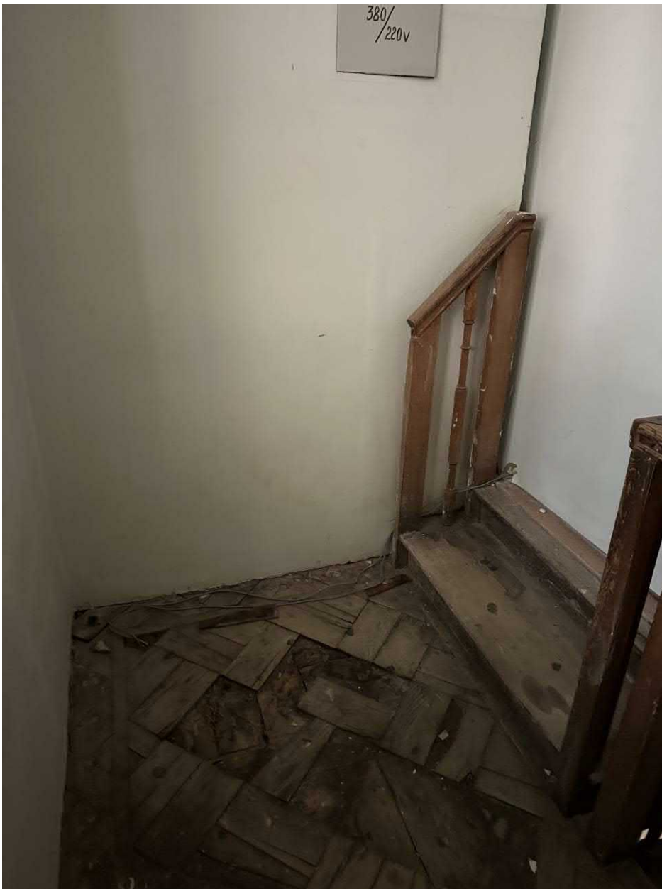
Фото 6. Деревянная лестница. Площадка 2-ого этажа
