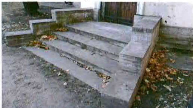
4. Крыльцо со стороны восточного фасада
