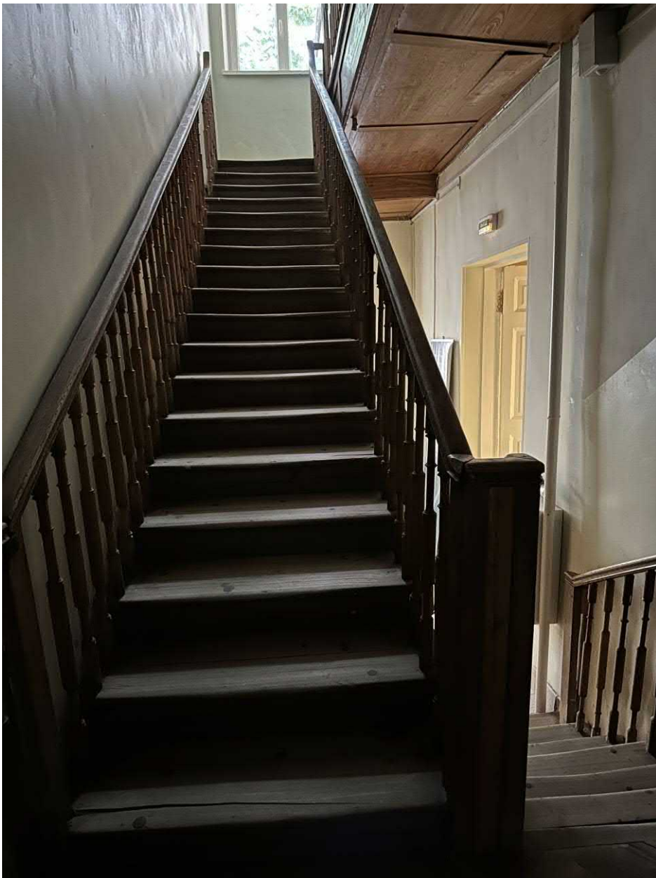
Фото 4. Деревянная лестница. 2 марш
