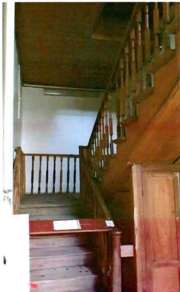
14. Деревянная лестница в северо-западной части здания
