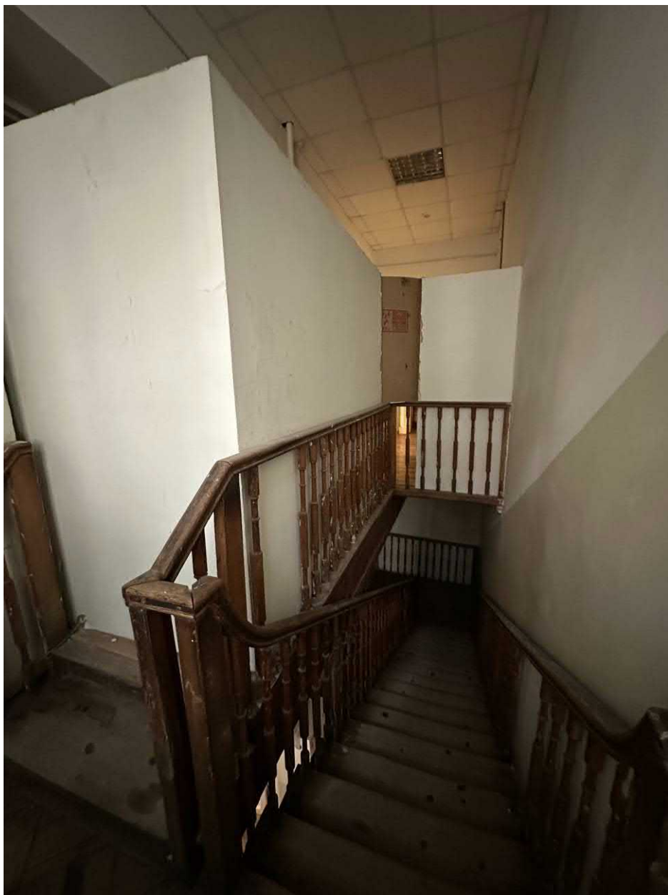
Фото 7. Деревянная лестница. Площадка 2-ого этажа
