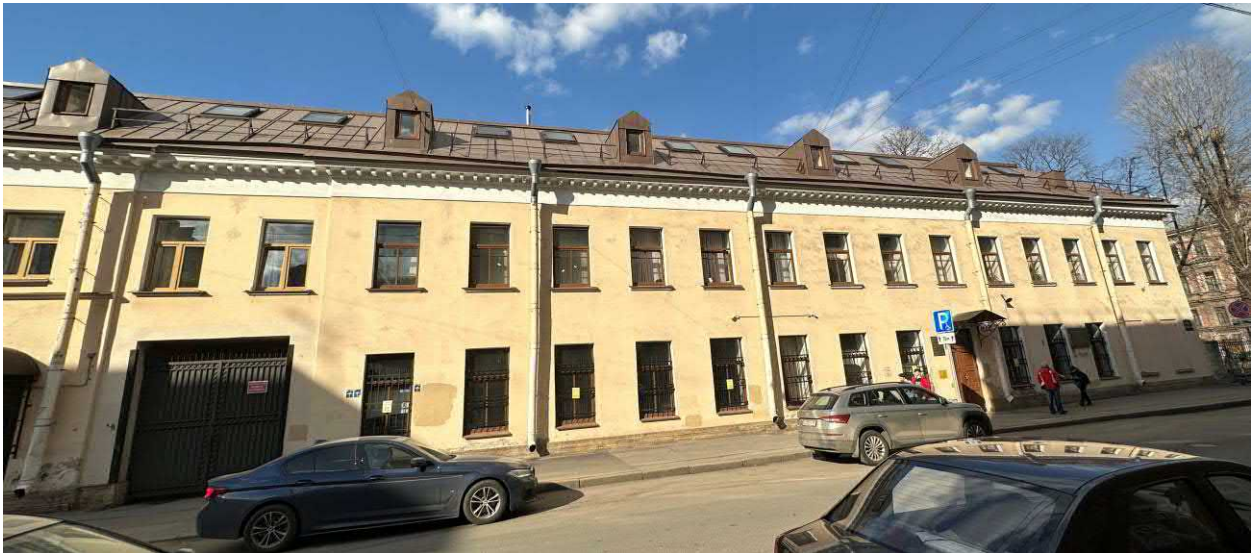
Фото 1. Общий вид здания
