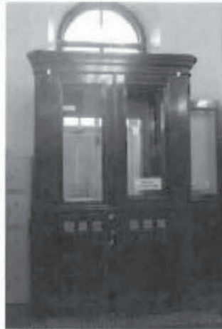
3. Тамбур главного входа.
