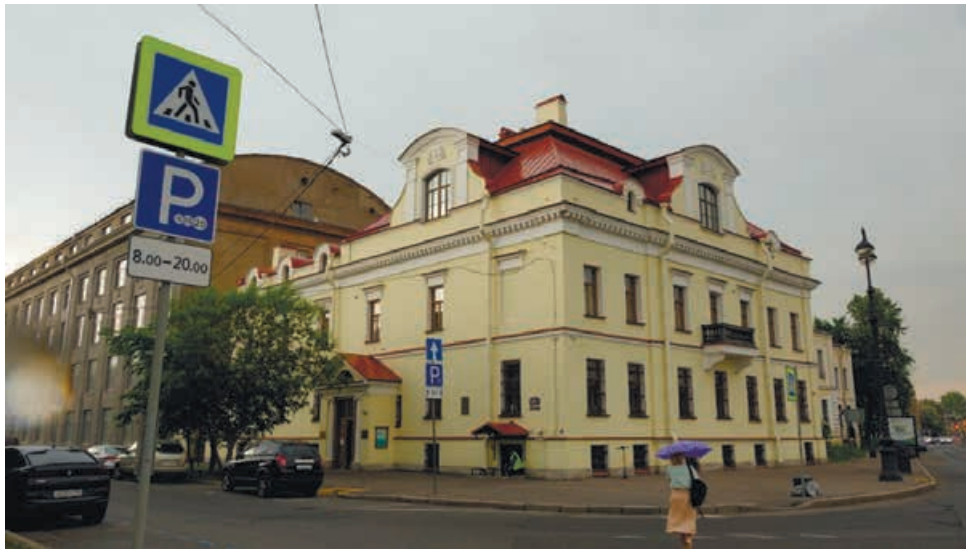
Фото 1. Лицевой и боковой фасады особняка М.П. Боткина. Общий вид. Дата фотофиксации: 15.05.2024
