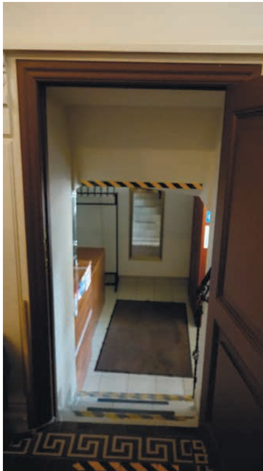
Фото 5. Вход в помещение 8. Общий вид. Дата фотофиксации: 15.05.2024
