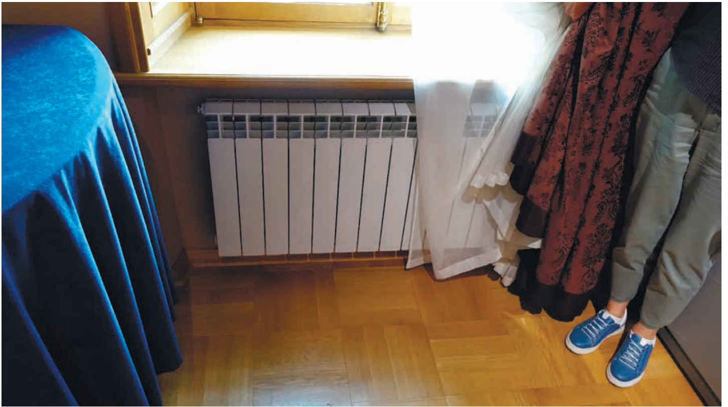
Фото 33. Секционный радиатор в помещении 115. Фрагмент. Дата фотофиксации: 15.05.2024
