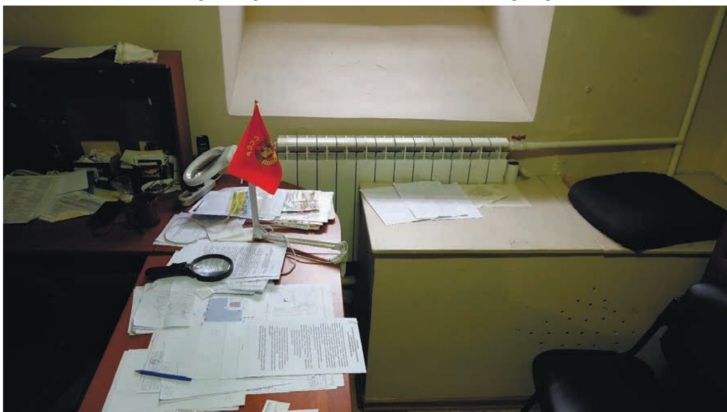
Фото 22. Секционный радиатор в помещении 9. Общий вид. Дата фотофиксации: 15.05.2024
