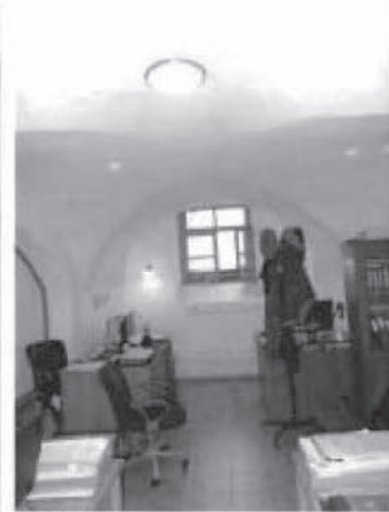
4. Свод цокольного этажа.
