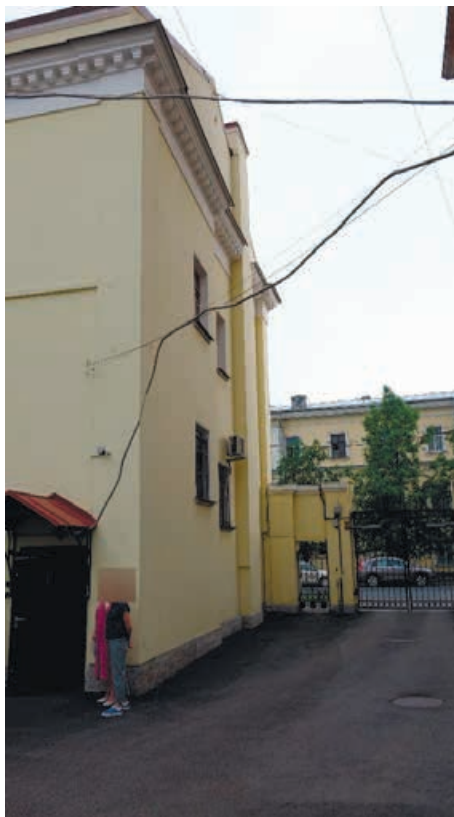
Фото 4. Дворовый фасад особняка М.П. Боткина. Фрагмент прилегающей ограды. Дата фотофиксации: 15.05.2024
