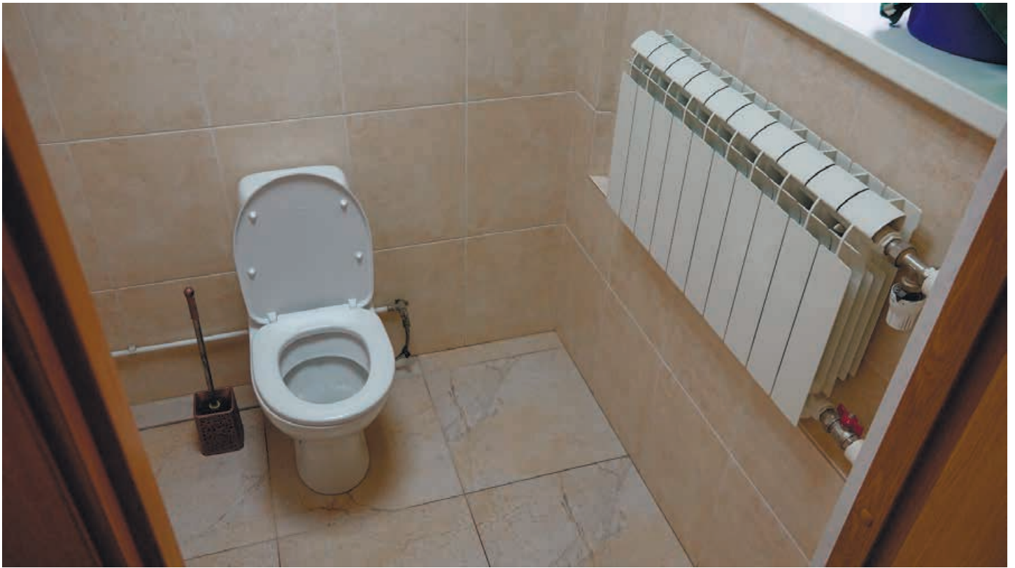
Фото 57. Туалет и секционный радиатор в помещении 205. Дата фотофиксации: 15.05.2024
