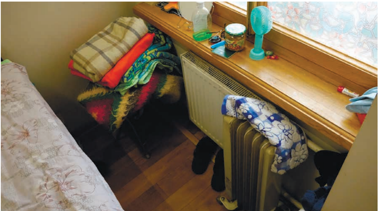
Фото 40. Радиатор в помещении 109. Общий вид. Дата фотофиксации: 15.05.2024
