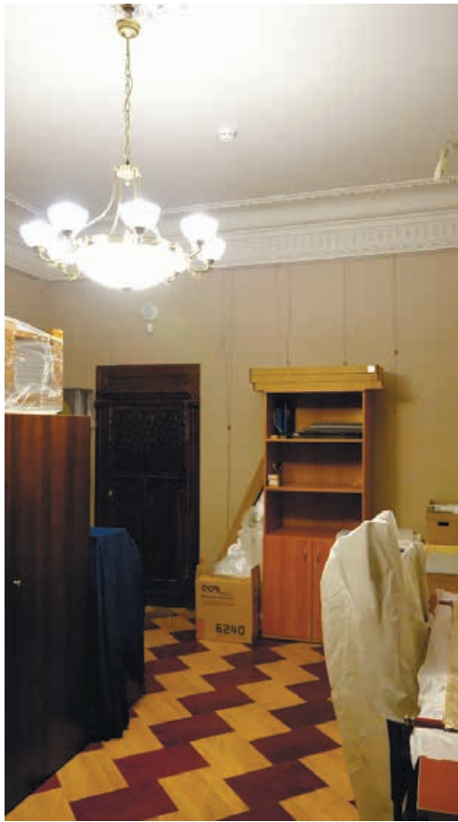
Фото 51. Радиатор за бытовими предметами в помещении 212. Дата фотофиксации: 15.05.2024
