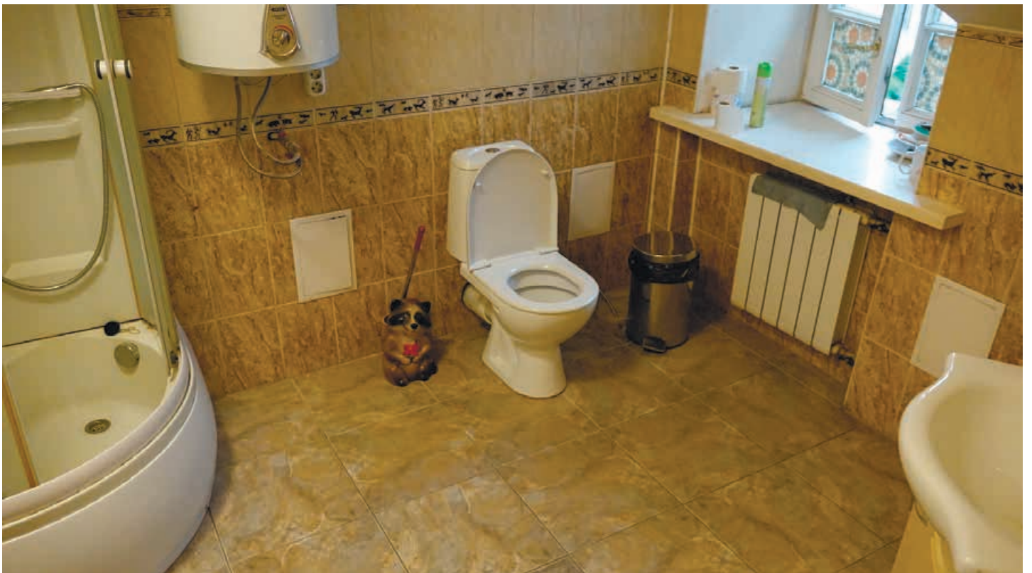
Фото 68. Туалет, секционный радиатор, душевая, накопительный водонагреватель в помещении 305. Дата фотофиксации: 15.05.2024
