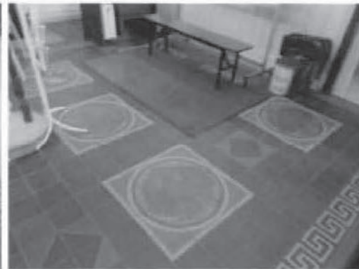
6. Покрытие пола нижнего уровня вестибюля.
