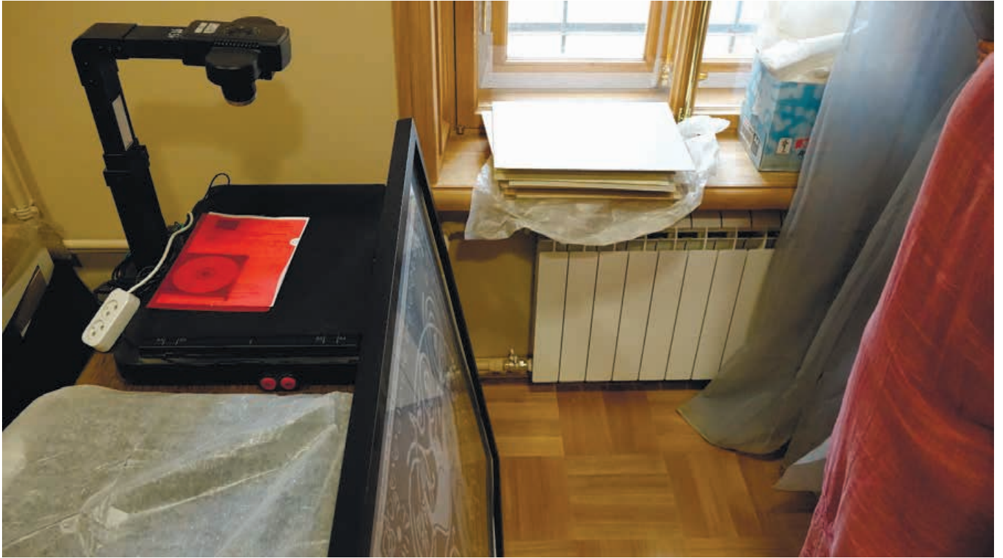
Фото 45. Секционный радиатор помещения 111. Фрагмент. Дата фотофиксации: 15.05.2024
