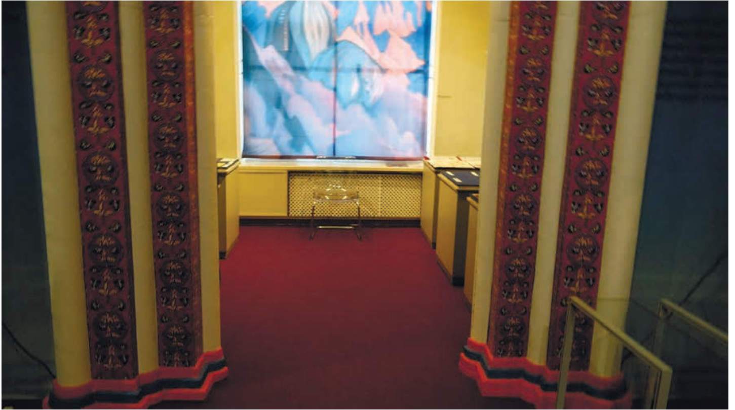
Фото 73. Секционный радиатор за декоративной решёткой в помещении 313. Общий вид. Дата фотофиксации: 15.05.2024
