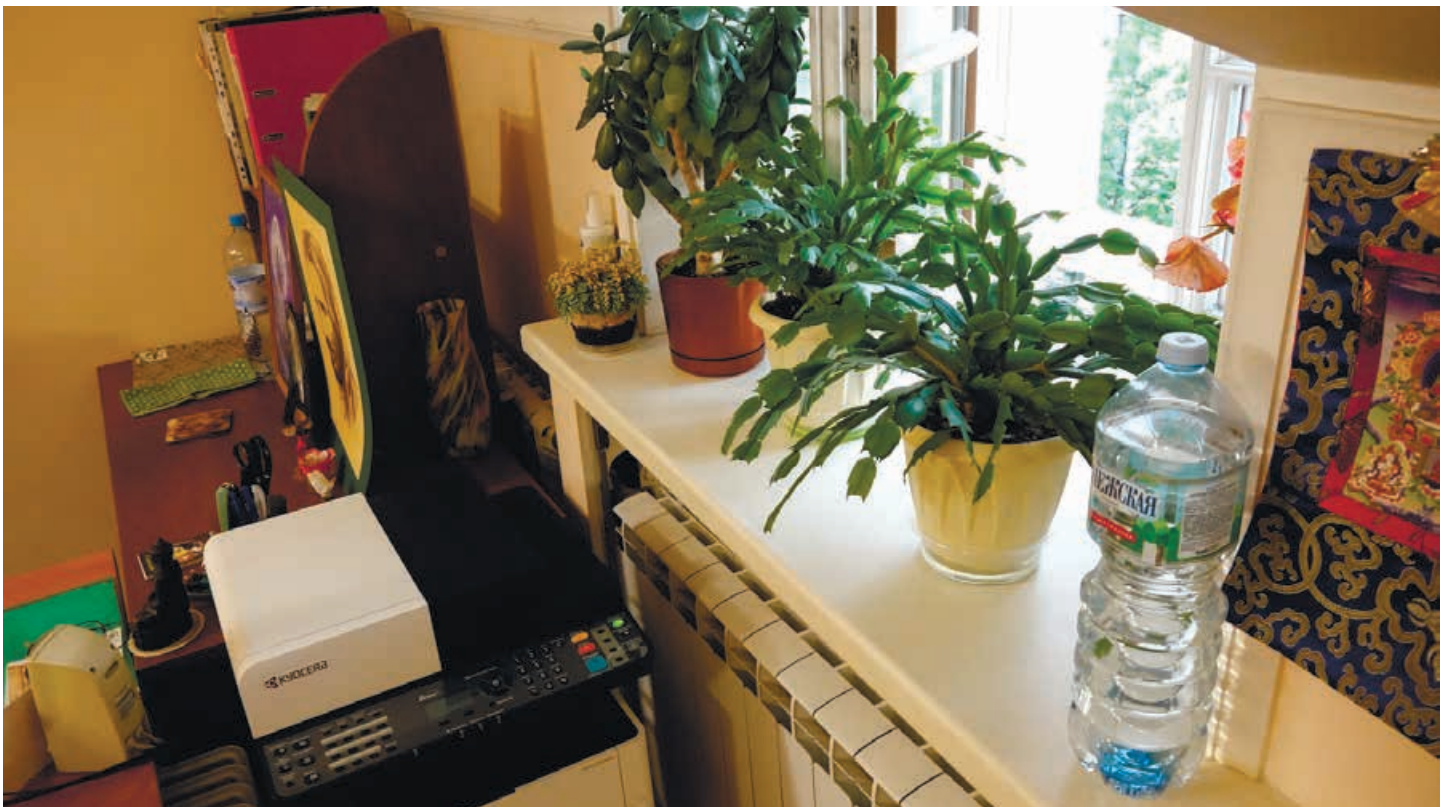
Фото 82. Секционные радиаторы в помещении 303 за бытовыми предметами. Дата фотофиксации: 15.05.2024
