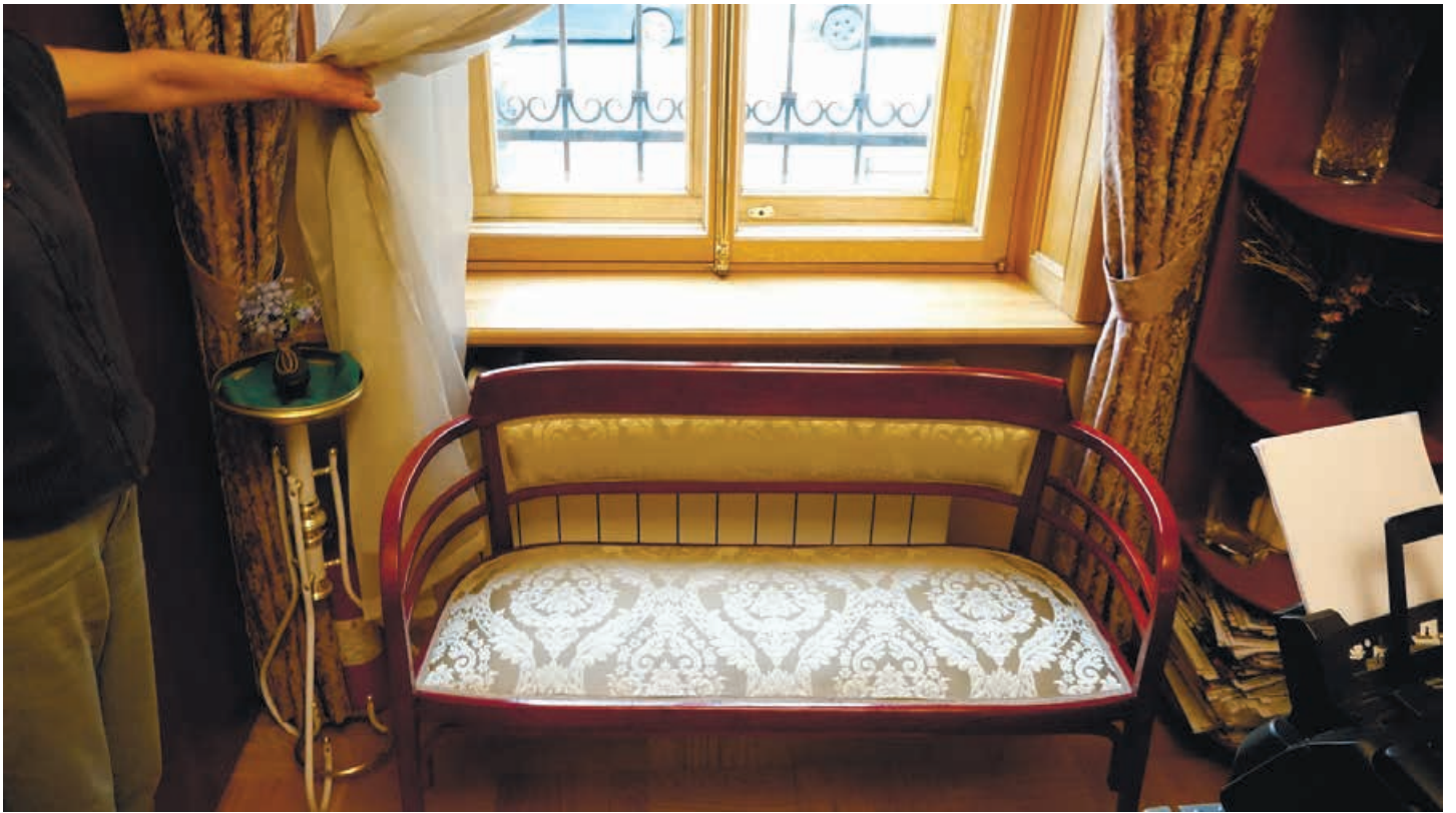
Фото 35. Секционный радиатор в помещении 116. Фрагмент. Дата фотофиксации: 15.05.2024
