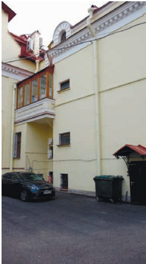
Фото 3. Дворовый фасад особняка М.П. Боткина. Балконные и оконные заполнения. Дата фотофиксации: 15.05.2024
