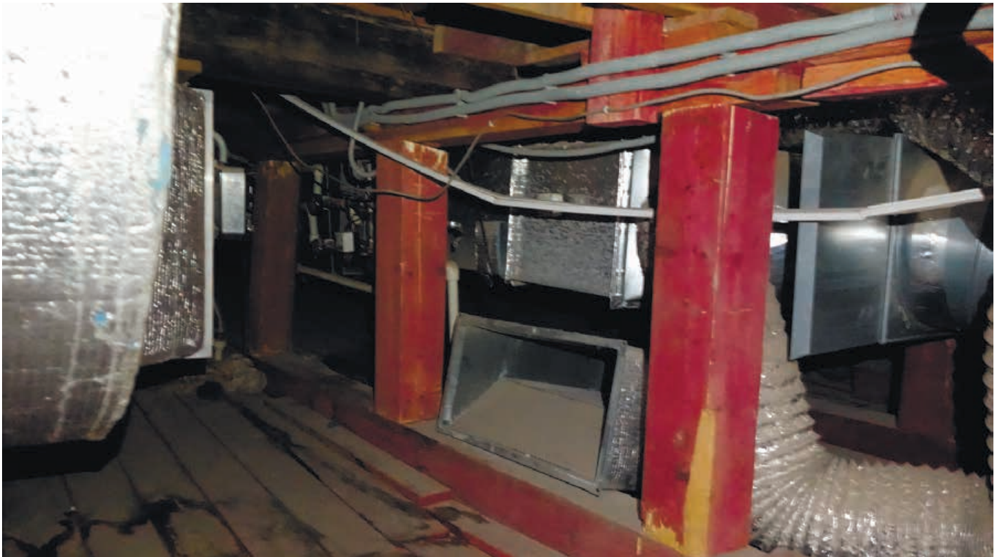
Фото 70. Вентиляционный спуск в помещении 307. Трубопроводная магистраль за системой вентиляции. Дата фотофиксации: 15.05.2024
