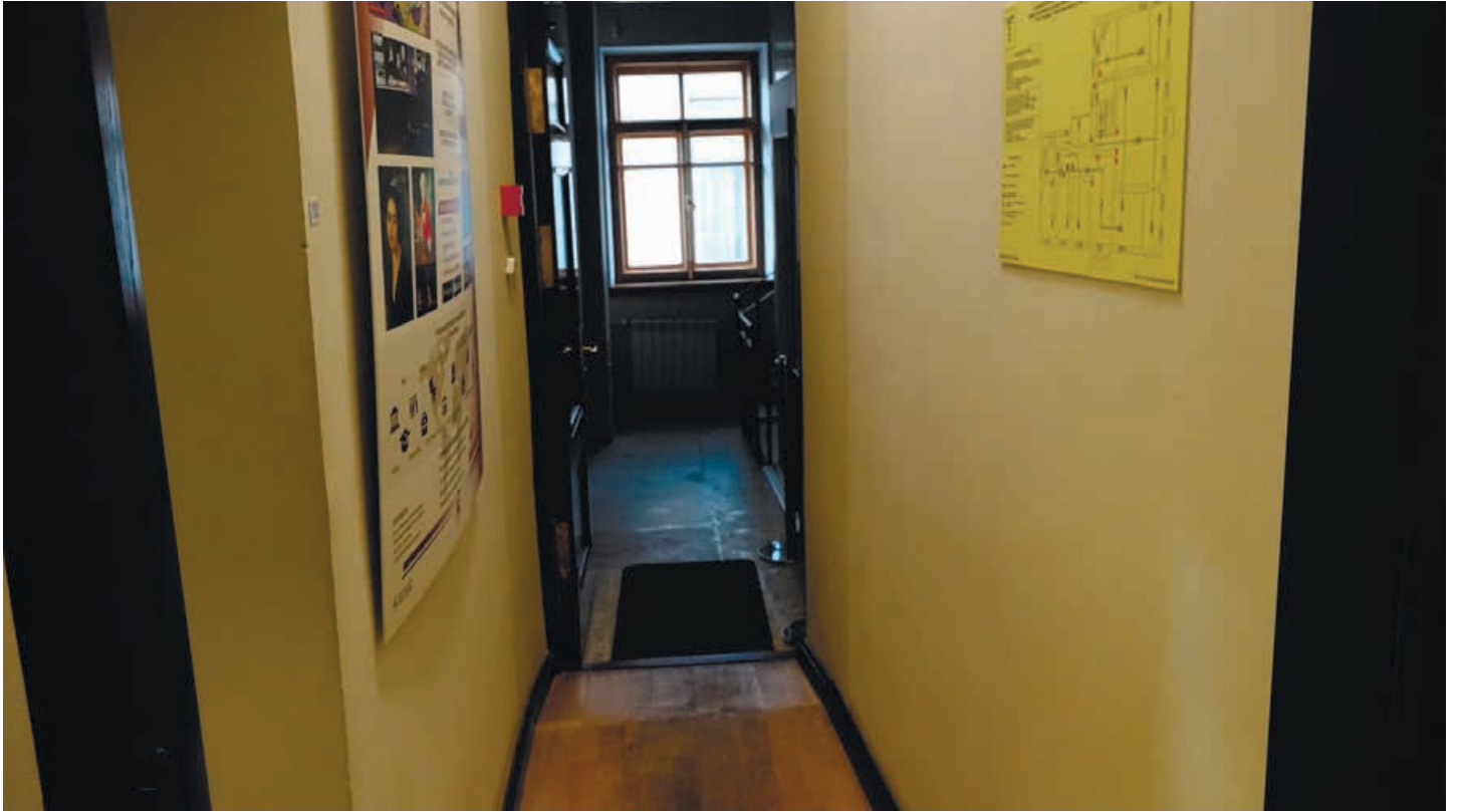
Фото 63. Секционный радиатор в помещении 204. Общий вид. Дата фотофиксации: 15.05.2024
