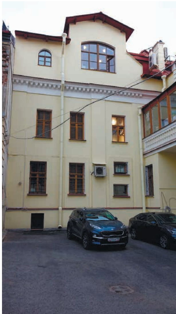
Фото 2. Дворовый фасад особняка М.П. Боткина. Фрагмент. Дата фотофиксации: 15.05.2024
