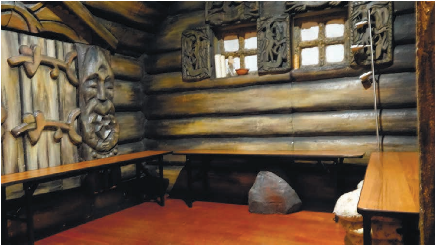
Фото 79. Радиатор за бытовыми предметами в помещении 316. Дата фотофиксации: 15.05.2024
