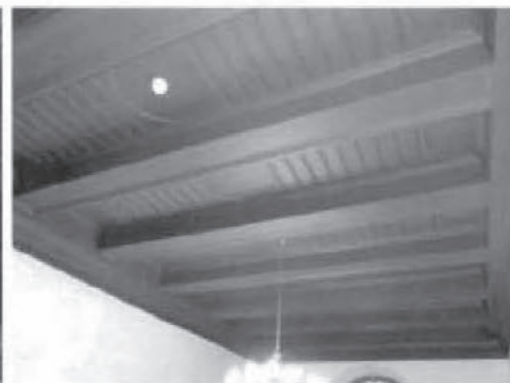
8. Оформление потолка над лестничной клеткой.
