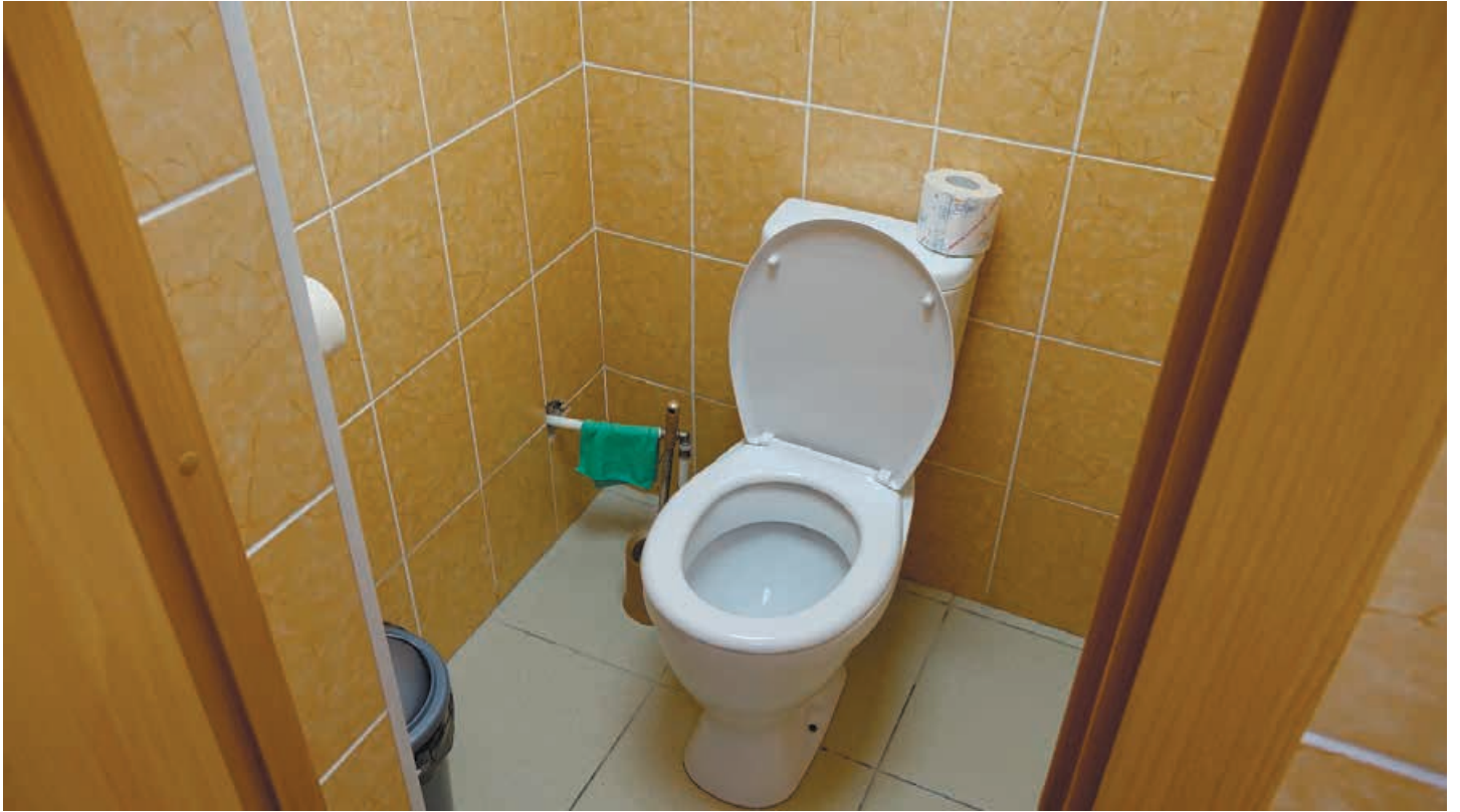
Фото 19. Туалет в помещении 15. Общий вид. Дата фотофиксации: 15.05.2024
