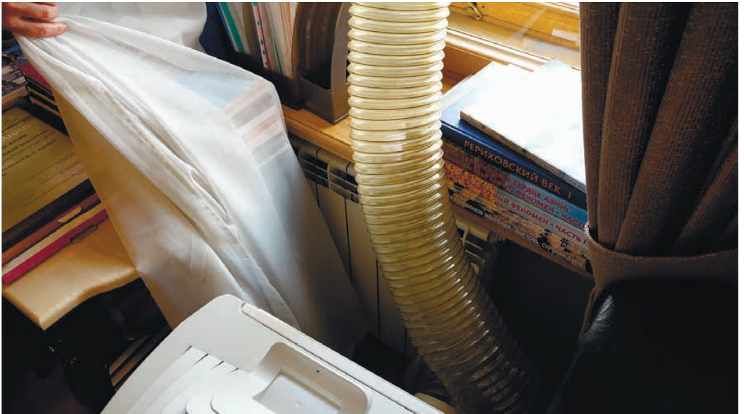
Фото 38. Секционный радиатор в помещении 117. Фрагмент. Дата фотофиксации: 15.05.2024
