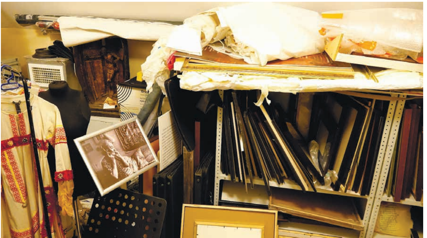
Фото 80. Радиатор за бытовыми предметами в помещении 317. Дата фотофиксации: 15.05.2024
