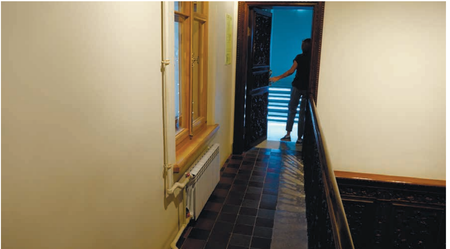
Фото 46. Секционный радиатор в помещении 208. Общий вид. Трубопровод окрашен. Дата фотофиксации: 15.05.2024
