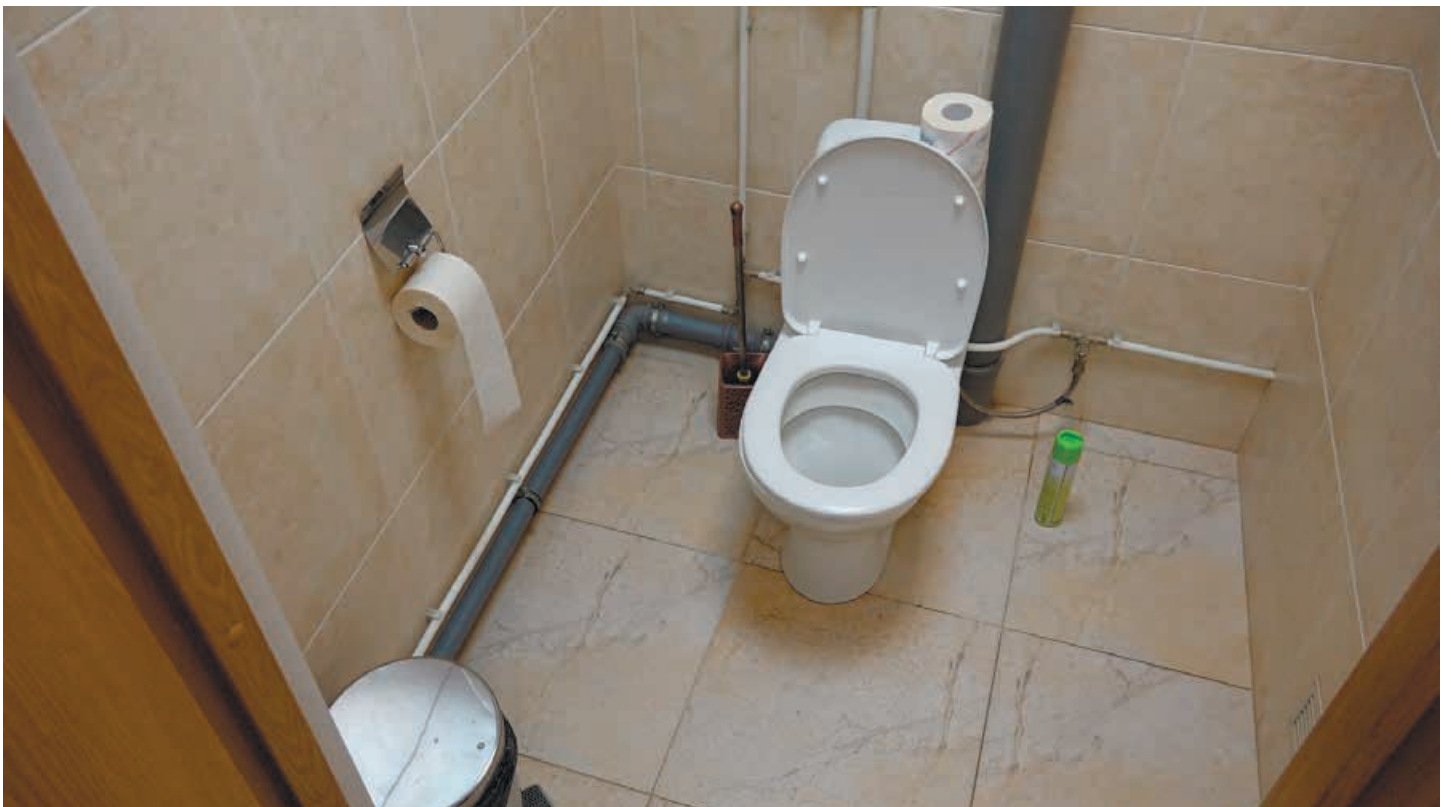
Фото 58. Туалет и трубопровод в помещении 205. Общий вид. Дата фотофиксации: 15.05.2024
