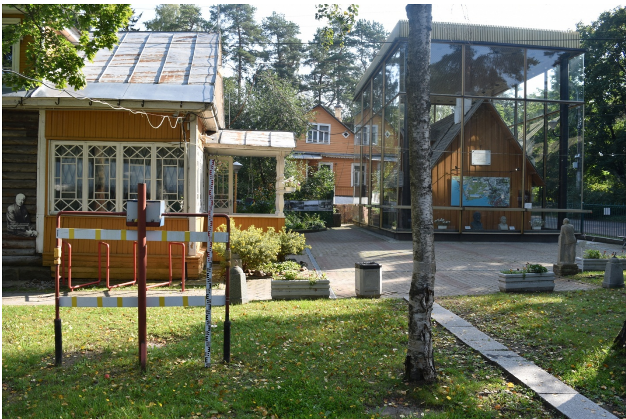
Рис. 29. Санкт-Петербург, Сестрорецк, "Сарай Н.А. Емельянова"-2024. Точка фотофиксации-6. Вид с запада. Для масштаба использована рейка длиной 2 м.
