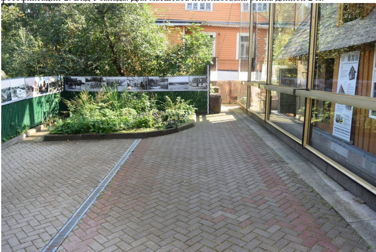
Рис. 24. Санкт-Петербург, Сестрорецк, "Сарай Н.А. Емельянова"-2024. Точка фотофиксации-3. Вид с запада. Для масштаба использована рейка длиной 2 м.
