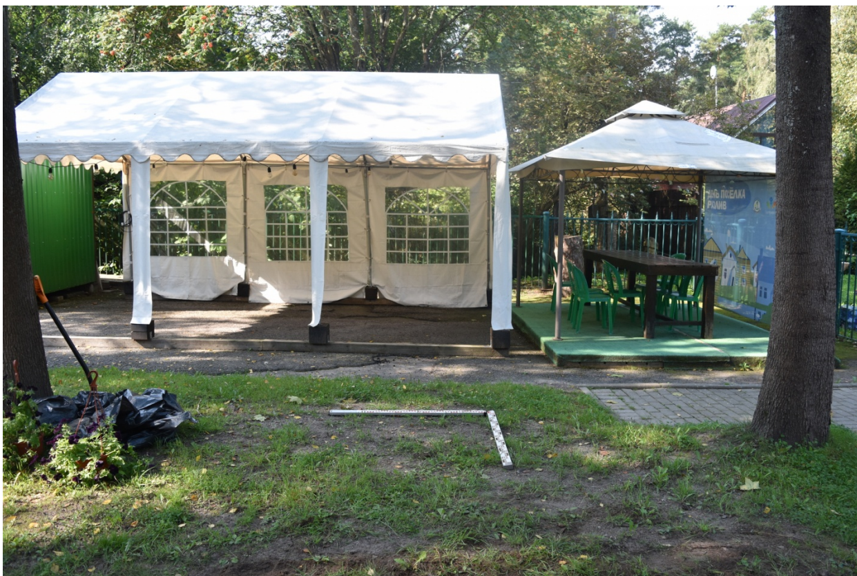
Рис. 31. Санкт-Петербург, Сестрорецк, "Сарай Н.А. Емельянова"-2024. Шурф 1 до начала работ. Вид с востока. Для масштаба использованы рейки длиной 1 м.
