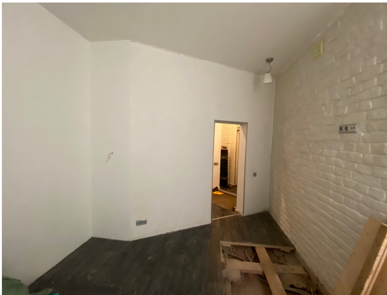
6. Фрагмент интерьера комнаты (помещение 2/24.6);
