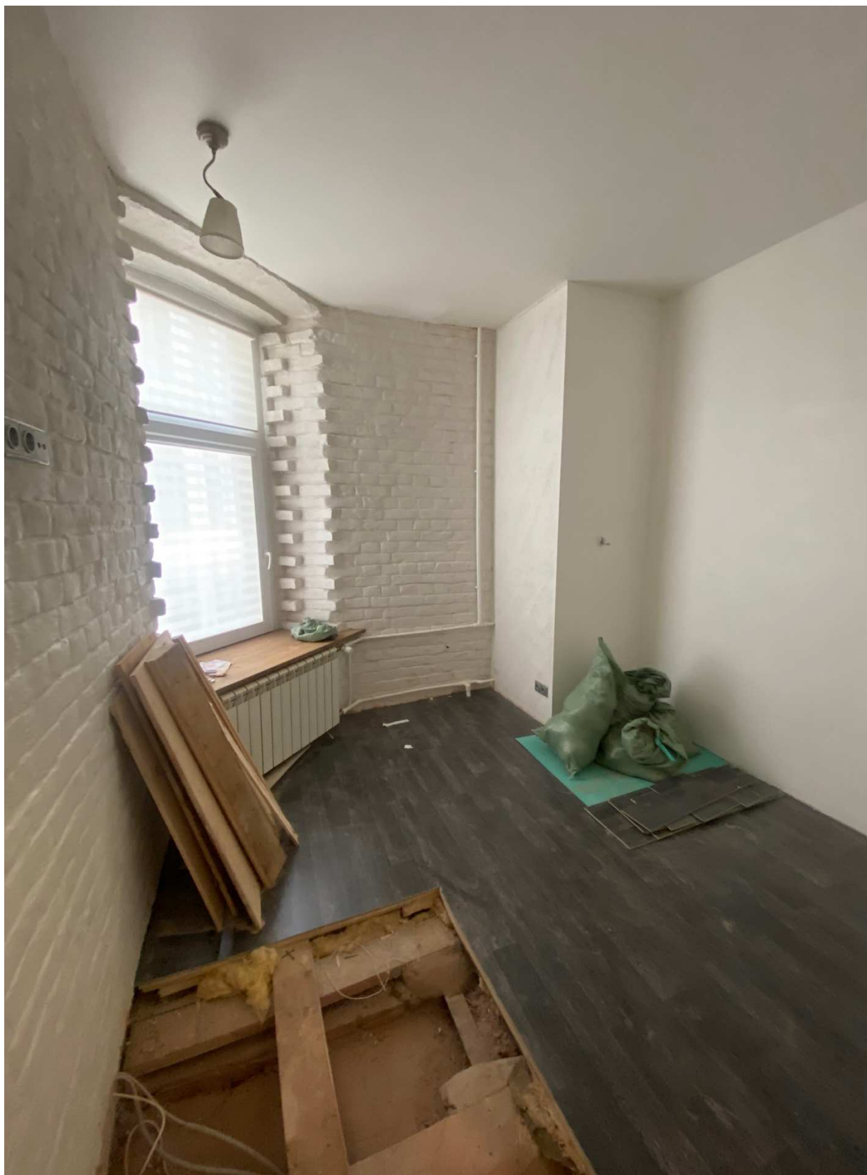
5. Фрагмент интерьера комнаты (помещение 2/24.6);
