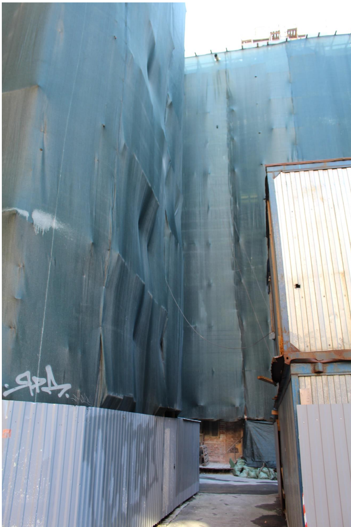
Фото 7. Общий вид дворовых фасадов объекта культурного наследия регионального значения «Дом А.А. Смирнова».
