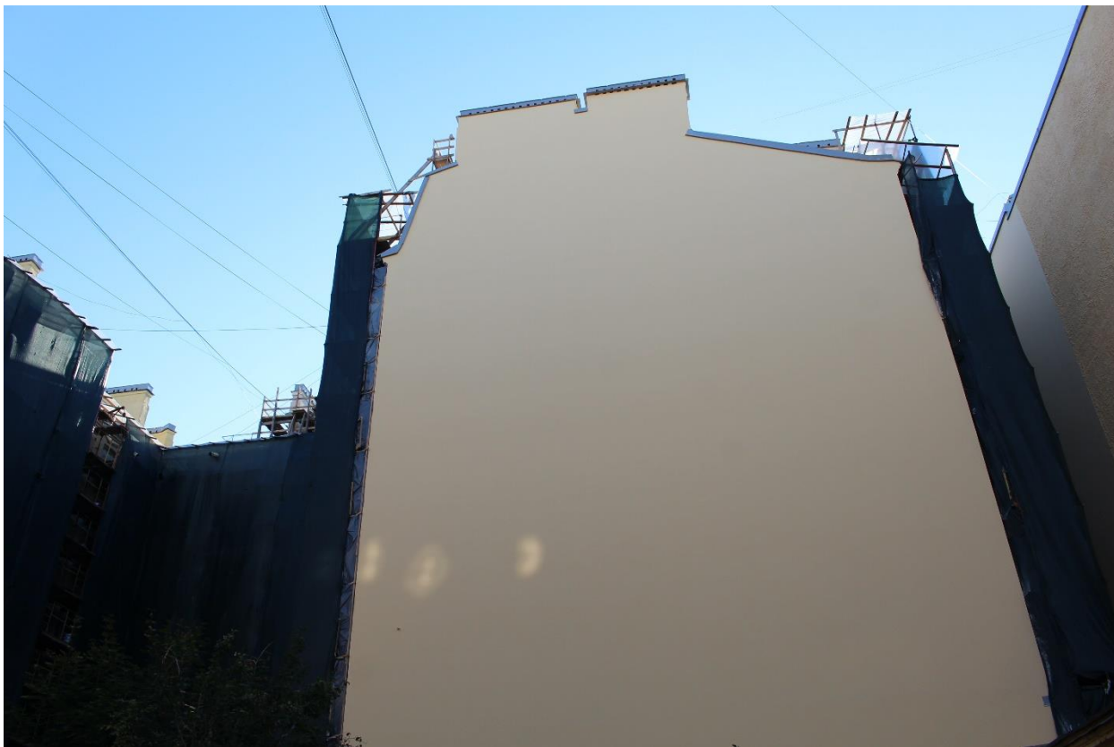
Фото 9. Вид на брандмауэрную стену объекта культурного наследия регионального значения «Дом А.А. Смирнова».
