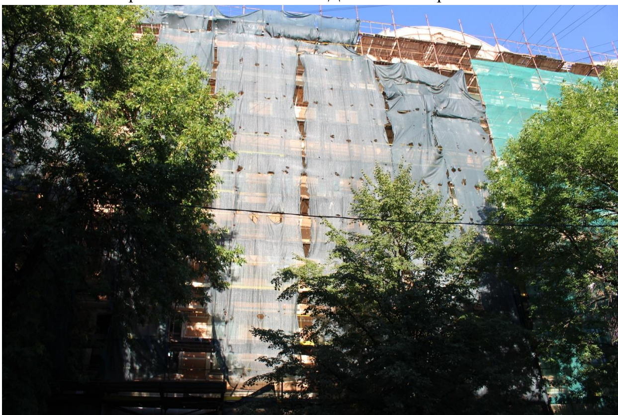
Фото 4. Вид на юго-западный лицевой фасад объекта культурного наследия регионального значения «Дом А.А. Смирнова».
