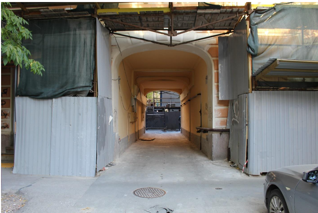
Фото 5. Вид на воротный проезд объекта культурного наследия регионального значения «Дом А.А. Смирнова» со стороны 12-й линии В.О.
