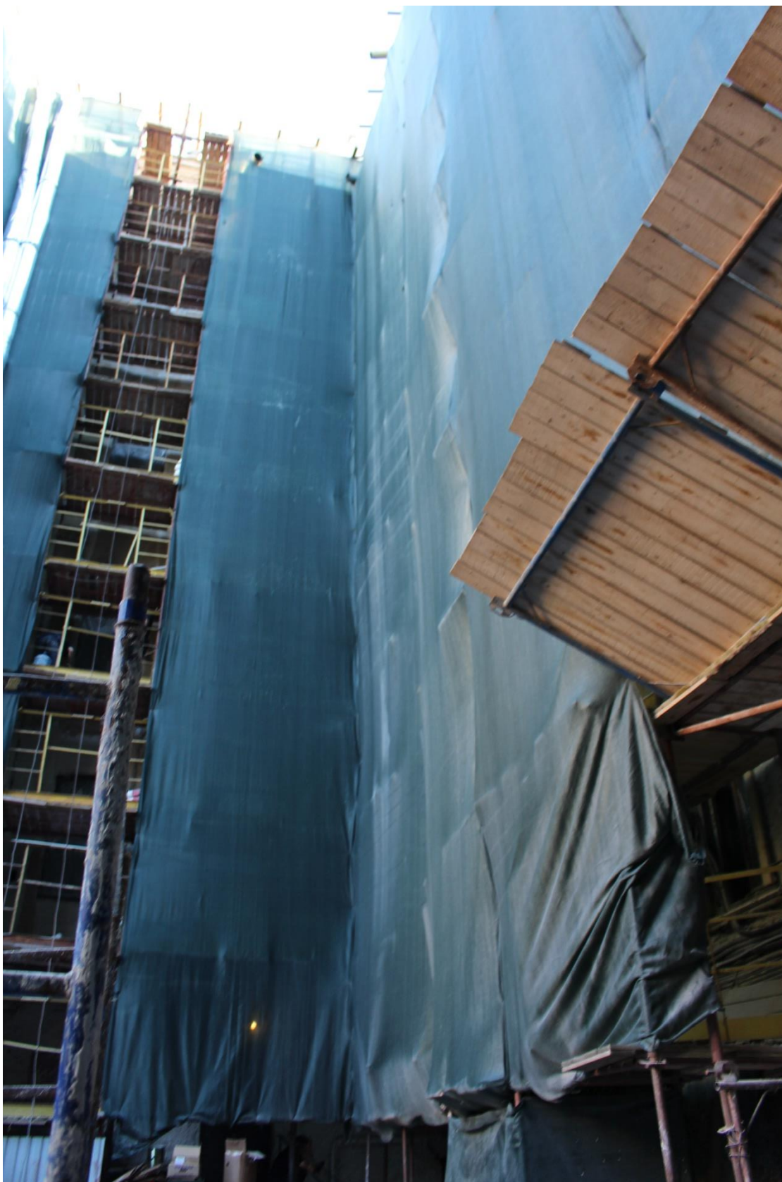
Фото 8. Общий вид дворовых фасадов объекта культурного наследия регионального значения «Дом А.А. Смирнова».
