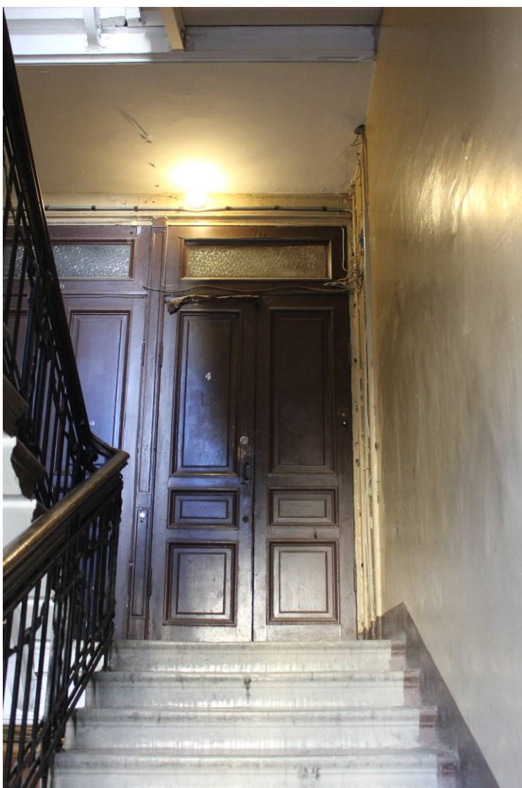
9. Выявленный объект культурного наследия «Дом И.И. Боргмана», по адресу: г. Санкт-Петербург, Съезжинская улица, дом 4, литера А. Общий вид лестничной клетки. Дата фотофиксации: 28 августа 2021 г.
