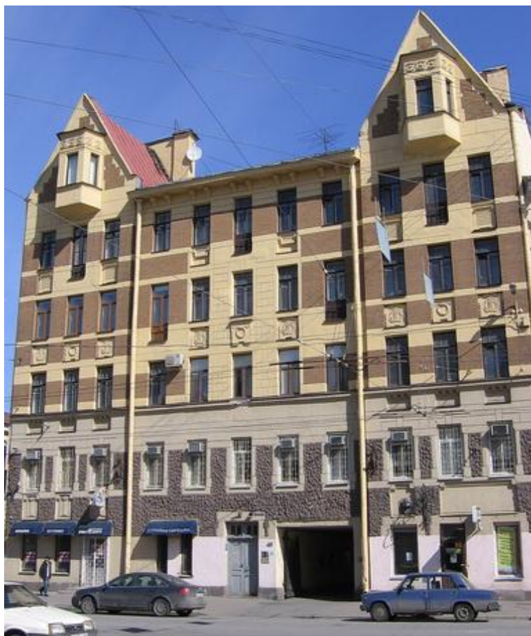
25. Дом И. И. Боргмана. Лицевой фасад. 2019 г. Источник: https://pastvu.com/
