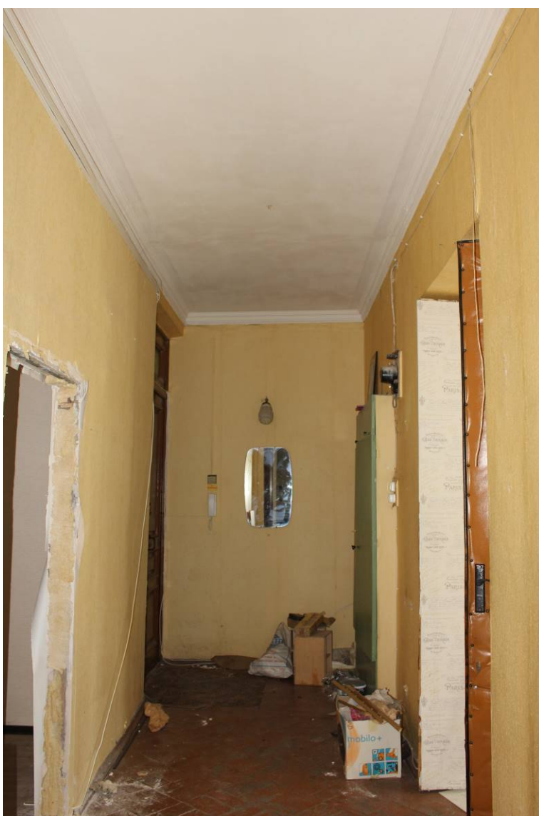
13. Выявленный объект культурного наследия «Дом И.И. Боргмана», по адресу: г. Санкт-Петербург, Съезжинская улица, дом 4, литера А. Квартира №4. Помещение 1. Общий вид помещения в сторону входной двери. Дата фотофиксации: 28 августа 2021 г.
