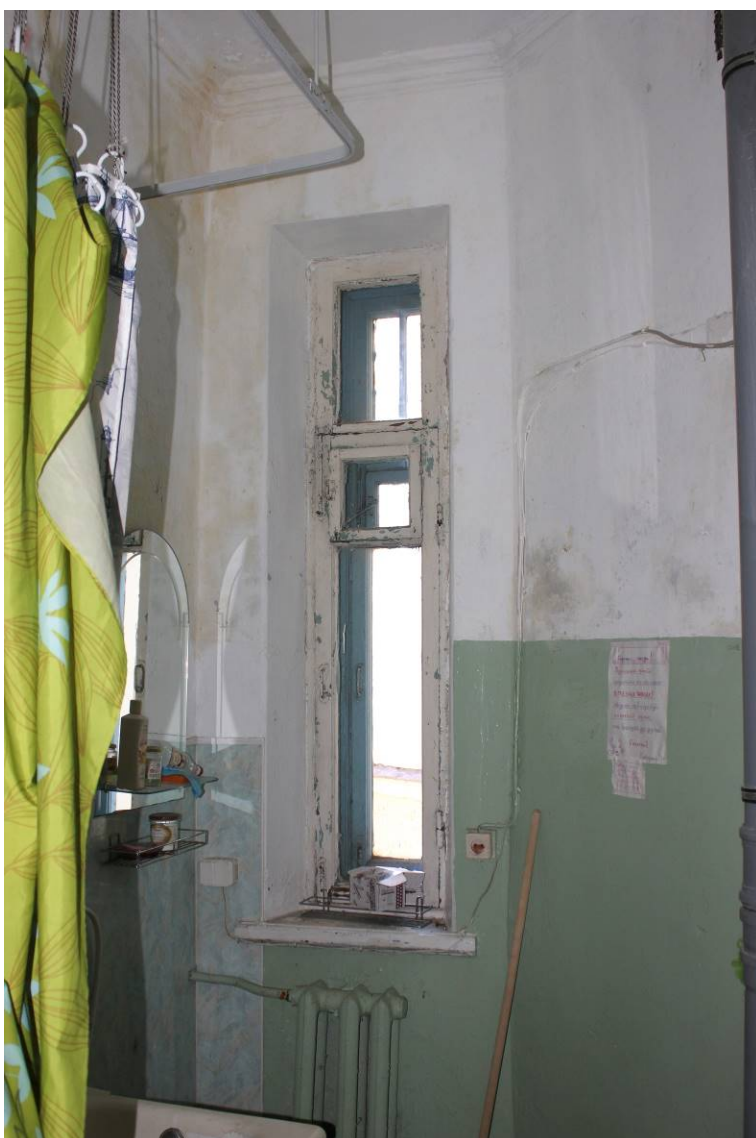
33. Выявленный объект культурного наследия «Дом И.И. Боргмана», по адресу: г. Санкт-Петербург, Съезжинская улица, дом 4, литера А. Квартира №4. Помещение 7. Фрагмент с показом оконного заполнения. Дата фотофиксации: 28 августа 2021 г.
