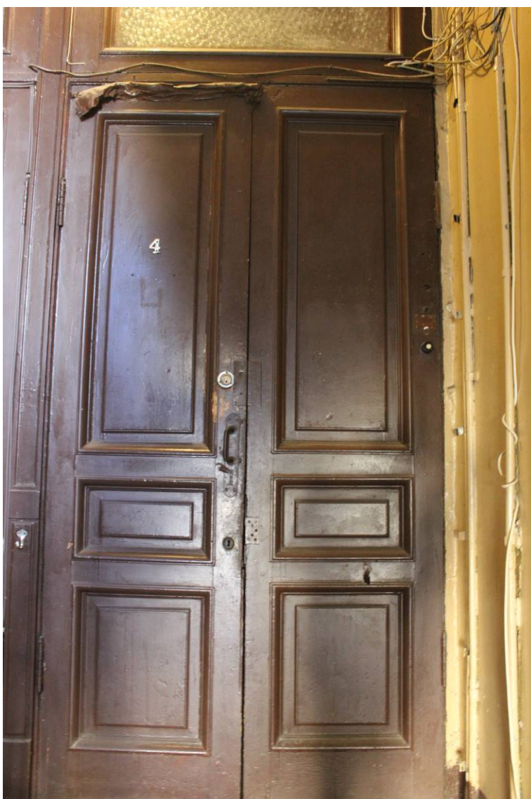
10. Выявленный объект культурного наследия «Дом И.И. Боргмана», по адресу: г. Санкт-Петербург, Съез жинская улица, дом 4, литера А. Квартира №4. Вид входной двери. Дата фотофиксации: 28 августа 2021 г.
