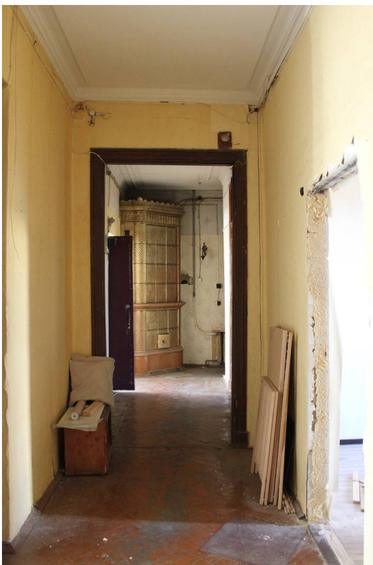
11. Выявленный объект культурного наследия «Дом И.И. Боргмана», по адресу: г. Санкт-Петербург, Съезжинская улица, дом 4, литера А. Квартира №4. Помещение 1. Общий вид. Дата фотофиксации: 28 августа 2021 г.
