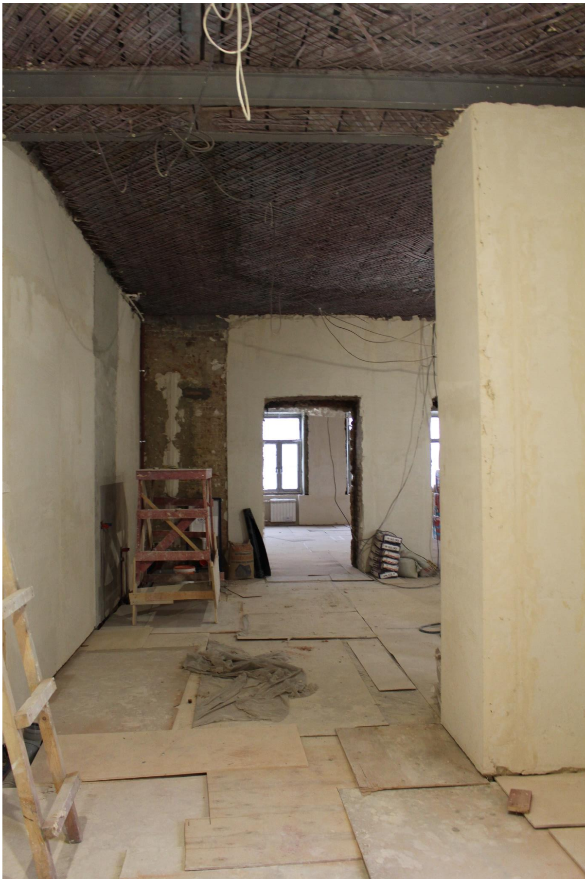
Фото 11. Выявленный объект культурного наследия «Дом, в котором в 1892-1913 годах жил ученый-баллист Н.А. Забудский». Квартира № 8. Помещения №№ 8, 9.
