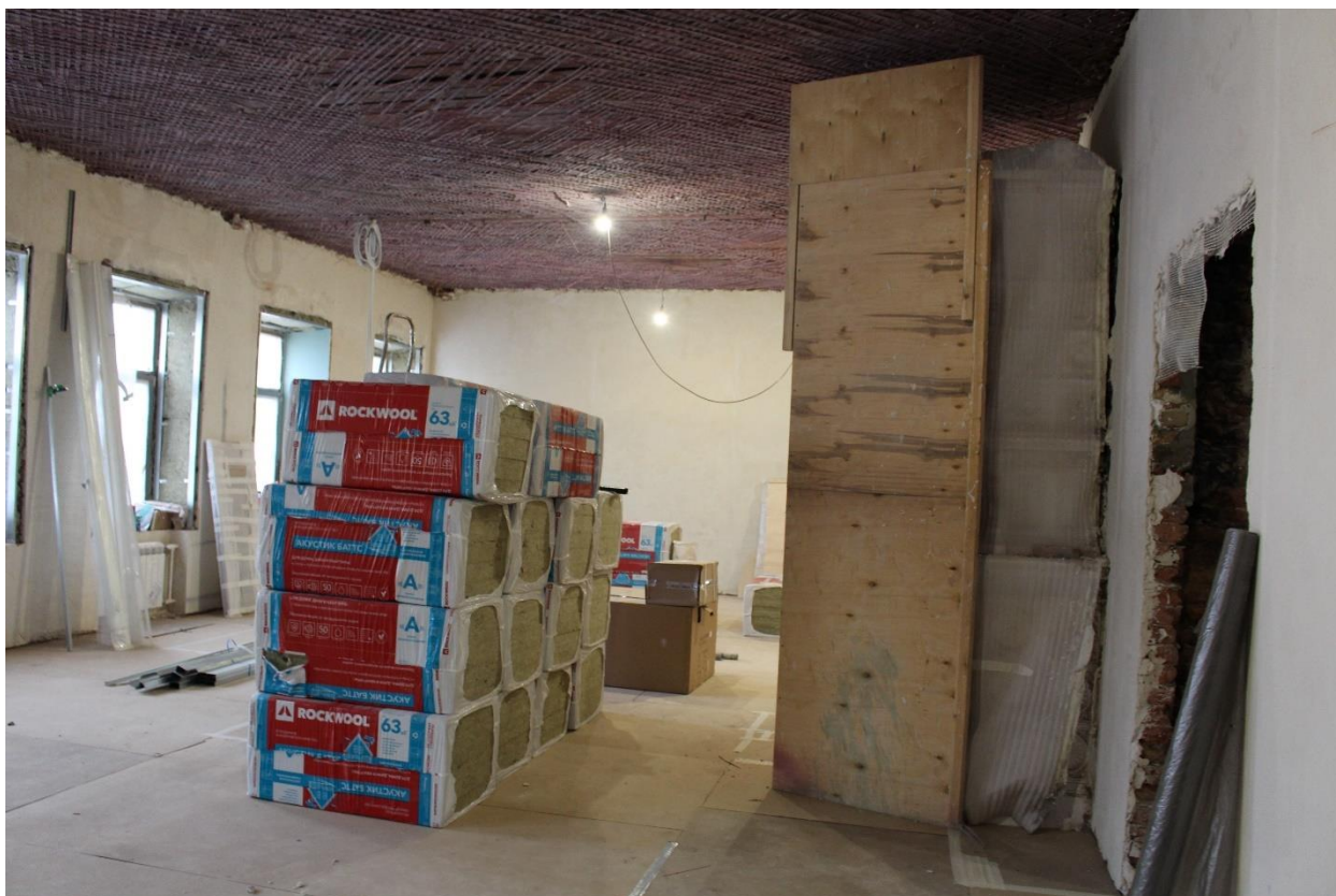
Фото 15. Выявленный объект культурного наследия «Дом, в котором в 1892-1913 годах жил ученый-баллист Н.А. Забудский». Квартира № 8. Вид на печь в помещении № 4.
