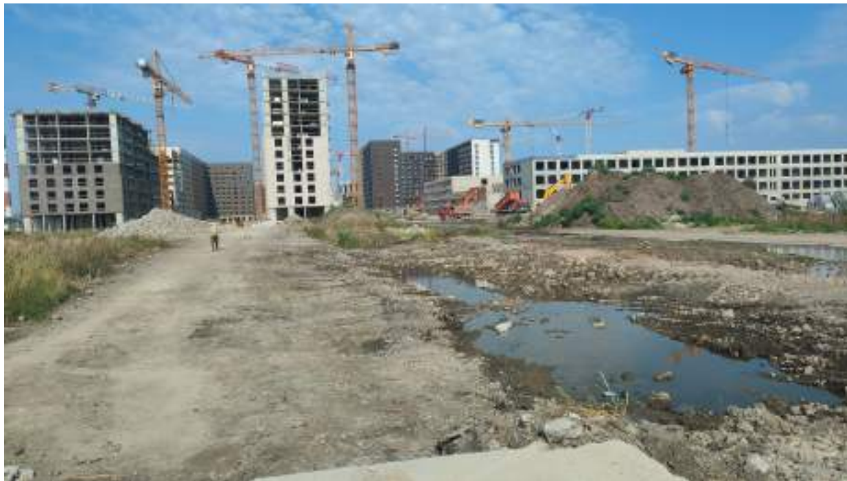
Точка фотофиксации 10. Центральная часть территории обследования. Вид с Ю.
