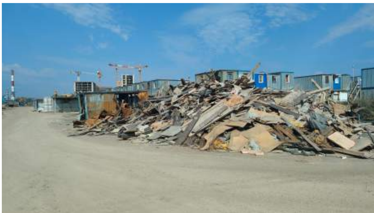
Точка фотофиксации 14. Южная часть территории обследования. Вид с Ю.
