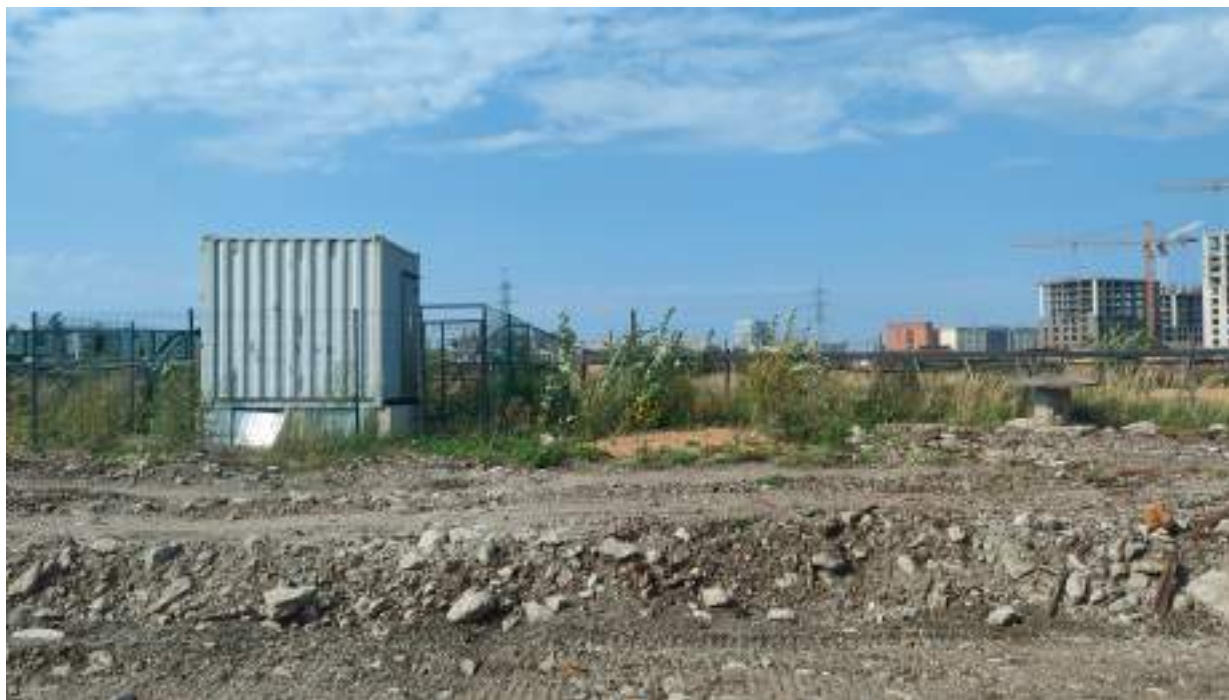
Точка фотофиксации 4. Центральная часть территории обследования. Вид с ВЮВ.
