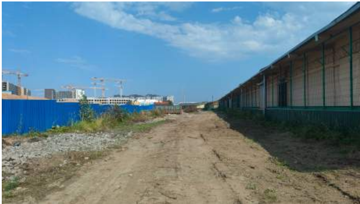
Точка фотофиксации 3. Южная часть территории обследования. Вид с ЮЮЗ
