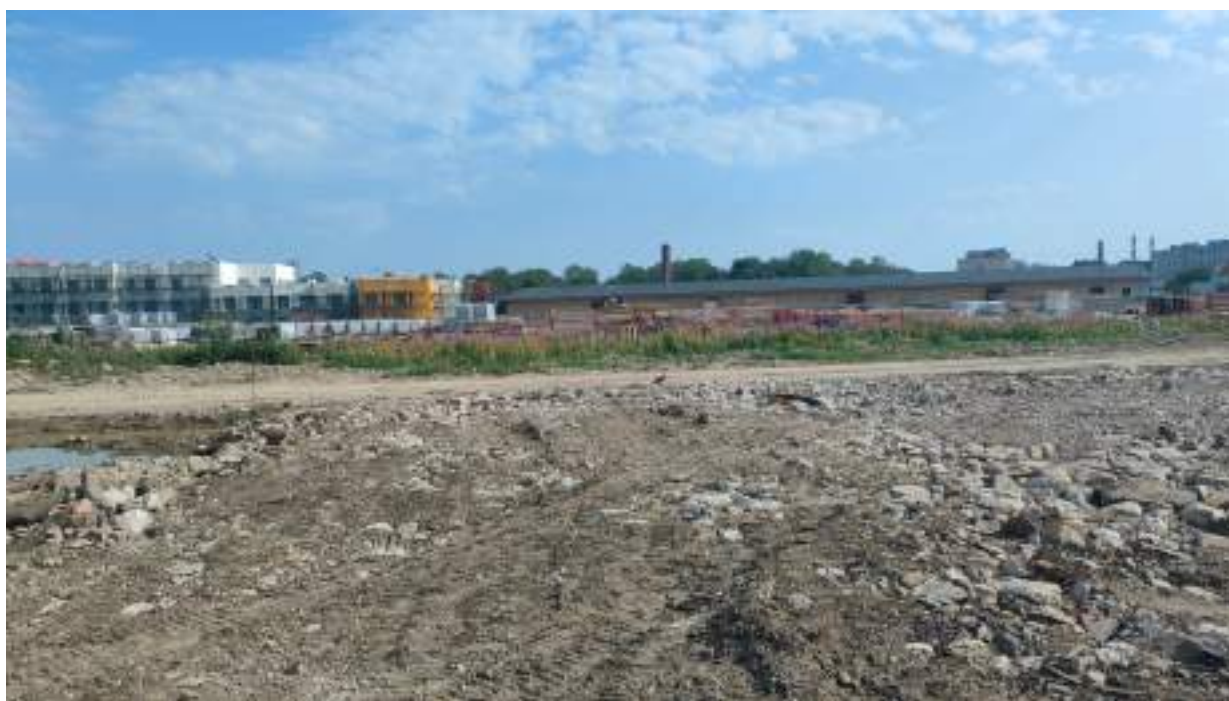
Точка фотофиксации 10. Центральная часть территории обследования. Вид с З.
