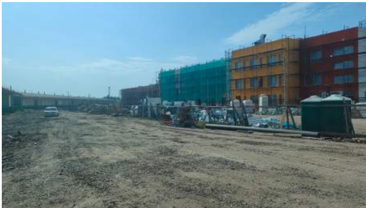
Точка фотофиксации 6. Северная часть территории обследования. Вид с С.
