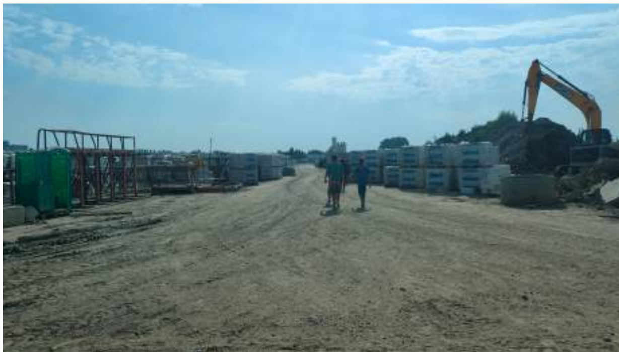
Точка фотофиксации 8. Северная часть территории обследования. Вид с С.
