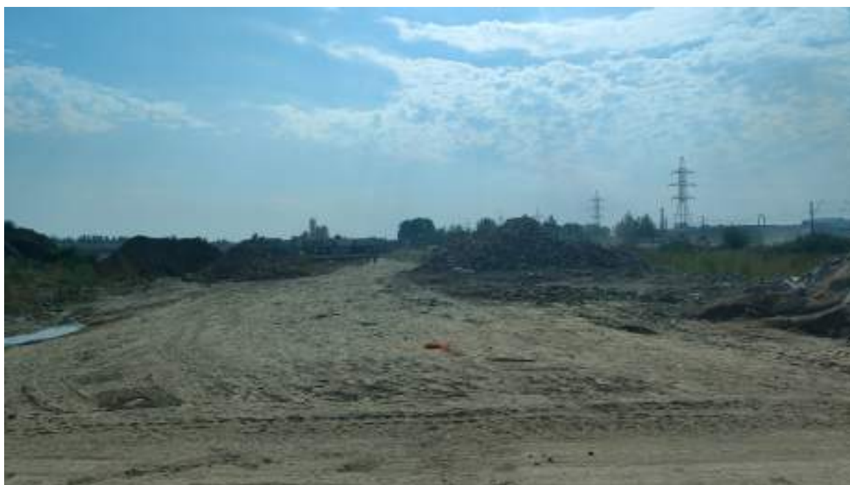
Точка фотофиксации 9. Северная часть территории обследования. Вид с С.
