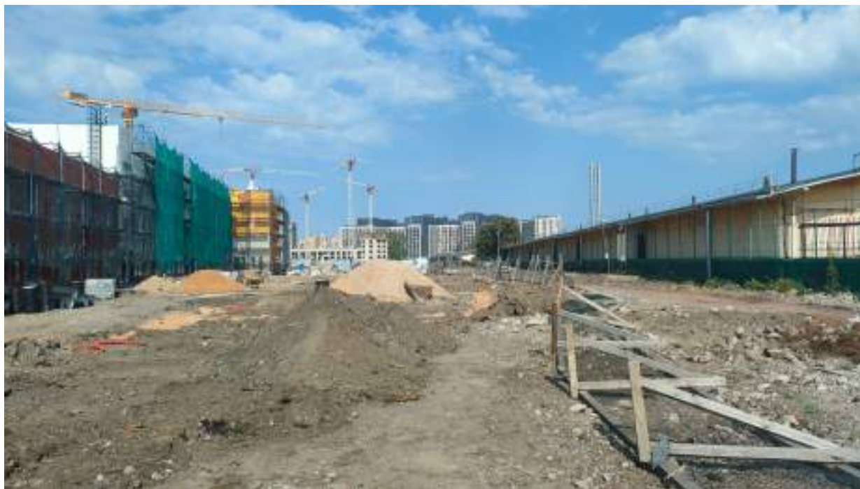
Точка фотофиксации 5. Центральная часть территории обследования. Вид с Ю.
