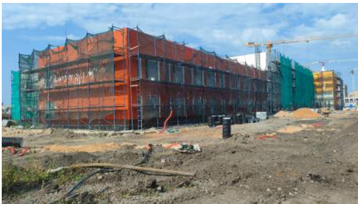
Точка фотофиксации 5. Центральная часть территории обследования. Вид с ЮВ.
