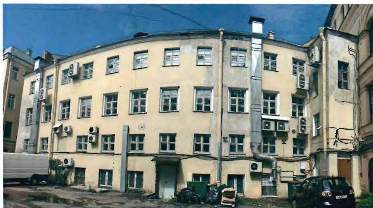
2. Дворовый фасад. Общий вид.
