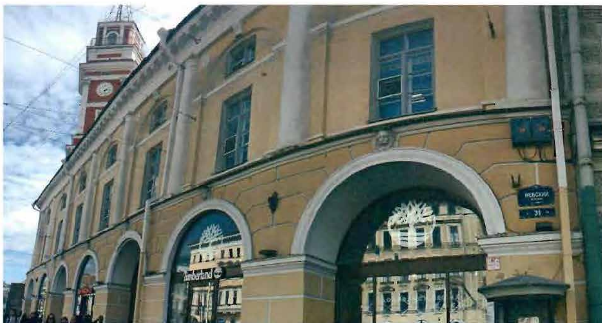
1. Лицевой фасад. Общий вид.
