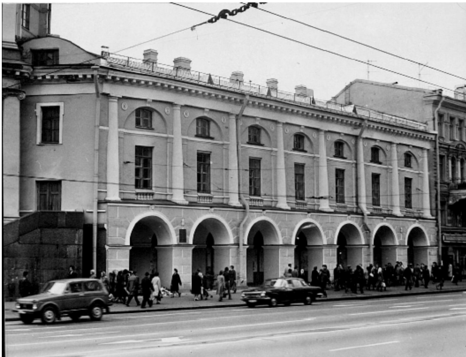
63. Невский проспект, 31. Здание Серебряных рядов (1784–1786 гг.). Северный лицевой фасад по Невскому проспекту. Фотография. Автор фото – А.П. Павлов. 1982 г. // Источник: Сектор хранения документированной информации Управления организационного обеспечения и контроля КГИОП (Архив КГИОП). П-139 Н-210 Б. Серебрянные ряды. Первичный паспорт на здание, 1936 г.
