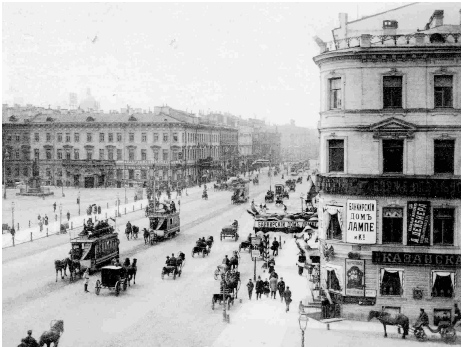
Илл. 19. Здание по Невскому проспекту, 28. Фотография. До 1902 г. Из: Невский проспект. Образы времени. Каталог выставки. – СПб., 2003. – С. 32.
