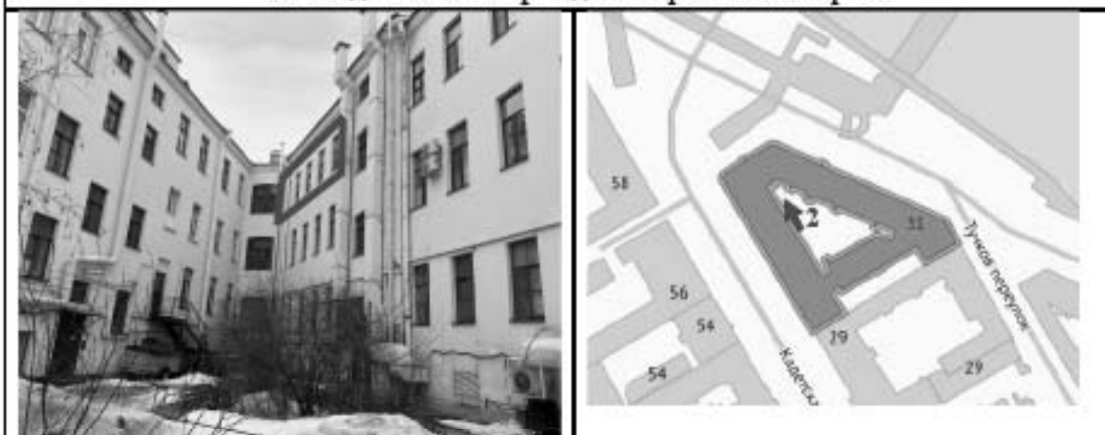
2. Вид на дворовые фасады
