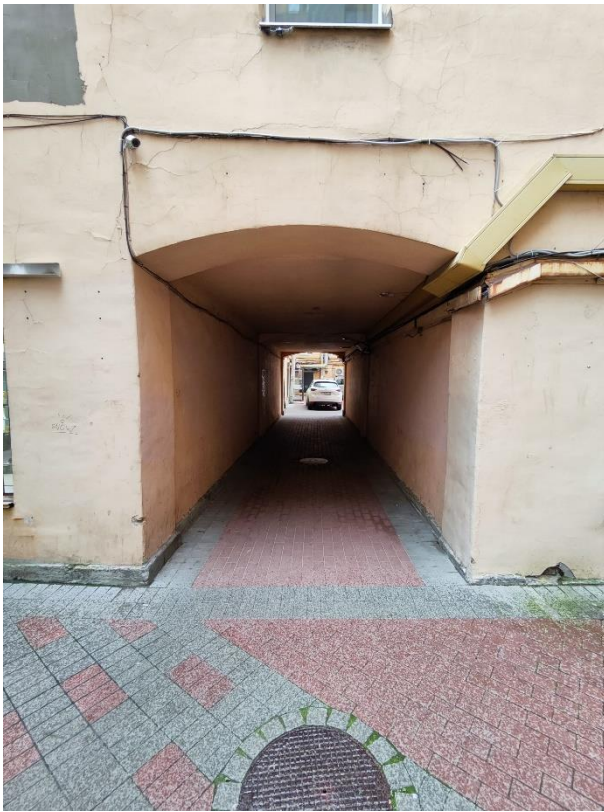
47. «Дом И.Ф. Александровского (Санкт-Петербургского Тульского поземельного банка)», Невский пр., д.63, литера А. Дворовый фасад. Фрагмент. Фото 19.07.2024г.
