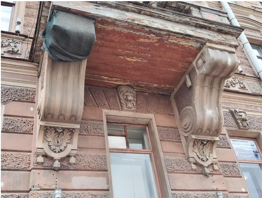
15. «Дом И.Ф. Александровского (Санкт-Петербургского Тульского поземельного банка)», Невский пр., д.63, литера А. Северный фасад. Фрагмент. Фото 19.07.2024г.
