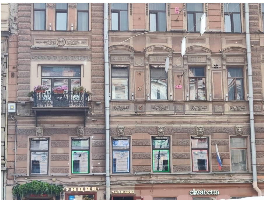
4. «Дом И.Ф. Александровского (Санкт-Петербургского Тульского поземельного банка)», Невский пр., д.63, литера А. Северный фасад. Фрагмент. Фото 19.07.2024г.
