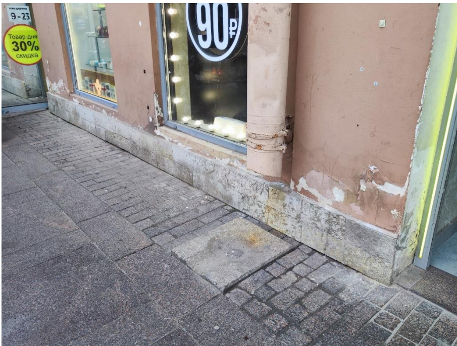
20. «Дом И.Ф. Александровского (Санкт-Петербургского Тульского поземельного банка)», Невский пр., д.63, литера А. Северный фасад. Фрагмент. Фото 19.07.2024г.
