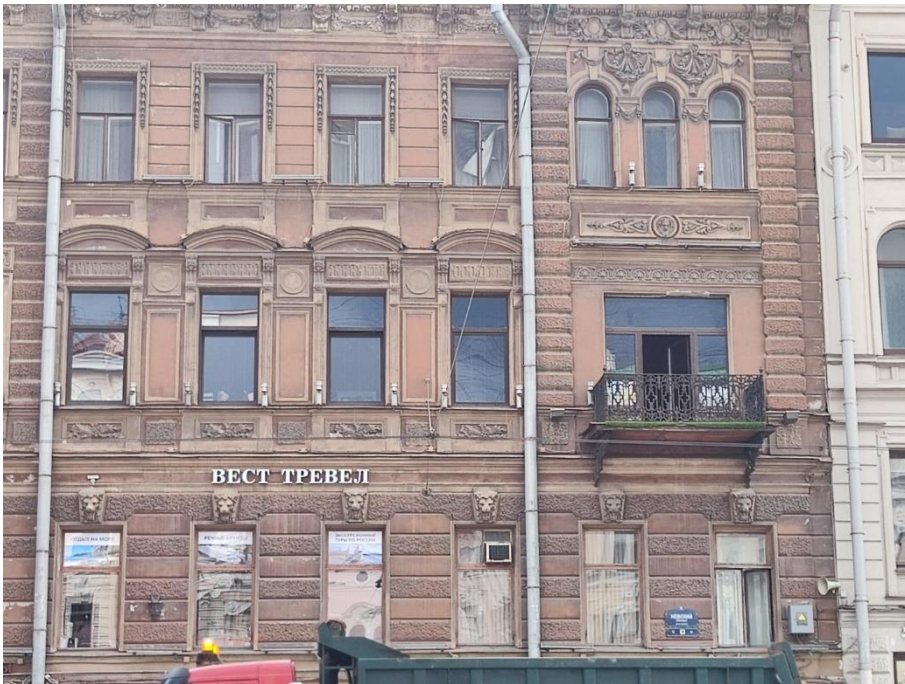
9. «Дом И.Ф. Александровского (Санкт-Петербургского Тульского поземельного банка)», Невский пр., д.63, литера А. Северный фасад. Фрагмент. Фото 19.07.2024г.
