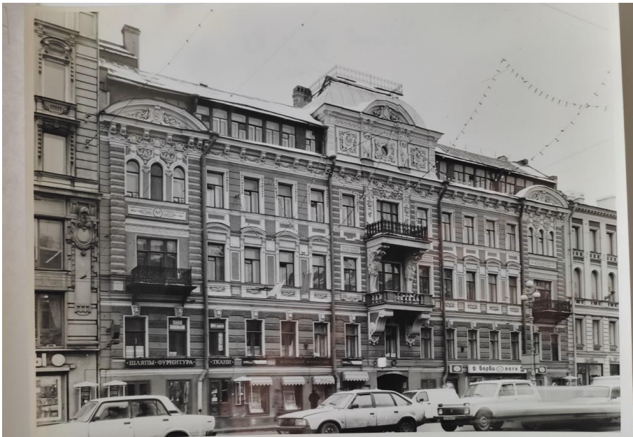
40. Невский пр., д.63. Главный фасад. 1996г. архив КГИОП
