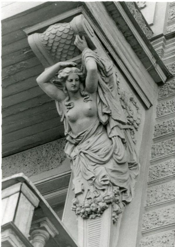
38. Вид консоли в виде поясной горельефной фигуры кариатиды, расположенной в простенке между окнами второго этажа и поддерживающей балкон на фасаде дома № 63 на Невском проспекте. 1981 г. ЦГАКФФД СПб Ар 120026.
