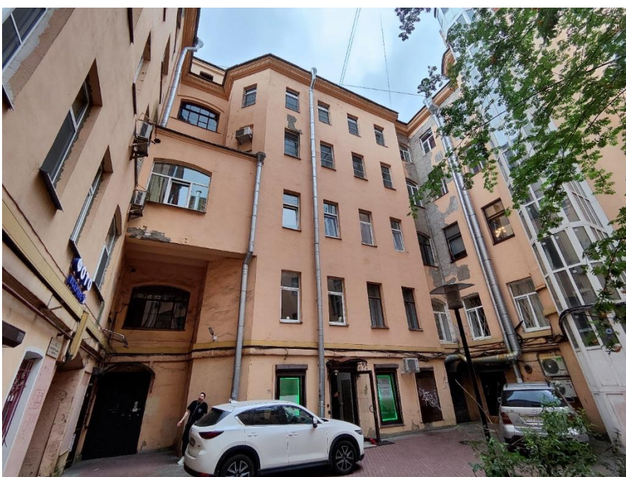
28. «Дом И.Ф. Александровского (Санкт-Петербургского Тульского поземельного банка)», Невский пр., д.63, литера А. Дворовый фасад. Общий вид. Фото 19.07.2024г.
