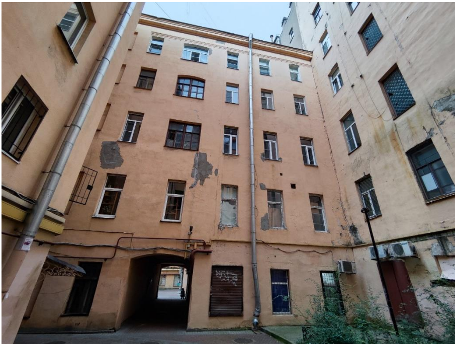
39. «Дом И.Ф. Александровского (Санкт-Петербургского Тульского поземельного банка)», Невский пр., д.63, литера А. Дворовый фасад. Общий вид. Фото 19.07.2024г.
