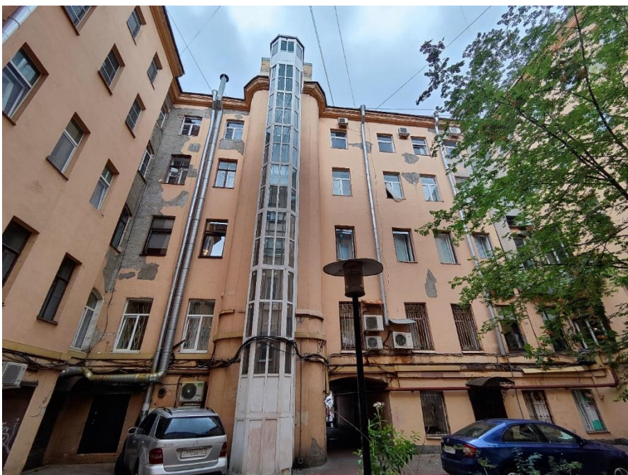
31. «Дом И.Ф. Александровского (Санкт-Петербургского Тульского поземельного банка)», Невский пр., д.63, литера А. Дворовый фасад. Общий вид. Фото 19.07.2024г.
