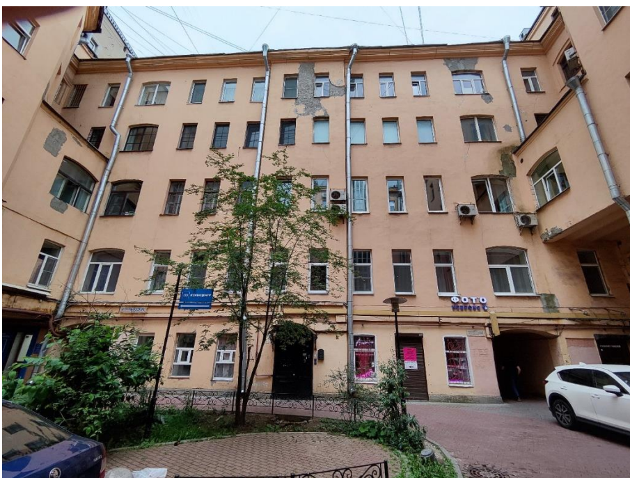
24. «Дом И.Ф. Александровского (Санкт-Петербургского Тульского поземельного банка)», Невский пр., д.63, литера А. Дворовый фасад. Общий вид. Фото 19.07.2024г.
