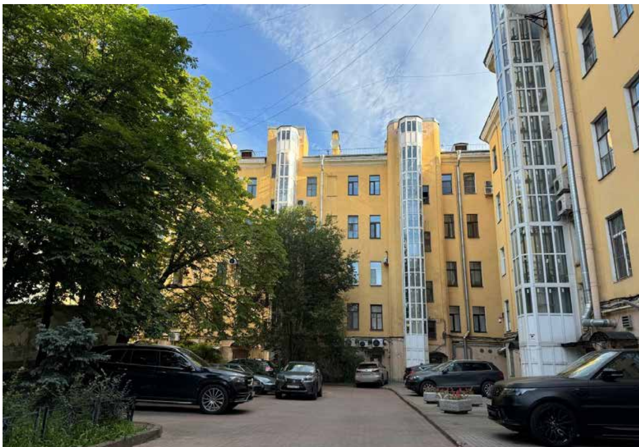
Фото 16. Вид на дворовые фасады объекта культурного наследия.
