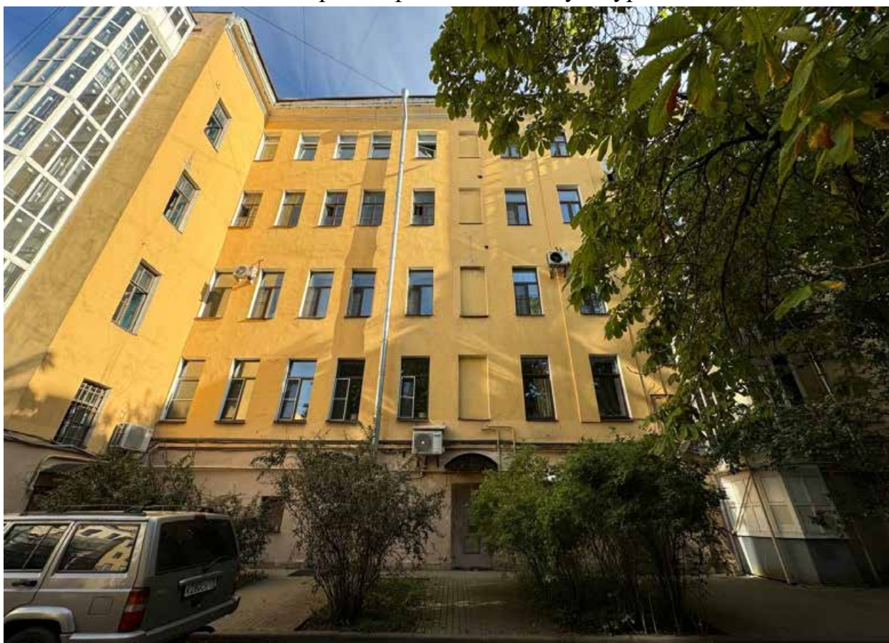
Фото 20. Вид на дворовой фасад объекта культурного наследия.
