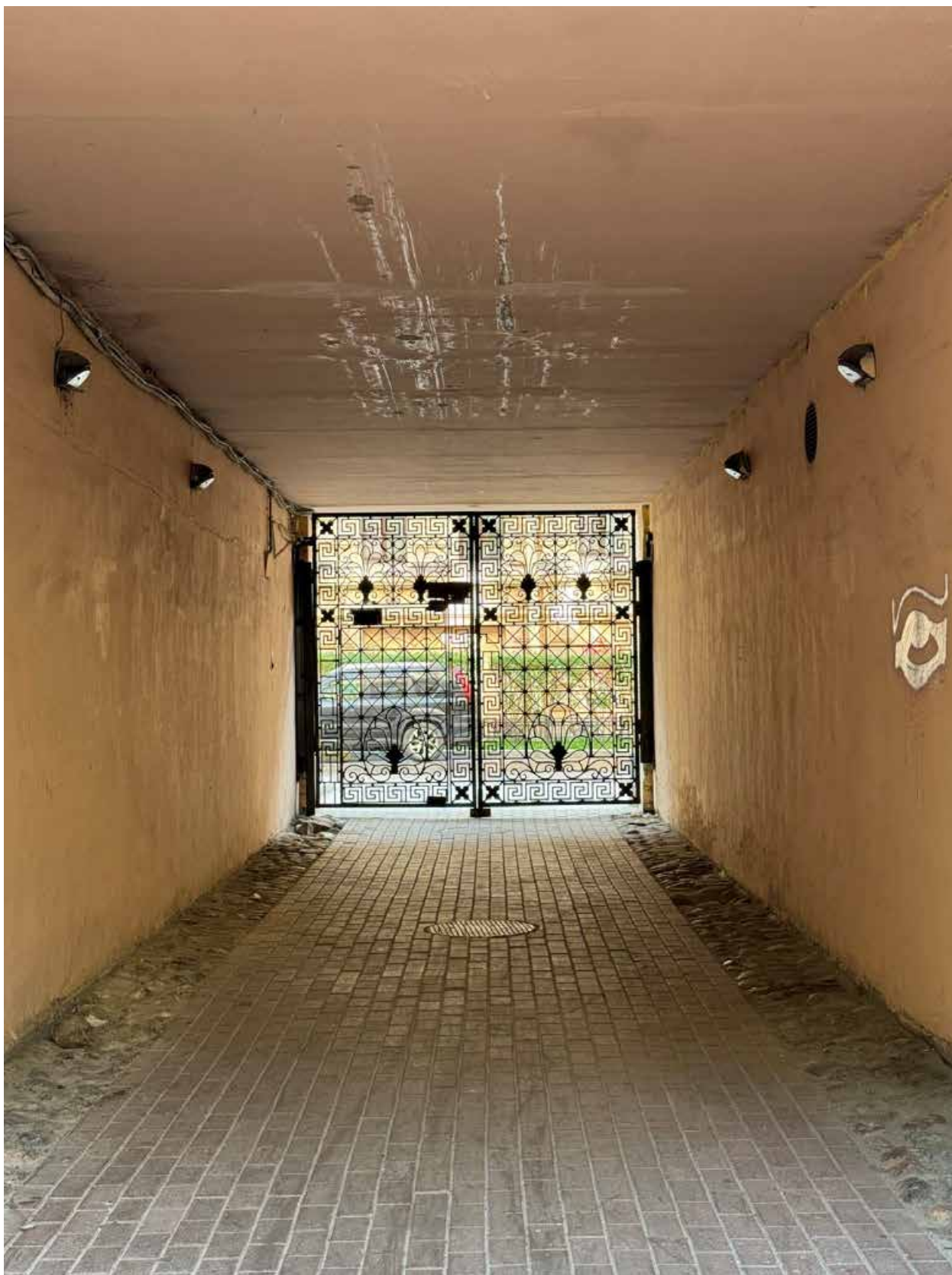
Фото 15. Общий вид арки объекта культурного наследия.
