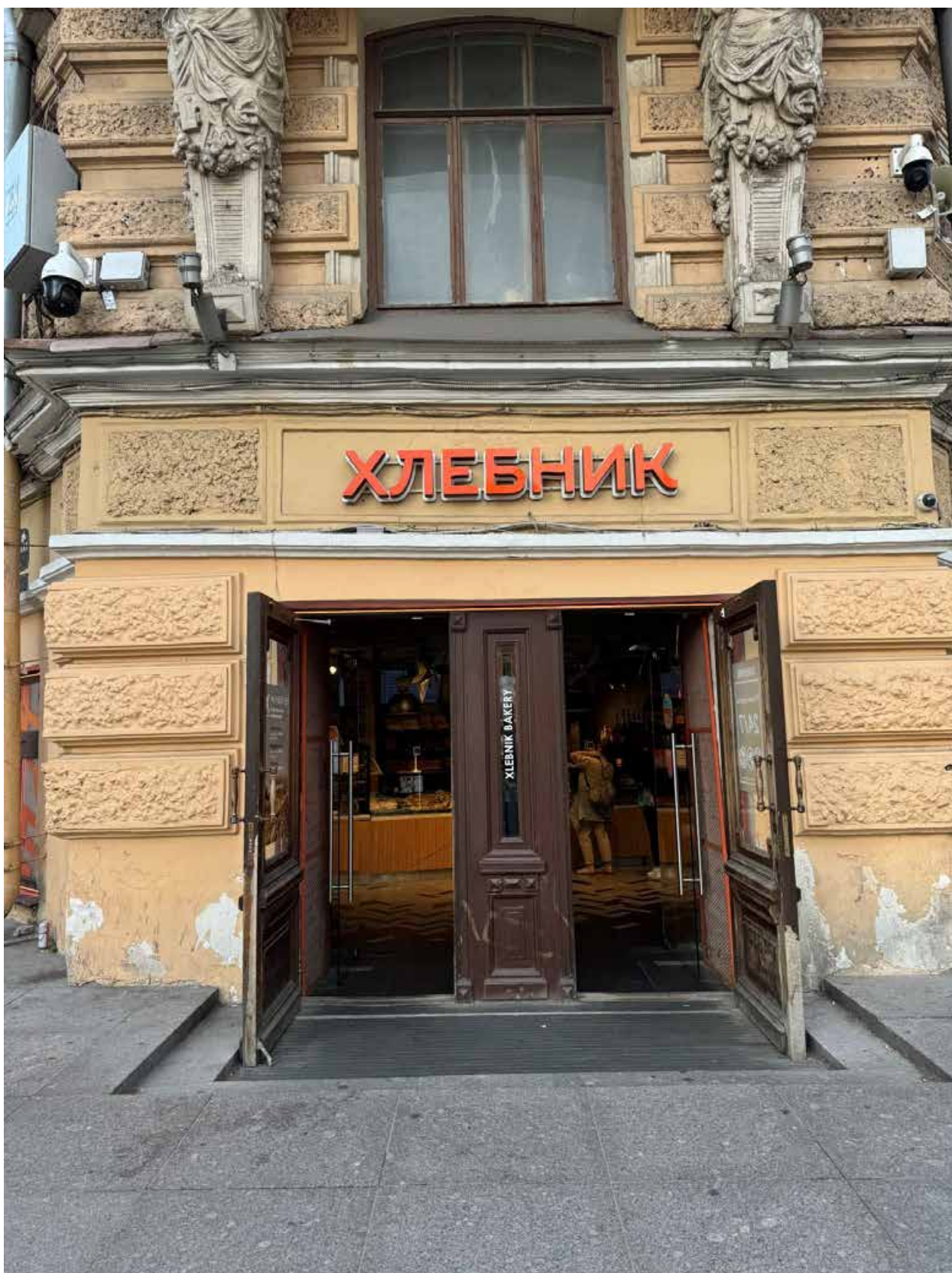
Фото 7. Входная группа торцевой части фасада объекта культурного наследия по Невскому проспекту.
