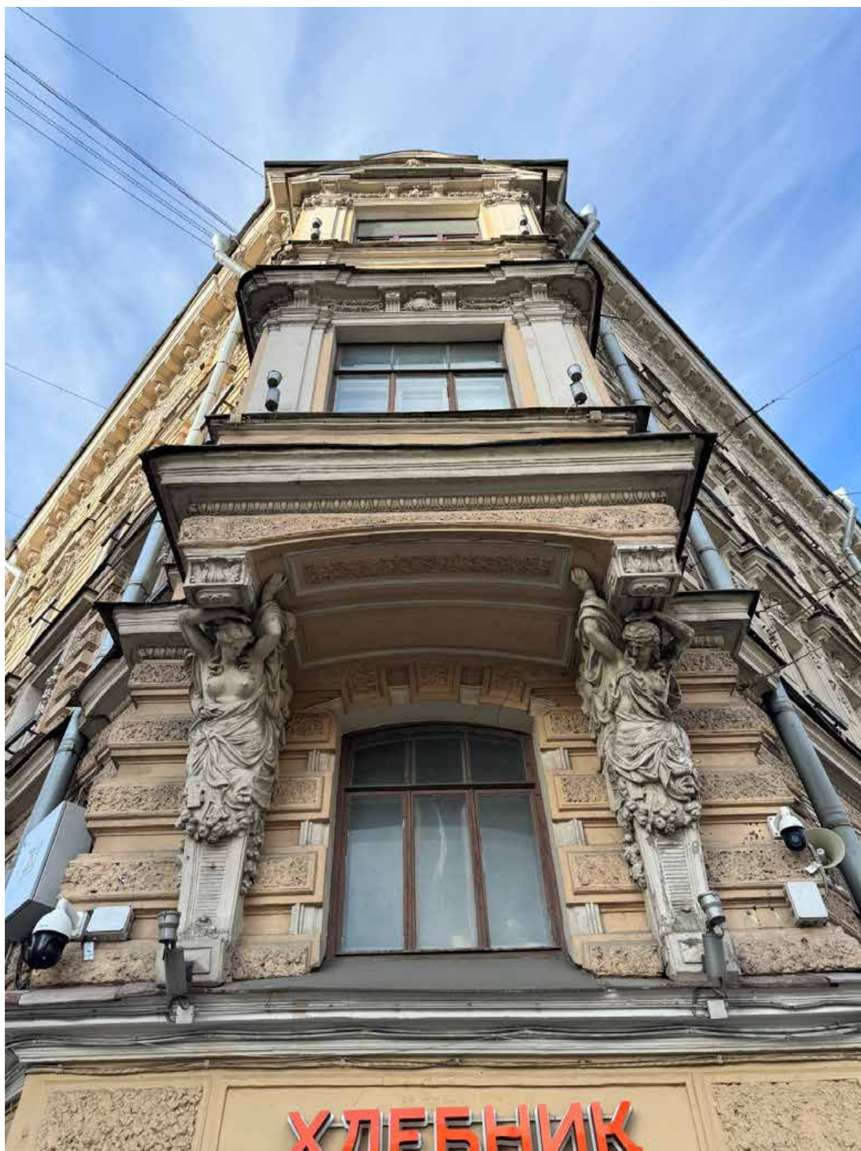
Фото 8. Элементы торцевой части фасада объекта культурного наследия по Невскому проспекту.
