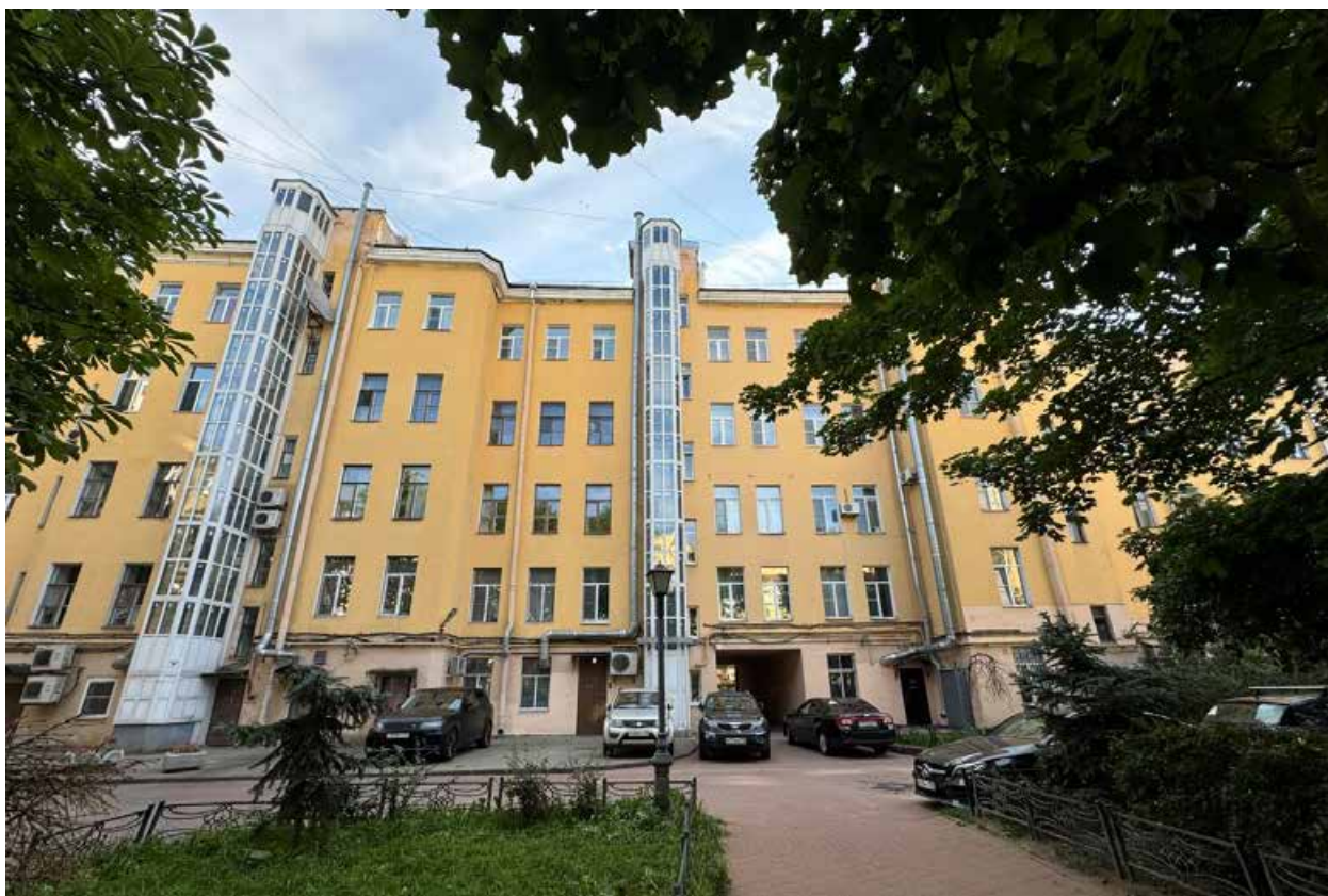
Фото 19. Вид на дворовой фасад объекта культурного наследия.
