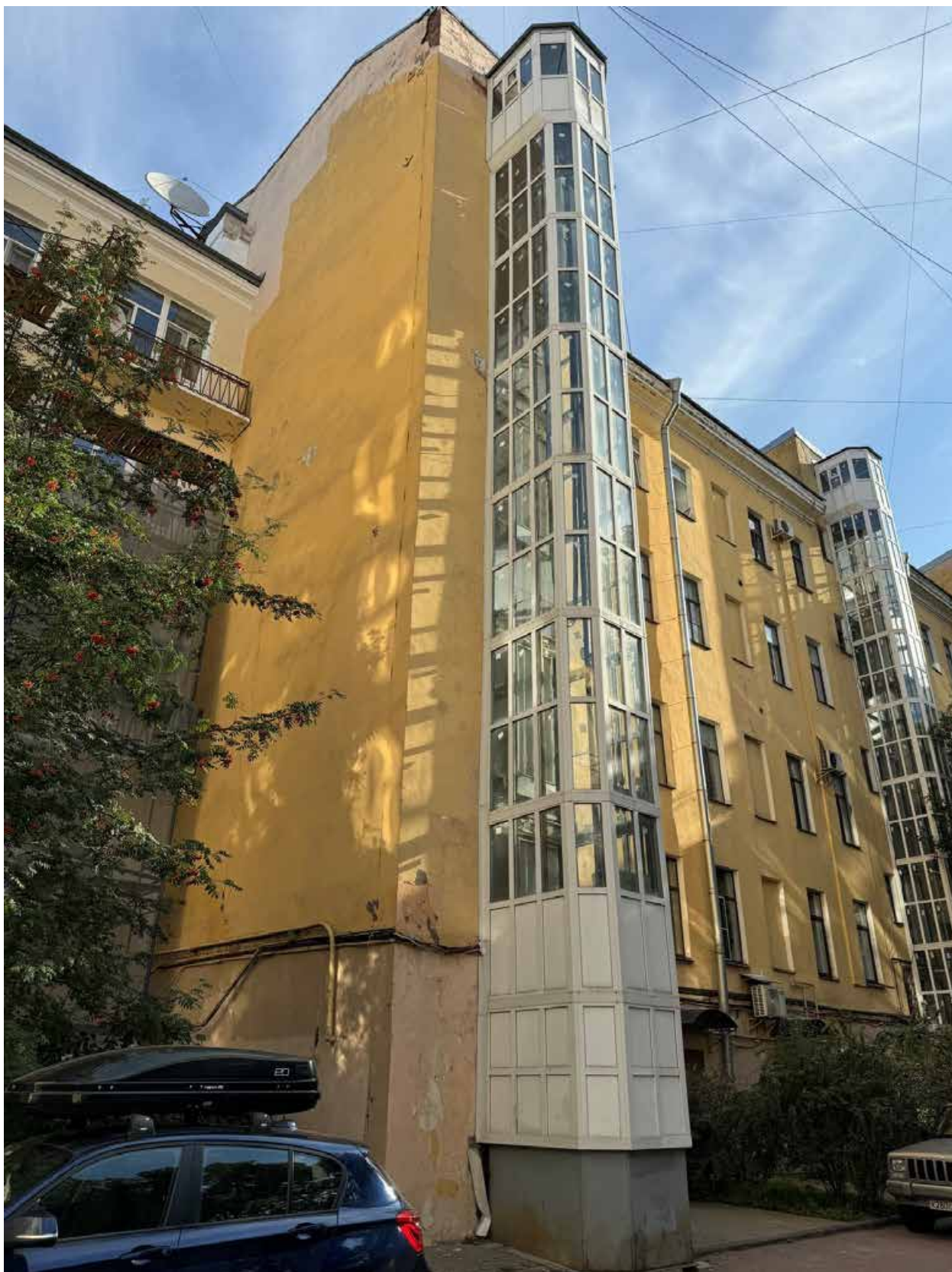
Фото 21. Вид на дворовой фасад объекта культурного наследия.
