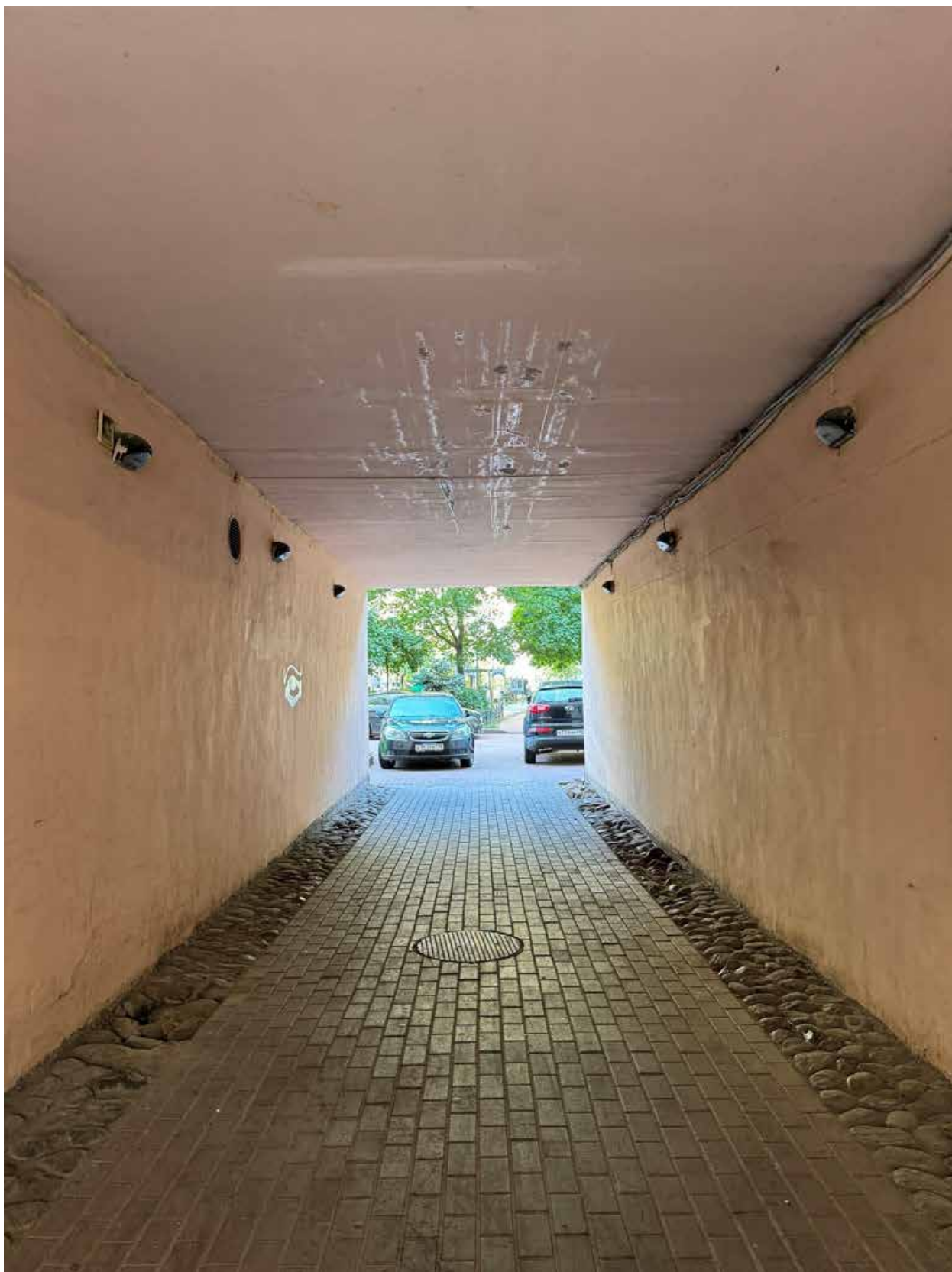
Фото 14. Общий вид арки объекта культурного наследия.
