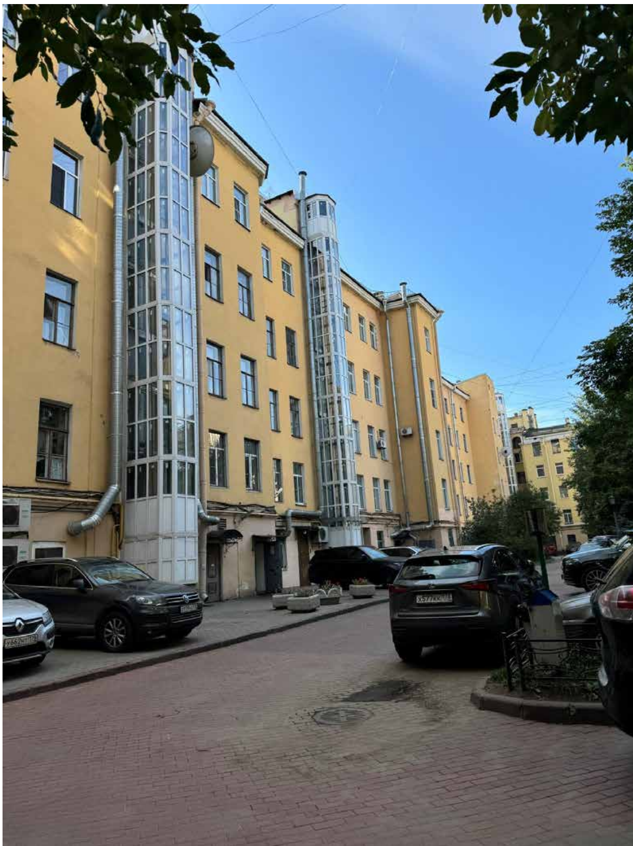
Фото 23. Вид на дворовой фасад объекта культурного наследия.
