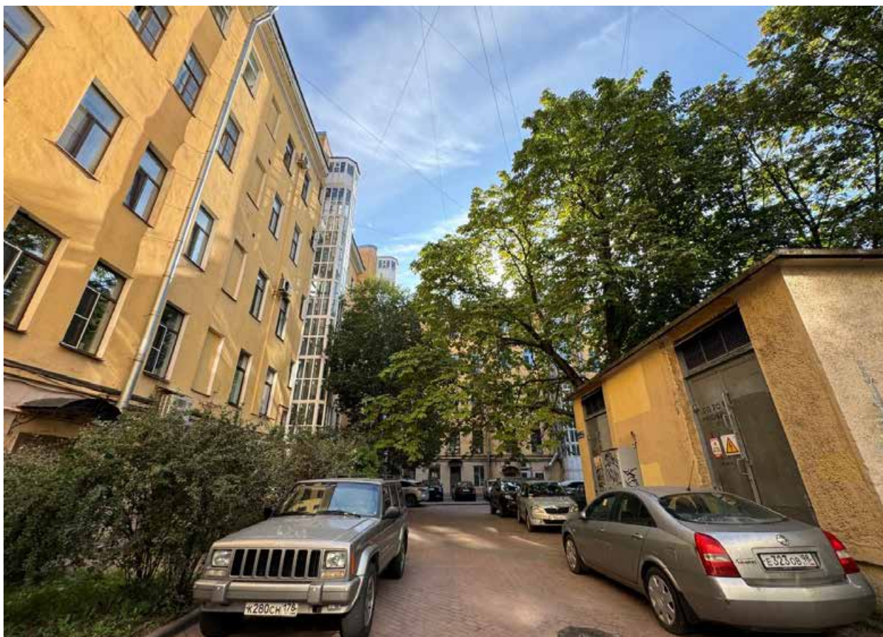
Фото 22. Вид на дворовые фасады объекта культурного наследия.
