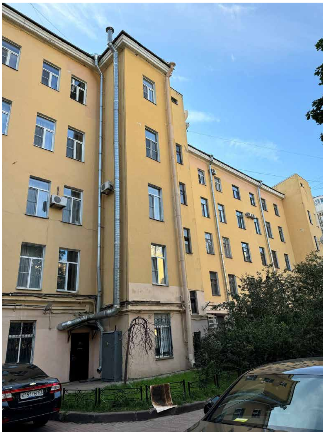
Фото 18. Фрагмент дворового фасада объекта культурного наследия.
