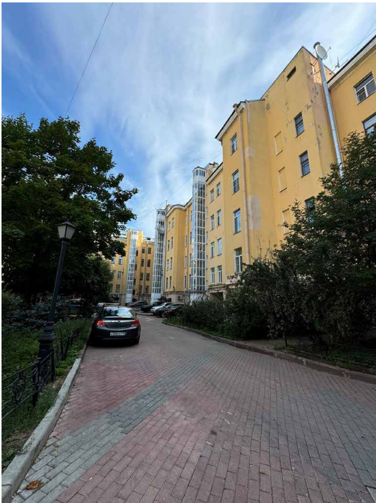
Фото 25. Вид на дворовые фасады объекта культурного наследия.
