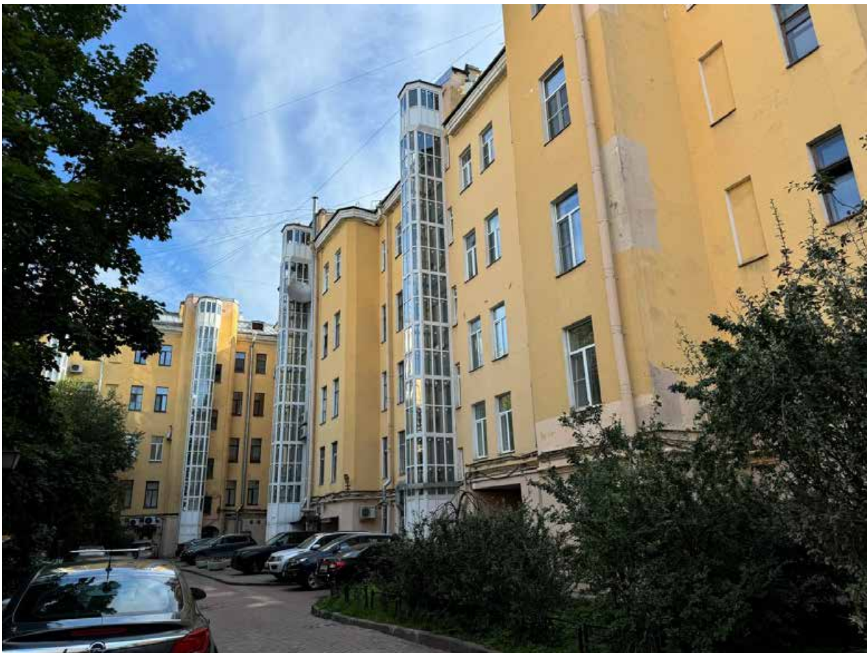
Фото 24. Вид на дворовые фасады объекта культурного наследия.
