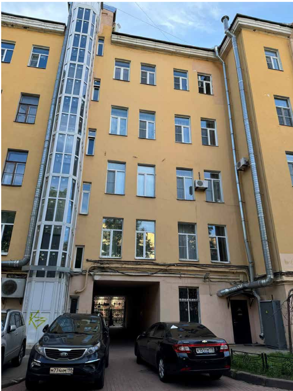
Фото 17. Фрагмент дворового фасада объекта культурного наследия.
