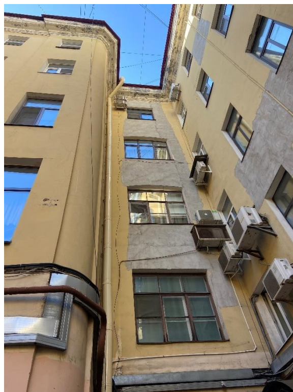
Фото 17. Вид на фрагмент дворового фасада.
