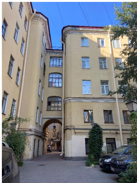
Фото 10. Вид на дворовые фасады.
