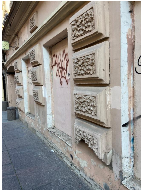
Фото 6. Фрагмент лицевого фасада по Пушкинской улице.
