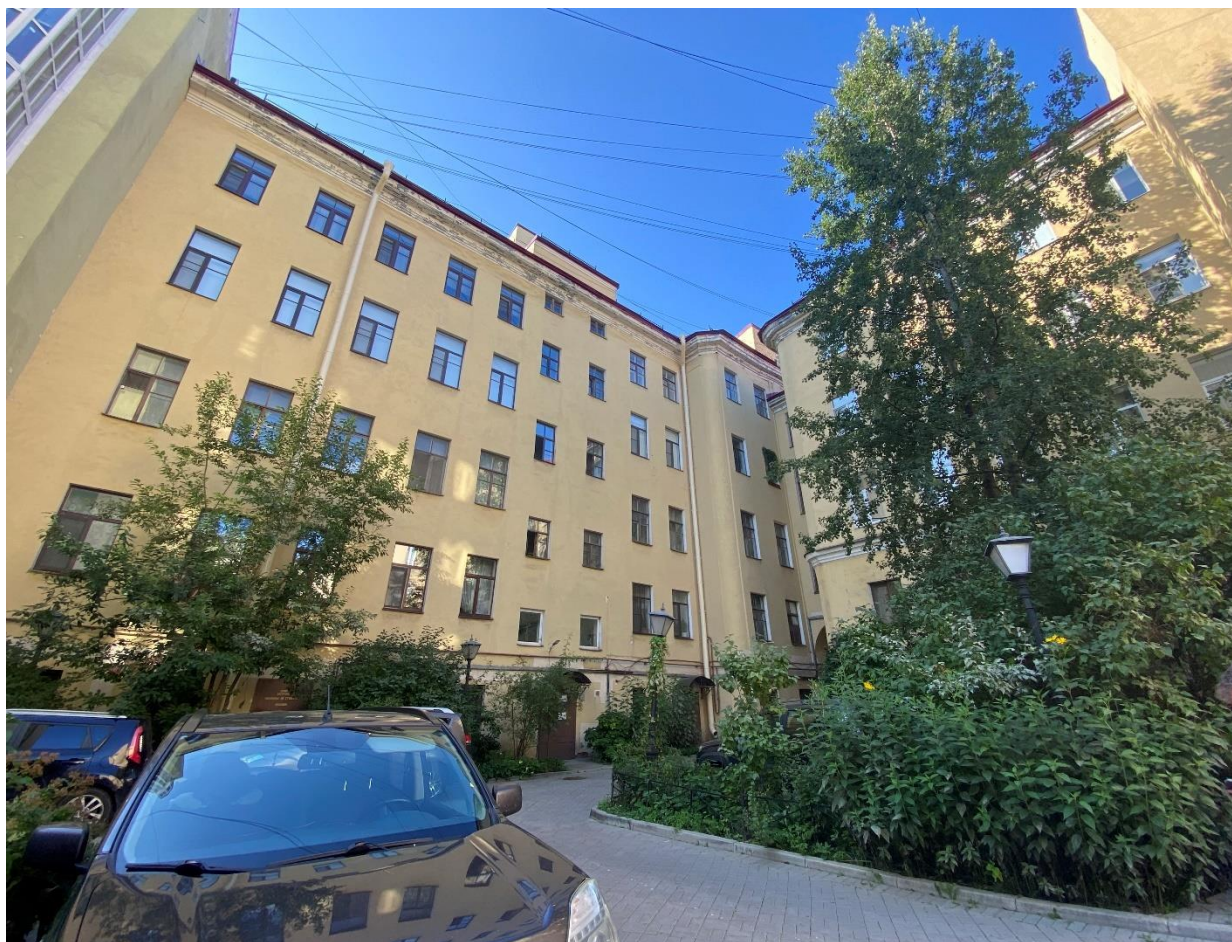
Фото 11. Вид на дворовый фасад (корпус по Пушкинской улице).
