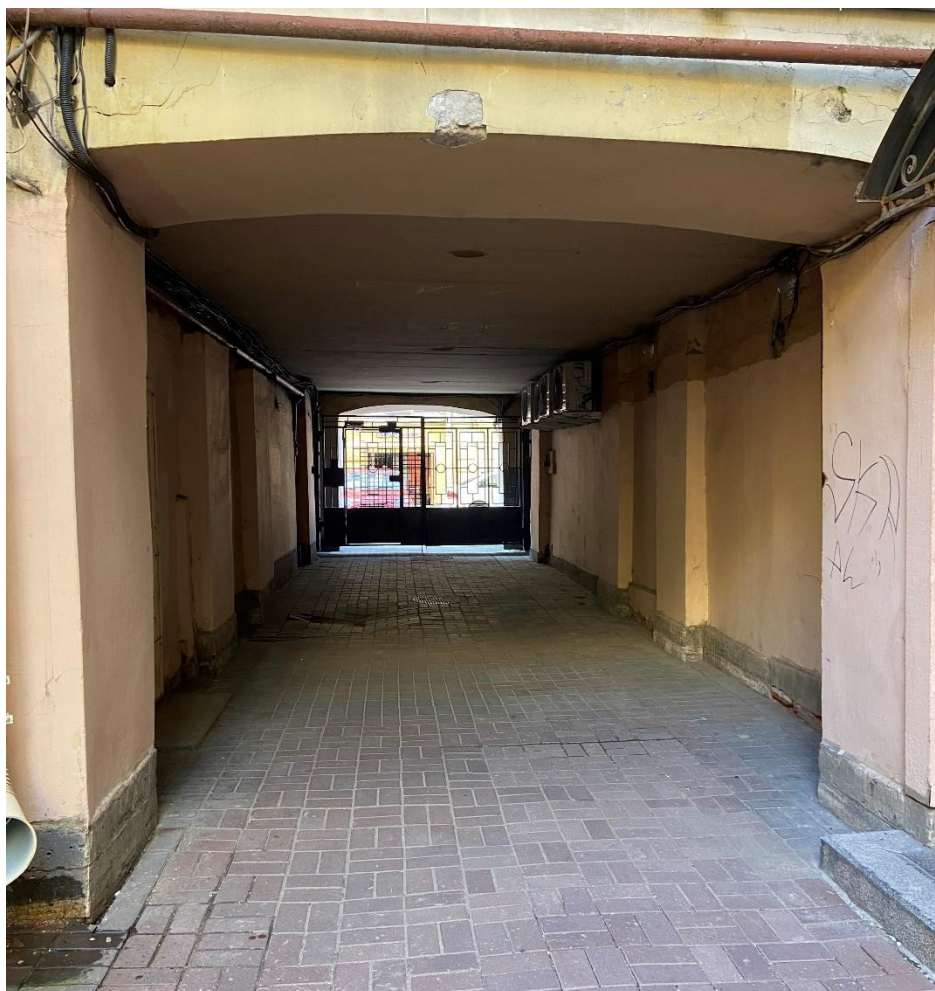
Фото 18. Вид на арочный проезд.
