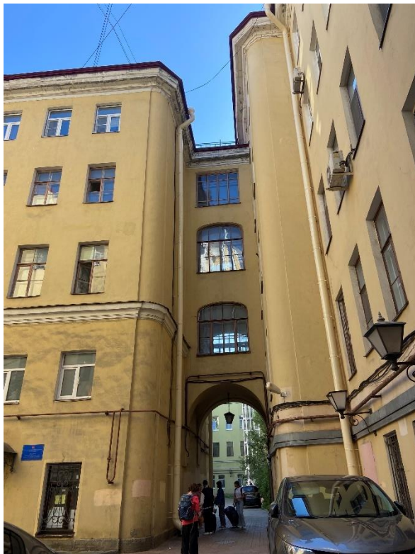
Фото 12. Вид на дворовые фасады.
