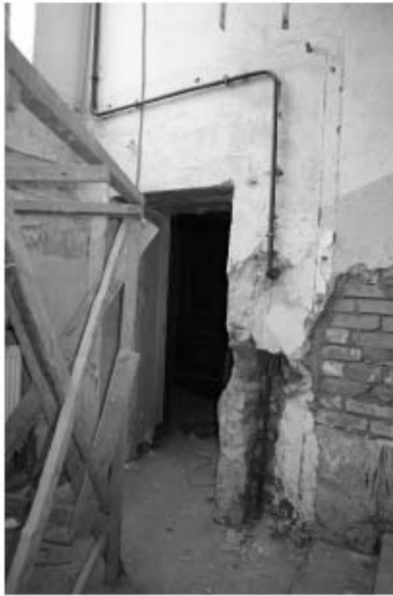
Фото 1.7. 1 этаж, лестничная площадка, лестница III.
