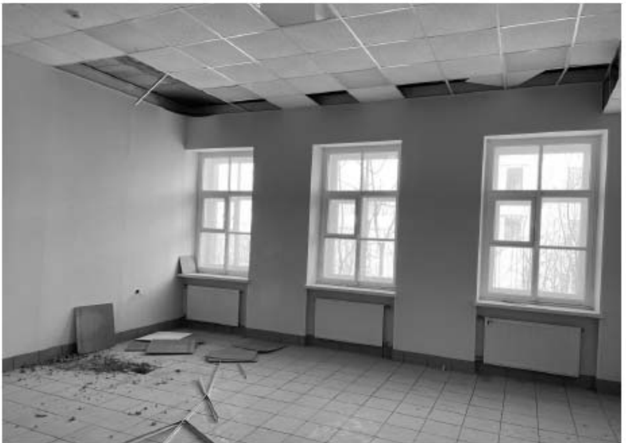
Фото 2.14. 2 этаж. Помещения по западному фасаду.
