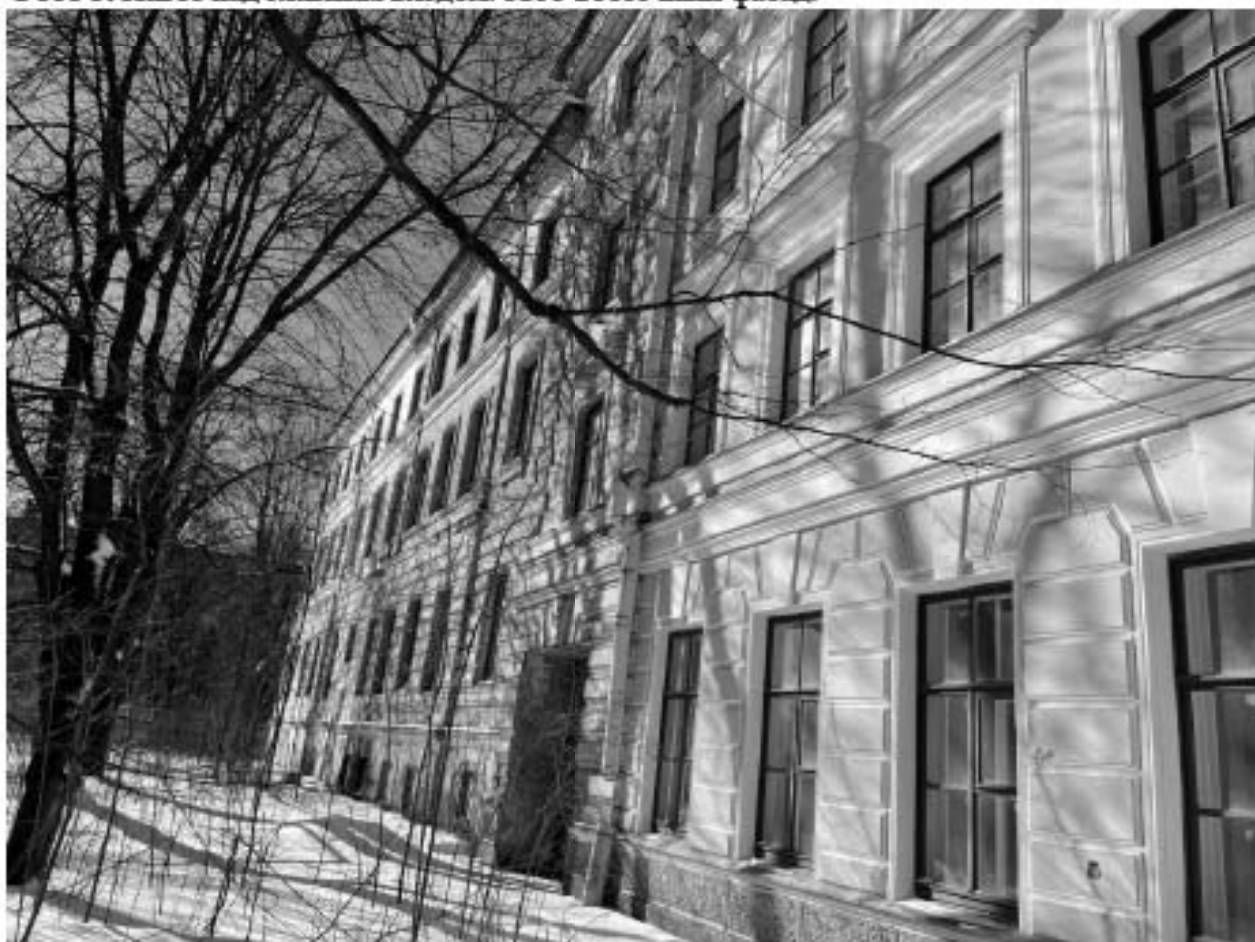
Фото 6. Юго-восточный фасад здания. Фрагмент
