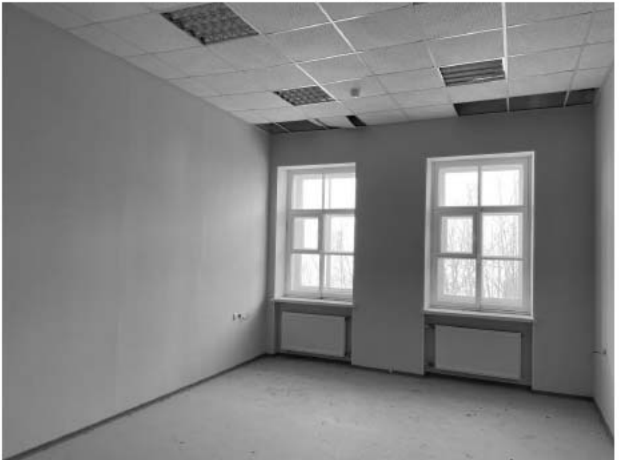
Фото 2.8. 2 этаж. Помещение по западному фасаду.
