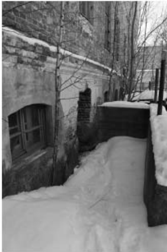
Фото 12. Северо-западный (дворовой) фасад. Фрагмент.
