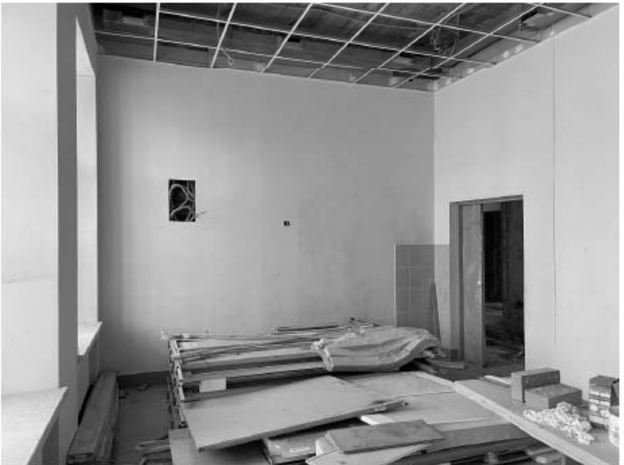
Фото 1.22. 1 этаж. Помещение по западному фасаду.
