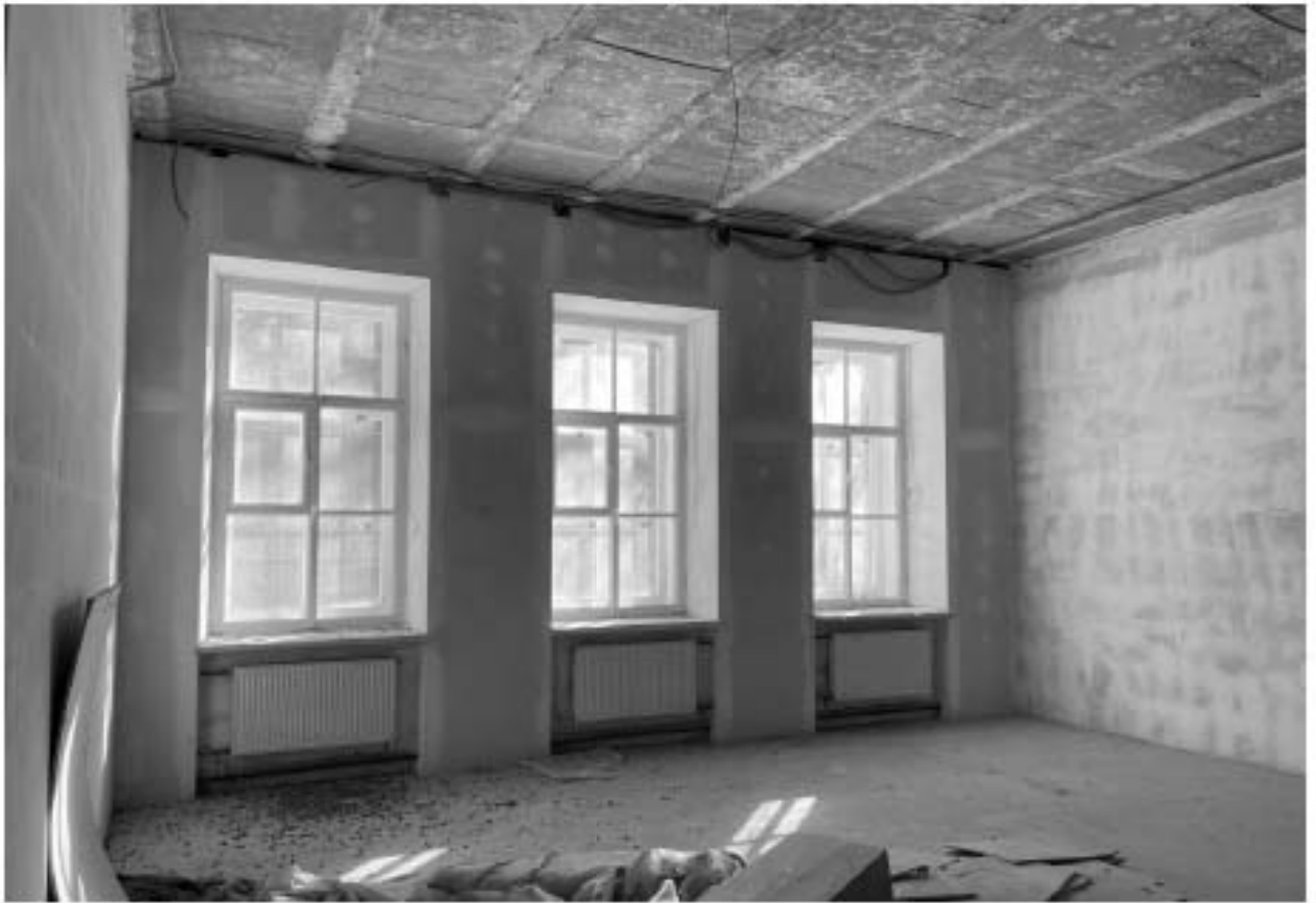
Фото 1.16. 1 этаж. Помещения по восточному фасаду.
