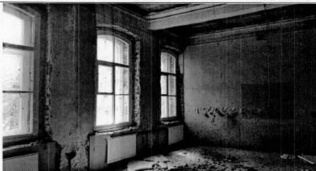
10. Помещение в уровне 2-го этажа
