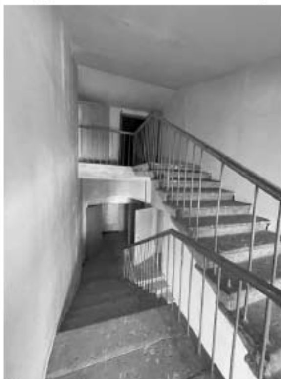
Фото 5.1. Лестница в южной части.
