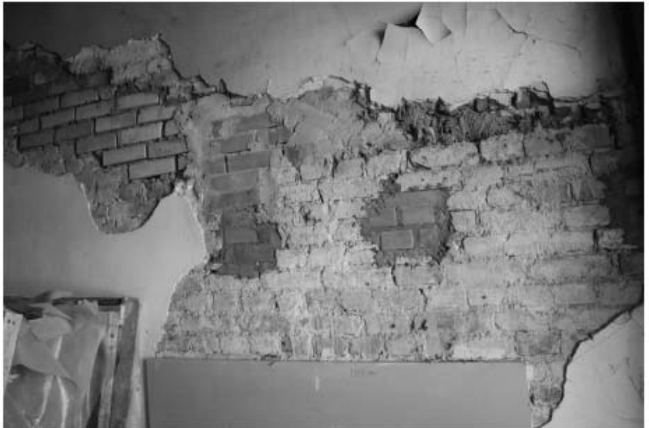
Фото 3.26. 3 этаж, фрагмент кирпичной кладки, лестничная клетка лестницы I*.
