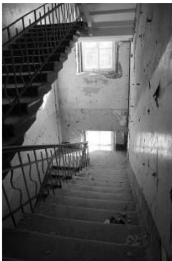
Фото 2.28. 2 этаж, лестница II.
