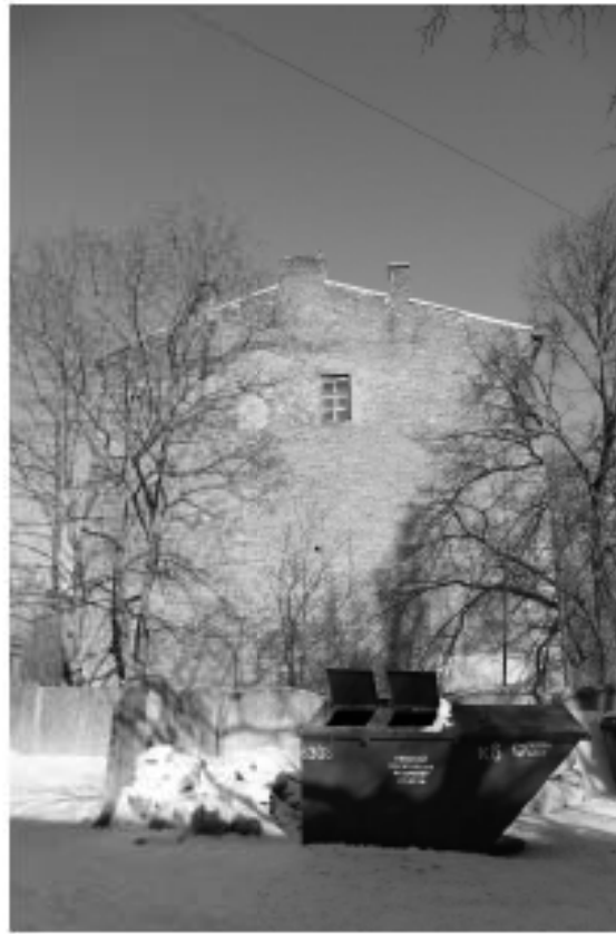
Фото 15. Юго-западный (торцевой) фасад. Общий вид.
