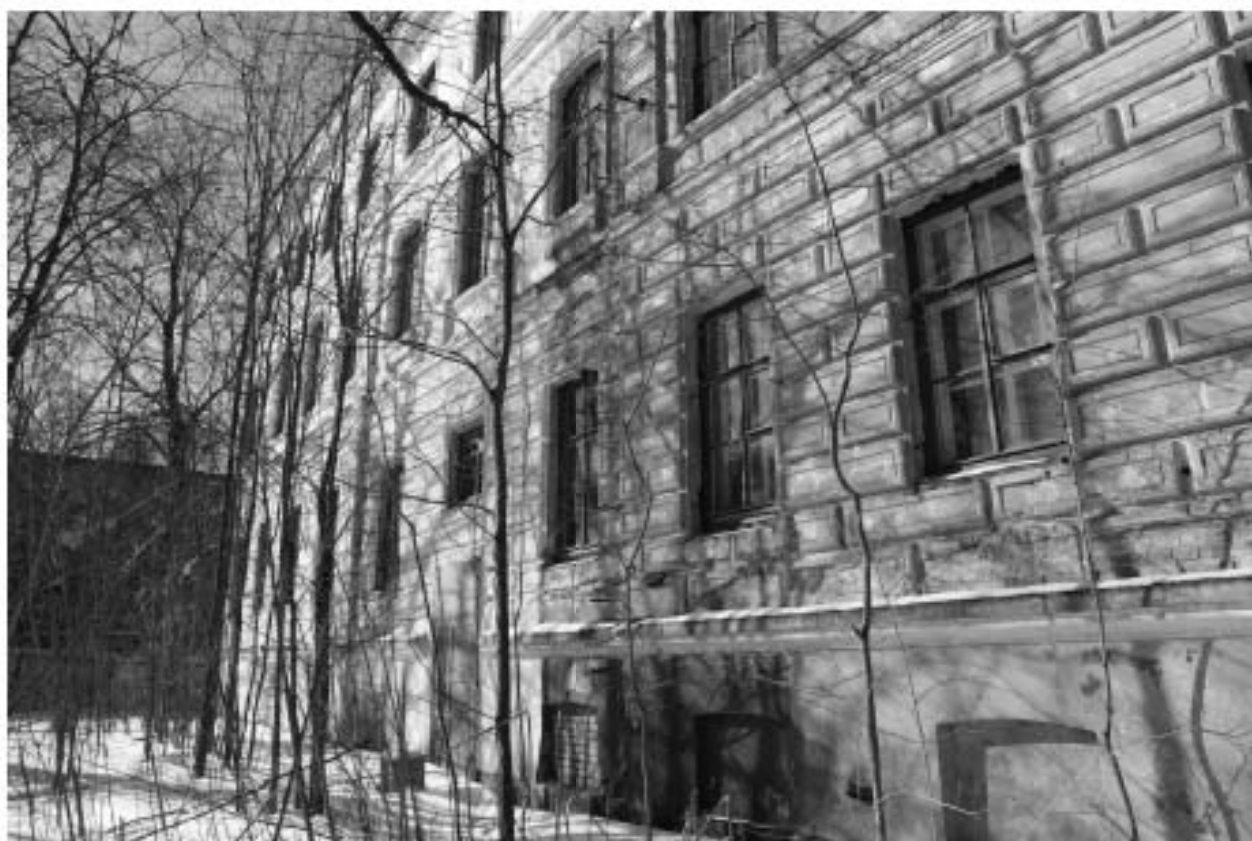
Фото 3. Юго-восточный фасад здания. Фрагмент.
