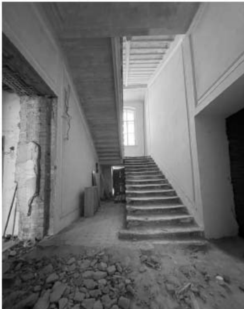
Фото 1.1. Центральная лестница. Площадка 1 этажа.
