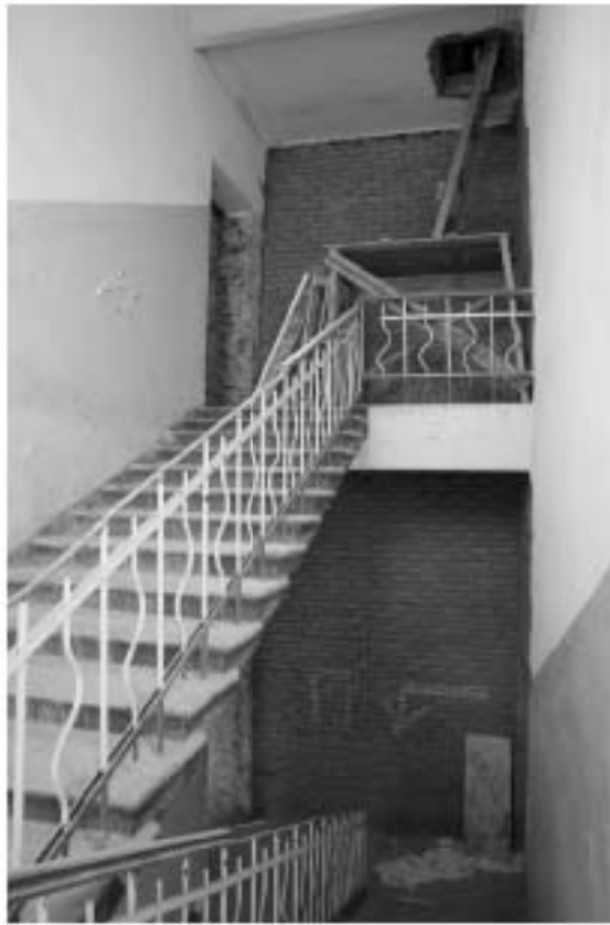
Фото 3.3. 3 этаж, лестница II.
