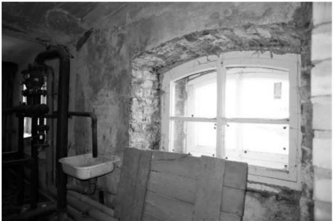
Фото п.10. Подвал, помещение 2.
