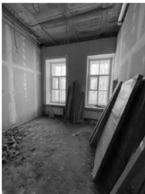
Фото 1.9, 1.10. 1 этаж. Помещения по западному фасаду.
