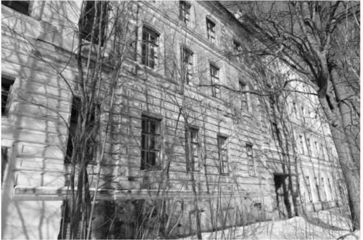
Фото 5. Юго-восточный фасад здания. Фрагмент.
