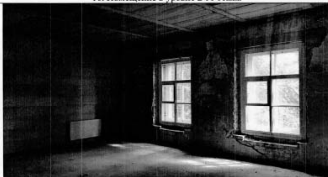
11. Помещение в уровне 2-го этажа
