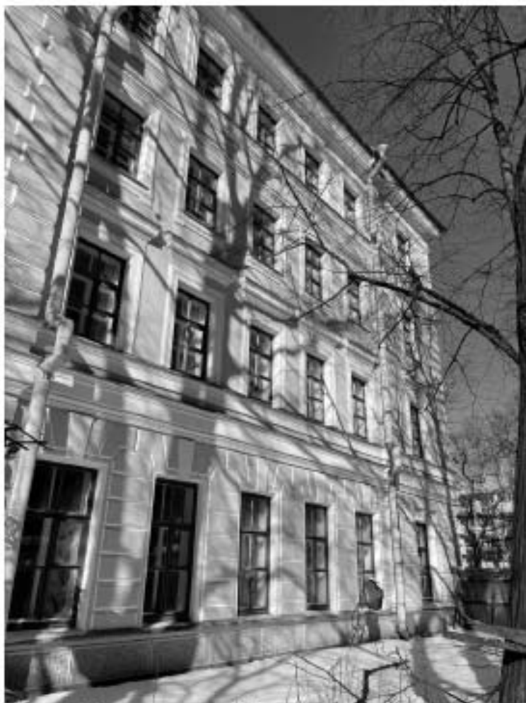
Фото 3. Юго-восточный фасад здания. Фрагмент.
