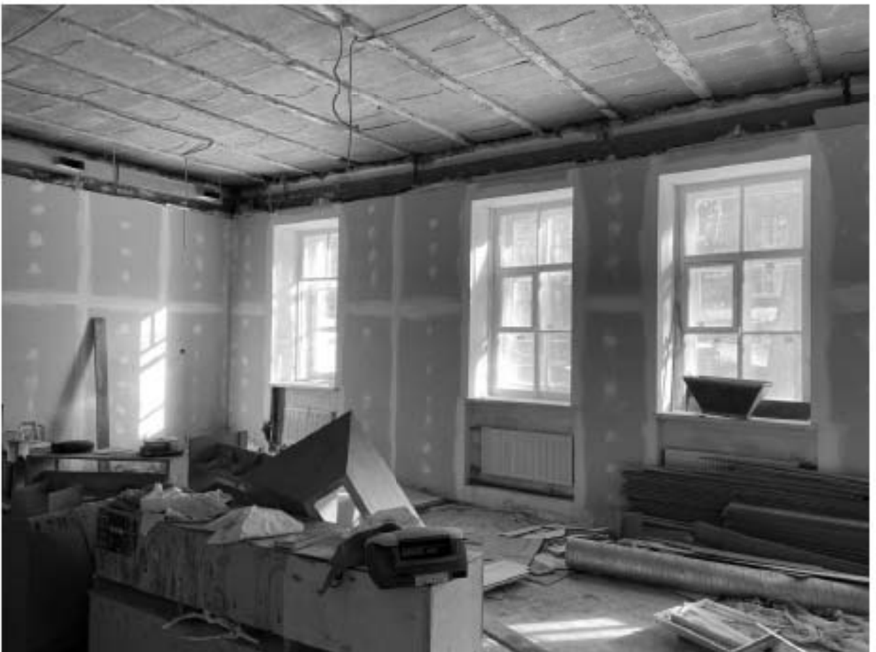
Фото 1.12. 1 этаж. Помещение по восточному фасаду.
