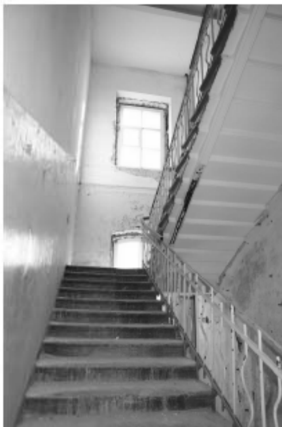
Фото 3.1. 3 этаж, лестница II.
