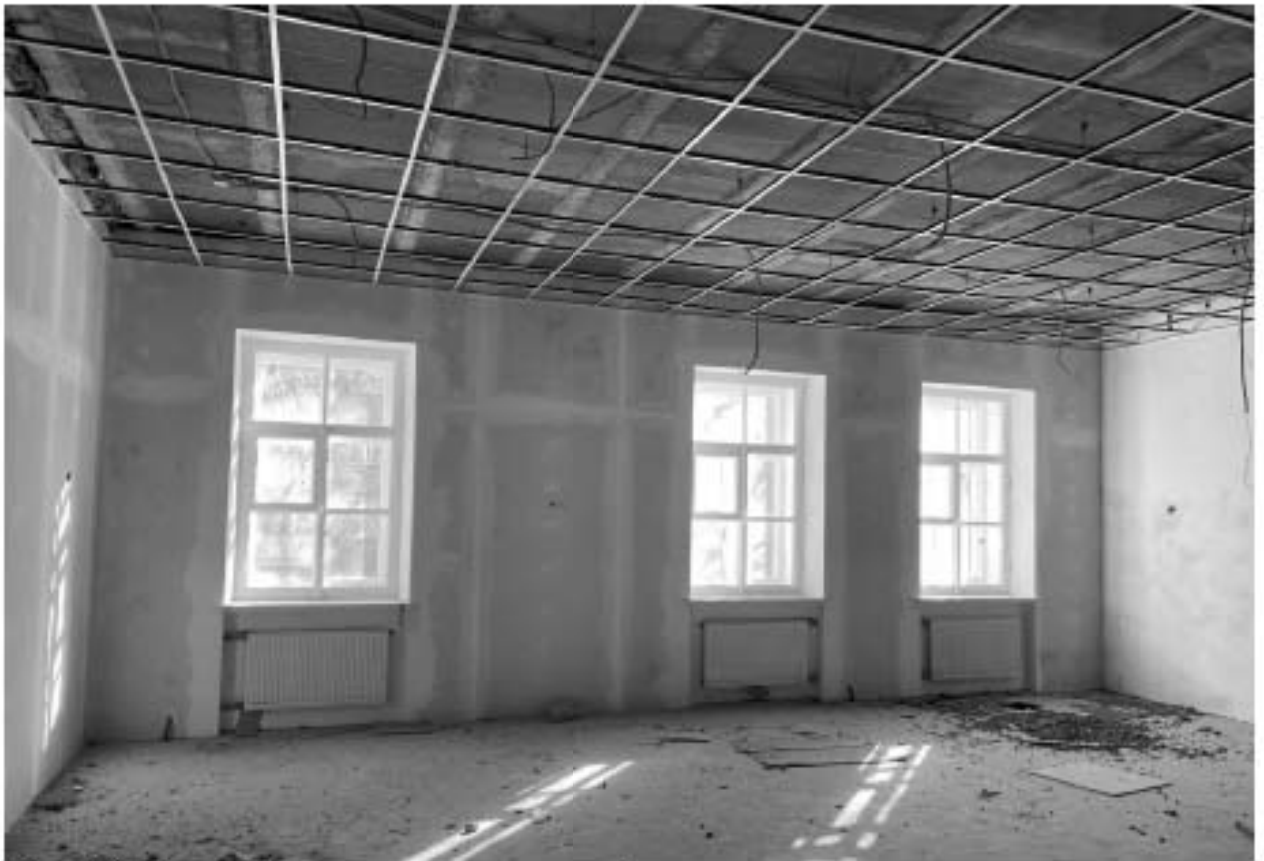
Фото 2.3. 2 этаж. Помещение по восточному фасаду.
