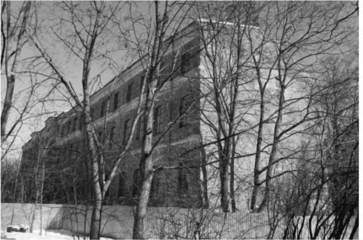
Фото 17. Юго-западный (торцевой) фасад. Общий вид.
