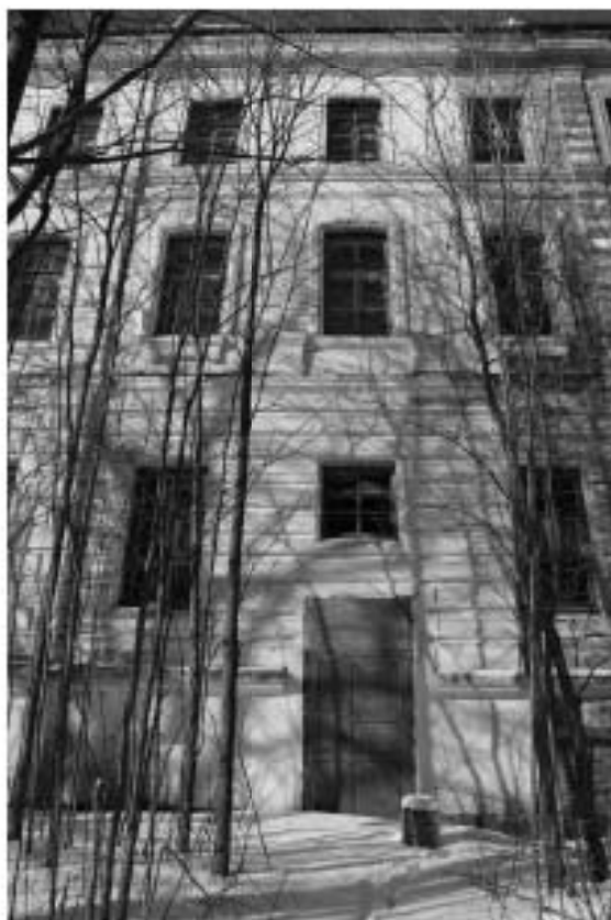
Фото 4. Юго-восточный фасад здания. Фрагмент.
