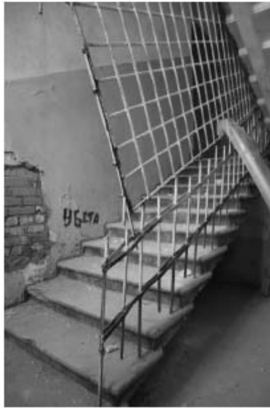
Фото 1.5. 1 этаж, лестница III.
