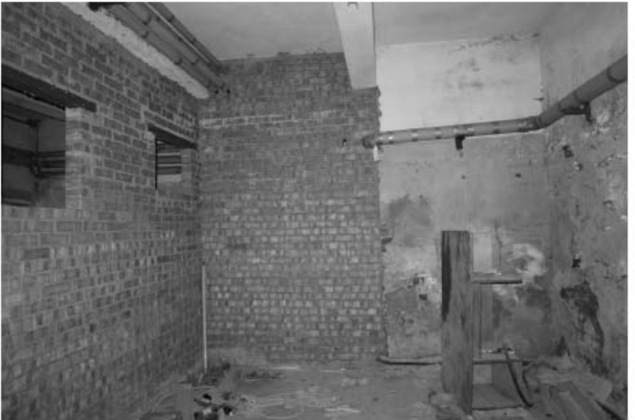
Фото п.4. Подвал, помещение 1.
