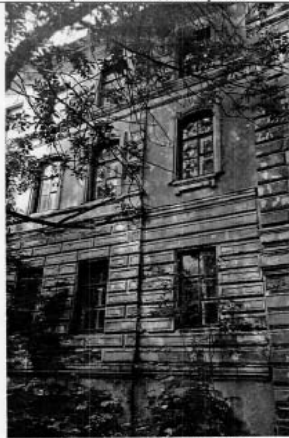
4. Фрагмент восточного фасада
