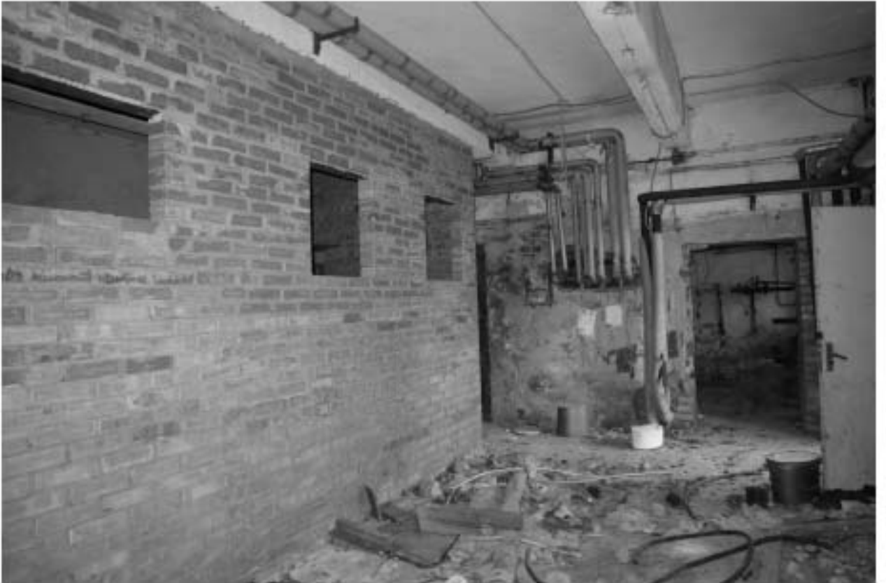
Фото п.3. Подвал, помещение 1.
