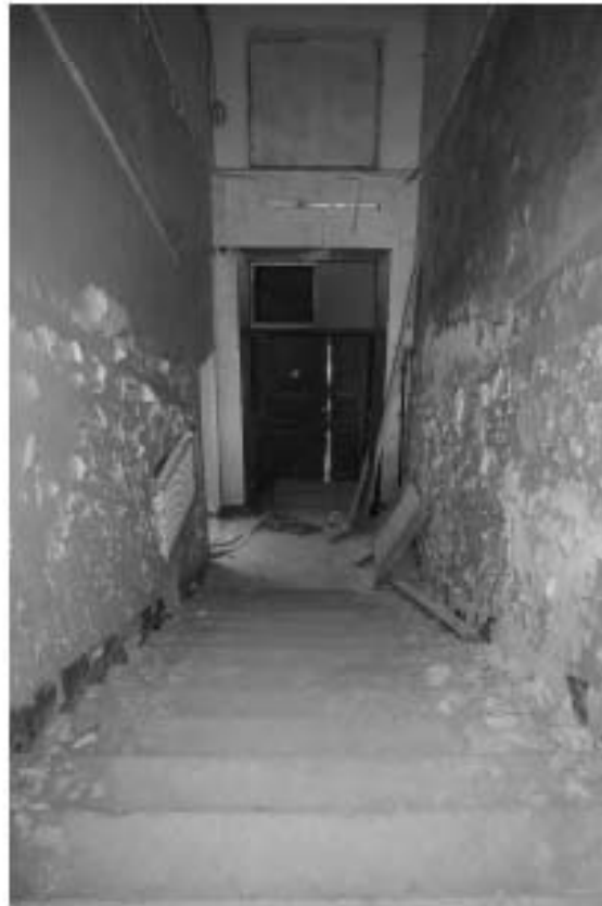
Фото 1.34. 1 этаж, лестница II.
