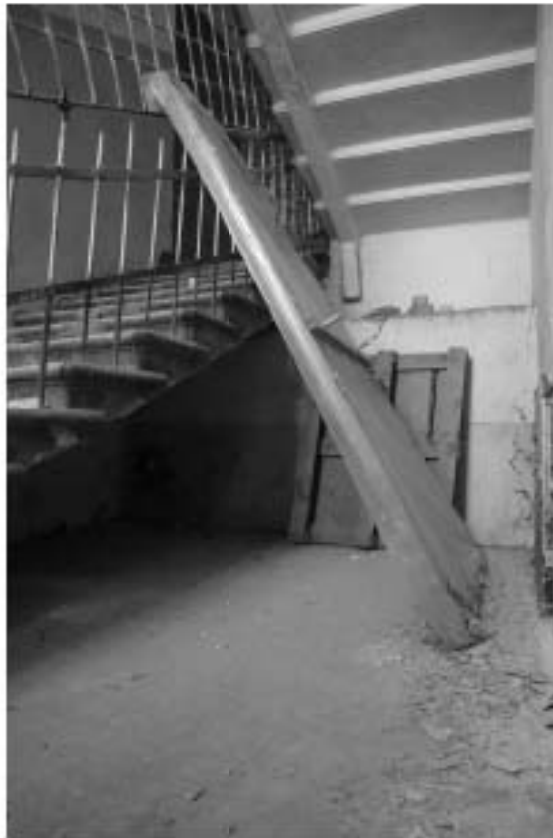
Фото 1.4. 1 этаж, лестница III.
