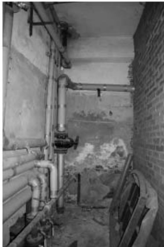
Фото п.2. Подвал, помещение 1.
