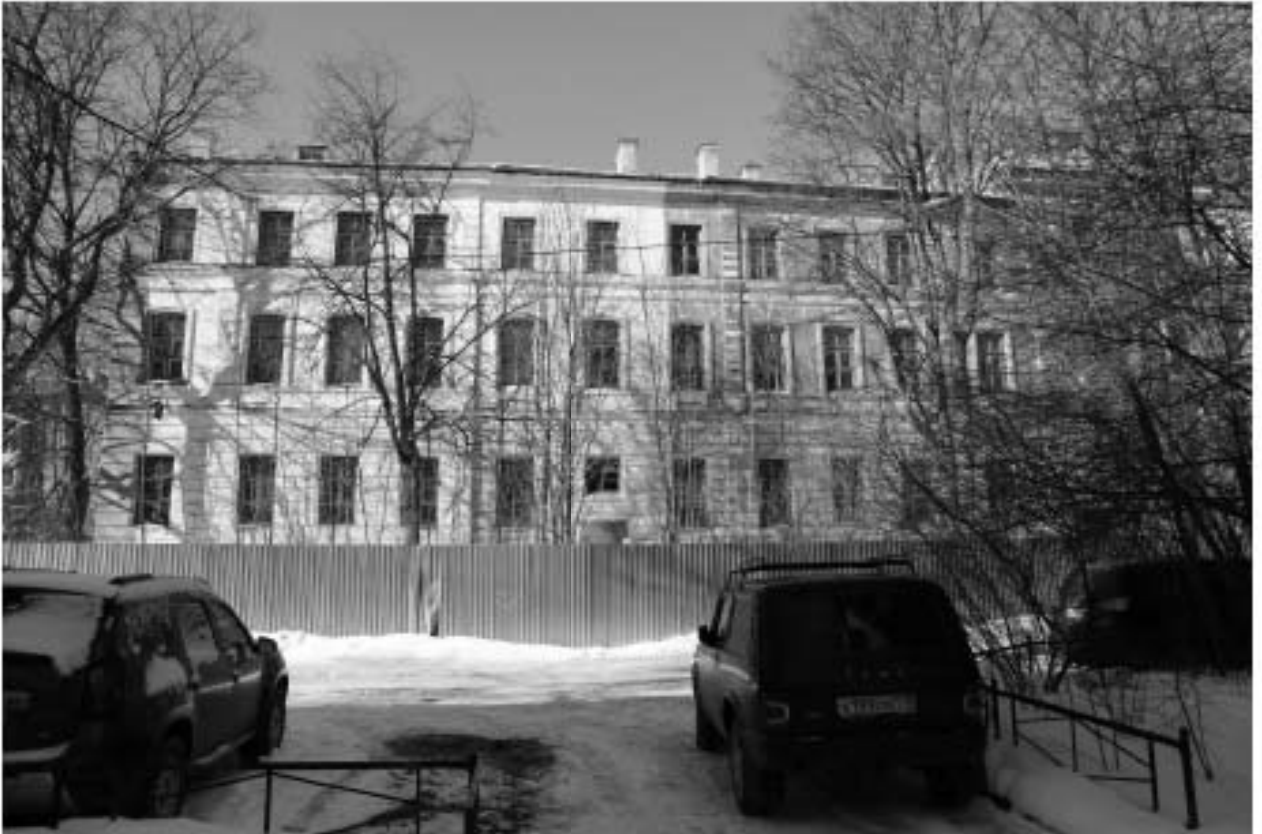
Фото 1. Юго-восточный фасад здания.
