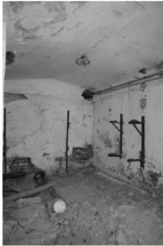
Фото п.9. Подвал, помещение 2.
