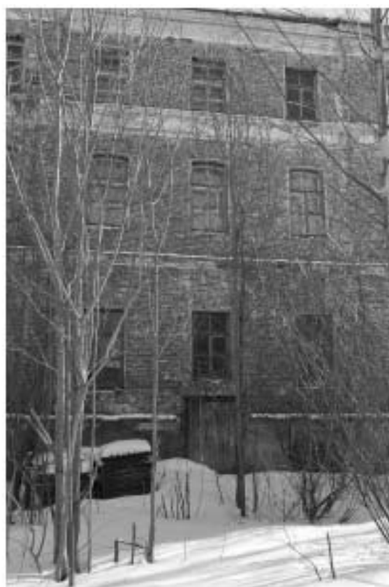
Фото 10. Северо-западный (дворовой) фасад. Фрагмент.
