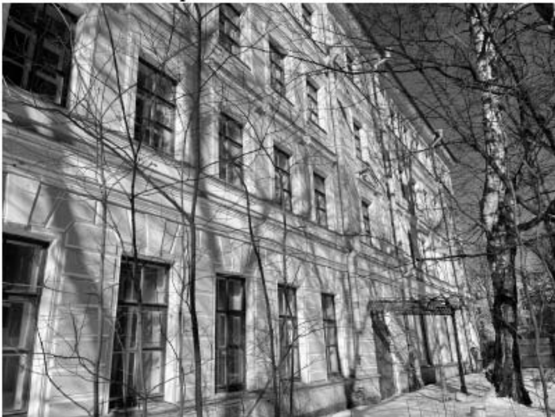
Фото 2. Юго-восточный фасад здания. Фрагмент.
