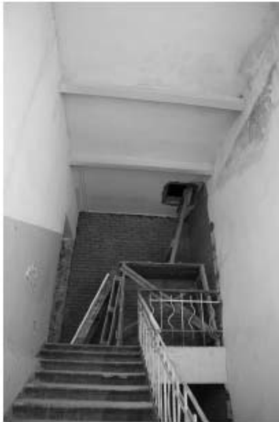
Фото 3.4. 3 этаж, лестница II.
