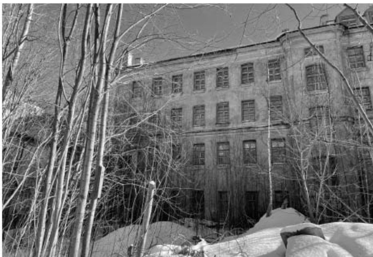
Фото 14. Северо-западный фасад. Фрагмент
