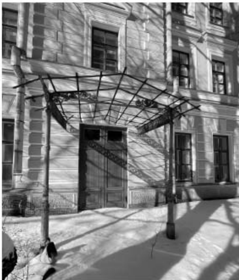
Фото 5. Навес над главным входом. Юго-восточный фасад.
