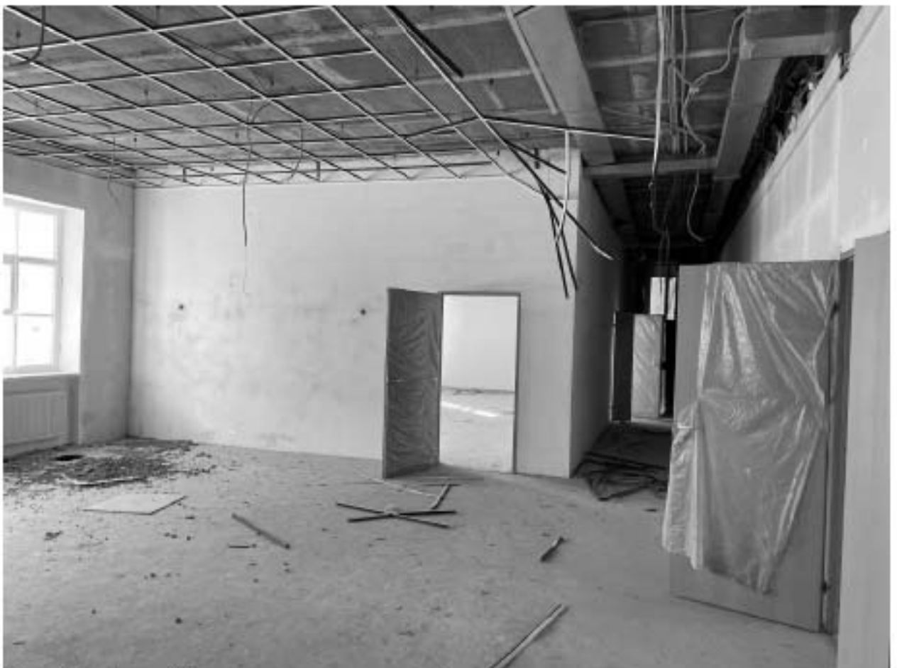
Фото 2.4. 2 этаж. Помещение по восточному фасаду
