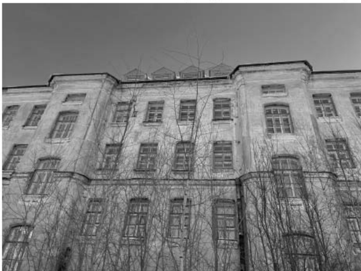
Фото 13. Северо-западный фасад. Фрагмент.
