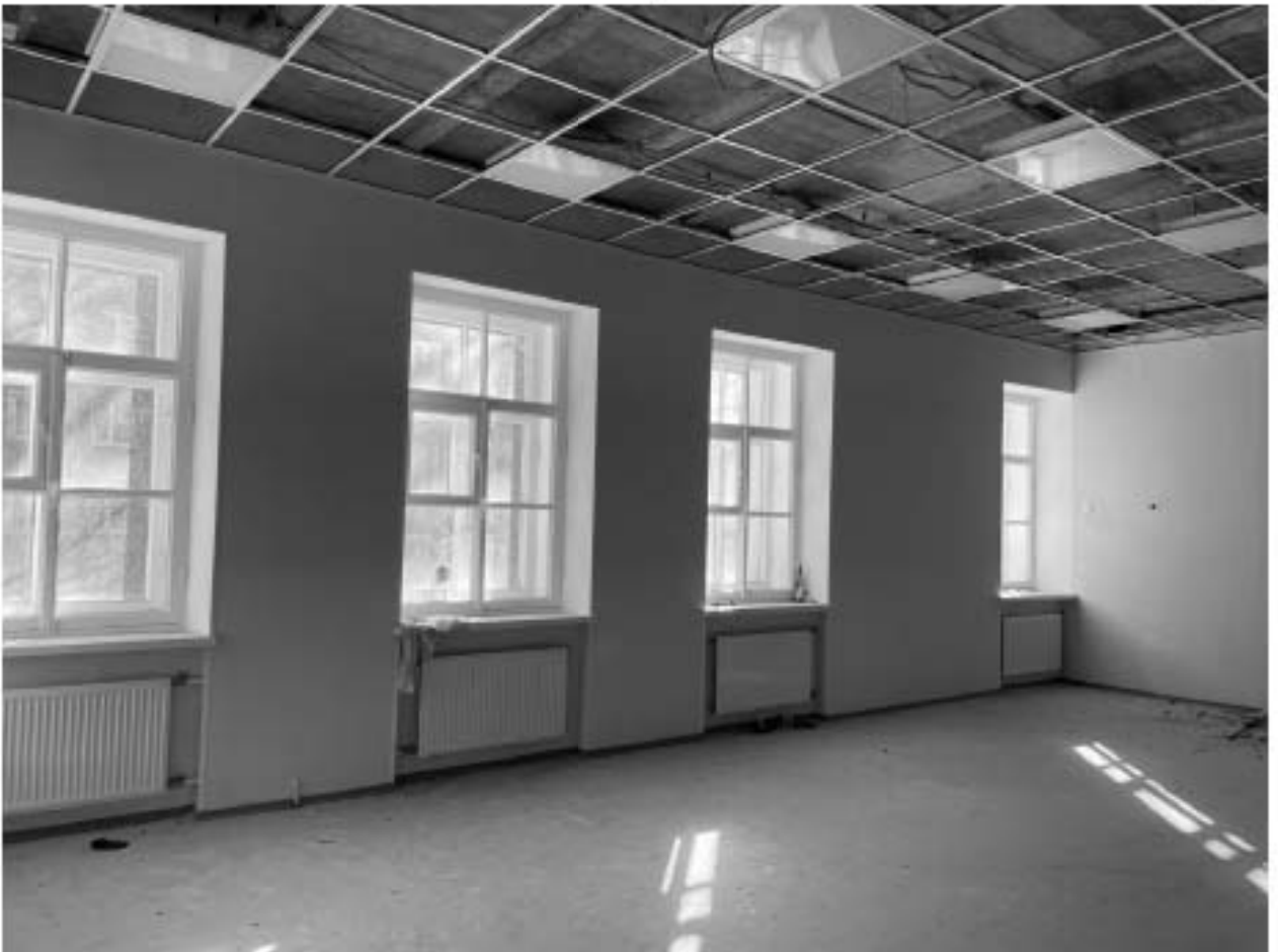
Фото 2.15. 2 этаж. Помещения по восточному фасаду.
