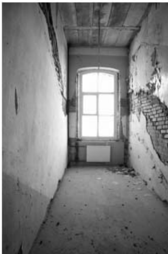
Фото 2.21. 2 этаж, лестничная клетка лестницы I*.
