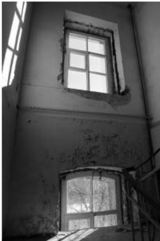
Фото 3.2. 3 этаж, лестничная площадка, лестница II.
