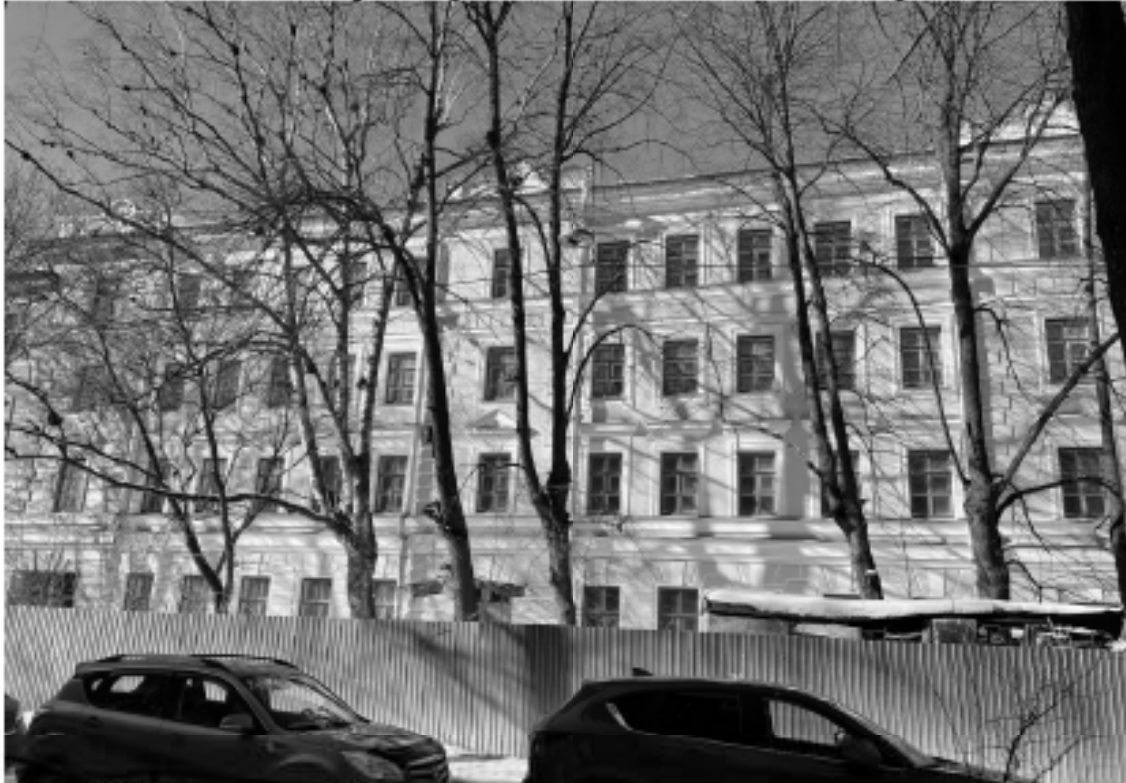
Фото 1. Юго-восточный фасад здания
