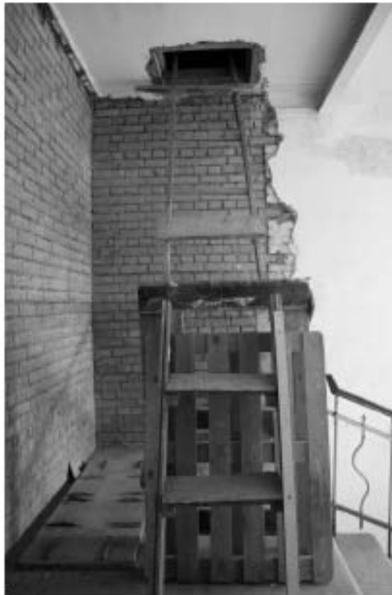
Фото 3.6. 3 этаж, лестничная площадка, лестница II.
