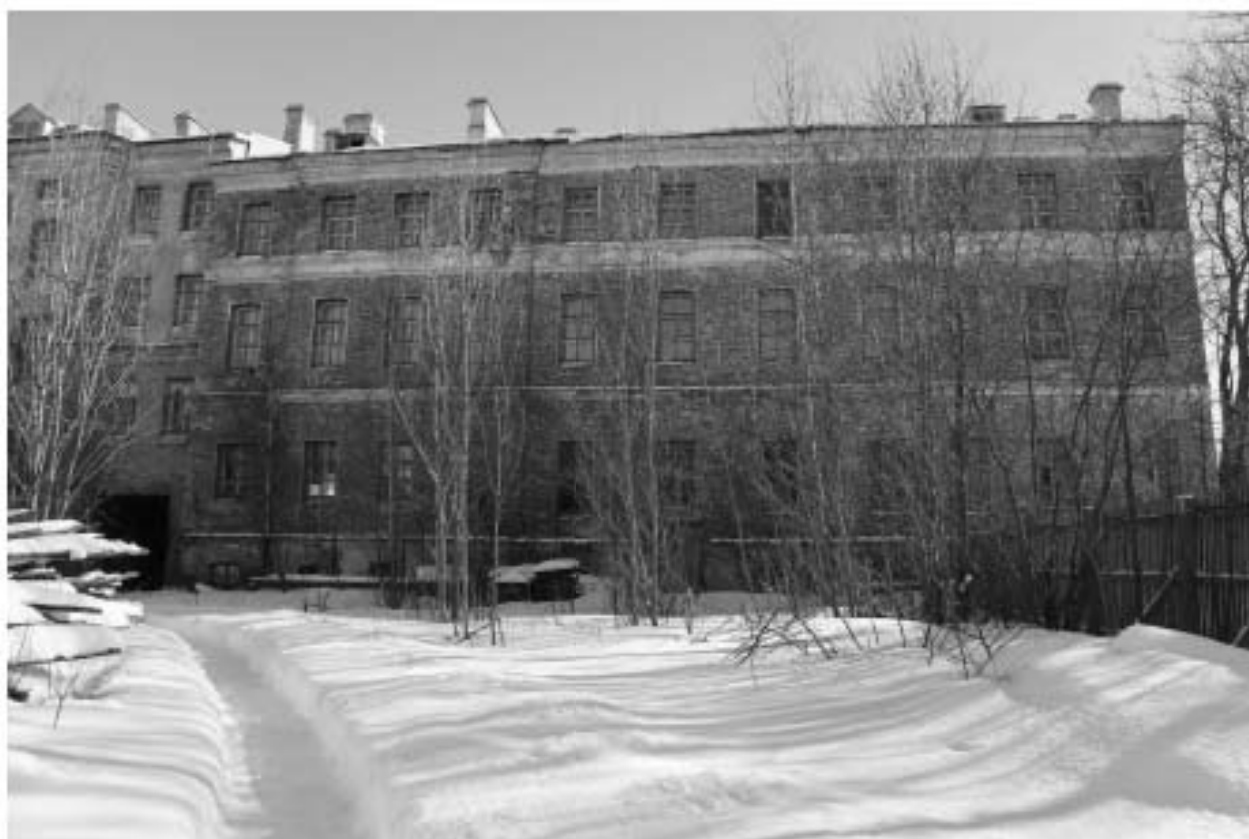
Фото 9. Северо-западный (дворовой) фасад. Общий вид.
