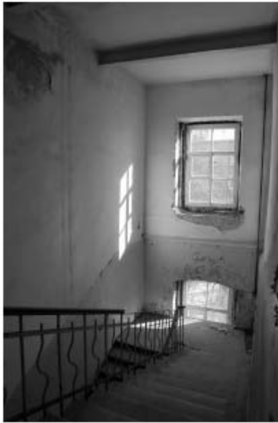
Фото 3.5. 3 этаж, лестница II.
