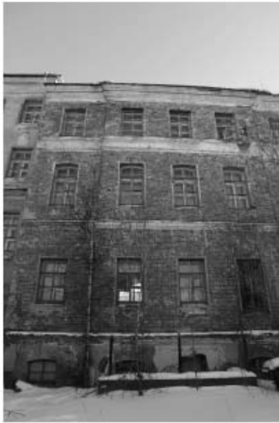
Фото 11. Северо-западный (дворовой) фасад. Фрагмент.
