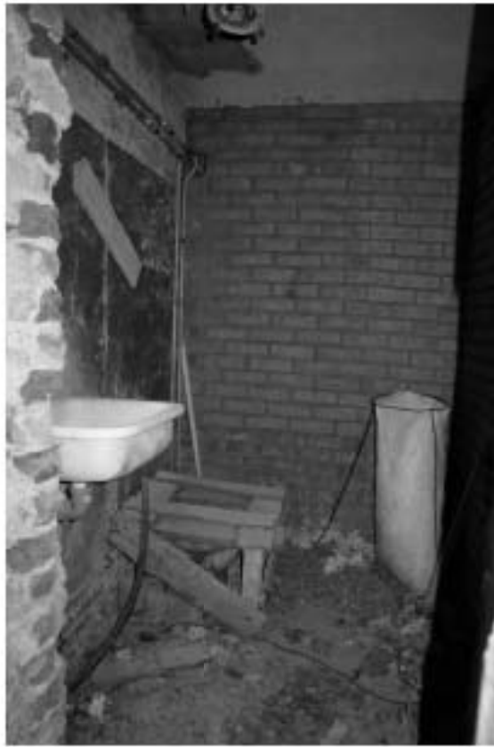
Фото п.7. Подвал, помещение 3.
