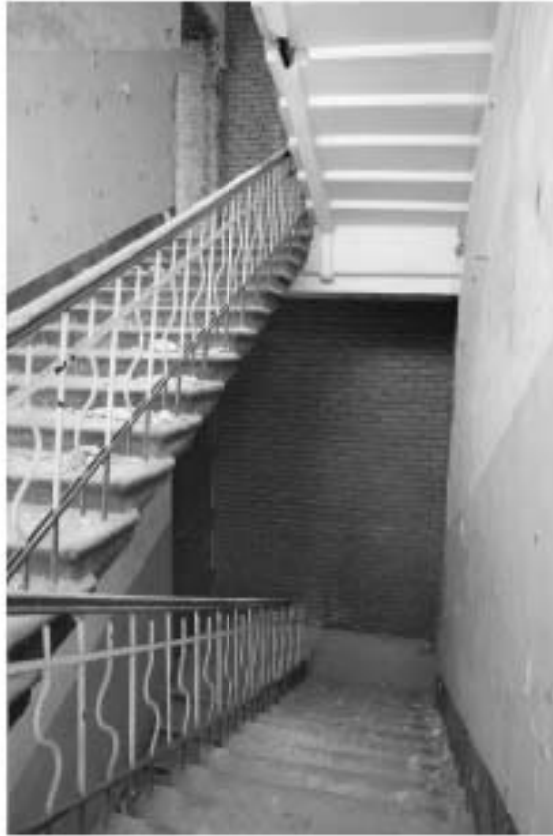
Фото 1.1. 1 этаж, лестница III.
