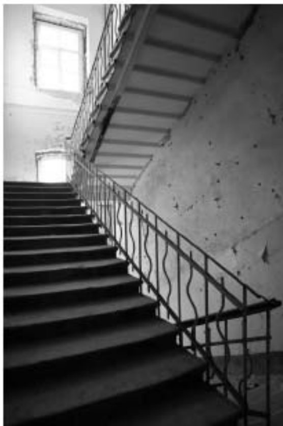
Фото 2.27. 2 этаж, лестница II.
