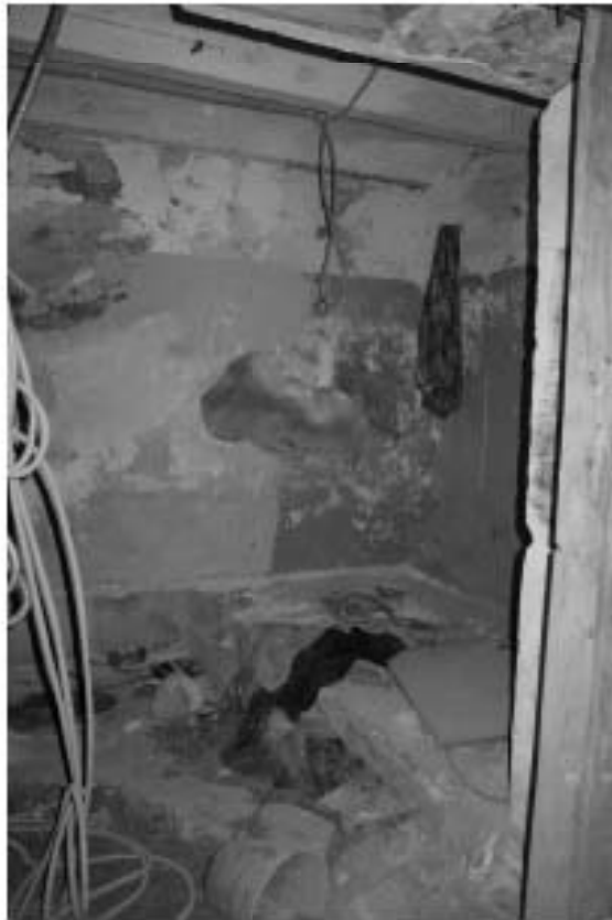
Фото п.6. Подвал, помещение 5.
