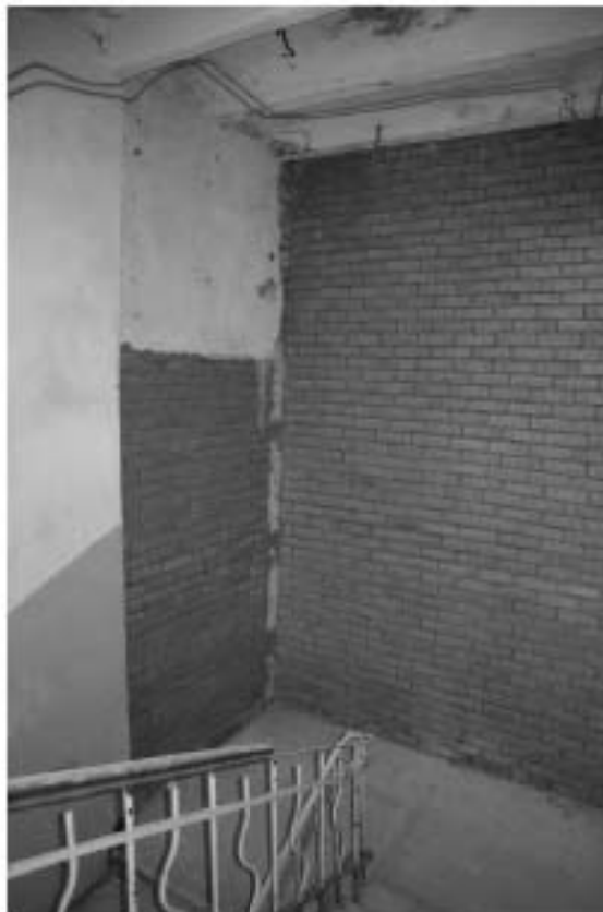
Фото 1.2. 1 этаж, лестничная площадка, лестница III.
