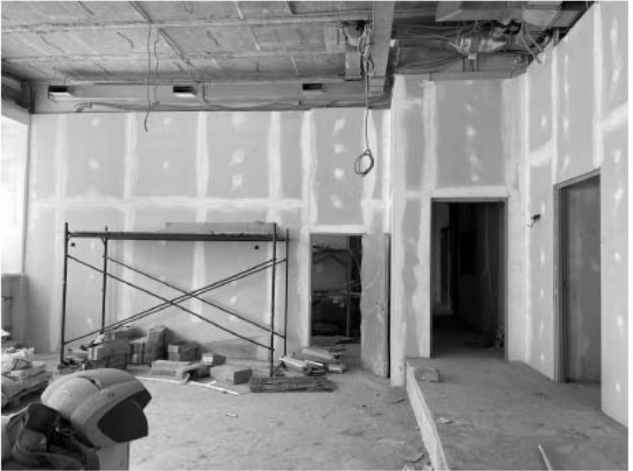
Фото 1.13. 1 этаж. Помещение по восточному фасаду
