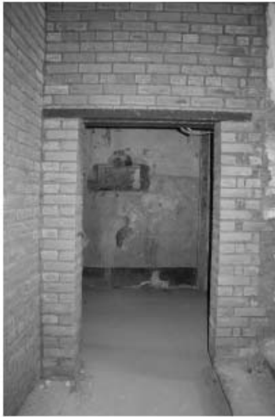
Фото 1.3. 1 этаж, лестничная площадка, лестница III.
