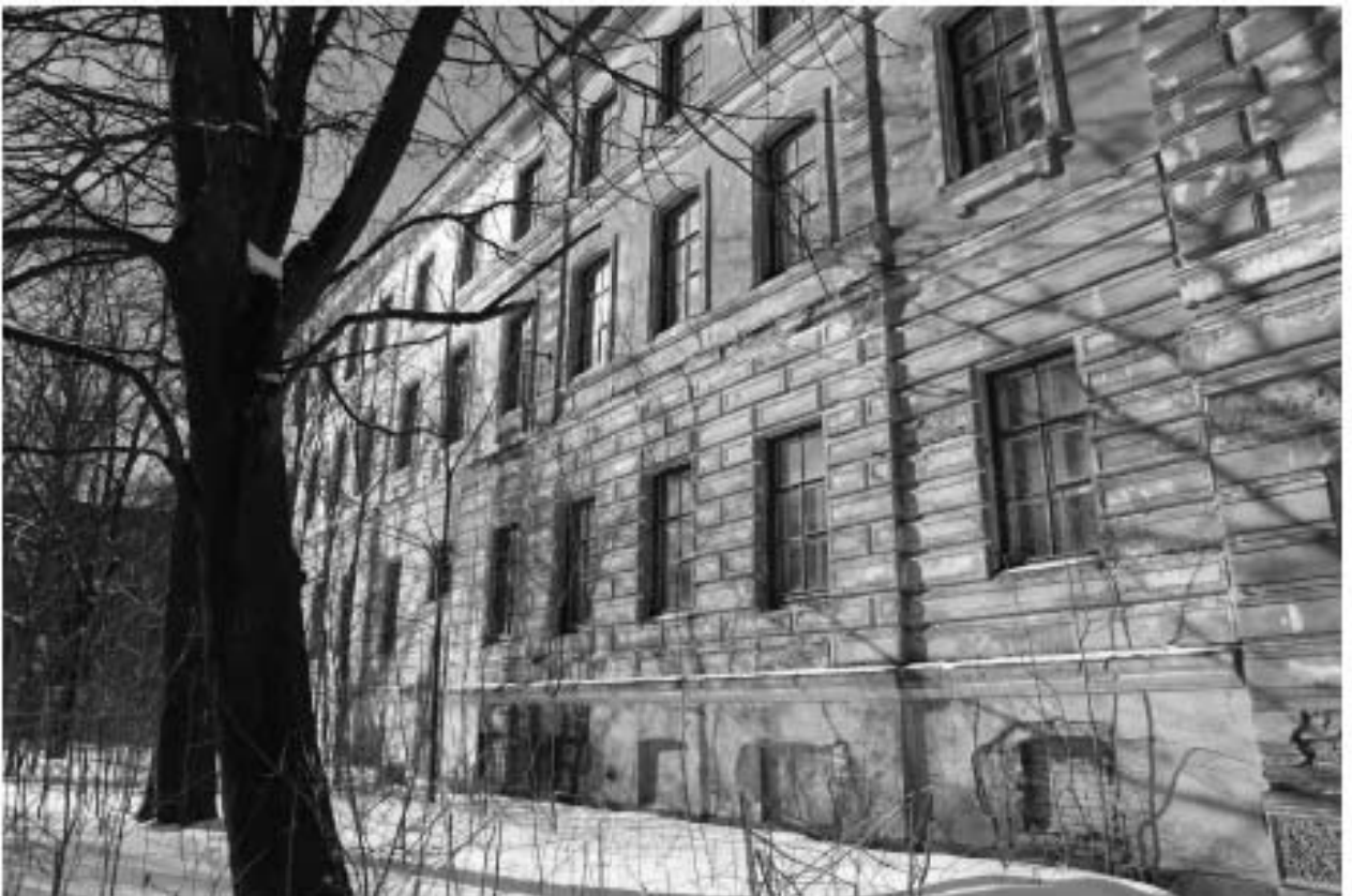
Фото 2. Юго-восточный фасад здания. Фрагмент.
