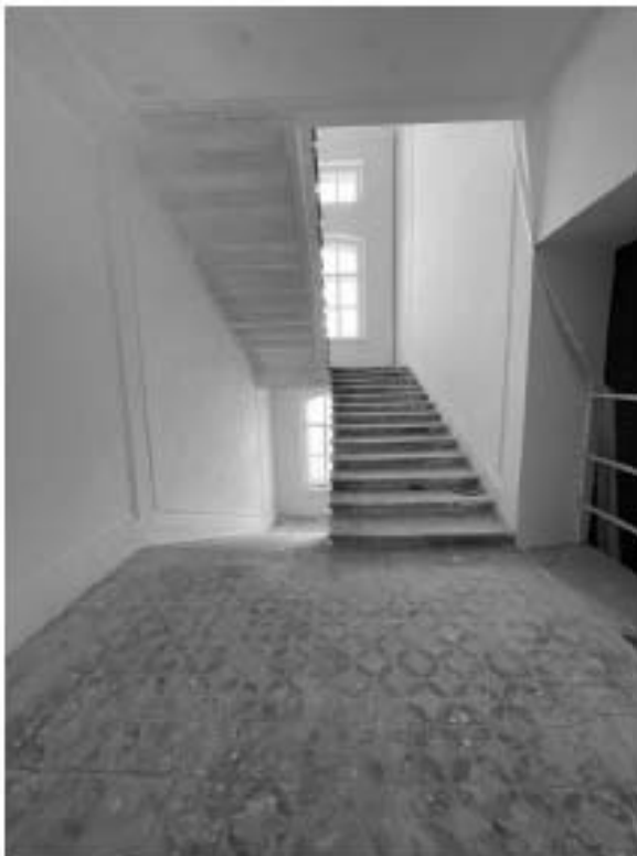
Фото 3.10. Площадка 3 этажа центральной лестницы.
