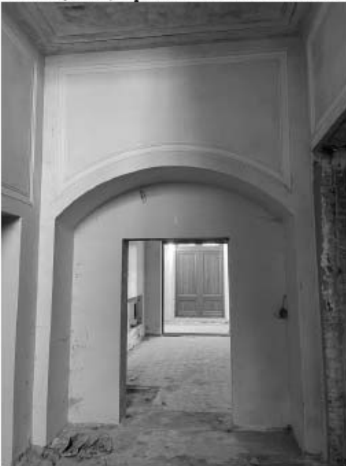
Фото 1.4. Площадка 1 этажа центральной лестницы.
