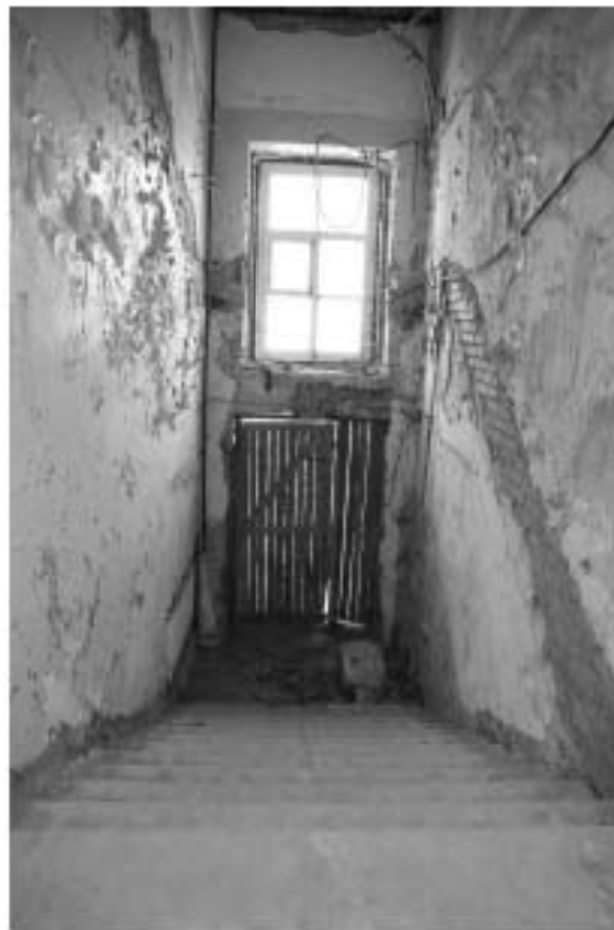
Фото 1.36. 1 этаж, лестница I.
