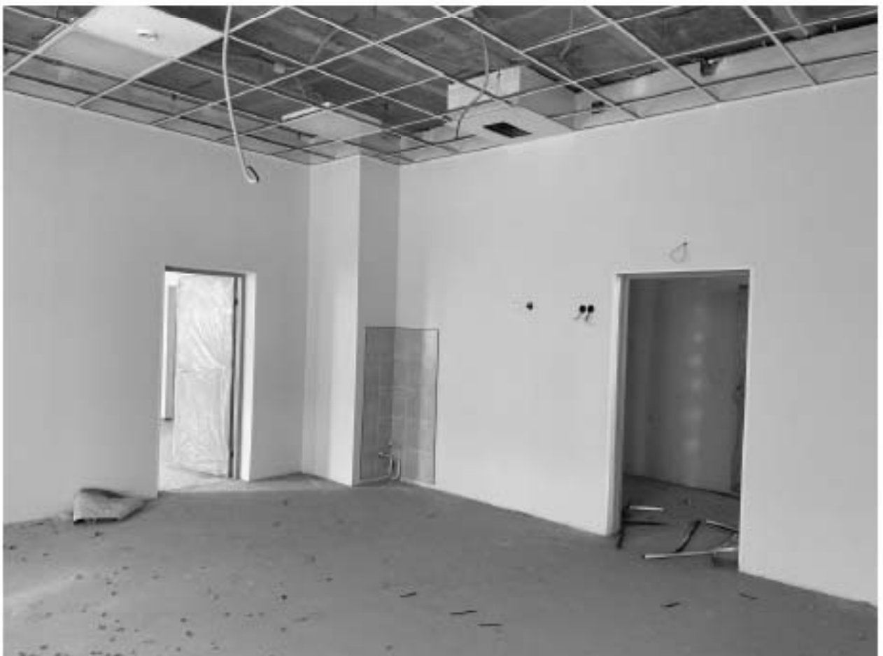
Фото 2.12. 2 этаж. Помещения по восточному фасаду.
