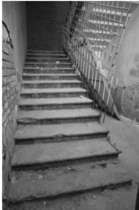
Фото 1.6. 1 этаж, лестница III.
