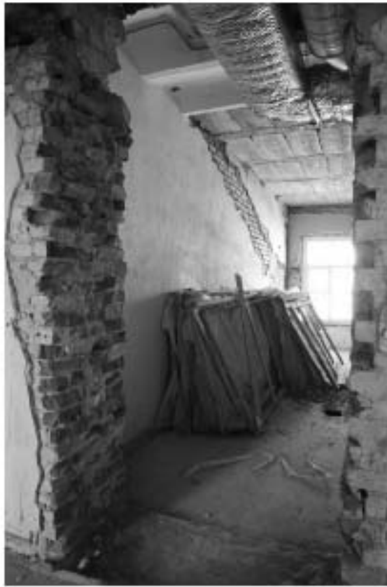
Фото 3.23. 3 этаж, лестничная клетка лестницы I*.
