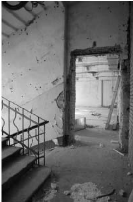
Фото 2.26. 2 этаж, лестничная площадка, лестница II.
