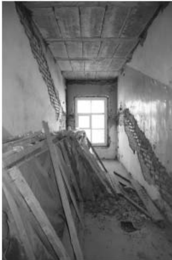
Фото 3.24. 3 этаж, лестничная клетка лестницы I*.
