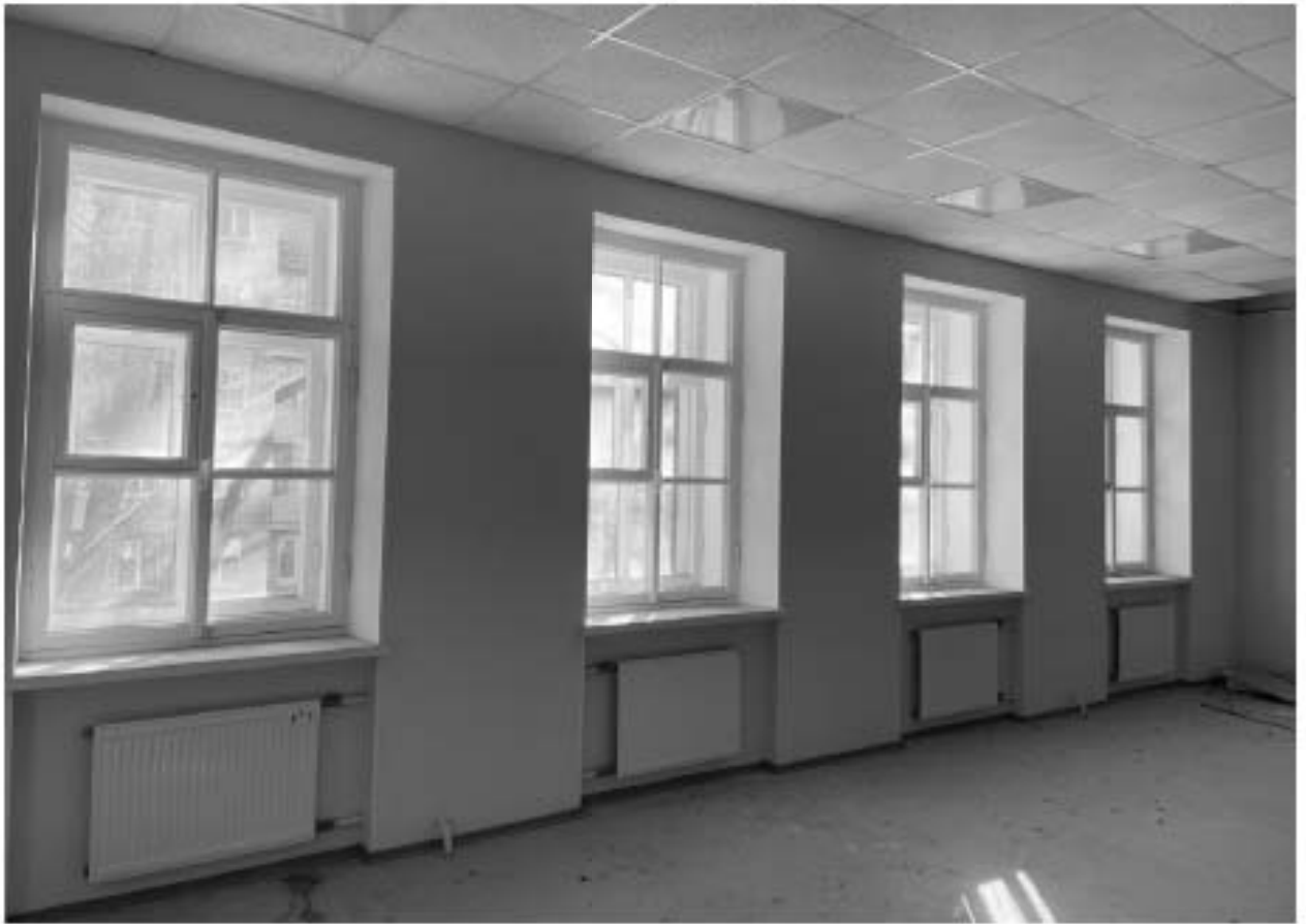
Фото 2.13. 2 этаж. Помещения по восточному фасаду.
