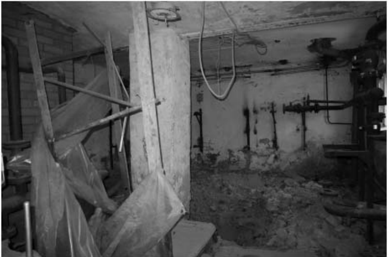
Фото п.8. Подвал, помещение 2.
