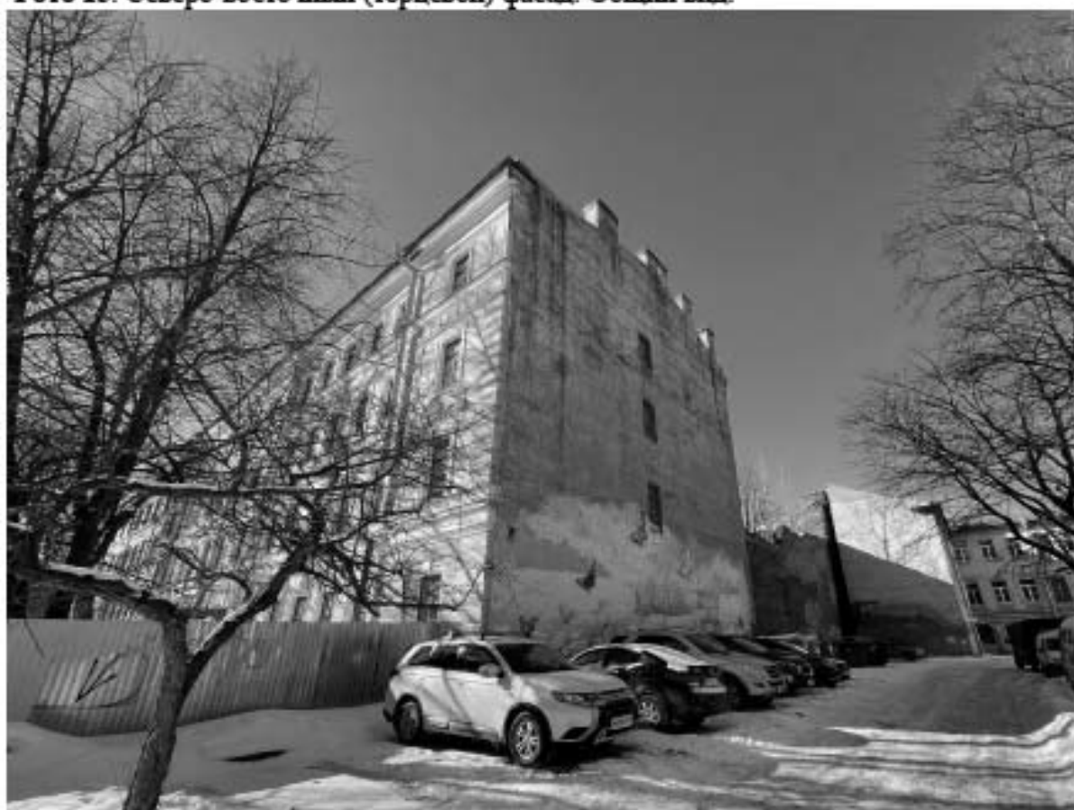
Фото 16. Северо-восточный (торцевой) фасад. Общий вид.
