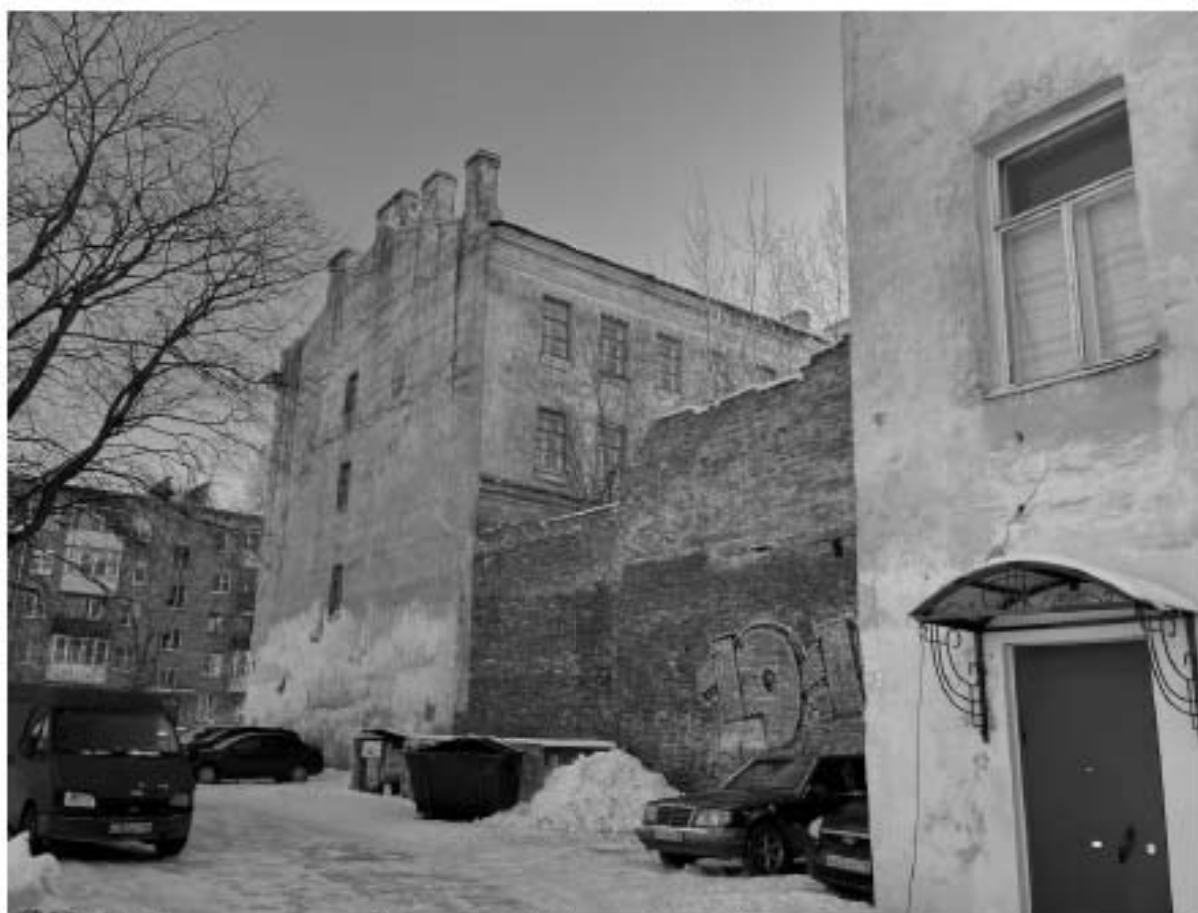
Фото 15. Северо-восточный (торцевой) фасад. Общий вид.
