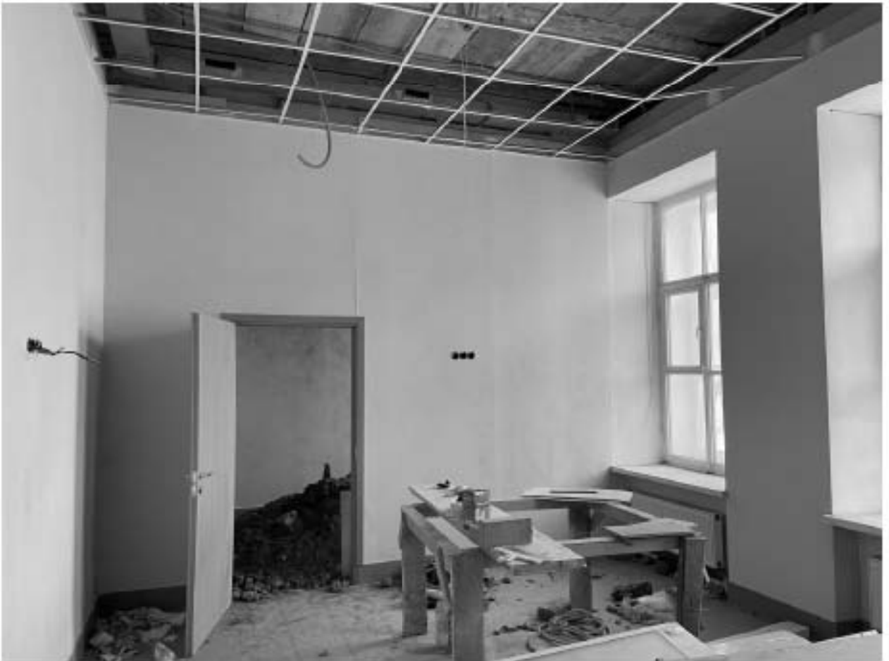
Фото 1.20. 1 этаж. Помещение по западному фасаду.
