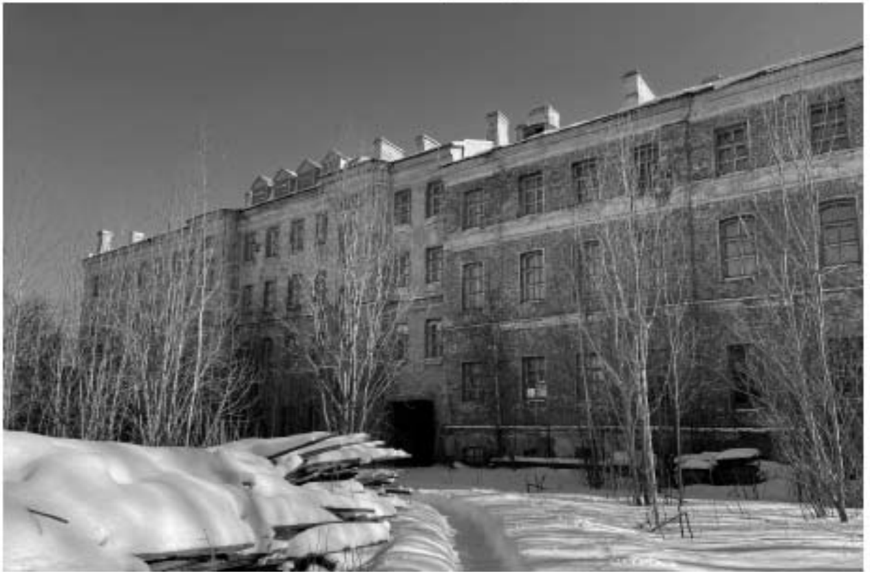
Фото 9. Северо-западный (дворовой) фасад. Общий вид.
