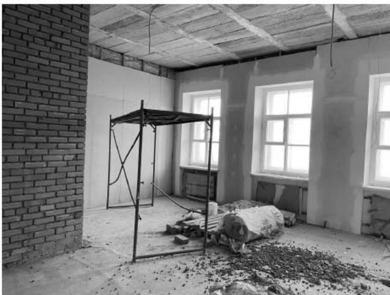
Фото 2.7. 2 этаж. Помещение по западному фасаду.
