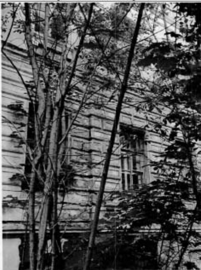
3. Фрагмент восточного фасада
