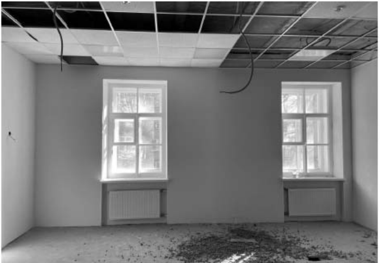
Фото 2.11. 2 этаж. Помещения по восточному фасаду.
