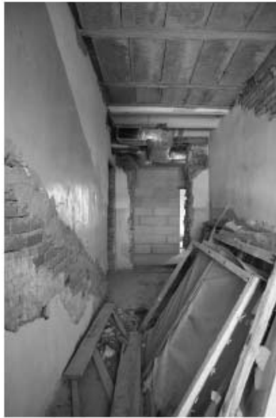
Фото 3.25. 3 этаж, лестничная клетка лестницы I*.
