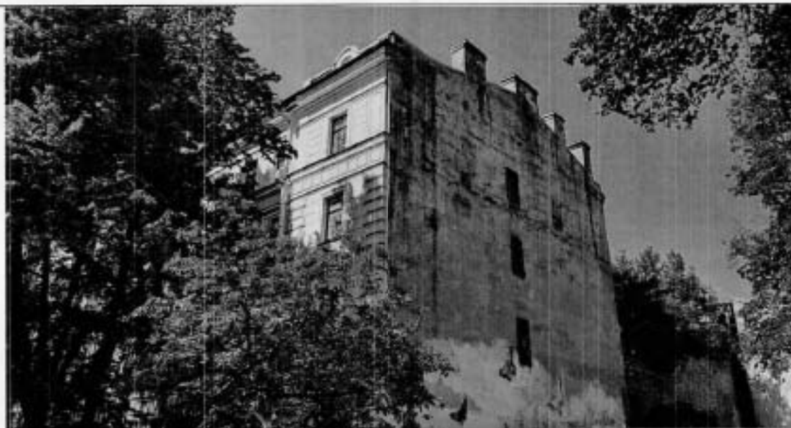
1. Северо-восточный угол здания
