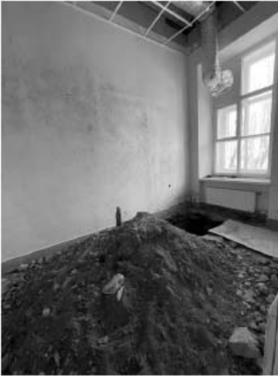
Фото 1.21. 1 этаж. Помещение по западному фасаду.
