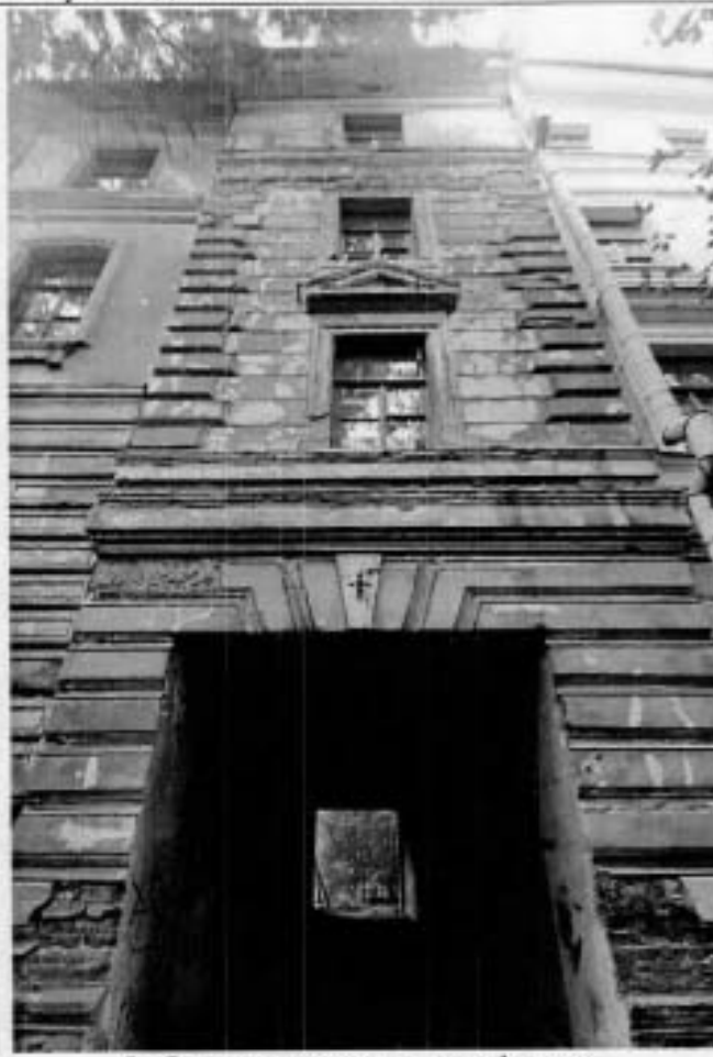
3. Фрагмент восточного фасада
