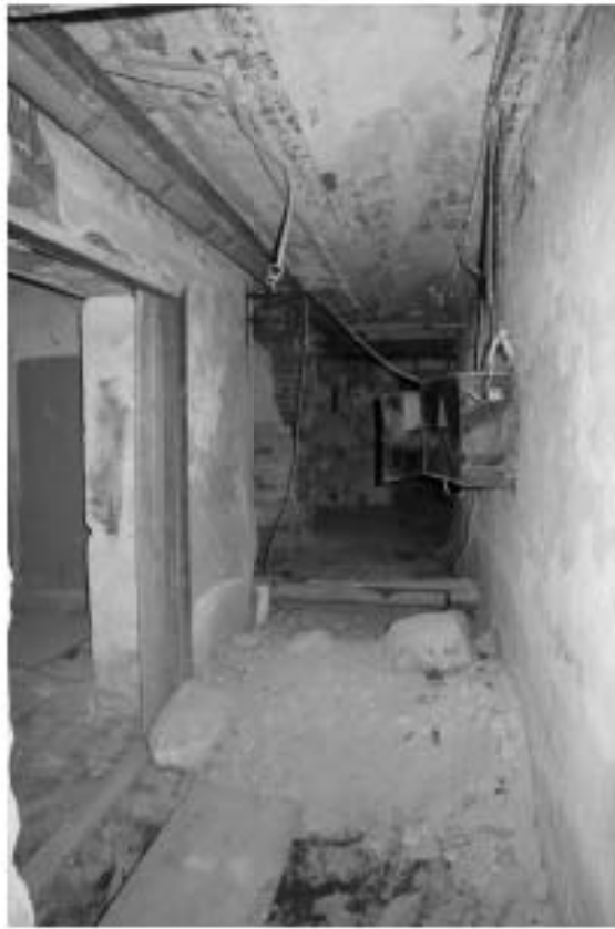
Фото п.5. Подвал, помещение 4.
