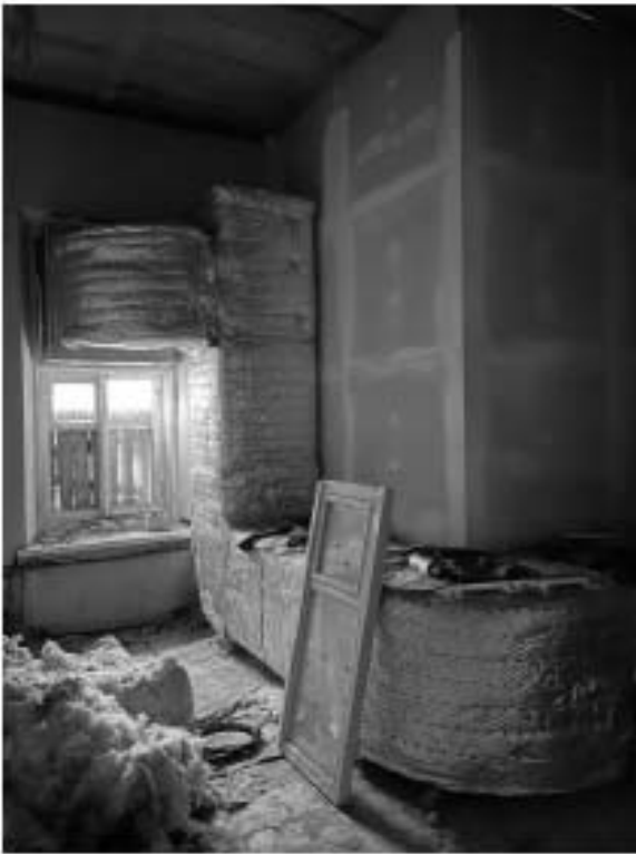
Фото 1.11. 1 этаж. Помещение по западному фасаду
