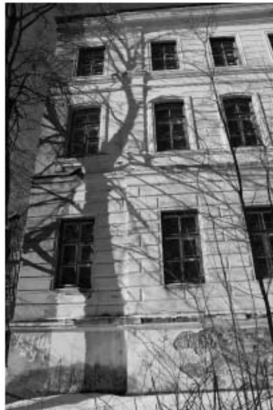
Фото 6. Юго-восточный фасад здания. Фрагмент.
