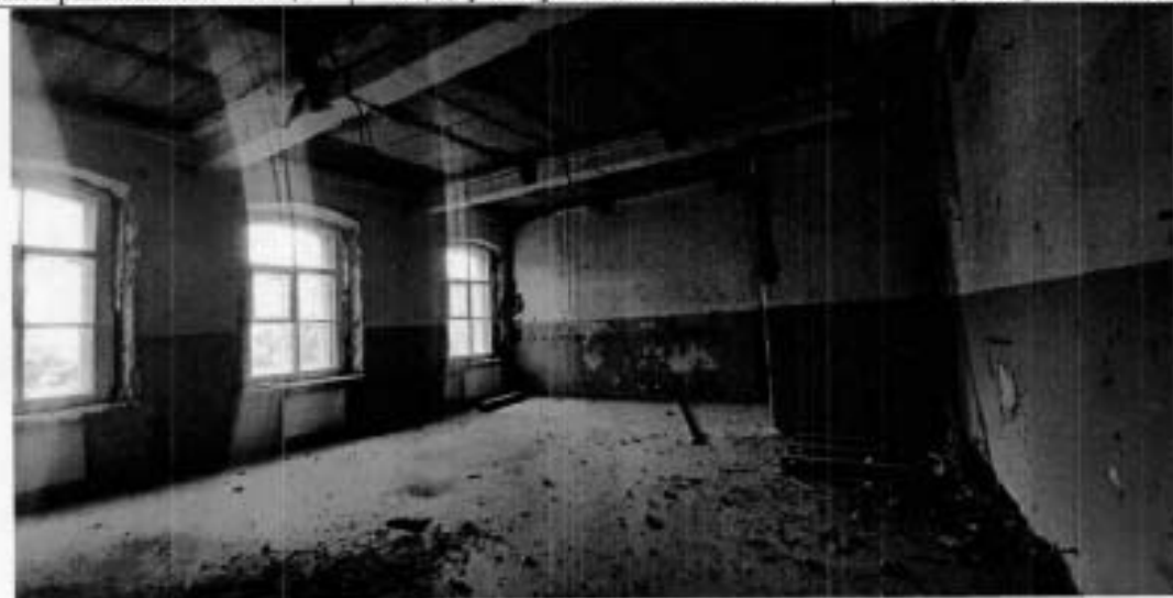
9. Помещение в уровне 2-го этажа
