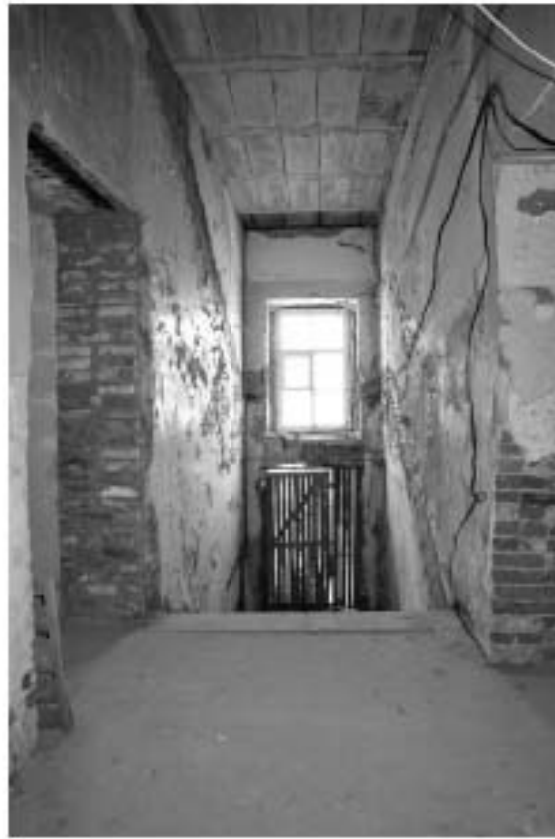
Фото 1.35. 1 этаж, помещение 1, лестница I.
