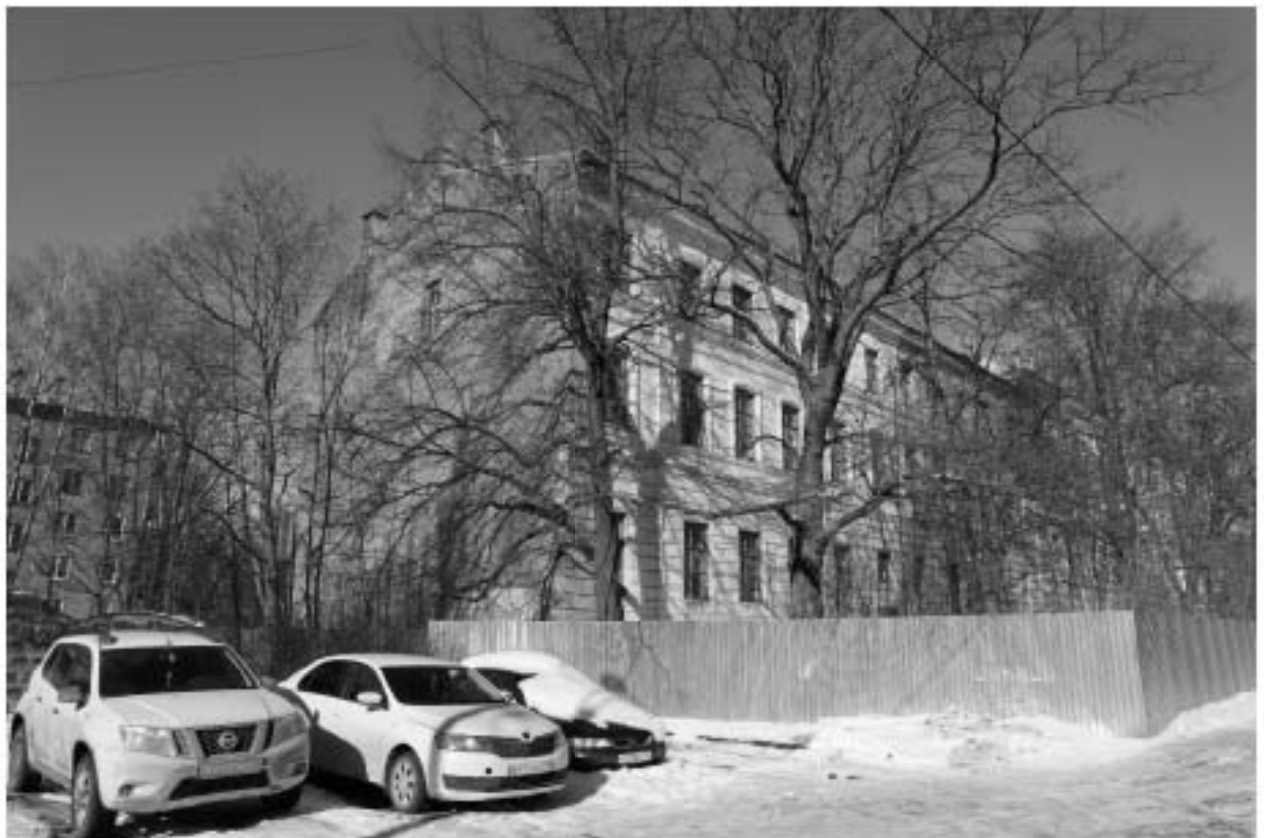
Фото 14. Северо-западный (дворовой) фасад. Фрагмент.
