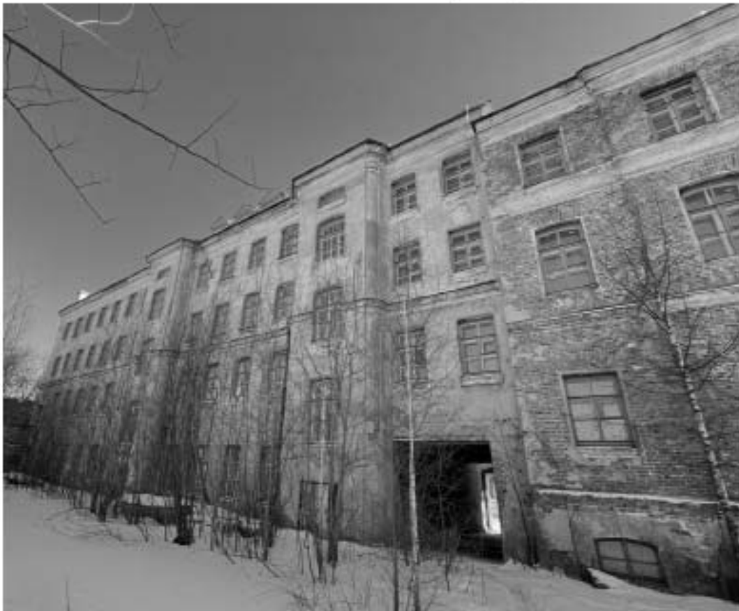
Фото 11. Северо-западный (дворовой) фасад. Общий вид
