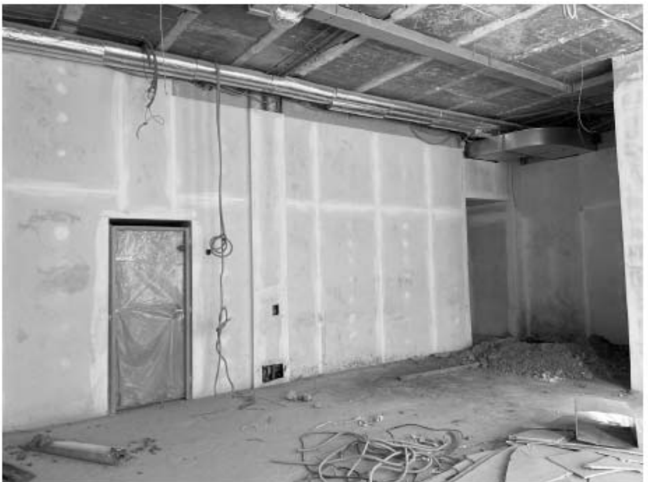
Фото 1.17. 1 этаж. Помещения по восточному фасаду.
