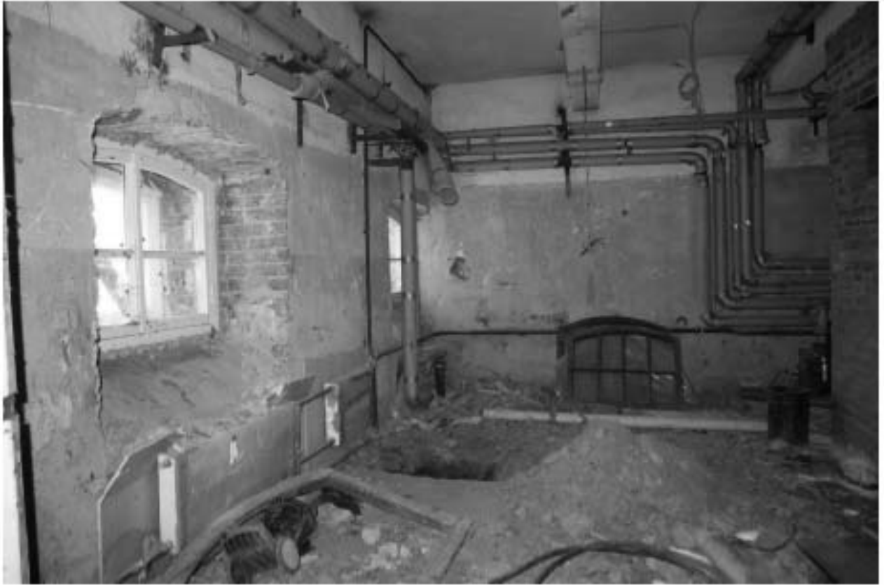
Фото п.1. Подвал, помещение 1.
