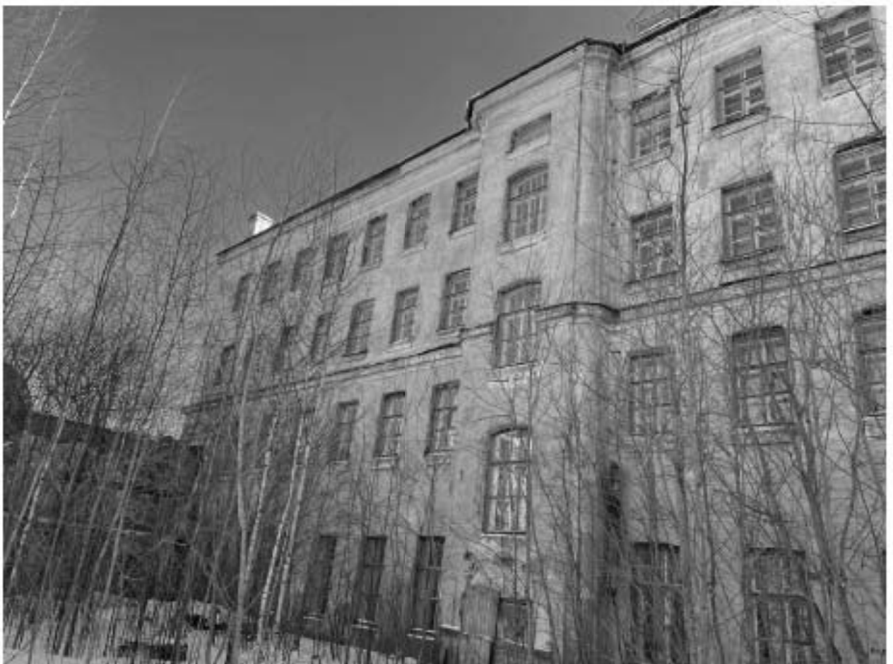
Фото 12. Северо-западный фасад. Фрагмент.
