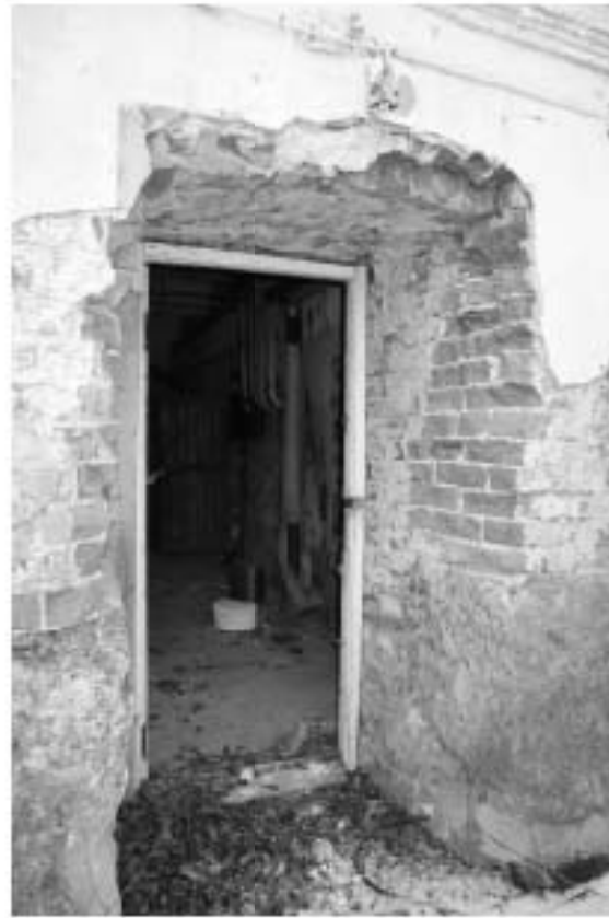
Фото 13. Северо-западный (дворовой) фасад. Фрагмент.
