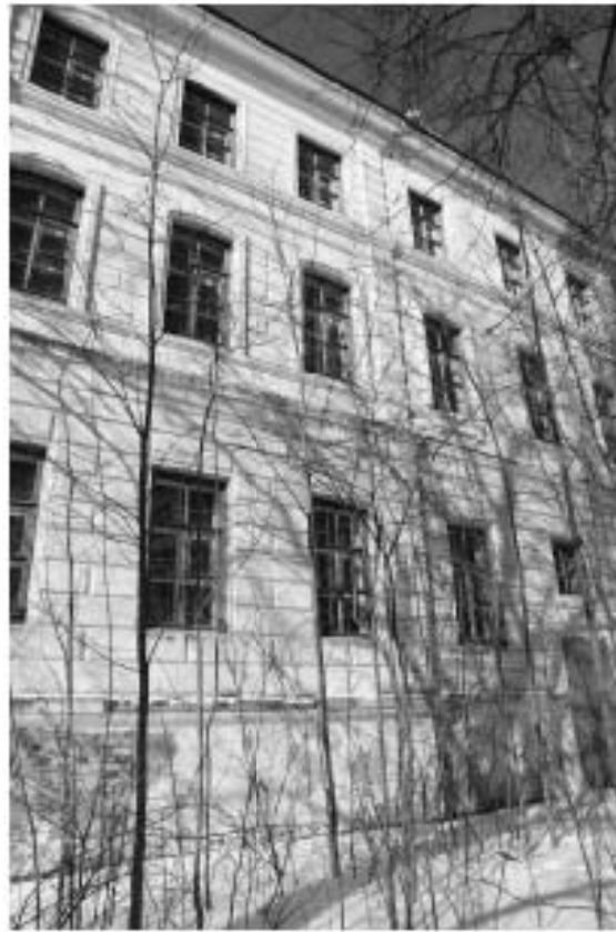
Фото 7. Юго-восточный фасад здания. Фрагмент.
