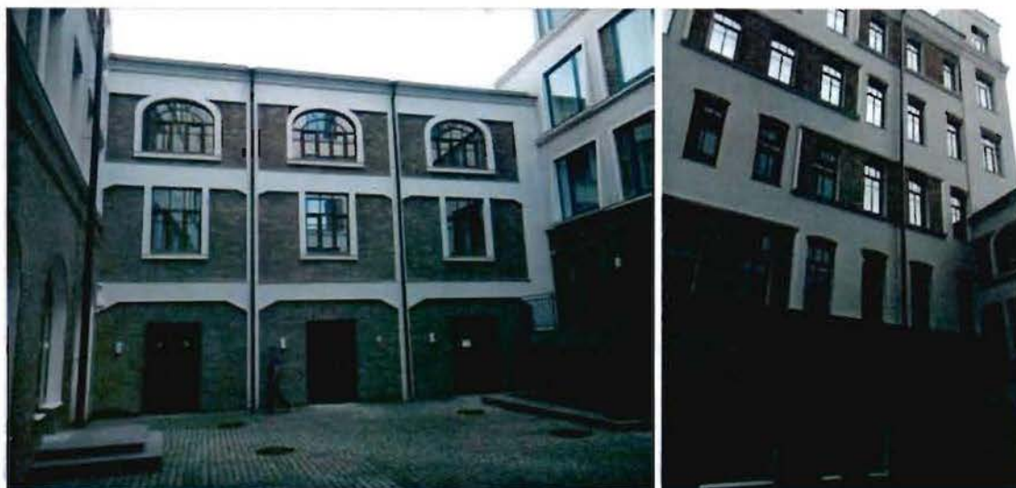
7, 8. Фасад лицевого корпуса по наб. Адмиралтейского канала
