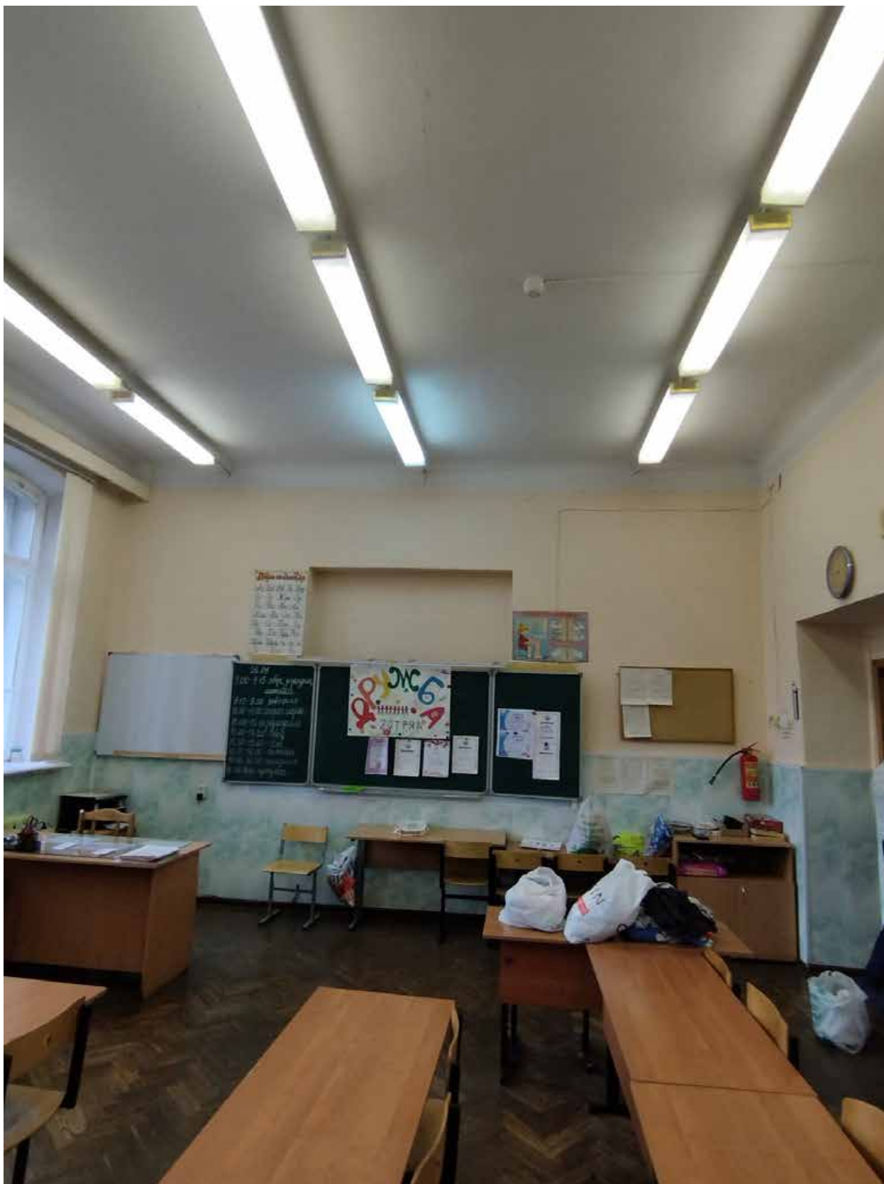
22. 2-й этаж, помещение №7
