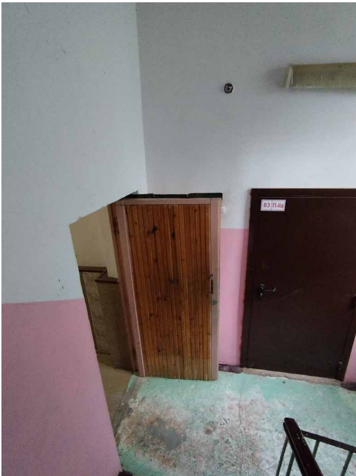
34. 2-й этаж, лестница в западной части здания, помещение №35.
