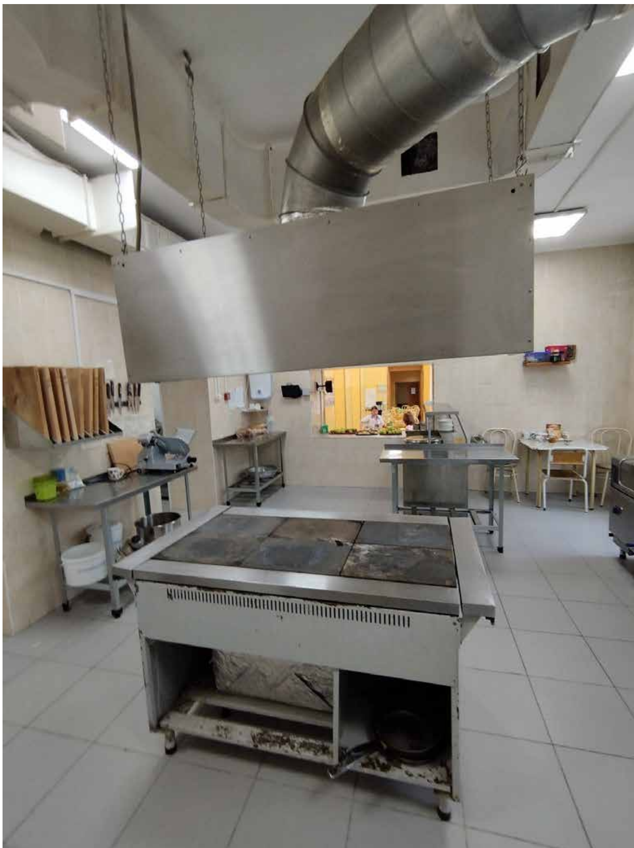
18. 1-й этаж, помещение №35.
