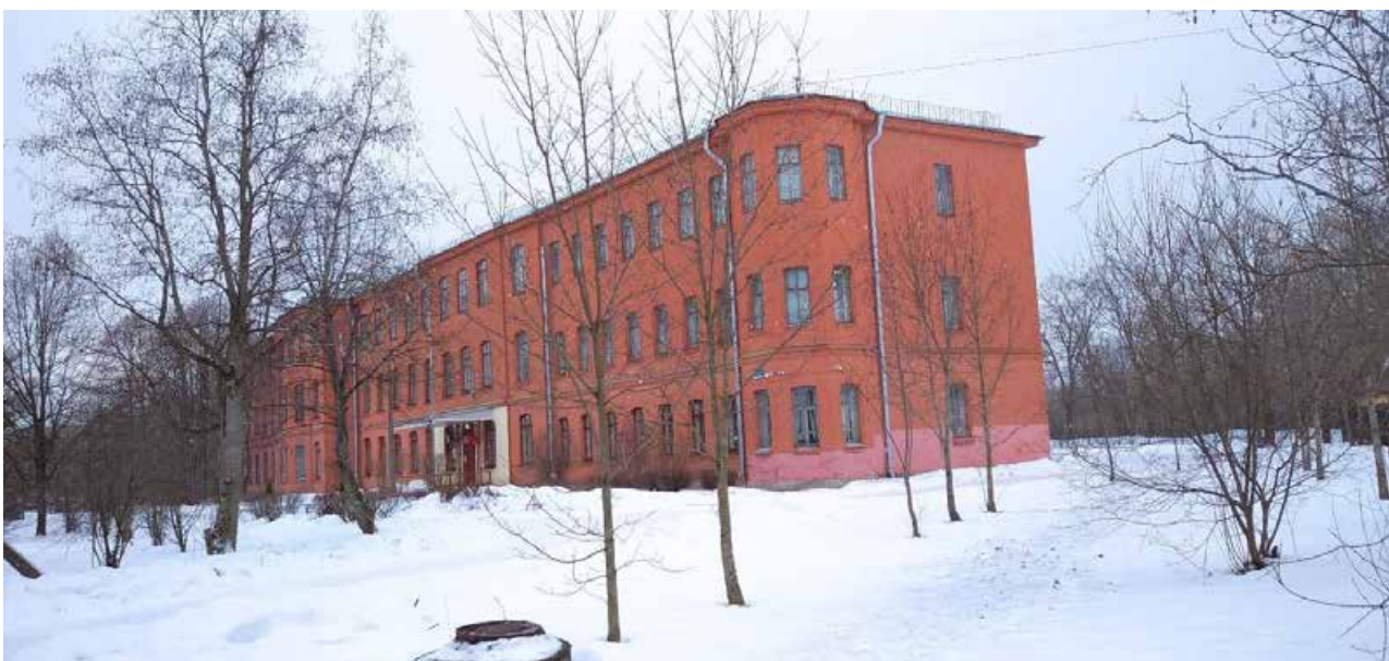
2. Вид на здание с юго-востока.
