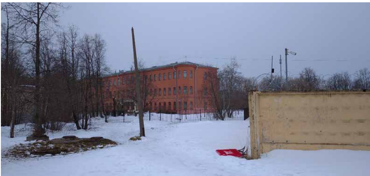
1. Вид на здание с юго-востока.
