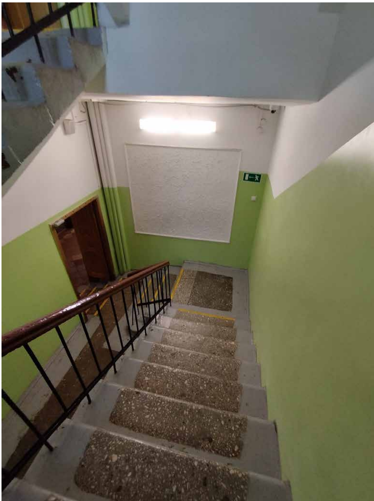
19. 1-й этаж, лестница на стыке основного объема здания и восточного ризалита северного фасада, помещение №47.
