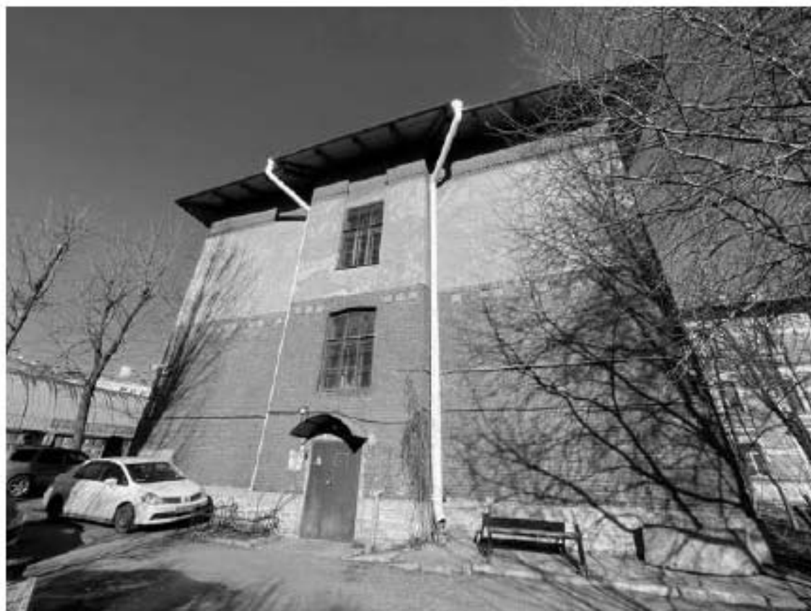
41. Вид на здание по адресу: улица Красного Курсанта, 34, литера Б
