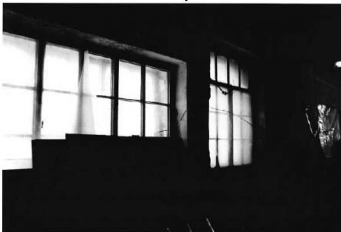
72. Фрагмент интерьера здания по адресу: улица Красного Курсанта, 32, литера Б
