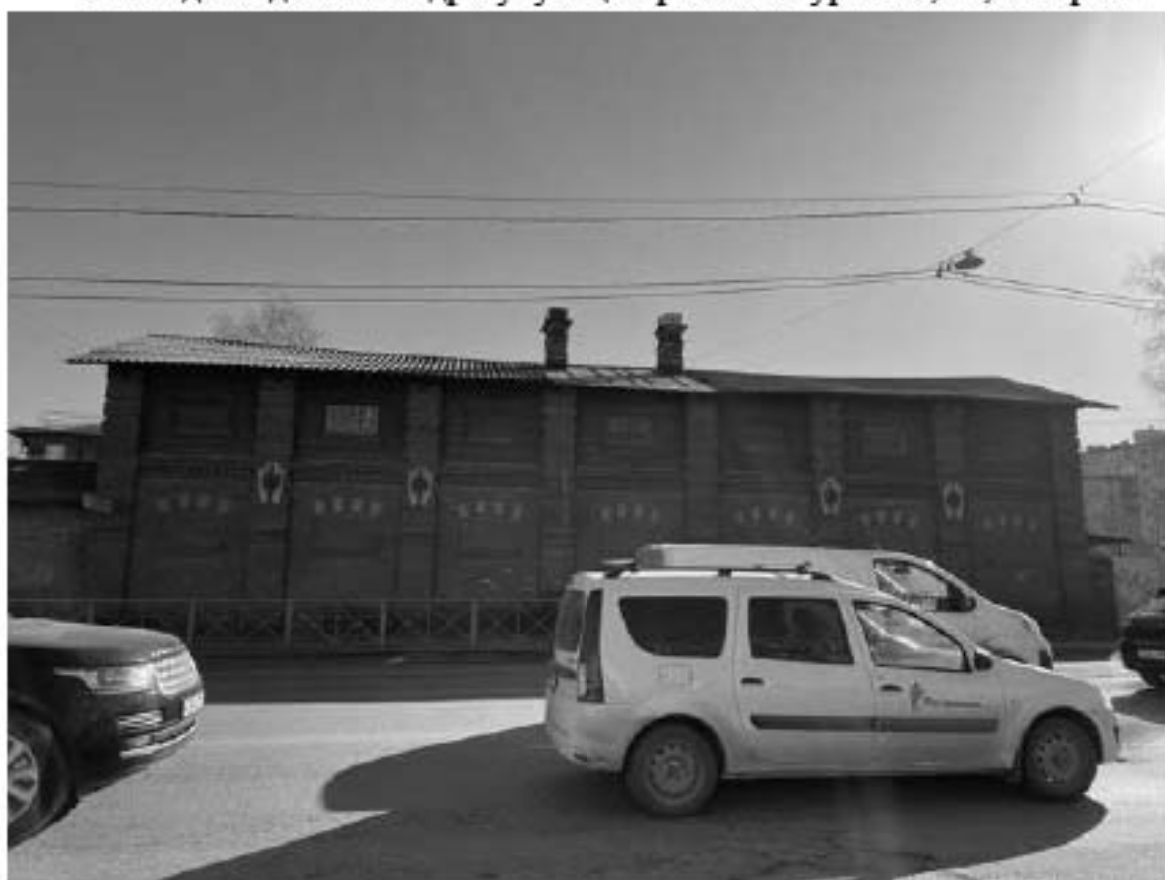
14. Вид на здание по адресу: улица Красного Курсанта, 36, литера Б
