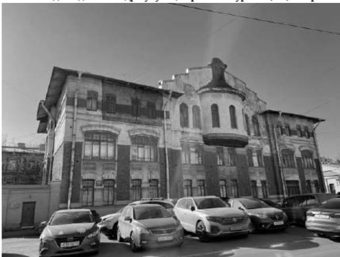
20. Вид на здание по адресу: улица Красного Курсанта, 32, литера А
