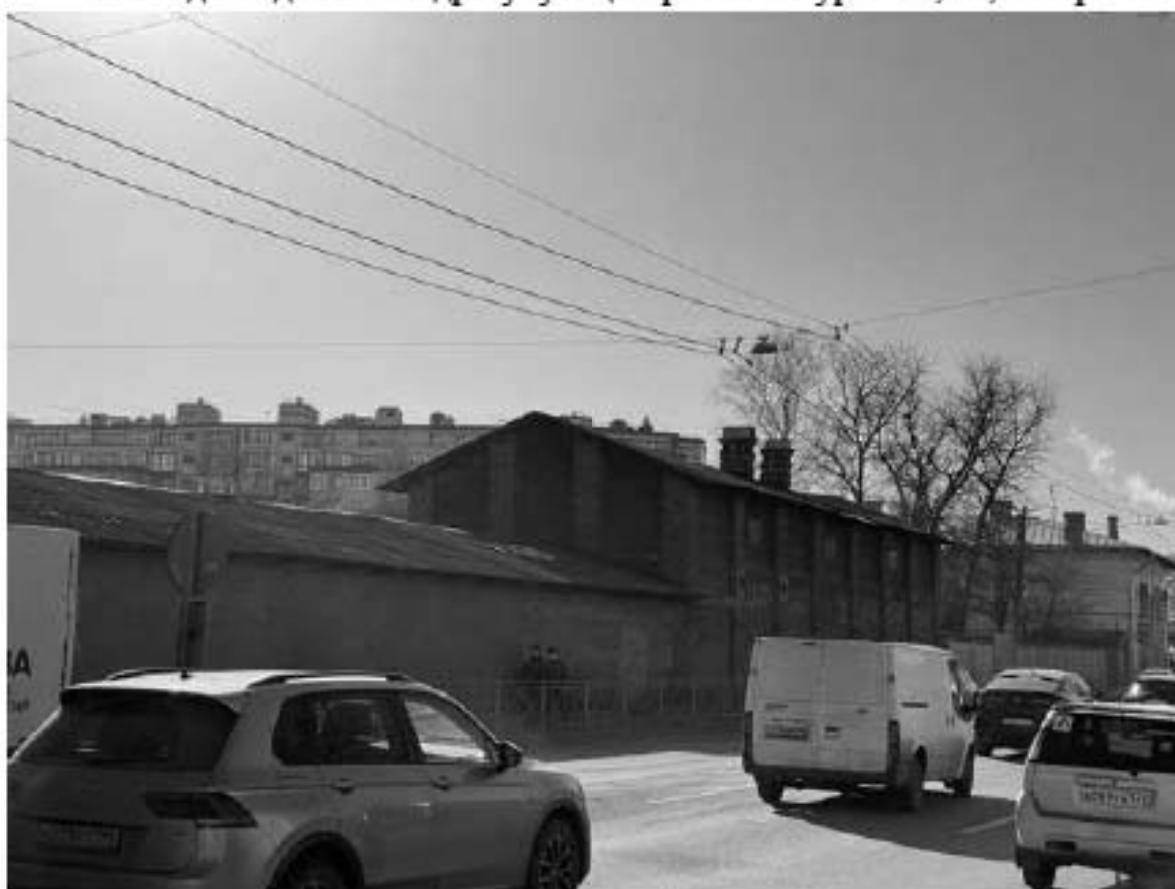
16. Вид на здание по адресу: улица Красного Курсанта, 36, литера Б
