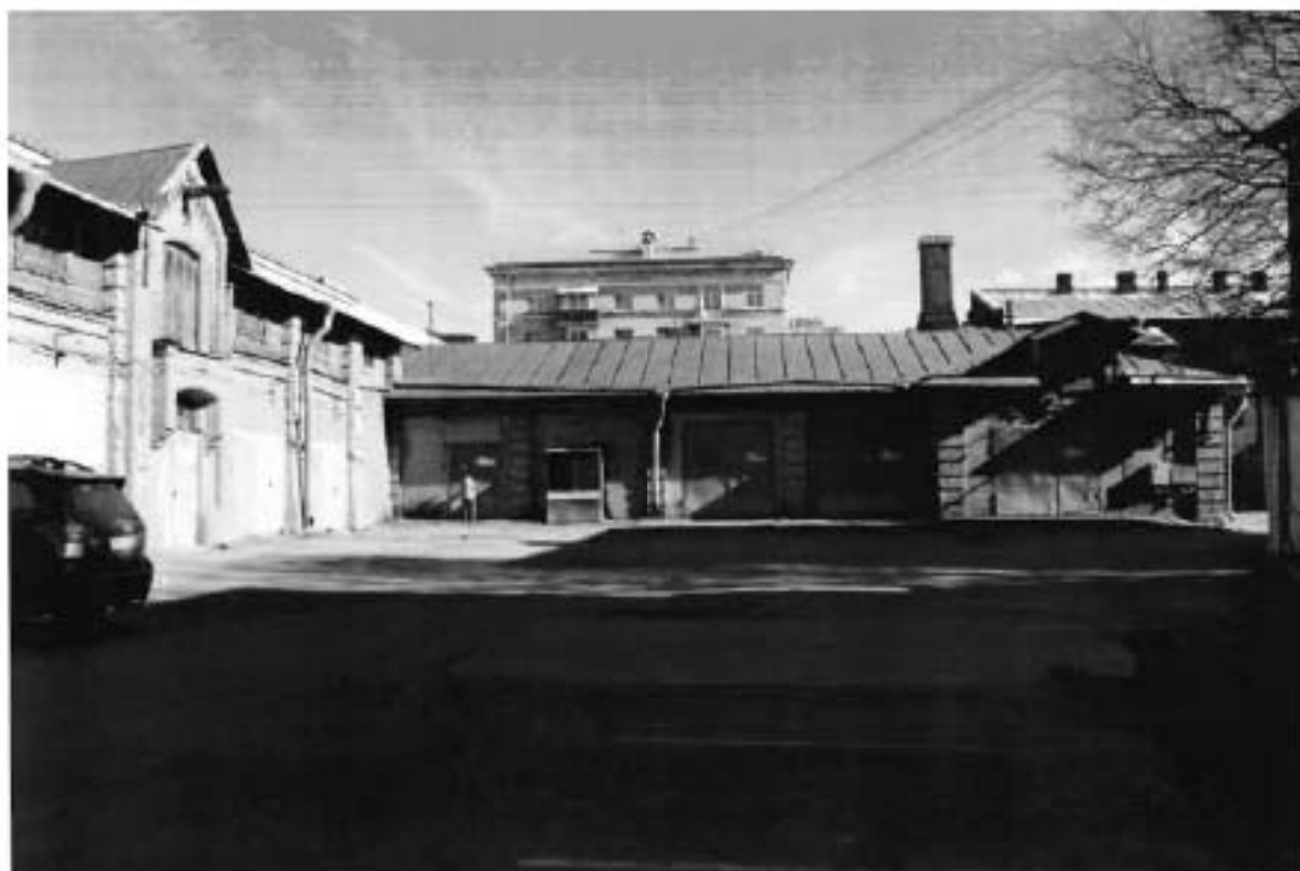
53. Вид на здание по адресу: улица Красного Курсанта, 32, литера Б
