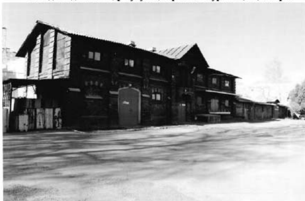
50. Вид на здание по адресу: улица Красного Курсанта, 36, литера Б
