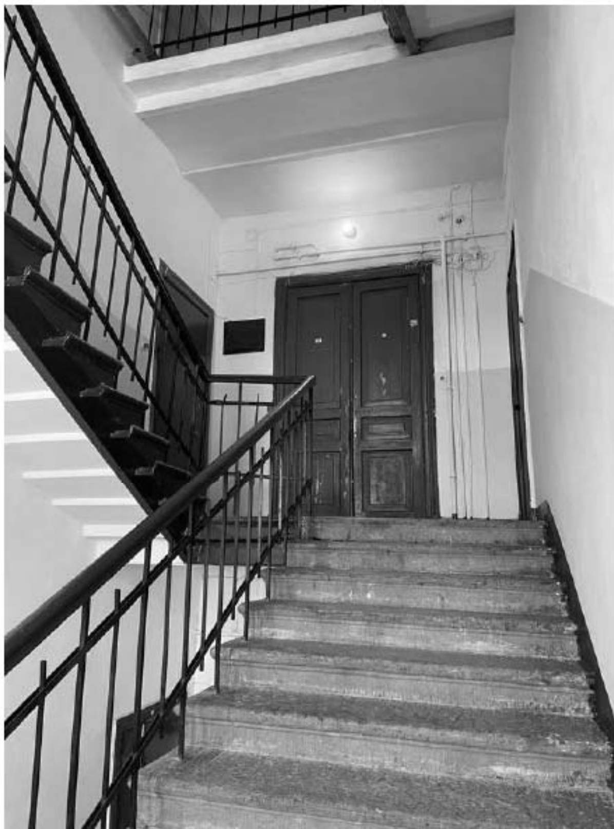
79. Фрагмент интерьера здания по адресу: улица Красного Курсанта, 34, литера Б
