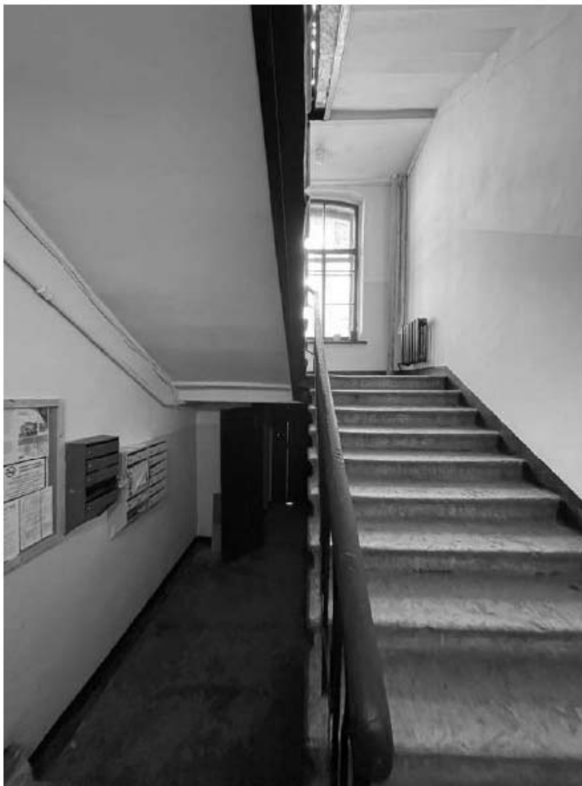
76. Фрагмент интерьера здания по адресу: улица Красного Курсанта, 34, литера Б
