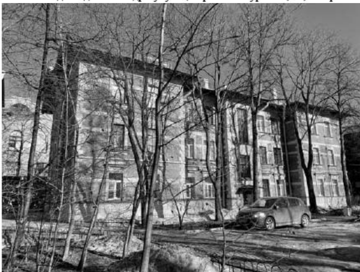
42. Вид на здание по адресу: улица Красного Курсанта, 34, литера А
