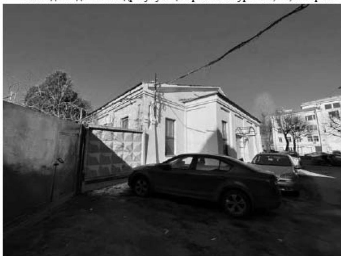
28. Вид на здание по адресу: улица Красного Курсанта, 36, литера Б
