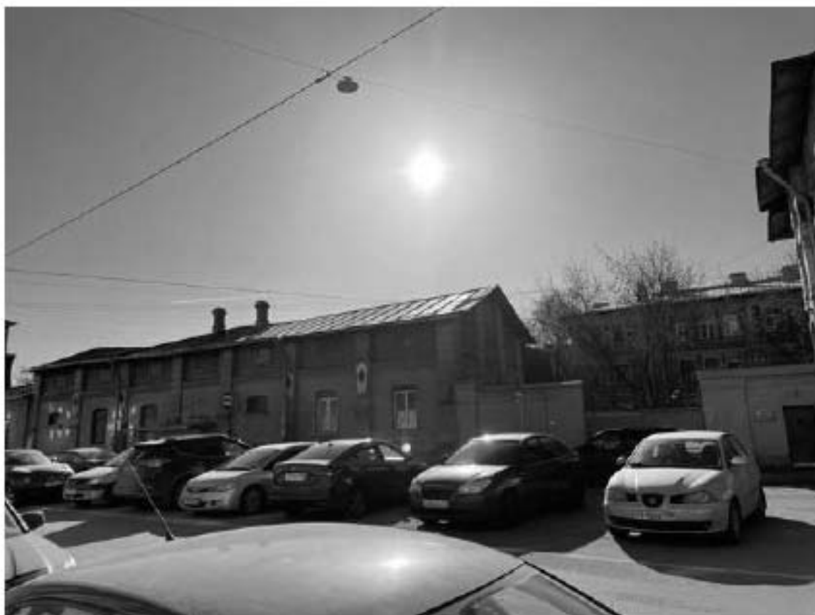
21. Вид на здание по адресу: улица Красного Курсанта, 32, литера Б
