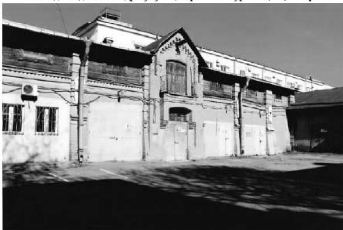
52. Вид на здание по адресу: улица Красного Курсанта, 32, литера Б
