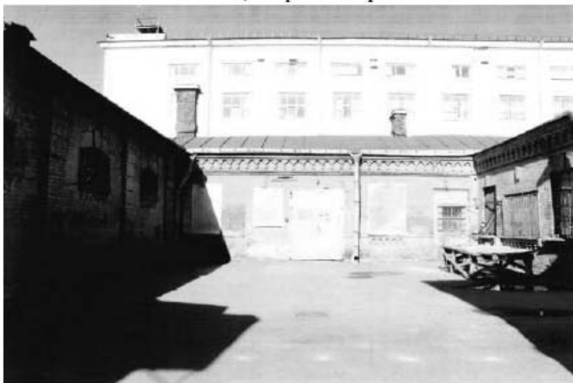
56. Вид на здание по адресу: улица Красного Курсанта, 32, литера Б
