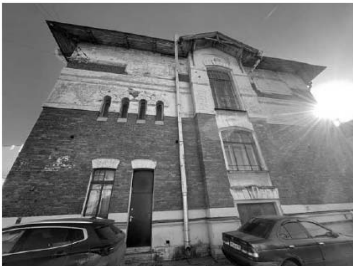
27. Вид на здание по адресу: улица Красного Курсанта, 32, литера А
