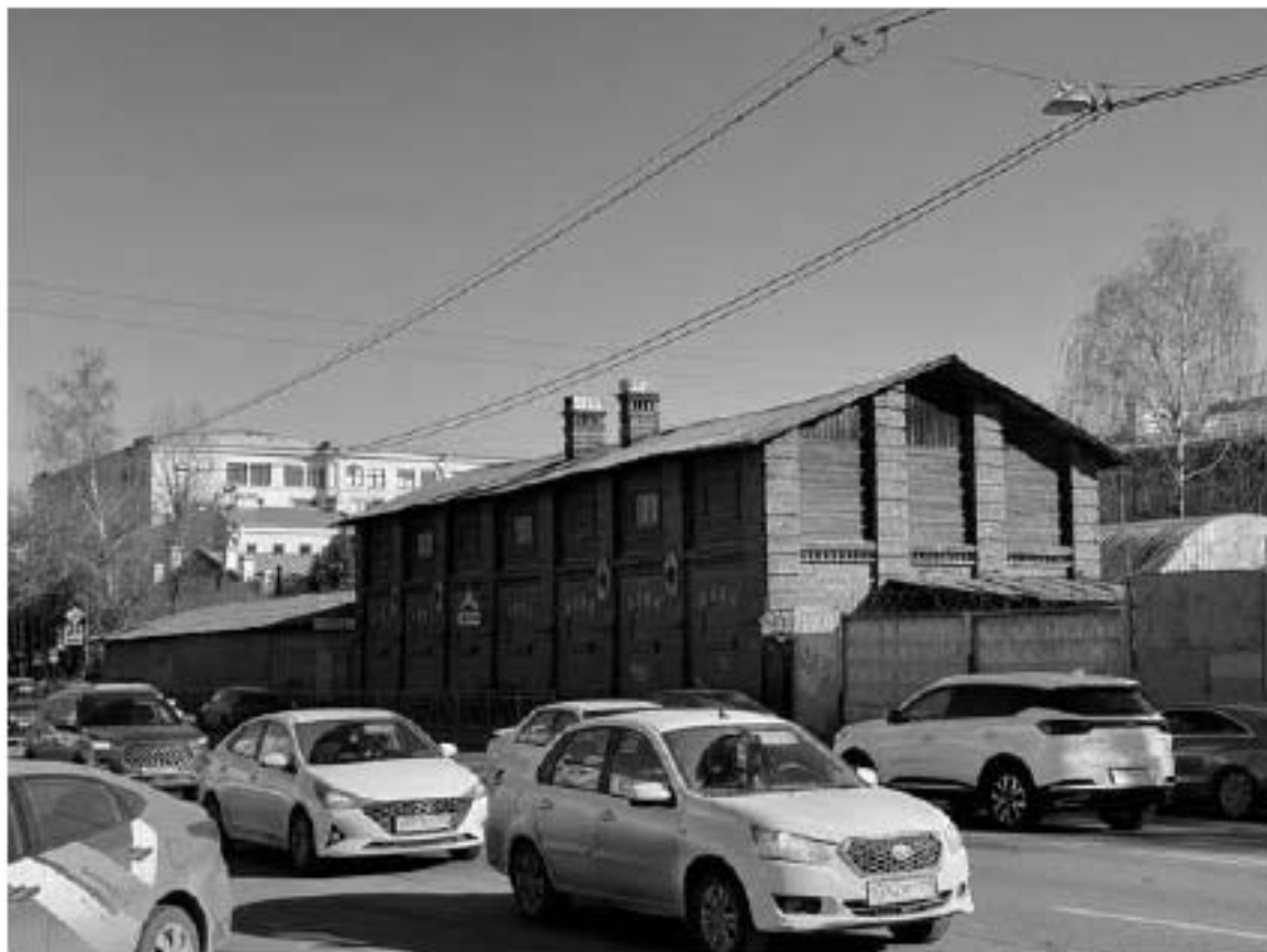
13. Вид на здание по адресу: улица Красного Курсанта, 36, литера Б
