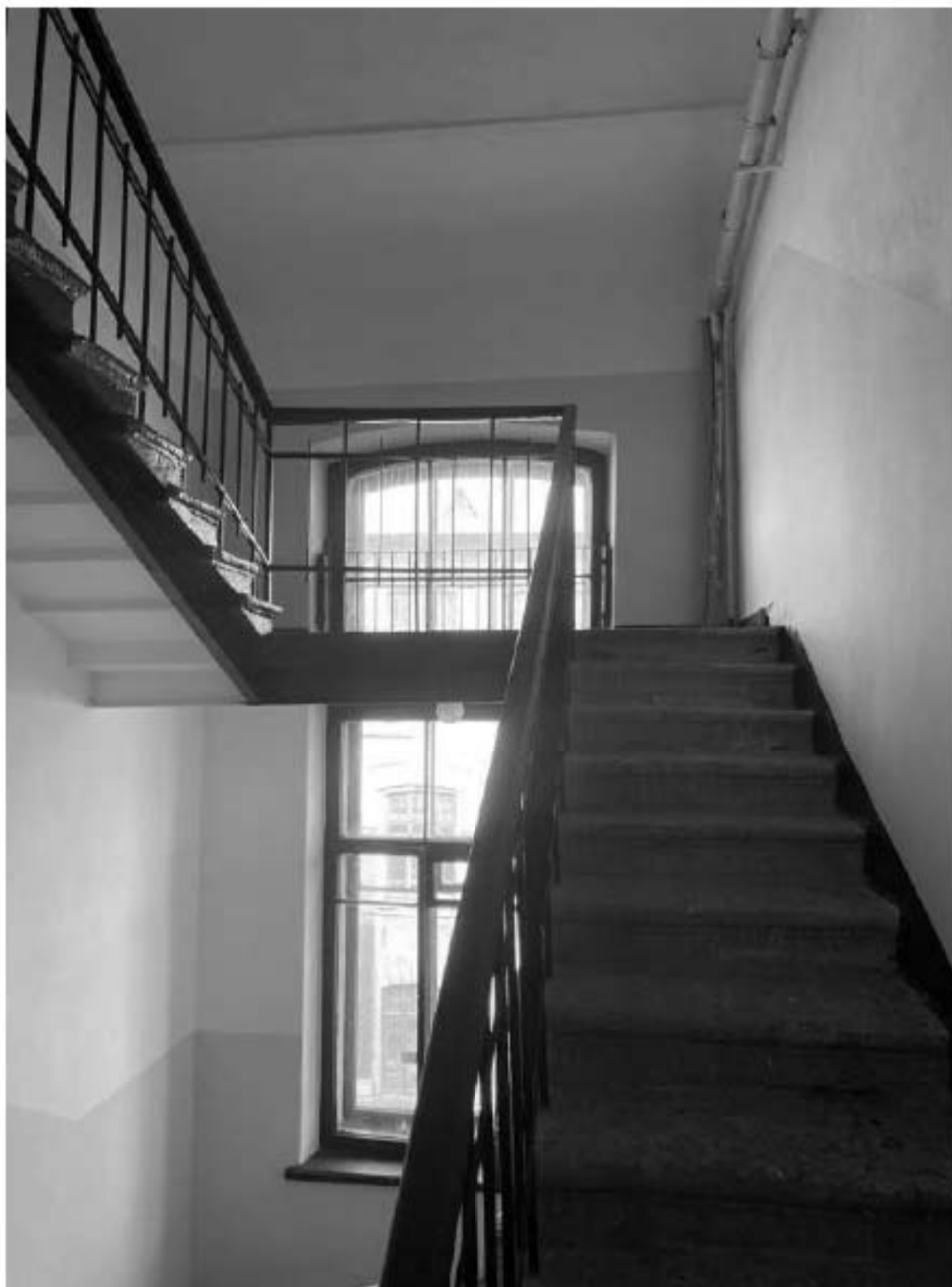
80. Фрагмент интерьера здания по адресу: улица Красного Курсанта, 34, литера Б
