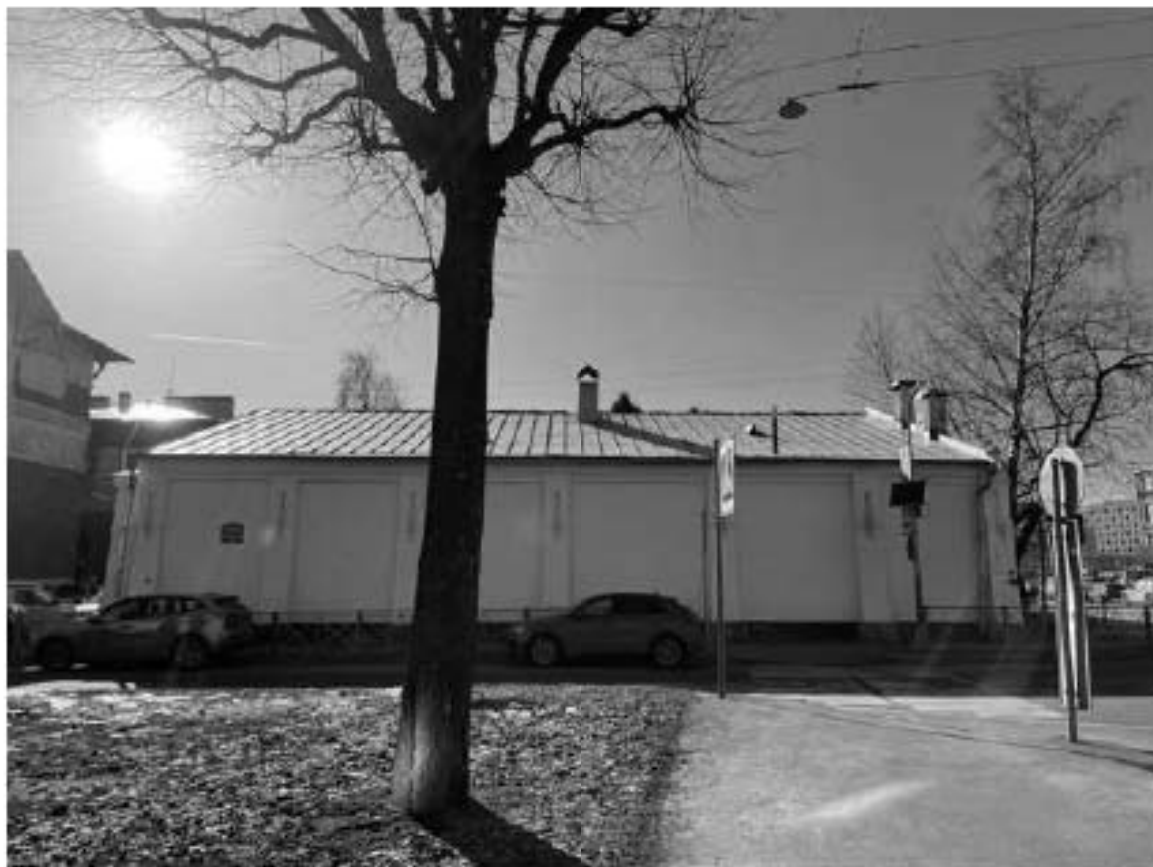
17. Вид на здание по адресу: улица Красного Курсанта, 36, литера Б
