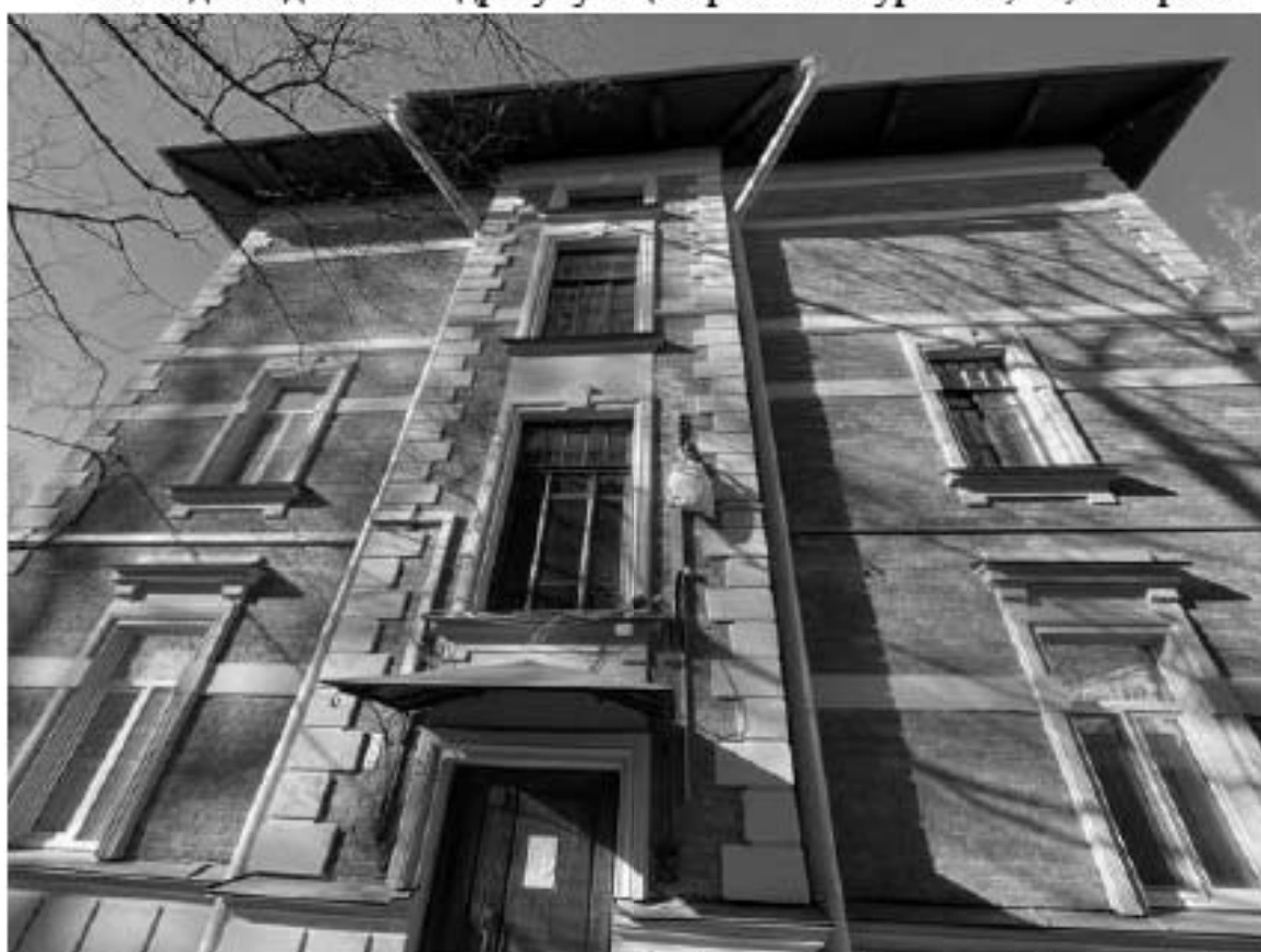
36. Вид на здание по адресу: улица Красного Курсанта, 34, литера А
