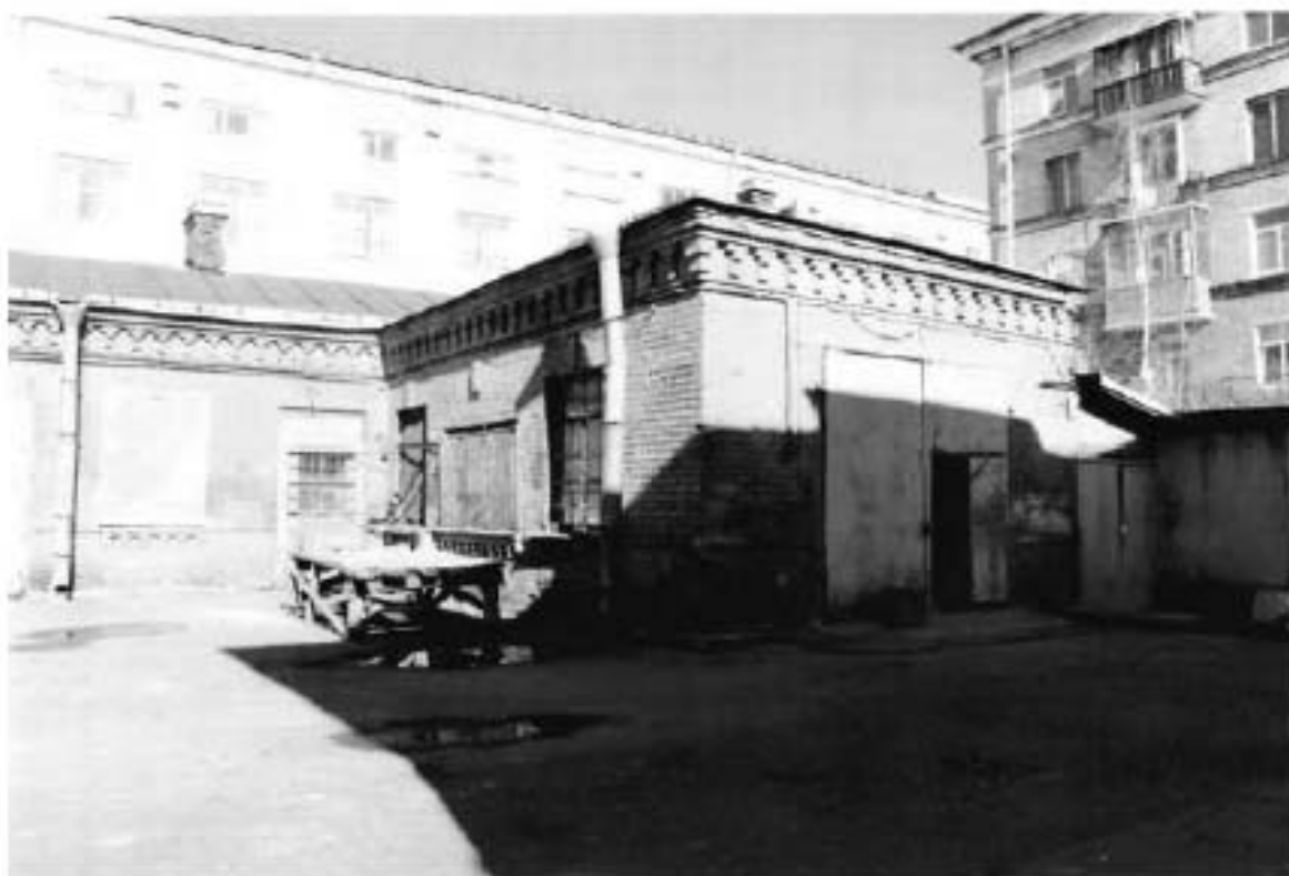
57. Вид на здание по адресу: улица Красного Курсанта, 32, литера Б
