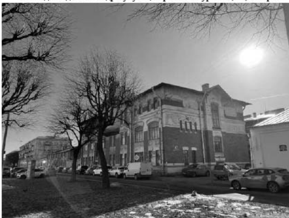
18. Вид на здание по адресу: улица Красного Курсанта, 32, литера А
