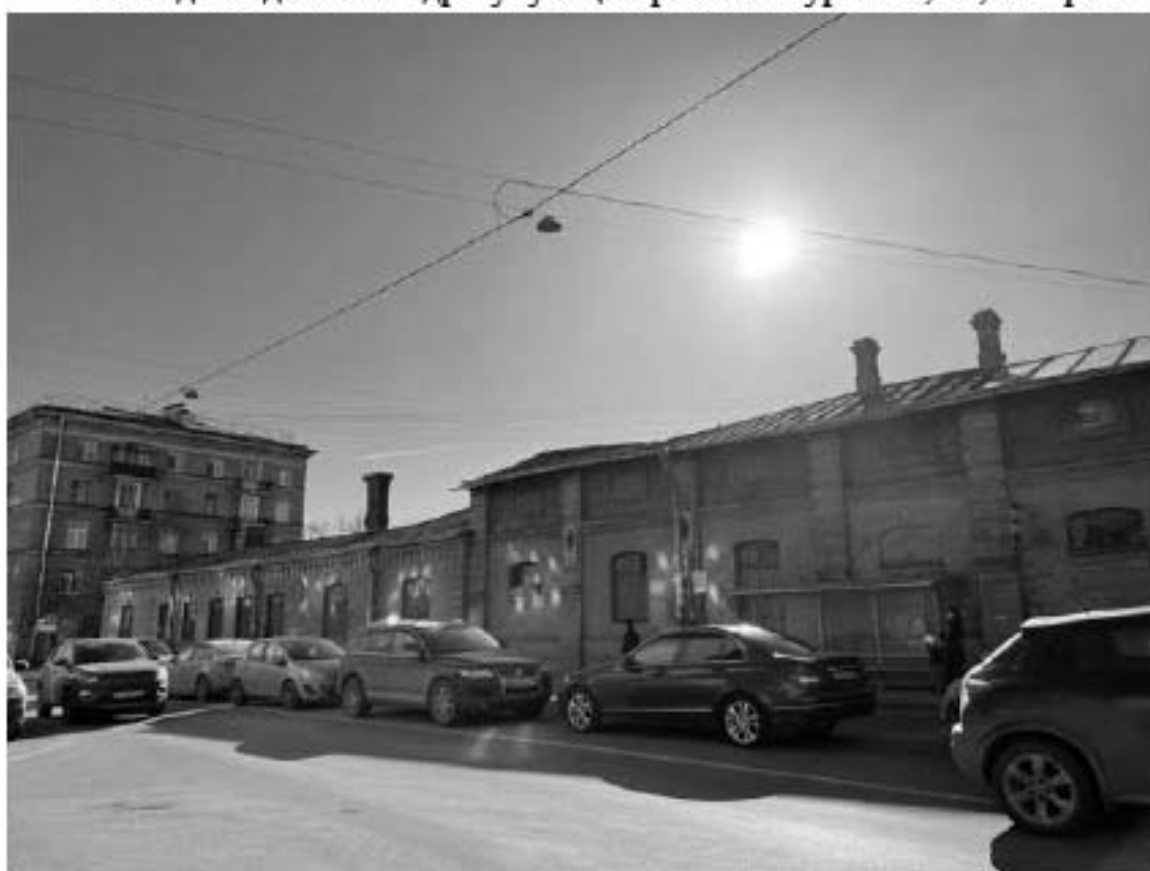
22. Вид на здание по адресу: улица Красного Курсанта, 32, литера Б
