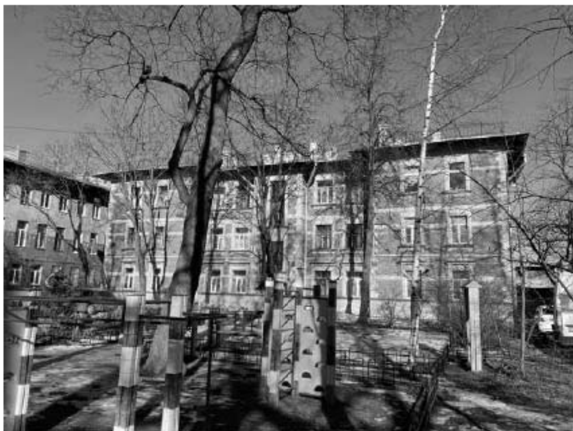
39. Вид на здание по адресу: улица Красного Курсанта, 34, литера А
