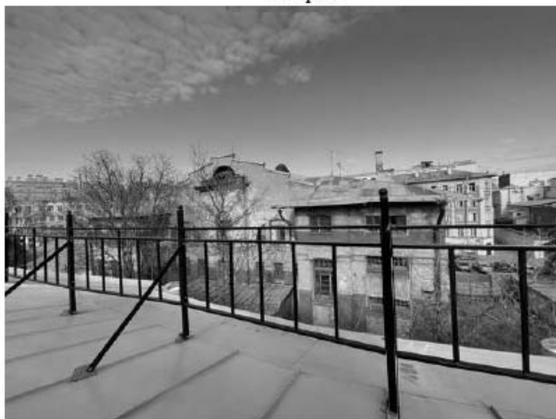
98. Фрагмент крыши здания по адресу: улица Красного Курсанта, 34, литера А
