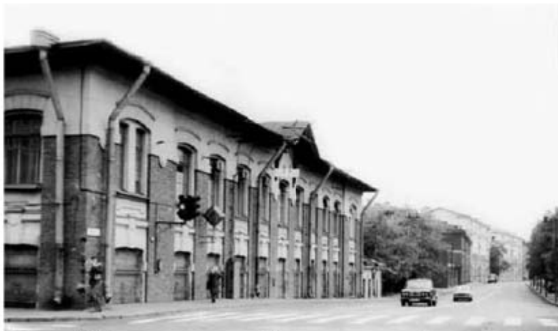
79. Вид одного из зданий Военно-космической академии им. А.Ф.Можайского по Ждановской набережной, 41. Архитектор В.А.Шевалев, 1900 год, бывшие казармы отдельного корпуса пограничной стражи. 1985 г. ЦГАКФФД СПб. Фотодокументы. Оп.1АР-152. Ед.хр.211663
