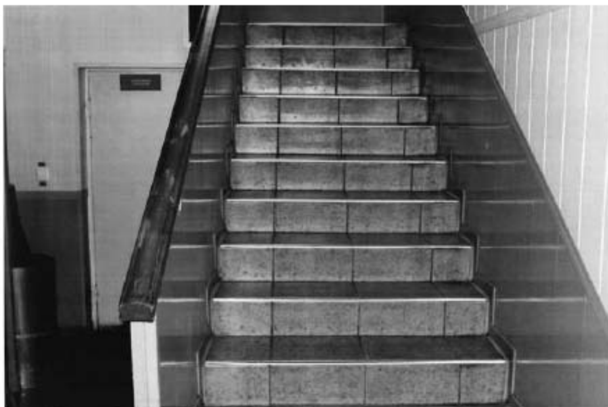
67. Фрагмент интерьера здания по адресу: Ждановская улица, 37, литера А
