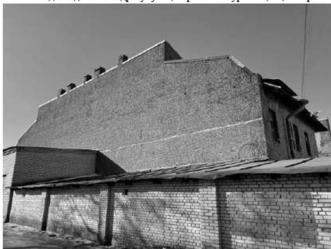
24. Вид на здание по адресу: улица Красного Курсанта, 32, литера В
