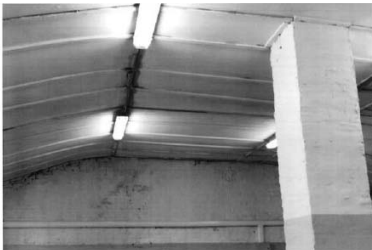
69. Фрагмент интерьера здания по адресу: улица Красного Курсанта, 36, литера Б
