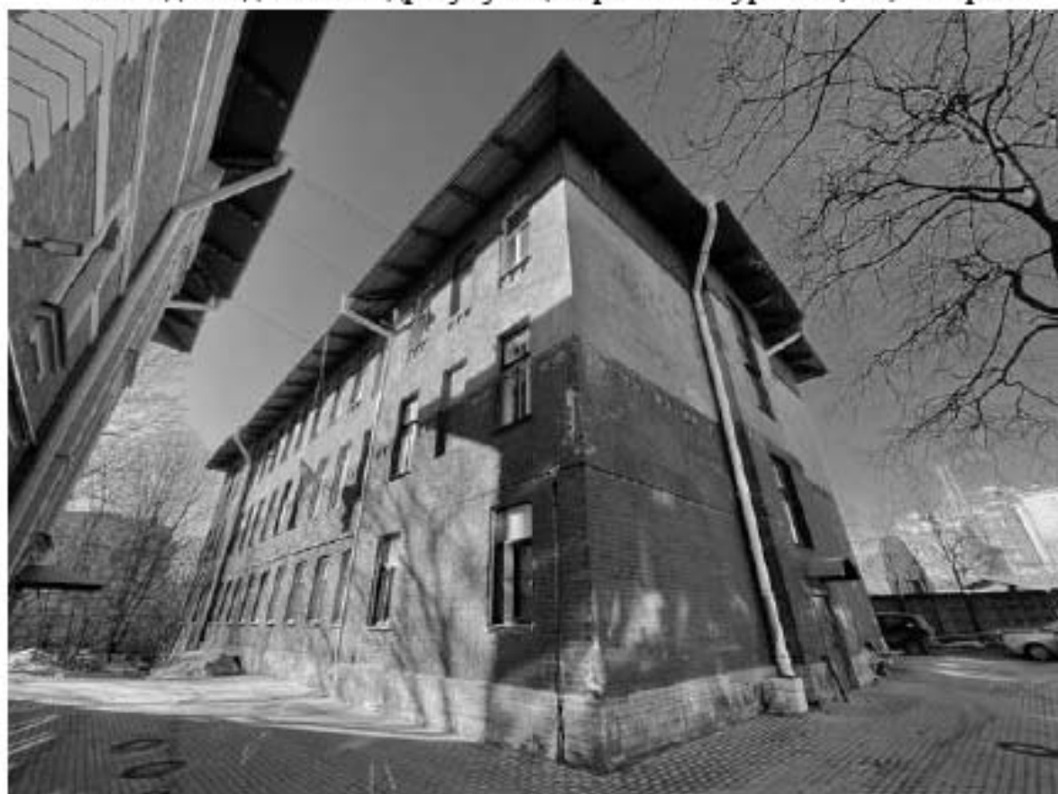
32. Вид на здание по адресу: улица Красного Курсанта, 34, литера Б
