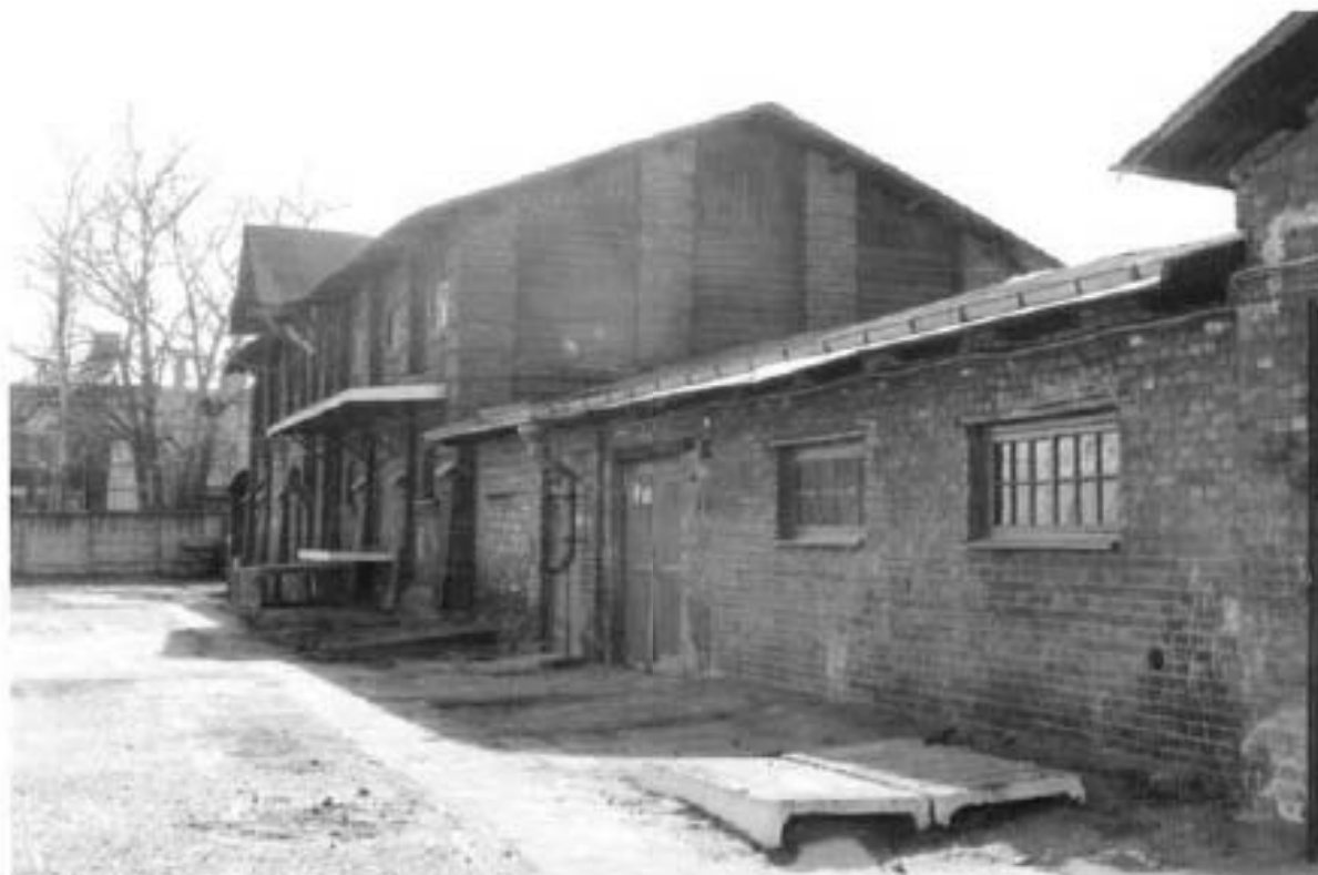
47. Вид на здание по адресу: улица Красного Курсанта, 36, литера Б
