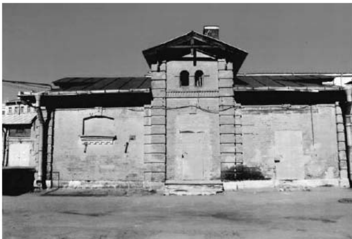
63. Вид на здание по адресу: улица Красного Курсанта, 32, литера Б
