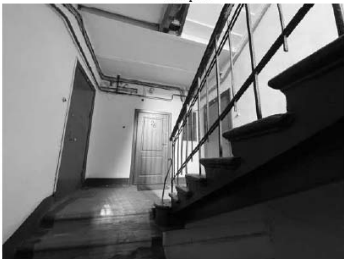
83. Фрагмент интерьера здания по адресу: улица Красного Курсанта, 34, литера Б
