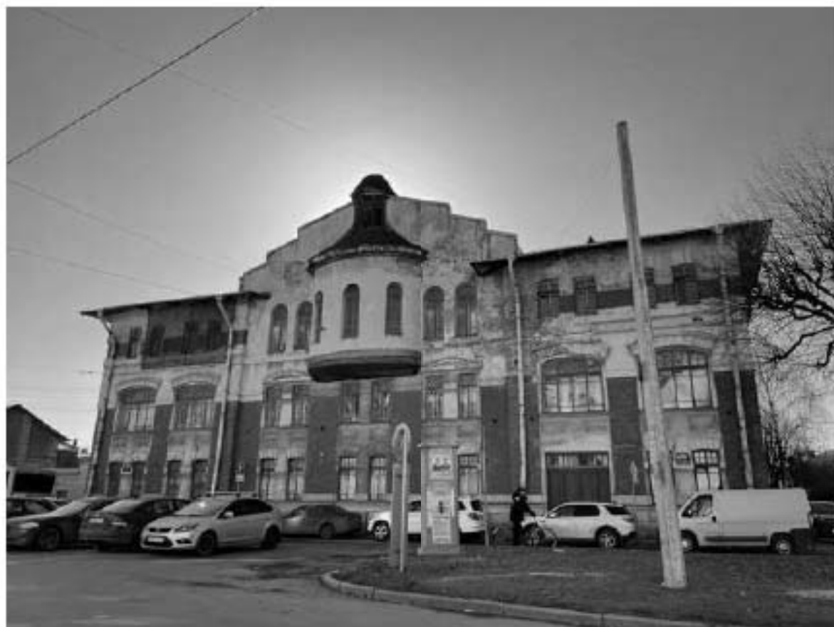
19. Вид на здание по адресу: улица Красного Курсанта, 32, литера А
