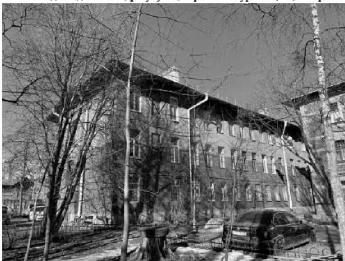
40. Вид на здание по адресу: улица Красного Курсанта, 34, литера Б
