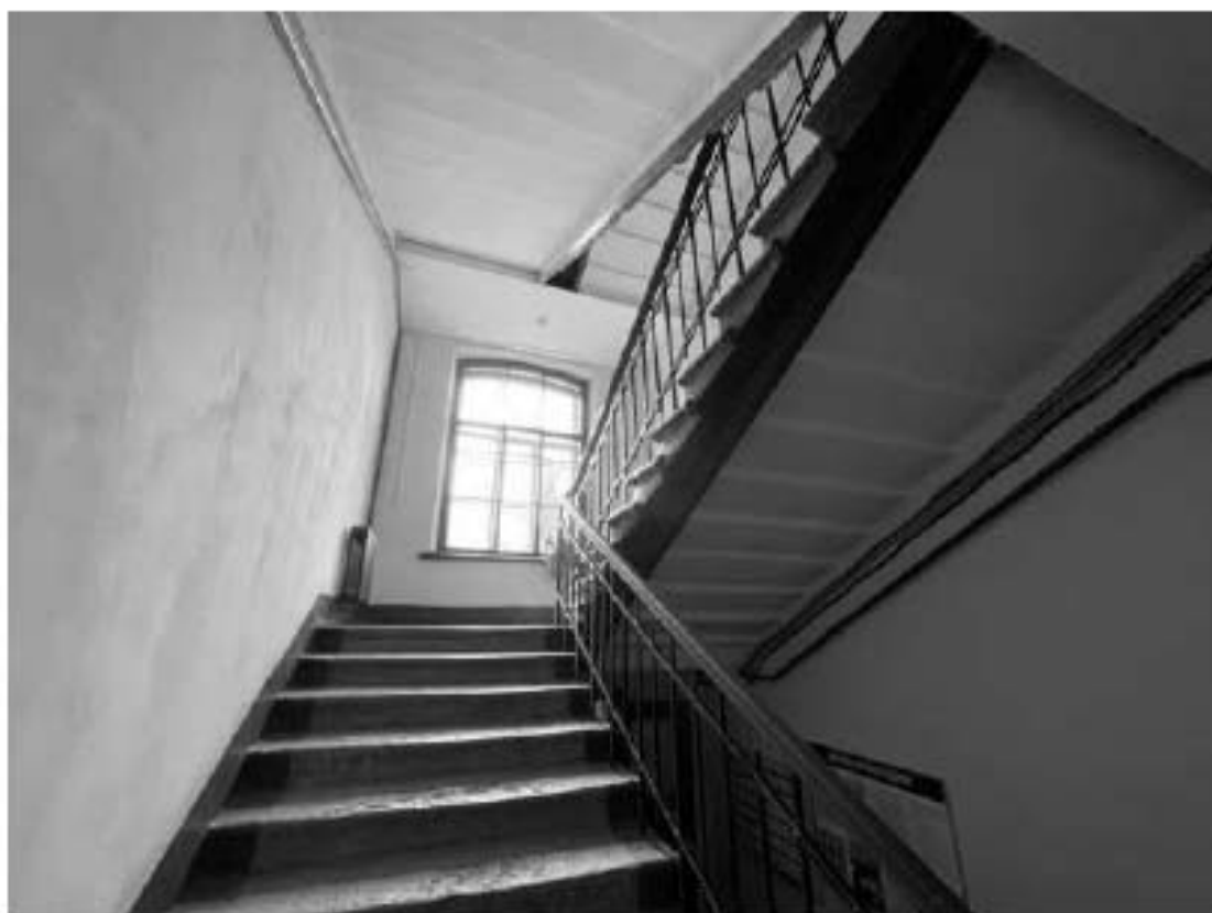
84. Фрагмент интерьера здания по адресу: улица Красного Курсанта, 34, литера Б
