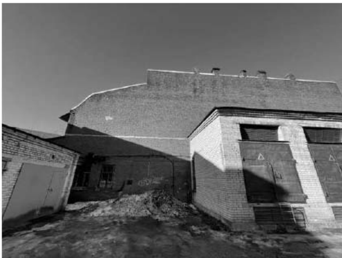
25. Вид на здание по адресу: улица Красного Курсанта, 32, литера В
