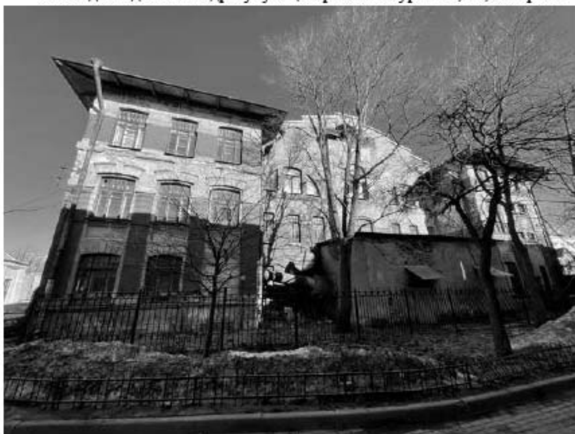
30. Вид на здание по адресу: улица Красного Курсанта, 32, литера А
