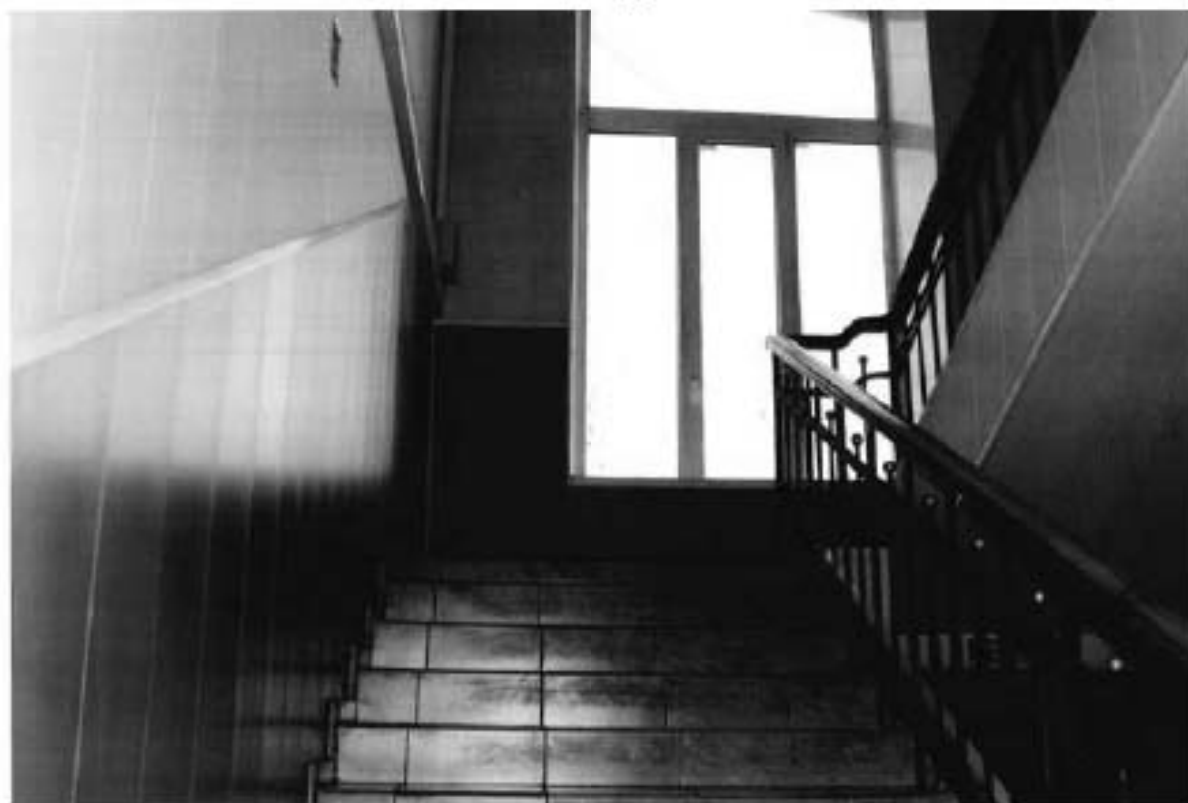
66. Фрагмент интерьера здания по адресу: Ждановская улица, 41, литера А
