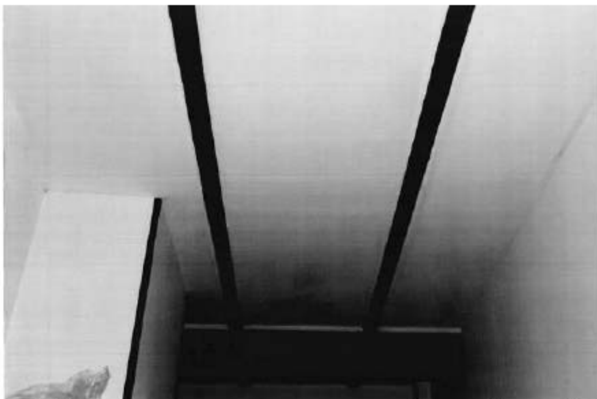
73. Фрагмент интерьера здания по адресу: улица Красного Курсанта, 34, №18/14
