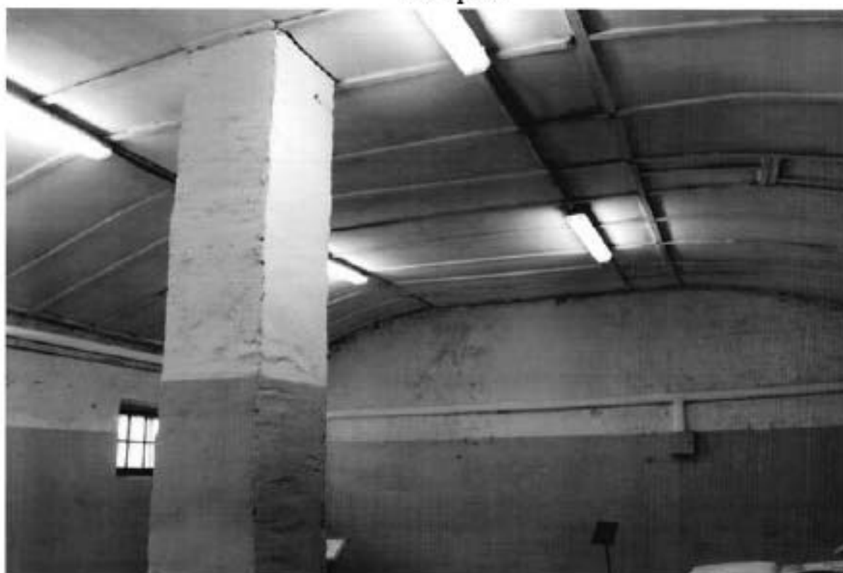
70. Фрагмент интерьера здания по адресу: улица Красного Курсанта, 36, литера Б
