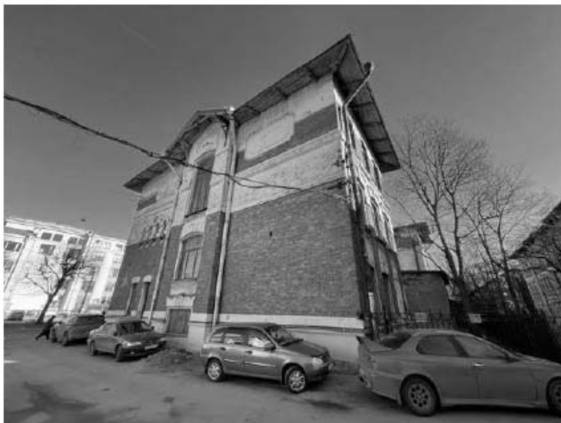
29. Вид на здание по адресу: улица Красного Курсанта, 32, литера А
