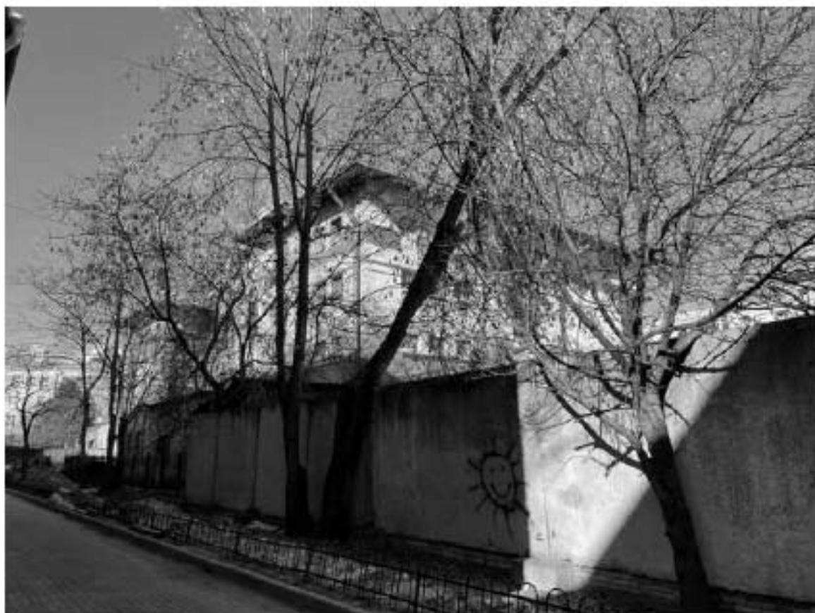
35. Вид на здание по адресу: улица Красного Курсанта, 32, литера А
