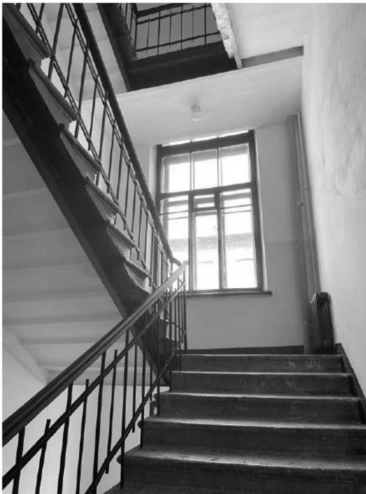
78. Фрагмент интерьера здания по адресу: улица Красного Курсанта, 34, литера Б
