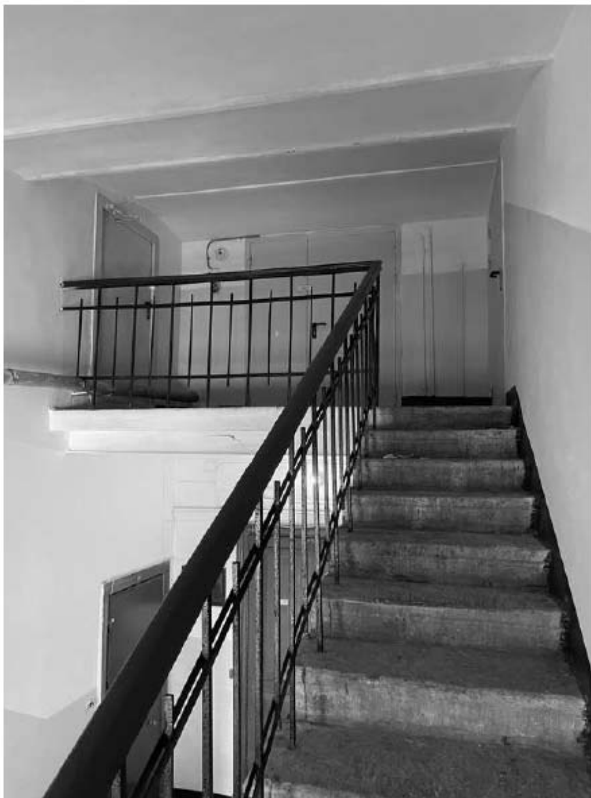
81. Фрагмент интерьера здания по адресу: улица Красного Курсанта, 34, литера Б
