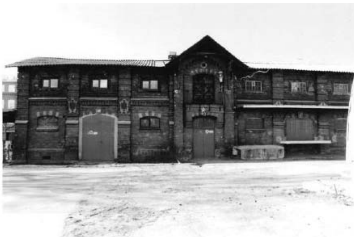
49. Вид на здание по адресу: улица Красного Курсанта, 36, литера Б
