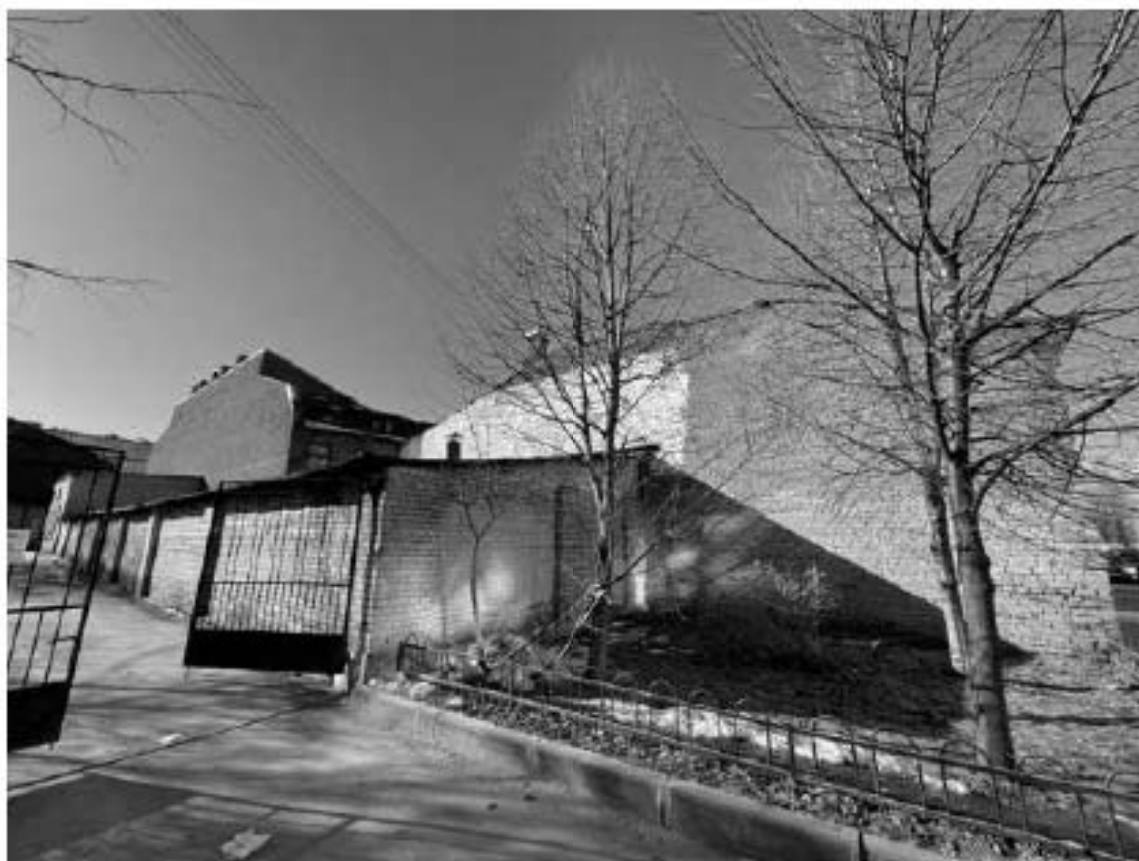
23. Вид на здание по адресу: улица Красного Курсанта, 32, литера Б
