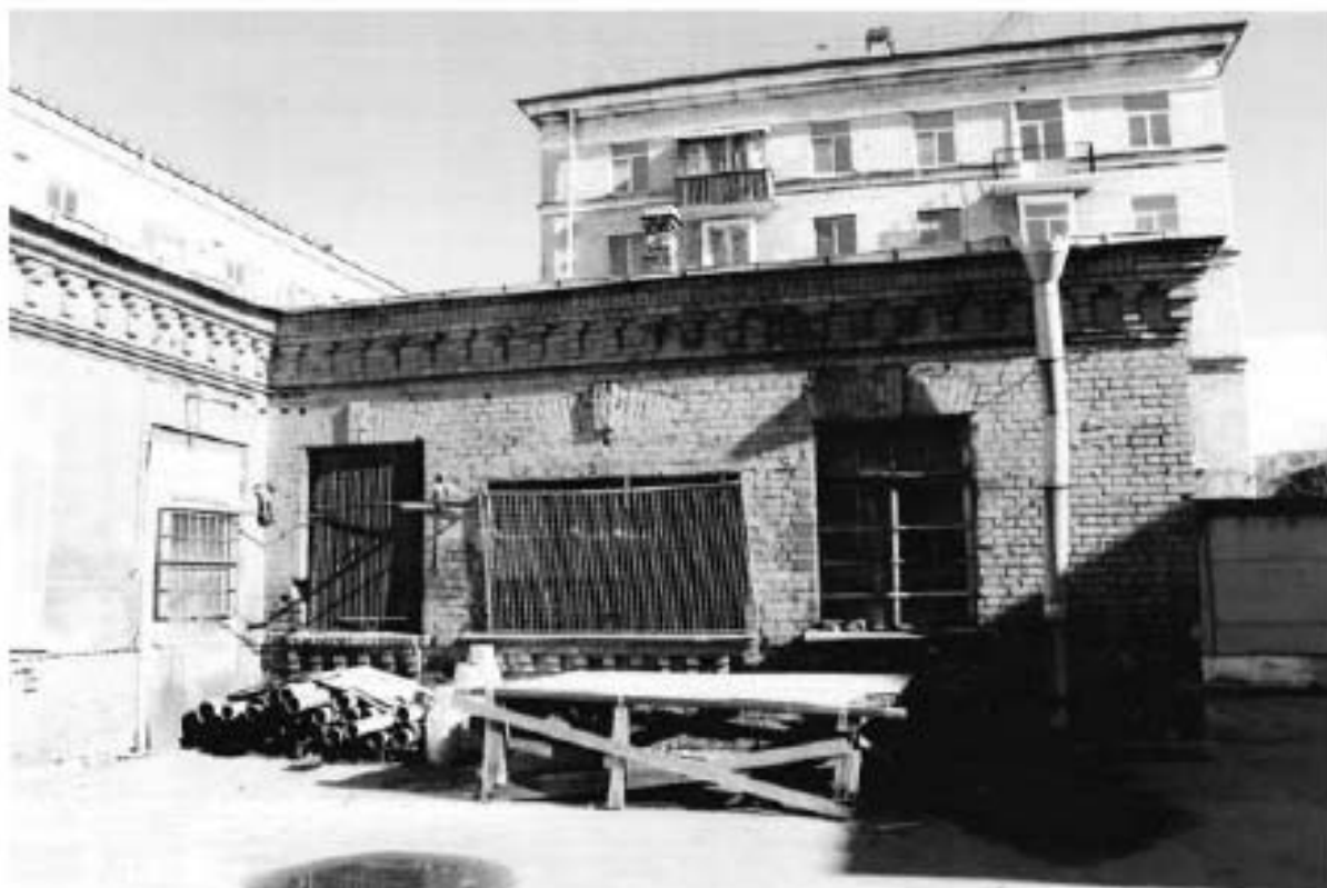
59. Вид на здание по адресу: улица Красного Курсанта, 32, литера Б
