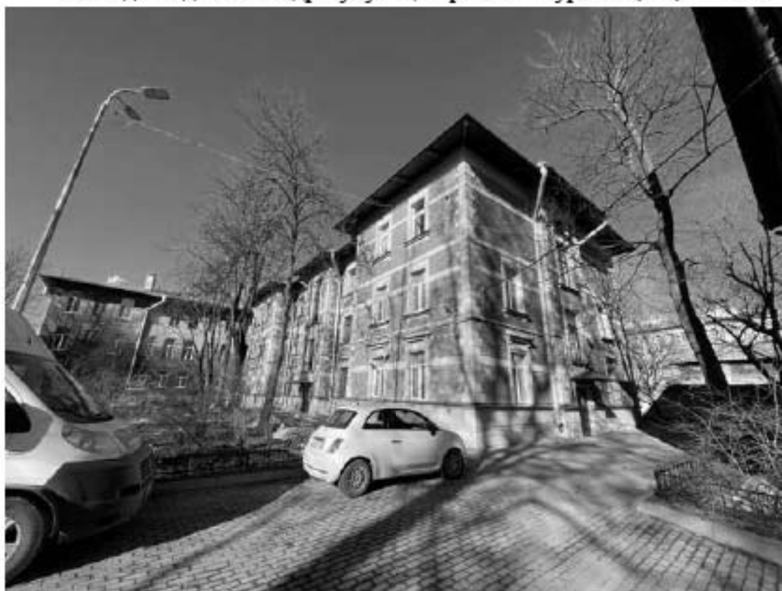
38. Вид на здание по адресу: улица Красного Курсанта, 34, литера А
