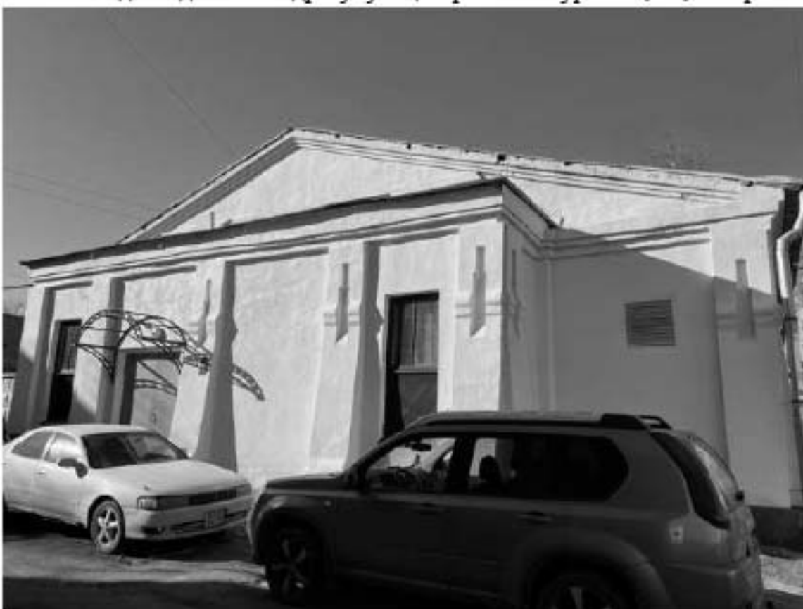
26. Вид на здание по адресу: улица Красного Курсанта, 36, литера Б
