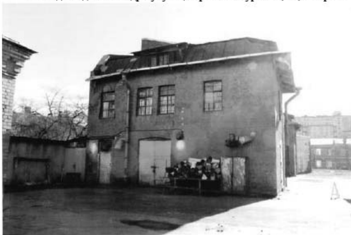
58. Вид на здание по адресу: улица Красного Курсанта, 32, литера В
