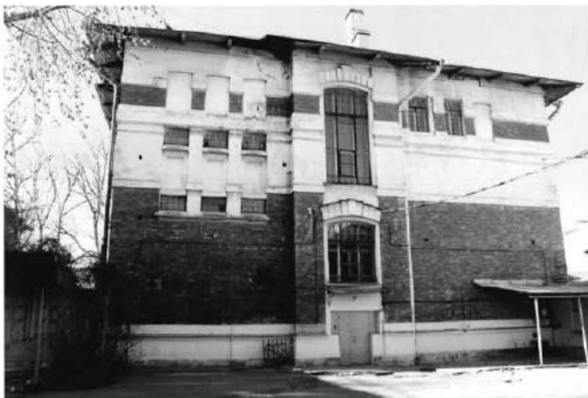
51. Вид на здание по адресу: улица Красного Курсанта, 32, литера А
