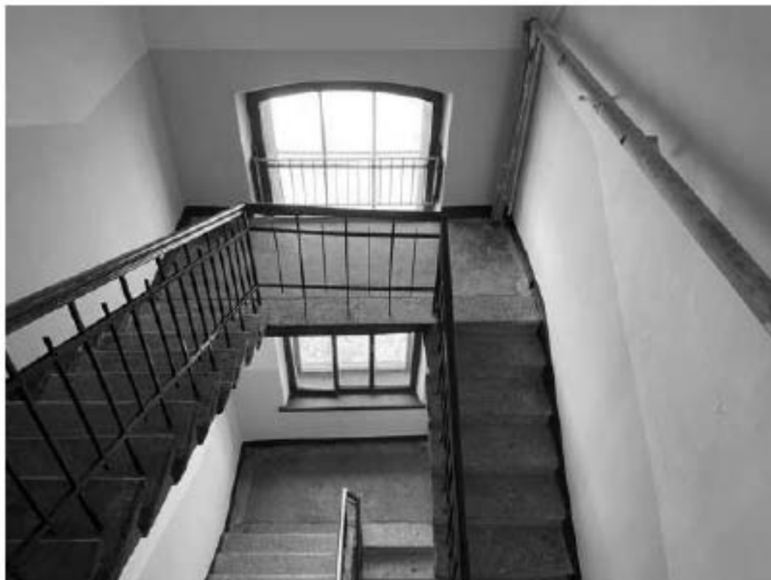
82. Фрагмент интерьера здания по адресу: улица Красного Курсанта, 34, литера Б
