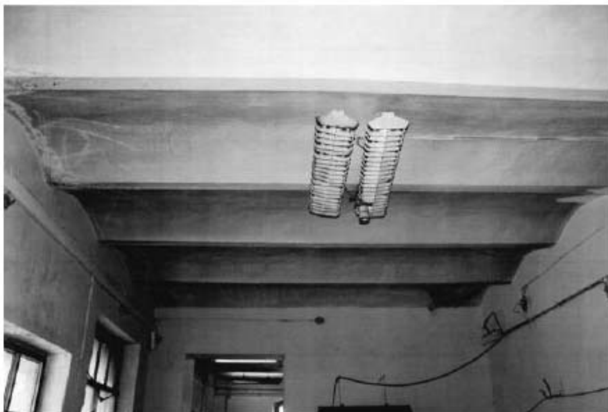
71. Фрагмент интерьера здания по адресу: улица Красного Курсанта, 32, литера Б
