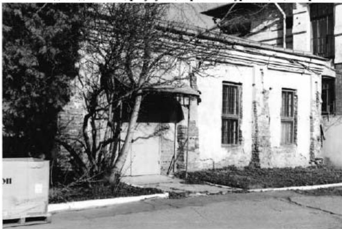
48. Вид на здание по адресу: улица Красного Курсанта, 36, литера Б
