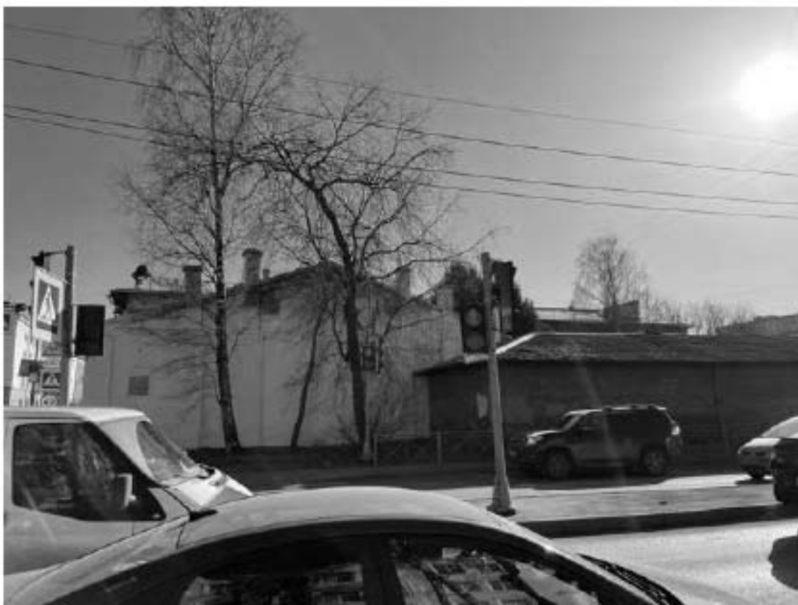
15. Вид на здание по адресу: улица Красного Курсанта, 36, литера Б
