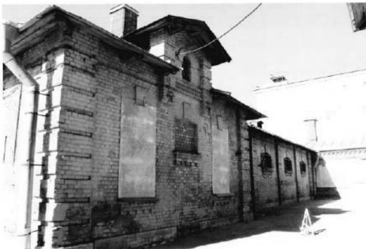
61. Вид на здание по адресу: улица Красного Курсанта, 32, литера Б
