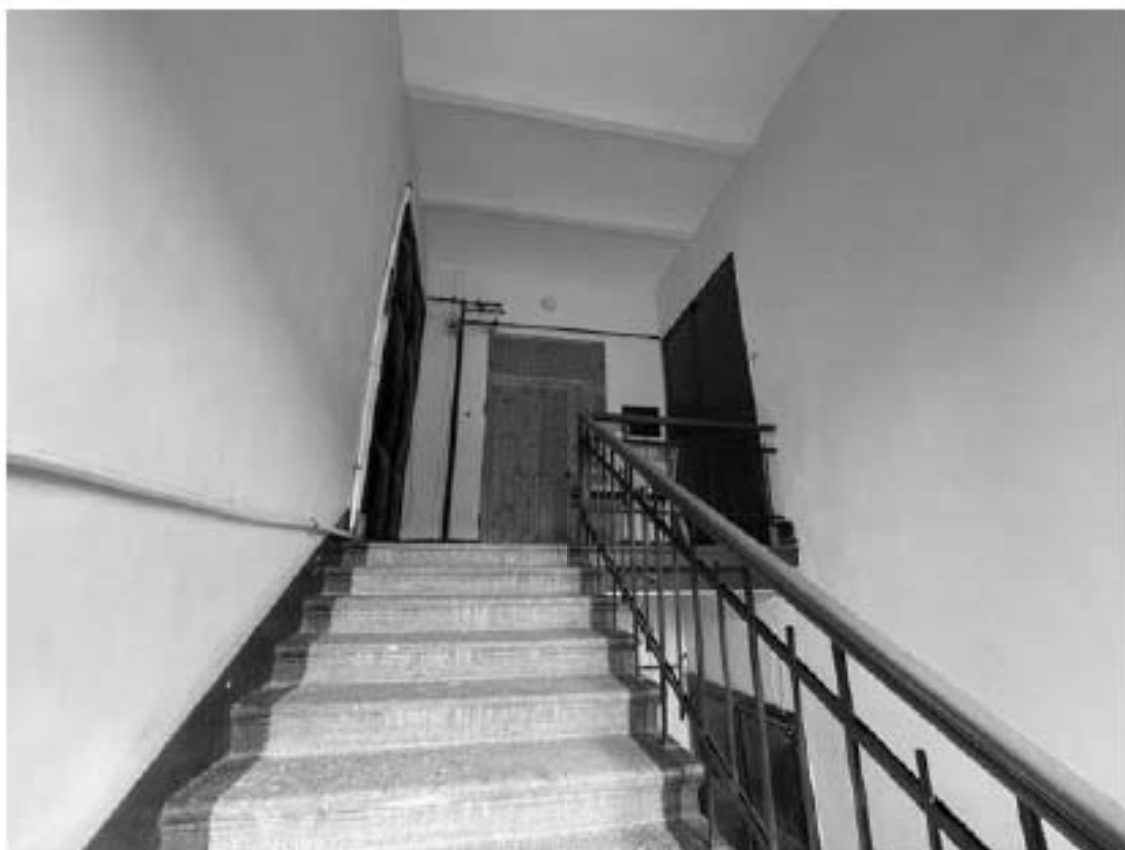
87. Фрагмент интерьера здания по адресу: улица Красного Курсанта, 34, литера Б
