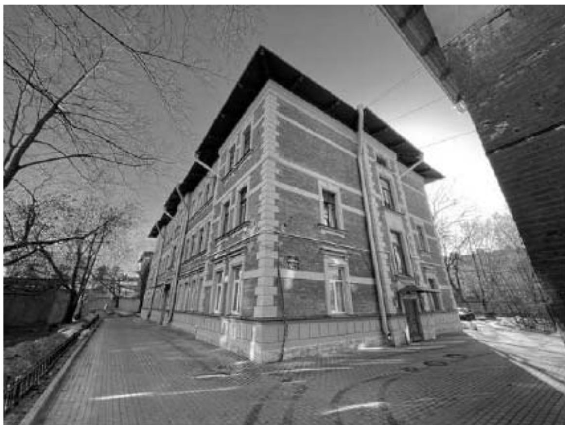
31. Вид на здание по адресу: улица Красного Курсанта, 34, литера А
