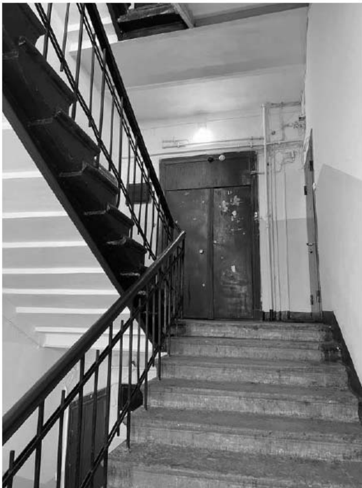
77. Фрагмент интерьера здания по адресу: улица Красного Курсанта, 34, литера Б
