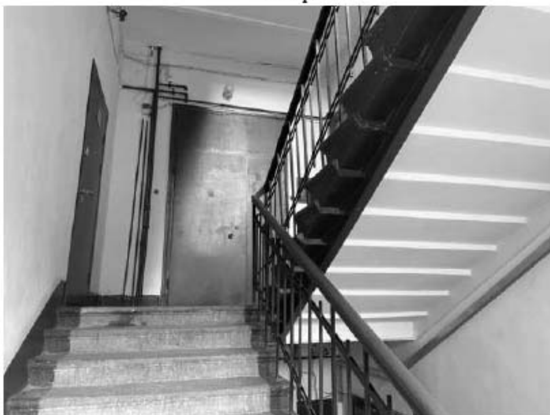
85. Фрагмент интерьера здания по адресу: улица Красного Курсанта, 34, литера Б
