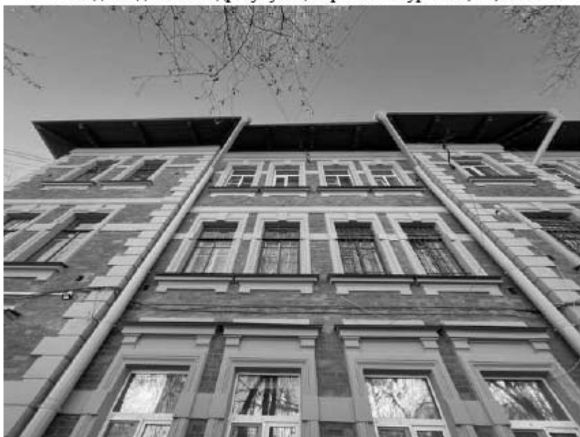
34. Вид на здание по адресу: улица Красного Курсанта, 34, литера А
