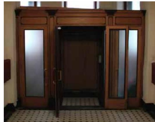
стены и потолок внутри тамбура облицованы деревянными панелями с профилированными филенками
