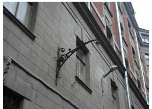
балкон на уровне 3-го этажа эркера на одном кронштейне со штукатурным декором, балконная дверь с профилированным наличником и разорванным треугольным сандриком, в центре которого львиный маскарон, сандрик на кронштейнах;
