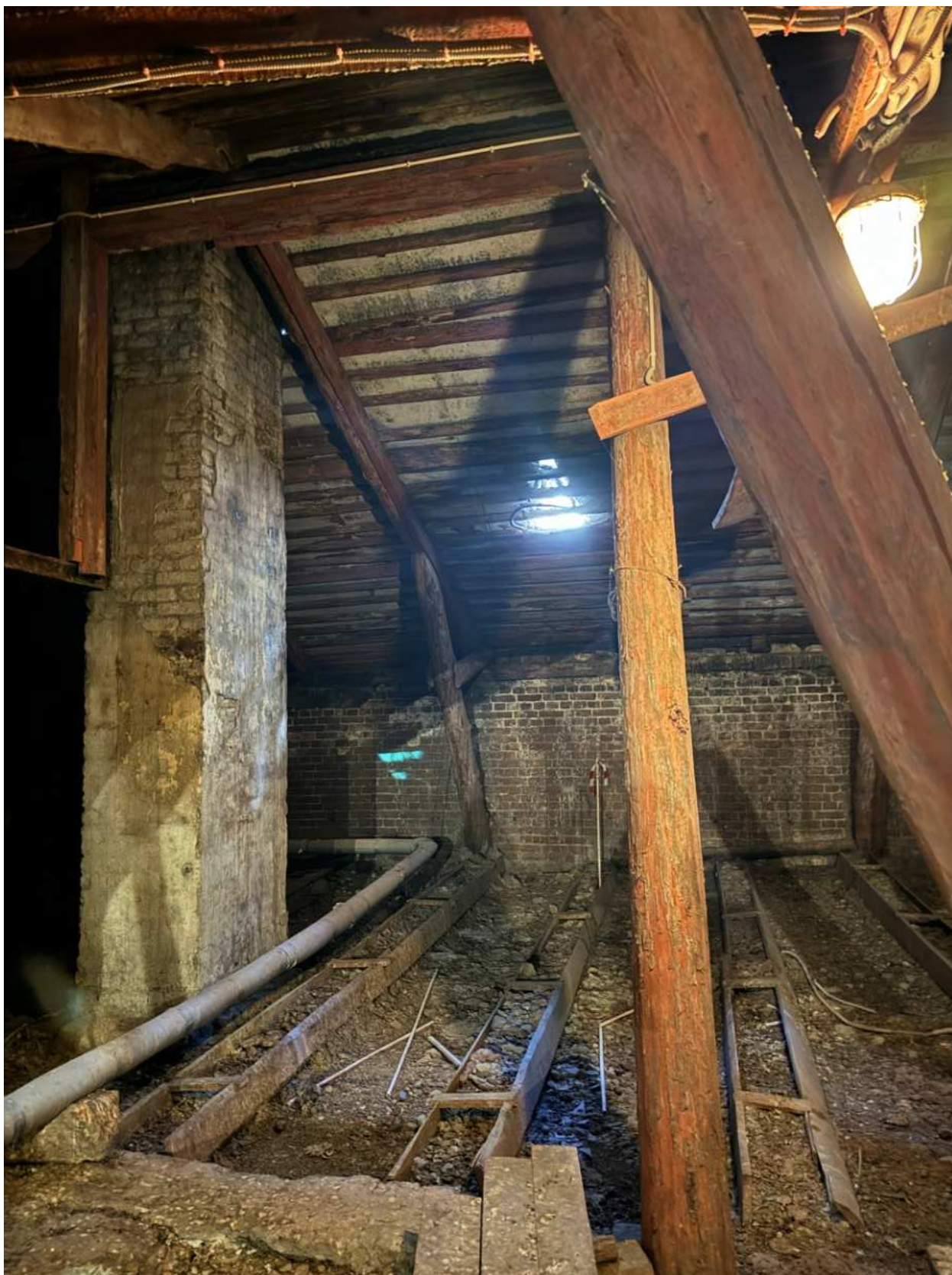
Фото 158. Вид на чердачные помещения объекта культурного наследия.
