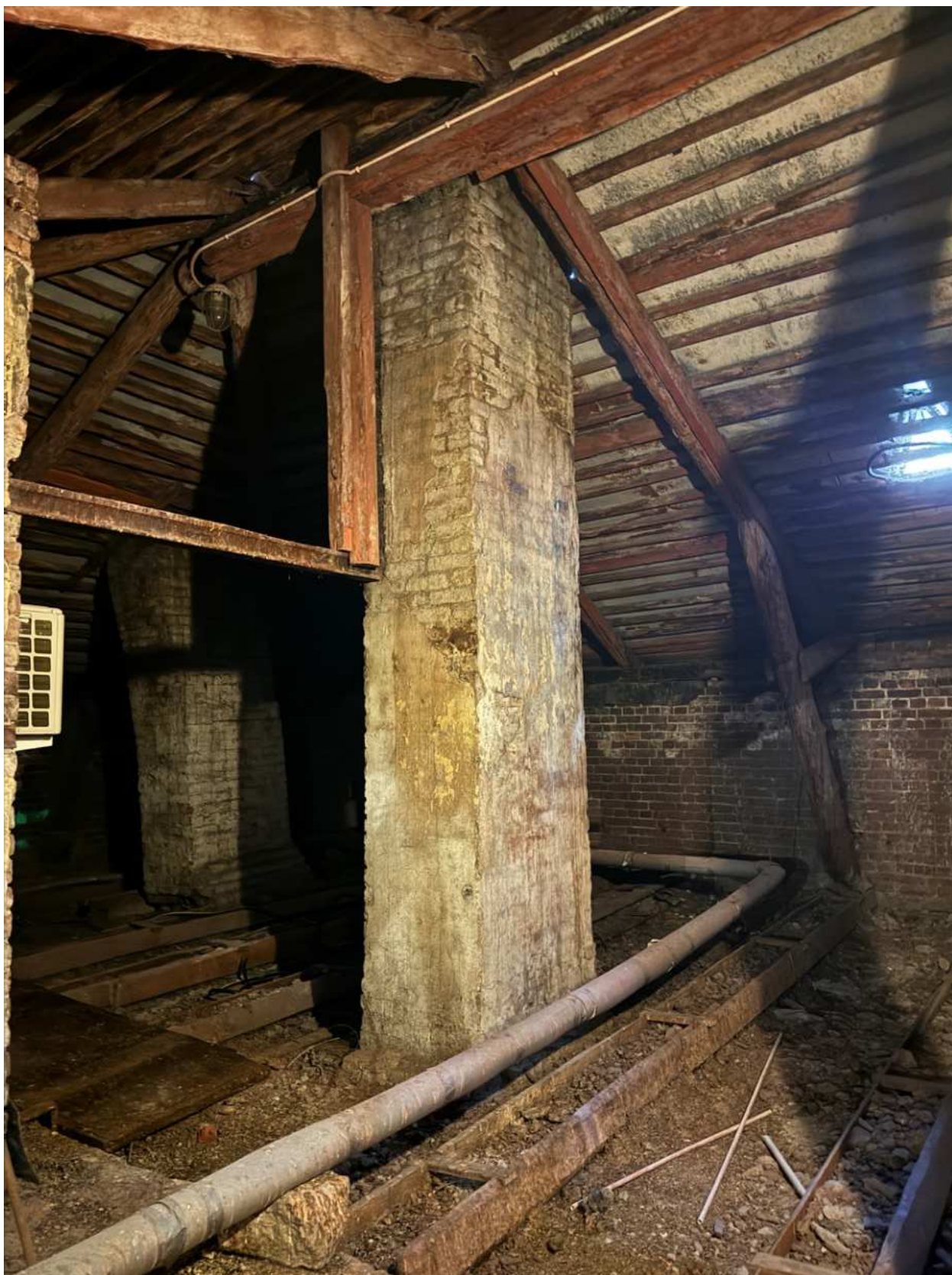
Фото 164. Вид на чердачные помещения объекта культурного наследия.
