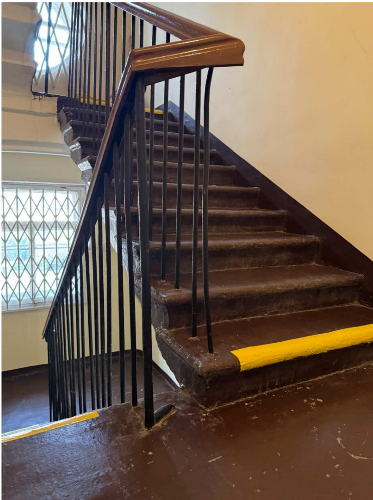
Фото 154. Вид на интерьер черной лестницы объекта культурного наследия.
