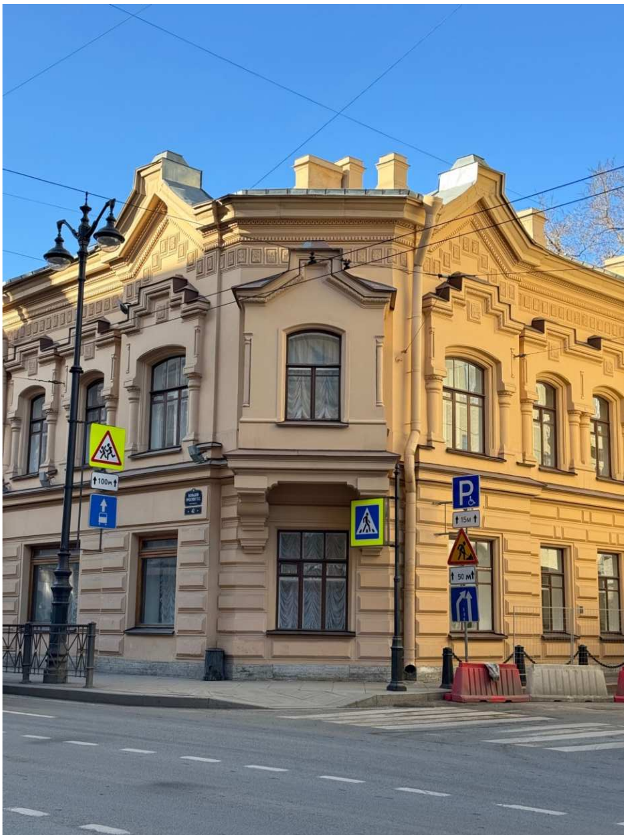
Фото 8. Вид на фасады объекта культурного наследия с перекрестка Стрельнинской улицы и Большого проспекта П.С.
