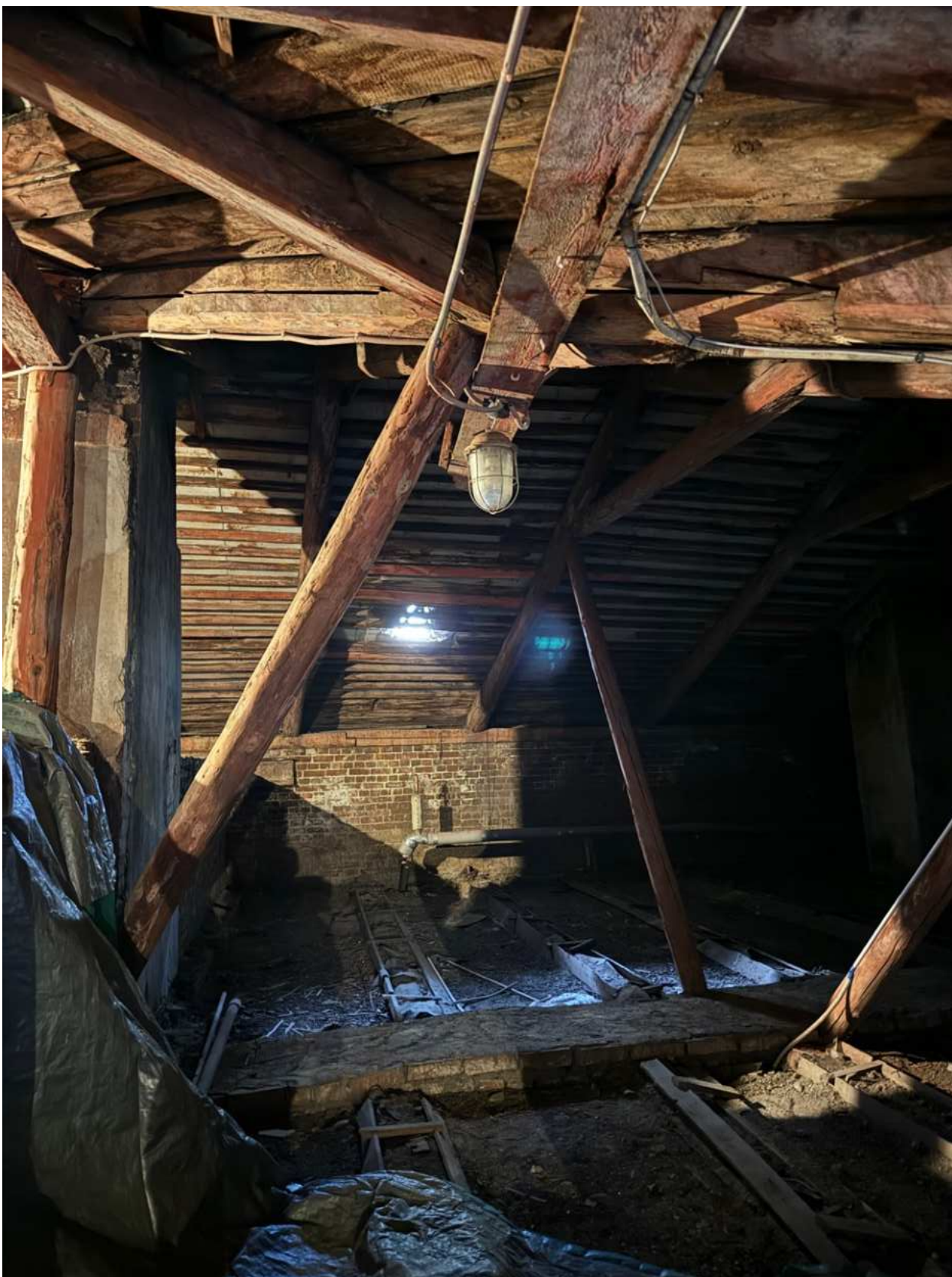
Фото 163. Вид на чердачные помещения объекта культурного наследия.
