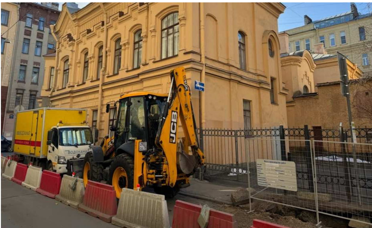
Фото 11. Вид на фасад объекта культурного наследия по Стрельнинской улице.
