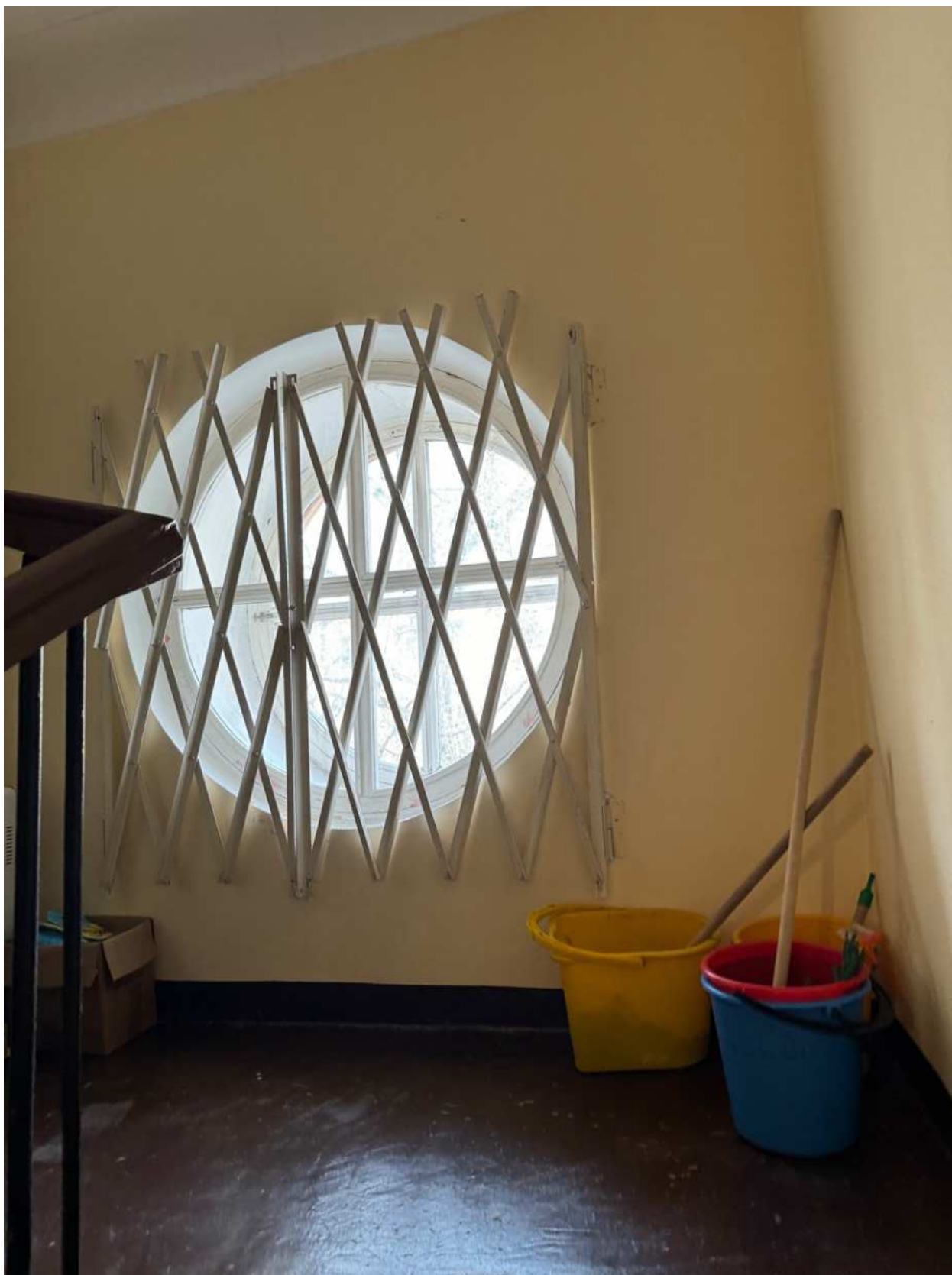
Фото 155. Вид на интерьер черной лестницы объекта культурного наследия.
