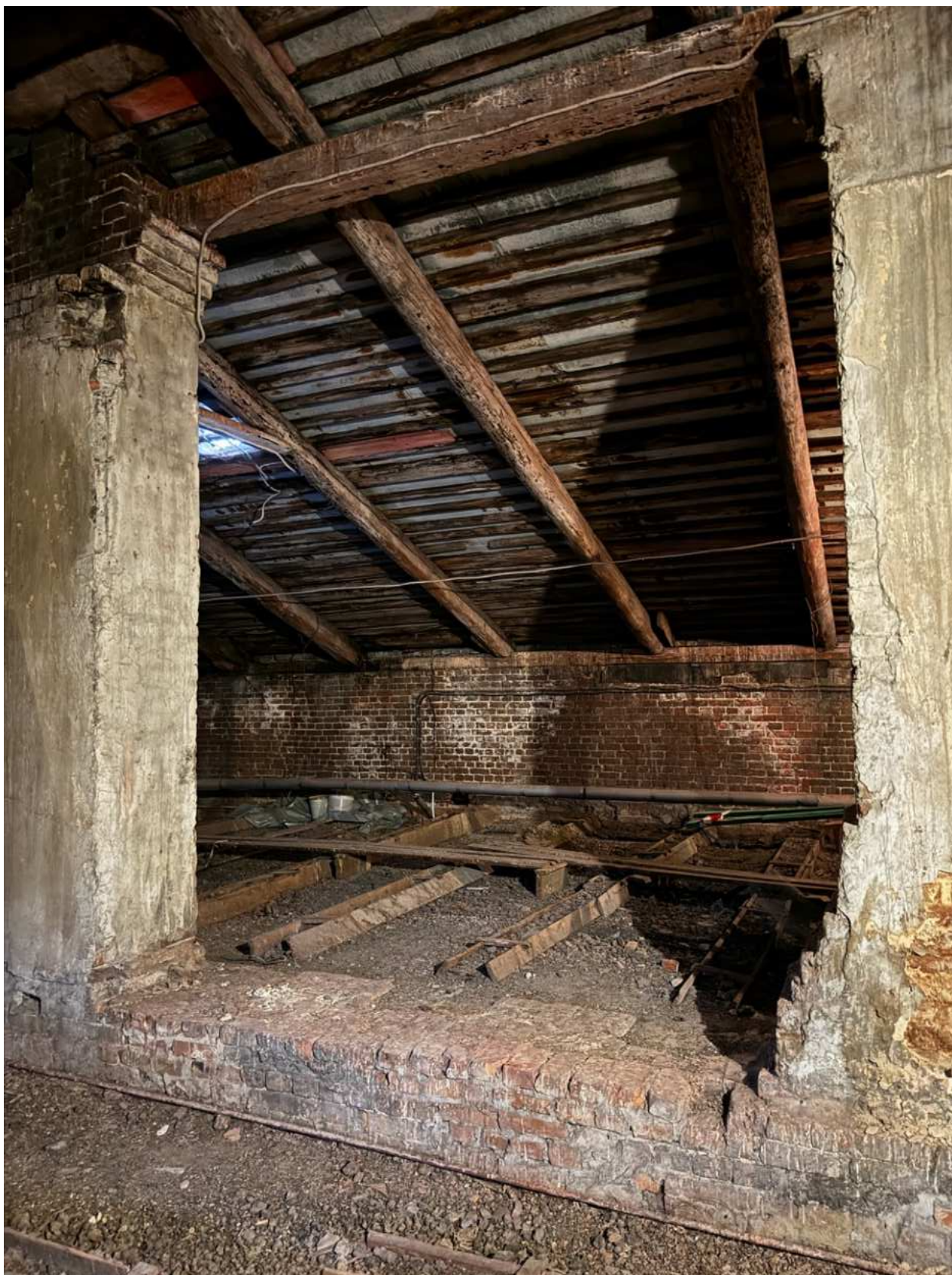
Фото 161. Вид на чердачные помещения объекта культурного наследия.
