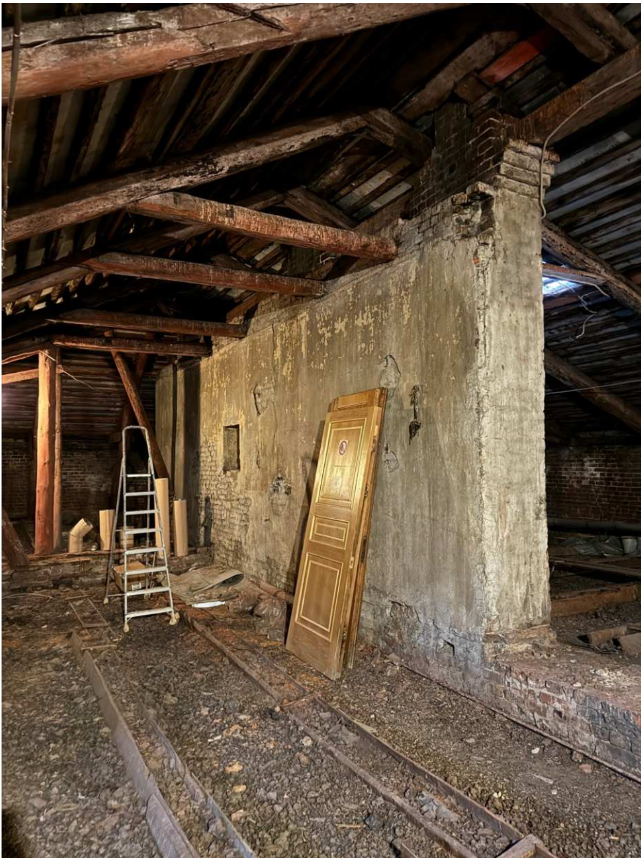
Фото 160. Вид на чердачные помещения объекта культурного наследия.
