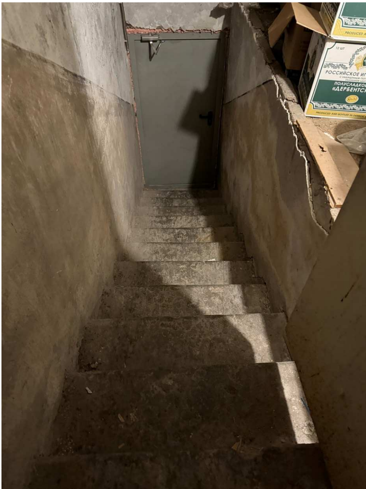
Фото 165. Вид на лестницу спуска в части чердака объекта культурного наследия.
