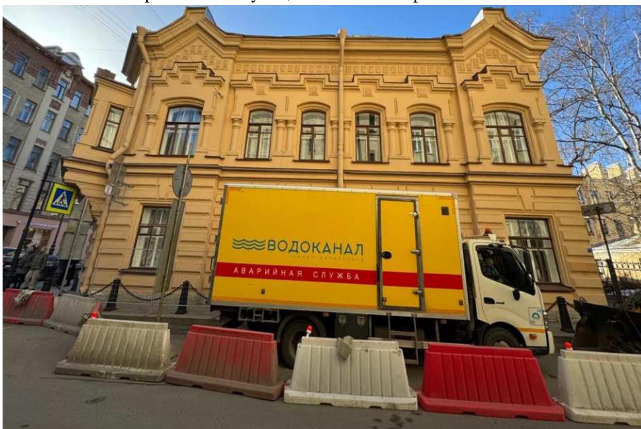
Фото 10. Вид на фасад объекта культурного наследия по Стрельнинской улице.
