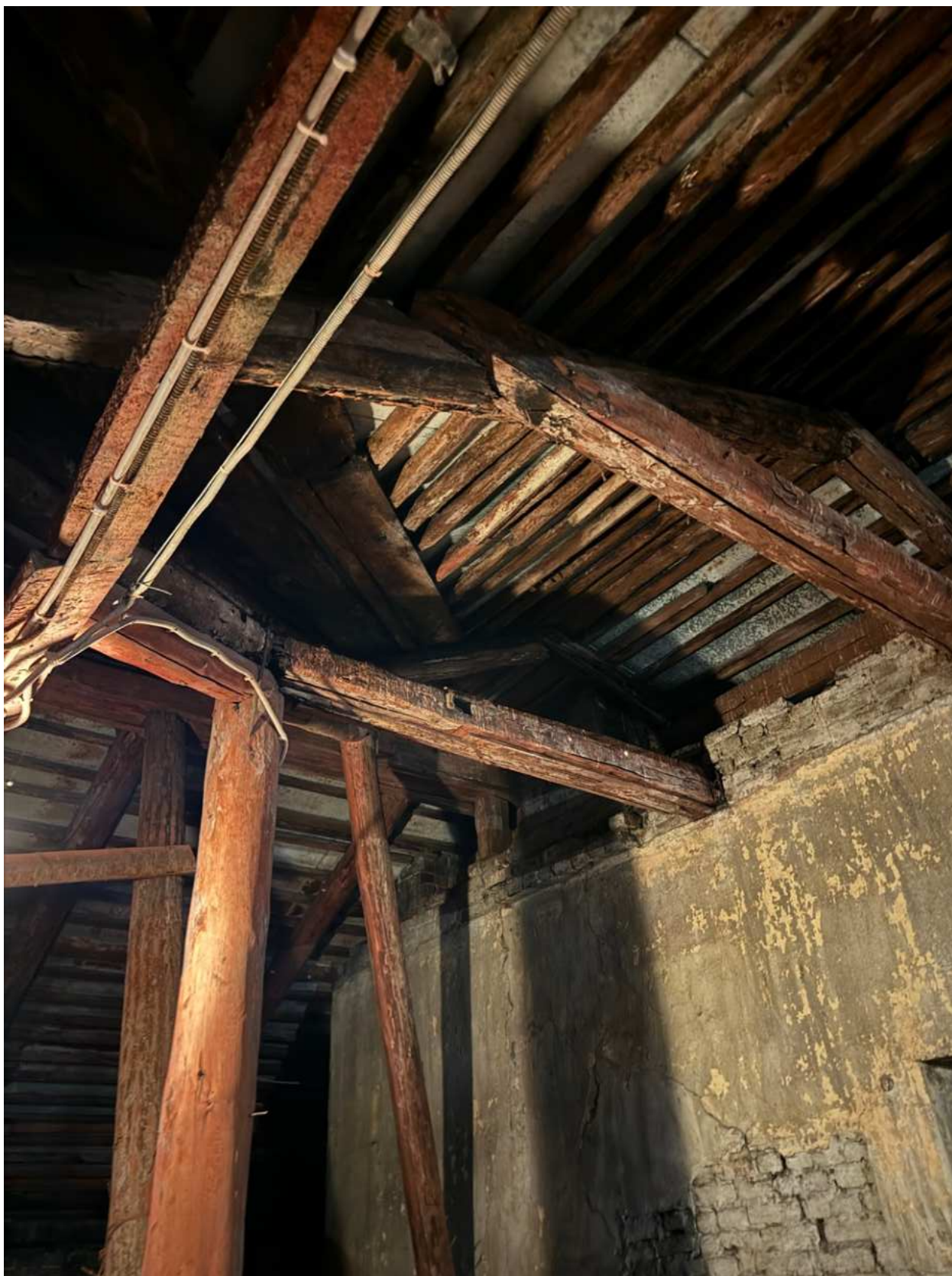
Фото 159. Вид на чердачные помещения объекта культурного наследия.
