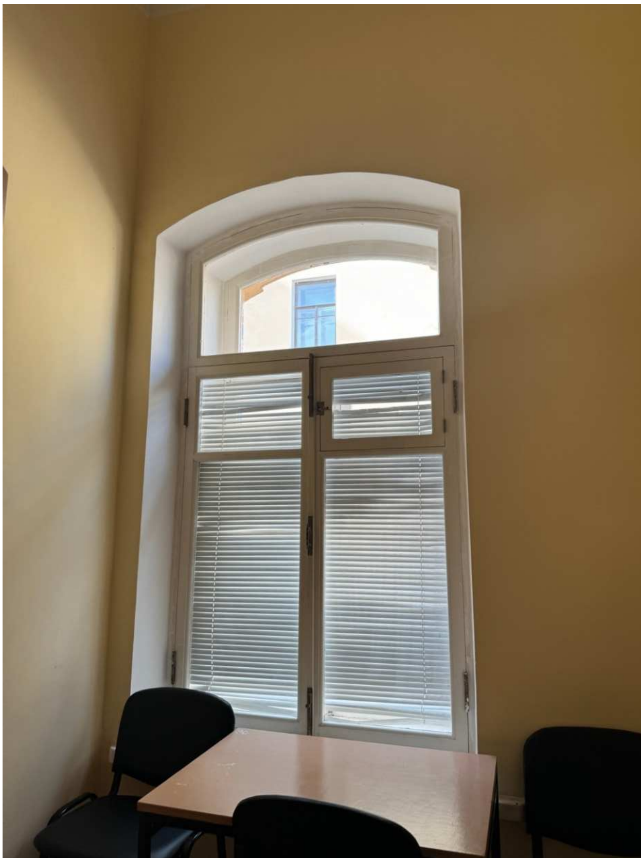
Фото 137. Вид на оконное заполнение помещения объекта культурного наследия.
