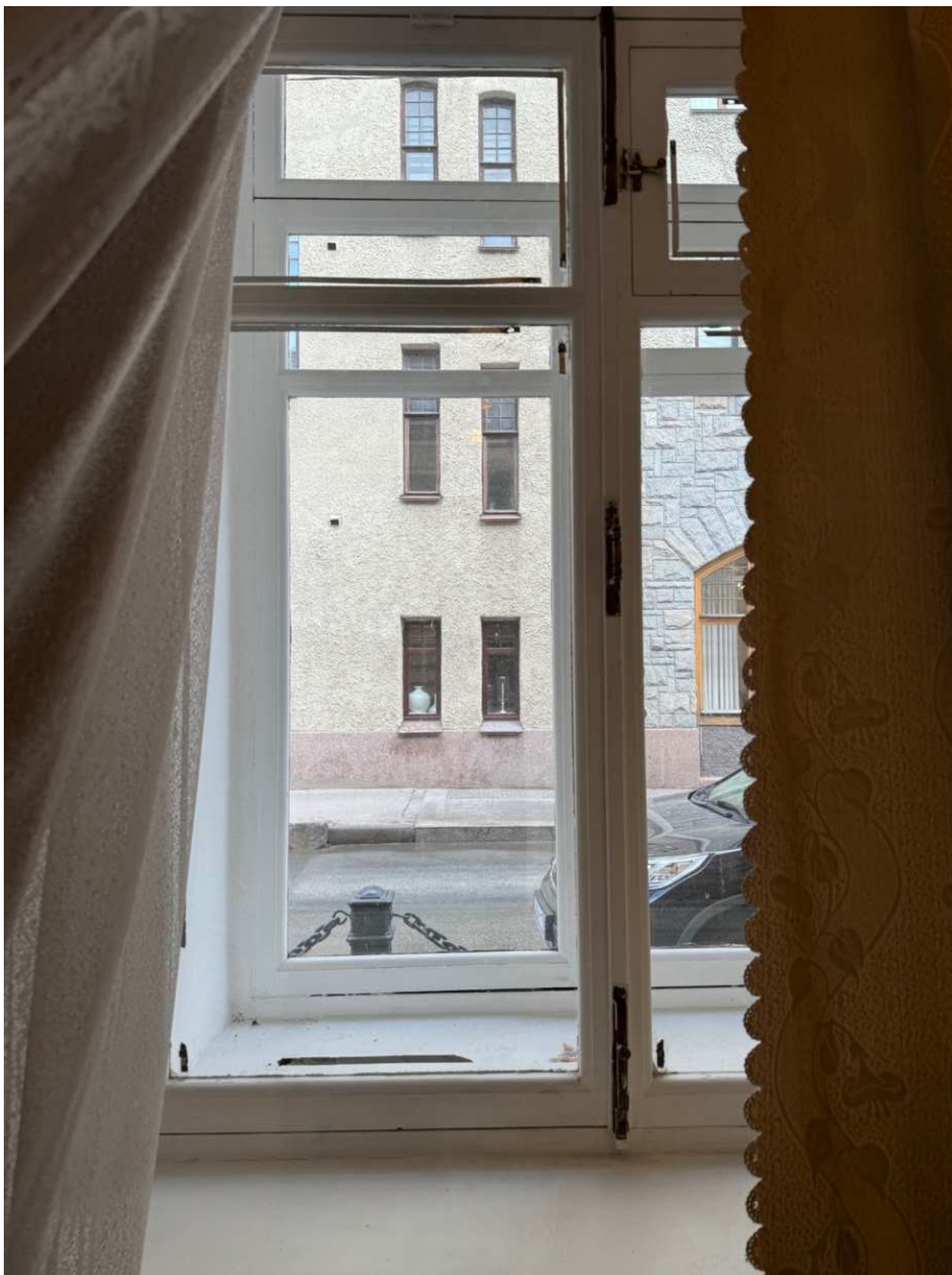
Фото 30. Вид на оконное заполнение помещения объекта культурного наследия.
