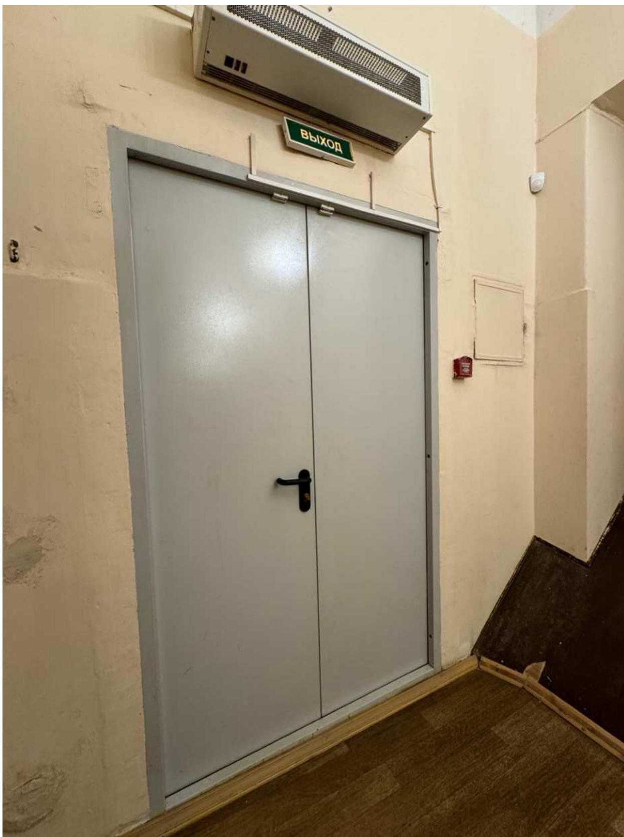
Фото 81. Вид на дверное заполнение объекта культурного наследия.
