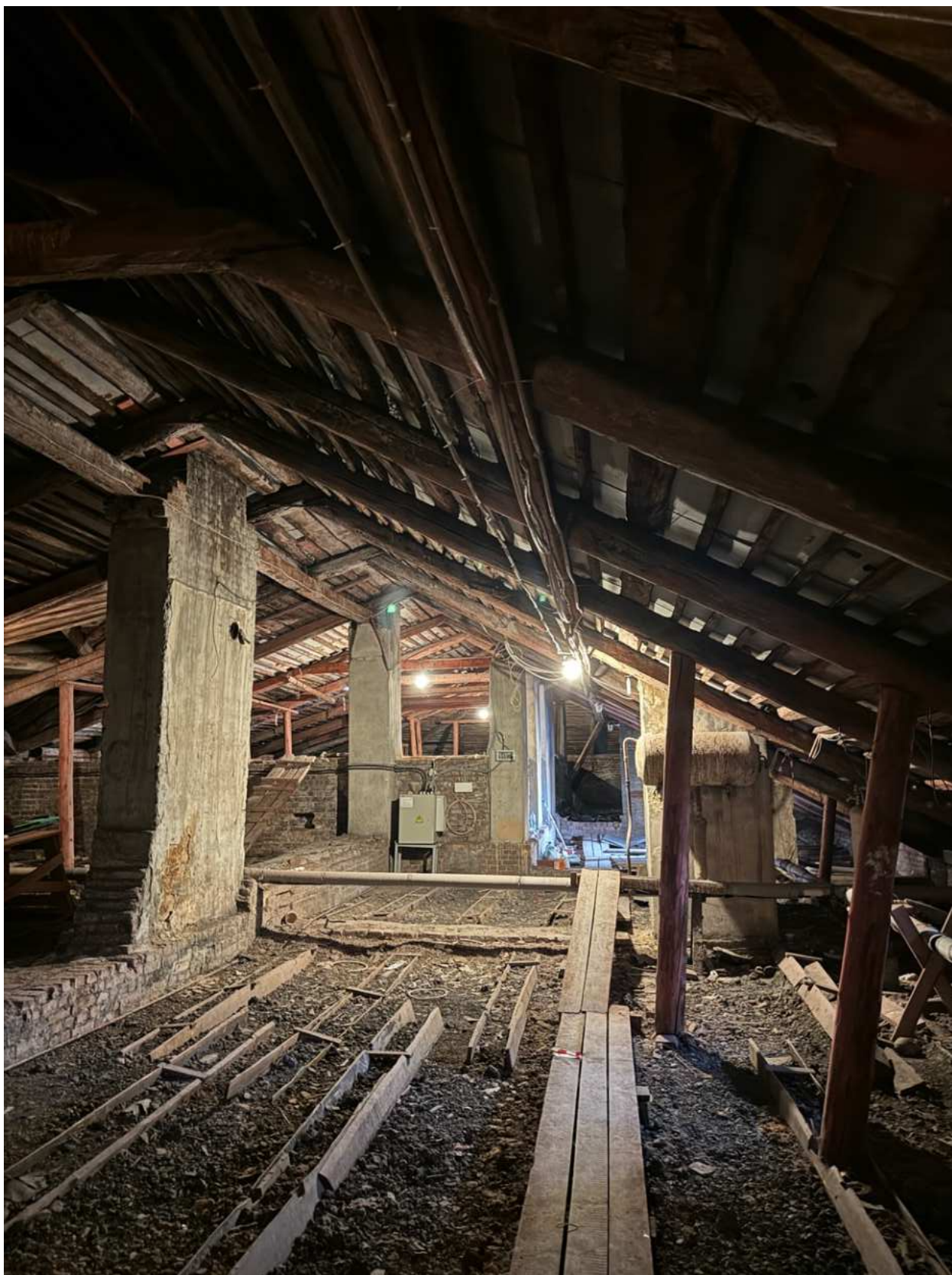
Фото 157. Вид на чердачные помещения объекта культурного наследия.
