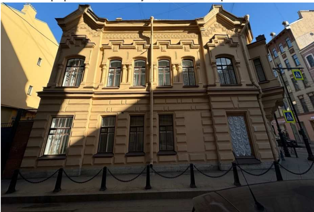
Фото 2. Общий вид лицевого фасада объекта культурного наследия по Колпинской улице.
