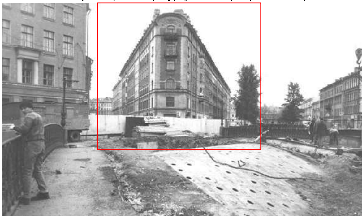
169. Демидов мост, ремонт. 1999 г. [Электронный ресурс] URL: https://pastvu.com/p/508823
