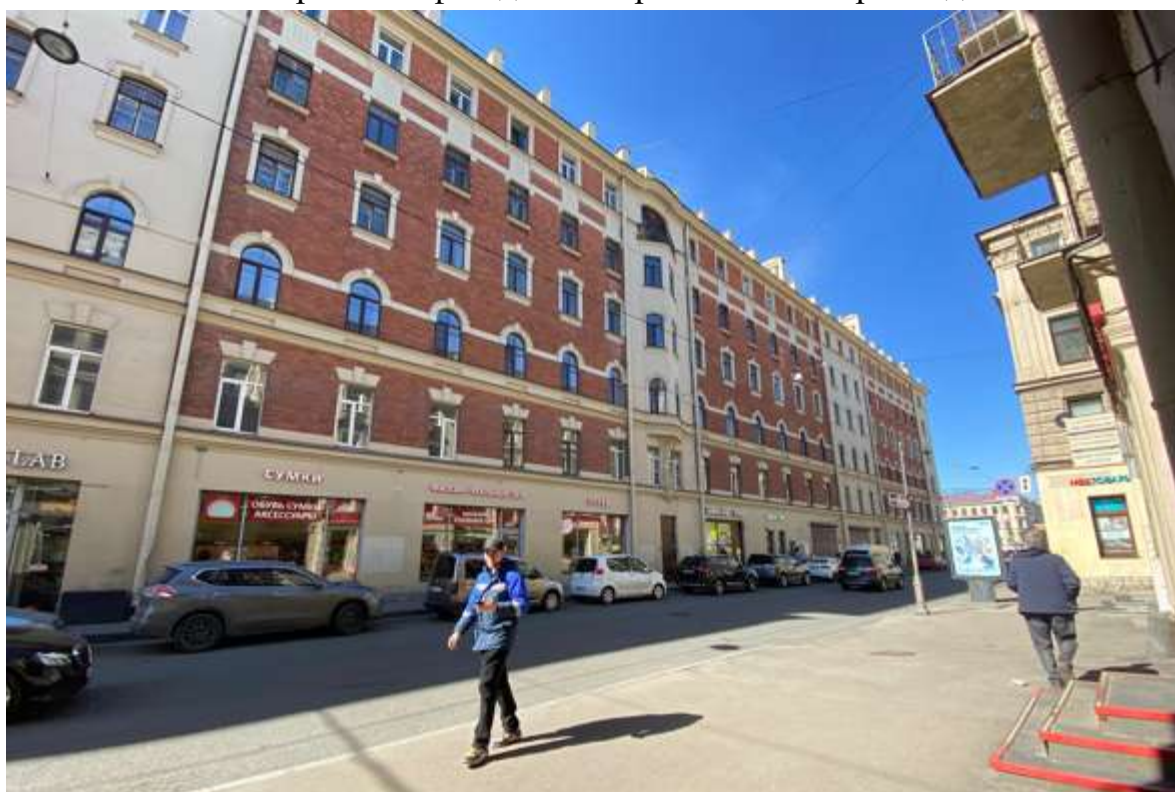
17. Фрагмент фасада со стороны переулка Гривцова
