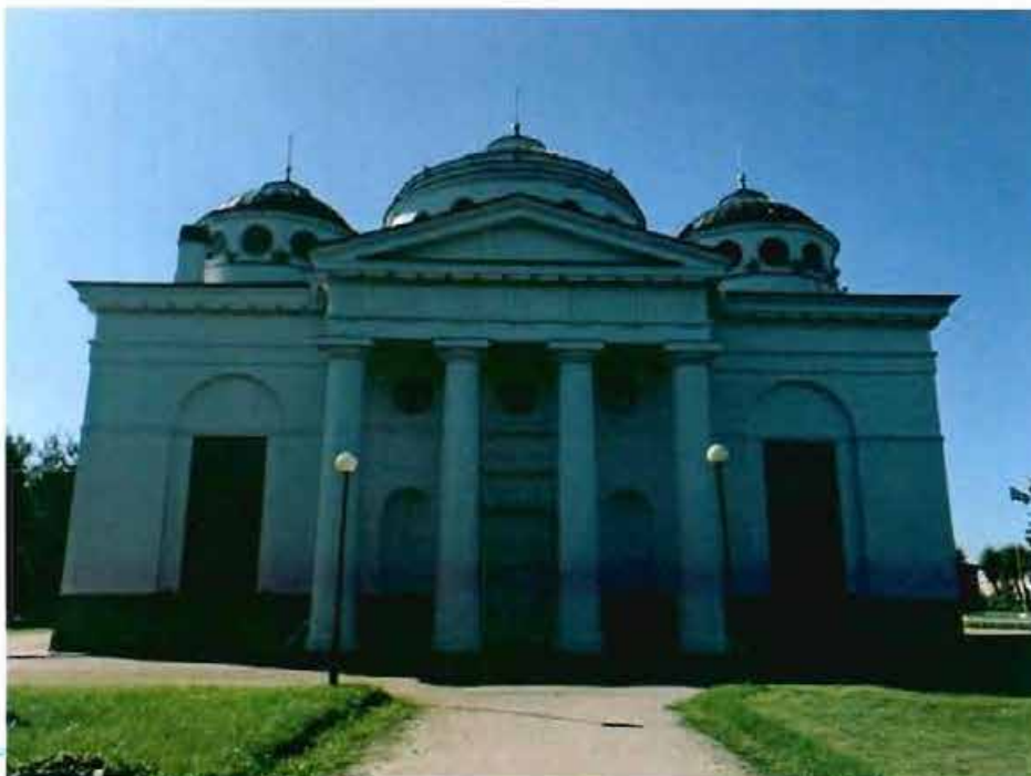
4. Вид на северный фасад.
