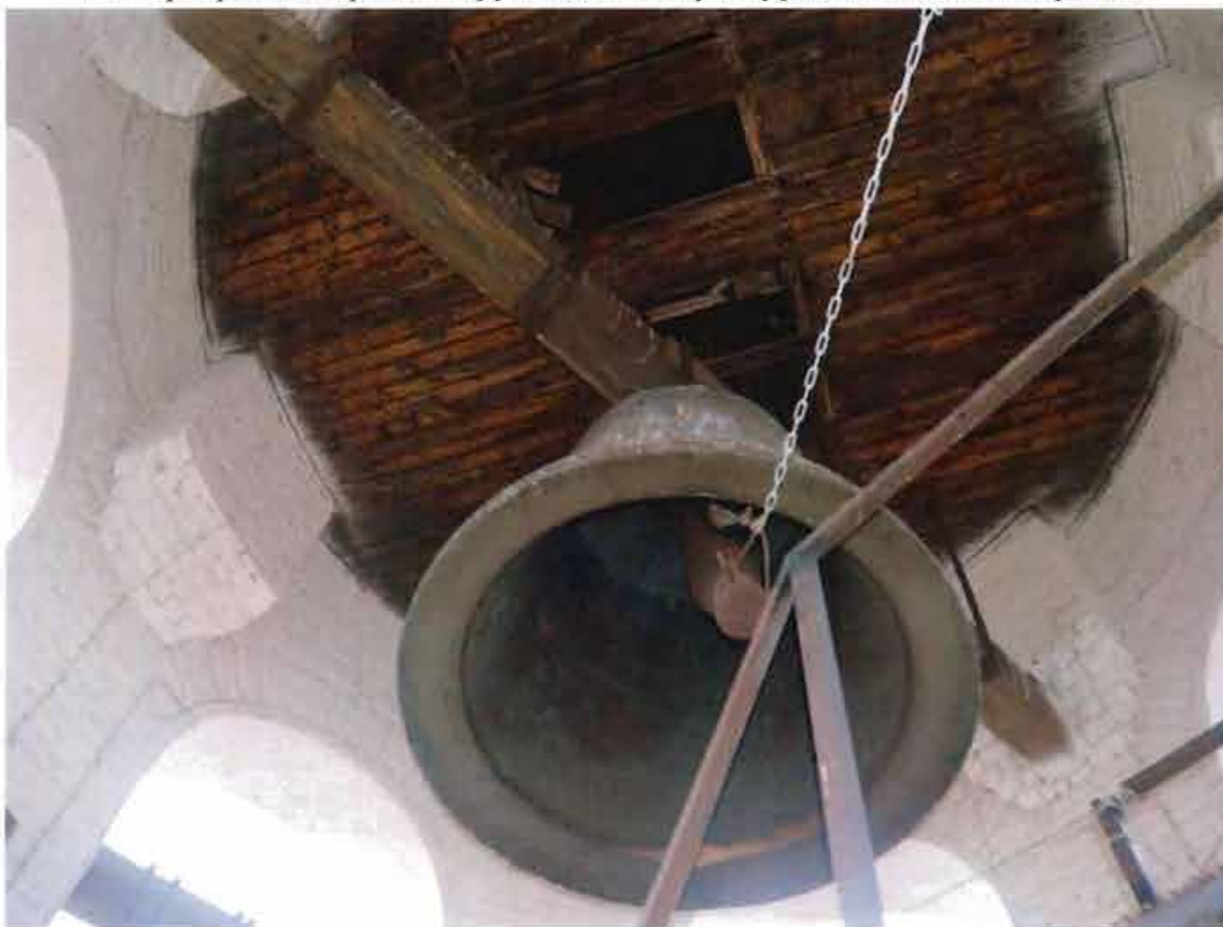
6. Перекрытия верхнего яруса объекта культурного наследия. Аркада.
