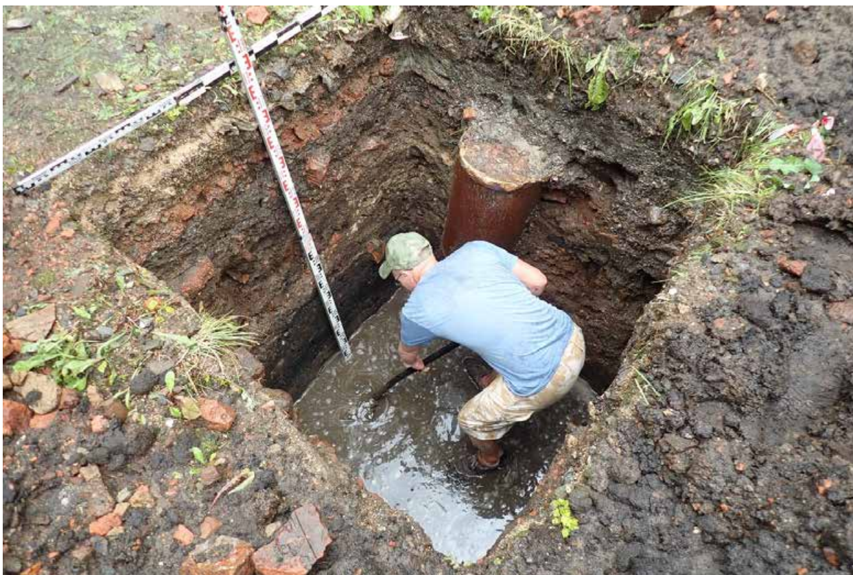
Рис. 15. Земельный участок с кадастровым номером 78:13:0007310:2145 по адресу г. Санкт-Петербург, Курская улица, дом 27. Прокопка материкового грунта.
