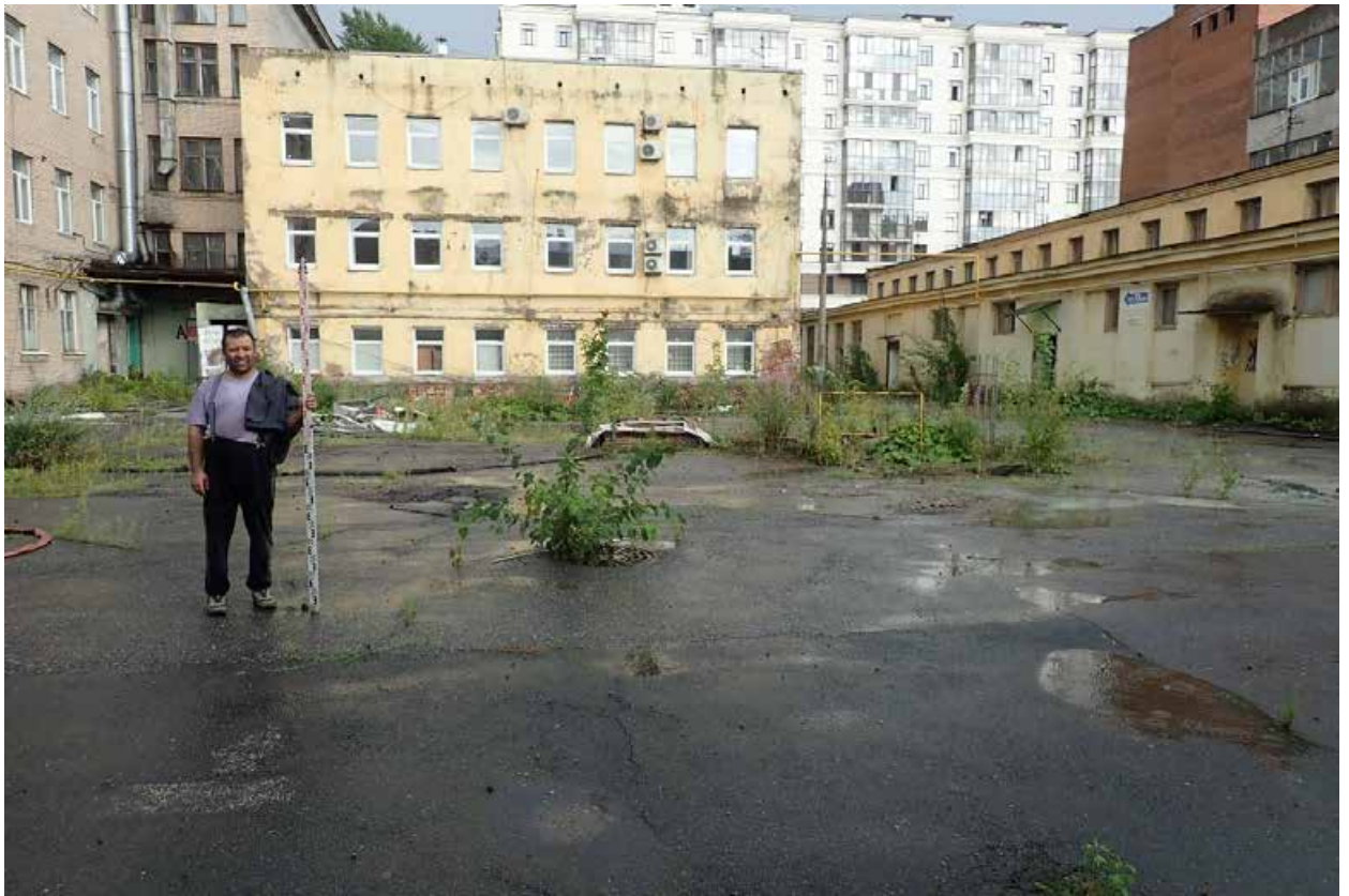
Рис. 17 Земельный участок с кадастровым номером 78:13:0007310:2145 по адресу г. Санкт-Петербург, Курская улица, дом 27. Точка фотофиксации 2, вид с запада.
