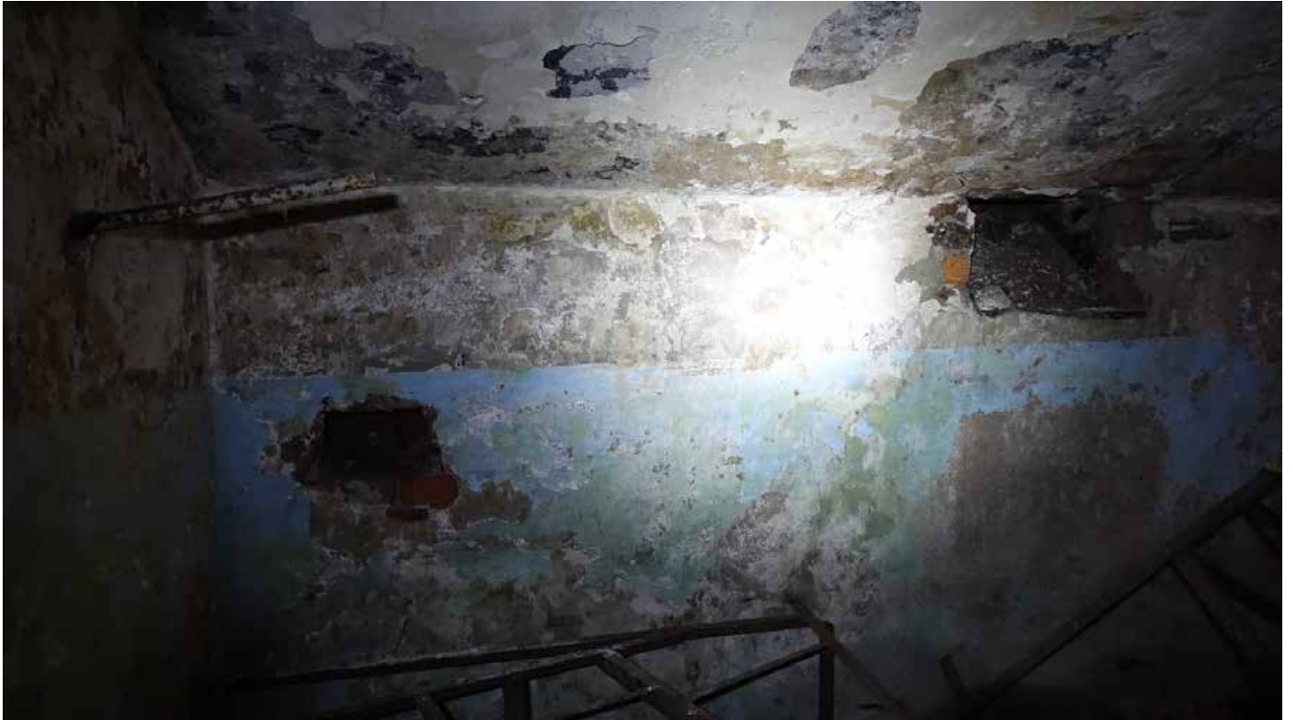
Фото 15. Помещение 154. Фрагмент свода и стены. Цокольный этаж. Дата фотофиксации: 01.03.24
