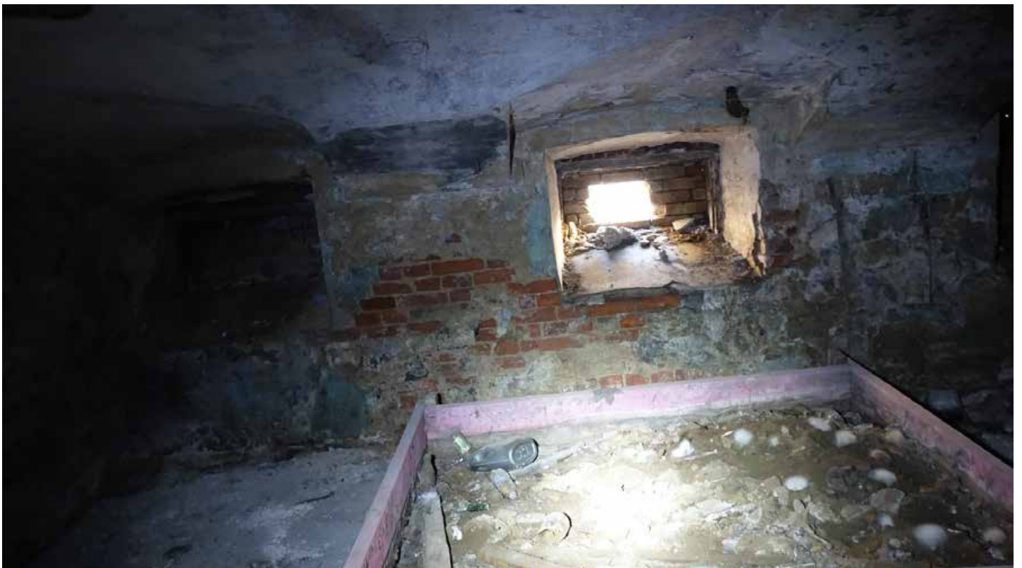
Фото 44. Помещение 8. Фрагмент стены и оконный проем. Цокольный этаж. Дата фотофиксации: 01.03.24
