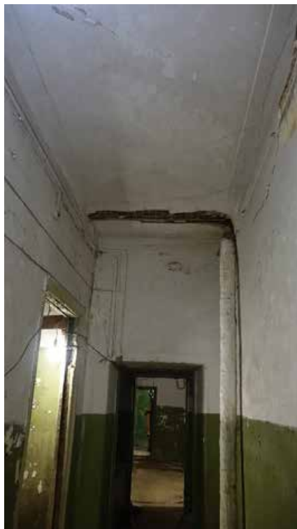
Фото 234. Помещение 128.Коридор. Третий этаж. Дата фотофиксации: 01.03.24
