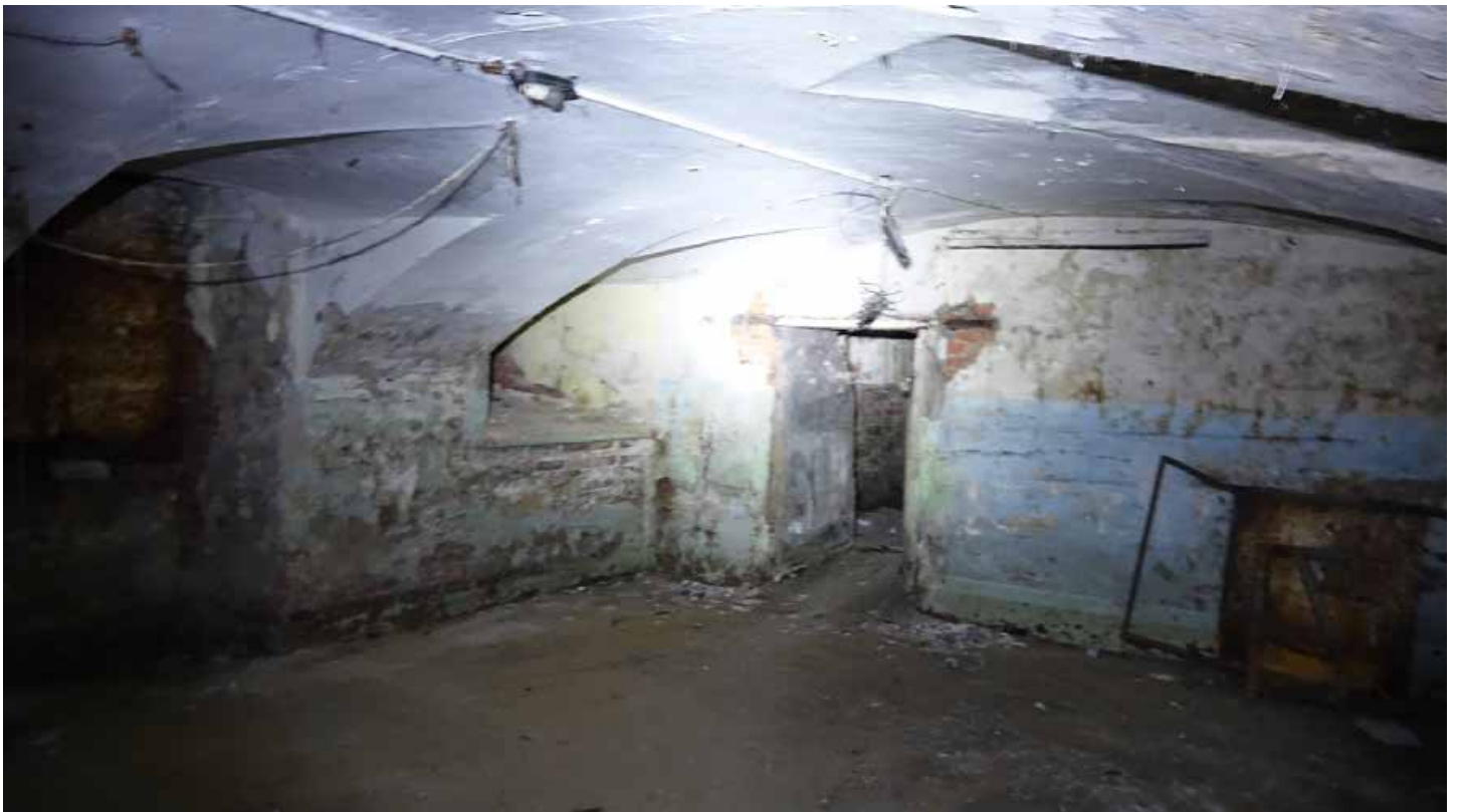
Фото 8. Помещение 151. Коробовый свод с распалубками. Цокольный этаж. Дата фотофиксации: 01.03.24
