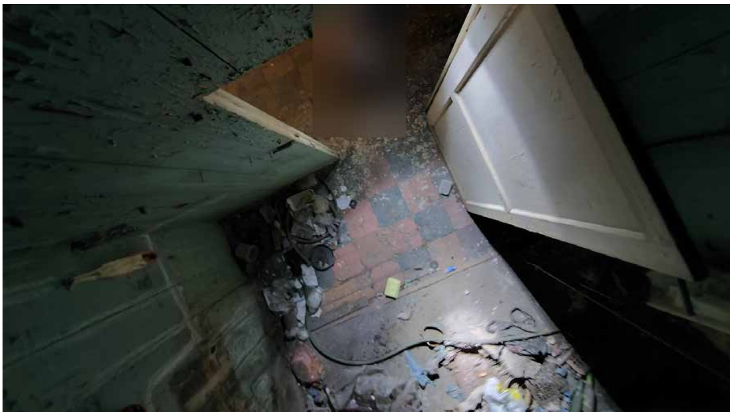
Фото 199. Помещение 106. Общий вид. Третий этаж. Дата фотофиксации: 01.03.24
