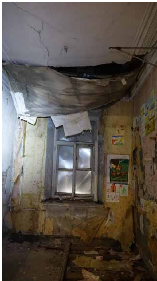
Фото 215. Помещение 123. Общий вид. Третий этаж. Дата фотофиксации: 01.03.24
