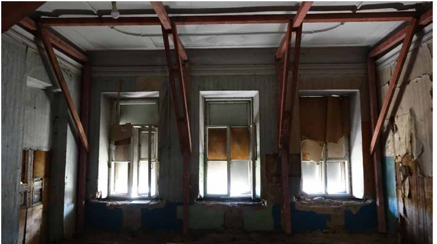
Фото 147. Помещение 58. Общий вид. Второй этаж. Дата фотофиксации: 01.03.24
