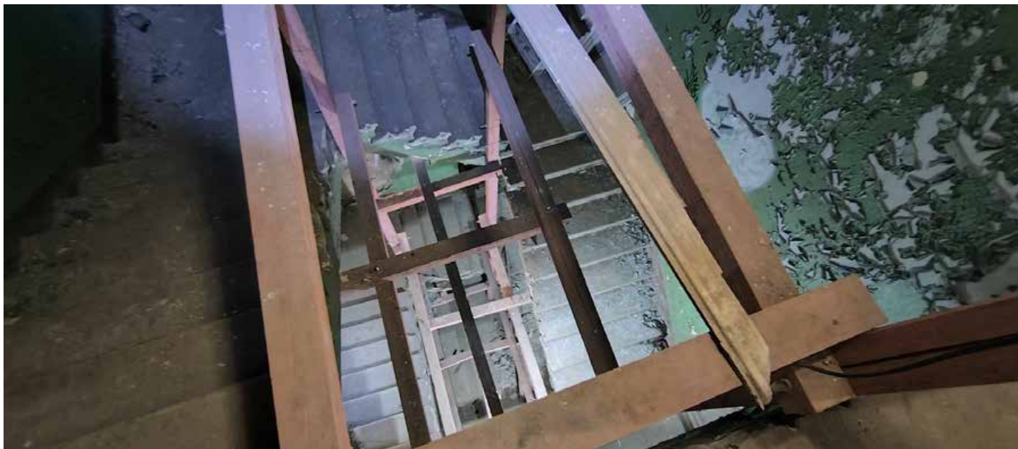
Фото 7. Лестница Л1. Вид сверху вниз с уровня 3-го этажа. Дата фотофиксации: 01.03.24
