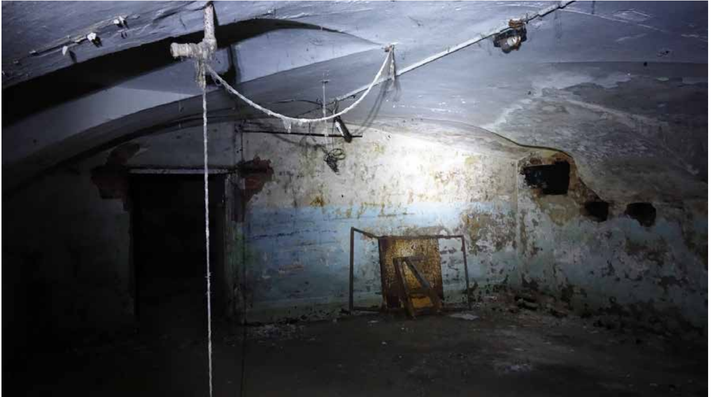
Фото 11. Помещение 151. Коробовый свод с распалубками. Цокольный этаж. Дата фотофиксации: 01.03.24
