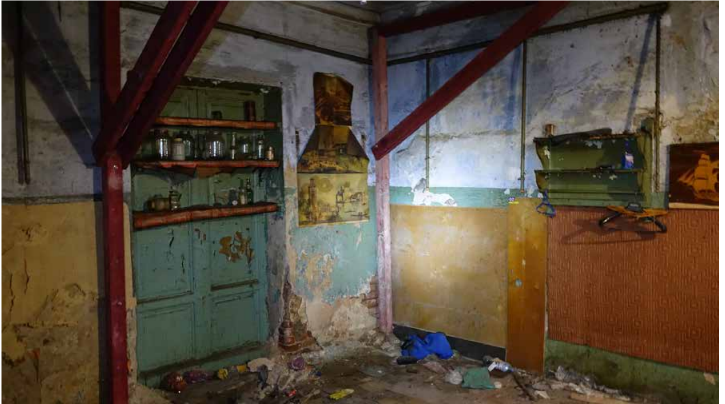
Фото 76. Помещение 22. Ниша в стене. Первый этаж. Дата фотофиксации: 01.03.24
