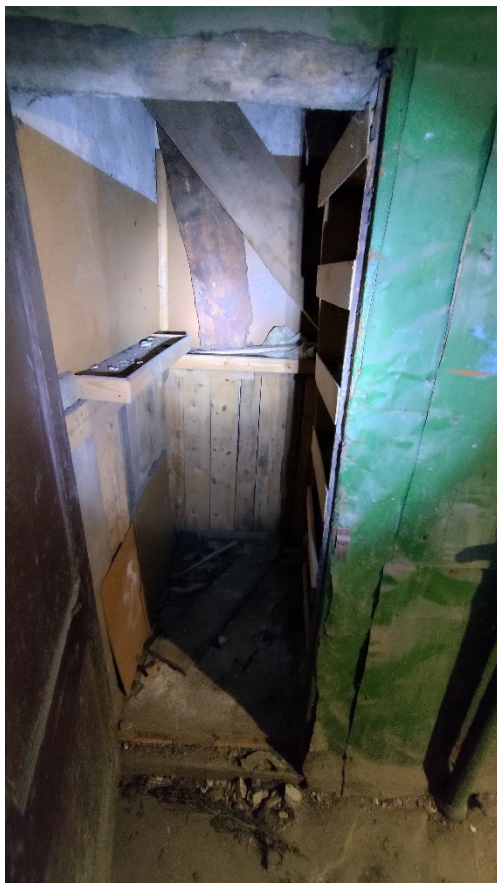
Фото 132. Помещение 2 со стороны лестницы Л2. Первый этаж. Дата фотофиксации: 01.03.24
