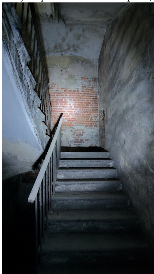
Фото 16. Служебная лестница ЛЗ. Лестничный марш в уровне 1-го этажа. Дата фотофиксации: 01.03.24
