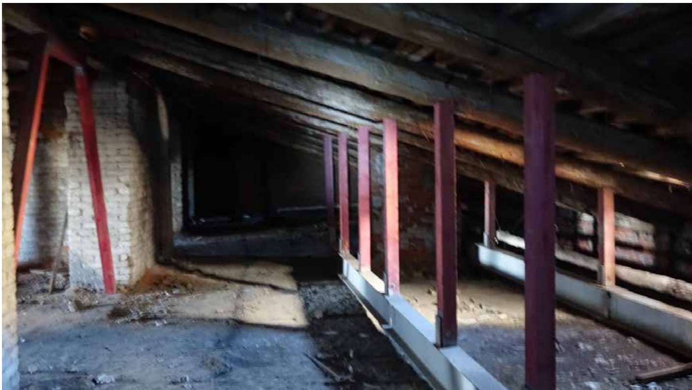
Фото 246. Мансарда. Основной объём. Фрагмент. Дата фотофиксации: 01.03.24
