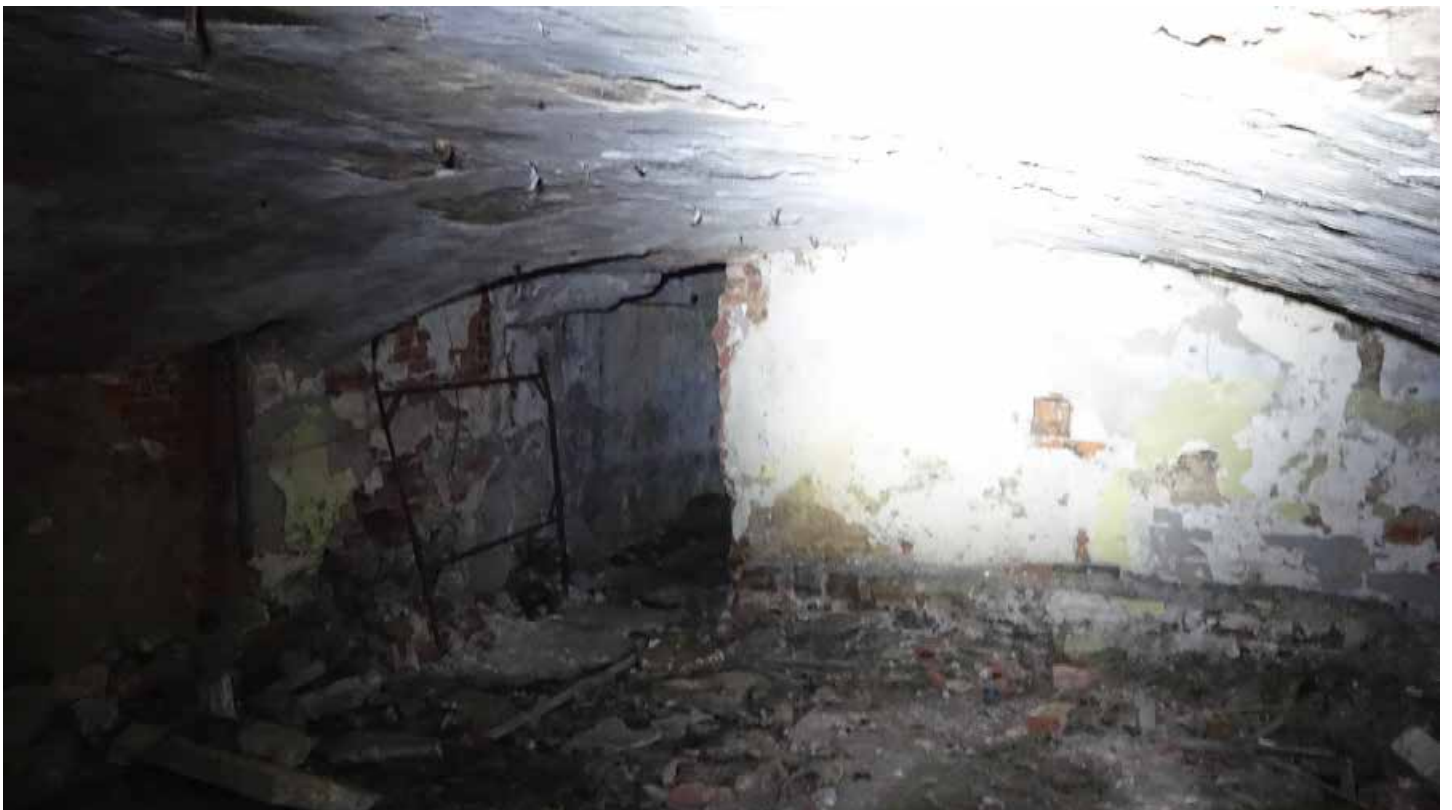
Фото 30. Помещение 147. Цилиндрический свод. Цокольный этаж. Дата фотофиксации: 01.03.24
