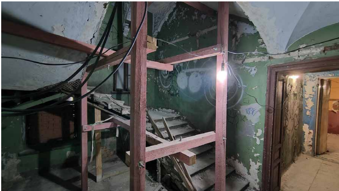
Фото 1. Парадная лестница Л1. Вид на нижний марш. Дата фотофиксации: 01.03.24
