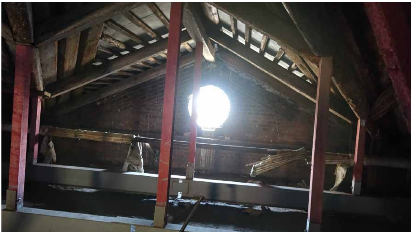
Фото 248. Окно люкарна во фронтоне. Мансарда. Дата фотофиксации: 01.03.24
