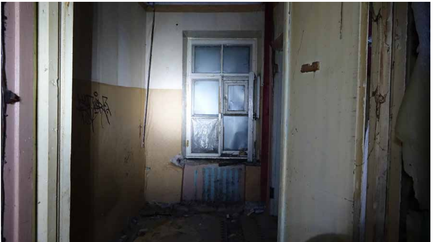
Фото 73. Помещение 23. Общий вид. Первый этаж. Дата фотофиксации: 01.03.24
