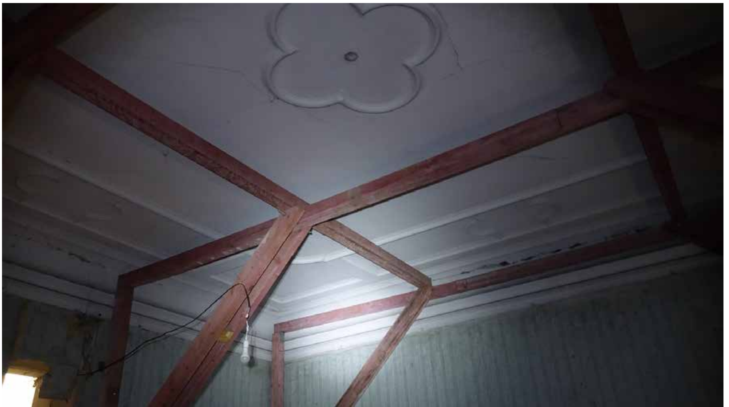
Фото 148. Помещение 58. Розетка в виде квадрифолии, вдоль которой расположены зеркала в штукатурном обрамлении с фигурными сложно профилированными деталями. Второй этаж. Дата фотофиксации: 01.03.24
