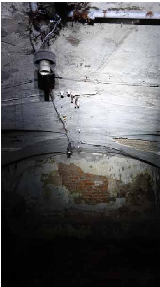
Фото 35. Помещения 148-149. Коробовый свод с распалубками. Остатки электропроводки. Цокольный этаж. Дата фотофиксации: 01.03.24
