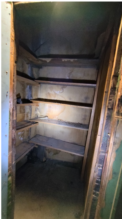
Фото 242. Помещение 8. Общий вид. Третий этаж. Дата фотофиксации: 01.03.24
