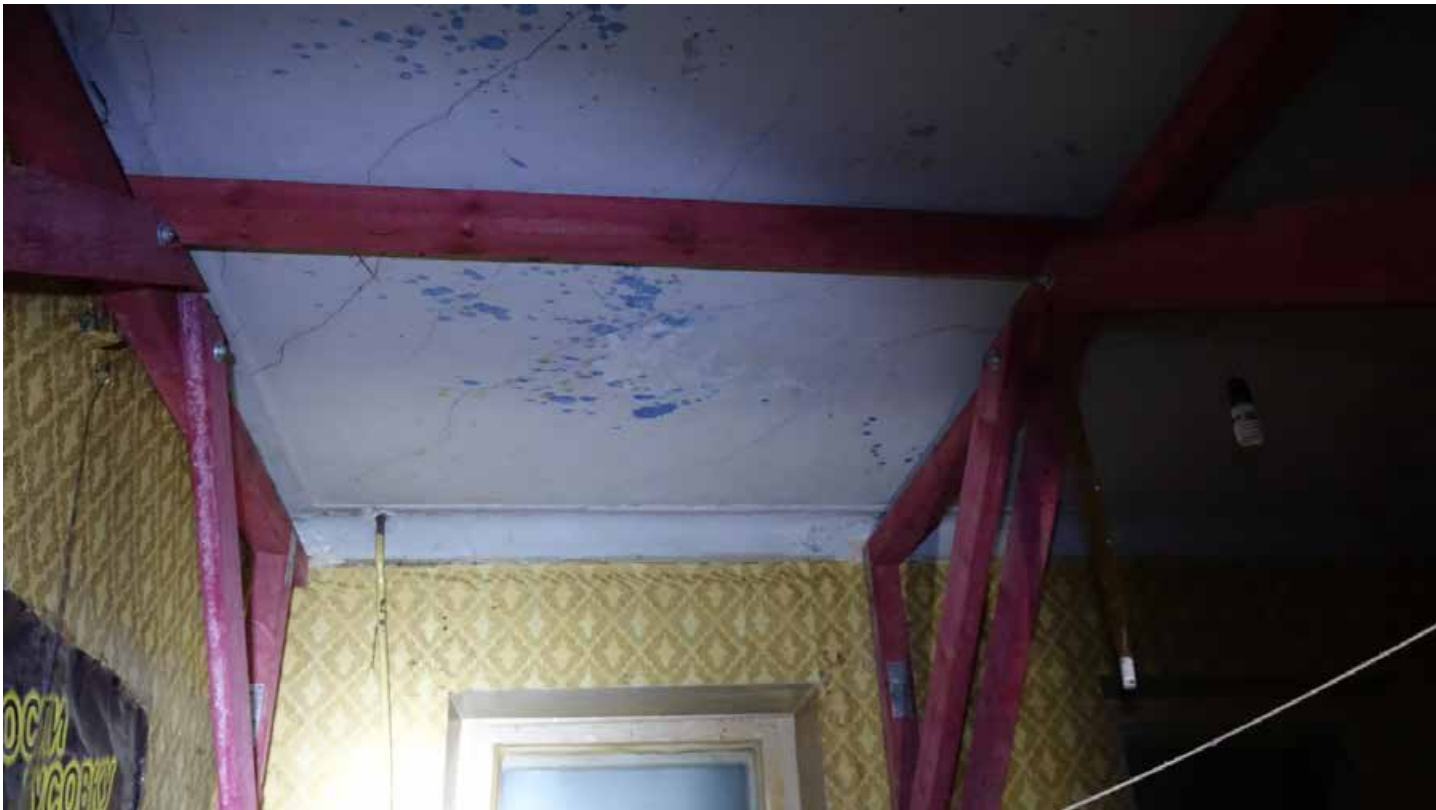
Фото 88. Помещение 21. Падуга потолка советского времени. Первый этаж. Дата фотофиксации: 01.03.24
