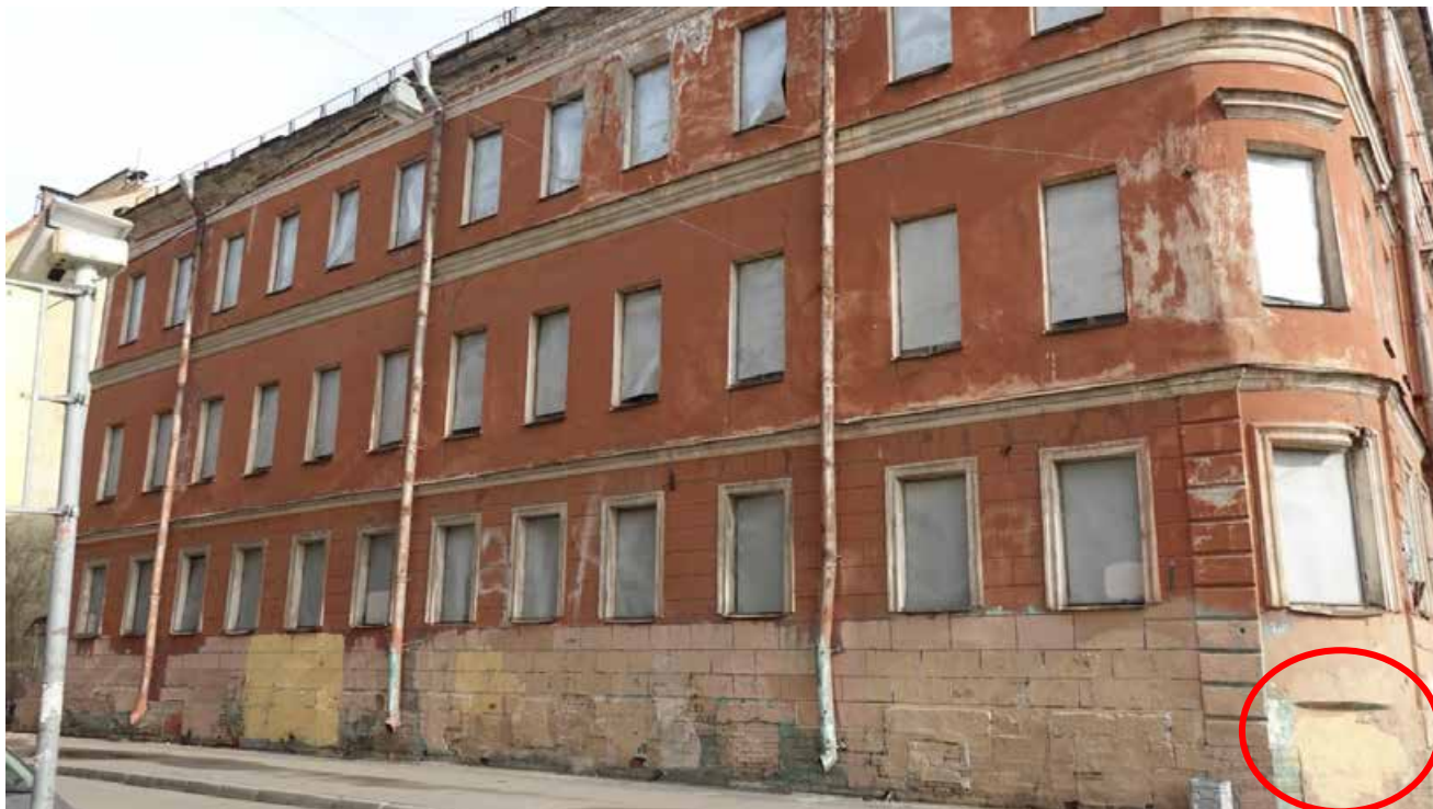
Фото 3. Западный фасад. Вид на замурованный приямок. Дата фотофиксации: 01.03.24
