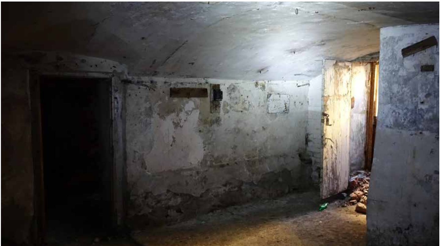
Фото 2. Помещение 153. Цилиндрический свод. Цокольный этаж. Вид на окно цоколя. Дата фотофиксации: 01.03.24
