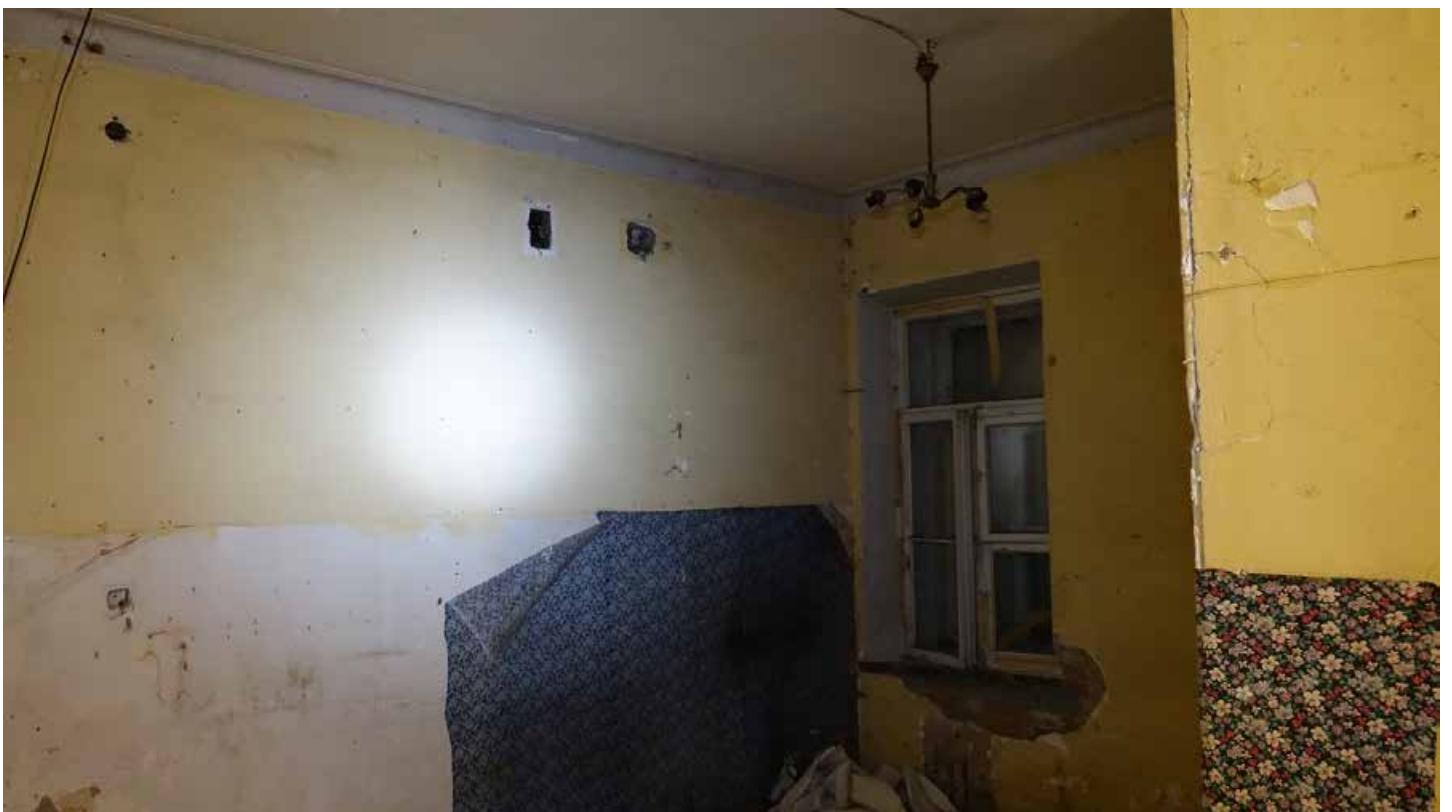
Фото 127. Помещение 45. Вентиляционные отверстия. Первый этаж. Дата фотофиксации: 01.03.24
