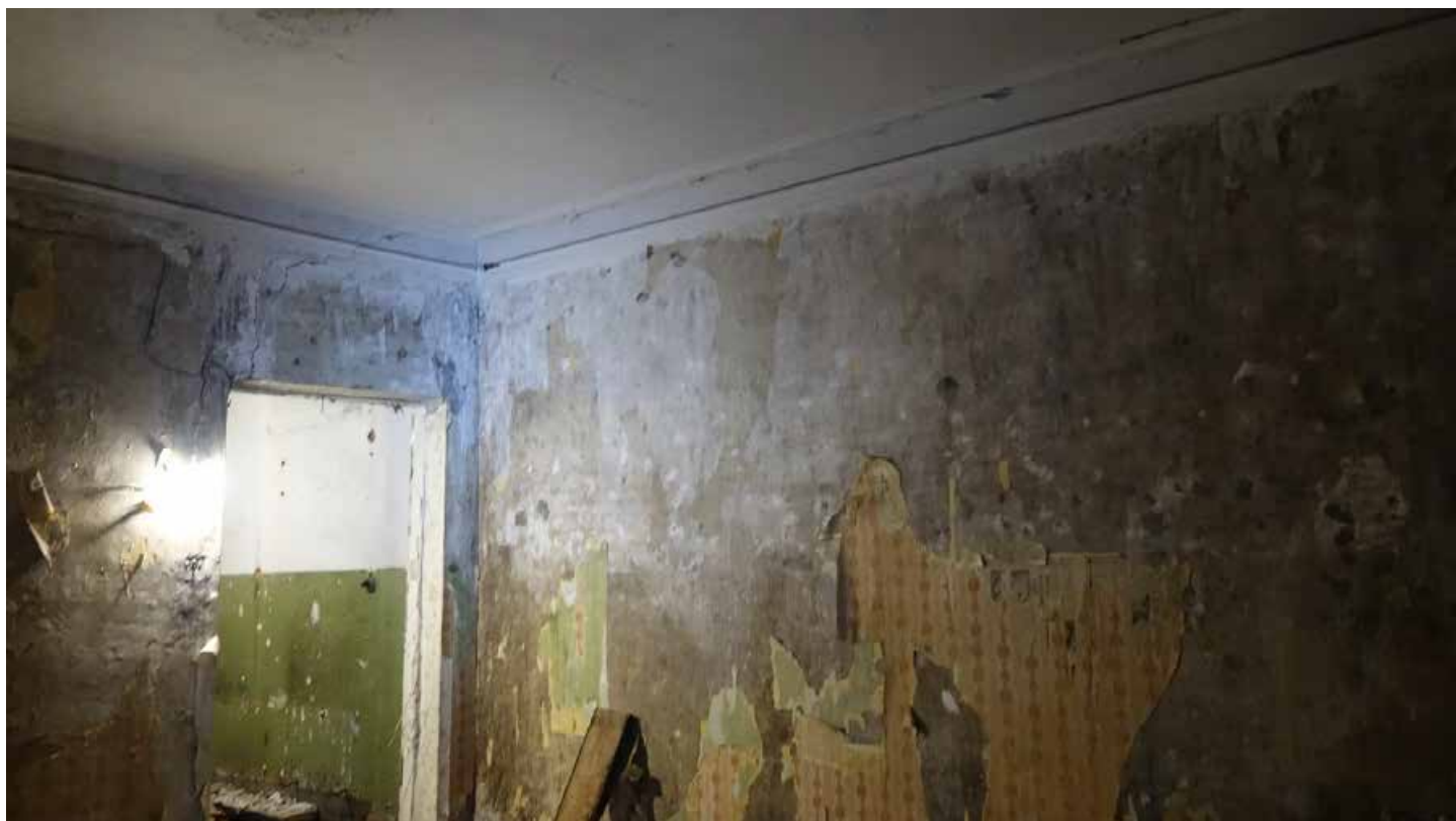
Фото 229. Помещение 133. Карниз советского периода. Третий этаж. Дата фотофиксации: 01.03.24
