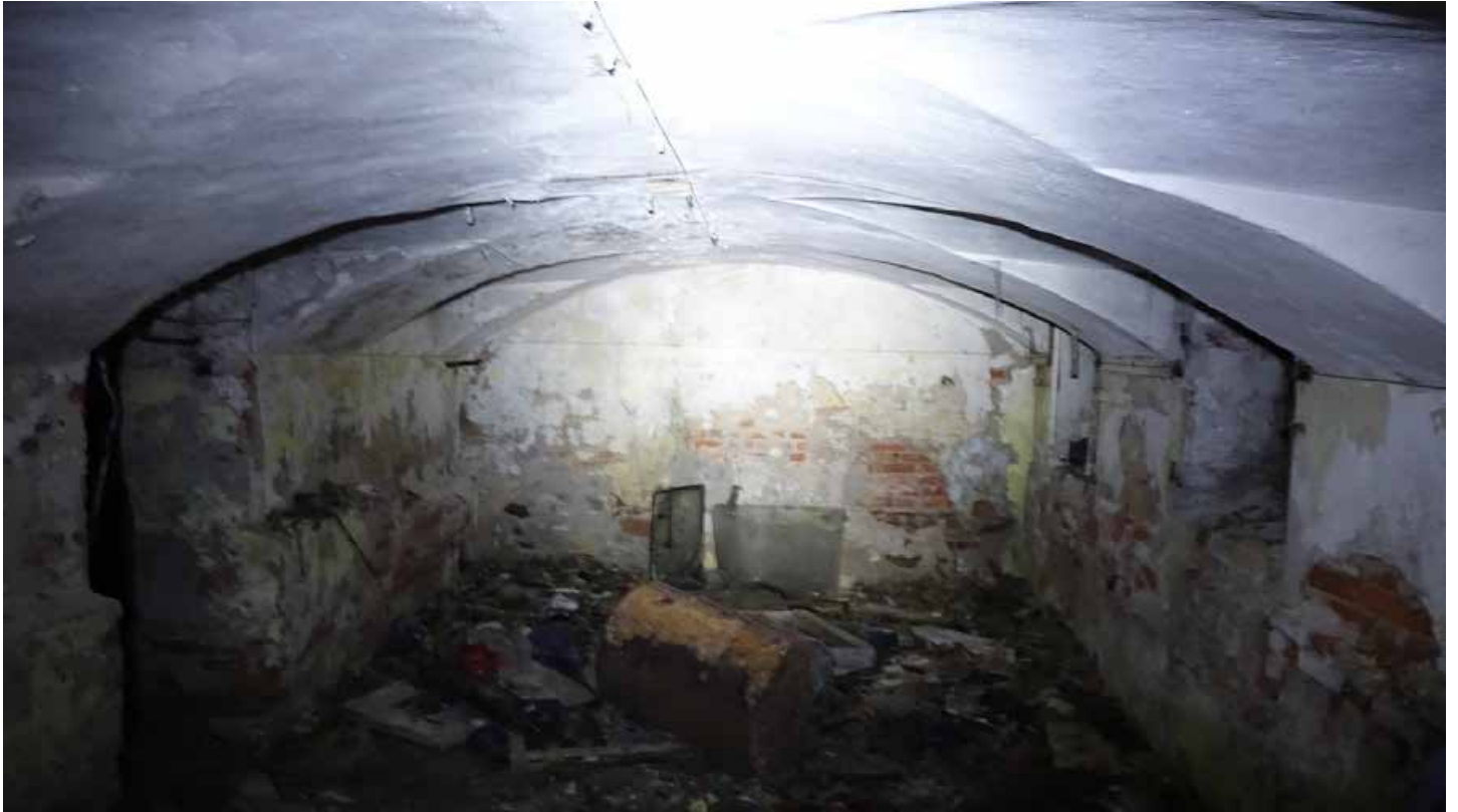
Фото 27. Помещение 146. Коробовый свод с распалубками. Цокольный этаж. Дата фотофиксации: 01.03.24
