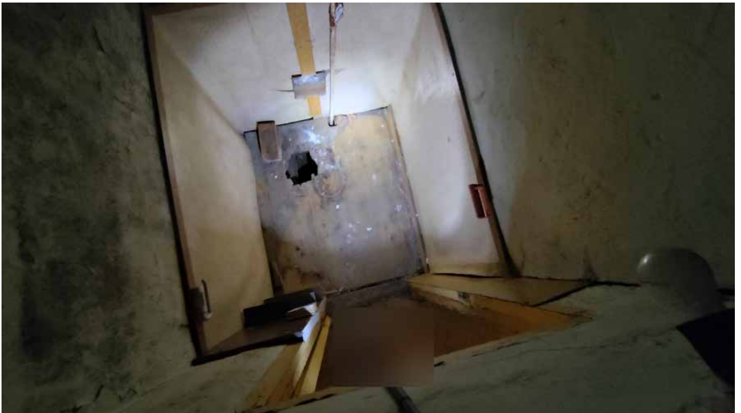
Фото 233. Помещение 134. Общий вид. Третий этаж. Дата фотофиксации: 01.03.24
