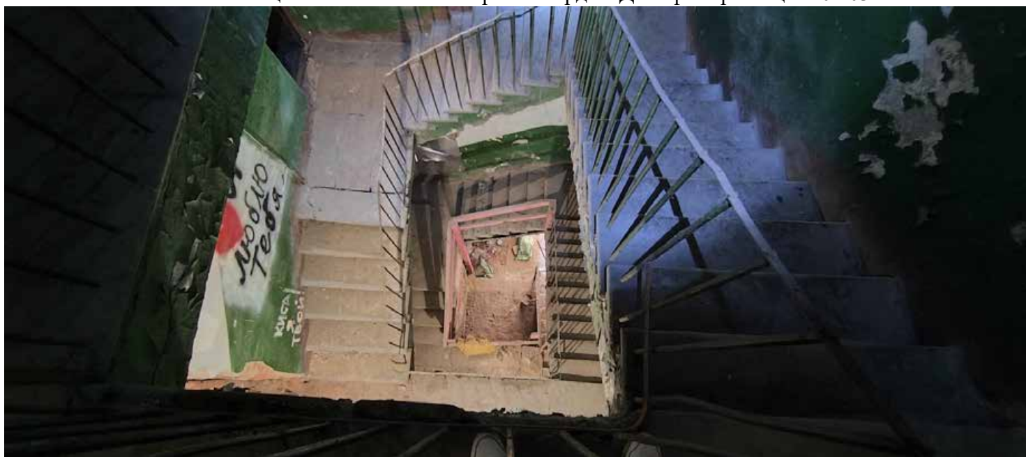
Фото 12. Лестница Л4. Общий вид сверху вниз с уровня 3-го этажа. Дата фотофиксации: 01.03.24
