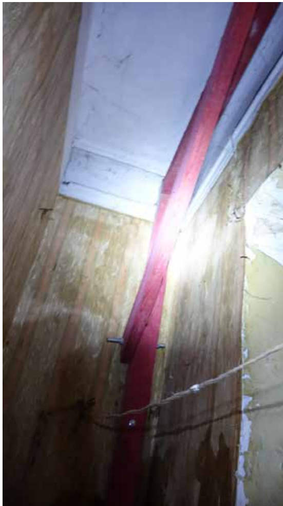
Фото 102. Помещение 5. Падуга и профилированный карниз советского времени. Первый этаж. Дата фотофиксации: 01.03.24
