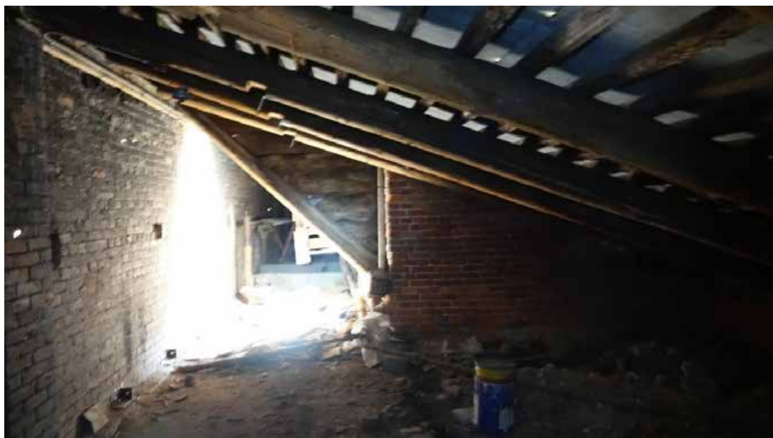
Фото 244. Мансарда. Вид со стороны входа лестницы Л2. Дата фотофиксации: 01.03.24
