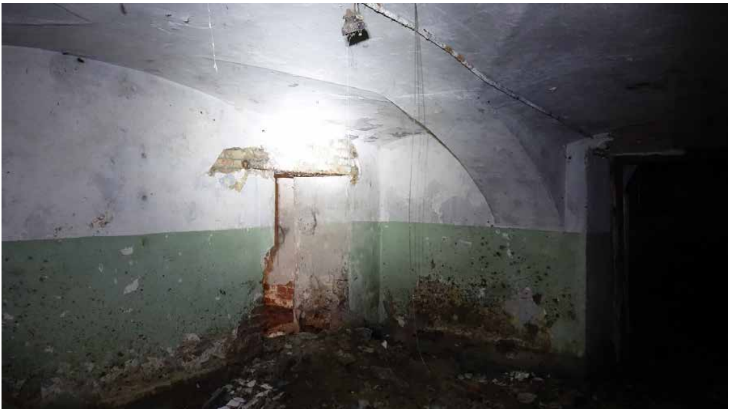
Фото 56. Помещение 2. Стены, фрагмент свода. Цокольный этаж. Дата фотофиксации: 01.03.24
