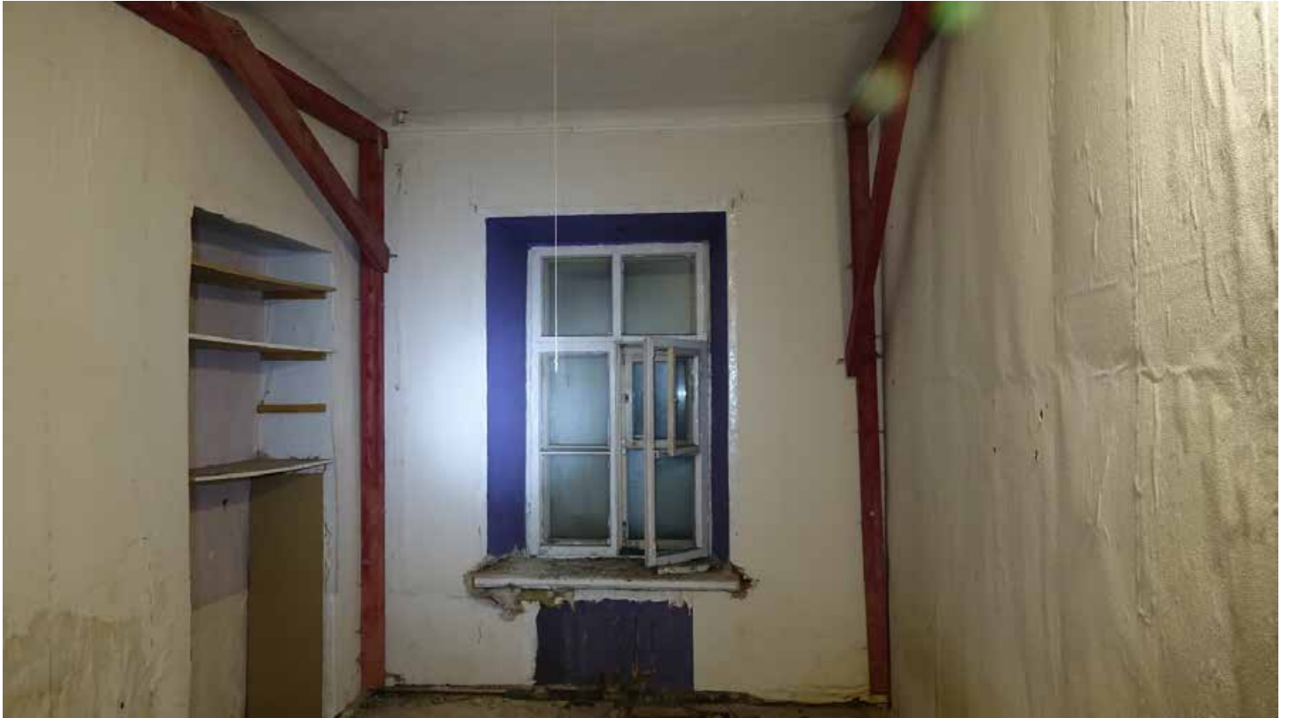
Фото 92. Помещение 12. Общий вид. Первый этаж. Дата фотофиксации: 01.03.24
