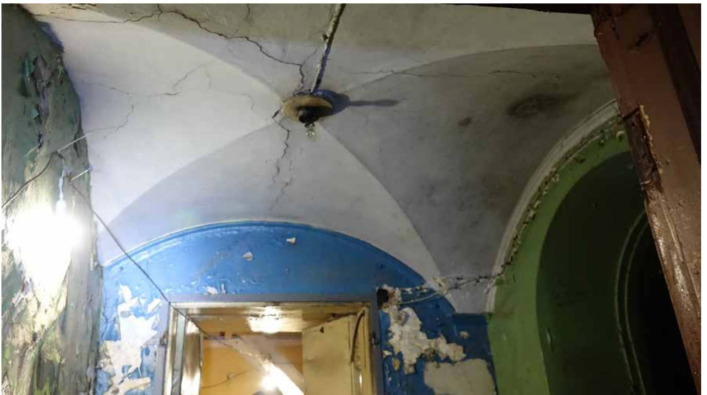
Фото 103. Помещение 2. Крестовый свод. Первый этаж. Дата фотофиксации: 01.03.24
