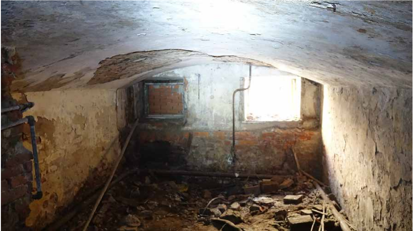
Фото 21. Помещение 158. Цилиндрический свод. Вид на оконные проемы цокольного этажа. Цокольный этаж. Дата фотофиксации: 01.03.24
