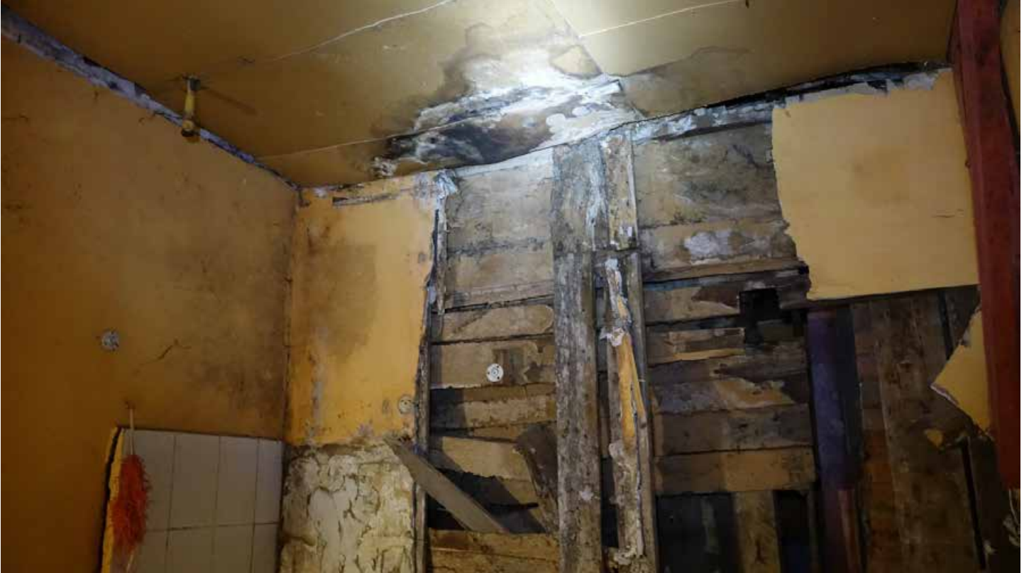
Фото 124. Помещение 44. Общий вид. Первый этаж. Дата фотофиксации: 01.03.24
