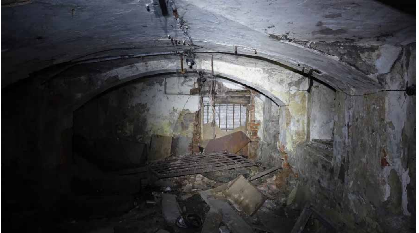
Фото 33. Помещения 148-149. Коробовый свод с распалубками и подпружной аркой. Цокольный этаж. Дата фотофиксации: 01.03.24
