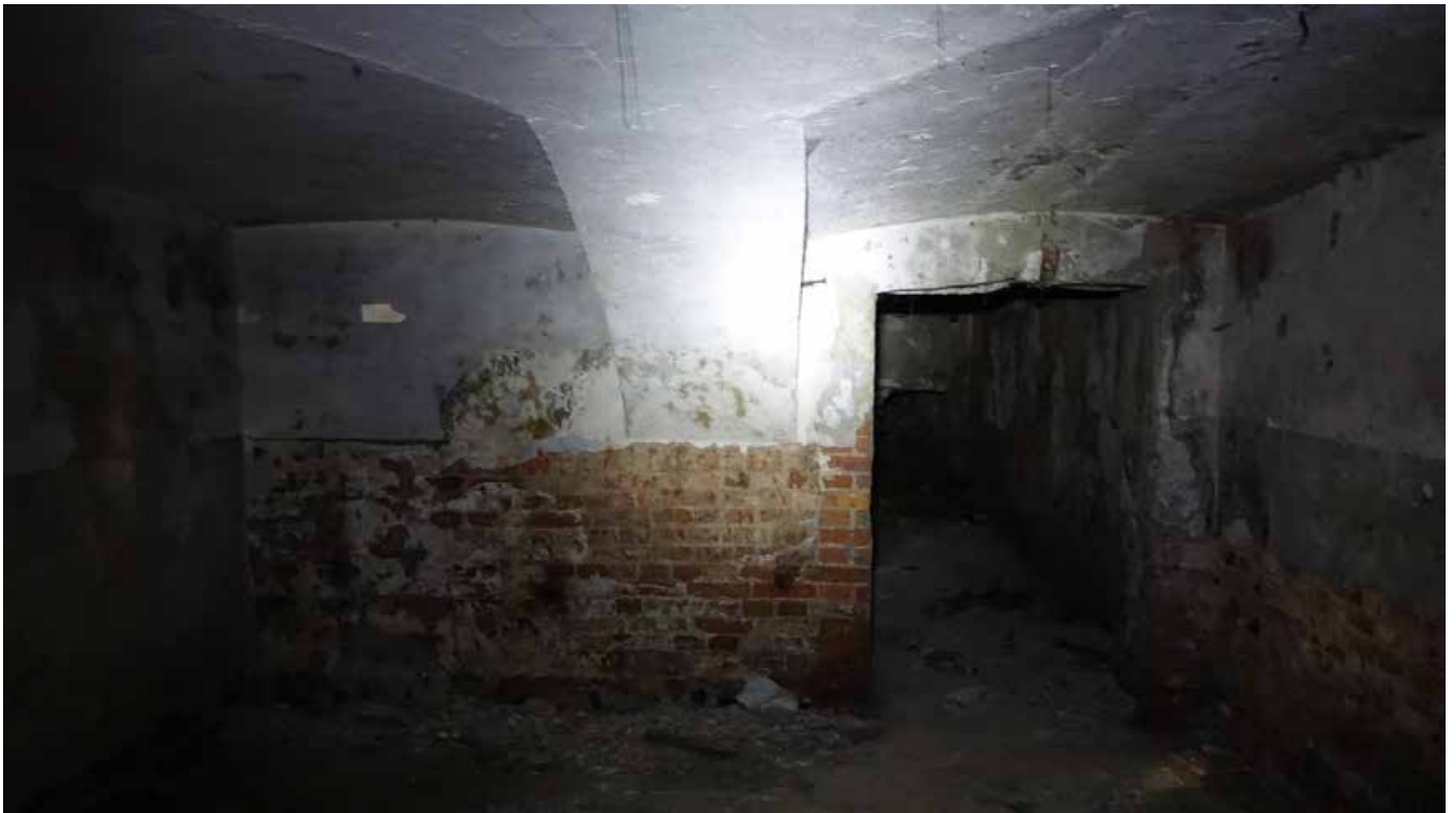
Фото 47. Помещение 5. Коробовый свод с распалубками. Фрагмент. Цокольный этаж. Дата фотофиксации: 01.03.24
