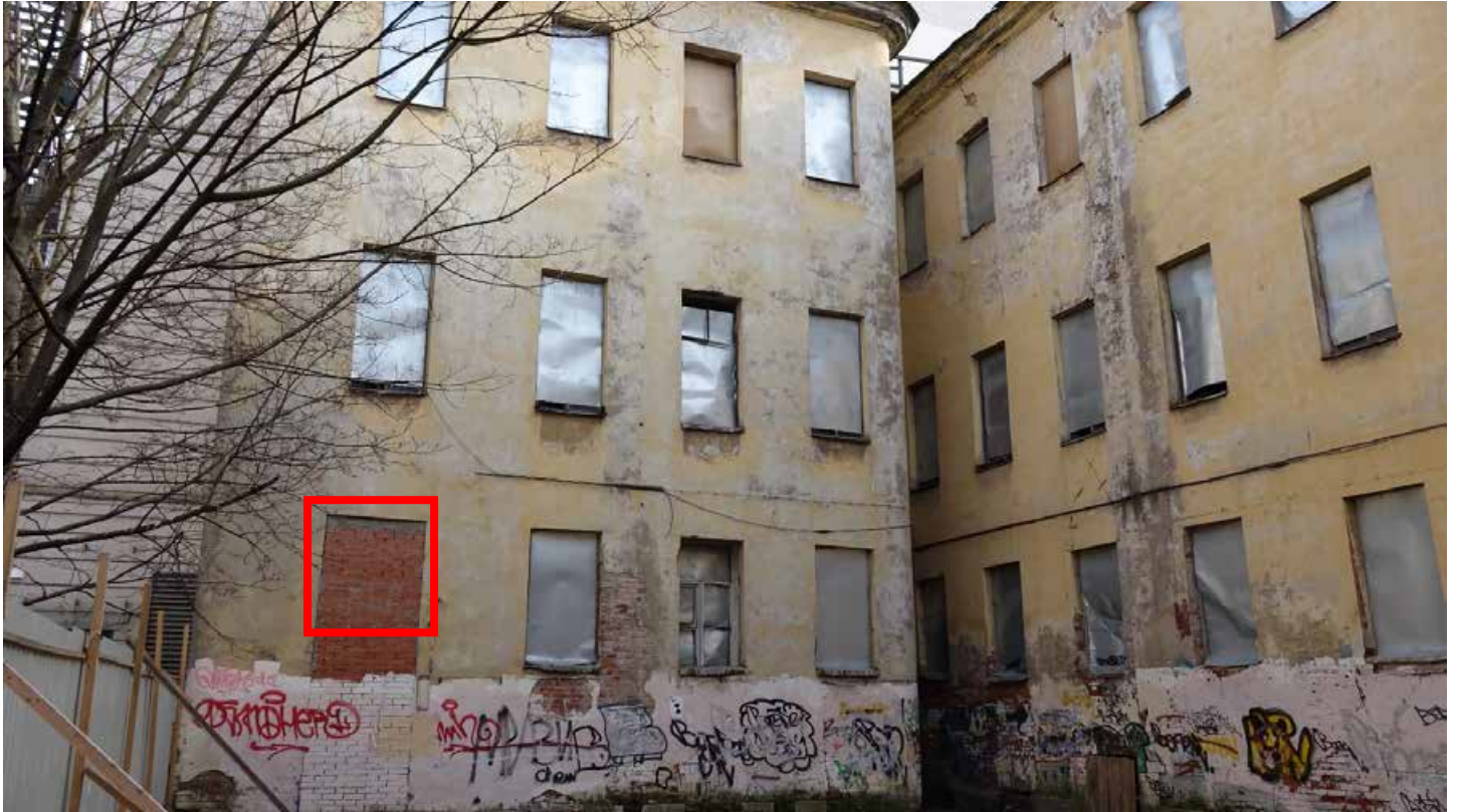
Фото 25. Оконные заполнения восточного фасада с защитными конструкциями. Дата фотофиксации: 01.03.24
