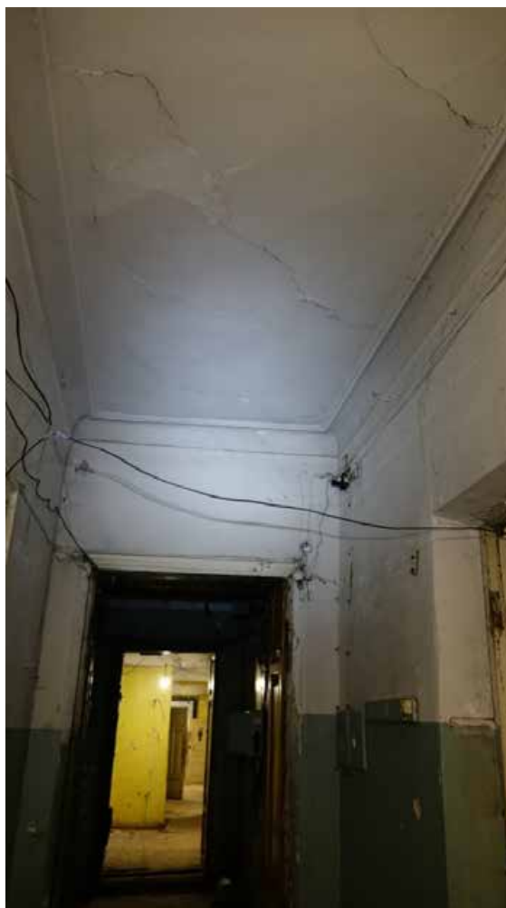
Фото 207. Помещение 113. Коридор. Третий этаж. Дата фотофиксации: 01.03.24
