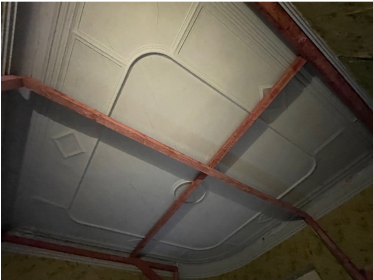
Фото 166. Помещение 76. Комплексная отделка потолка тянутым профилированным декором с падугой. Второй этаж. Дата фотофиксации: 01.03.24
