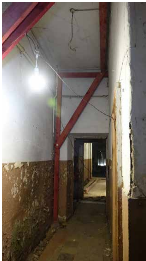
Фото 134. Помещение 47. Коридор второго этажа. Общий вид. Дата фотофиксации: 01.03.24
