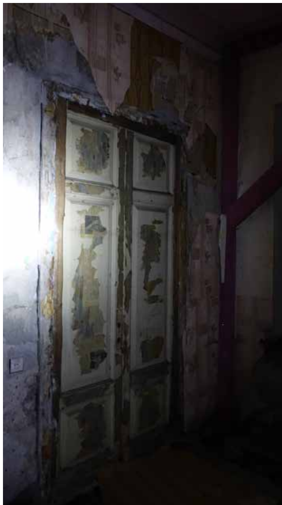
Фото 85. Помещение 20. Двустворчатые филенчатые двери. Дата фотофиксации: 01.03.24
