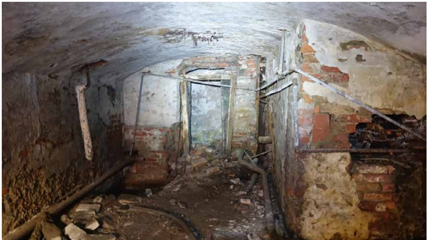
Фото 20. Помещение 158. Цилиндрический свод. Цокольный этаж. Дата фотофиксации: 01.03.24
