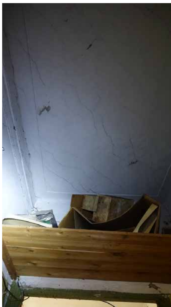
Фото 231. Коридор между помещениями 118 и 128. Фрагмент карниза. Третий этаж. Дата фотофиксации: 01.03.24
