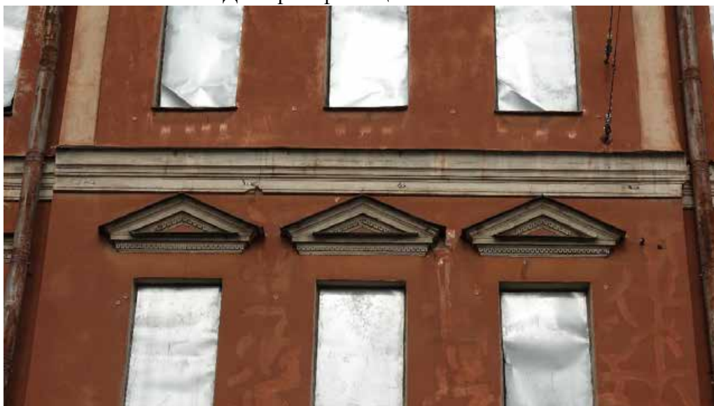
Фото 8. Треугольные профилированные сандрики южного фасада. Дата фотофиксации: 01.03.24
