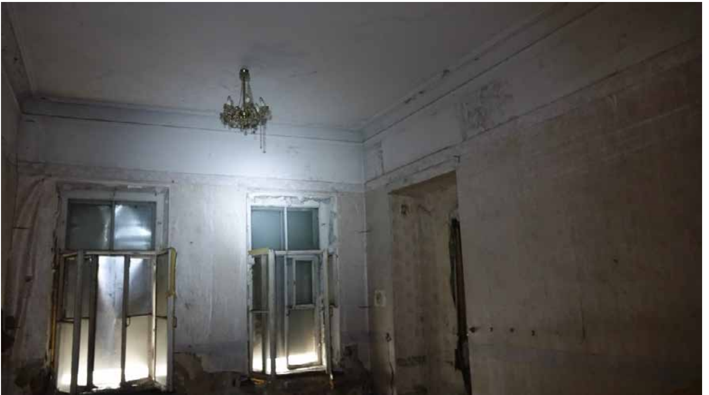
Фото 143. Помещение 57. Общий вид. Второй этаж. Дата фотофиксации: 01.03.24
