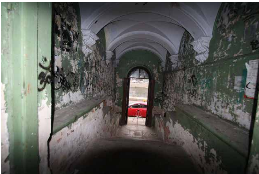
Фото 105. Помещение 1, парадный вестибюль. Общий вид. Дата фотофиксации: 01.03.24
