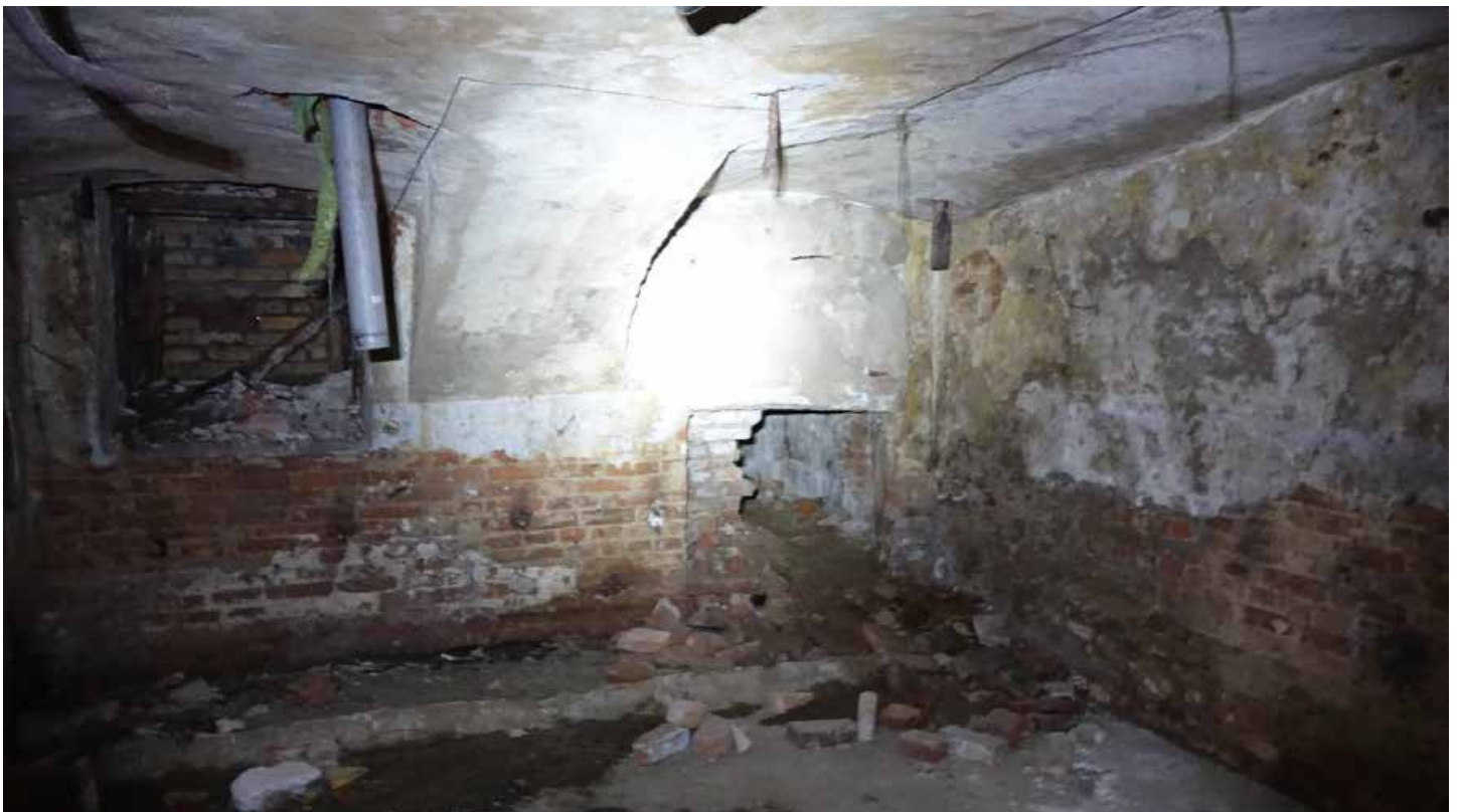
Фото 40. Помещение 6. Фрагмент стены, свода, заложный оконный проем. Цокольный этаж. Дата фотофиксации: 01.03.24
