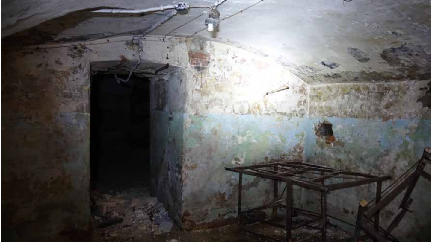
Фото 13. Помещение 154. Цилиндрический свод. Цокольный этаж. Дата фотофиксации: 01.03.24
