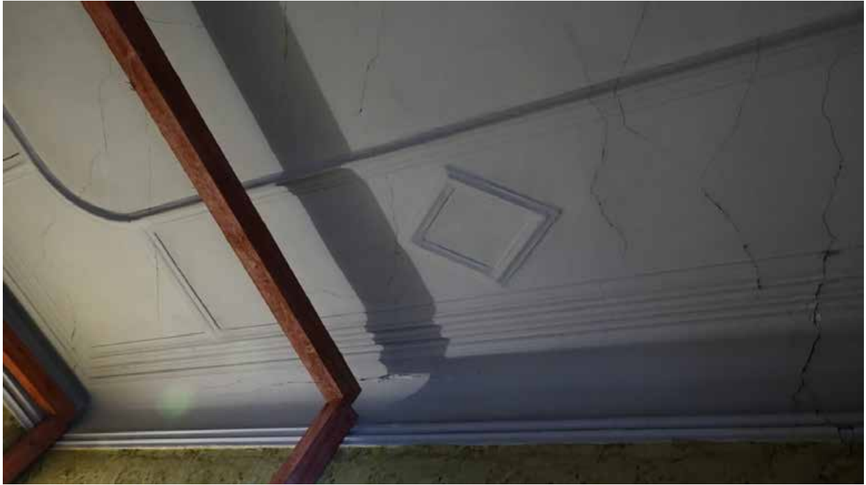
Фото 167. Помещение 76. Потолочная геометрическая композиция. Фрагмент. Второй этаж. Дата фотофиксации: 01.03.24
