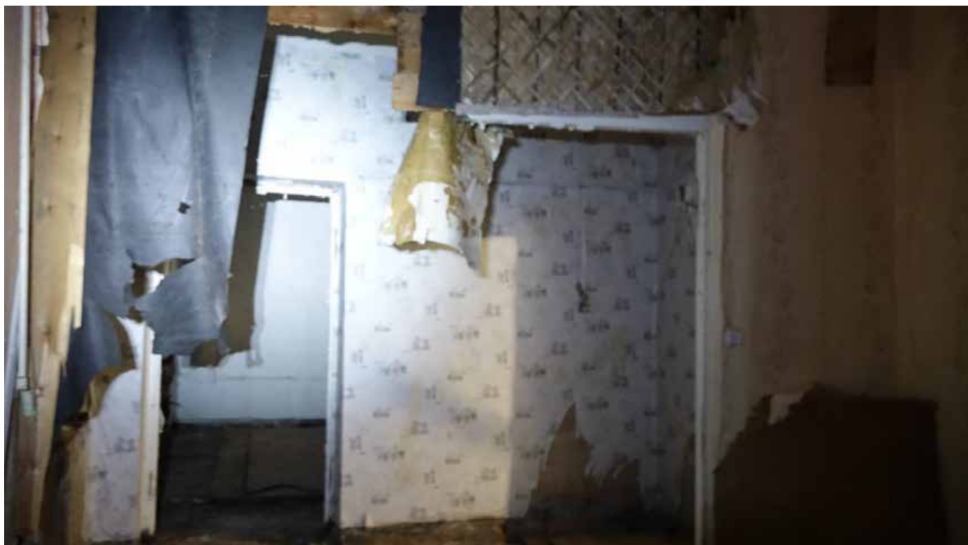
Фото 201. Вид из помещения 107 на помещение 108. Третий этаж. Дата фотофиксации: 01.03.24
