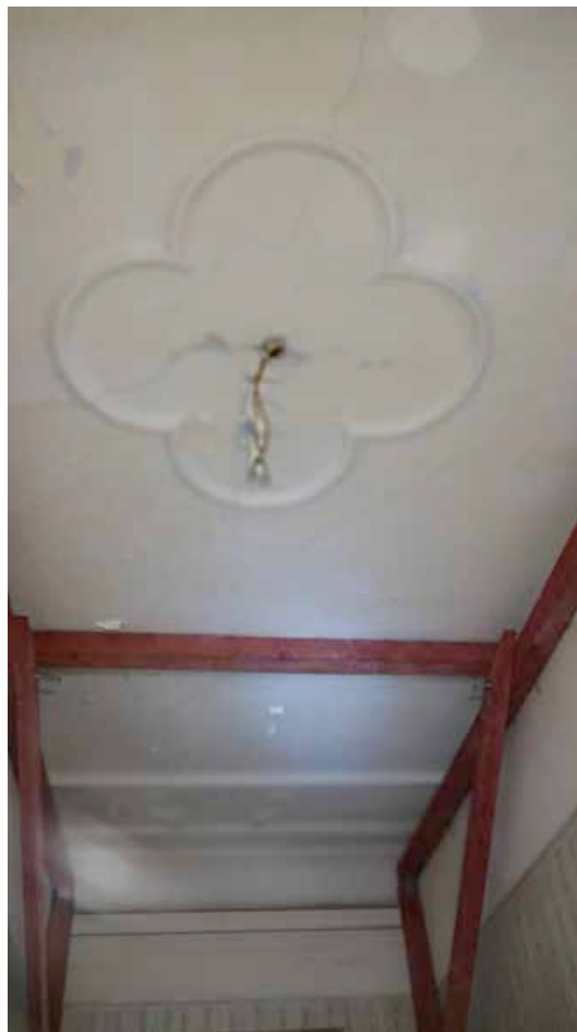
Фото 162. Помещение 73. Вид на потолок. Второй этаж. Дата фотофиксации: 01.03.24
