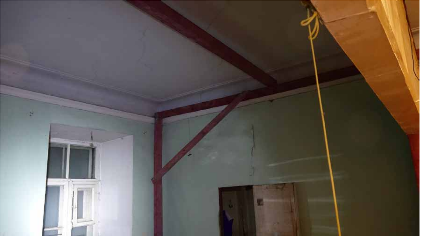
Фото 94. Помещение 14. Падуга и профилированный карниз советского времени. Первый этаж. Дата фотофиксации: 01.03.24
