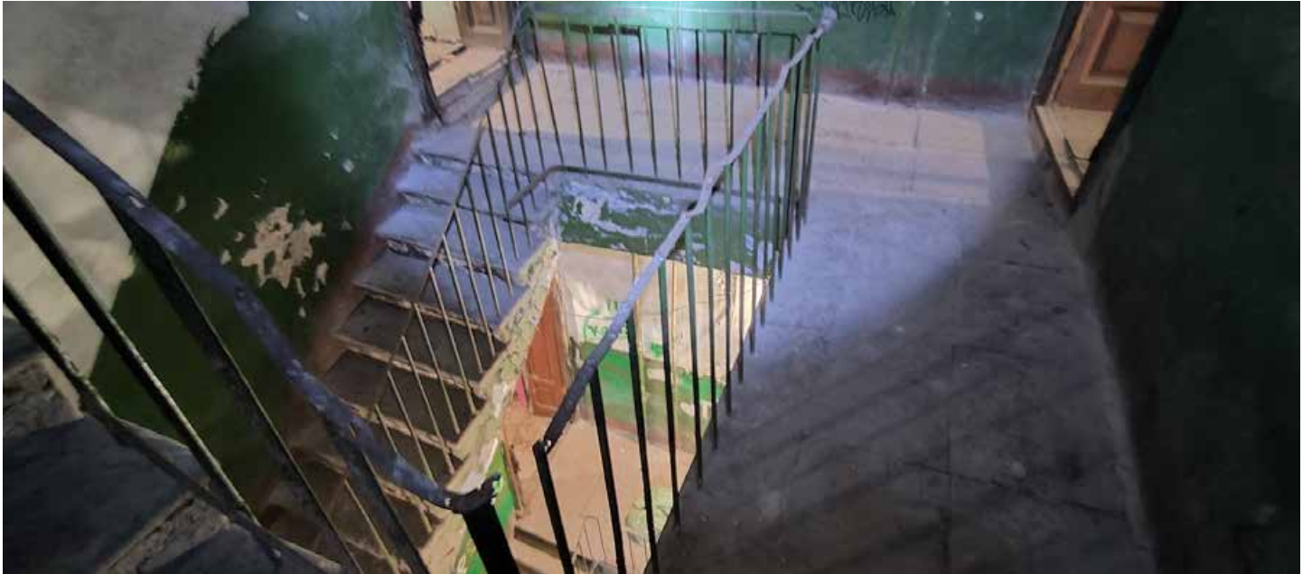
Фото 13. Лестница Л4. Площадка 3-го этажа. Дата фотофиксации: 01.03.24
