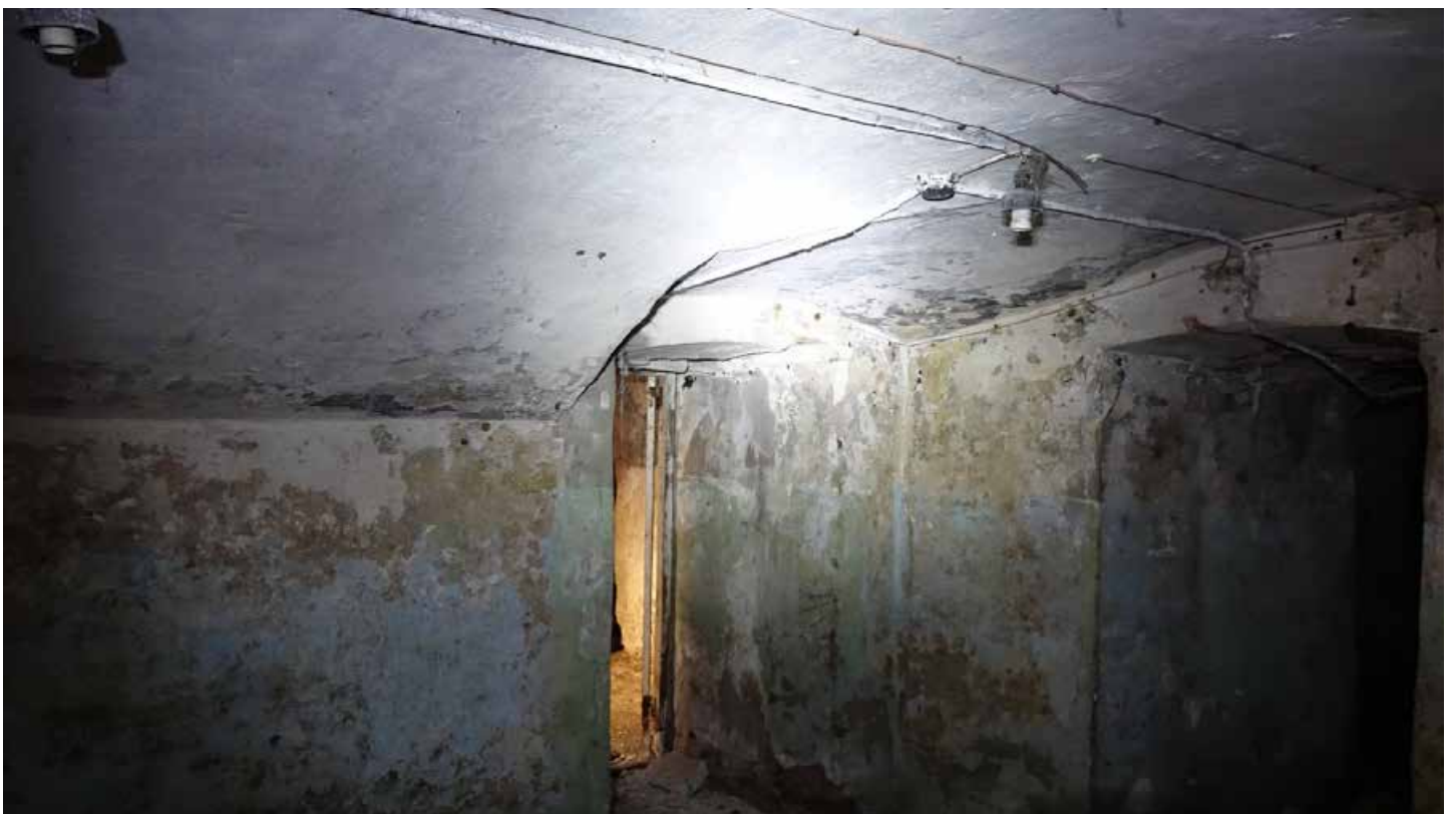
Фото 14. Помещение 154. Фрагмент коробового свода с распалубками. Цокольный этаж. Дата фотофиксации: 01.03.24
