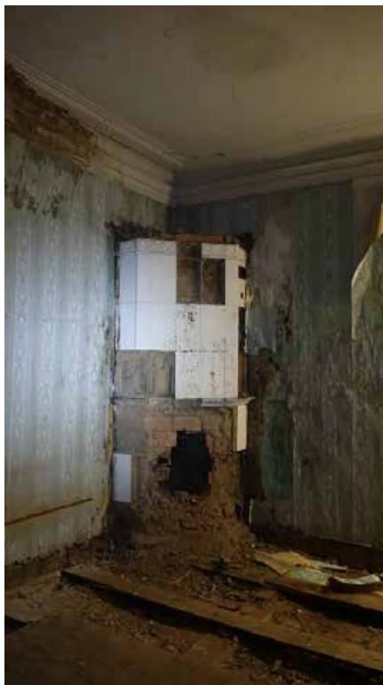
Фото 224. Помещение 131. Вид на угловую печь. Третий этаж. Дата фотофиксации: 01.03.24
