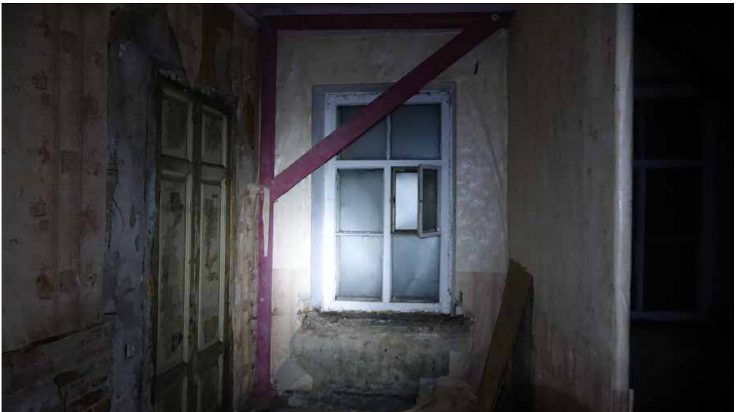
Фото 83. Помещение 20. Общий вид. Первый этаж. Дата фотофиксации: 01.03.24
