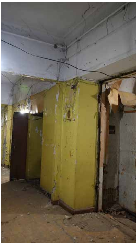
Фото 211. Помещение 118. Третий этаж. Дата фотофиксации: 01.03.24
