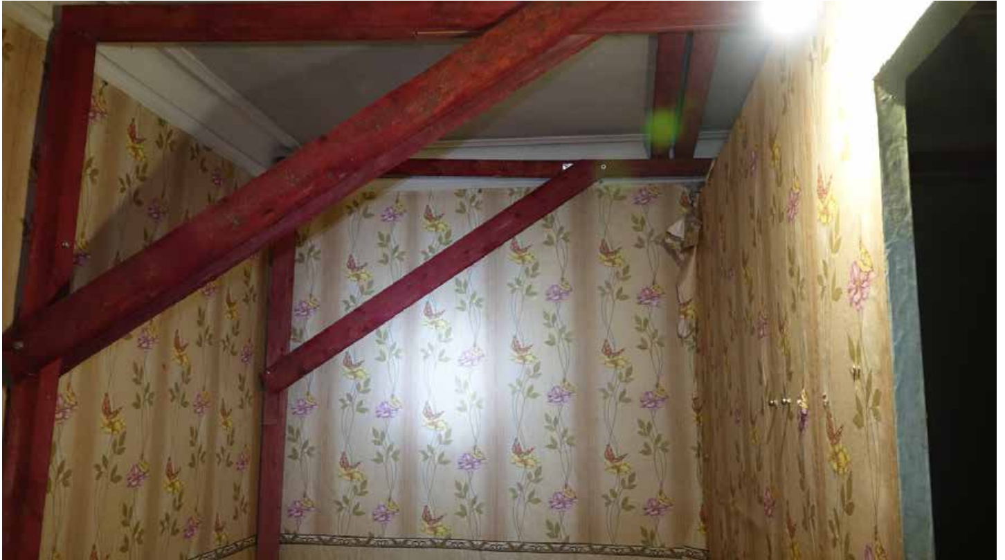
Фото 96. Помещение 10. Падуга и профилированный карниз советского времени. Первый этаж. Дата фотофиксации: 01.03.24
