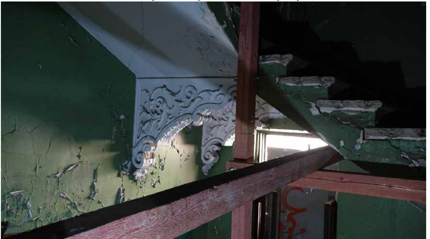
Фото 6. Лестница Л1. Фрагмент с кронштейнами. Дата фотофиксации: 01.03.24
