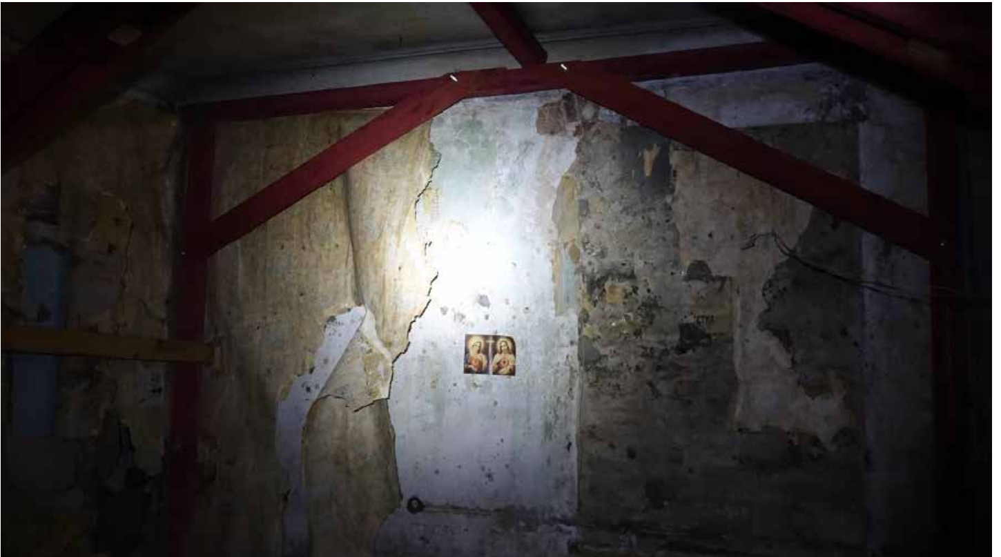
Фото 65. Помещение 33. Общий вид. Первый этаж. Дата фотофиксации: 01.03.24
