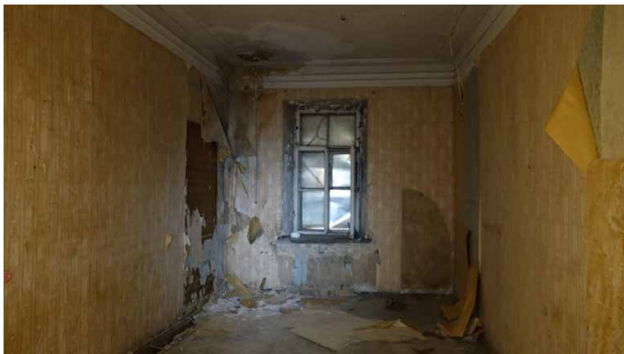
Фото 209. Помещение 115. Общий вид. Третий этаж. Дата фотофиксации: 01.03.24
