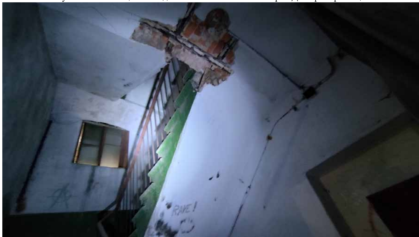
Фото 20. Службная лестница Л2. Лестничные марши. Дата фотофиксации: 01.03.24
