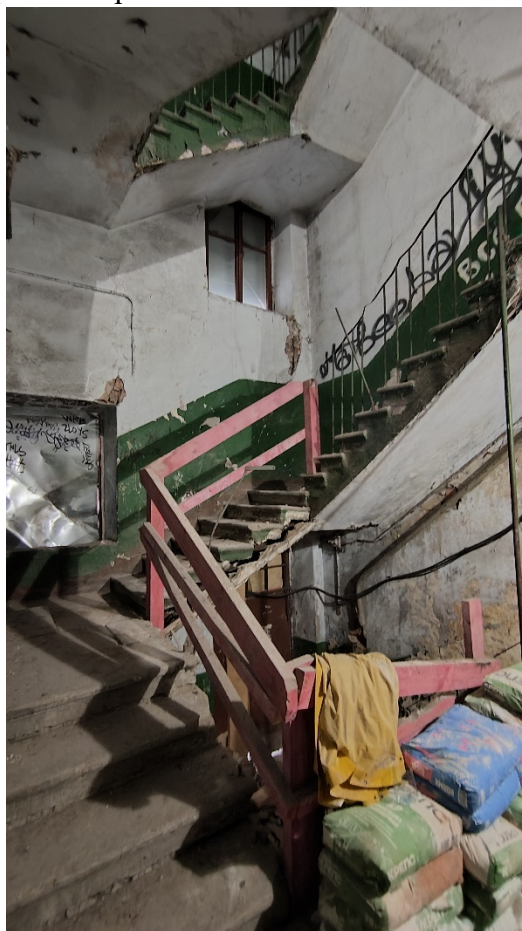
Фото 10. Лестница Л4. Общий вид. Дата фотофиксации: 01.03.24
