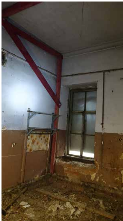
Фото 135. Помещение 49. Карнизы советского периода и оконные заполнения. Второй этаж. Дата фотофиксации: 01.03.24
