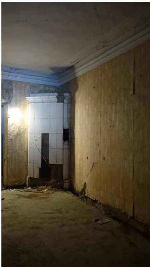
Фото 210. Помещение 115. Вид на угловую печь. Третий этаж. Дата фотофиксации: 01.03.24
