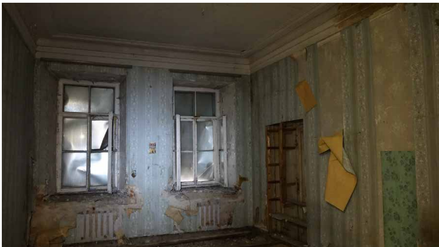
Фото 223. Помещение 131. Третий этаж. Дата фотофиксации: 01.03.24
