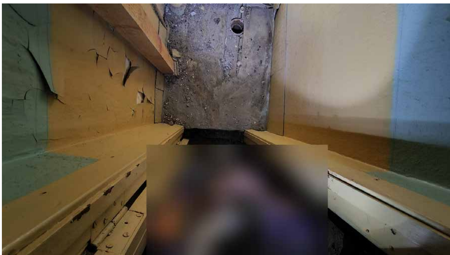
Фото 184. Помещение 93. Общий вид. Второй этаж. Дата фотофиксации: 01.03.24
