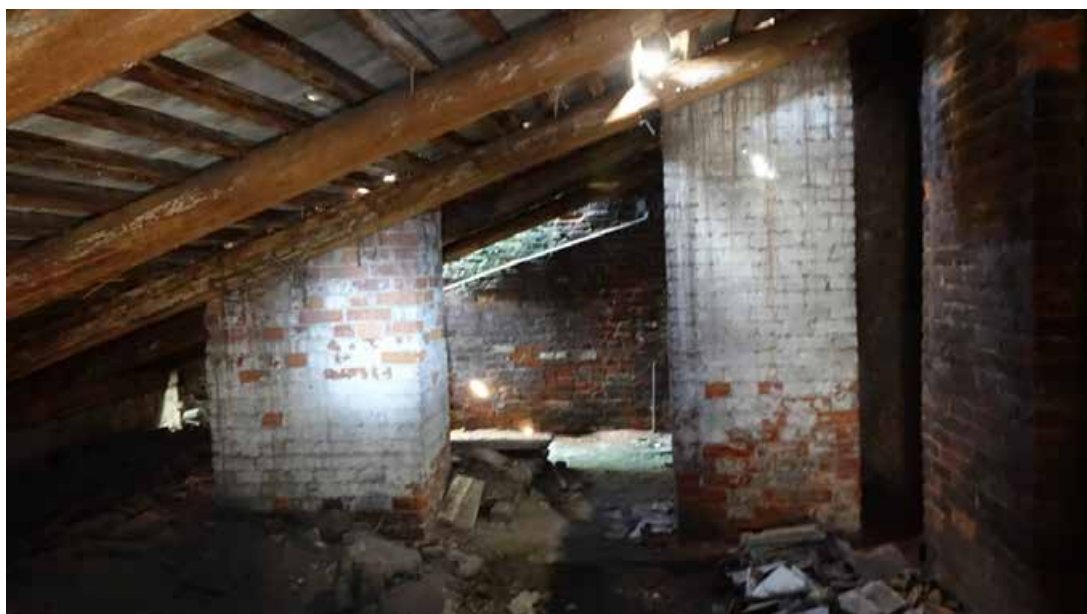
Фото 245. Мансарда. Вид на вход со стороны лестницы Л2. Дата фотофиксации: 01.03.24
