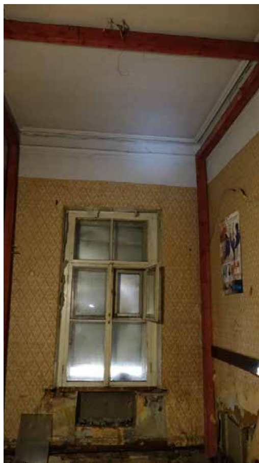
Фото 170. Помещение 77. Общий вид. Второй этаж. Дата фотофиксации: 01.03.24
