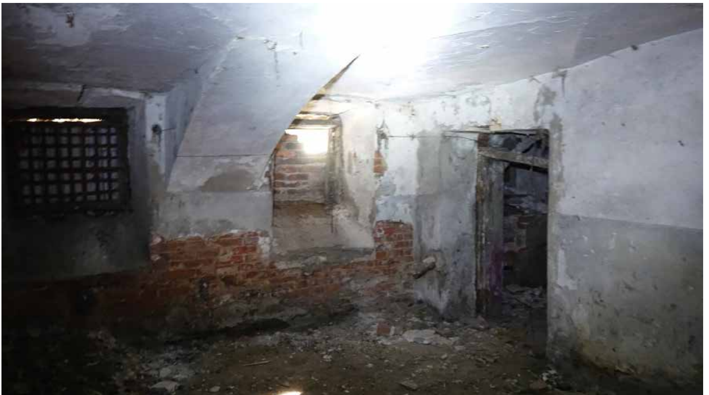
Фото 46. Помещение 5. Вид на заложённые оконные проёмы цокольного этажа. Фрагмент свода. Дата фотофиксации: 01.03.24
