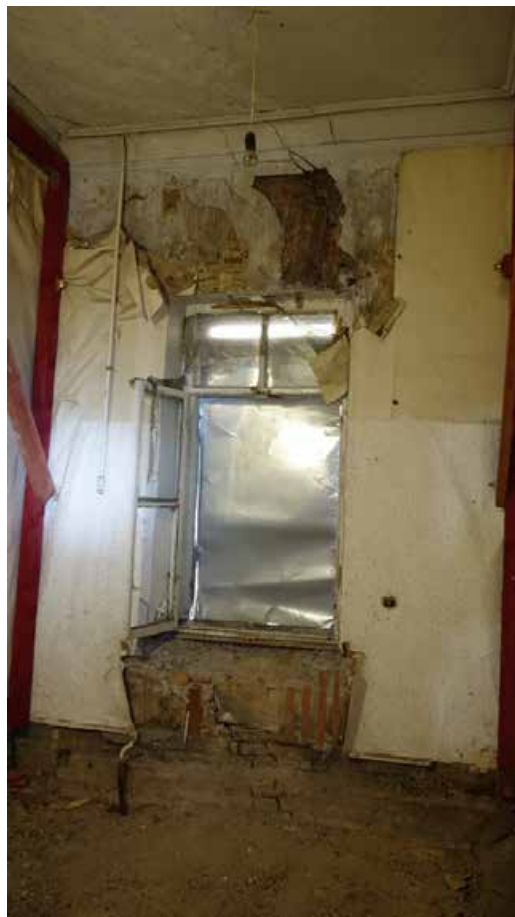
Фото 155. Помещение 64. Оконные заполнения. Второй этаж. Дата фотофиксации: 01.03.24
