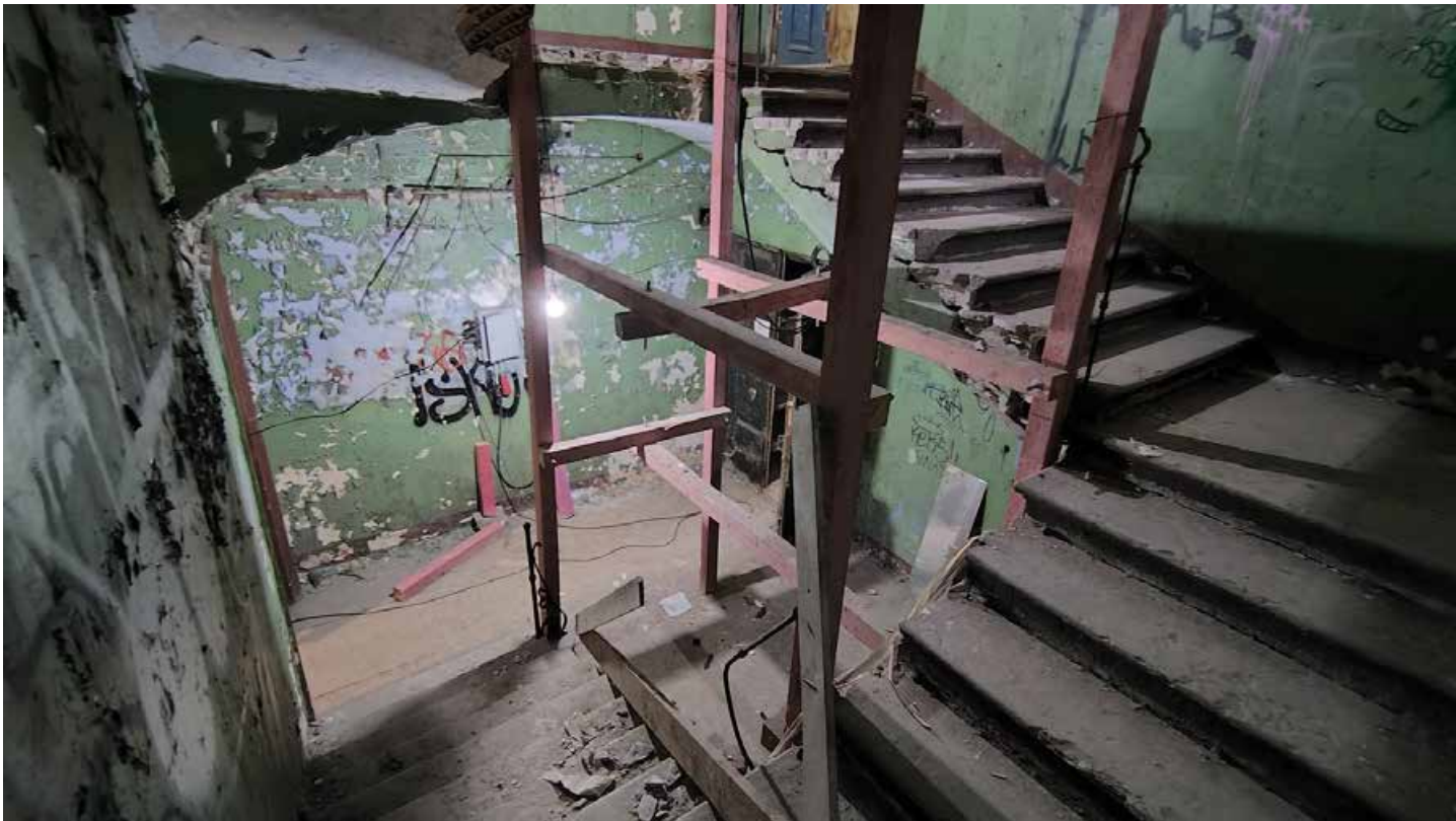
Фото 3. Лестница Л1. Межэтажная площадка. Дата фотофиксации: 01.03.24
