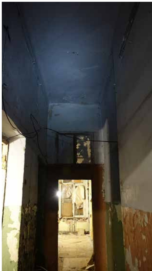
Фото 180. Помещение 89. Коридор. Второй этаж. Дата фотофиксации: 01.03.24
