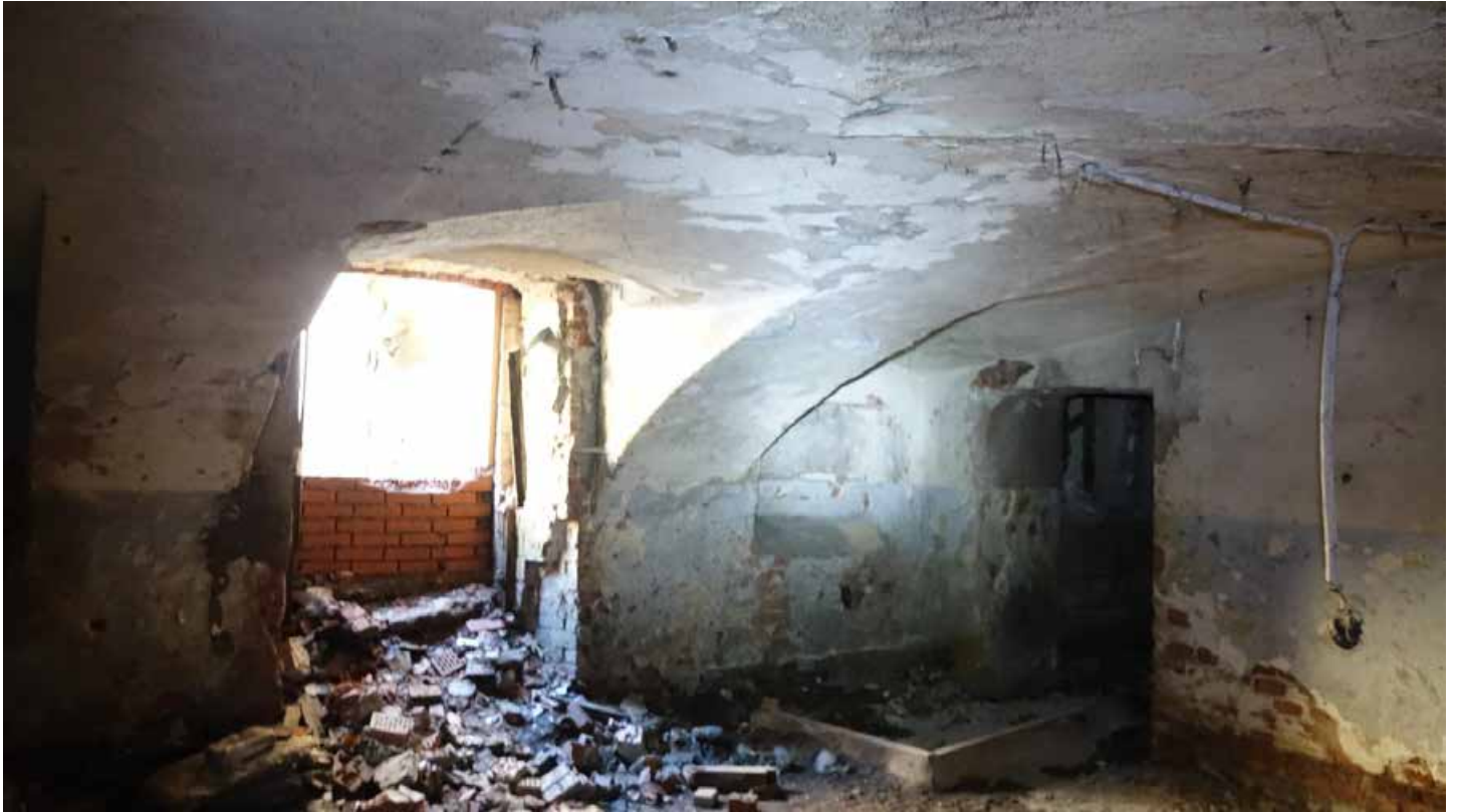
Фото 39. Помещение 1. Вид на частично заложный дверной проем приямка. Цокольный этаж. Дата фотофиксации: 01.03.24
