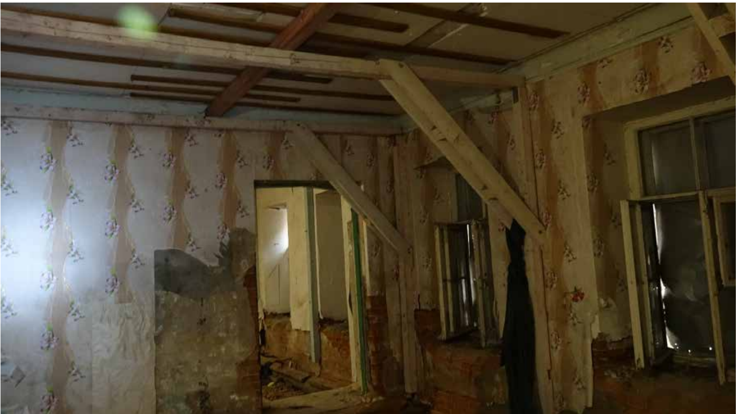
Фото 119. Помещение 38. Общий вид. Первый этаж. Дата фотофиксации: 01.03.24
