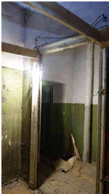
Фото 236. Помещение 136. Вид на дверной проем. Третий этаж. Дата фотофиксации: 01.03.24
