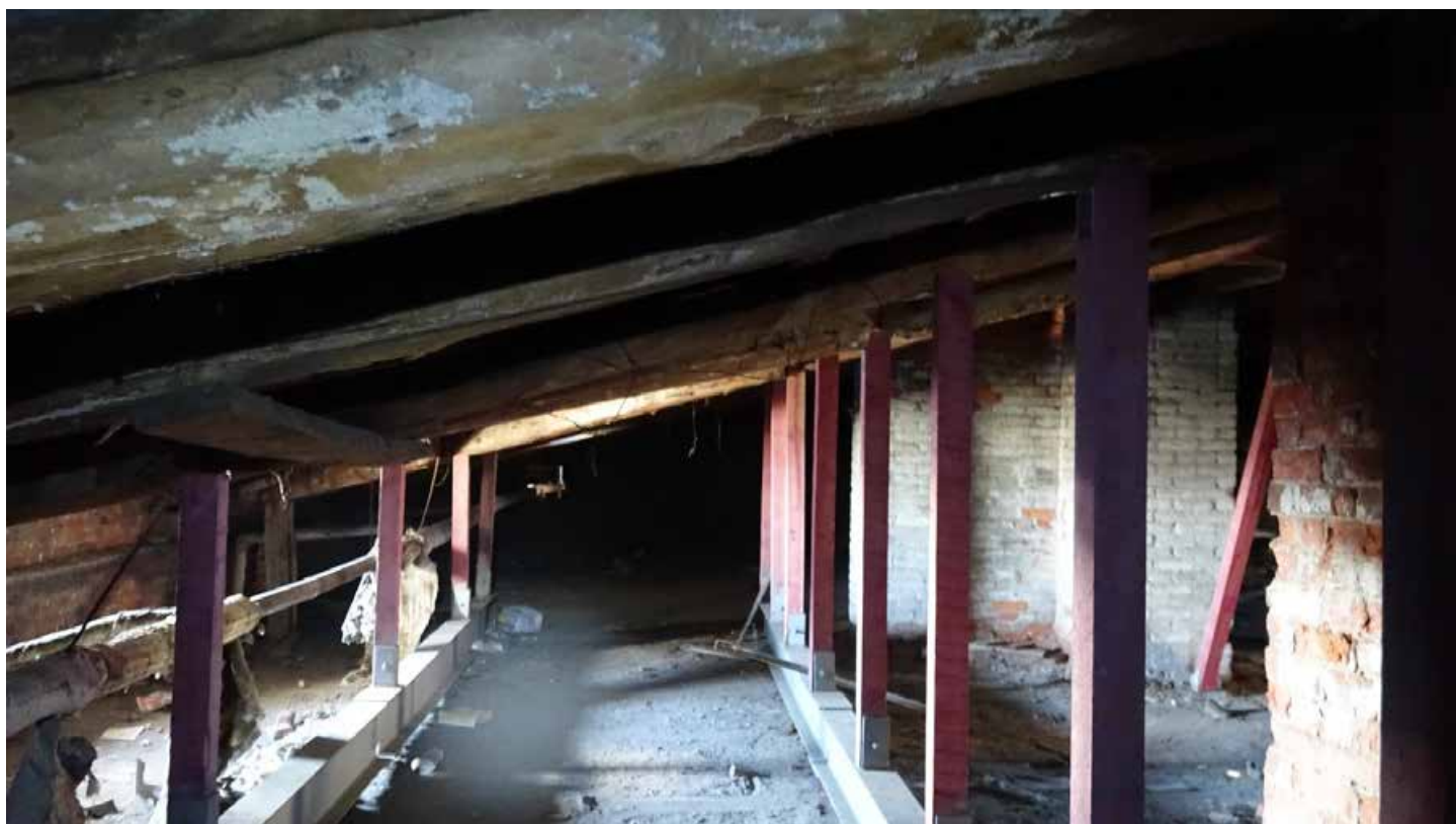
Фото 247. Мансарда. Основной объём. фрагмент. Дата фотофиксации: 01.03.24
