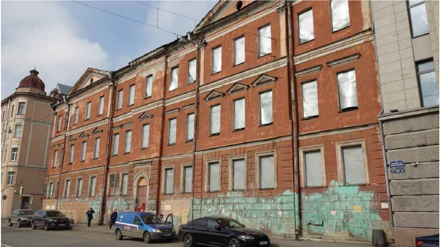
Фото 5. Южный фасад. Общий вид. Дата фотофиксации: 01.03.24
