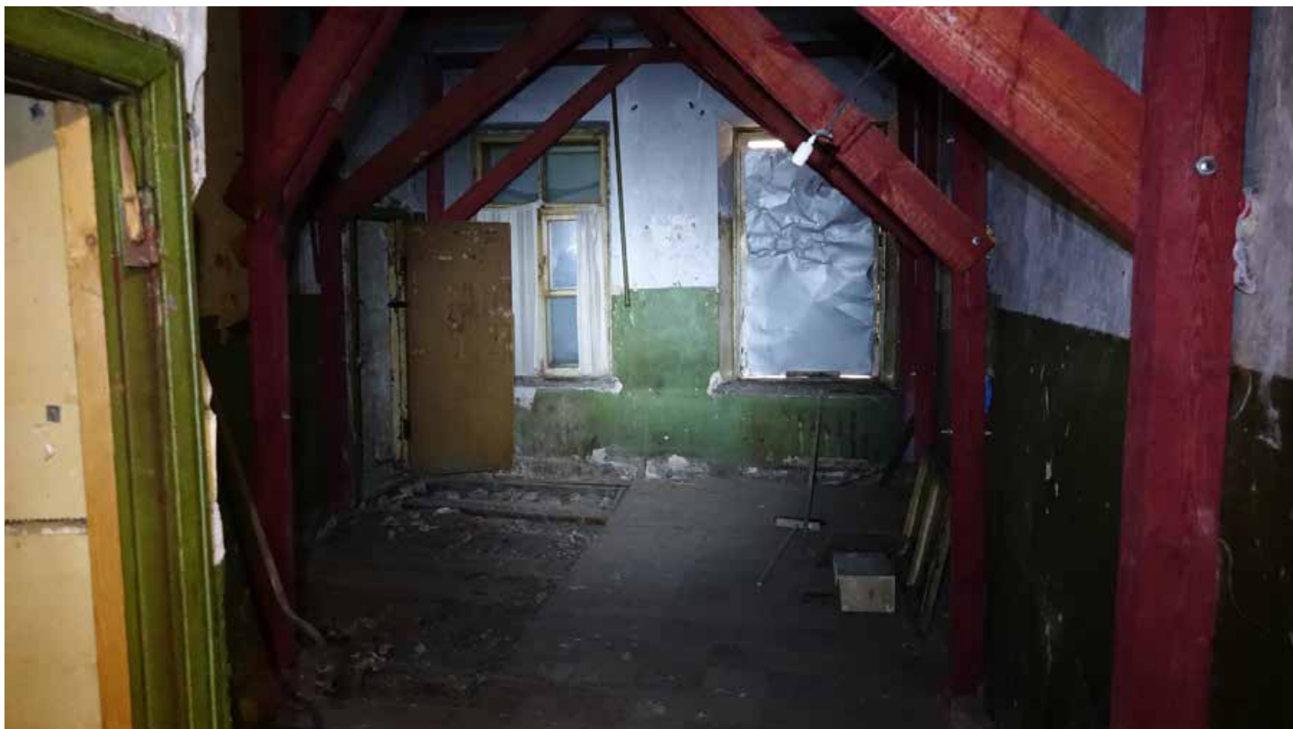
Фото 63. Помещение 31. Общий вид с конструкциями усиления. Первый этаж. Дата фотофиксации: 01.03.24
