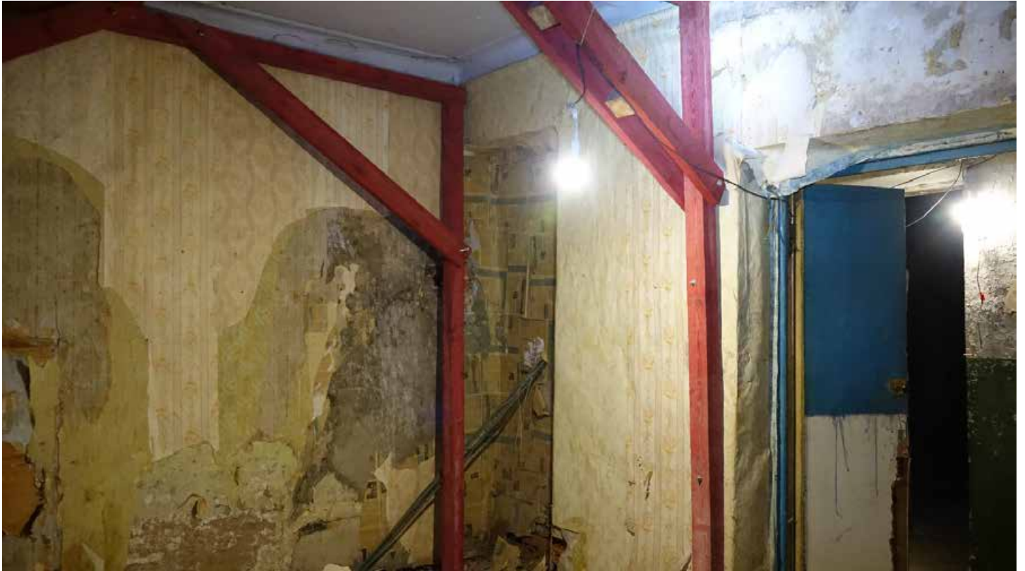
Фото 72. Проход между помещениями 29 и 27. Вид со стороны помещения 29. Первый этаж. Дата фотофиксации: 01.03.24
