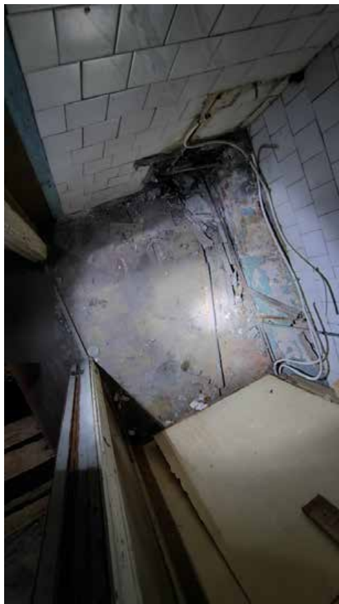
Фото 185. Помещение 94. Общий вид. Второй этаж. Дата фотофиксации: 01.03.24
