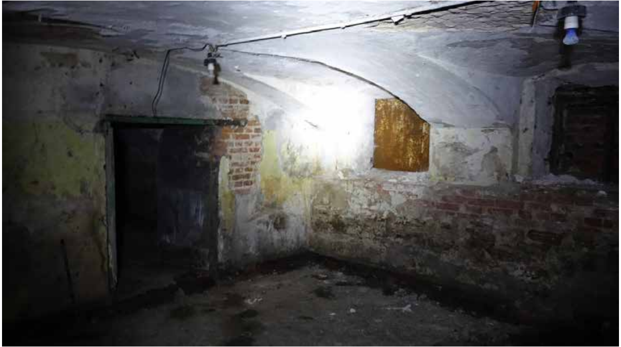
Фото 17. Помещение 150. Вид на заложённые оконные проёмы цокольного этажа. Цокольный этаж. Дата фотофиксации: 01.03.24
