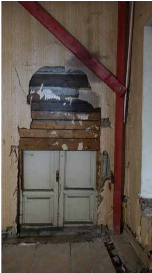
Фото 179. Помещение 84. Замурованное дверное заполнение. Второй этаж. Дата фотофиксации: 01.03.24
