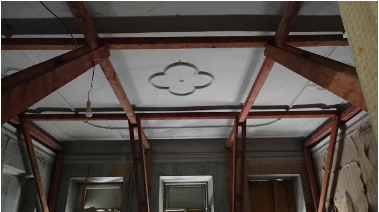
Фото 146. Помещение 58. Комплексная отделка потолка тянутым профилированным декором с падугой. Второй этаж. Дата фотофиксации: 01.03.24
