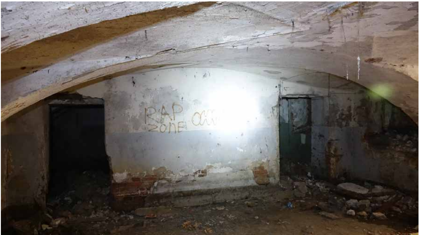
Фото 38. Помещение 1. Коробовый свод с распалубками. Цокольный этаж. Дата фотофиксации: 01.03.24
