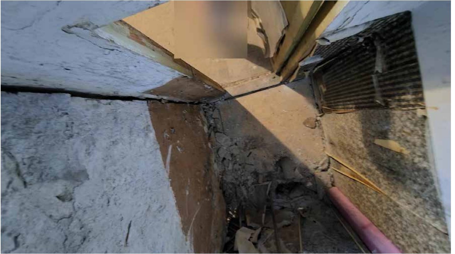
Фото 141. Помещение 54. Общий вид. Второй этаж. Дата фотофиксации: 01.03.24
