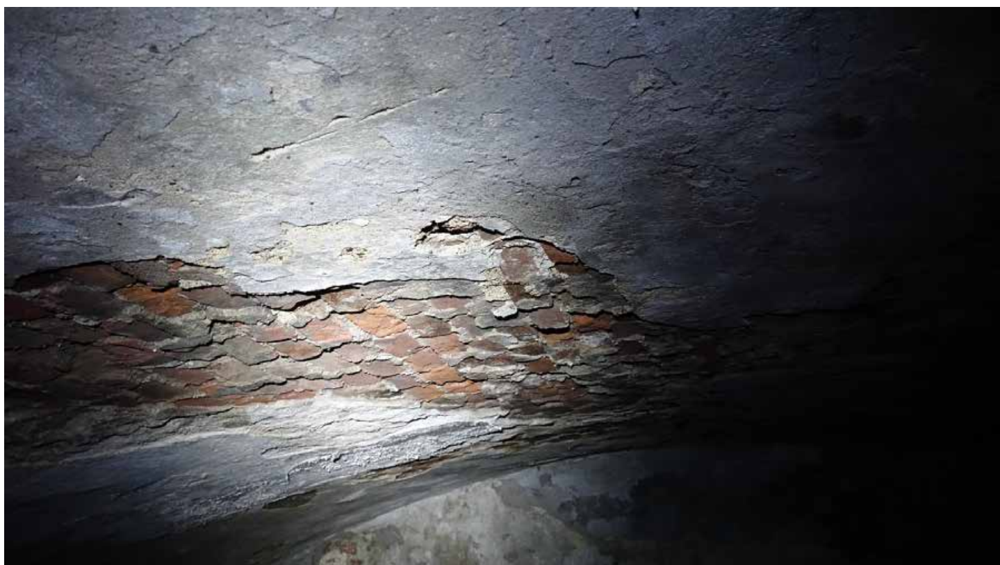
Фото 36. Помещения 148-149. Фрагмент коробового свода с распалубками. Цокольный этаж. Дата фотофиксации: 01.03.24
