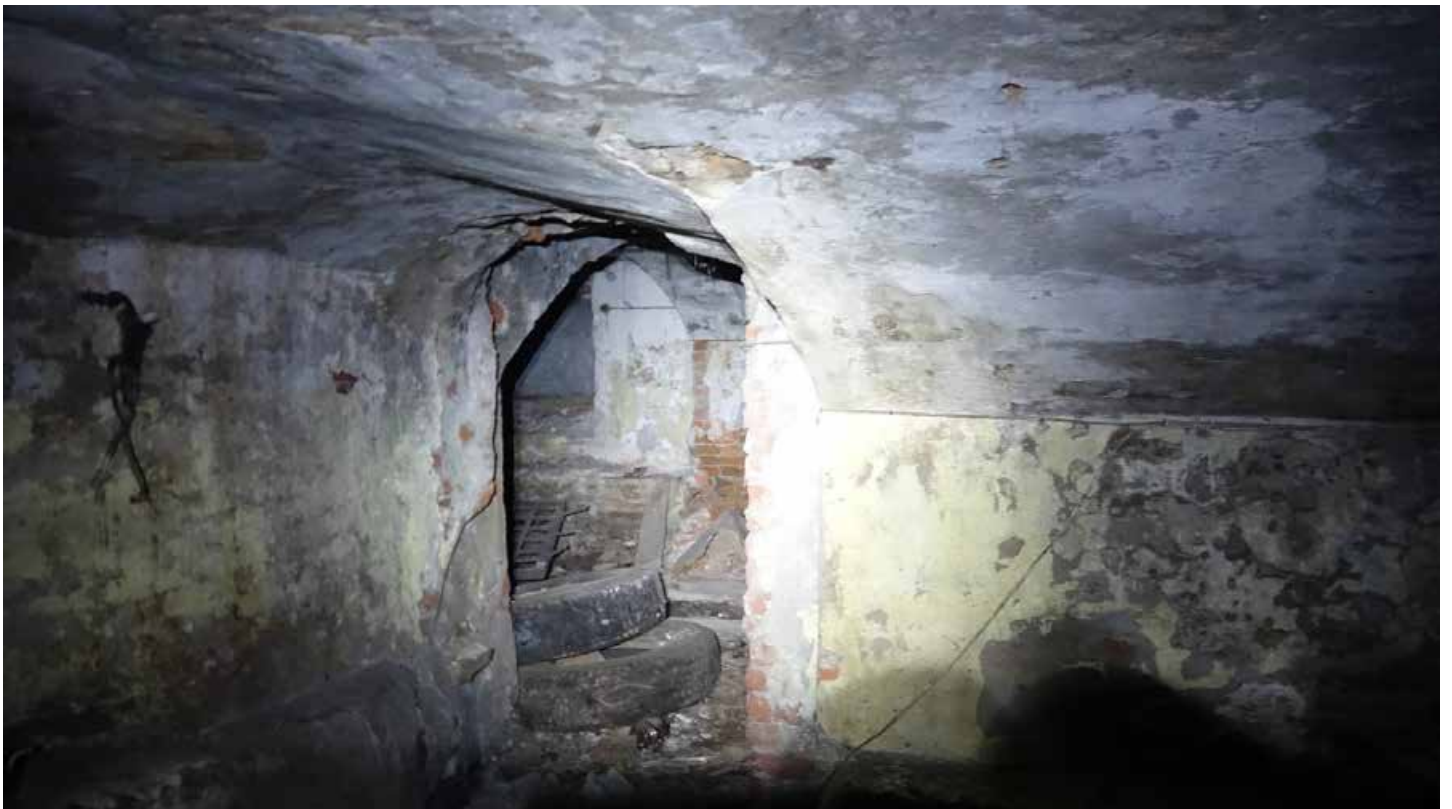
Фото 32. Помещение 147. Проход между помещениями 147 и 148. Цокольный этаж. Дата фотофиксации: 01.03.24
