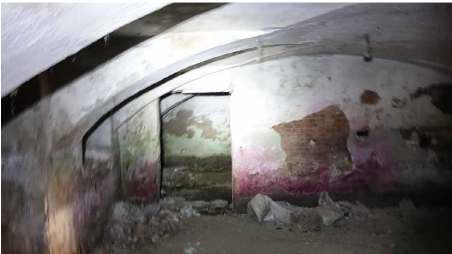
Фото 52. Помещение 4. Коробовый свод с распалубками. Цокольный этаж. Дата фотофиксации: 01.03.24
