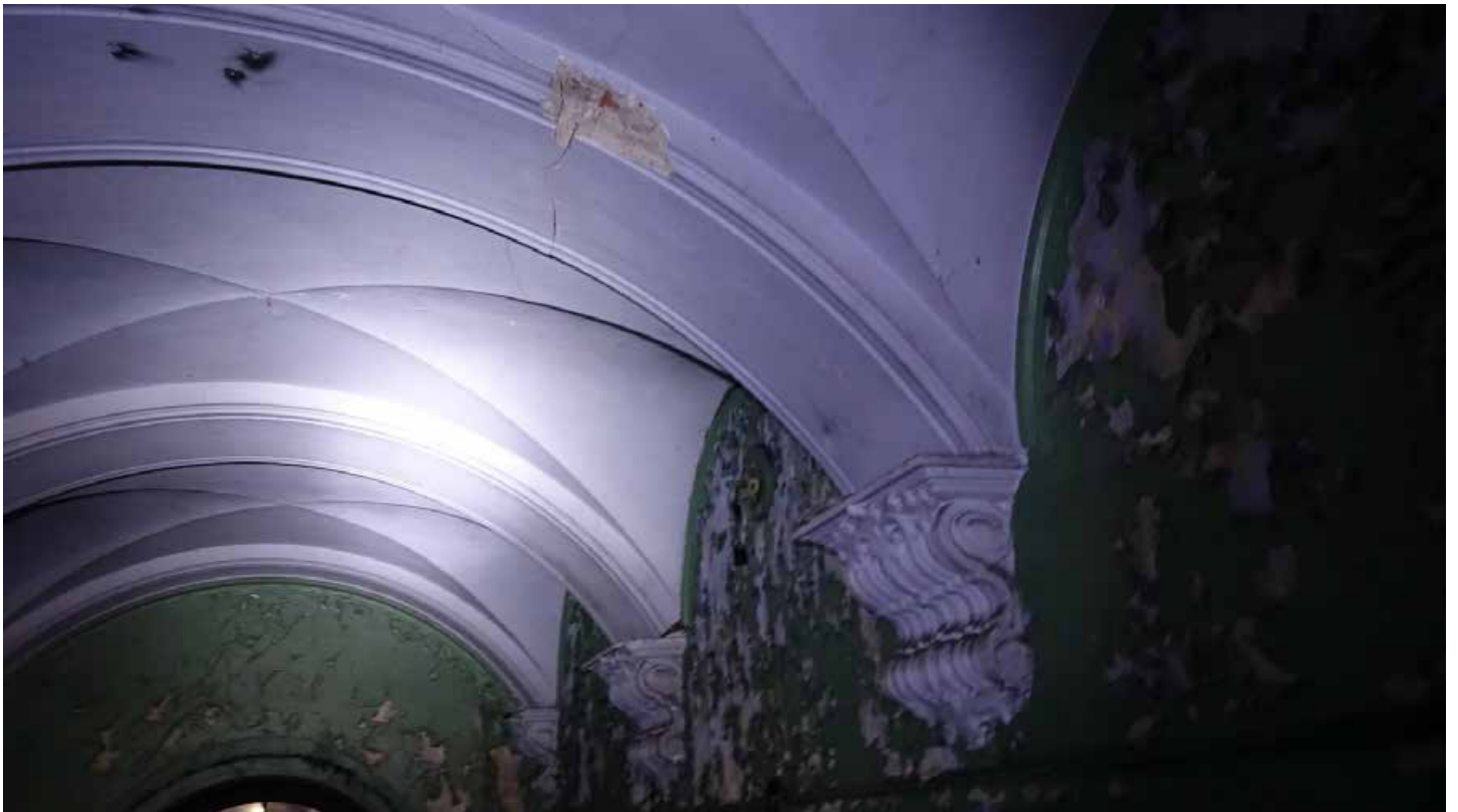
Фото 107. Помещение 1, парадный вестибюль, фрагмент. Своды, подпружные арки, валютообразные кронштейны. Первый этаж. Дата фотофиксации: 01.03.24
