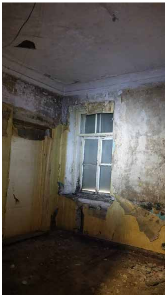
Фото 197. Помещение 99. Третий этаж. Дата фотофиксации: 01.03.24
