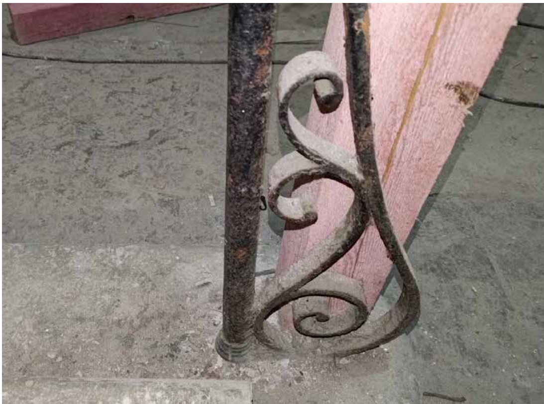
Фото 9. Лестница Л1. Валютообразный кронштейн в основании лестницы. Дата фотофиксации: 01.03.24
