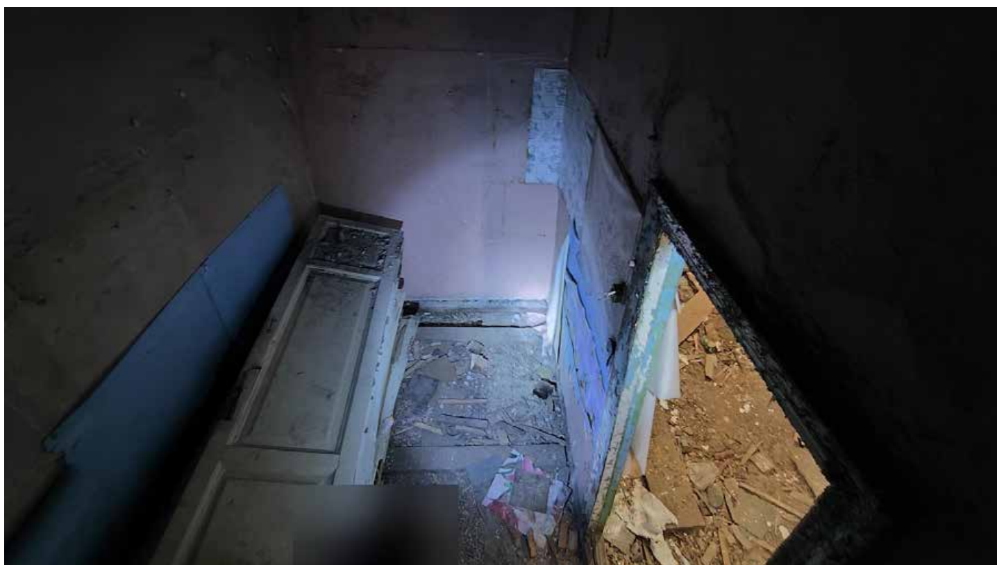
Фото 241. Помещение 140. Третий этаж. Дата фотофиксации: 01.03.24
