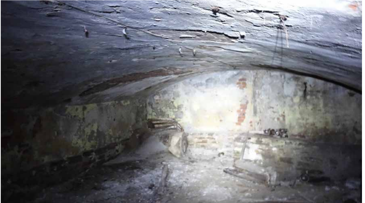
Фото 31. Помещение 147. Цилиндрический свод. Цокольный этаж. Дата фотофиксации: 01.03.24
