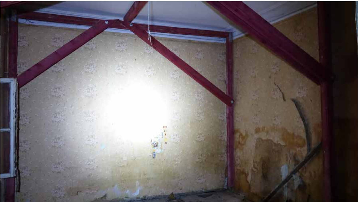
Фото 75. Помещение 24. Общий вид. Первый этаж. Дата фотофиксации: 01.03.24
