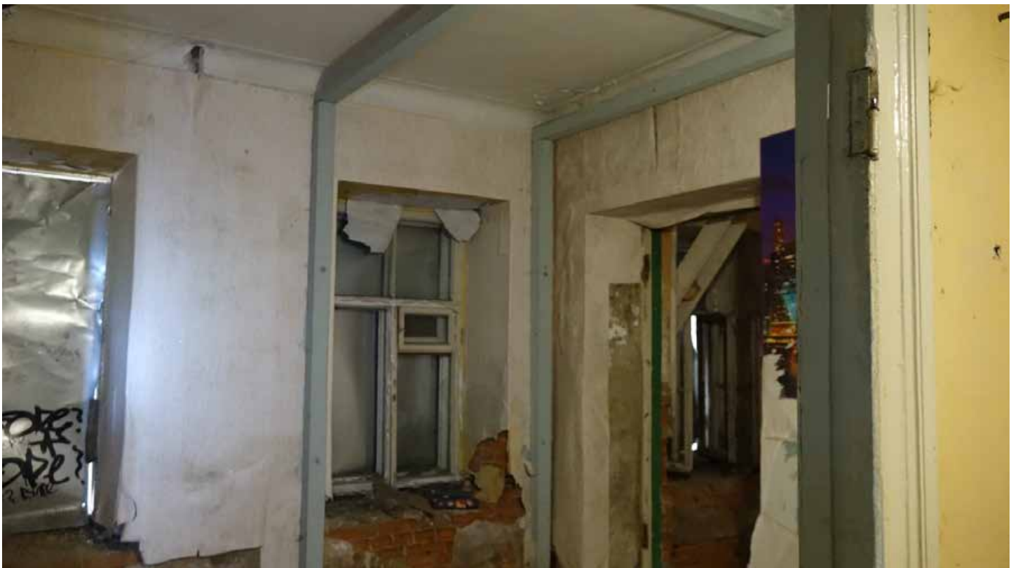
Фото 113. Помещение 37. Общий вид. Первый этаж. Дата фотофиксации: 01.03.24
