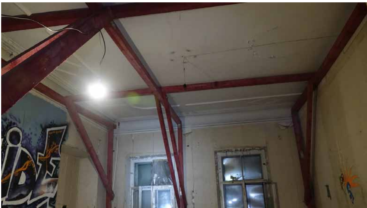
Фото 152. Помещение 59. Элементы исторической отделки потолка. Второй этаж. Дата фотофиксации: 01.03.24
