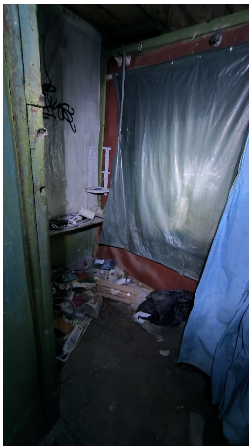
Фото 174. Помещение 81. Общий вид. Второй этаж. Дата фотофиксации: 01.03.24
