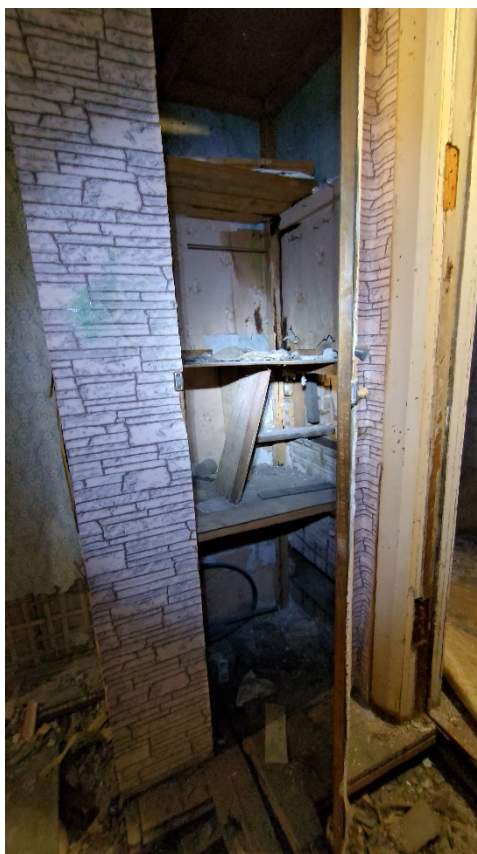
Фото 213. Помещение 121. Третий этаж. Дата фотофиксации: 01.03.24
