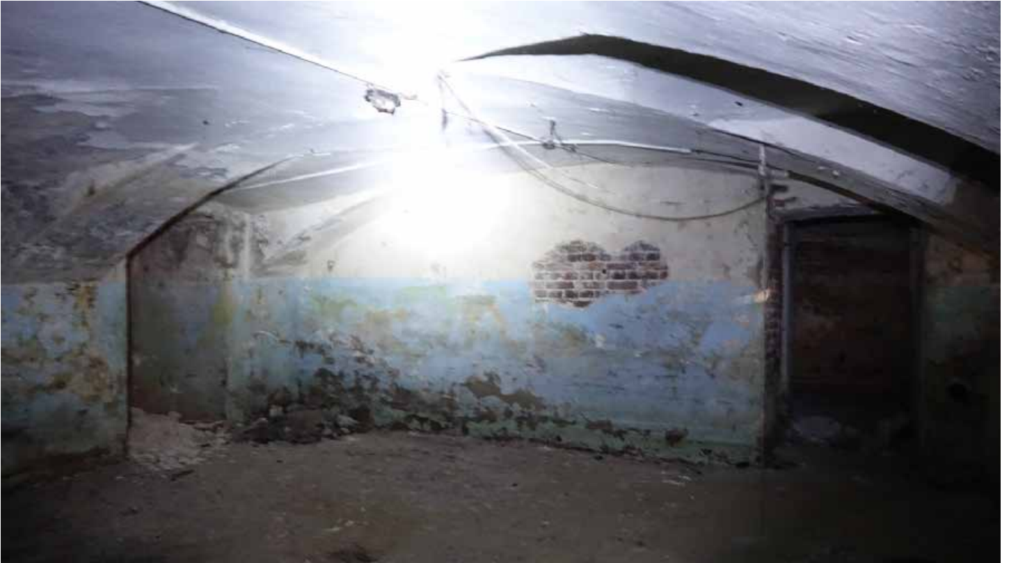
Фото 9. Помещение 151. Коробовый свод с распалубками. Цокольный этаж. Дата фотофиксации: 01.03.24
