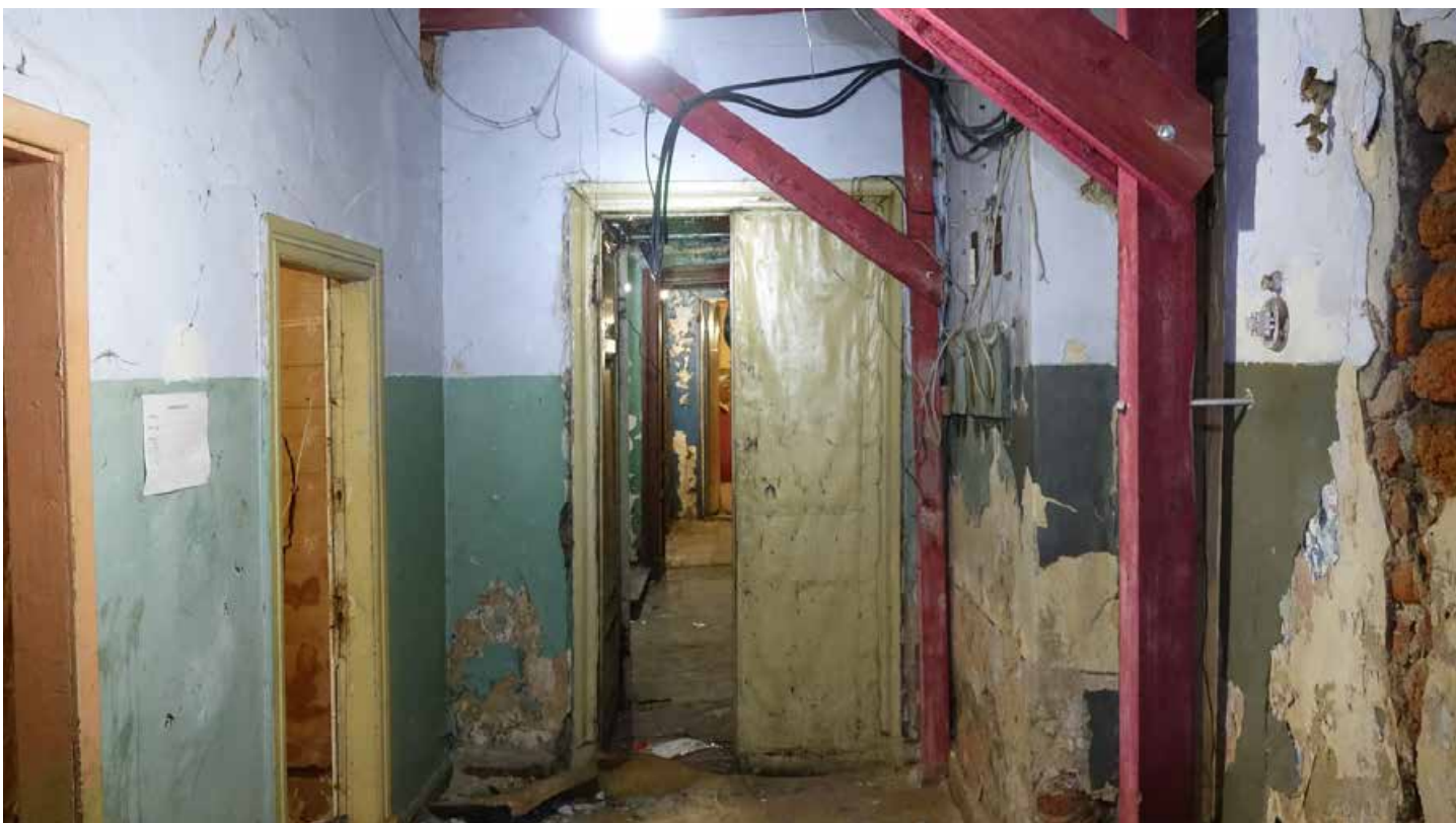
Фото 89. Помещение 4. Общий вид. Первый этаж. Дата фотофиксации: 01.03.24
