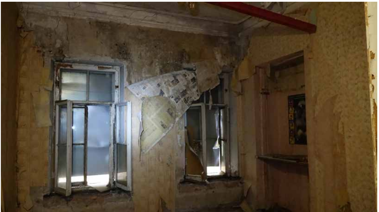
Фото 144. Помещение 62. Общий вид. Второй этаж. Дата фотофиксации: 01.03.24
