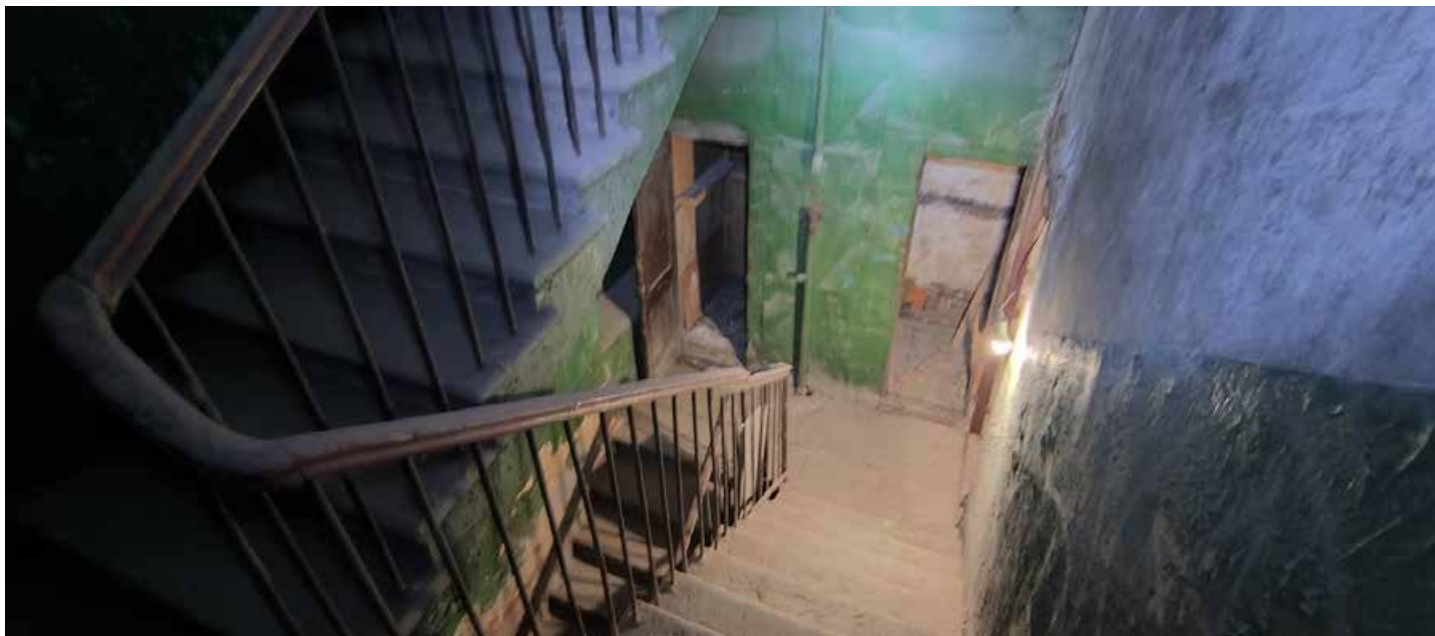
Фото 21. Служебная лестница Л2. Вид на площадку 1-го этажа. Дата фотофиксации: 01.03.24
