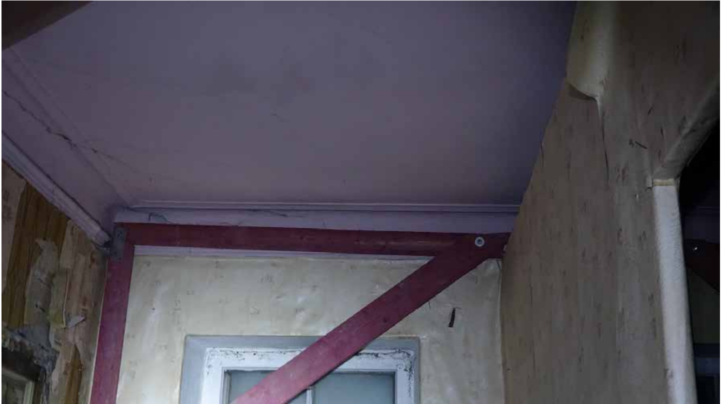
Фото 84. Помещение 20. Падуга и профилированный карниз советского времени. Первый этаж. Дата фотофиксации: 01.03.24
