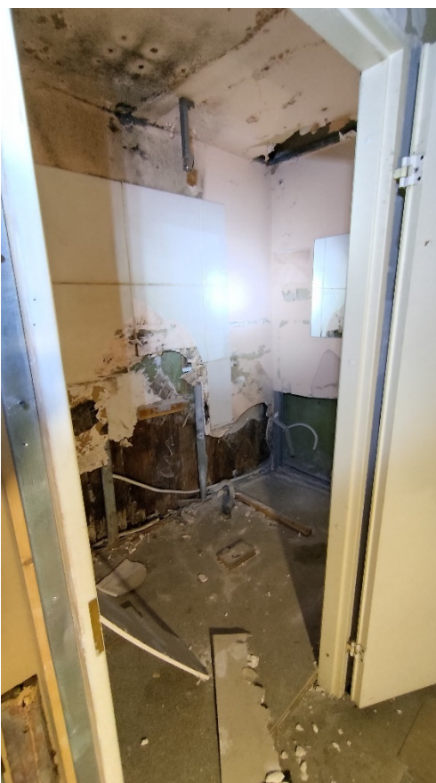
Фото 138. Помещение 53. Общий вид. Второй этаж. Дата фотофиксации: 01.03.24
