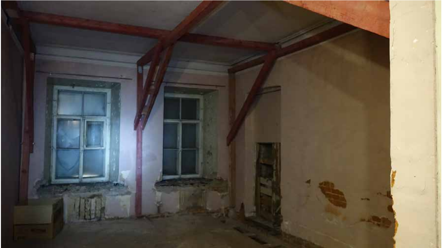
Фото 116. Помещение 40. Общий вид. Первый этаж. Дата фотофиксации: 01.03.24
