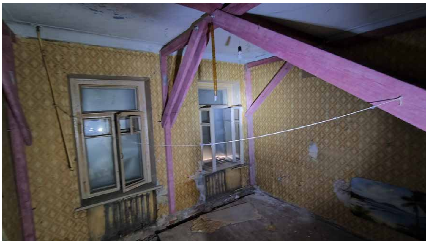
Фото 87. Помещение 21. Общий вид. Первый этаж. Дата фотофиксации: 01.03.24
