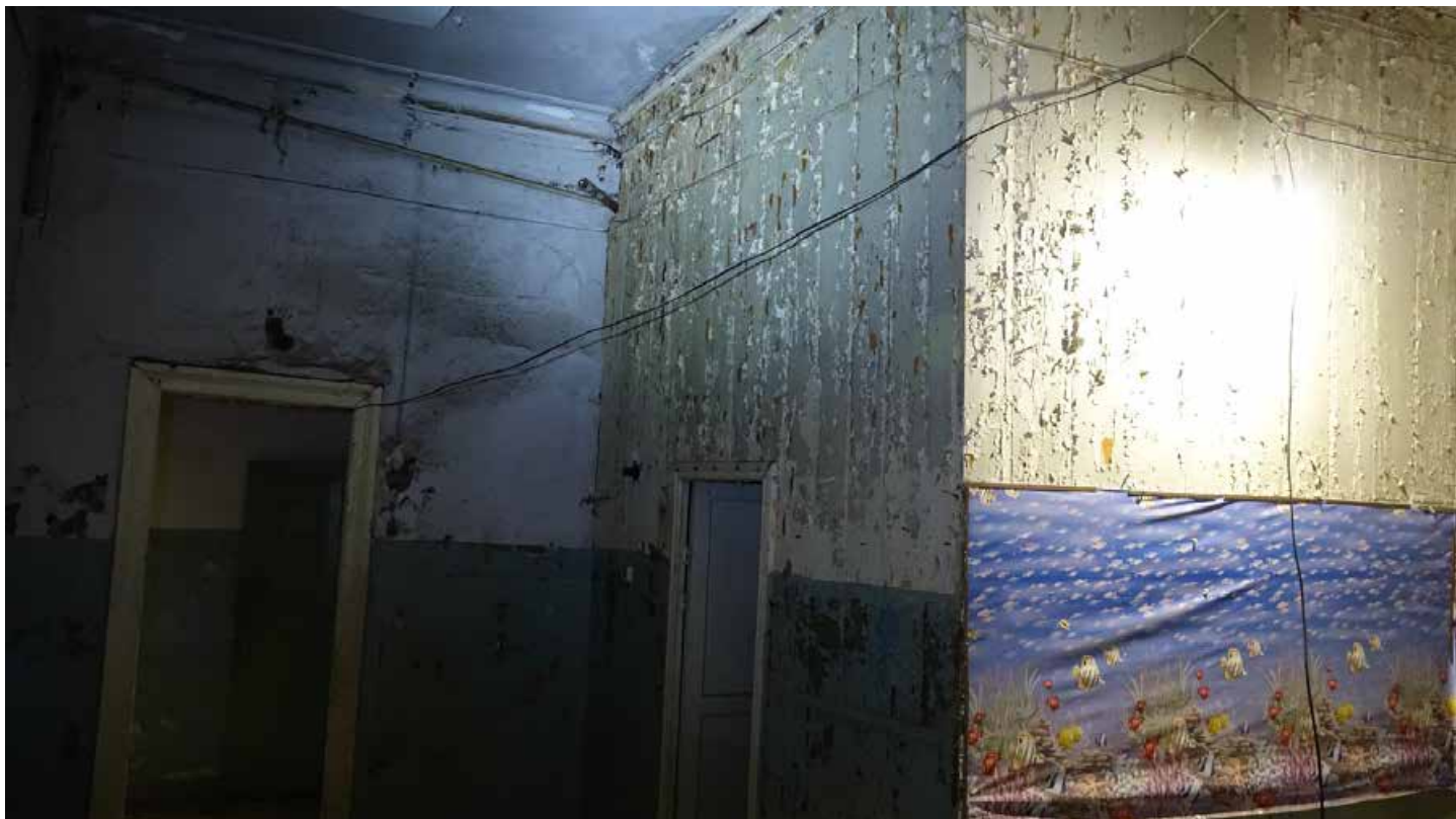
Фото 198. Помещение 105. Третий этаж. Дата фотофиксации: 01.03.24
