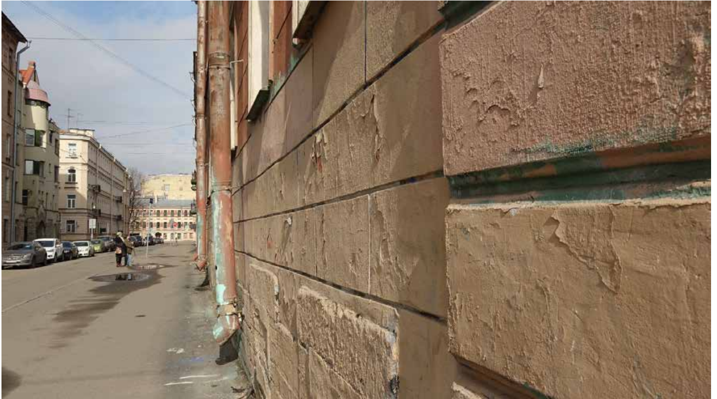
Фото 15. Фрагмент стены западного фасада с рустом. Дата фотофиксации: 01.03.24
