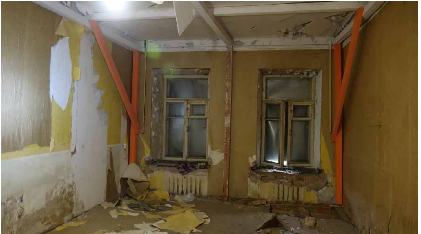
Фото 115. Помещение 39. Общий вид. Первый этаж. Дата фотофиксации: 01.03.24
