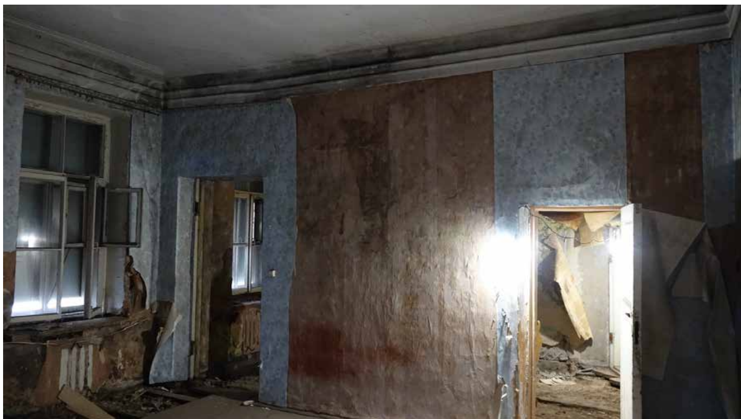
Фото 205. Помещение 112. Общий вид. Третий этаж. Дата фотофиксации: 01.03.24
