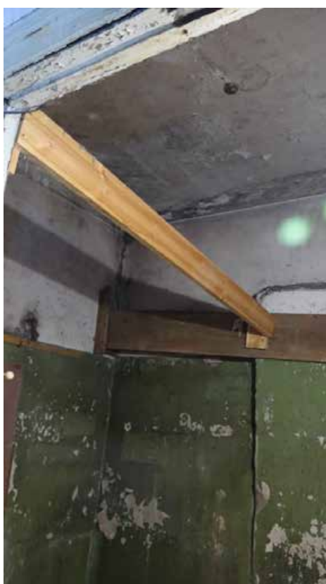
Фото 235. Помещение 136. Потолок. Третий этаж. Дата фотофиксации: 01.03.24
