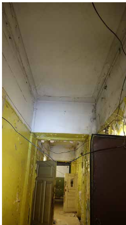
Фото 217. Помещение 124. Коридор. Третий этаж. Дата фотофиксации: 01.03.24
