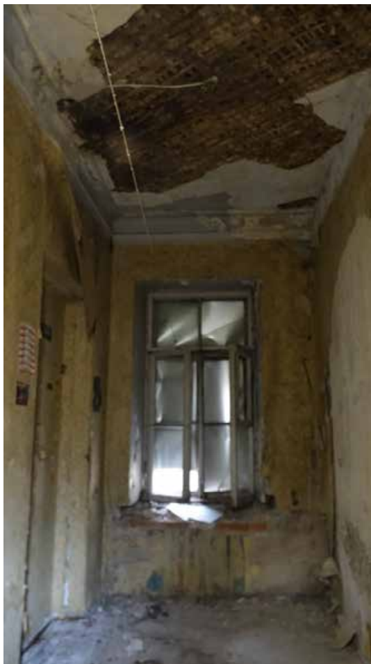
Фото 222. Помещение 129. Общий вид. Третий этаж. Дата фотофиксации: 01.03.24
