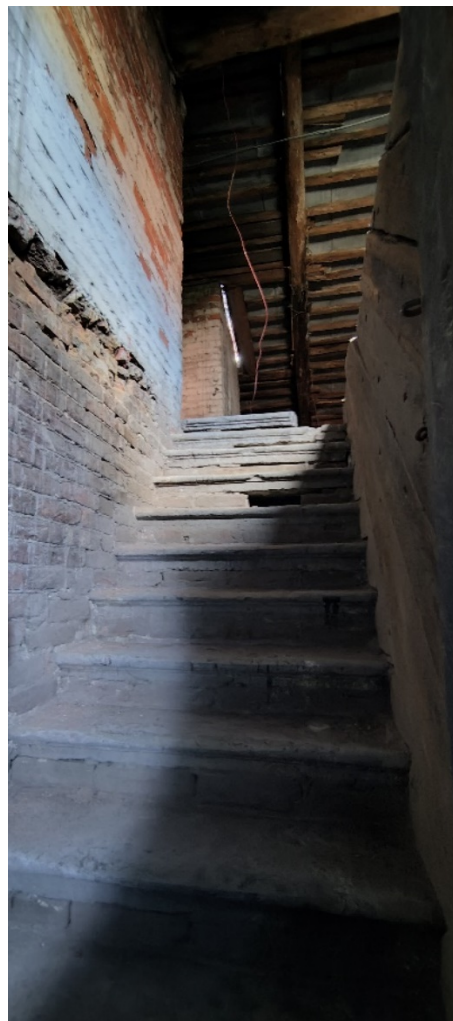
Фото 11. Лестница Л4. Лестничный марш на чердак. Дата фотофиксации: 01.03.24
