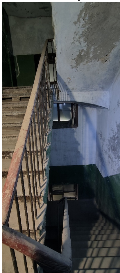
Фото 22. Служебная лестница Л2. Вид на межэтажную площадку чердачного марша. Дата фотофиксации: 01.03.24
