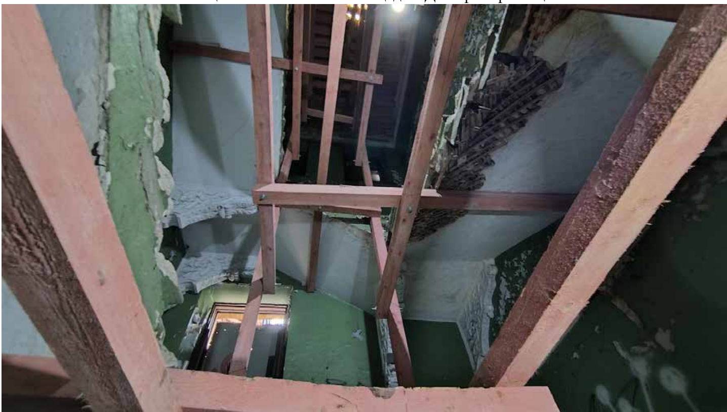
Фото 4. Лестница Л1. Кронштейны, лестничные марши. Дата фотофиксации: 01.03.24
