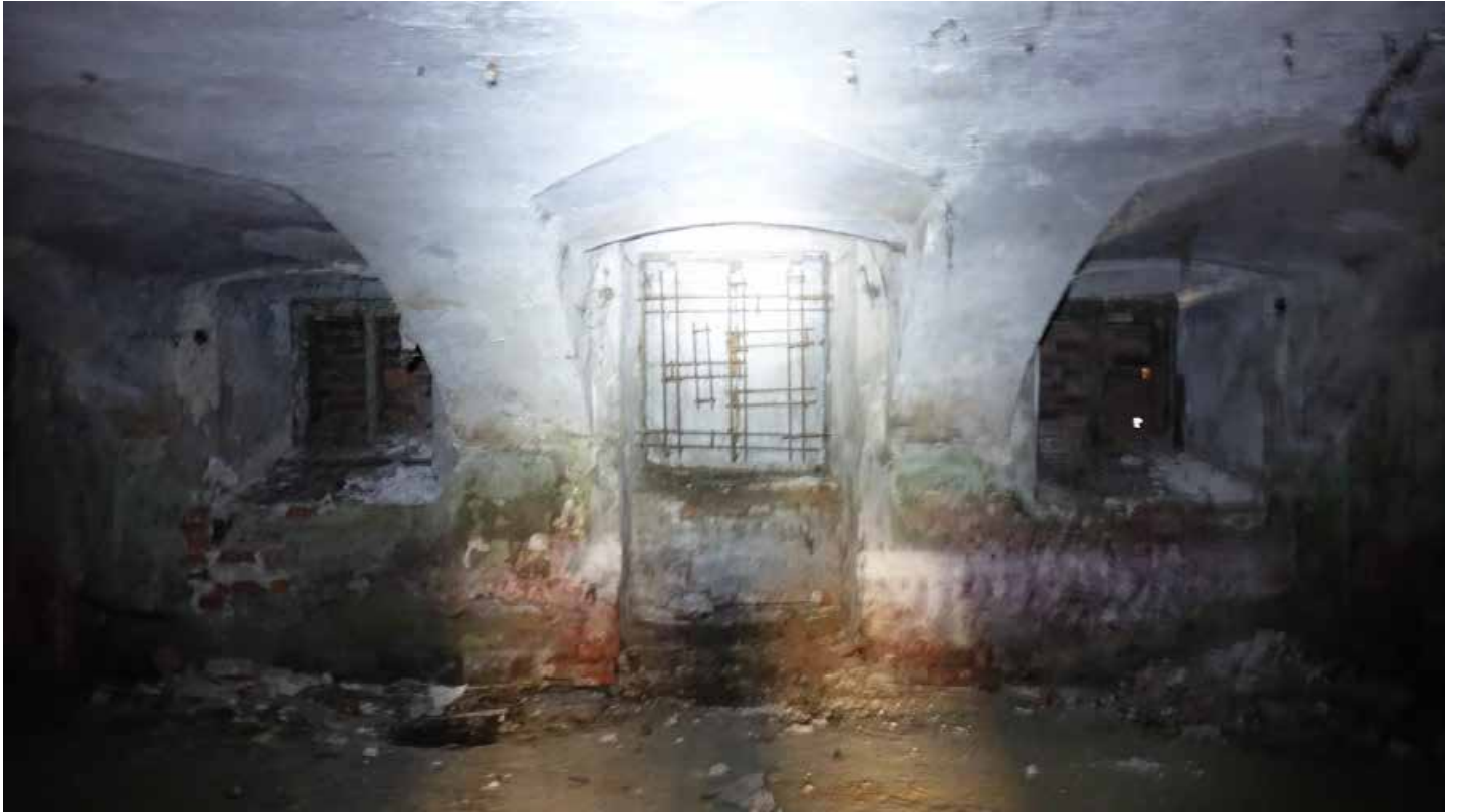
Фото 49. Помещение 4. Вид на заложённые проёмы цокольного этажа. Дата фотофиксации: 01.03.24
