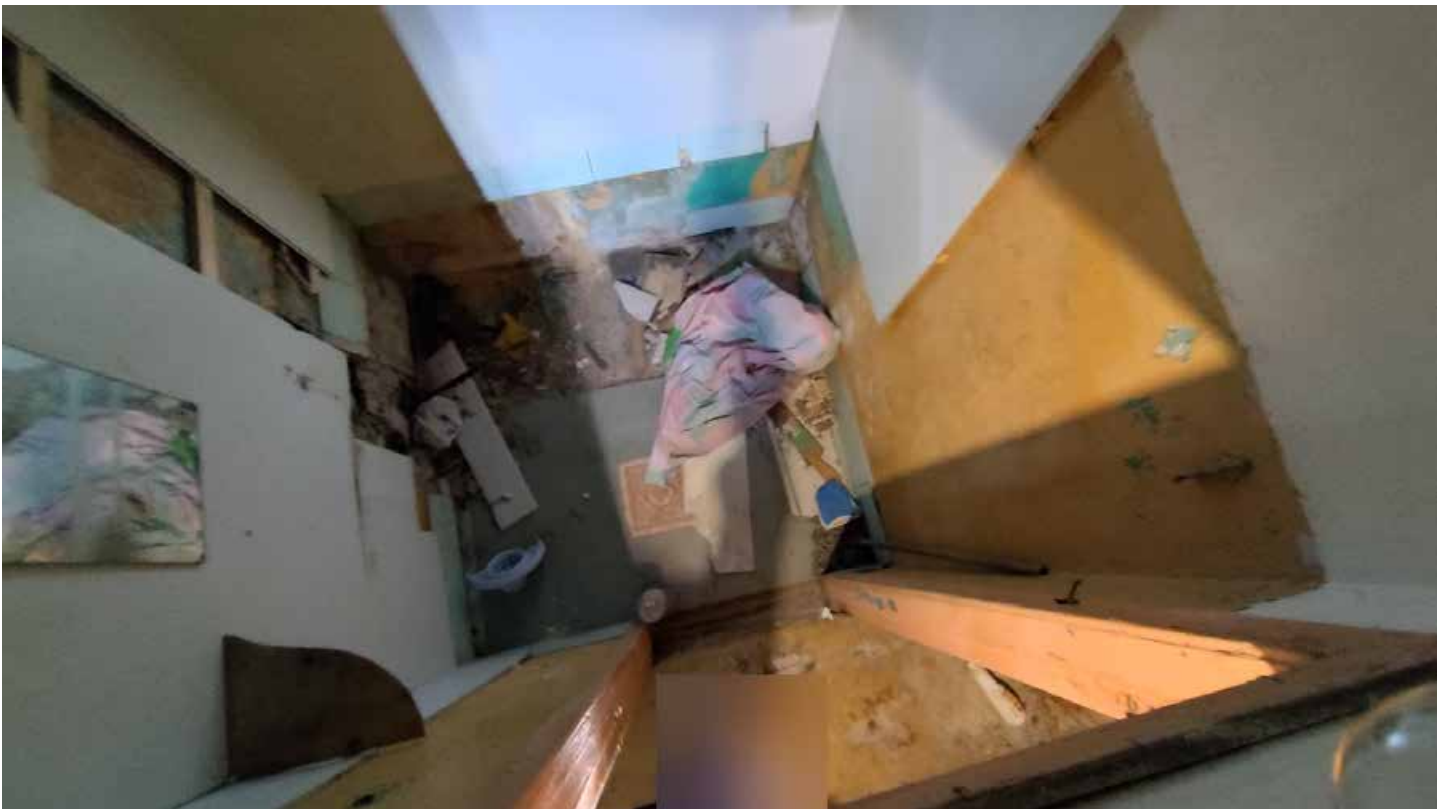
Фото 101. Помещение 7. Общий вид. Первый этаж. Дата фотофиксации: 01.03.24
