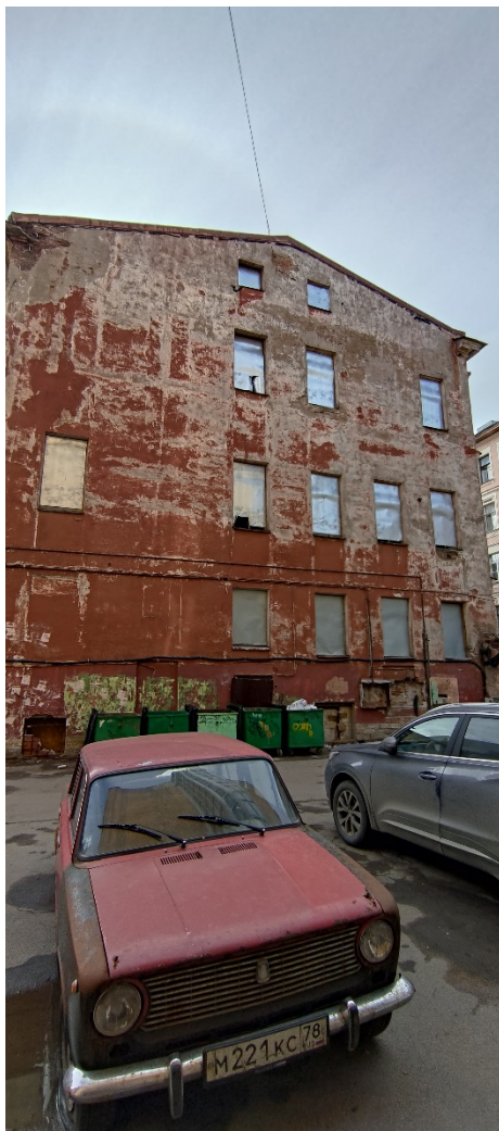
Фото 19. Северный торцевой фасад. Общий вид. Дата фотофиксации: 01.03.24
