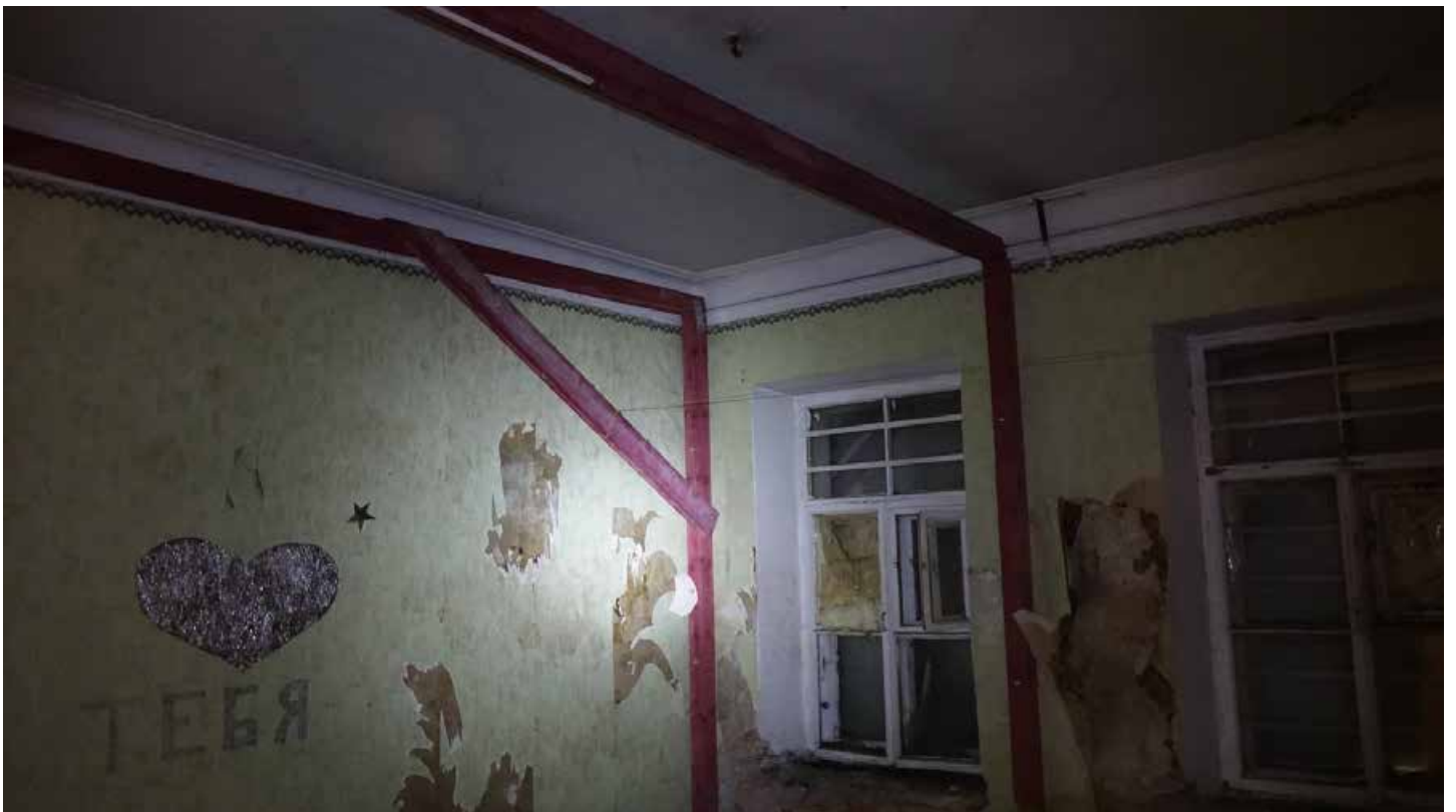
Фото 97. Помещение 11. Общий вид. Первый этаж. Дата фотофиксации: 01.03.24
