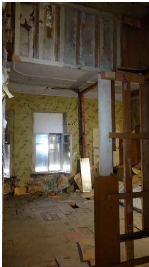
Фото 164. Вид на помещение 76 со стороны помещения 75. Второй этаж Дата фотофиксации: 01.03.24
