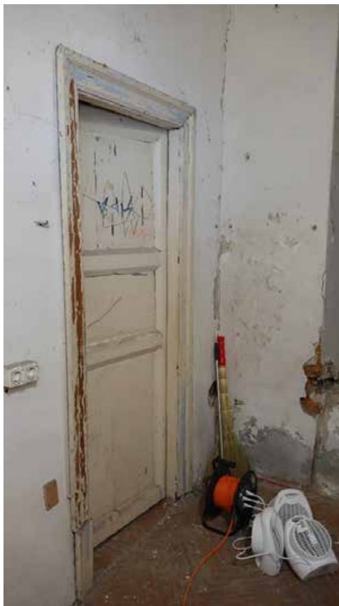
Фото 130. Помещение 46. Дверное заполнение советского времени. Общий вид. Первый этаж. Дата фотофиксации: 01.03.24
