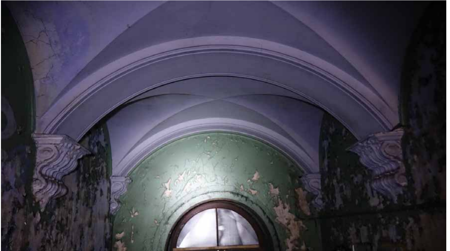
Фото 108. Помещение 1, парадный вестибюль. Подпружные арки, общий вид. Первый этаж. Дата фотофиксации: 01.03.24
