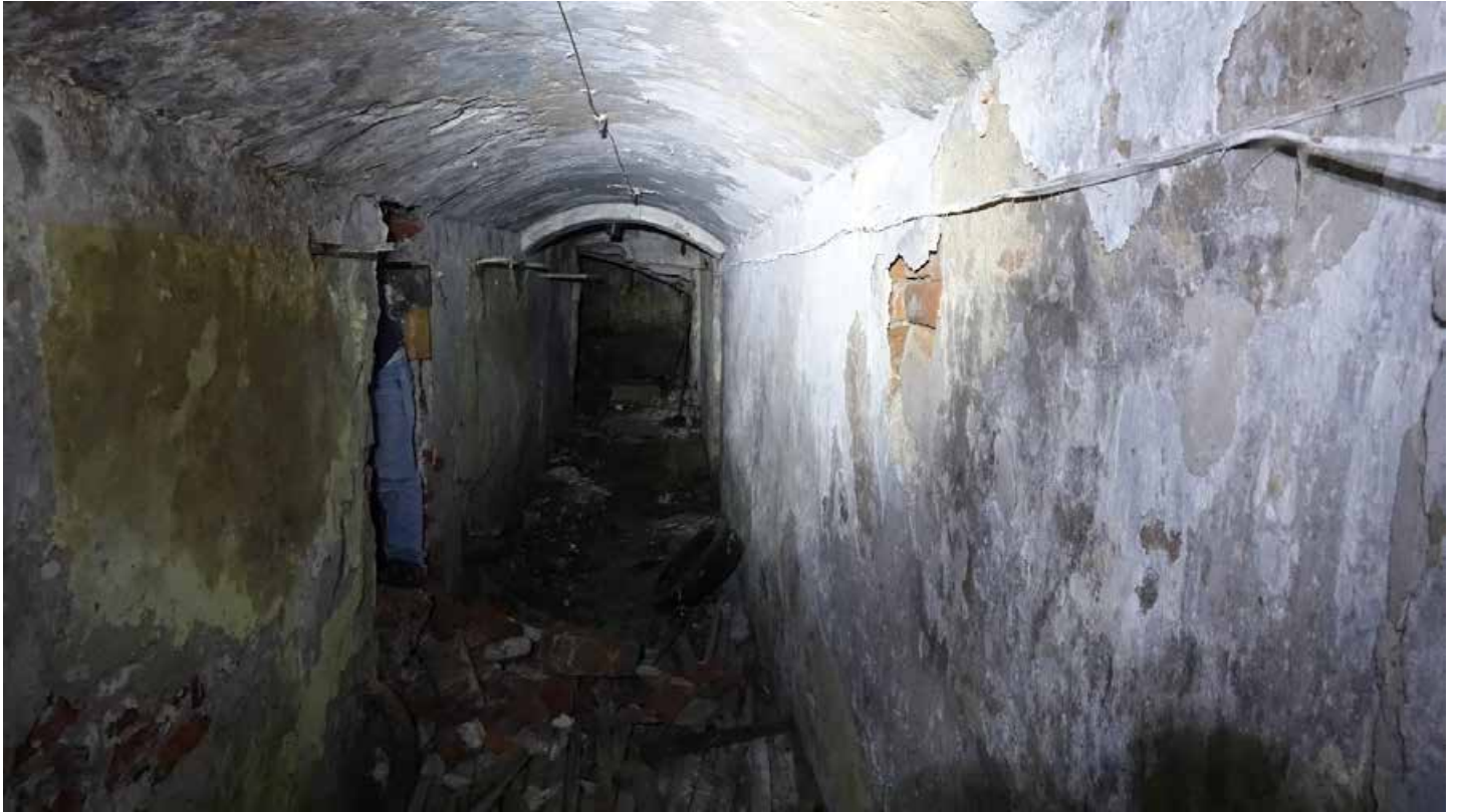
Фото 23. Помещение 144. Цилиндрический свод с подпружной аркой. Цокольный этаж. Дата фотофиксации: 01.03.24
