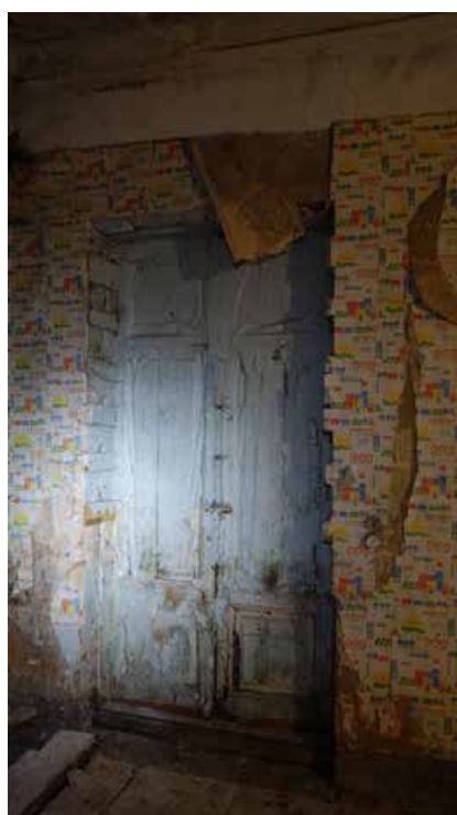
Фото 227. Помещение 130. Вид на проем с деревянным двустворчатым заполнением. Третий этаж. Дата фотофиксации: 01.03.24
