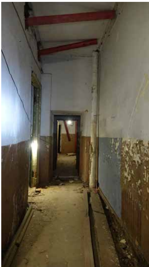
Фото 139. Помещение 51. Коридор, ведущий в помещения дворового флигеля. Второй этаж. Дата фотофиксации: 01.03.24
