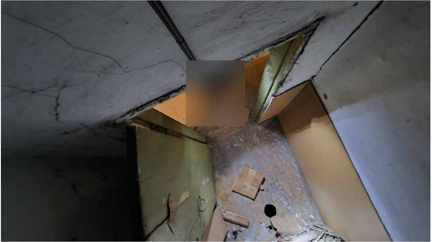
Фото 232. Помещение 135. Общий вид. Третий этаж. Дата фотофиксации: 01.03.24
