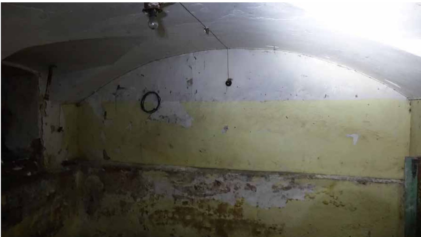
Фото 26. Помещение 145. Коробовый свод с распалубками. Цокольный этаж. Дата фотофиксации: 01.03.24
