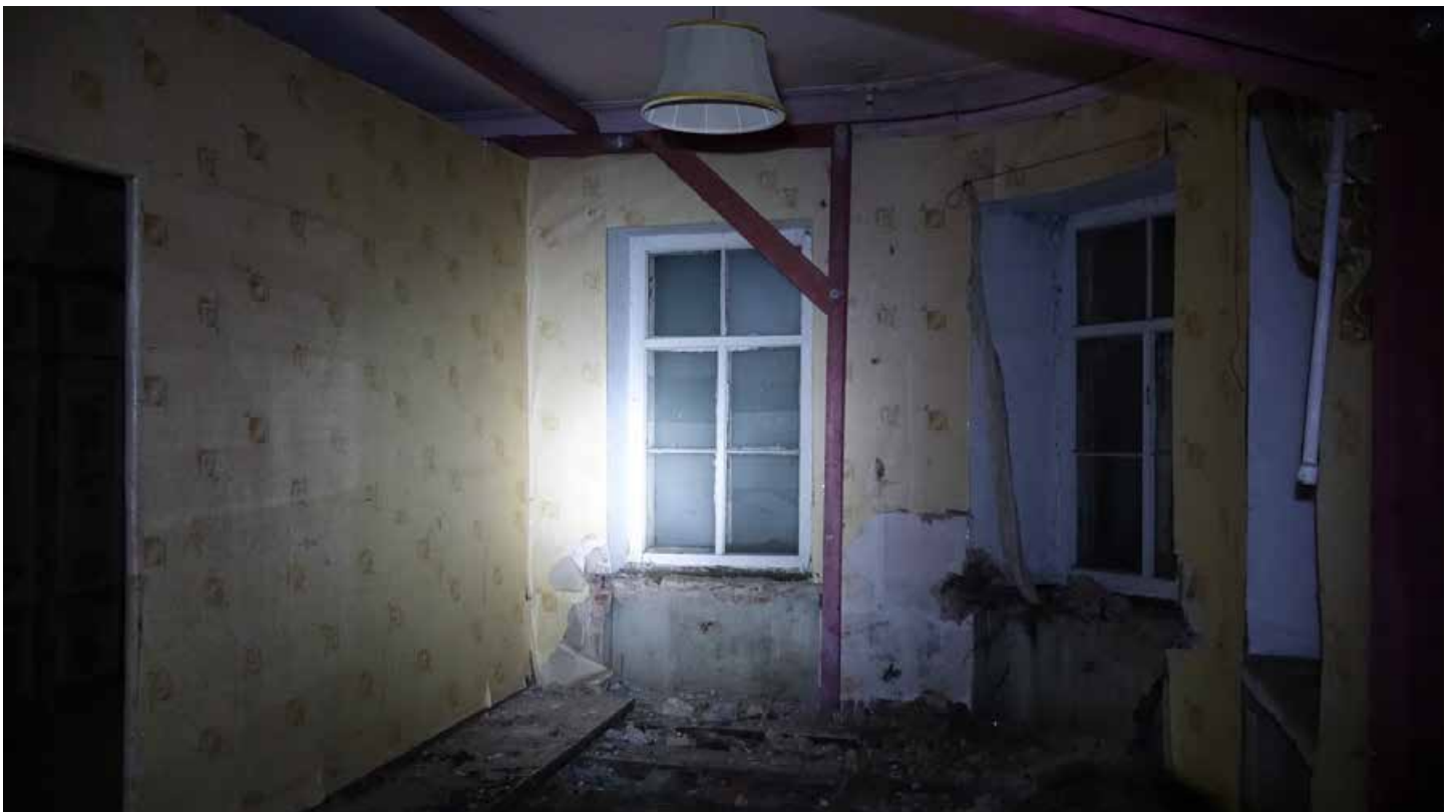
Фото 81. Помещение 19. Общий вид. Первый этаж. Дата фотофиксации: 01.03.24
