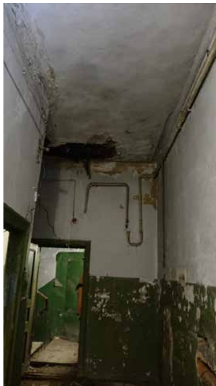
Фото 238. Помещение 138. Помещение в дворовом флигеле. Третий этаж. Дата фотофиксации: 01.03.24
