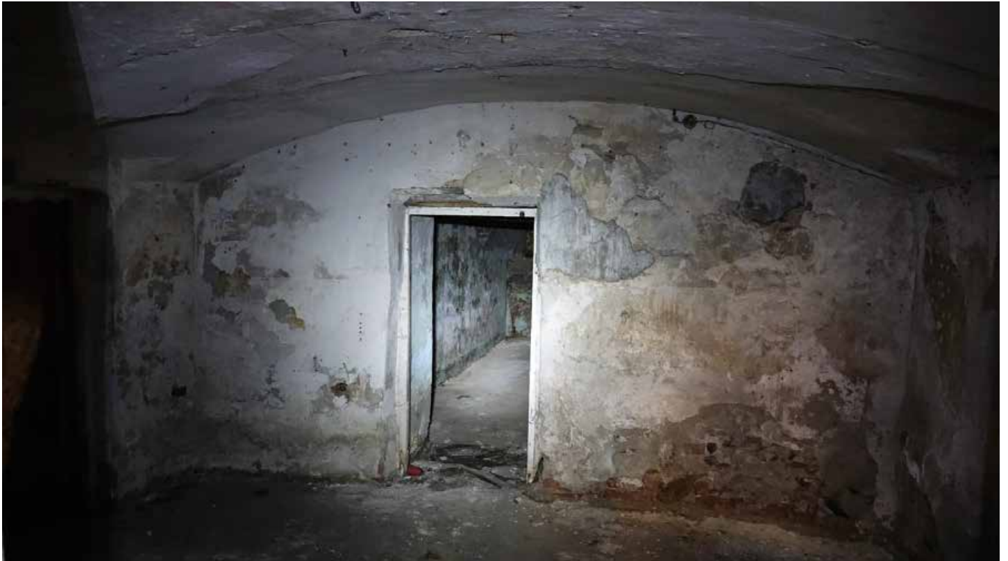
Фото 1. Помещение 153. Цилиндрический свод. Цокольный этаж. Дата фотофиксации: 01.03.24
