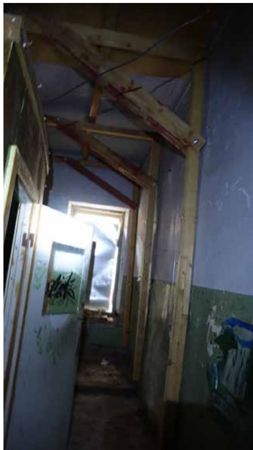
Фото 183. Помещение 92. Общий вид. Второй этаж. Дата фотофиксации: 01.03.24
