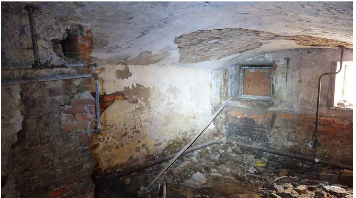
Фото 22. Помещение 158. Фрагмент стены и свода. Участок сохранившегося трубопровода. Дата фотофиксации: 01.03.24
