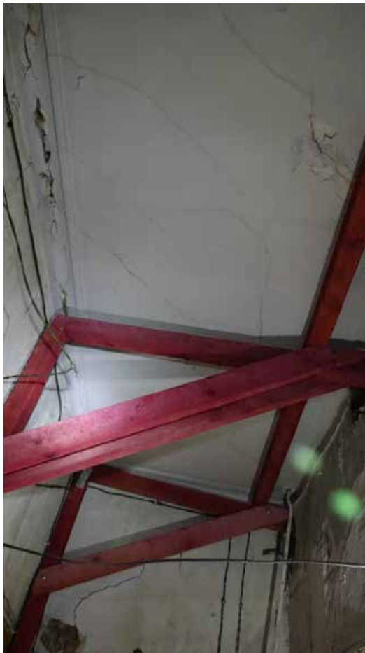
Фото 159. Помещение 69. Вид на потолок. Второй этаж. Дата фотофиксации: 01.03.24
