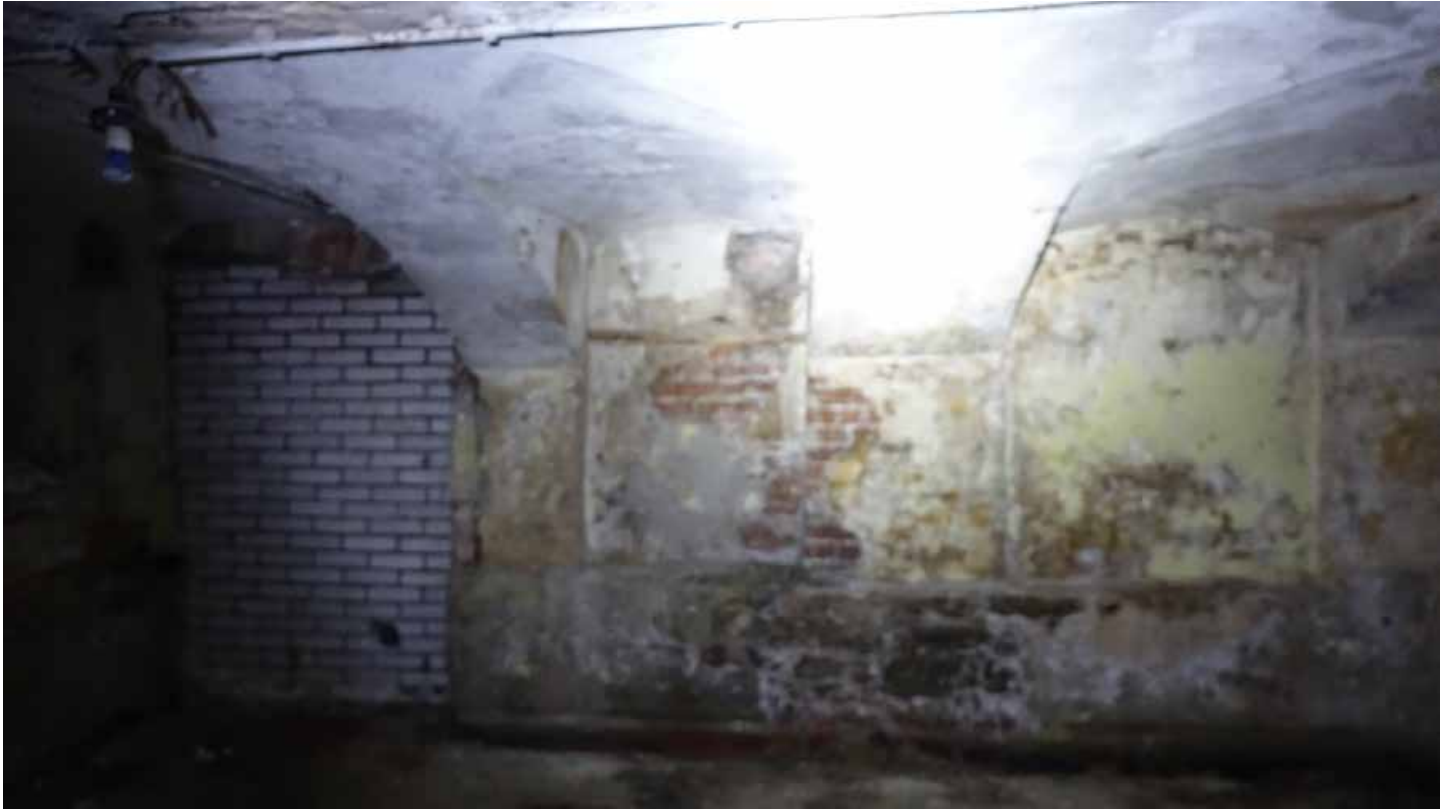
Фото 19. Помещение 150. Коробовый свод с распалубками. Цокольный этаж. Дата фотофиксации: 01.03.24
