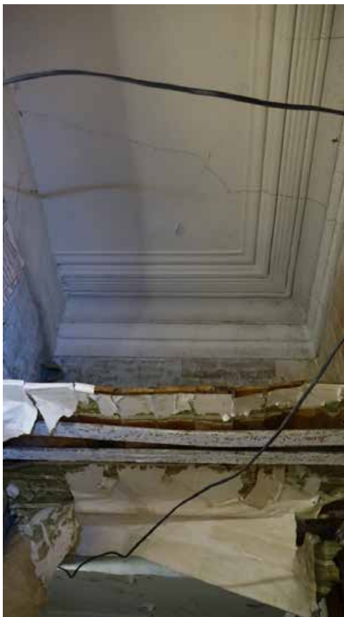
Фото 214. Помещение 120. Вид на потолок. Третий этаж. Дата фотофиксации: 01.03.24
