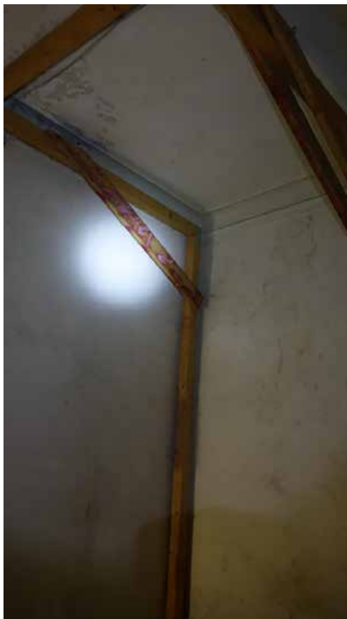
Фото 187. Помещение 95. Фрагмент. Второй этаж. Дата фотофиксации: 01.03.24
