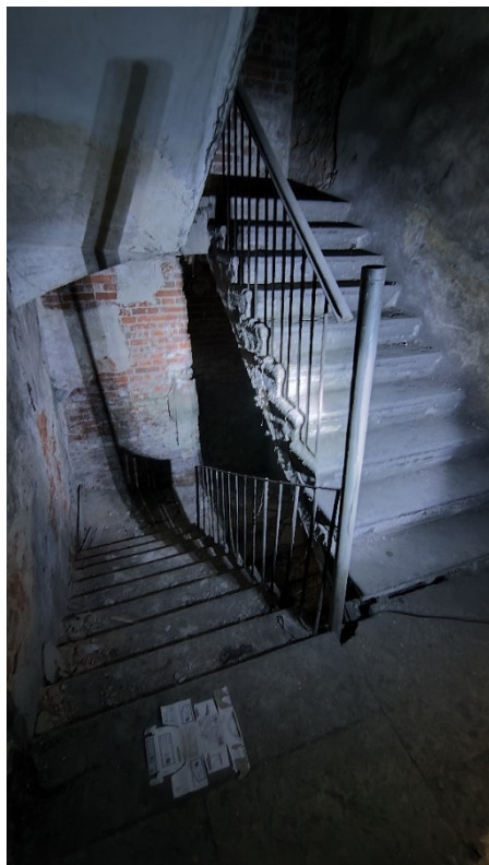
Фото 17. Служебная лестница ЛЗ. Фрагмент. Дата фотофиксации: 01.03.24
