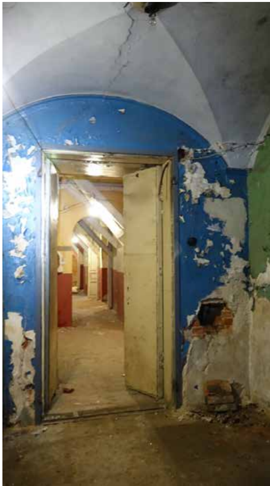
Фото 104. Помещение 112. Общий вид. Дата фотофиксации: 01.03.24
