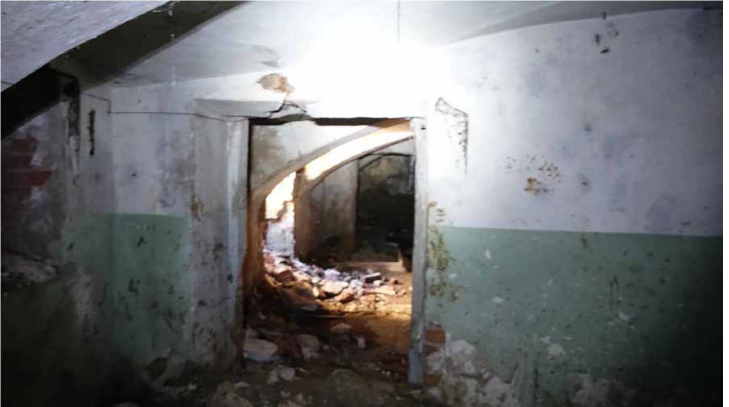
Фото 57. Проход между помещениями 2 и 1. Цокольный этаж. Дата фотофиксации: 01.03.24.
