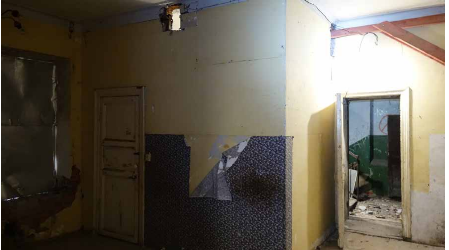
Фото 126. Помещение 45. Общий вид. Первый этаж. Дата фотофиксации: 01.03.24
