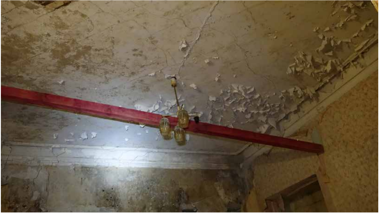
Фото 145. Помещение 62. Карниз советского периода. Второй этаж. Дата фотофиксации: 01.03.24
