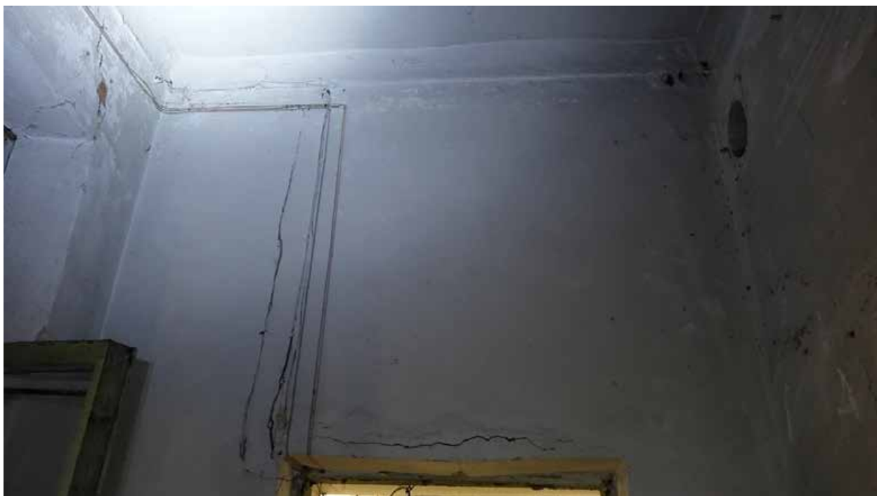
Фото 237. Помещение 137. Фрагмент стены и карниза. Третий этаж. Дата фотофиксации: 01.03.24
