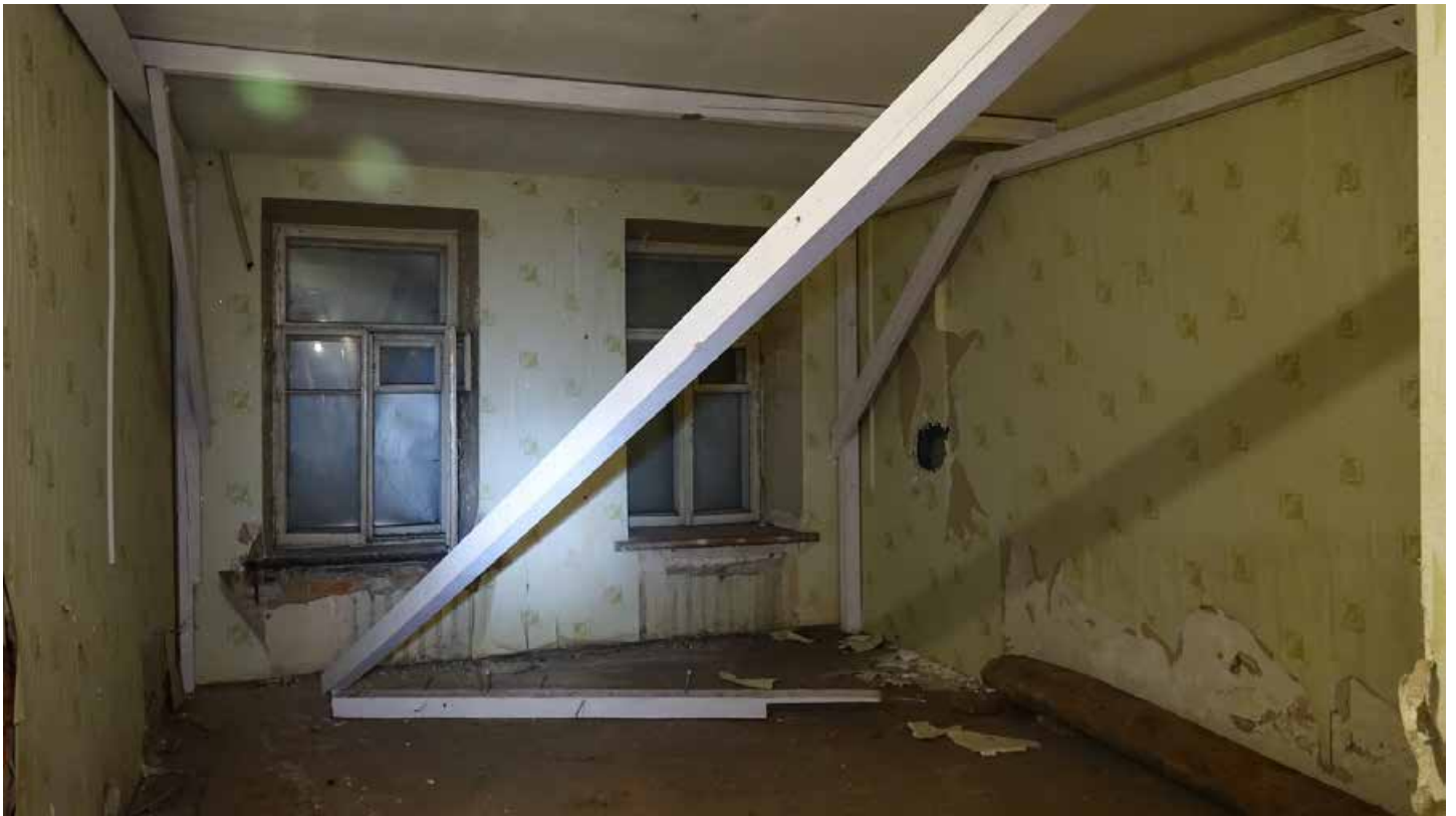
Фото 122. Помещение 42. Общий вид. Первый этаж. Дата фотофиксации: 01.03.24
