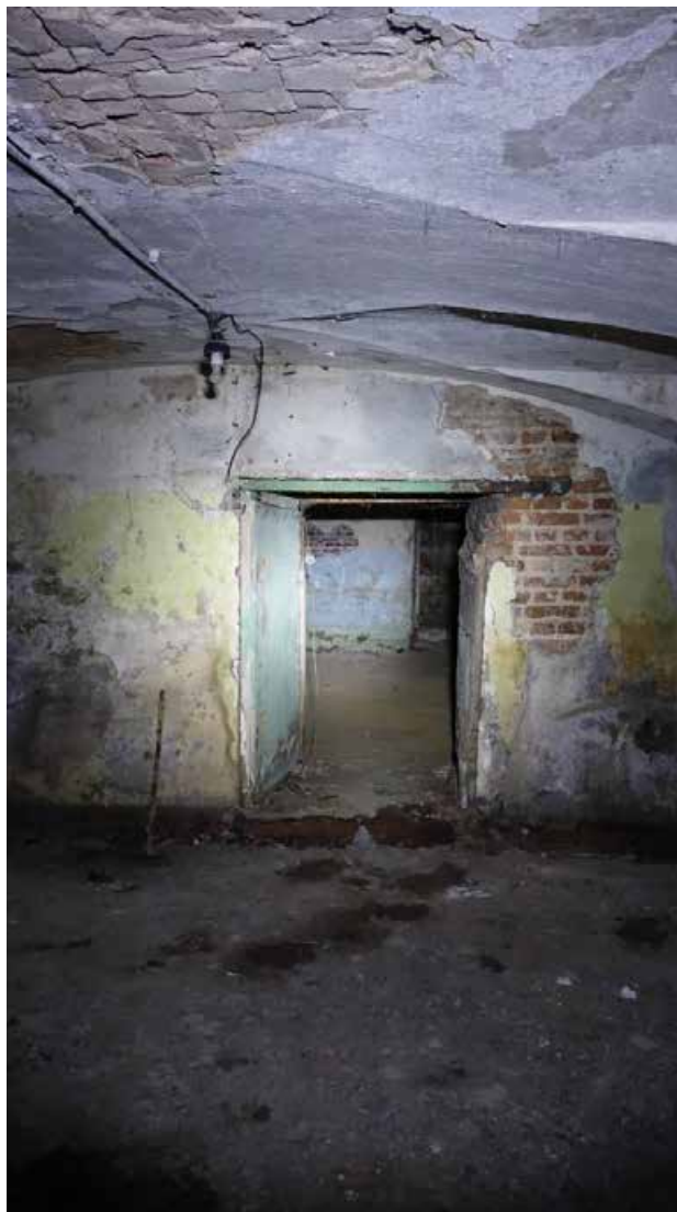
Фото 18. Помещение 150. Коробовый свод с распалубками. Цокольный этаж. Дата фотофиксации: 01.03.24
