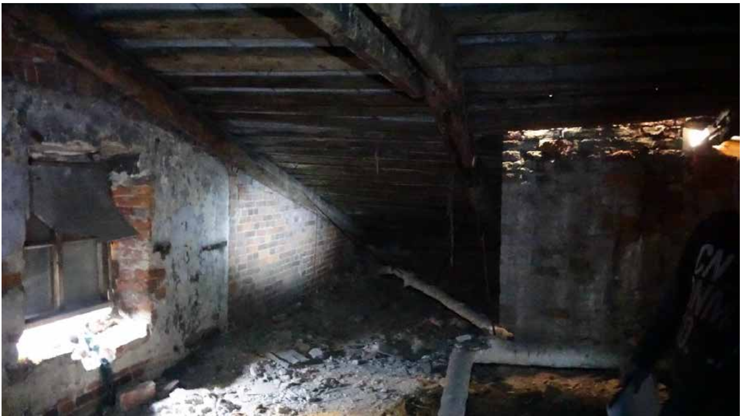
Фото 257. Несущая стена и оконное заполнение северного фасада. Фрагмент. Мансарда. Дата фотофиксации: 01.03.24
