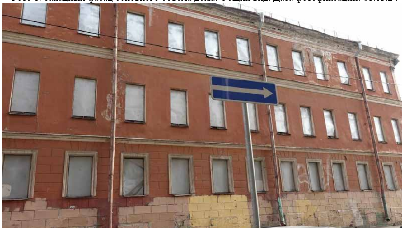
Фото 2. Западный фасад, фрагмент. Дата фотофиксации: 01.03.24
