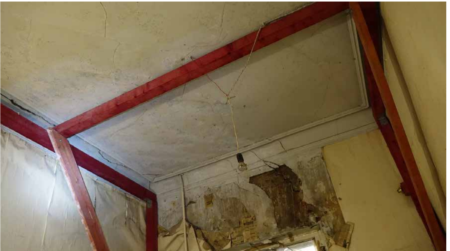
Фото 154. Помещение 64. Карнизы и падуга советского периода. Второй этаж. Дата фотофиксации: 01.03.24
