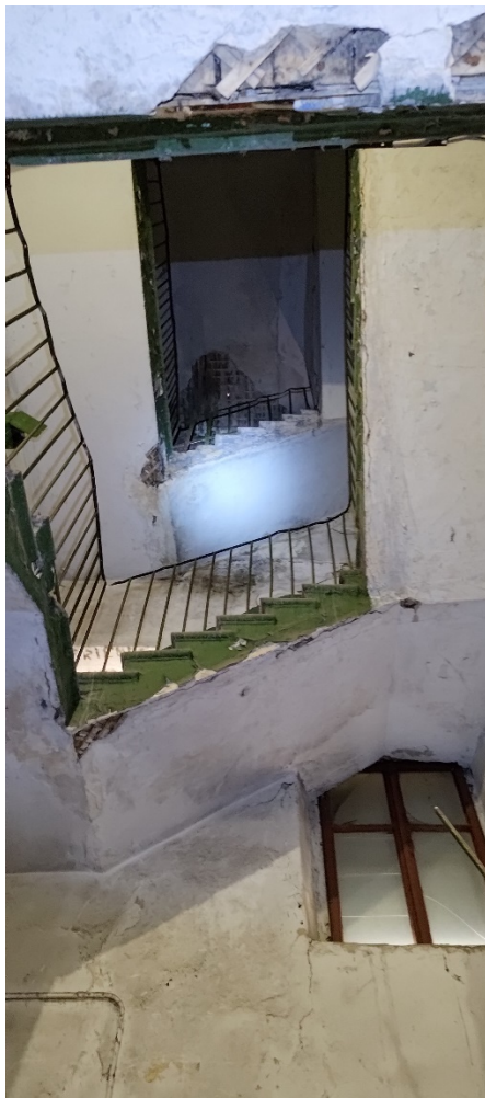
Фото 15. Лестница Л4. Вид снизу вверх на лестничные марши. Дата фотофиксации: 01.03.24
