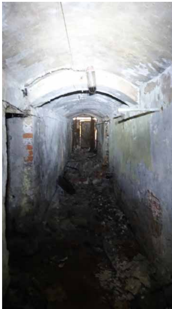
Фото 24. Помещение 144. Цилиндрический свод с подпружной аркой. Цокольный этаж. Дата фотофиксации: 01.03.24
