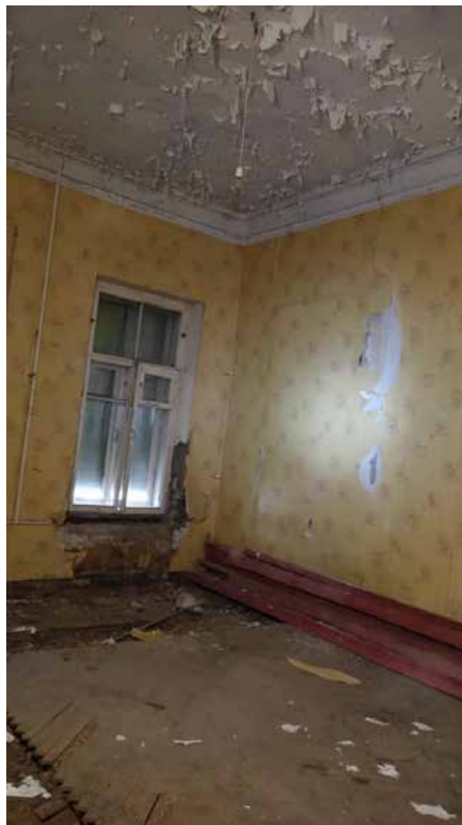
Фото 158. Помещение 67. Общий вид. Второй этаж. Дата фотофиксации: 01.03.24
