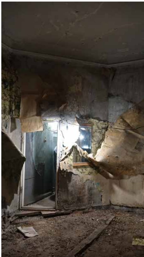
Фото 204. Помещение 111. Общий вид. Третий этаж. Дата фотофиксации: 01.03.24
