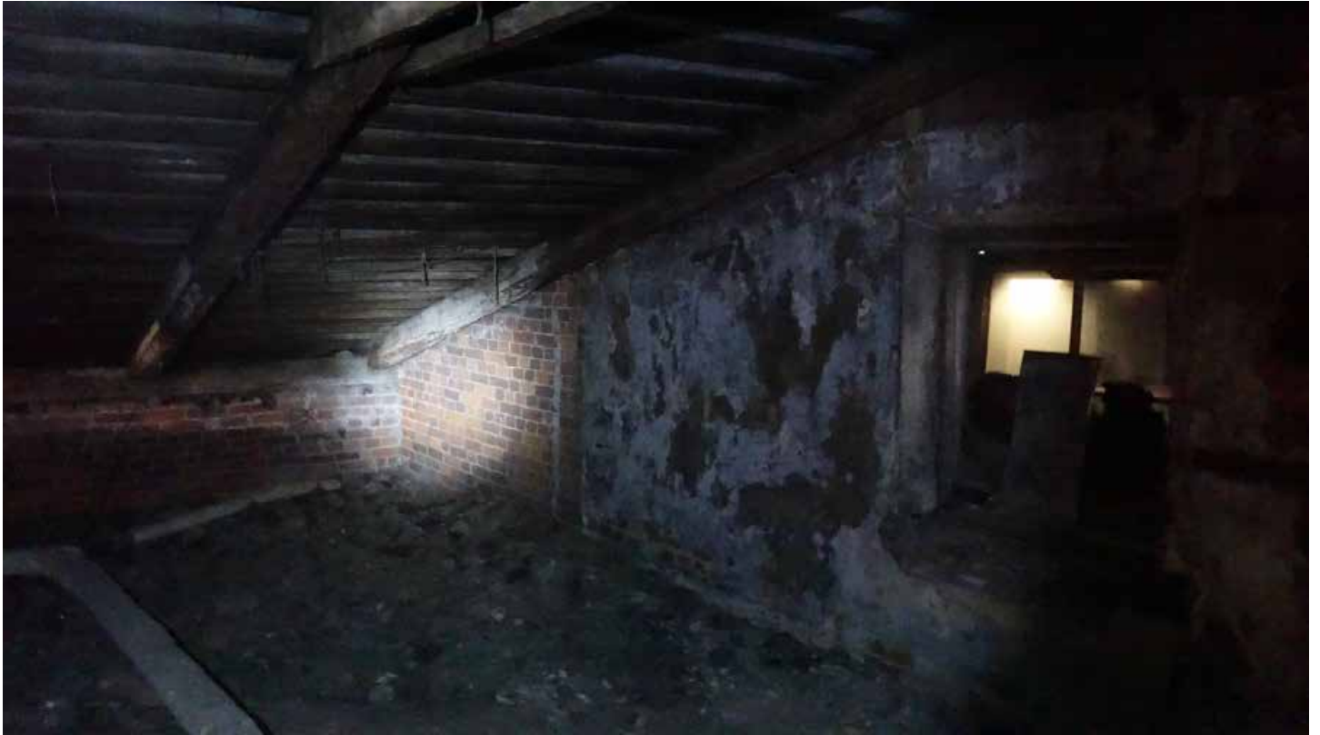
Фото 256. Несущая стена и оконное заполнение северного фасада. Фрагмент. Мансарда. Дата фотофиксации: 01.03.24
