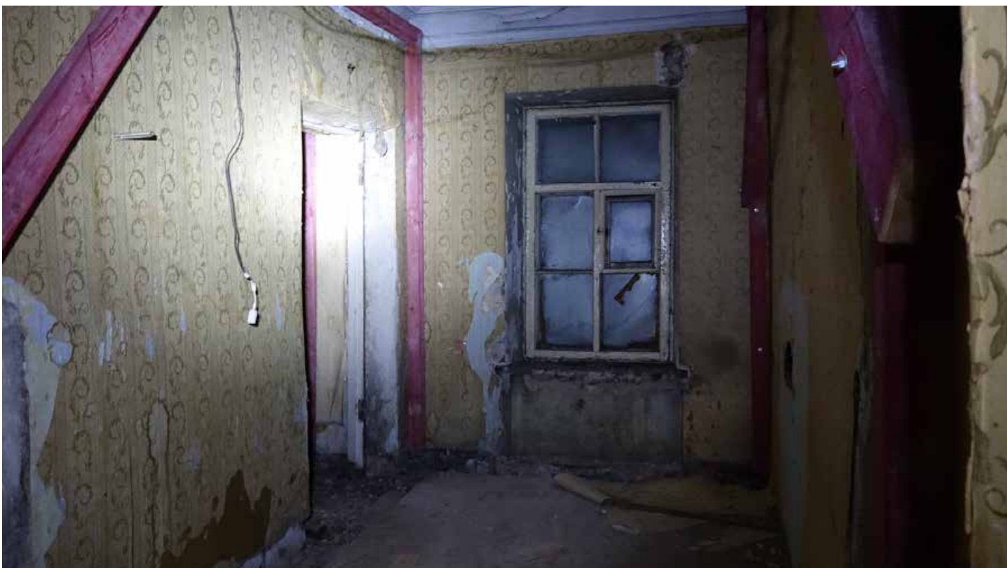
Фото 79. Помещение 18. Общий вид. Первый этаж. Дата фотофиксации: 01.03.24
