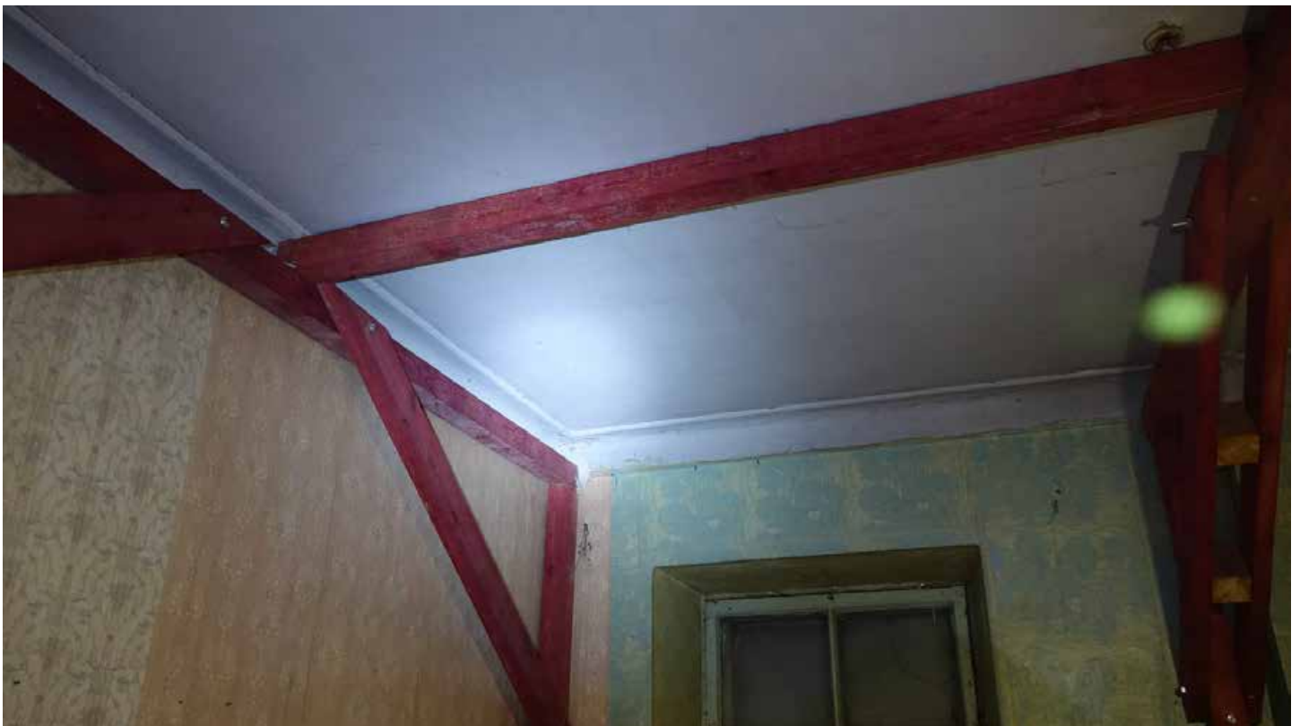
Фото 71. Помещение 29. Падуга и профилированный карниз советского времени. Первый этаж. Дата фотофиксации: 01.03.24
