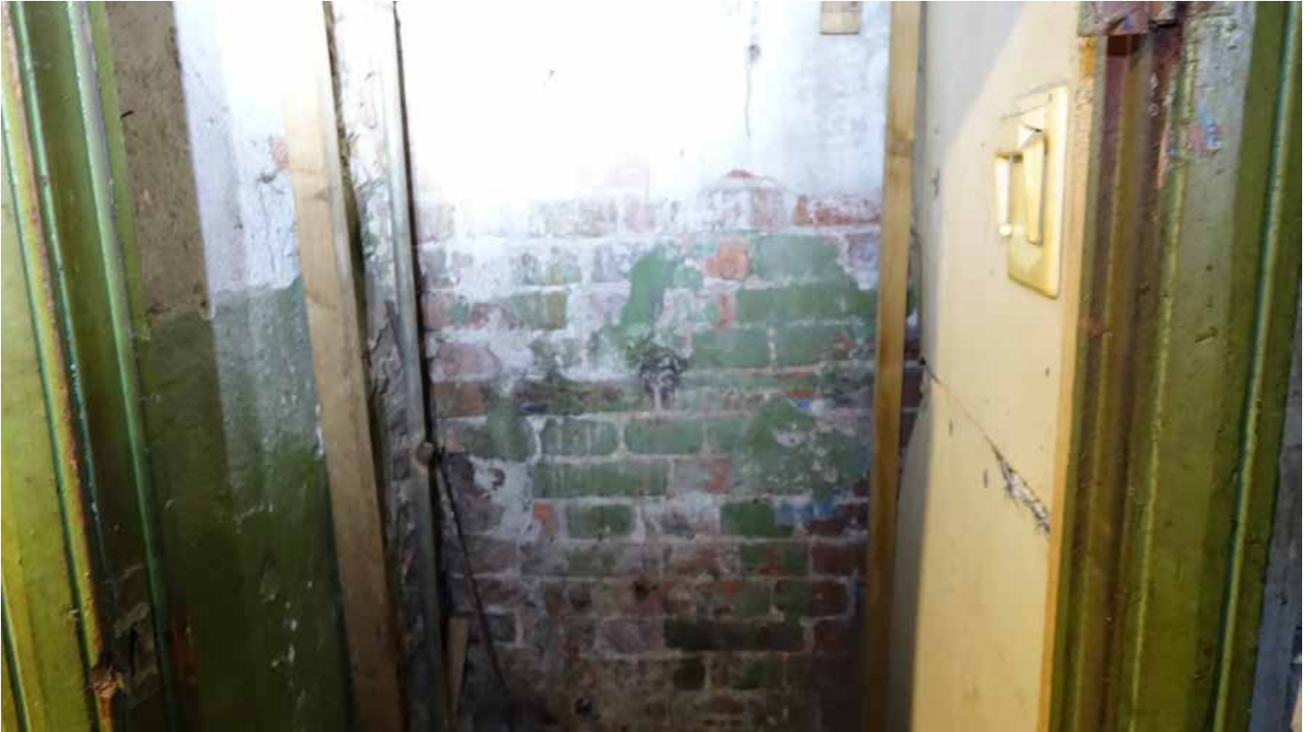
Фото 64. Помещение 32. Общий вид. Первый этаж. Дата фотофиксации: 01.03.24
