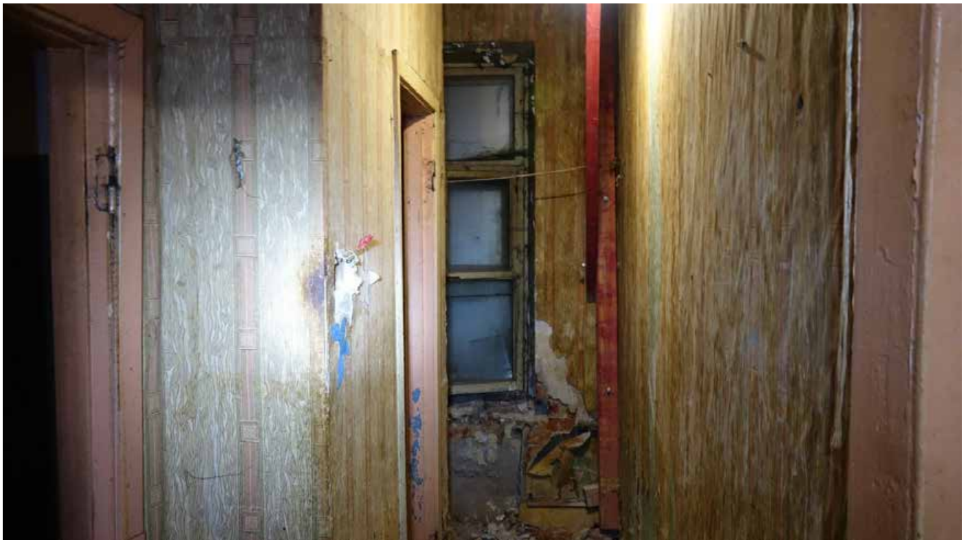
Фото 99. Помещение 5. Общий вид. Первый этаж. Дата фотофиксации: 01.03.24
