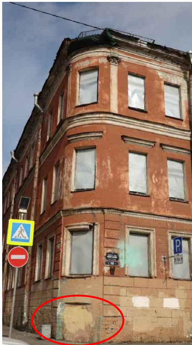
Фото 11. Вид на угловой объём и замурованный приямок со стороны наб. реки Фонтанки.
