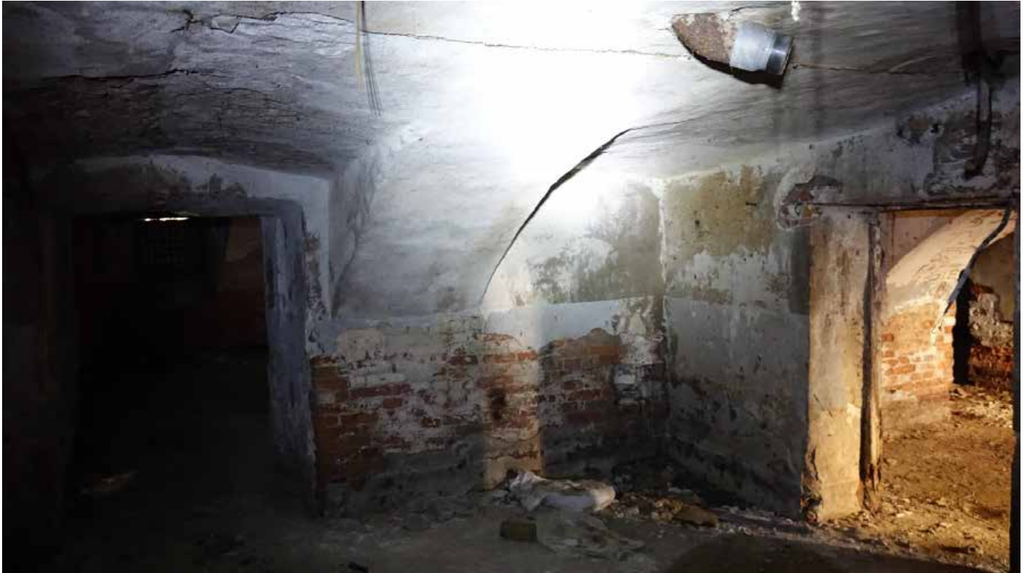
Фото 41. Помещение 6. Коробовый свод с распалубками. Цокольный этаж. Дата фотофиксации: 01.03.24
