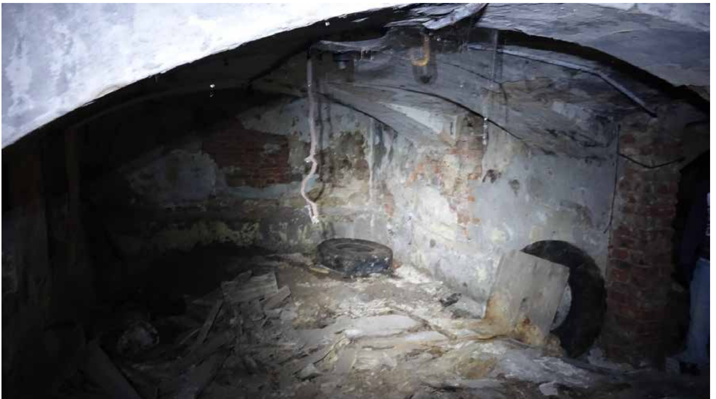
Фото 34. Помещения 148-149. Коробовый свод с распалубками. Цокольный этаж. Дата фотофиксации: 01.03.24
