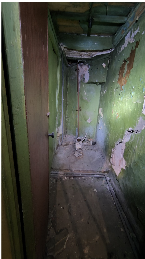
Фото 175. Помещение 82. Общий вид. Второй этаж. Дата фотофиксации: 01.03.24
