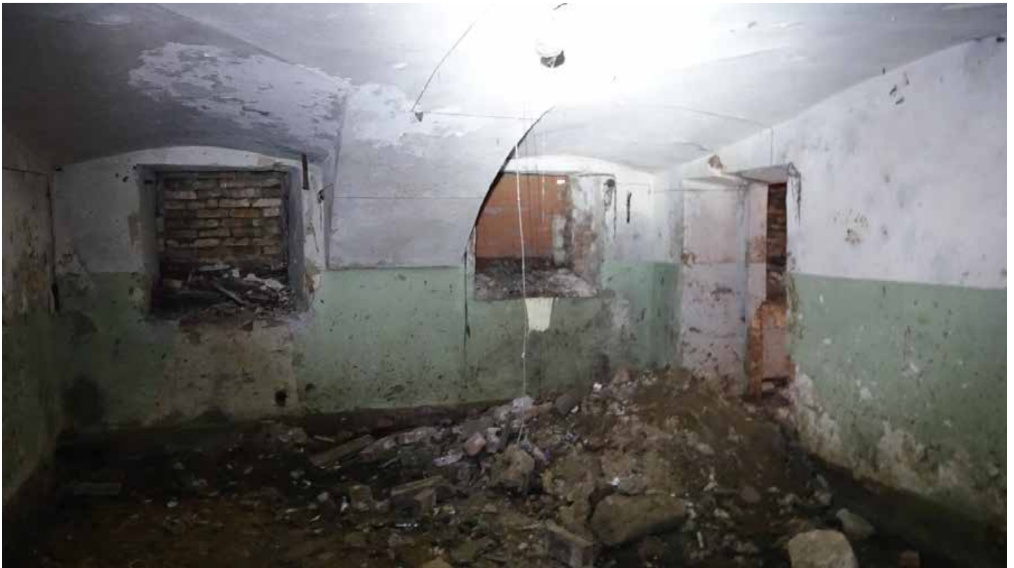
Фото 55. Помещение 2. Вид на оконные проемы цокольного этажа. Цокольный этаж. Дата фотофиксации: 01.03.24
