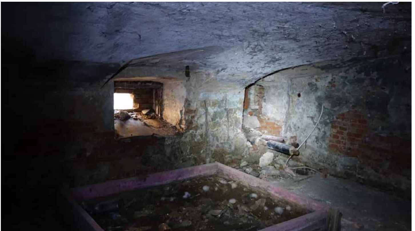
Фото 42. Помещение 8. Коробовый свод с распалубками, заложённый оконный проем. Цокольный этаж. Дата фотофиксации: 01.03.24
