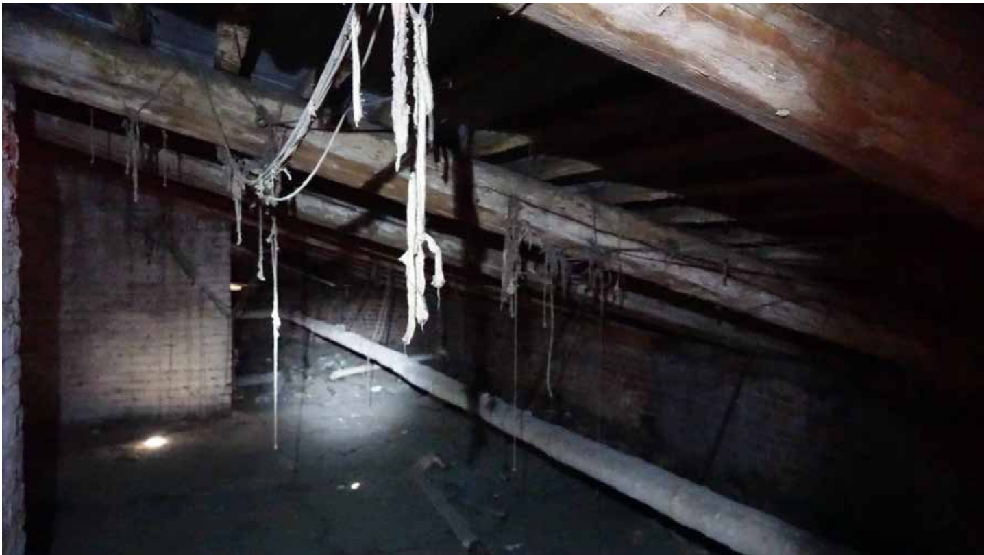
Фото 252. Мансарда. Фрагмент. Дата фотофиксации: 01.03.24
