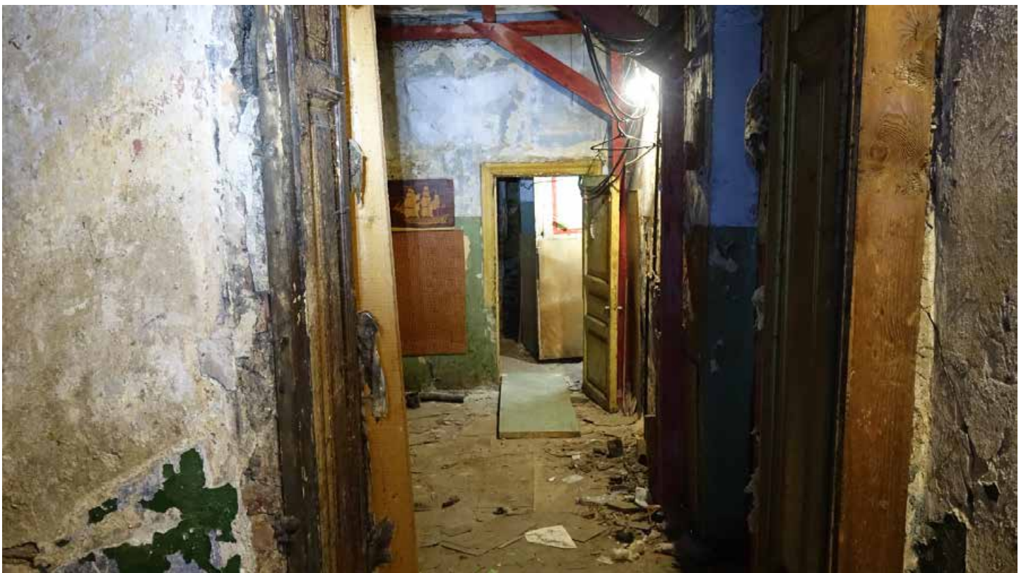
Фото 59. Проход между помещениями 25 и 22. Дверные панели тамбура. Первый этаж. Дата фотофиксации: 01.03.24
