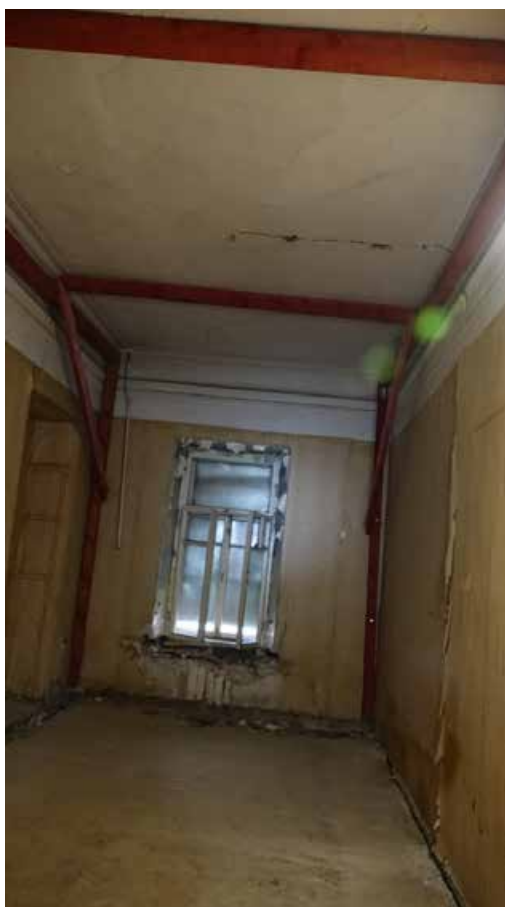
Фото 160. Помещение 71. Общий вид. Второй этаж. Дата фотофиксации: 01.03.24
