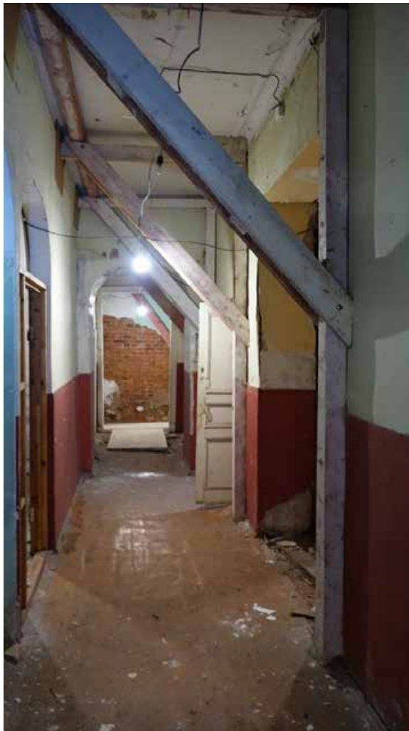
Фото 120. Помещение 35. Общий вид. Первый этаж. Дата фотофиксации: 01.03.24
