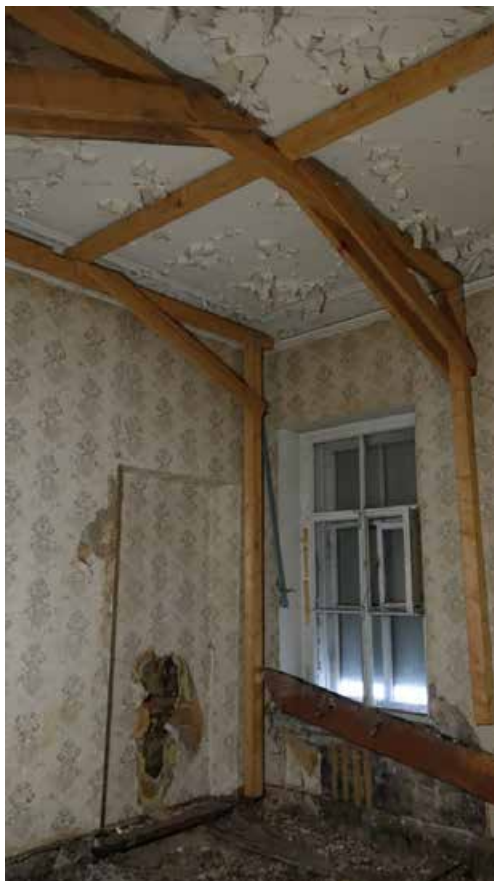
Фото 189. Помещение 91. Второй этаж. Дата фотофиксации: 01.03.24
