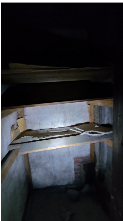
Фото 243. Помещение 7. Третий этаж. Дата фотофиксации: 01.03.24
