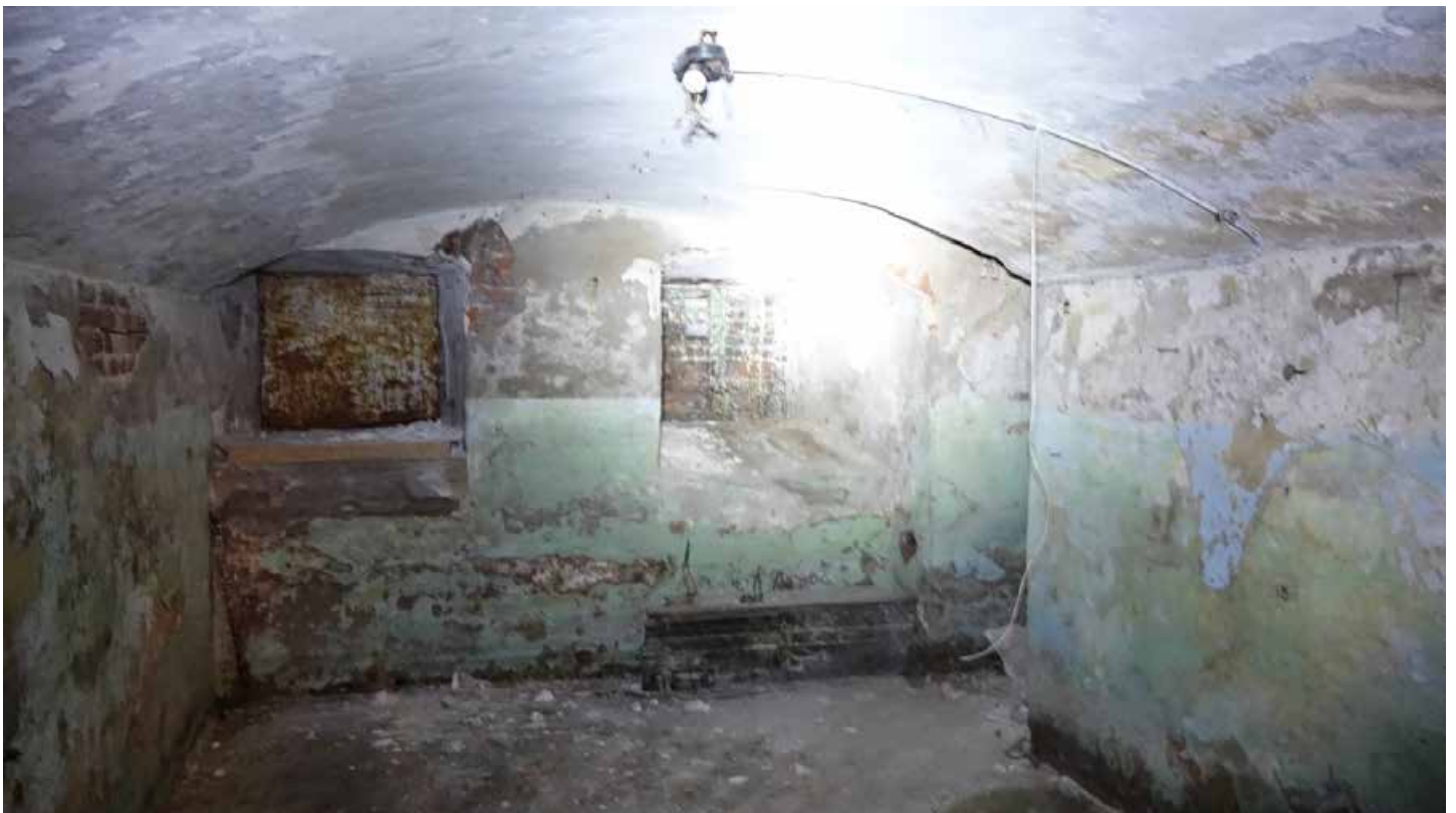
Фото 6. Помещение 152. Цилиндрический свод. Цокольный этаж. Вид на цокольные окна. Дата фотофиксации: 01.03.24
