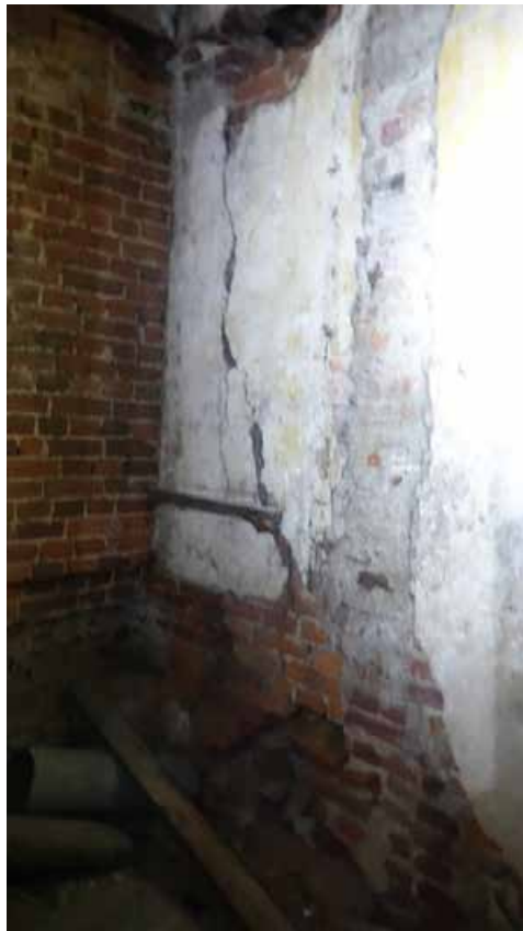
Фото 62. Помещение 26. Общий вид. Первый этаж. Дата фотофиксации: 01.03.24
