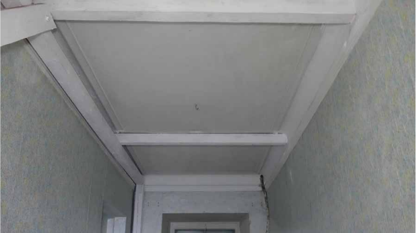
Фото 118. Помещение 41. Потолок. Первый этаж. Дата фотофиксации: 01.03.24
