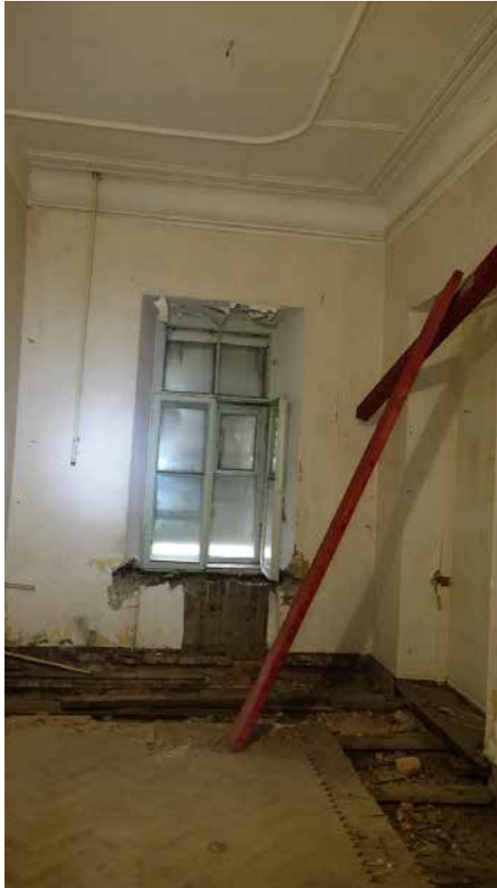
Фото 157. Помещение 66. Общий вид. Второй этаж. Дата фотофиксации: 01.03.24
