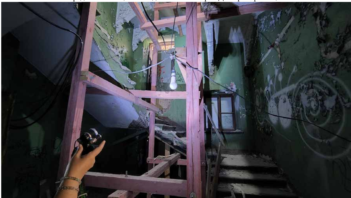
Фото 2. Парадная лестница Л1. Общий вид с лепными кронштейнами. Дата фотофиксации: 01.03.24
