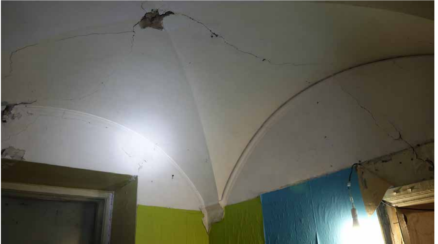
Фото 114. Помещение 36. Крестовый свод. Первый этаж. Дата фотофиксации: 01.03.24
