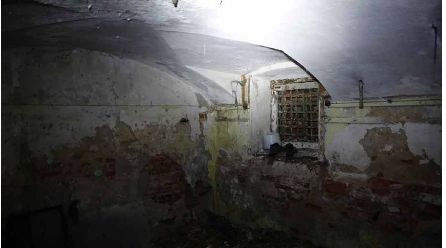
Фото 29. Помещение 146. Цокольное окно с решёткой из арматуры. Цокольный этаж. Дата фотофиксации: 01.03.24
