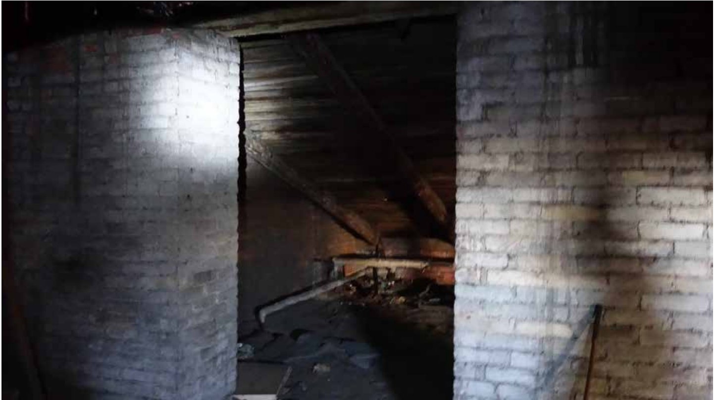
Фото 250. Кирпичные дымоходы. Фрагмент. Дата фотофиксации: 01.03.24
