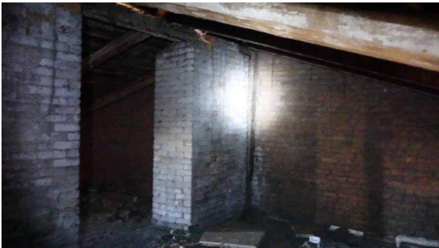
Фото 249. Кирпичные дымоходы, разделяющие основной объём мансарды. Общий вид. Дата фотофиксации: 01.03.24
