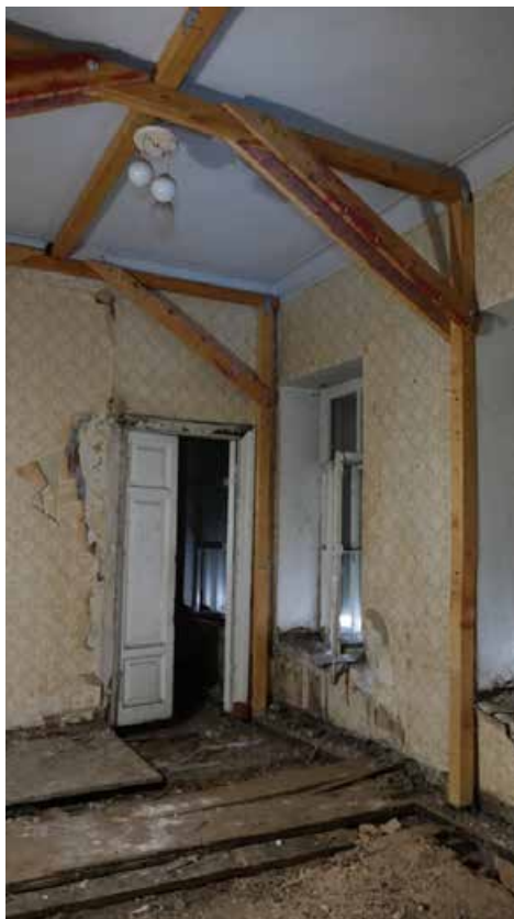
Фото 181. Помещение 87. Общий вид. Второй этаж. Дата фотофиксации: 01.03.24
