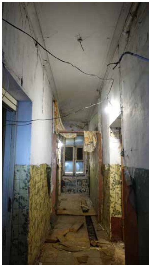
Фото 192. Помещение 98. Коридор. Третий этаж. Дата фотофиксации: 01.03.24
