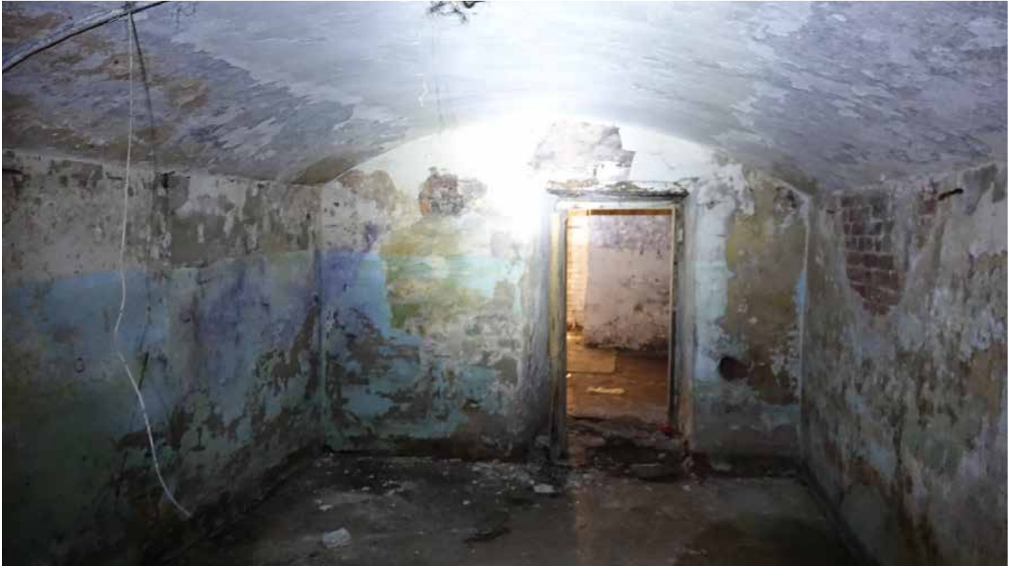
Фото 7. Помещение 152. Цилиндрический свод. Цокольный этаж. Дата фотофиксации: 01.03.24
