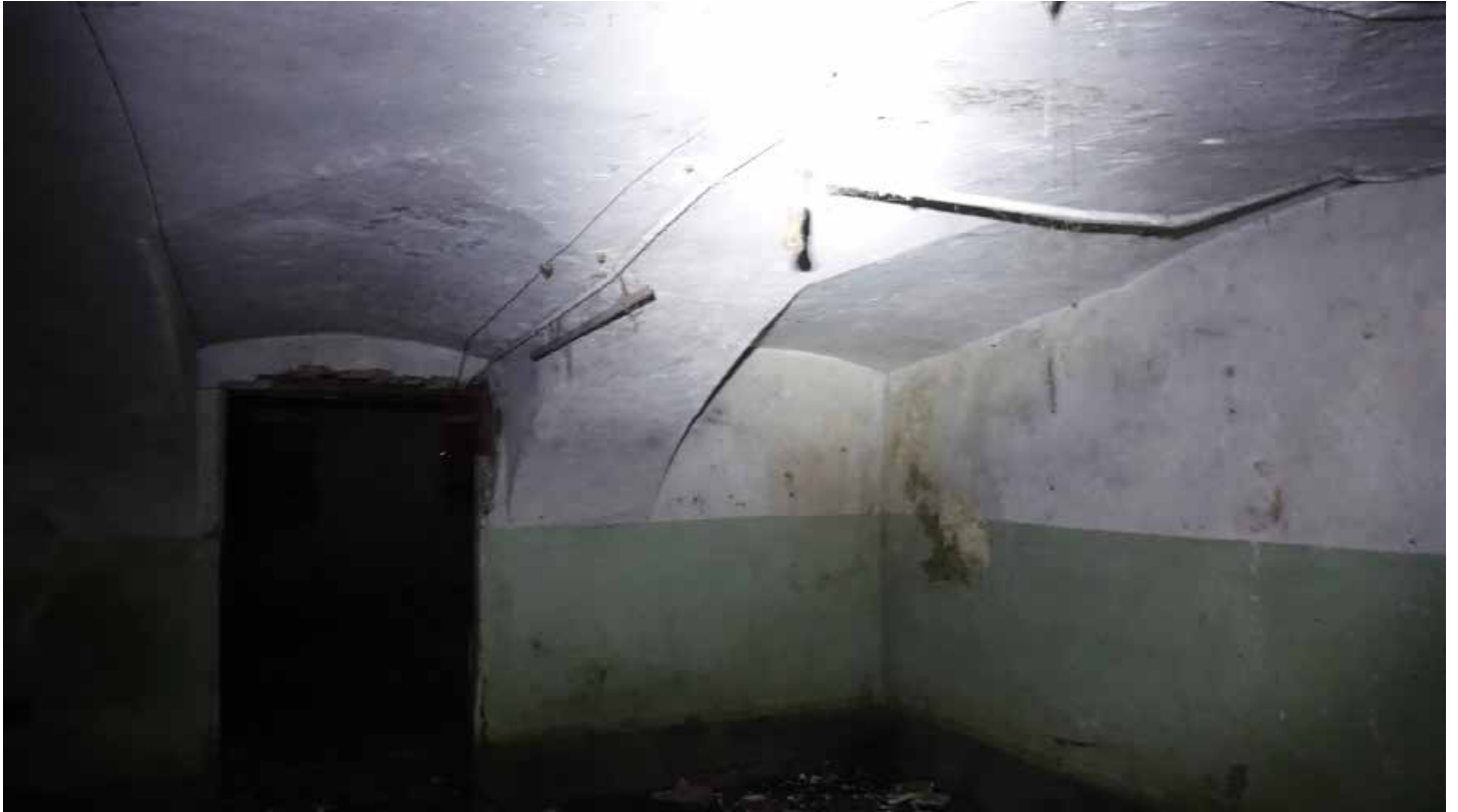
Фото 53. Помещение 3. Коробовый своды с распалубками. Цокольный этаж. Дата фотофиксации: 01.03.24
