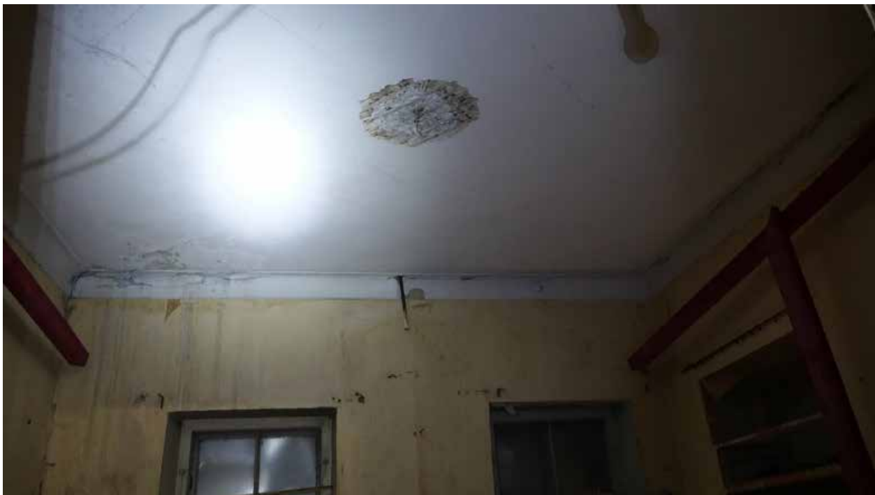
Фото 151. Помещение 60. Карниз советского образца. Второй этаж. Дата фотофиксации: 01.03.24
