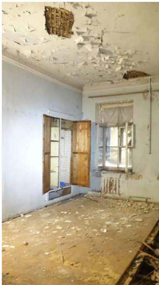
Фото 216. Помещение 122. Общий вид. Третий этаж. Дата фотофиксации: 01.03.24
