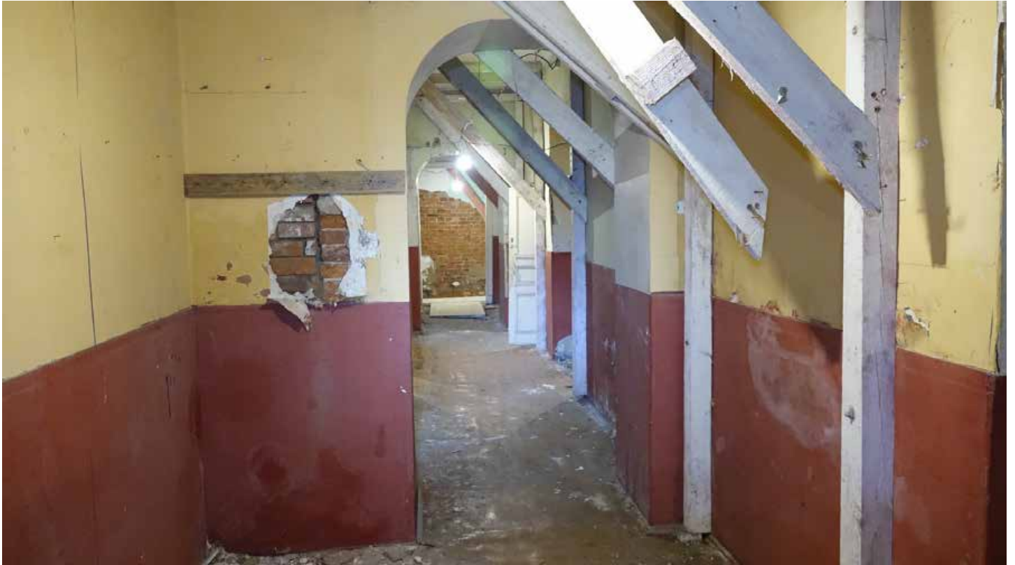
Фото 112. Коридор между помещениями 35 и 2. Общий вид. Первый этаж. Дата фотофиксации: 01.03.24
