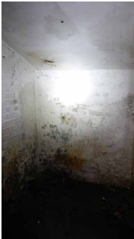
Фото 3. Помещение 155. Цокольный этаж. Дата фотофиксации: 01.03.24
