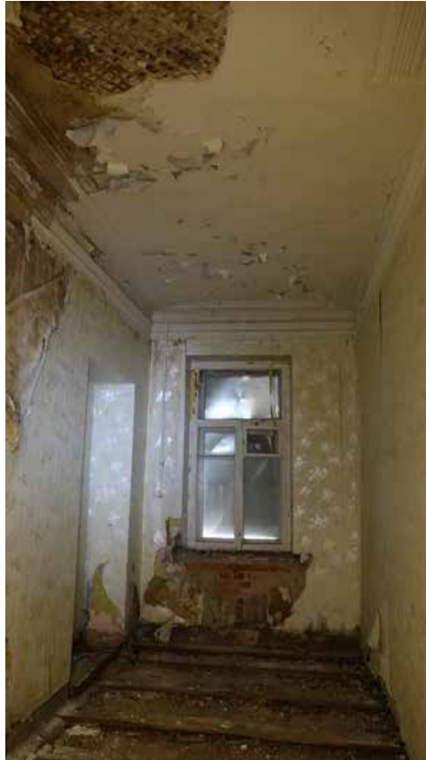
Фото 220. Помещение 126. Общий вид. Третий этаж. Дата фотофиксации: 01.03.24
