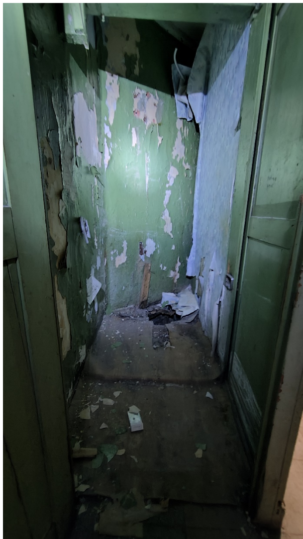
Фото 200. Помещение 110. Общий вид. Третий этаж. Дата фотофиксации: 01.03.24
