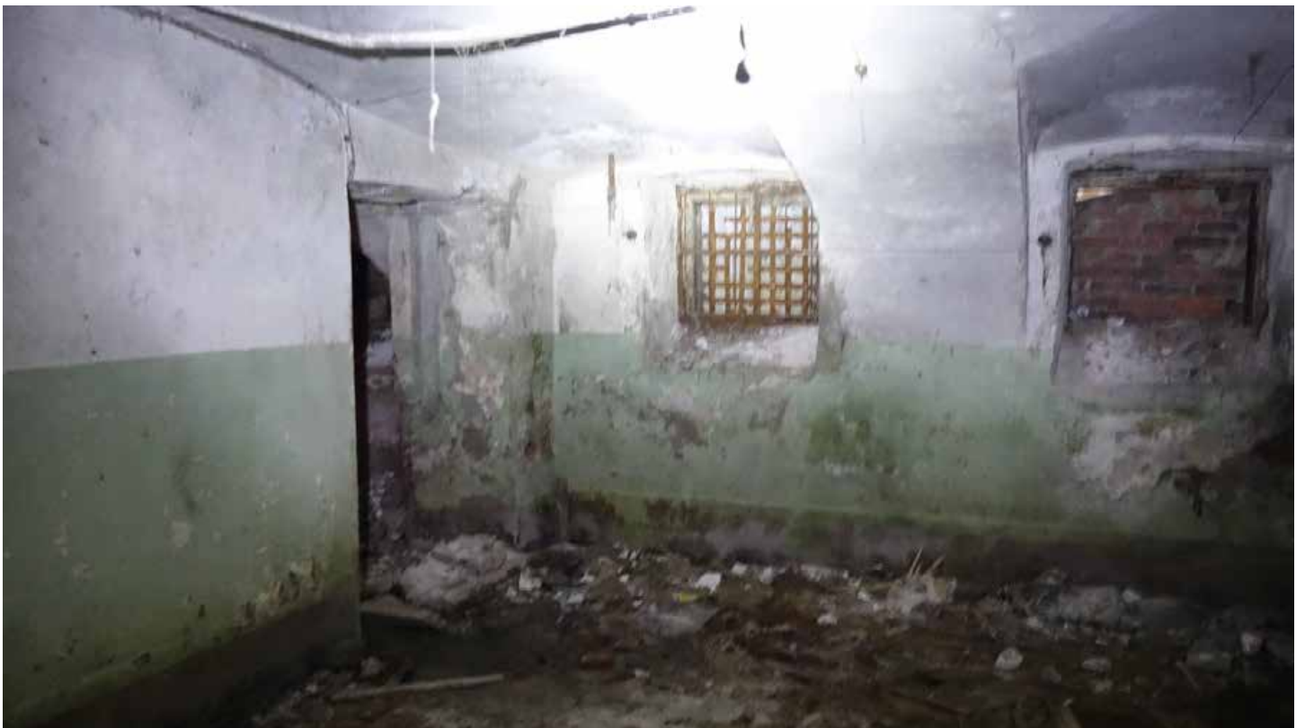
Фото 54. Помещение 3. Стены, фрагмент свода, оконные проемы. Цокольный этаж. Дата фотофиксации: 01.03.24
