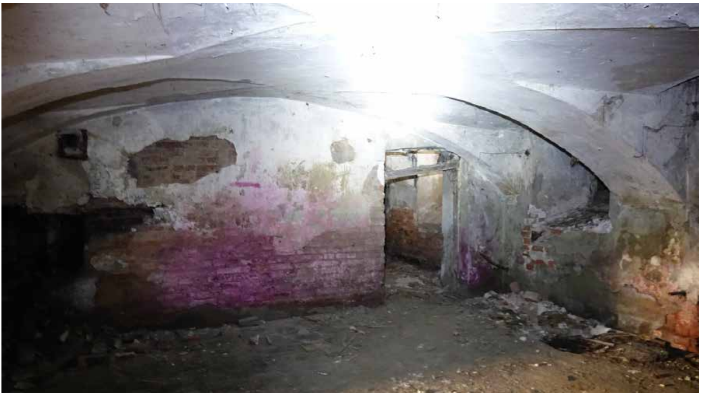
Фото 50. Помещение 4. Коробовый свод с распалубками. Цокольный этаж. Дата фотофиксации: 01.03.24
