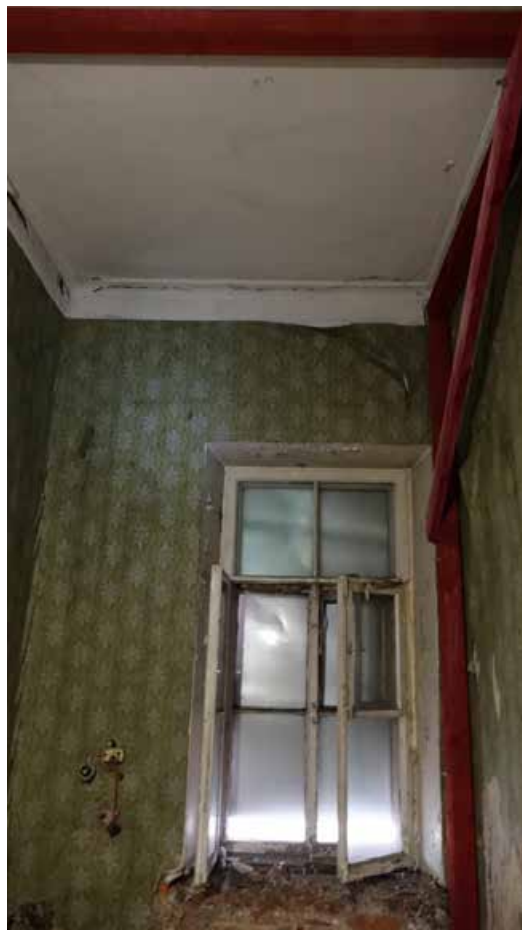
Фото 177. Помещение 83. Оконные заполнения. Второй этаж. Дата фотофиксации: 01.03.24
