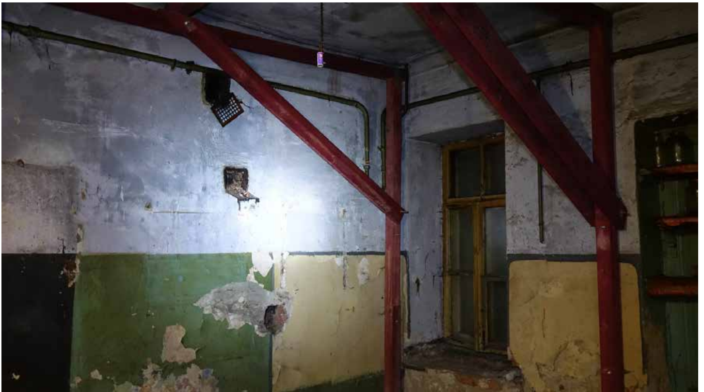
Фото 77. Помещение 22. Дымоход и вентиляционное отверстие. Первый этаж. Дата фотофиксации: 01.03.24
