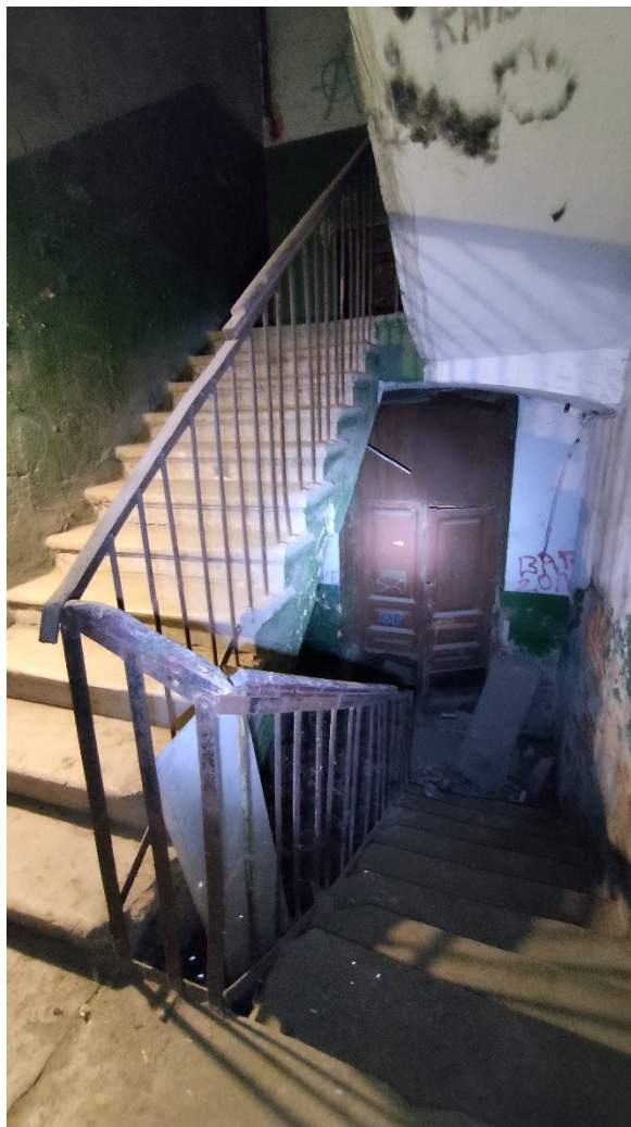
Фото 19. Службная лестница Л2. Вид на нижний лестничный марш. Дата фотофиксации: 01.03.24
