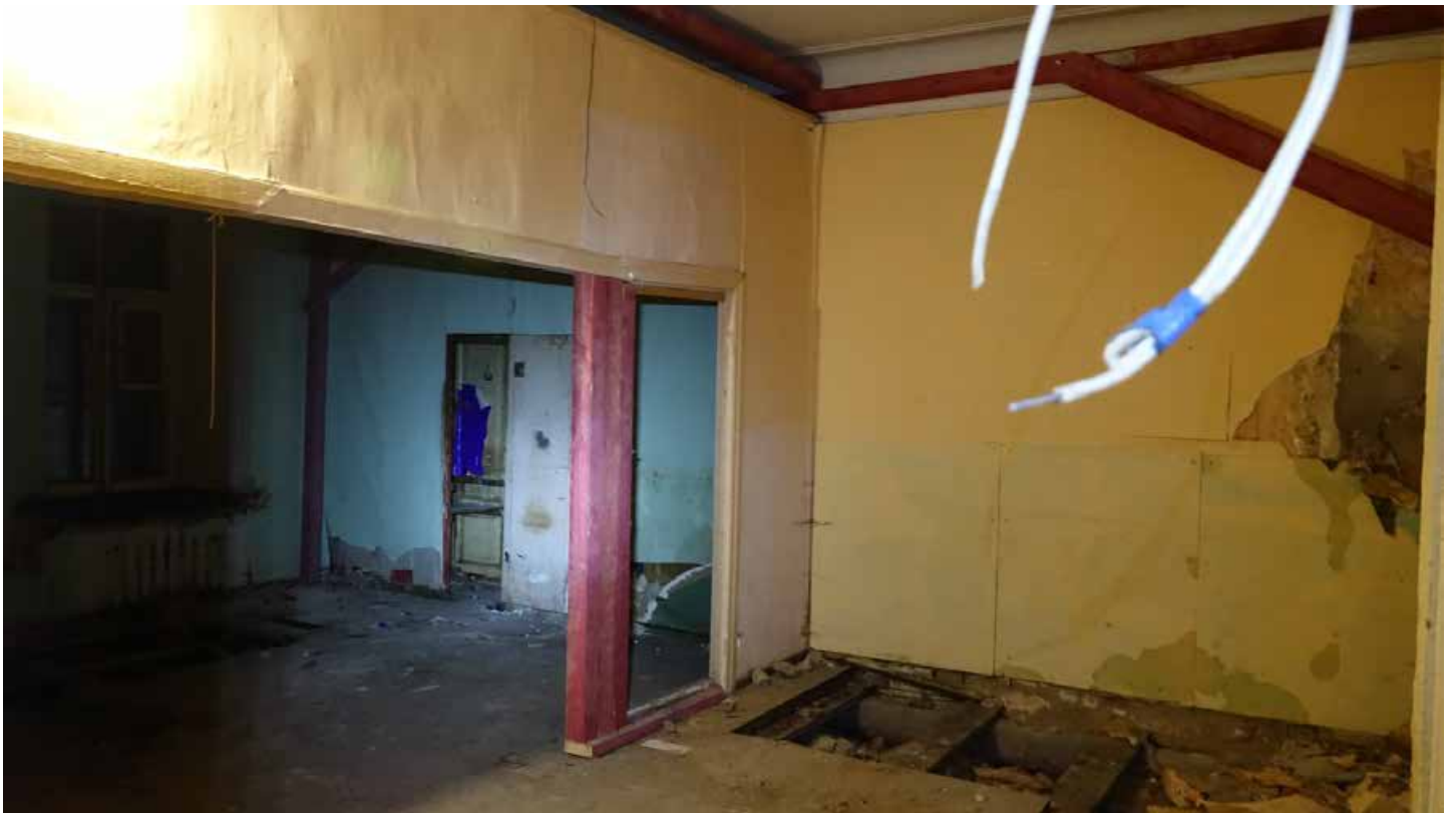
Фото 93. Помещение 13. Общий вид. Первый этаж. Дата фотофиксации: 01.03.24
