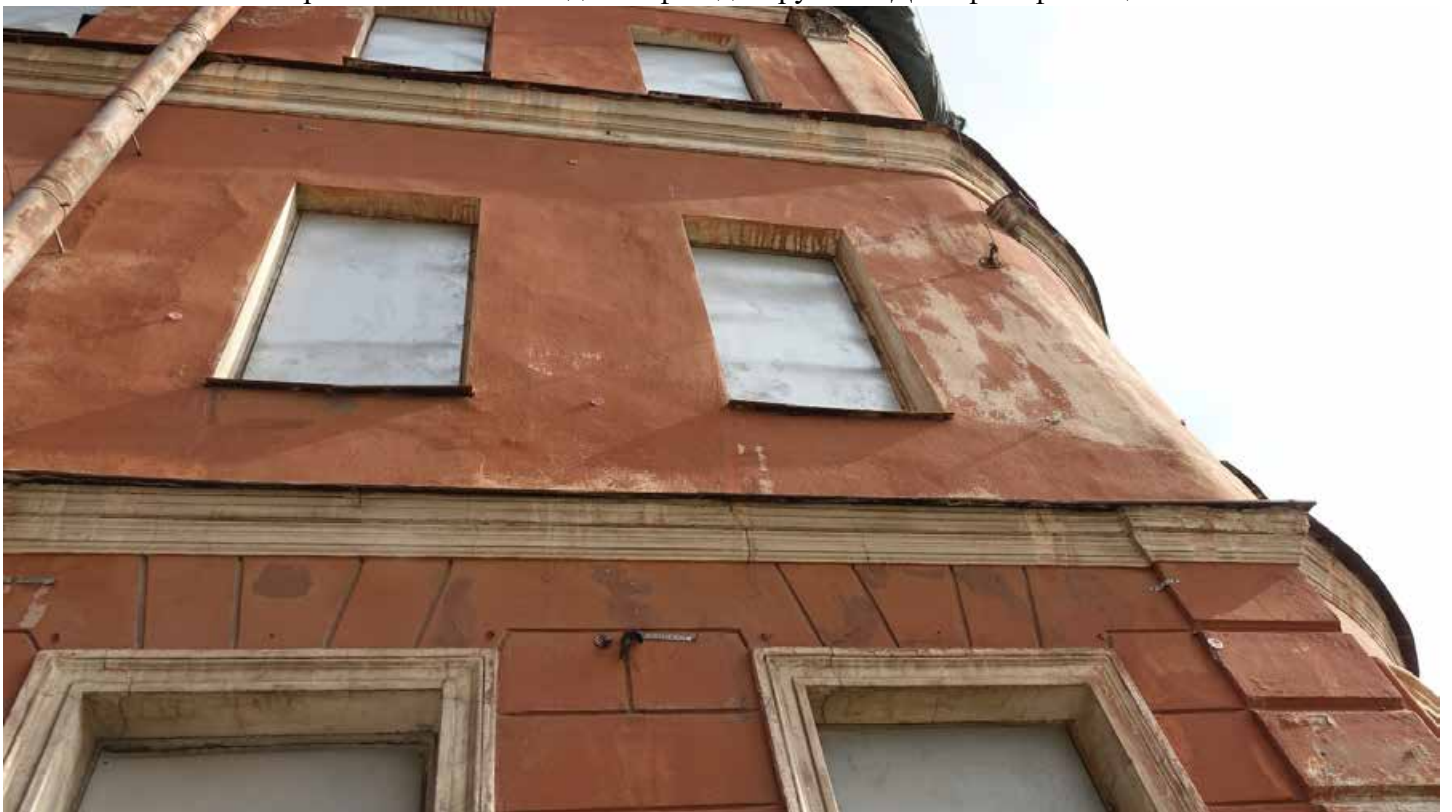
Фото 16. Западный фасад. Фрагмент. Профилированные междуэтажные карнизы.
