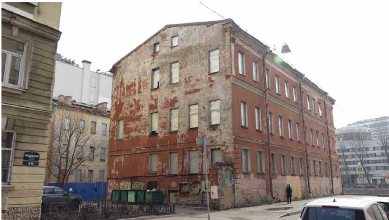
Фото 1. Западный фасад основного объёма дома. Общий вид. Дата фотофиксации: 01.03.24
