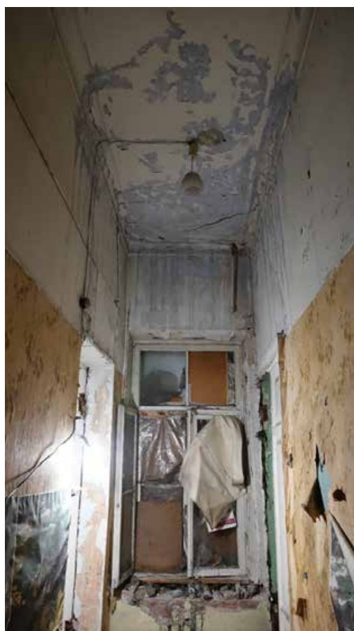
Фото 188. Помещение 90. Коридор. Второй этаж. Дата фотофиксации: 01.03.24
