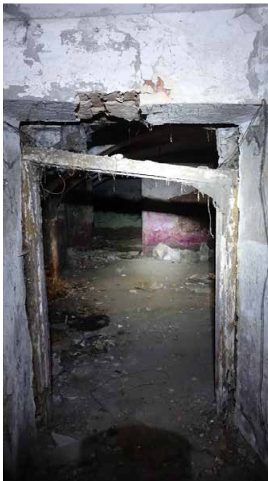
Фото 48. Проход между помещениями 5 и 4. Цокольный этаж. Дата фотофиксации: 01.03.24
