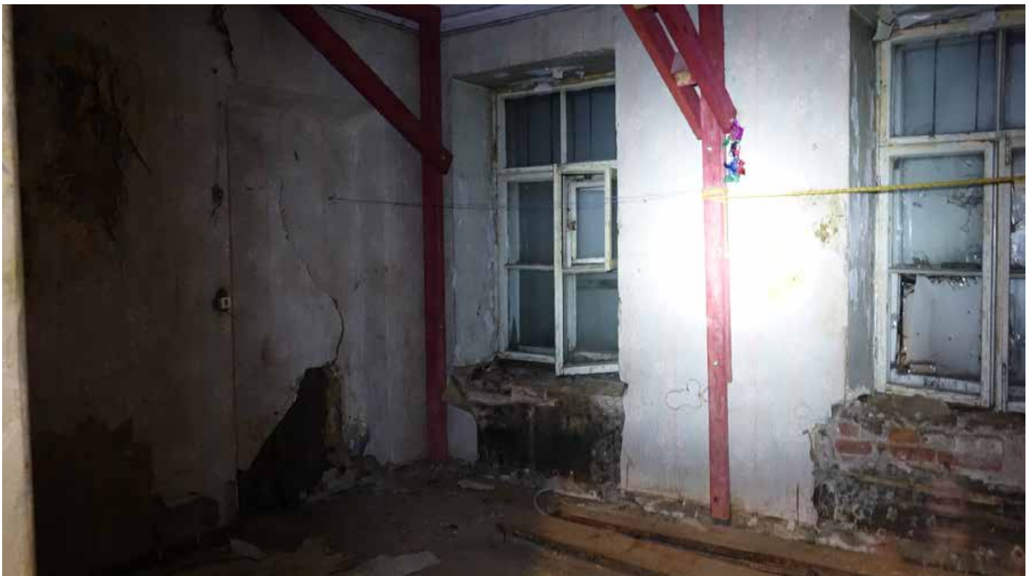
Фото 69. Помещение 30. Общий вид. Первый этаж. Дата фотофиксации: 01.03.24
