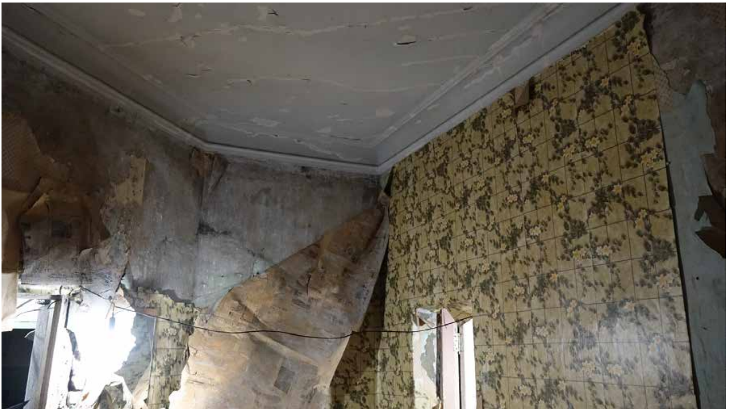
Фото 203. Проход между помещениями 109 и 111. Третий этаж. Дата фотофиксации: 01.03.24
