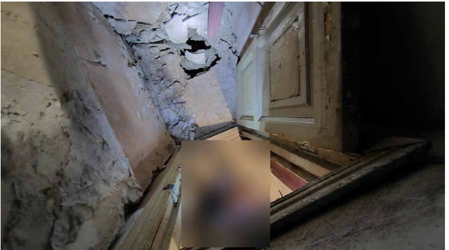
Фото 142. Помещение 55. Общий вид. Второй этаж. Дата фотофиксации: 01.03.24
