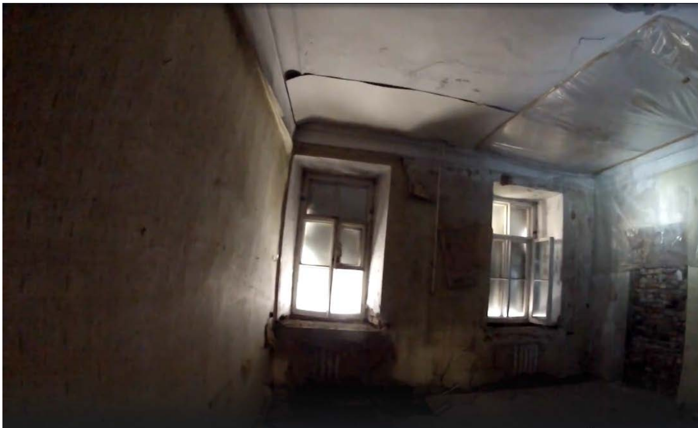
Фото 206. Помещение 114. Общий вид. Третий этаж. Дата фотофиксации: 01.03.24
