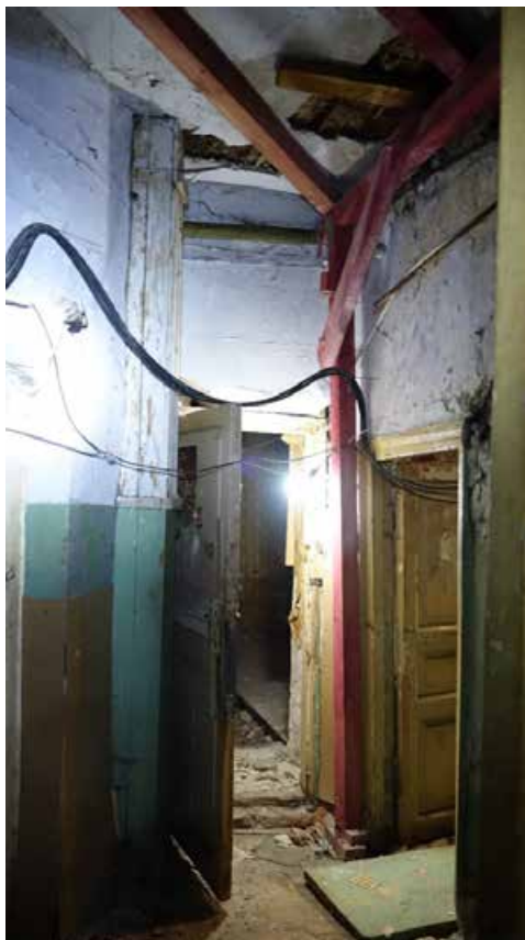
Фото 86. Помещение 17. Общий вид. Первый этаж. Дата фотофиксации: 01.03.24
