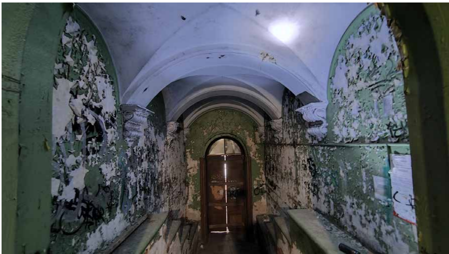
Фото 111. Парадный вестибюль. Своды и подпружные арки. Помещение 1. Общий вид. Дата фотофиксации: 01.03.24
