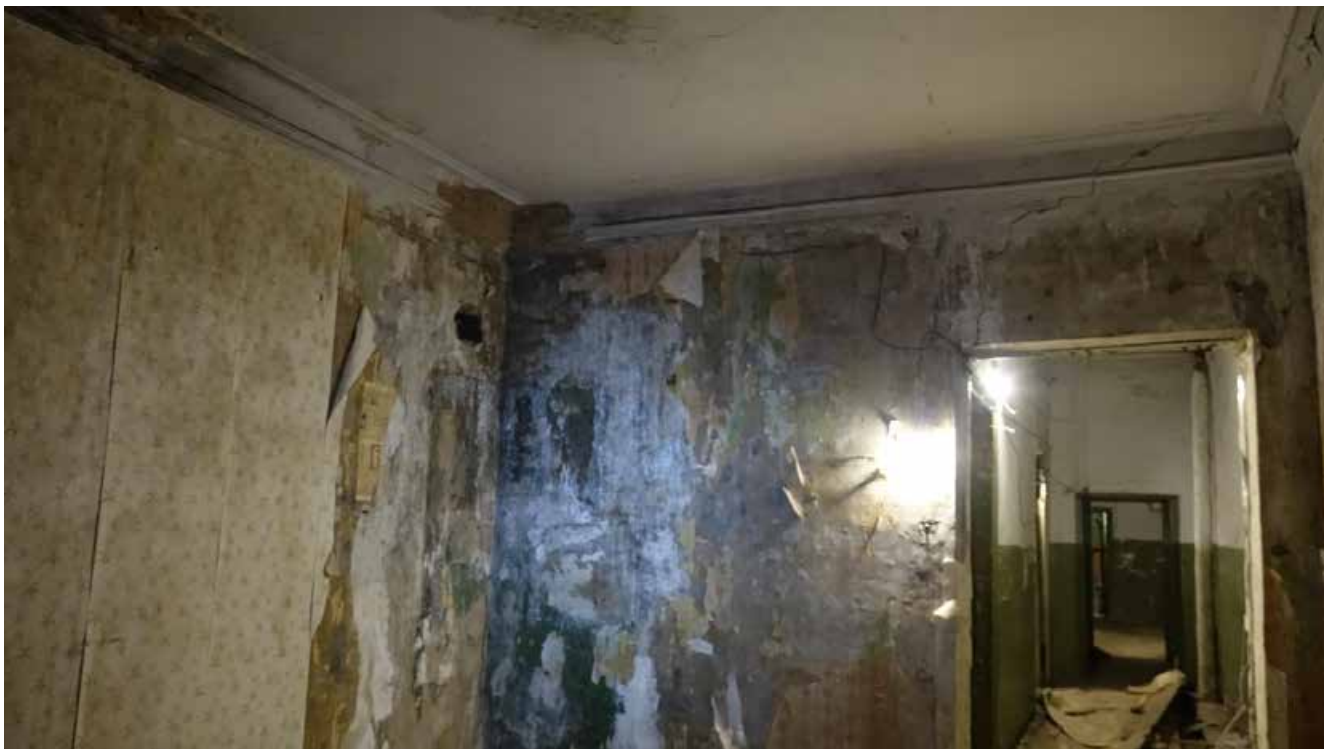
Фото 230. Помещение 133. Третий этаж. Дата фотофиксации: 01.03.24
