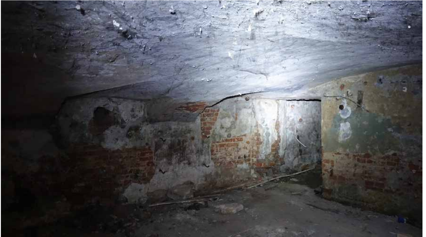
Фото 43. Помещение 8. Коробовый свод с распалубками. Фрагмент. Цокольный этаж. Дата фотофиксации: 01.03.24
