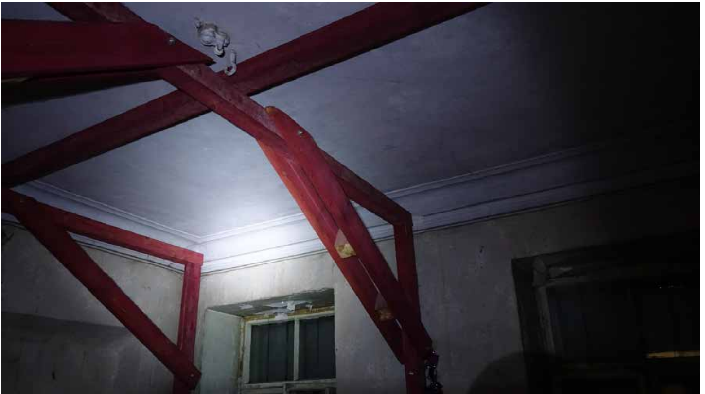
Фото 70. Помещение 30. Падуга и профилированный карниз советского времени. Первый этаж. Дата фотофиксации: 01.03.24
