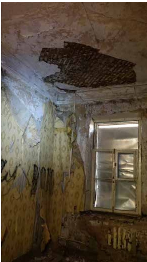
Фото 212. Помещение 119. Третий этаж. Дата фотофиксации: 01.03.24
