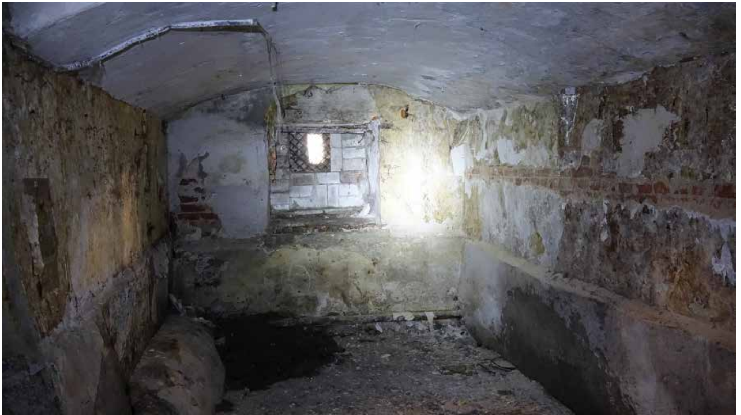
Фото 5. Помещение 157. Цилиндрический свод. Цокольный этаж. Вид на цокольное окно. Дата фотофиксации: 01.03.24
