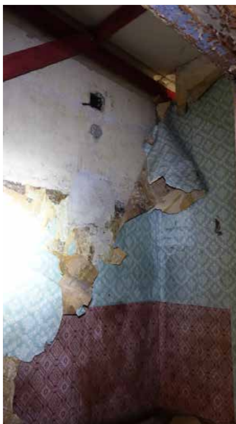
Фото 136. Помещение 48. Общий вид. Второй этаж. Дата фотофиксации: 01.03.24
