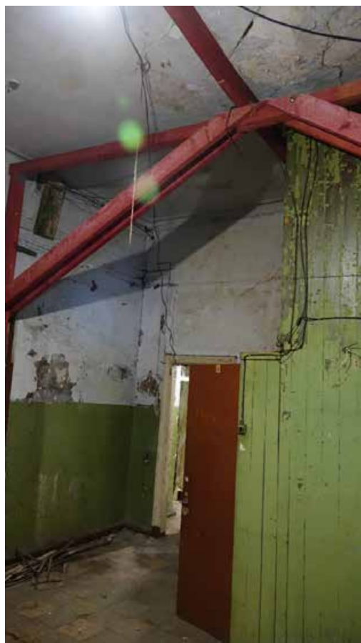
Фото 176. Помещение 80. Общий вид. Второй этаж. Дата фотофиксации: 01.03.24
