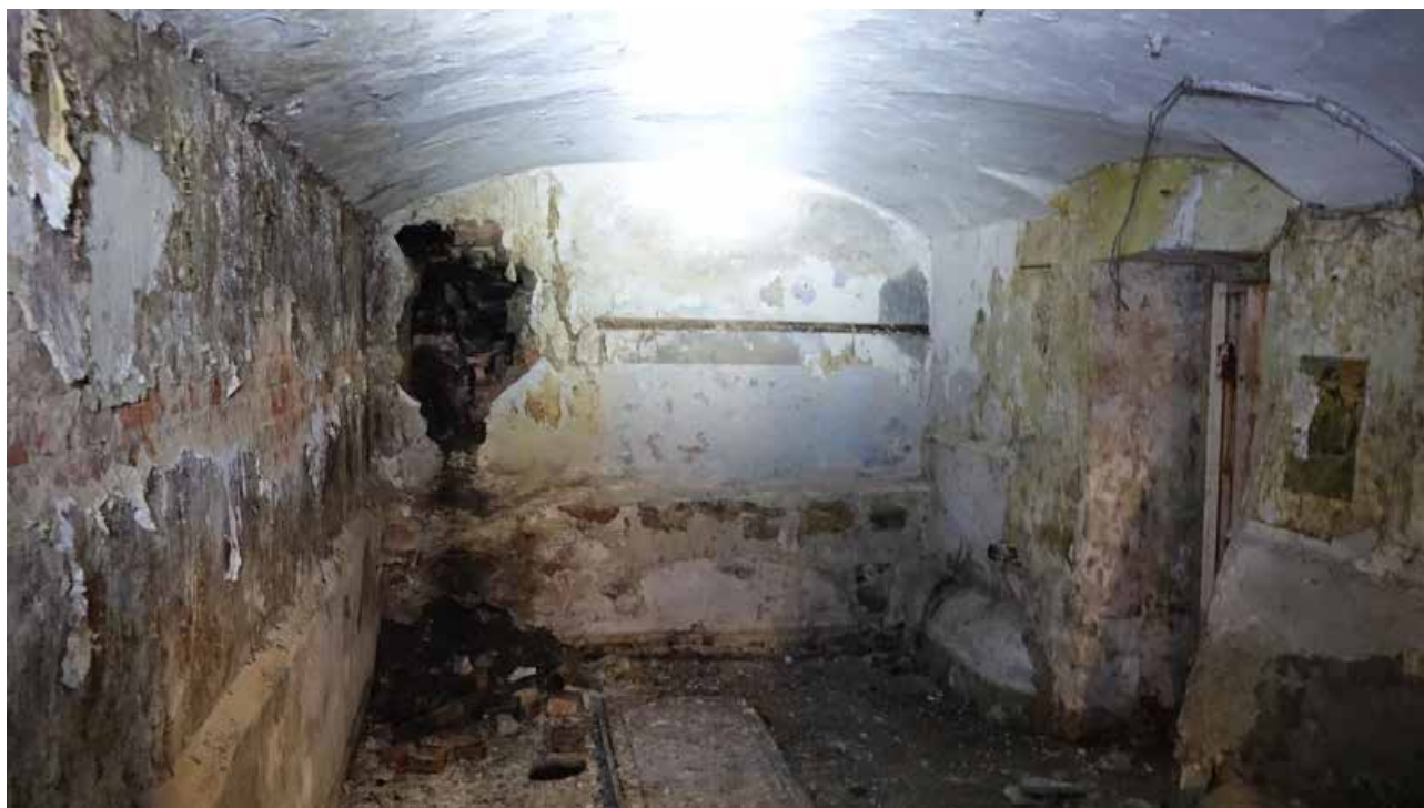
Фото 4. Помещение 157. Коробовый свод с распалубками. Цокольный этаж. Дата фотофиксации: 01.03.24
