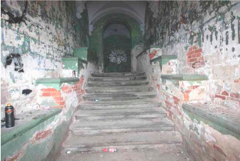
Фото 106. Помещение 1, гранитная лестница парадного вестибюля. Общий вид. Первый этаж. Дата фотофиксации: 01.03.24
