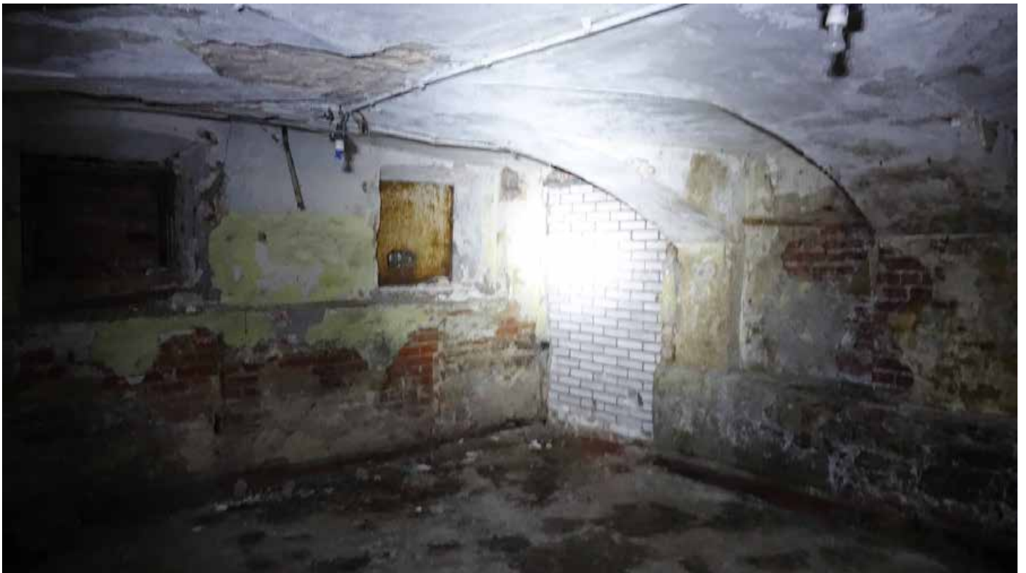
Фото 16. Помещение 150. Коробовый свод с распалубками. Цокольный этаж. Дата фотофиксации: 01.03.24
