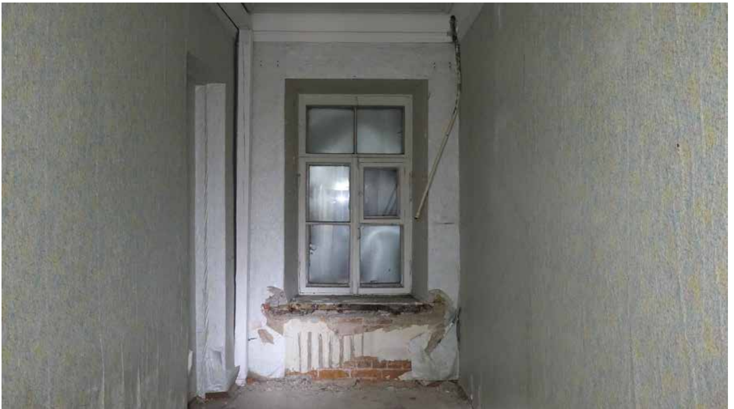
Фото 117. Помещение 41. Общий вид. Первый этаж. Дата фотофиксации: 01.03.24
