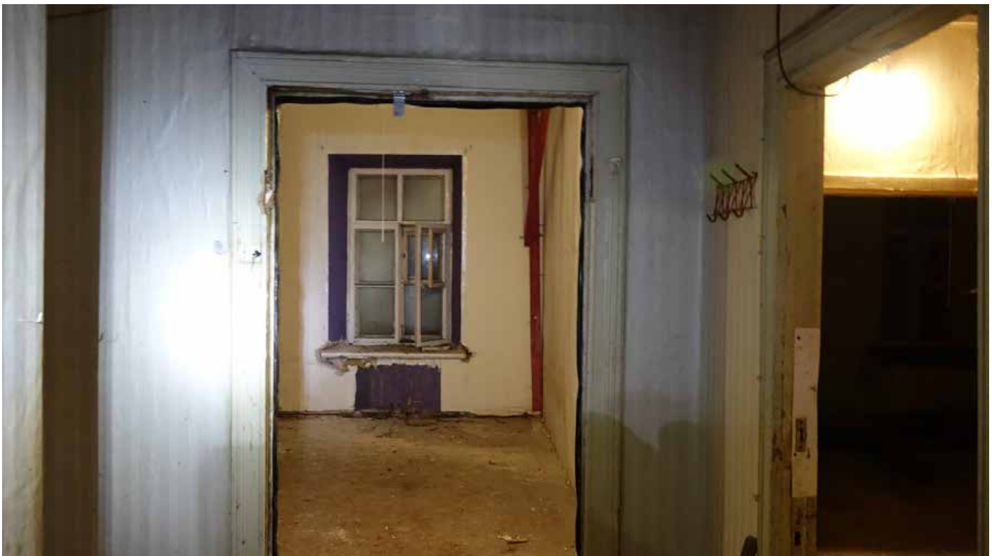
Фото 91. Помещение 9. Общий вид. Первый этаж. Дата фотофиксации: 01.03.24
