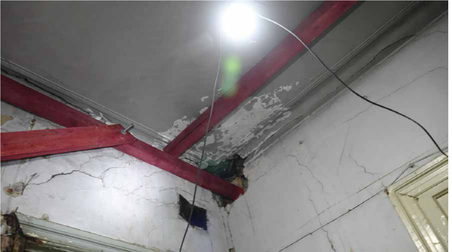
Фото 153. Помещение 63. Фрагмент. Второй этаж. Дата фотофиксации: 01.03.24
