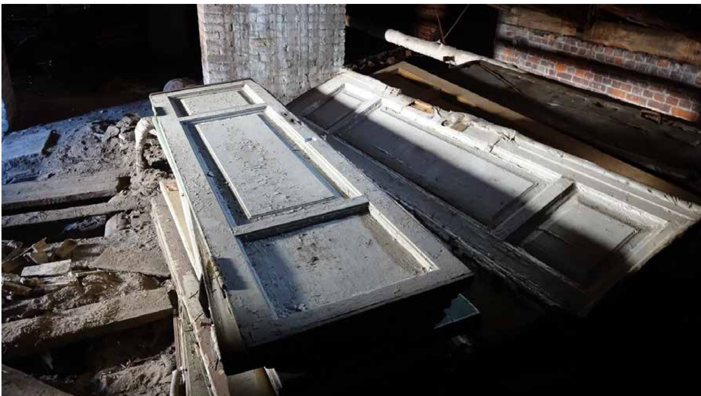
Фото 255. Демонтированные двери у входа в мансарду со стороны лестницы Л4. Дата фотофиксации: 01.03.24
