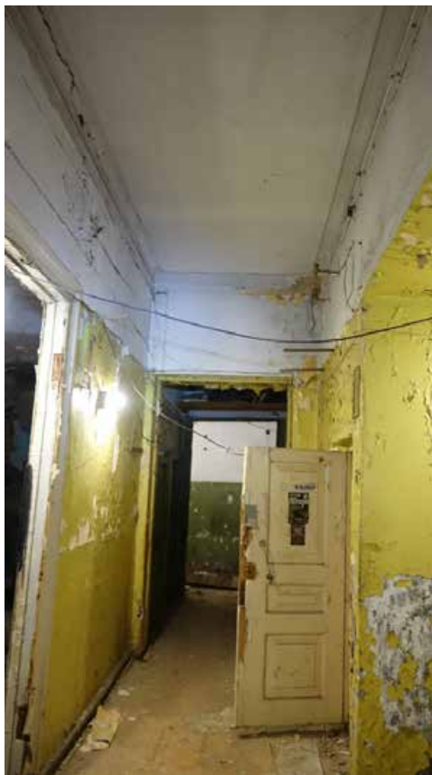
Фото 221. Коридор. Продолжение помещения 124. Третий этаж. Дата фотофиксации: 01.03.24
