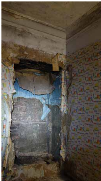
Фото 226. Помещение 130. Ниша в стене. Третий этаж. Дата фотофиксации: 01.03.24
