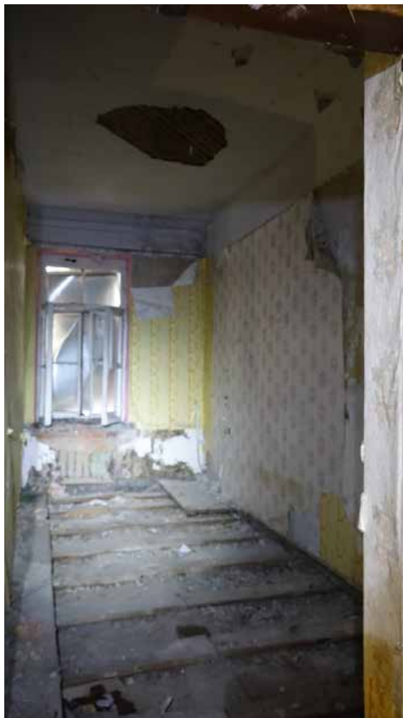
Фото 218. Помещение 125. Общий вид. Третий этаж. Дата фотофиксации: 01.03.24
