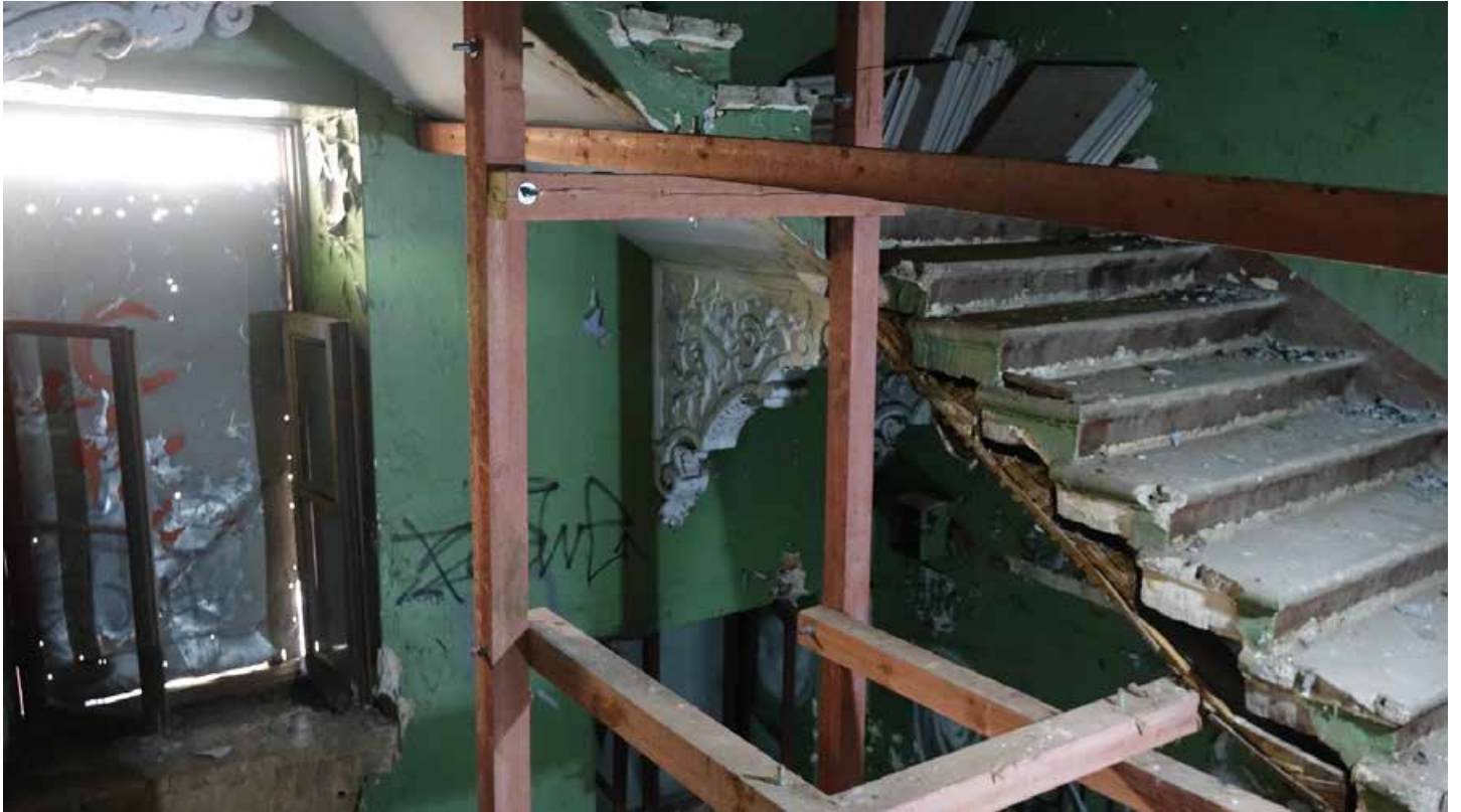
Фото 5. Лестница Л1. Фрагмент с кронштейном. Дата фотофиксации: 01.03.24
