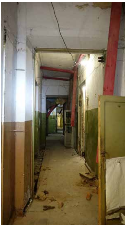
Фото 140. Помещение 56. Коридор центрального объема. Второй этаж. Дата фотофиксации: 01.03.24
