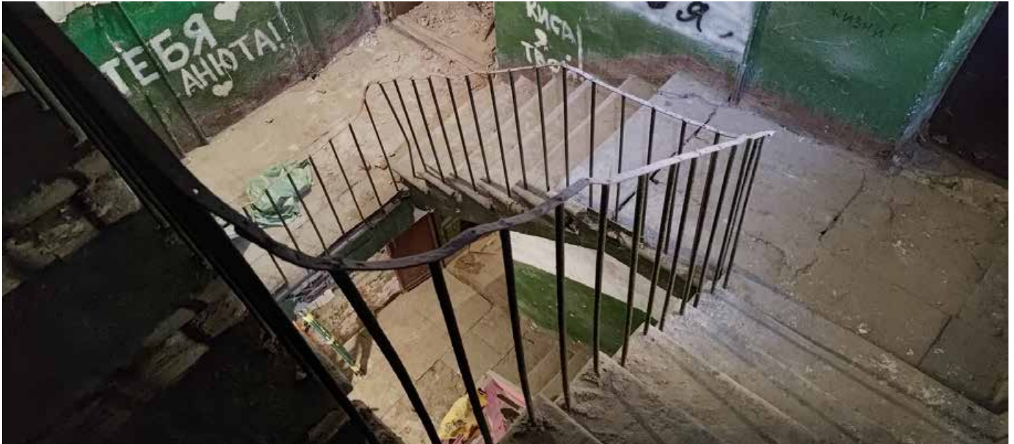
Фото 14. Лестница Л4. Площадка 2-го этажа. Дата фотофиксации: 01.03.24
