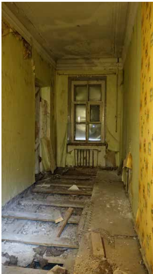
Фото 228. Помещение 132. Общий вид. Третий этаж. Дата фотофиксации: 01.03.24
