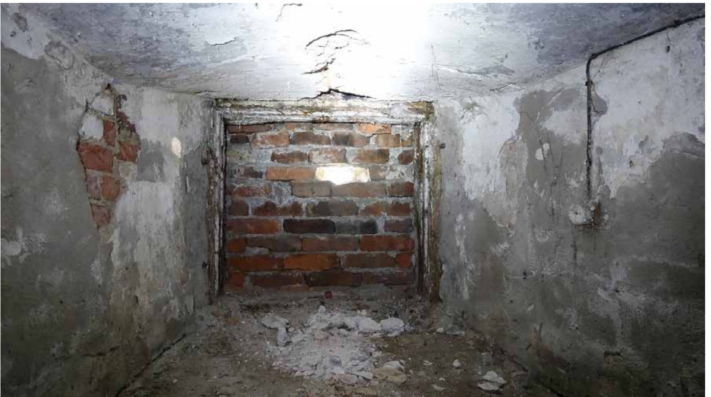
Фото 10. Помещение 151. Цокольный этаж. Вид на заложный оконный проем цокольного этажа. Дата фотофиксации: 01.03.24
