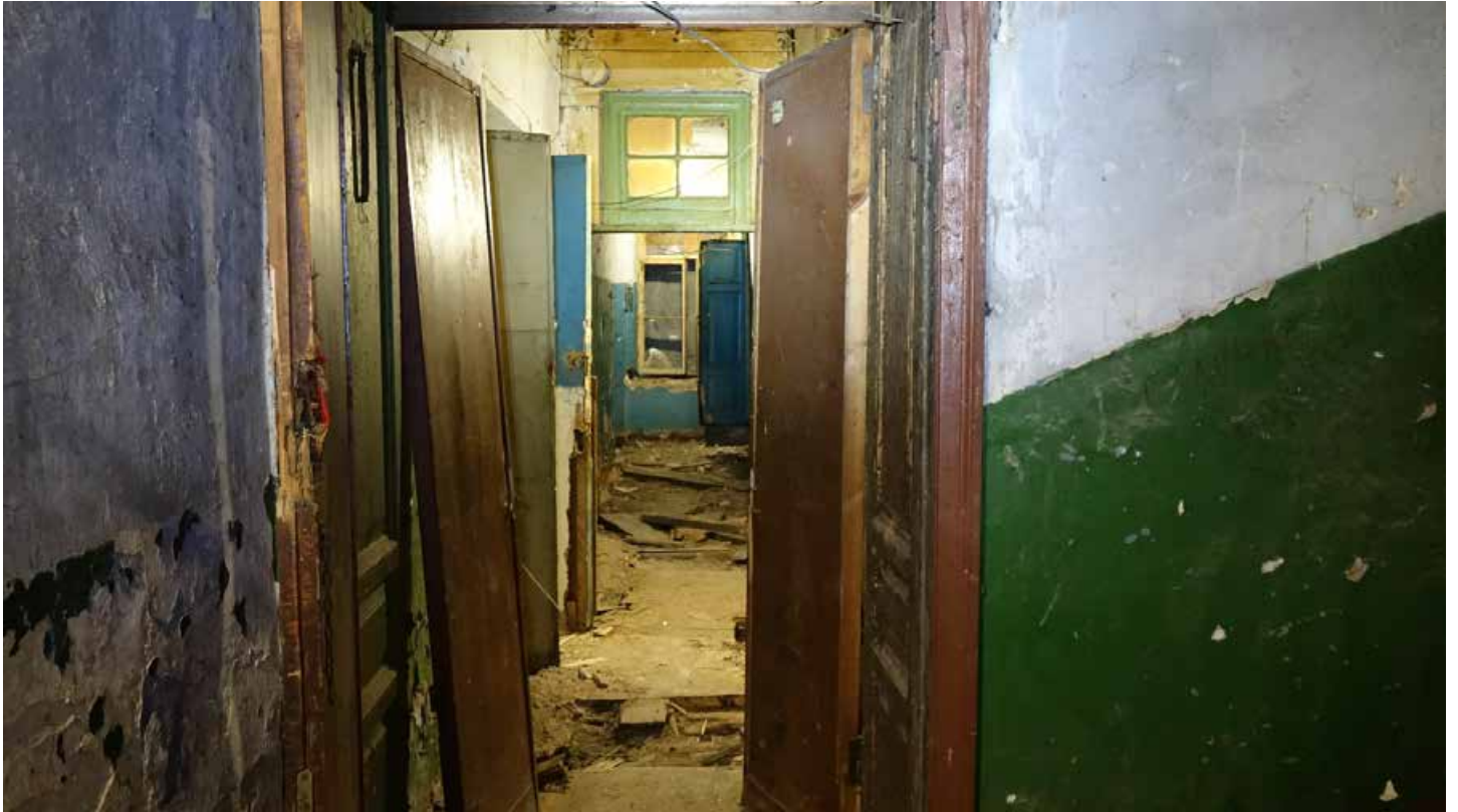
Фото 60. Проход между помещениями 25 и 27. Дверные панели тамбура. Первый этаж. Дата фотофиксации: 01.03.24
