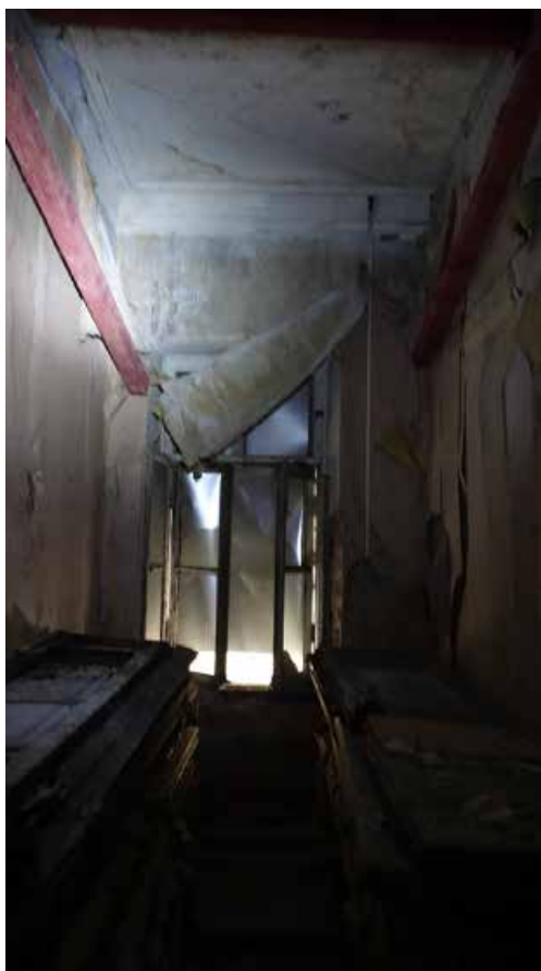
Фото 150. Помещение 61. Общий вид. Второй этаж. Дата фотофиксации: 01.03.24
