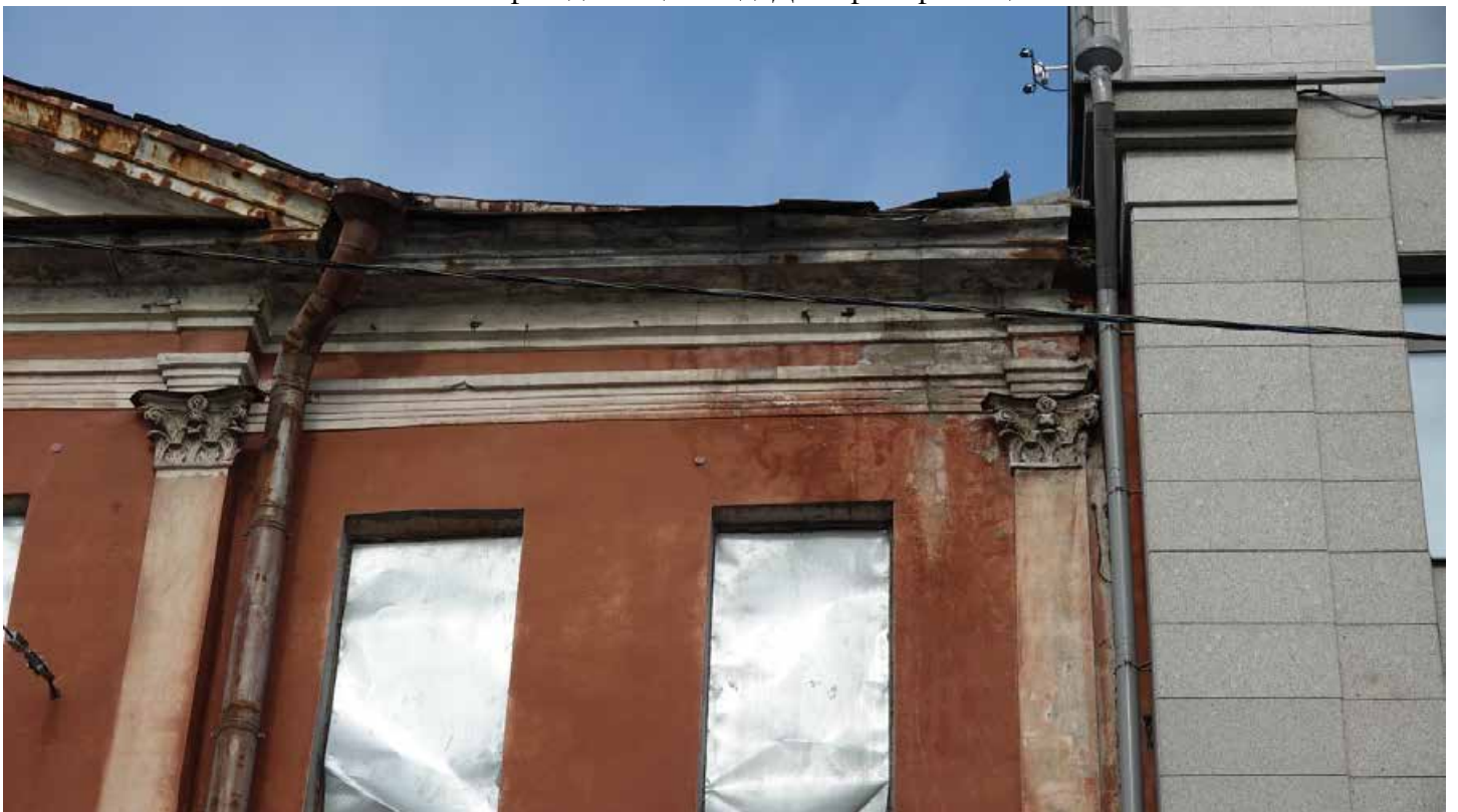
Фото 6. Фрагменты пилястр композитного ордера и карнизов южного фасада. Дата фотофиксации: 01.03.24
