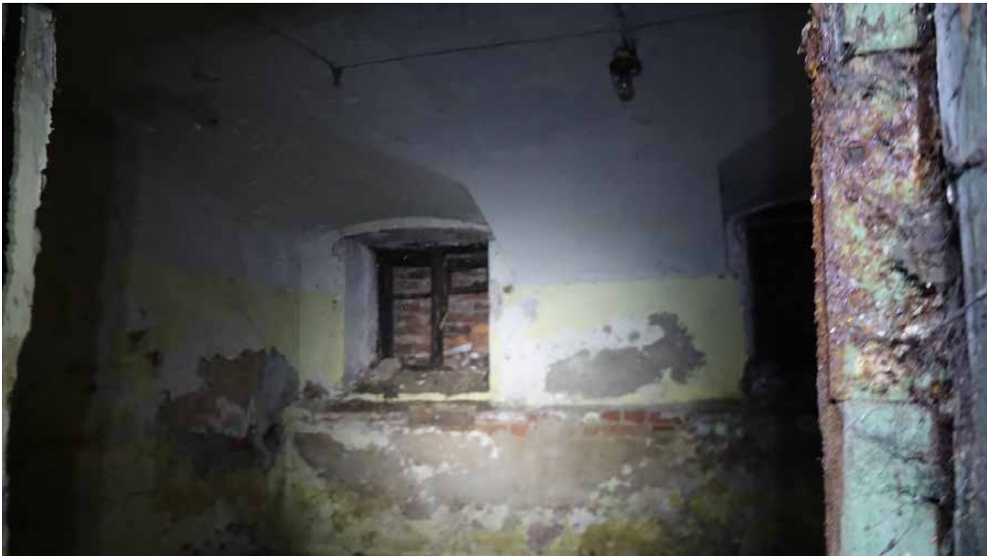
Фото 25. Помещение 145. Вид на оконные проемы цокольного этажа в распалубках. Дата фотофиксации: 01.03.24
