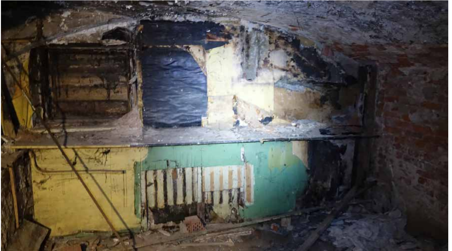
Фото 68. Помещение 143. Цилиндрический свод. Цокольный этаж. Дата фотофиксации: 01.03.24
