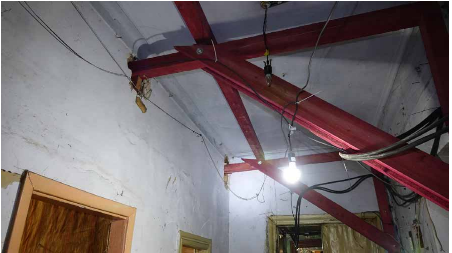
Фото 90. Помещение 4. Падуга потолка советского времени. Первый этаж. Дата фотофиксации: 01.03.24
