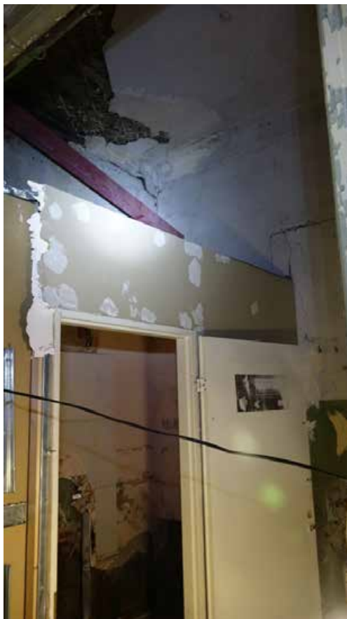
Фото 137. Помещение 52. Общий вид. Второй этаж. Дата фотофиксации: 01.03.24
