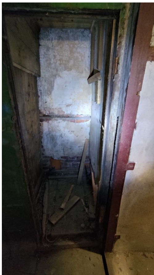
Фото 131. Помещение 3 со стороны лестницы Л2. Общий вид. Первый этаж. Дата фотофиксации: 01.03.24
