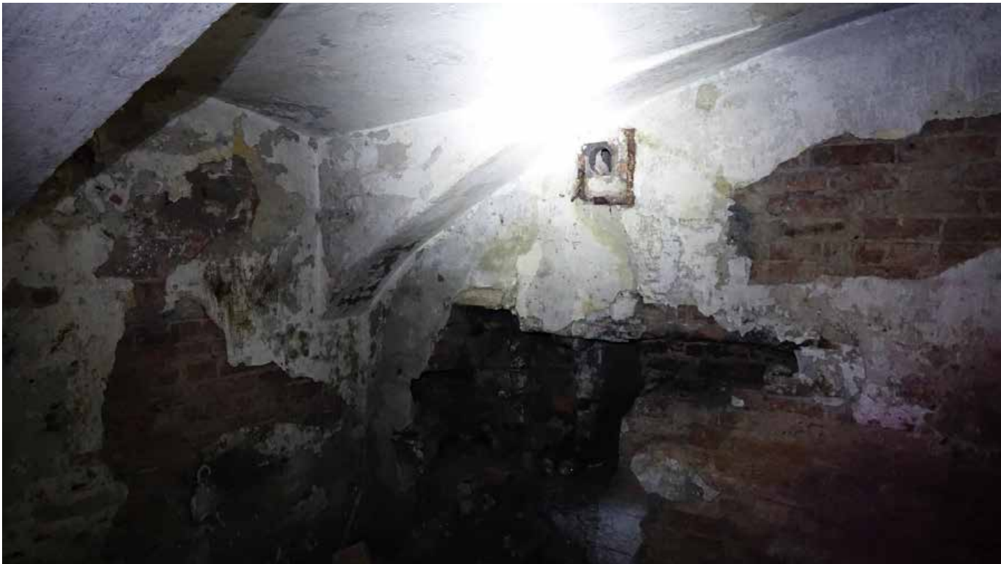
Фото 51. Помещение 4. Фрагмент стены и свода. Цокольный этаж. Дата фотофиксации: 01.03.24
