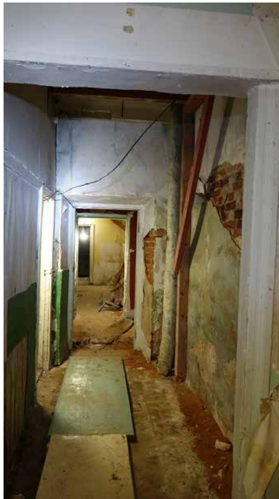
Фото 123. Коридор между помещениями 42 и 45. Общий вид. Первый этаж. Дата фотофиксации: 01.03.24
