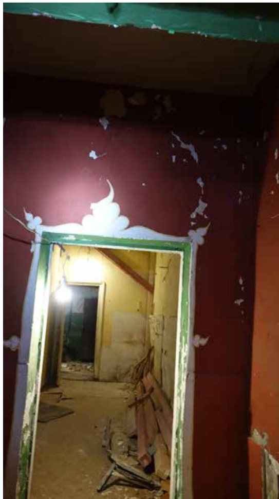
Фото 125. Коридор между помещениями 42 и 45. Фрагмент. Первый этаж. Дата фотофиксации: 01.03.24
