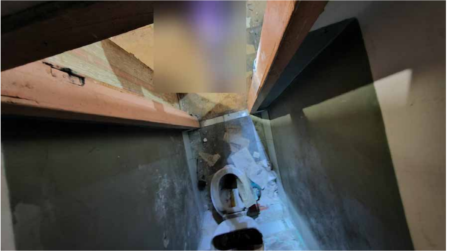
Фото 100. Помещение 6. Общий вид. Первый этаж. Дата фотофиксации: 01.03.24
