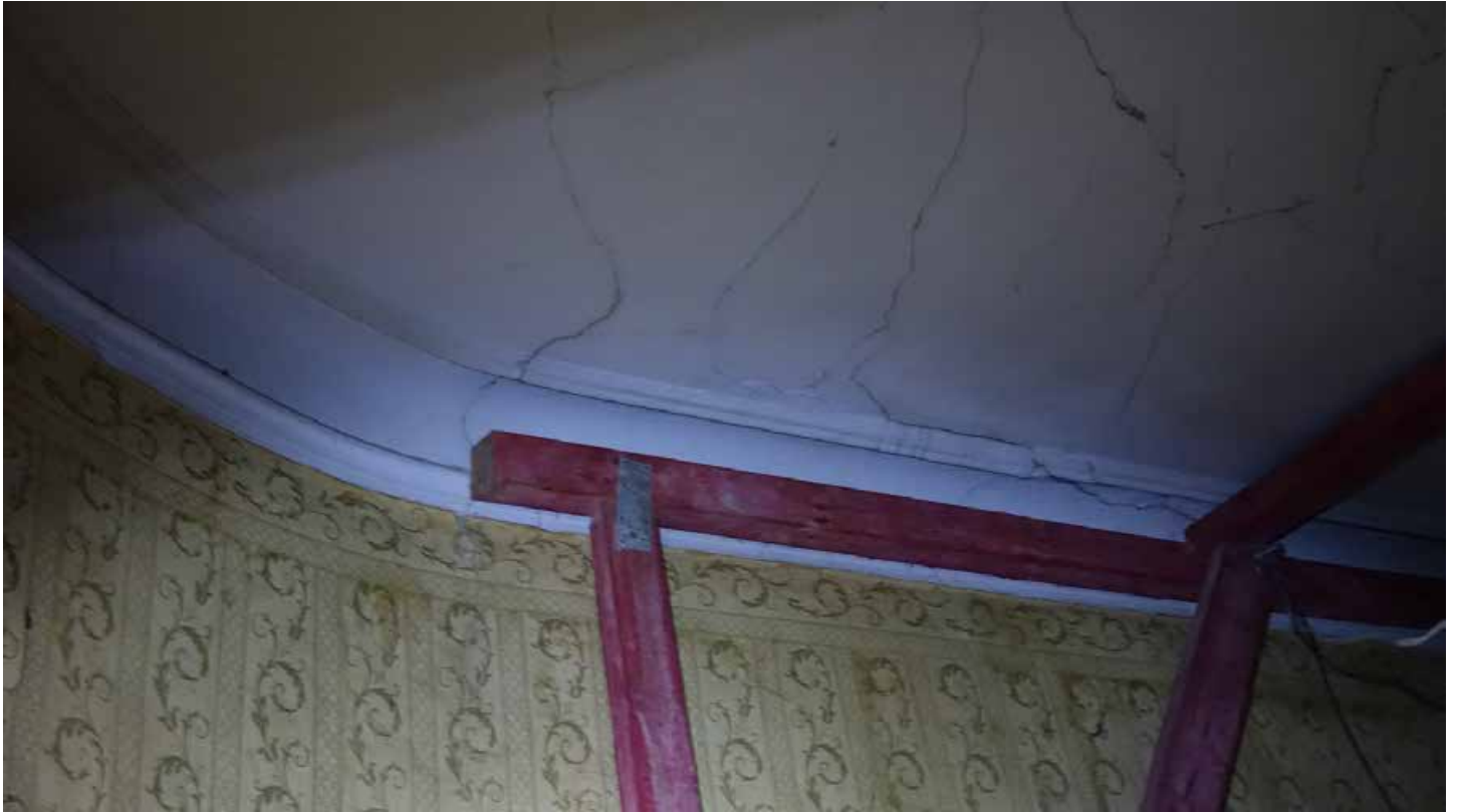
Фото 80. Помещение 18. Падуга и профилированный карниз советского времени. Первый этаж. Дата фотофиксации: 01.03.24
