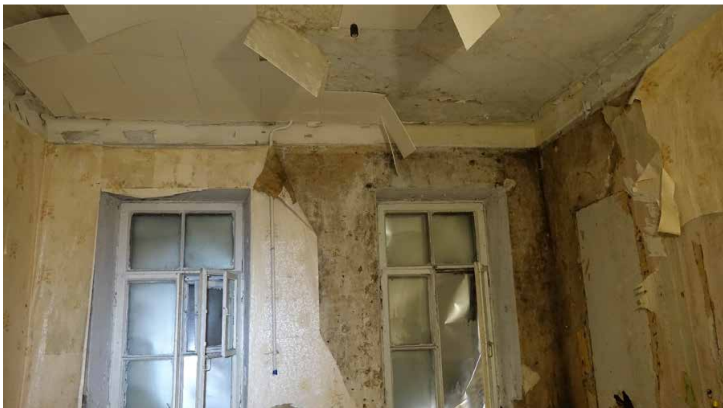
Фото 219. Помещение 127. Третий этаж. Дата фотофиксации: 01.03.24
