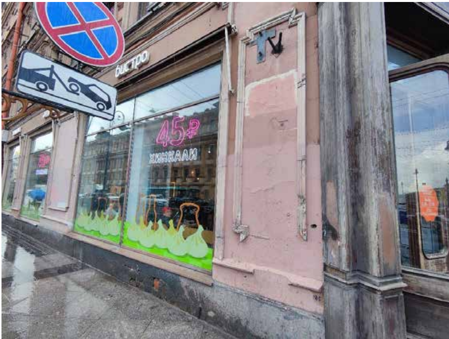
19. «Здание, где размещался ресторан «К.П. Палкин», Владимирский пр., д. 1/47, литера Б. Восточный фасад. Фрагмент. Фото 31.07.2024г.
