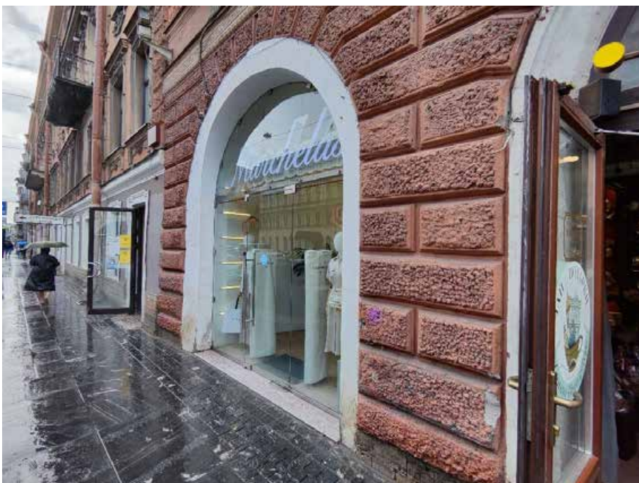
25. «Здание, где размещался ресторан «К.П. Палкин», Владимирский пр., д. 1/47, литера Б. Восточный фасад. Фрагмент. Фото 31.07.2024г.
