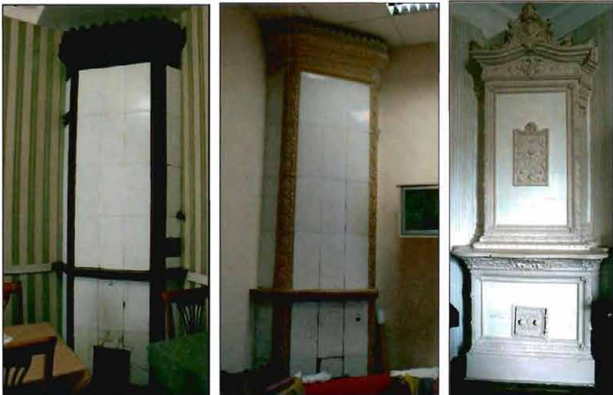
Фото №17-19. Печь угловая (кв. 29, 30, пом. 52-Н).
