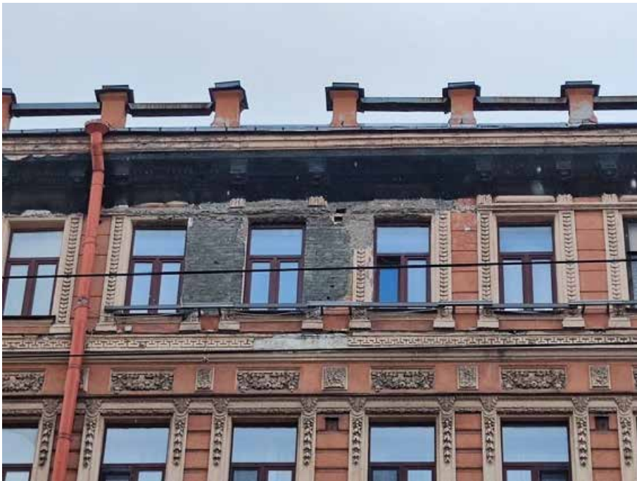
11. «Здание, где размещался ресторан «К.П. Палкин», Владимирский пр., д. 1/47, литера Б. Восточный фасад. Фрагмент. Фото 31.07.2024г.
