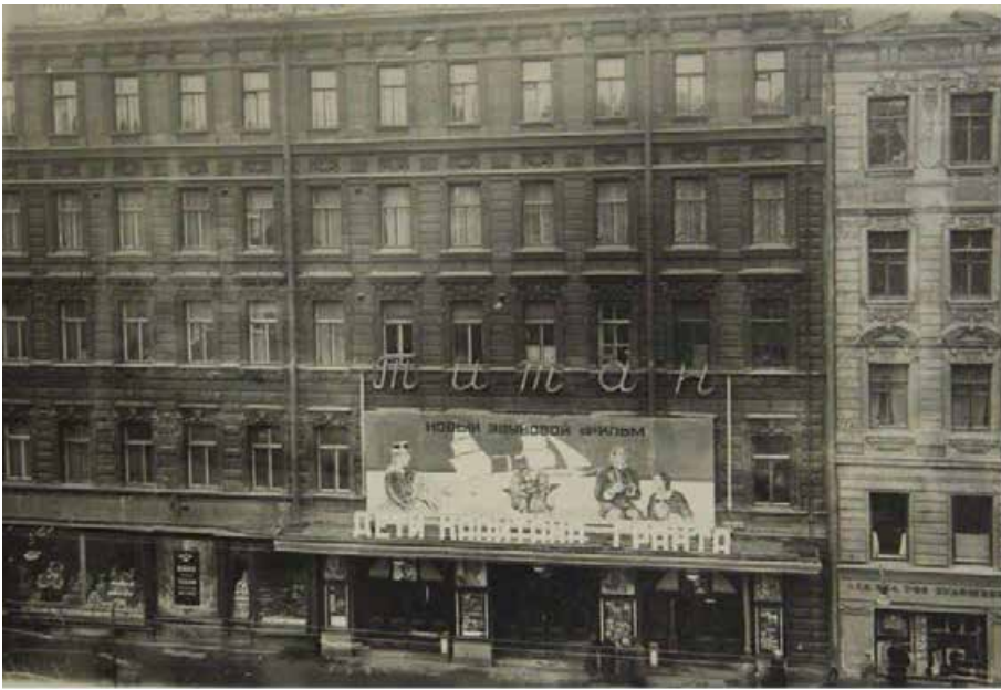
41. Наружный вид здания кинотеатра «Титан». 1936 г. ЦГАКФФД СПб. Шифр: Гр. 54609.
