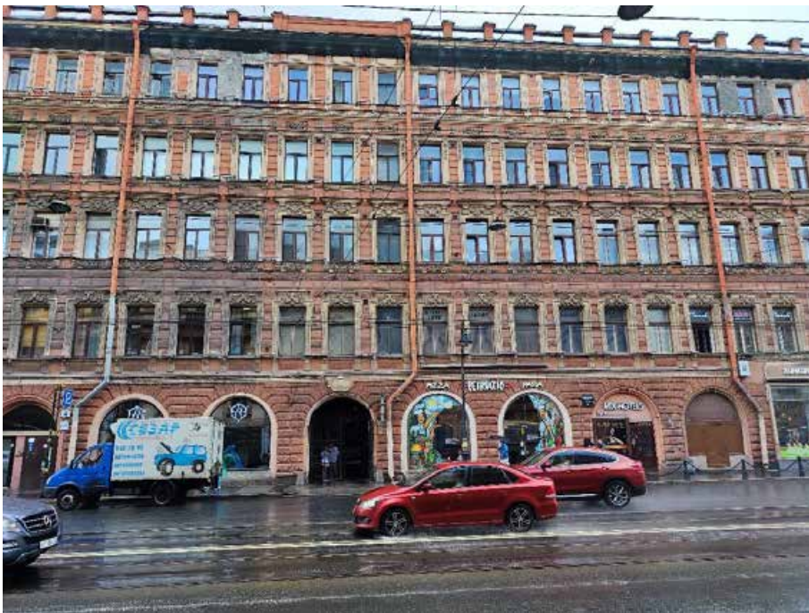
9. «Здание, где размещался ресторан «К.П. Палкин», Владимирский пр., д. 1/47, литера Б. Восточный фасад. Фрагмент. Фото 31.07.2024г.
