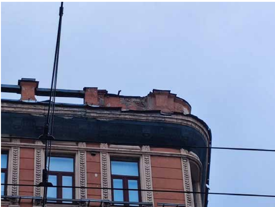
12. «Здание, где размещался ресторан «К.П. Палкин», Владимирский пр., д. 1/47, литера Б. Восточный фасад. Фрагмент. Фото 31.07.2024г.
