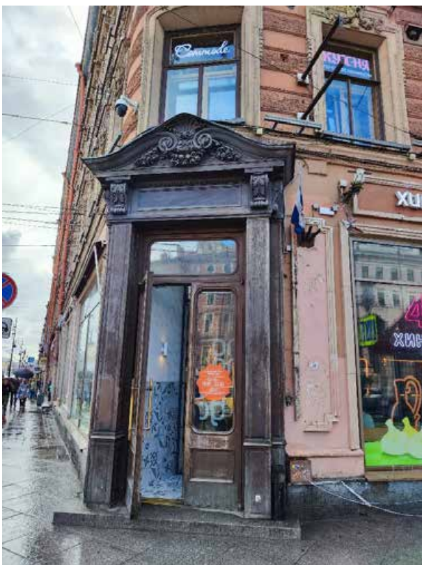
13. «Здание, где размещался ресторан «К.П. Палкин», Владимирский пр., д. 1/47, литера Б. Восточный фасад. Фрагмент. Фото 31.07.2024г.
