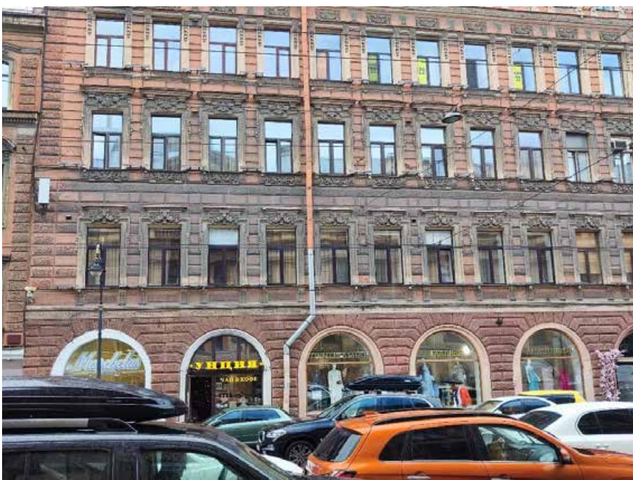
6. «Здание, где размещался ресторан «К.П. Палкин», Владимирский пр., д. 1/47, литера Б. Восточный фасад. Фрагмент. Фото 31.07.2024г.
