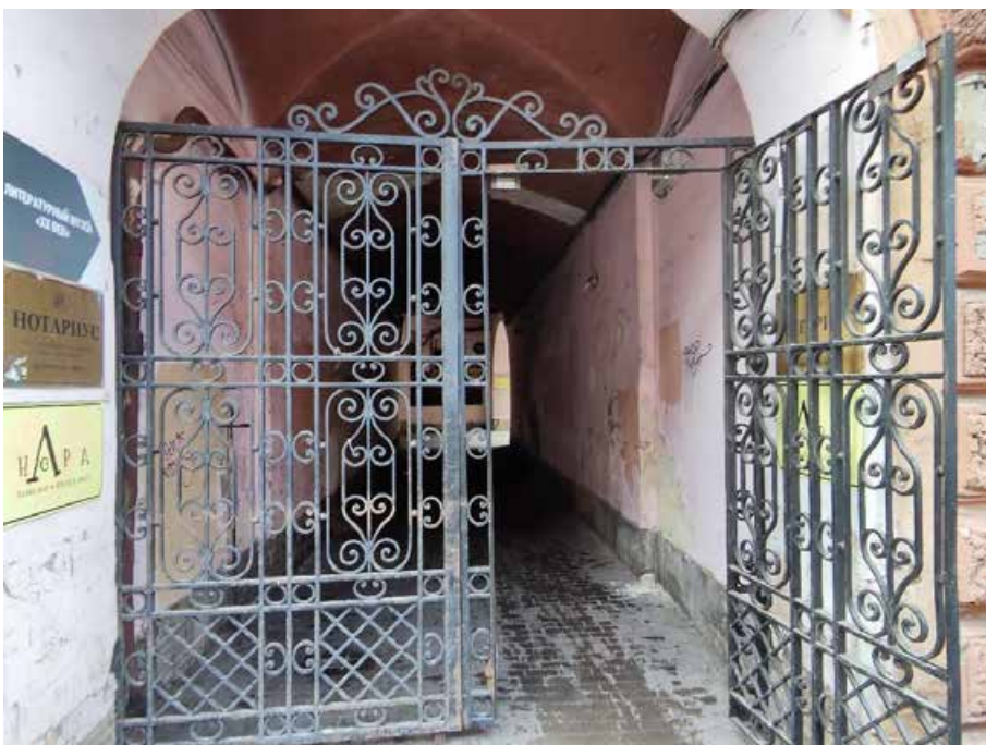
27. «Здание, где размещался ресторан «К.П. Палкин», Владимирский пр., д. 1/47, литера Б. Восточный фасад. Фрагмент. Фото 31.07.2024г.
