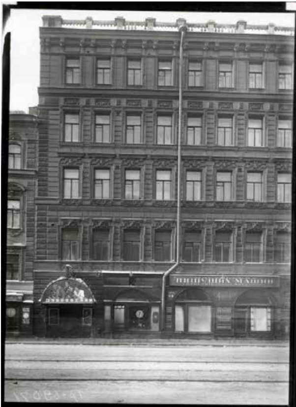
42. ЦГАКФФД СПб. Шифр: Гр 69071. 1938 г. Фрагмент центрального фасада дома №1 на проспекте Нахимсона (дом К.П. Палкина, арх. Кейзер А. К. (1873-1874 гг.), Хренов А. С. (реконструкция 1904-1905 гг.).
