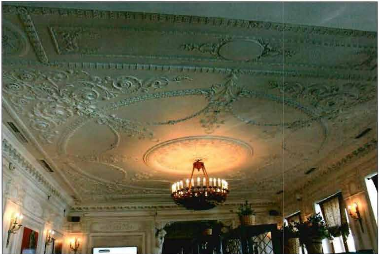
Фото №3, 4. Помещение 58-Н (1) 2-го этажа.
