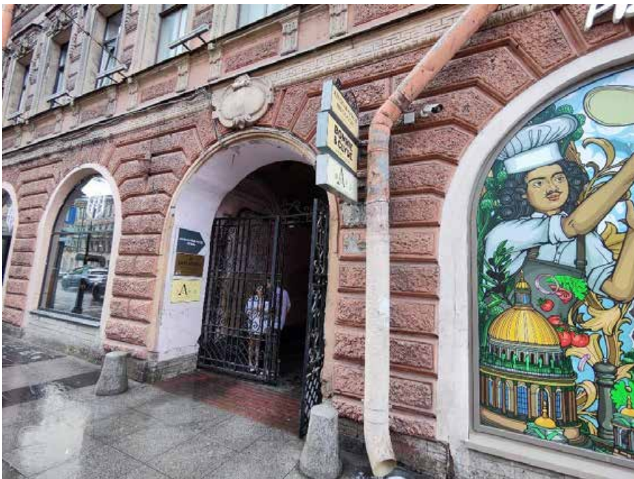
24. «Здание, где размещался ресторан «К.П. Палкин», Владимирский пр., д. 1/47, литера Б. Восточный фасад. Фрагмент. Фото 31.07.2024г.
