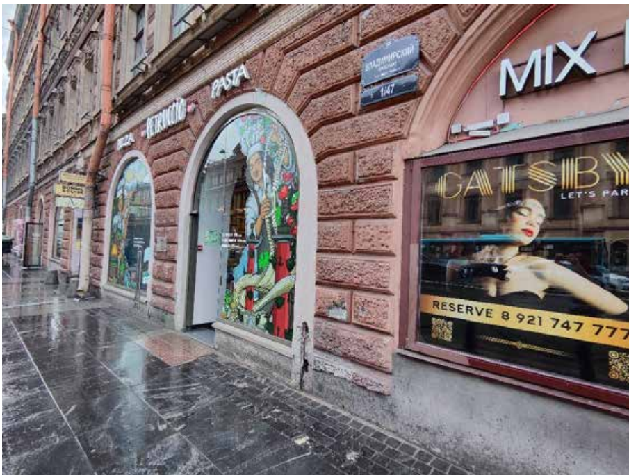
22. «Здание, где размещался ресторан «К.П. Палкин», Владимирский пр., д. 1/47, литера Б. Восточный фасад. Фрагмент. Фото 31.07.2024г.
