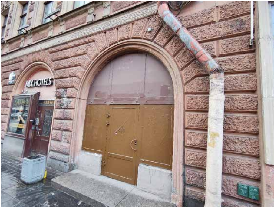
21. «Здание, где размещался ресторан «К.П. Палкин», Владимирский пр., д. 1/47, литера Б. Восточный фасад. Фрагмент. Фото 31.07.2024г.
