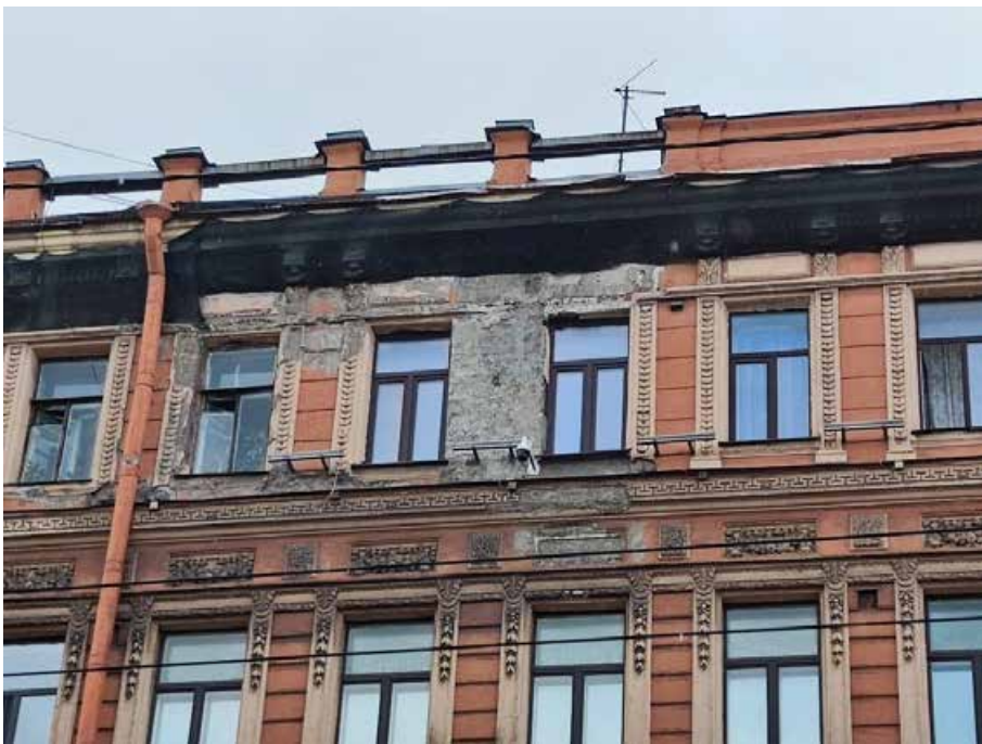
8. «Здание, где размещался ресторан «К.П. Палкин», Владимирский пр., д. 1/47, литера Б. Восточный фасад. Фрагмент. Фото 31.07.2024г.
