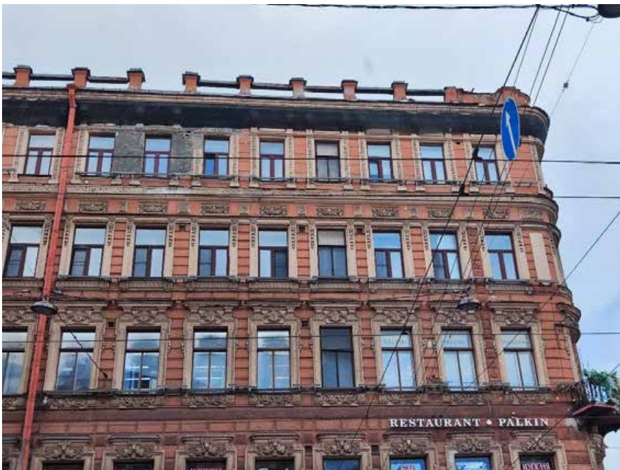
10. «Здание, где размещался ресторан «К.П. Палкин», Владимирский пр., д. 1/47, литера Б. Восточный фасад. Фрагмент. Фото 31.07.2024г.
