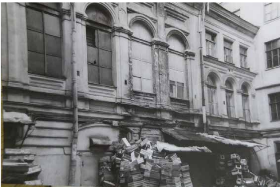
61. Техническое заключение по обследованию дома № 1/47 по Владимирскому проспекту. Вид на восточный фасад дворового флигеля. 1977 г. КГИОП. П. 757.
