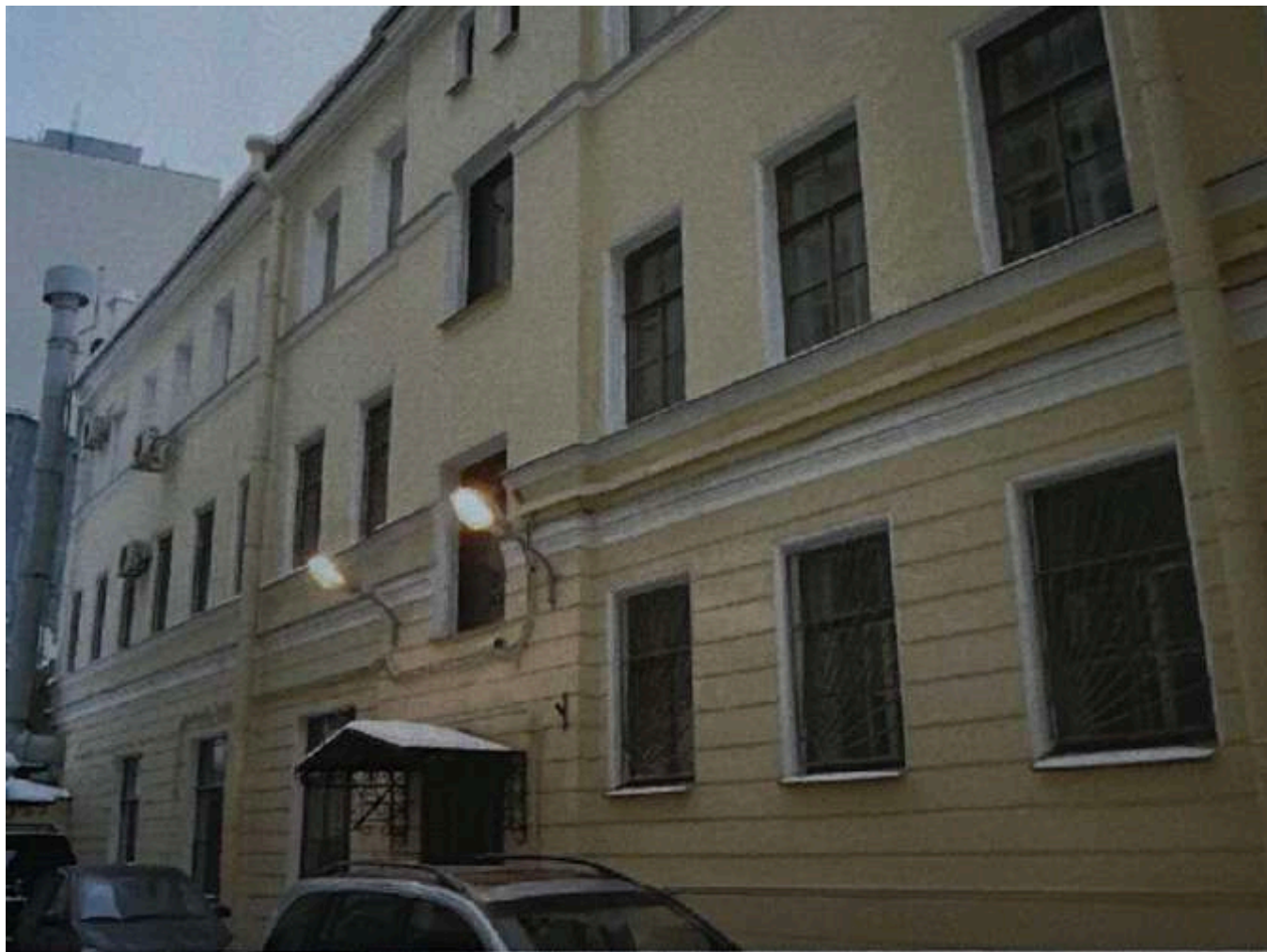
79. Здание по адресу: Невский пр., д.53. Фрагмент фасада. Фотография. 2007 г. // Источник: Архив КГИОП. П.1500-Н. Пр.-105. Заключение по результатам обследования технического состояния основных несущих конструкций здания, расположенного по адресу: г. Санкт-Петербург, Невский пр., д.53. 2007 г.
