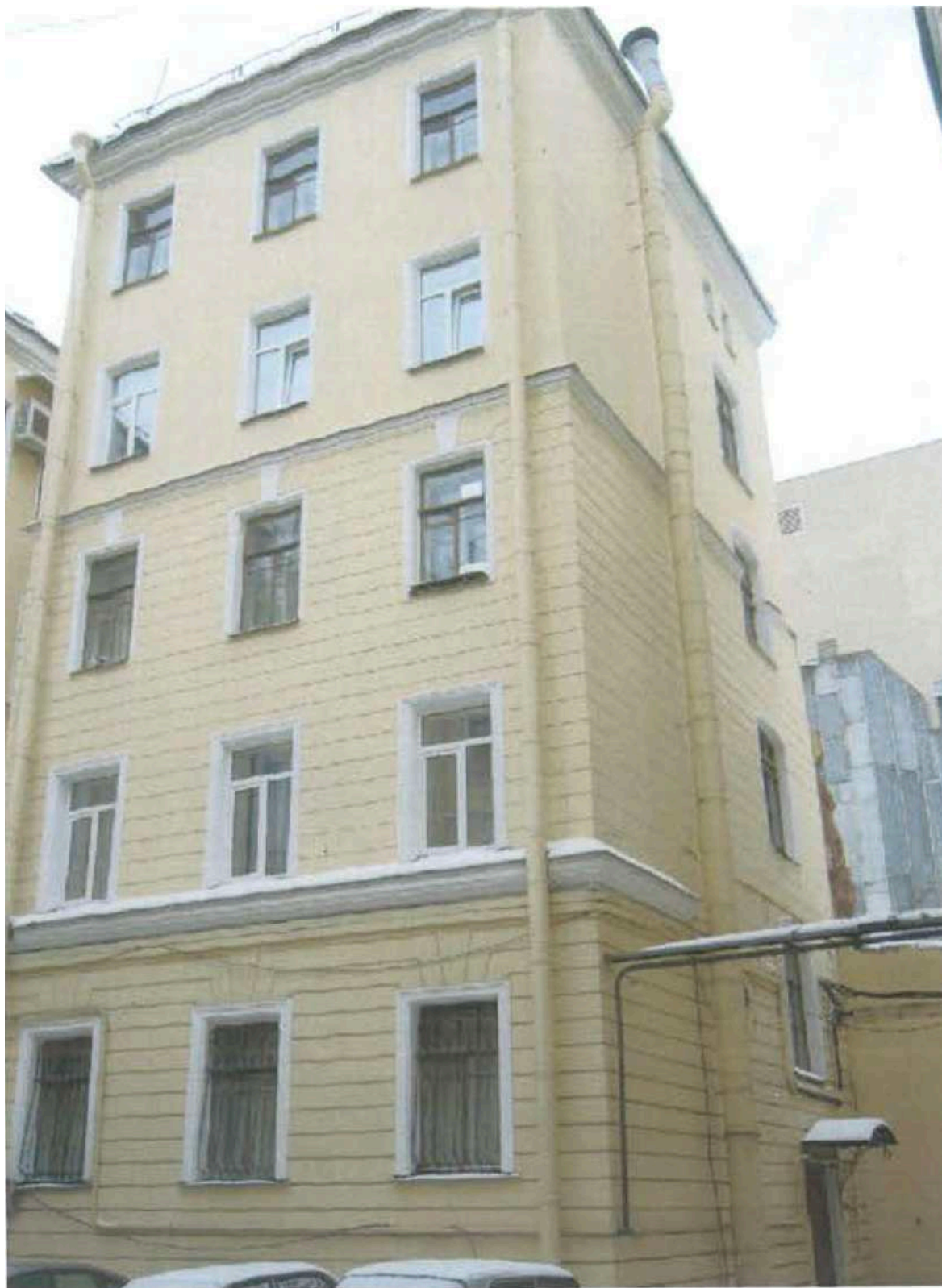
85. Невский проспект, дом 53. Фрагмент дворового фасада. Фотография. 2007 г. // Источник: Архив КГИОП. П.1500-Н. Пр.-105. Заключение по результатам обследования технического состояния основных несущих конструкций здания, расположенного по адресу: г. Санкт-Петербург, Невский пр., д.53. 2007 г.
