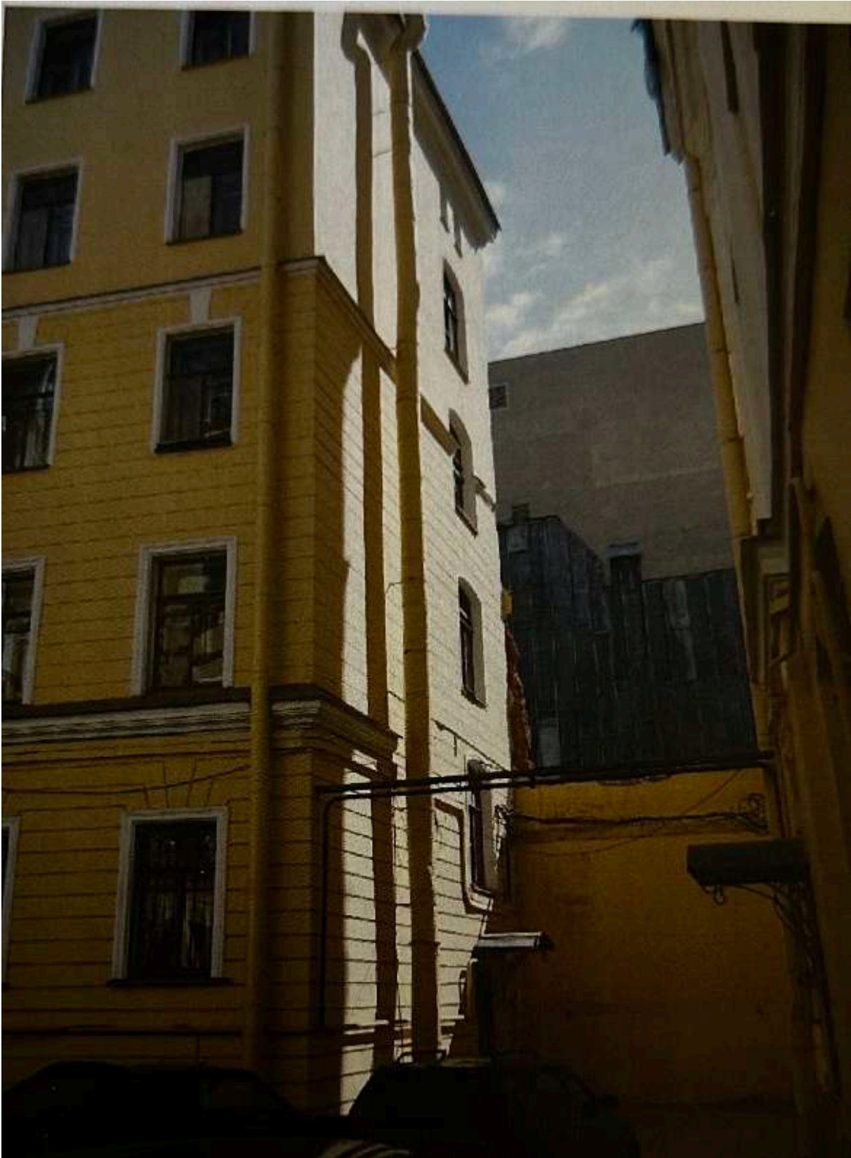
78. Общий вид стены здания по адресу: Невский пр., 53. Фотография. 2006 г. // Источник: Архив КГИОП. 1500-Н. Пр.-104. Заключение по результатам обследования технического состояния фрагмента стены здания по адресу: г. Санкт-Петербург, Невский пр., д. 53. 2006 г.
