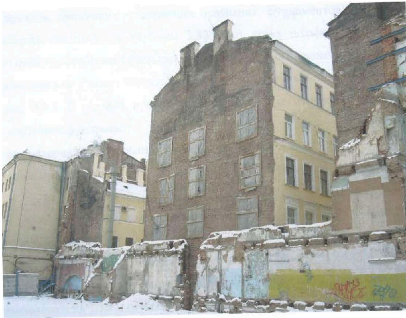
88. Часть стены соседнего демонтированного здания. Фотография. 2007 г. // Источник: Архив КГИОП. П.1500-Н. Пр.-105. Заключение по результатам обследования технического состояния основных несущих конструкций здания, расположенного по адресу: г. Санкт-Петербург, Невский пр., д.53. 2007 г.
