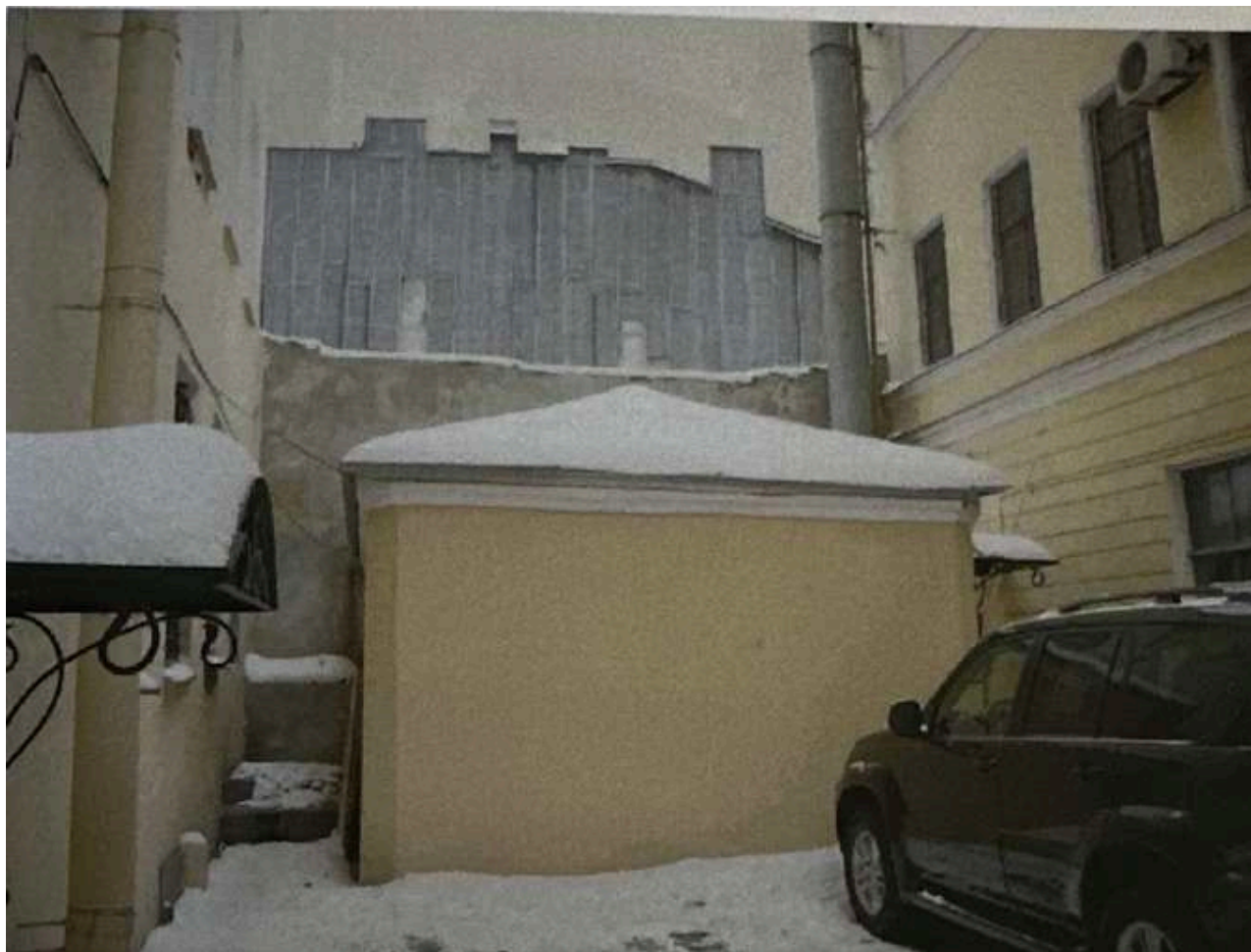
81. Здание по адресу: Невский пр., д. 53. Дворовая пристройка. Фотография. 2007 г. // Источник: Архив КГИОП. П.1500-Н. Пр.-105. Заключение по результатам обследования технического состояния основных несущих конструкций здания, расположенного по адресу: г. Санкт-Петербург, Невский пр., д.53. 2007 г.
