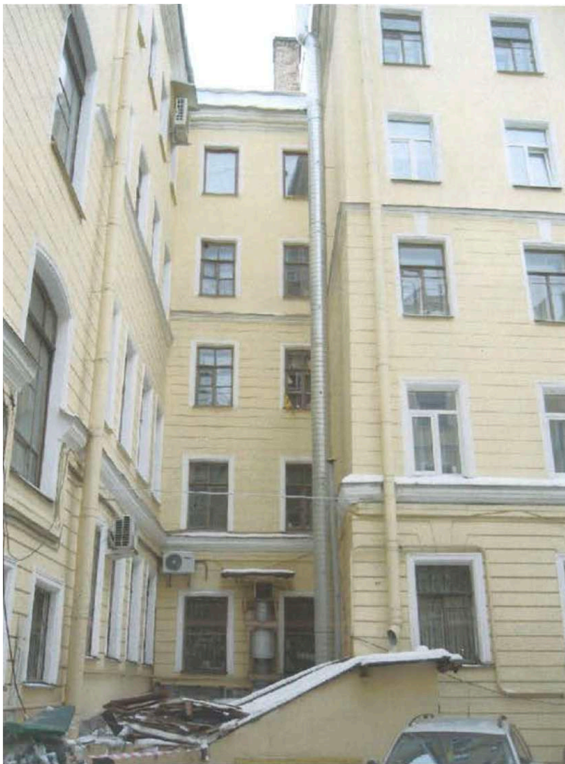
84. Невский проспект, дом 53. Фрагмент дворового фасада. Фотография. 2007 г. // Источник: Архив КГИОП. П.1500-Н. Пр.-105. Заключение по результатам обследования технического состояния основных несущих конструкций здания, расположенного по адресу: г. Санкт-Петербург, Невский пр., д.53. 2007 г.
