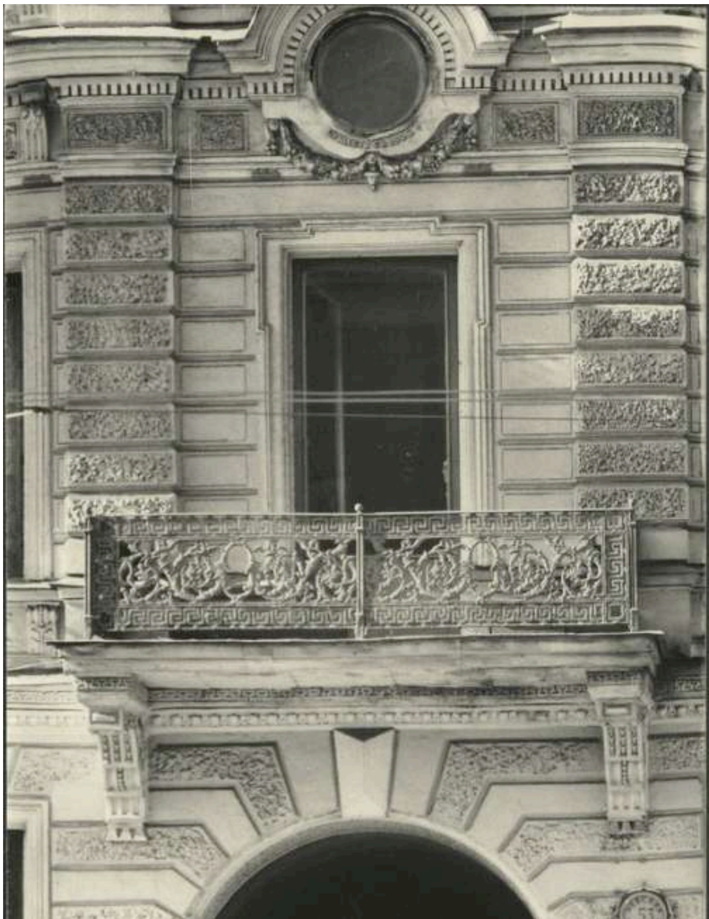
71. Невский проспект, дом 53. Фрагмент лицевого фасада. Фотография. Автор фото – Шувалов А.Ф. 1989 г. // Источник: ГМИ СПб Инв.№-II-Б-38309 ф.
