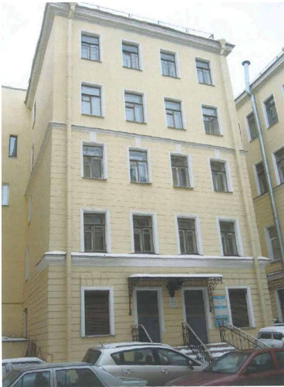
86. Невский проспект, дом 53. Фрагмент дворового фасада. Фотография. 2007 г. // Источник: Архив КГИОП. П.1500-Н. Пр.-105. Заключение по результатам обследования технического состояния основных несущих конструкций здания, расположенного по адресу: г. Санкт-Петербург, Невский пр., д.53. 2007 г.
