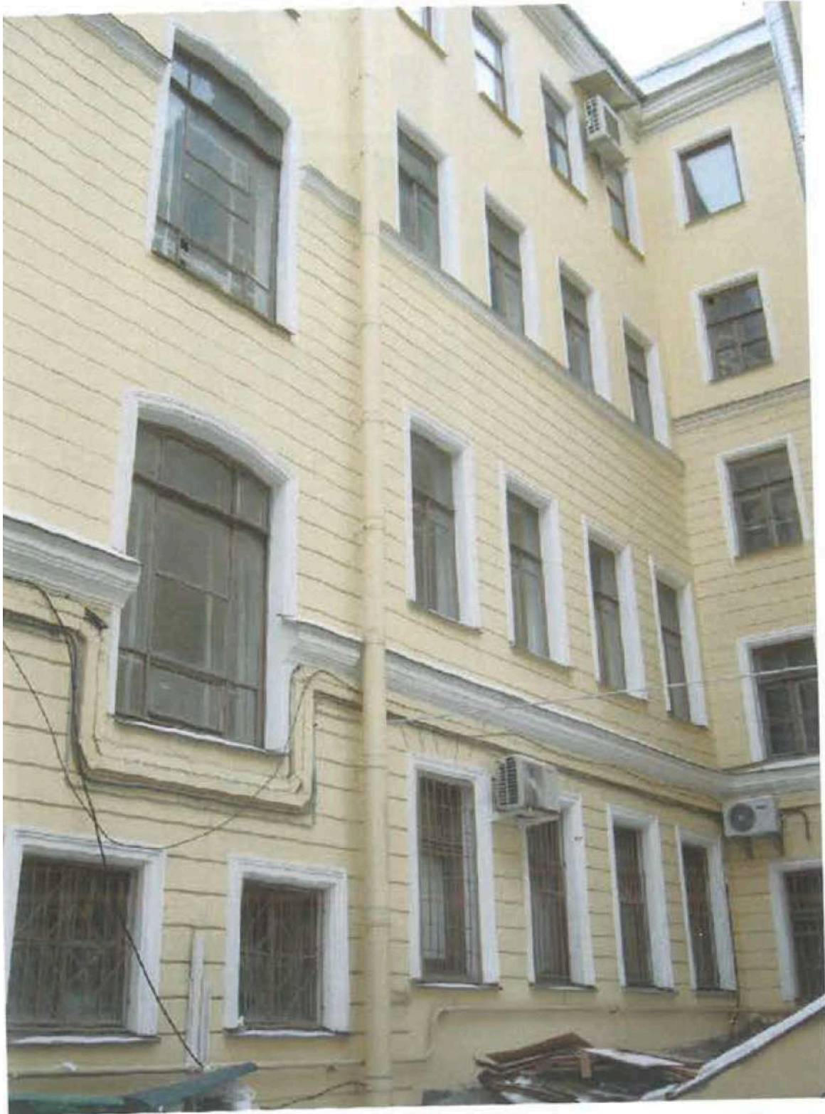
83. Невский проспект, дом 53. Фрагмент дворового фасада. Фотография. 2007 г. // Источник: Архив КГИОП. П.1500-Н. Пр.-105. Заключение по результатам обследования технического состояния основных несущих конструкций здания, расположенного по адресу: г. Санкт-Петербург, Невский пр., д.53. 2007 г.
