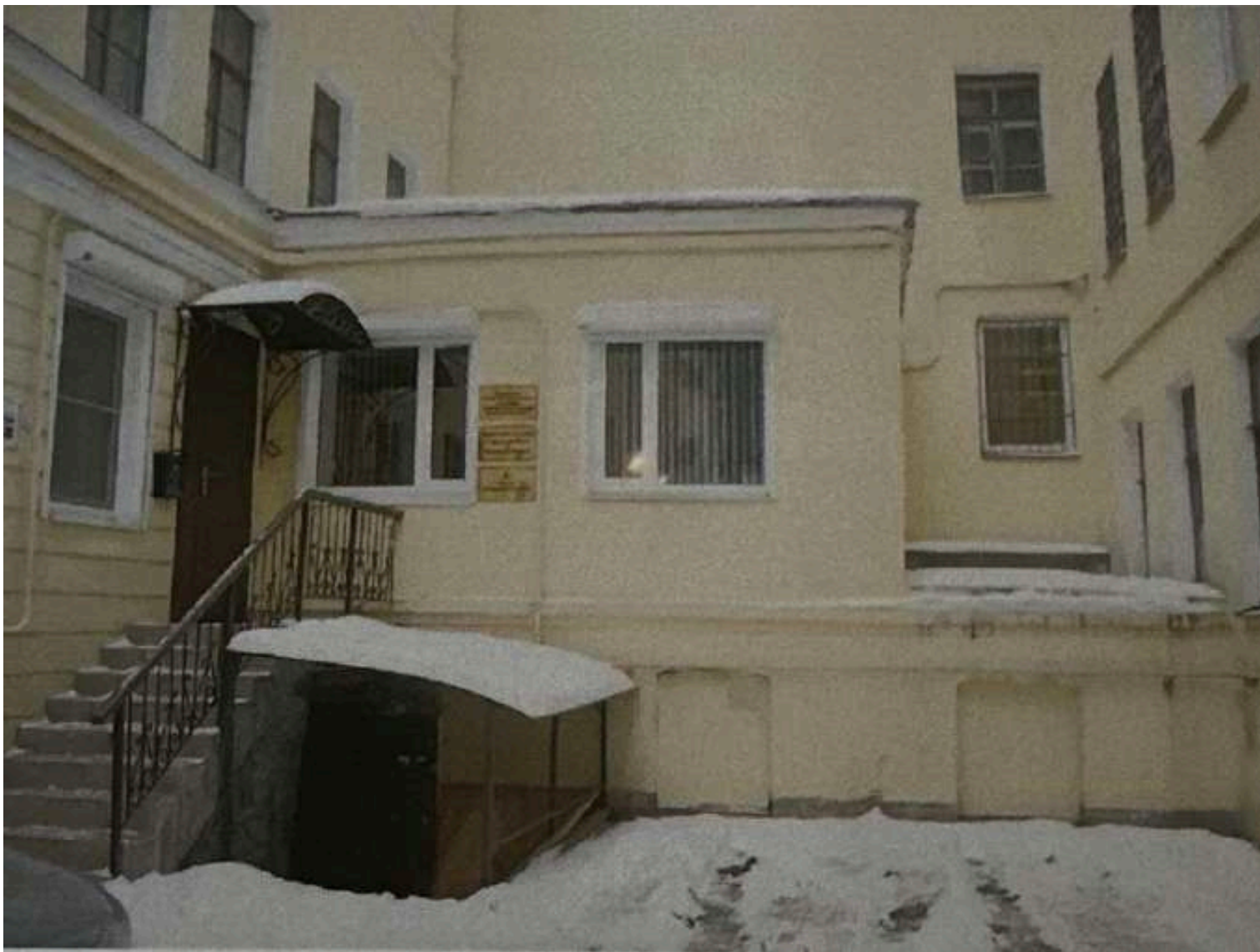
80. Здание по адресу: Невский пр., д. 53. Фрагмент дворовой пристройки. Фотография. 2007 г. // Источник: Архив КГИОП. П.1500-Н. Пр.-105. Заключение по результатам обследования технического состояния основных несущих конструкций здания, расположенного по адресу: г. Санкт-Петербург, Невский пр., д.53. 2007 г.
