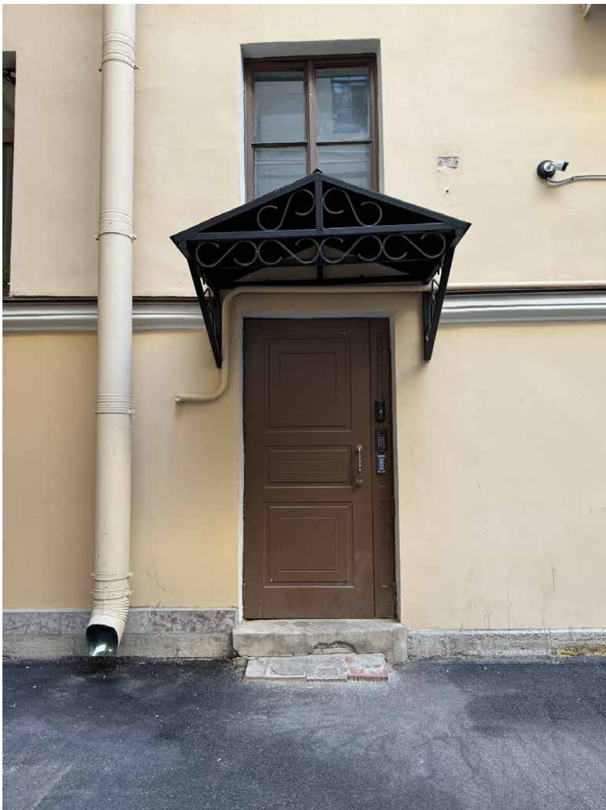
Фото 7. Вид на вход в парадную, ведущую в квартиру № 14, объекта культурного наследия.
