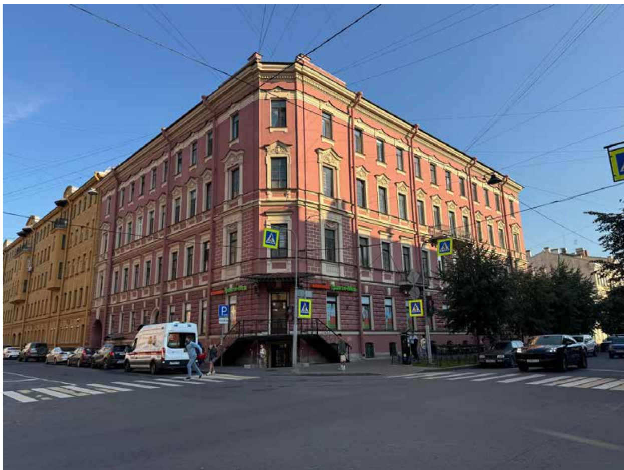
Фото 3. Общий вид с перекрестка улиц Рылеева и Маяковского объекта культурного наследия.
