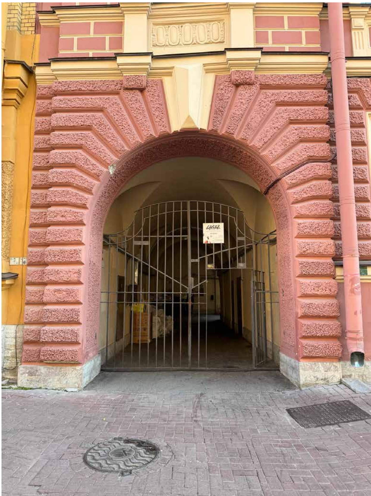
Фото 2. Арка проезда во двор объекта культурного наследия.
