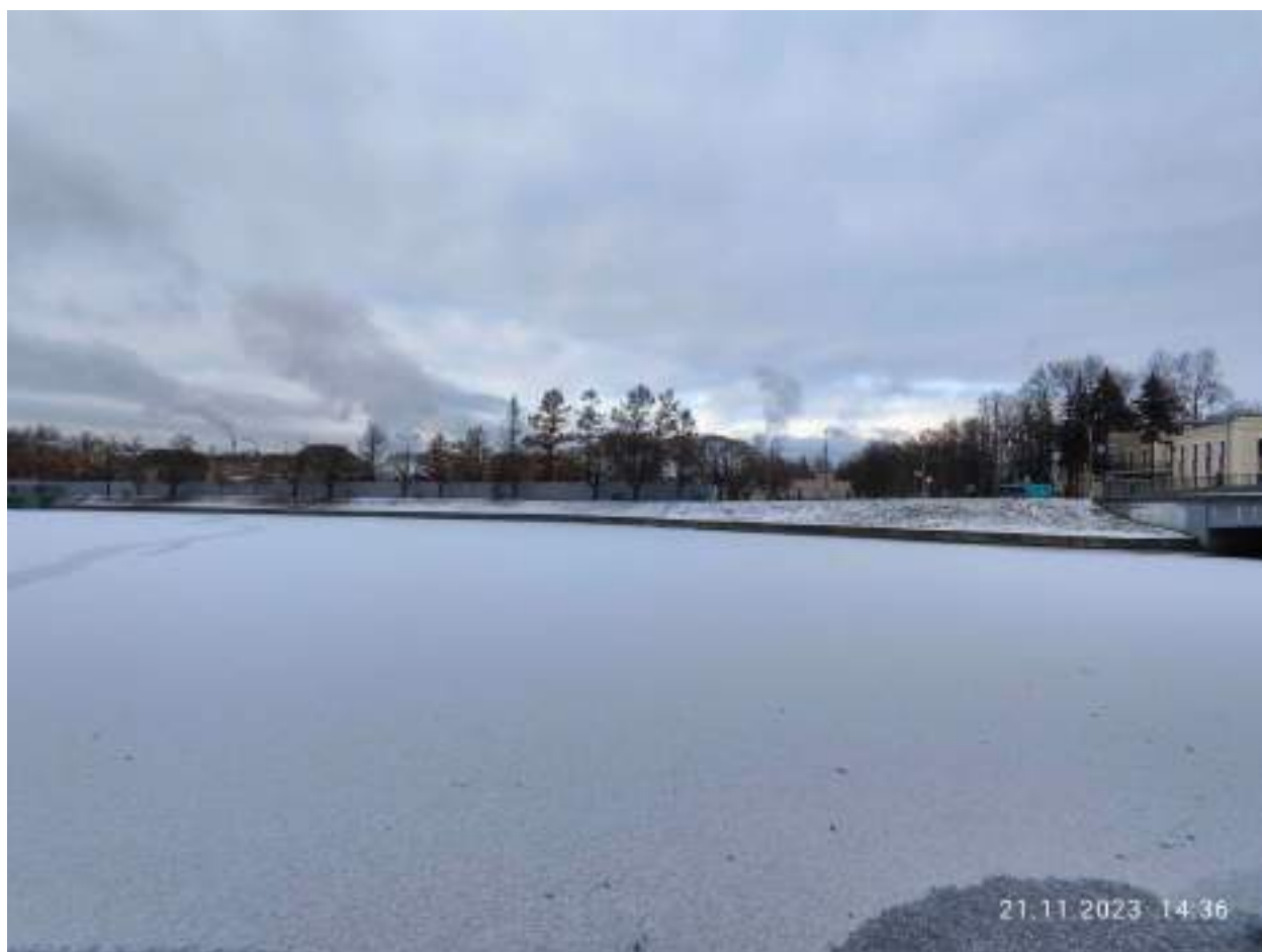
7. Вид на объект культурного наследия федерального значения «Заводы Ижорские Адмиралтейские. Плотина главная №1 с подпорной стеной». 21.11.2023
