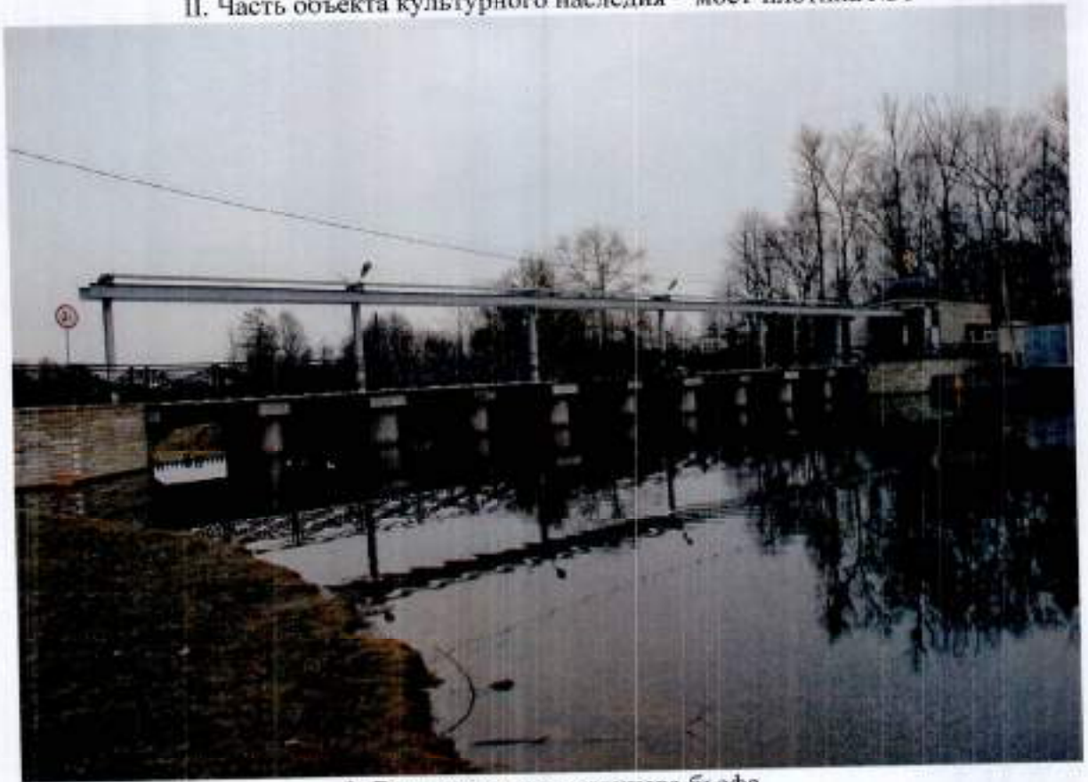
3. Вид со стороны верхнего бьефа
