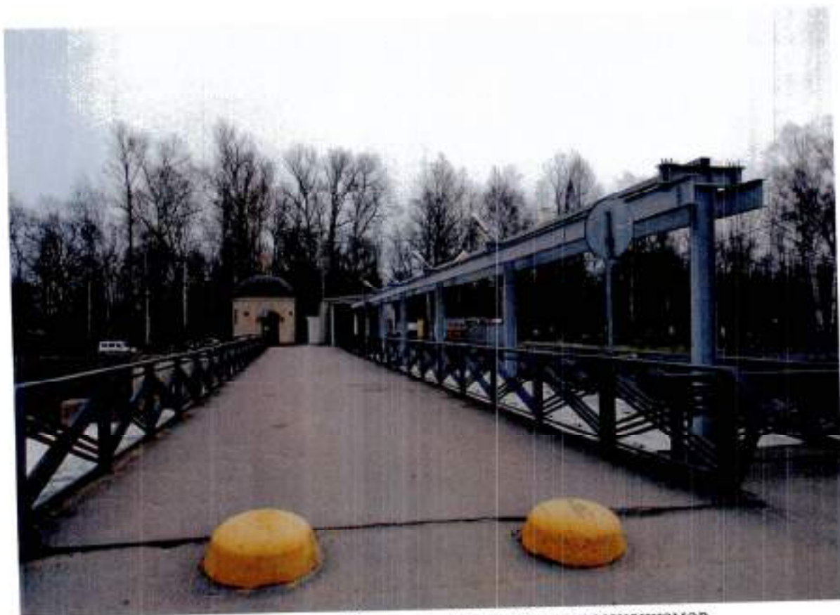
5. Дорожное покрытие. Эстакада для подъемных механизмов
