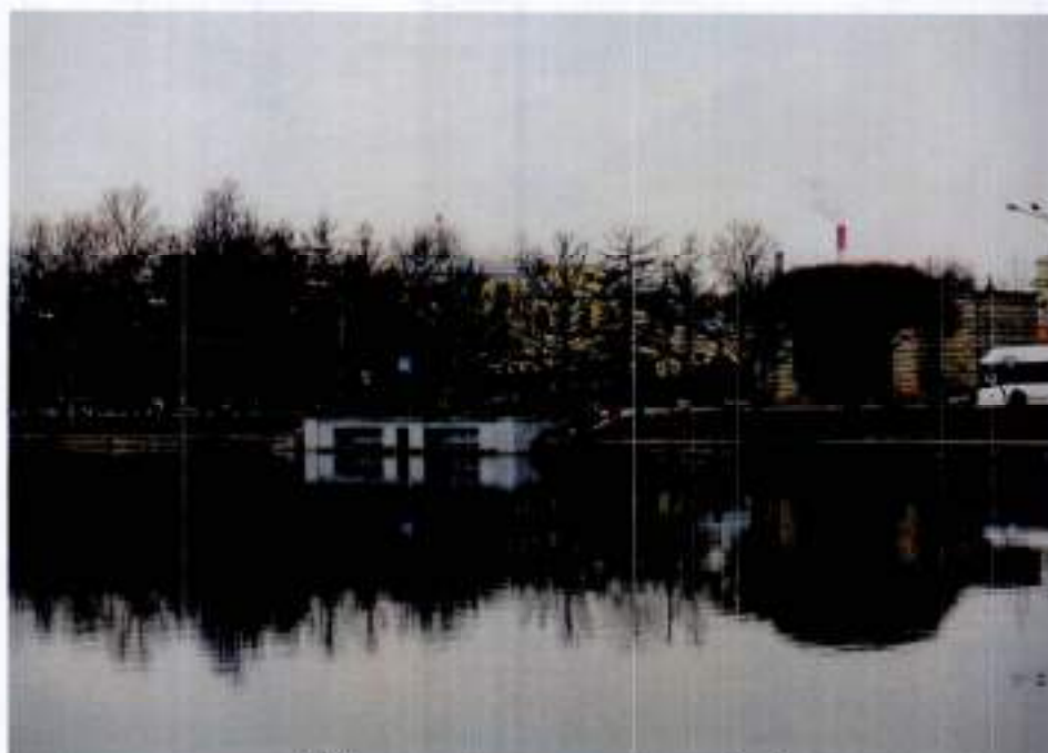
1. Вид со стороны верхнего бьефа
