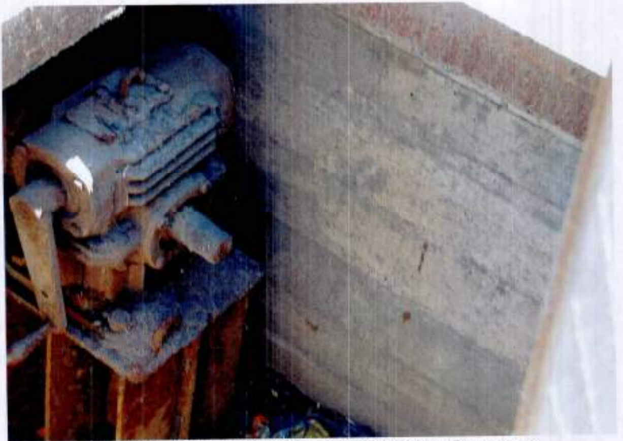
6. Приямок с подъемными механизмами на смотровой площадке
