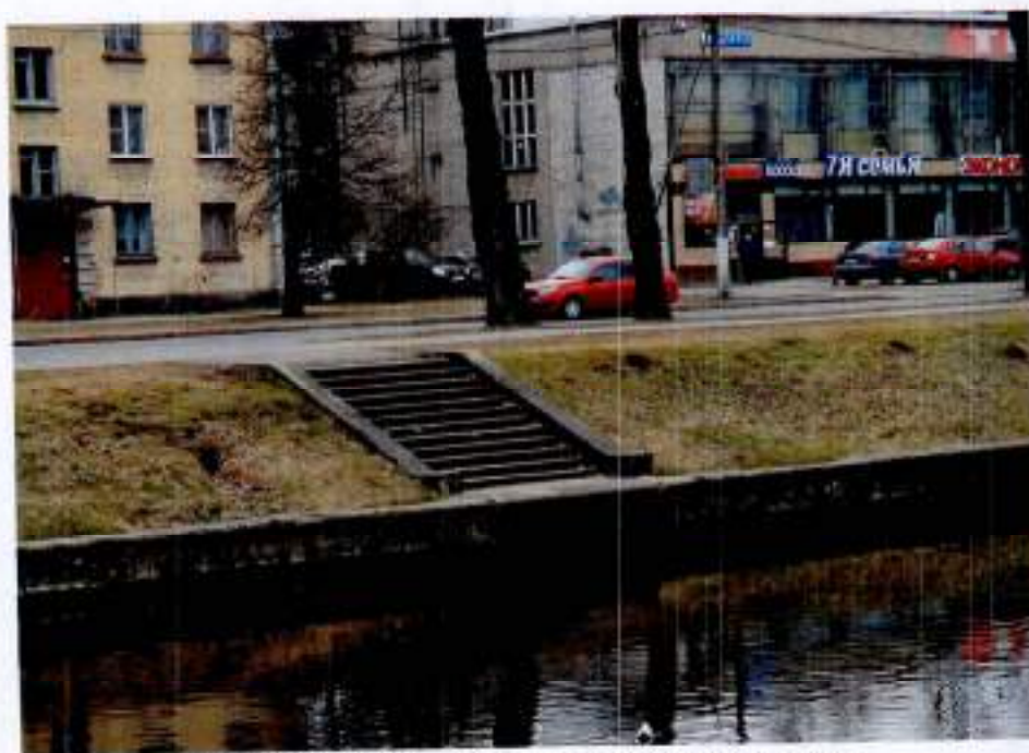
2. Железобетонный лестничный спуск к воде
