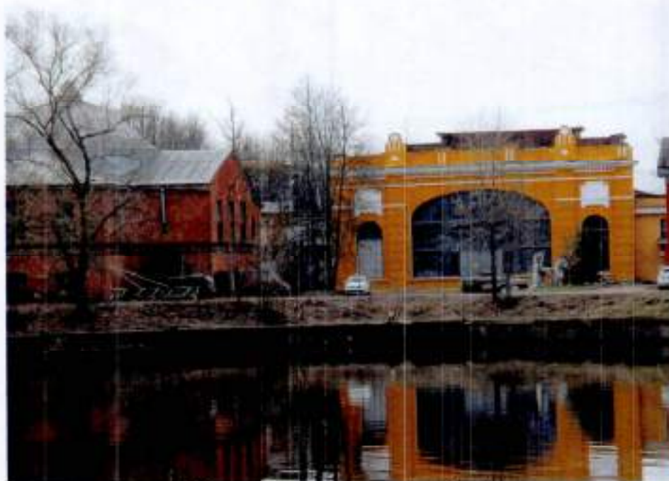
2. Вид со стороны нижнего бьефа
