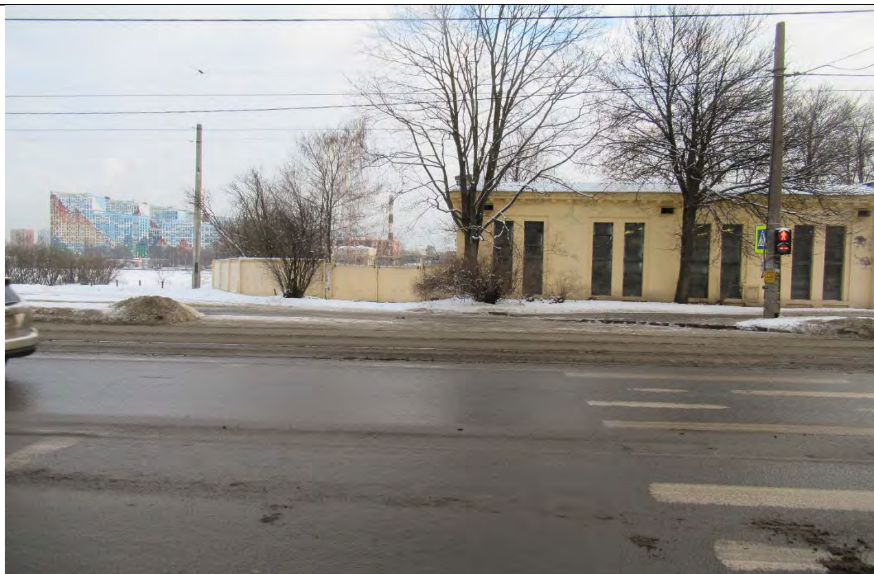
9. Вид на насосную станцию по адресу: г. Санкт-Петербург, проспект Обуховской Обороны, дом 98, литера А. расположенную на «участке набережной реки Невы «сад «Куракина Дача» - Шлиссельбургский мост», литера Б с точки у здания по адресу: ул. Дудко, дом 3, лит. Б. Дата фото: 15.12.2020 г.
