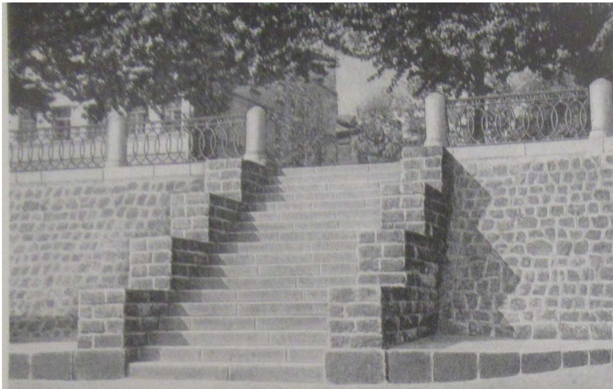
Ил. 30. Лестница на разгрузочную площадку. Тип № 1.
