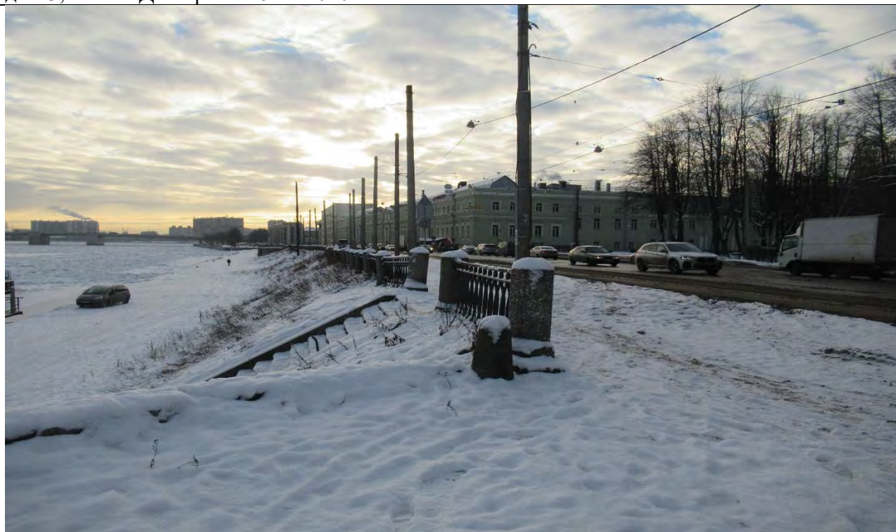
10. Вид на «участок набережной реки Невы «сад «Куракина Дача» - Шлиссельбургский мост», лит. Б от точки напротив парка им. Бабушкина, по адресу: просп. Обуховской Обороны, 149 по направлению к Володарскому мосту. Дата фото: 15.12.2020 г.
