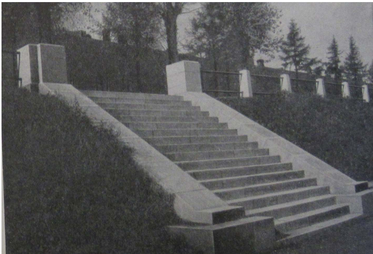
Ил. 31. Лестница на разгрузочную площадку. Тип № 2.
