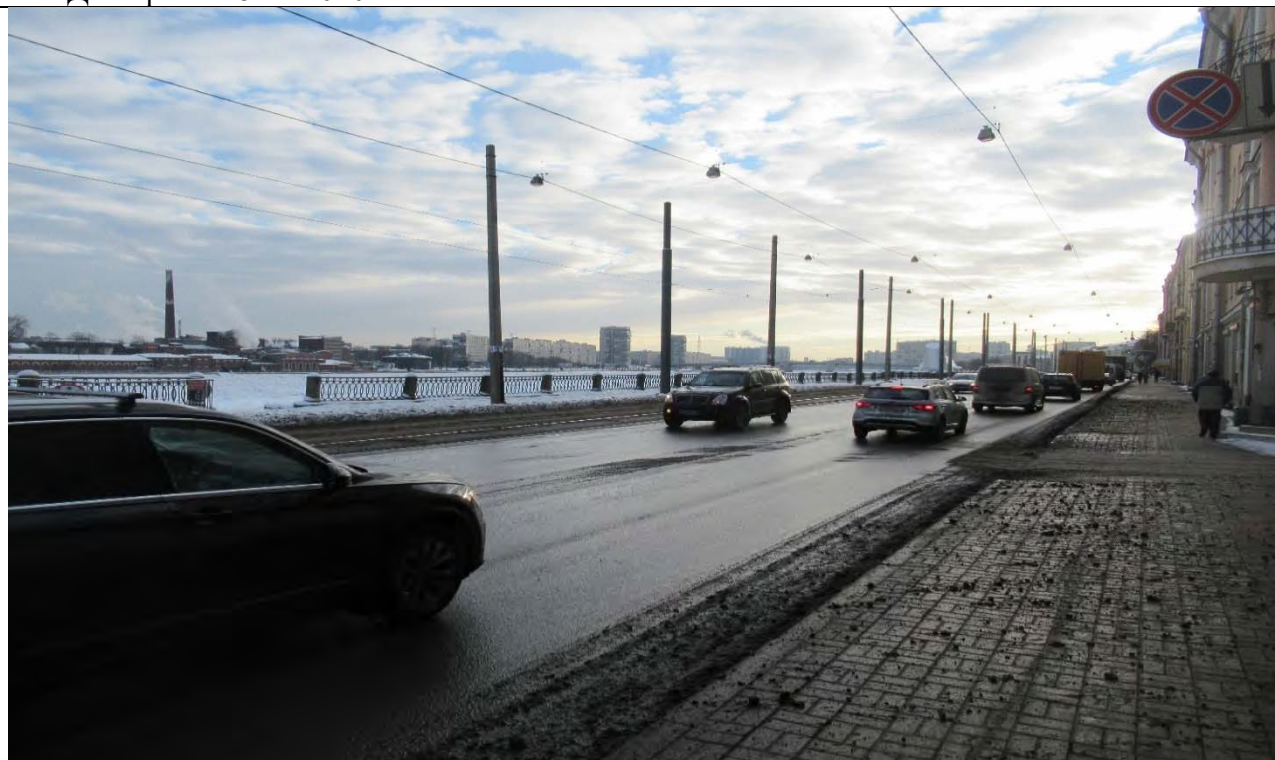
16. Вид на «участок набережной реки Невы «сад «Куракина Дача» - Шлиссельбургский мост», литера Б от точки у здания по адресу: просп. Обуховской Обороны, 139. Дата фото: 15.12.2020 г.
