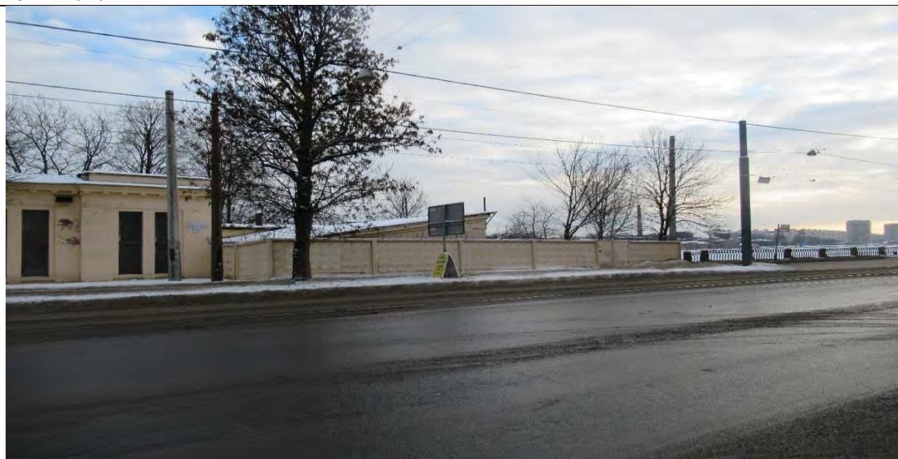
8. Вид на насосную станцию по адресу: г. Санкт-Петербург, проспект Обуховской Обороны, дом 98, литера А. расположенную на «участке набережной реки Невы «сад «Куракина Дача» - Шлиссельбургский мост», литера Б от здания по адресу: просп. Обуховской обороны, 127. Дата фото: 15.12.2020 г.
