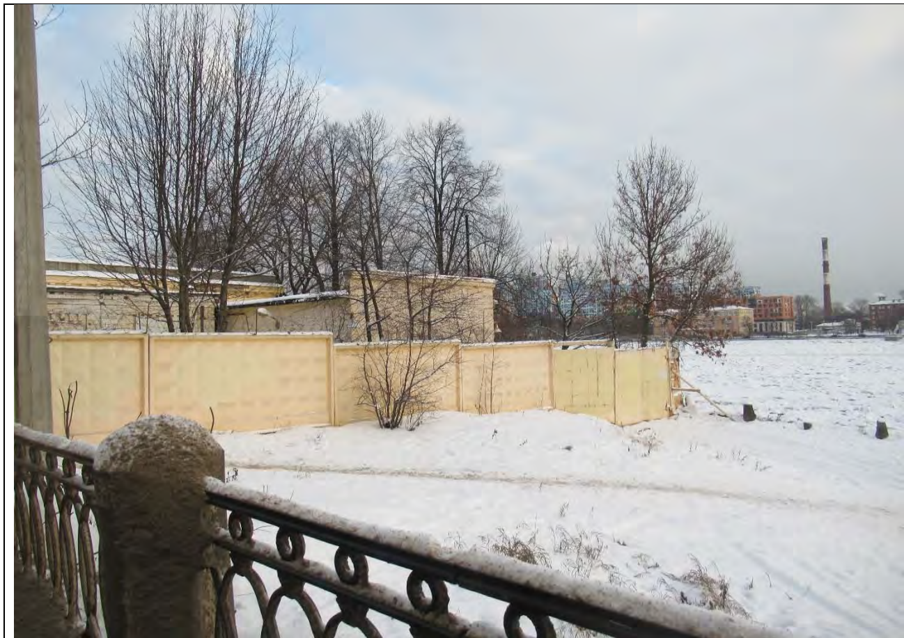
7. Вид на насосную станцию по адресу: г. Санкт-Петербург, проспект Обуховской Обороны, дом 98, литера А. расположенную на «участке набережной реки Невы «сад «Куракина Дача» - Шлиссельбургский мост», литера Б с точки на набережной. Дата фото: 15.12.2020 г.
