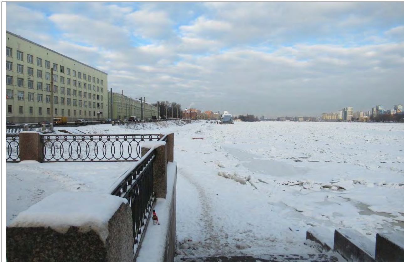
19. Вид на «участок набережной реки Невы «сад «Куракина Дача» - Шлиссельбургский мост», литера Б от спуска на набережную от точки у здания по адресу: просп. Обуховской Обороны, дом 151, лит. А. Дата фото: 15.12.2020 г.
