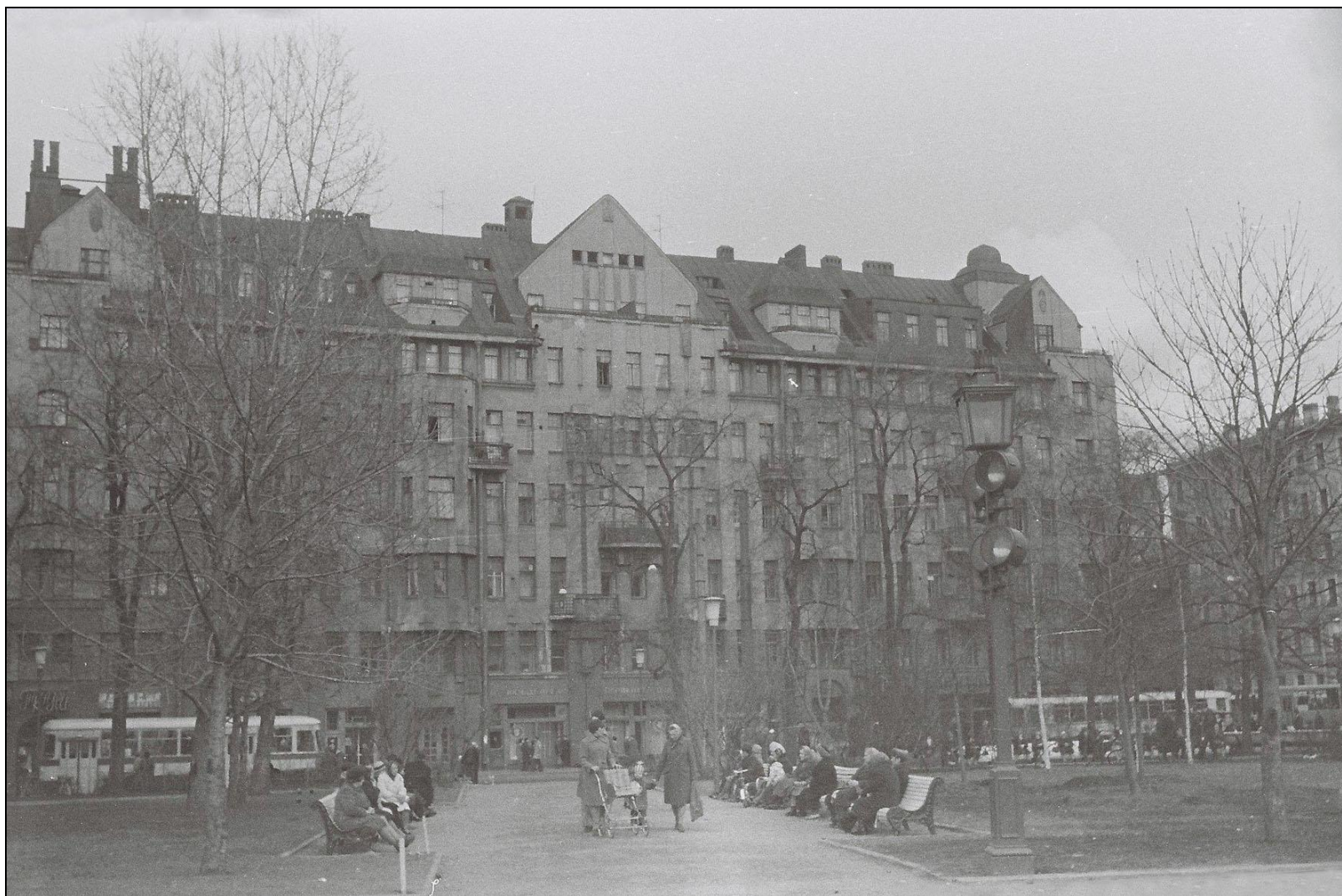
Илл. 18. Жилой комплекс Бассейного товарищества. Вид со стороны сада «Прудки». Фотография. 1976 г. Автор съемки: неизвестен. Старые фотографии: https://pastvu.com .
