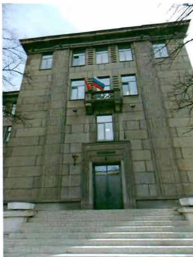
Фото 2. Фрагмент западного фасада.
