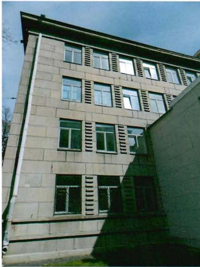
Фото 5. Фрагмент южного фасада.
