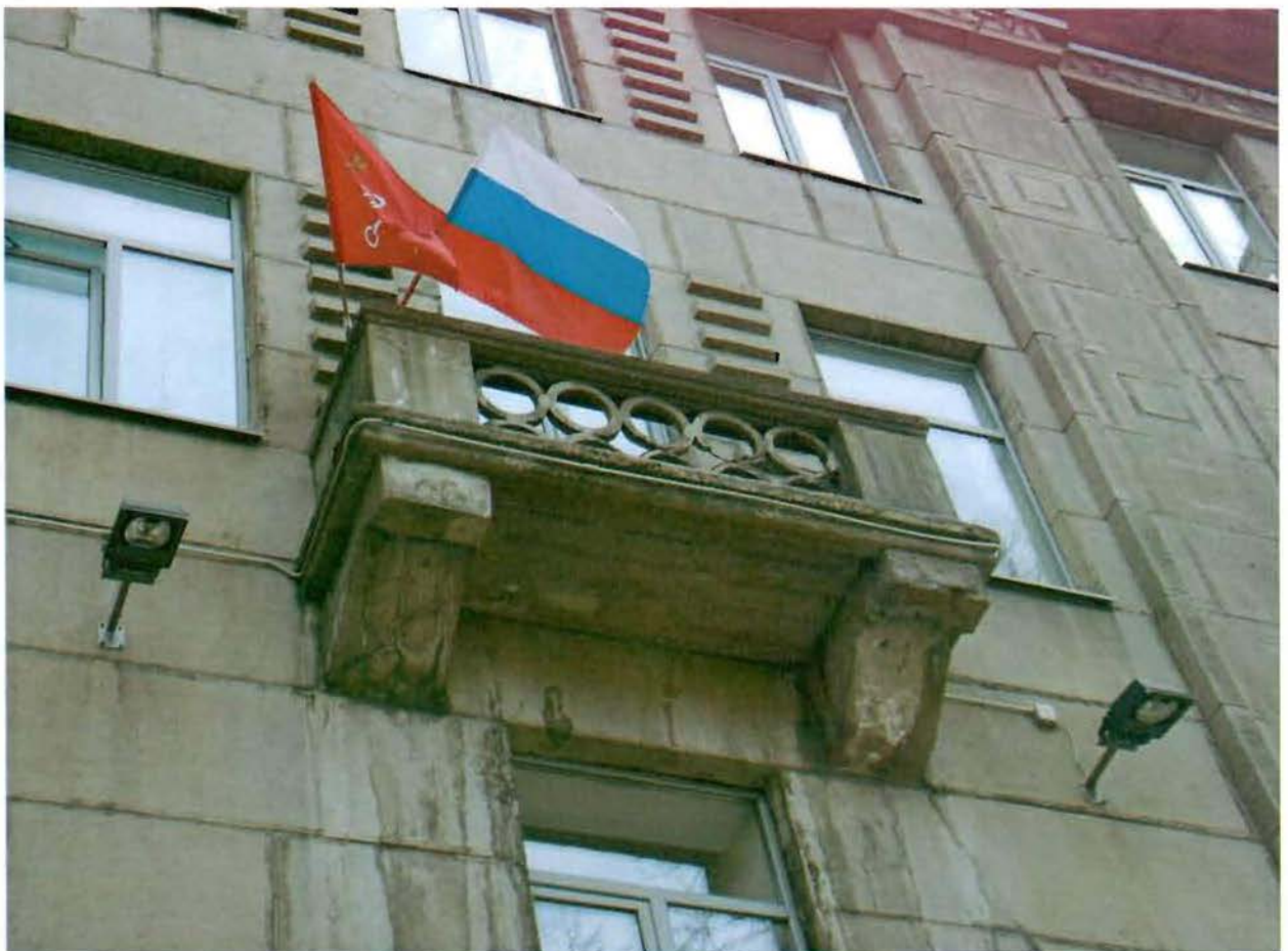
Фото 6. Балкон на западном фасаде.
