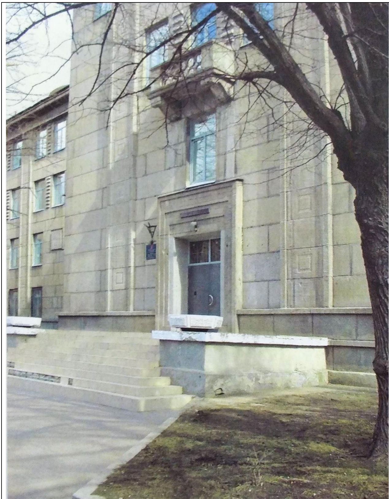
8. Фрагмент главного западного фасада. Фото 2009 г.
