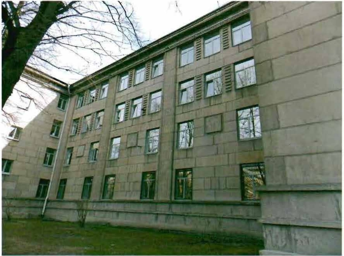
Фото 9. Фрагмент западного фасада.
