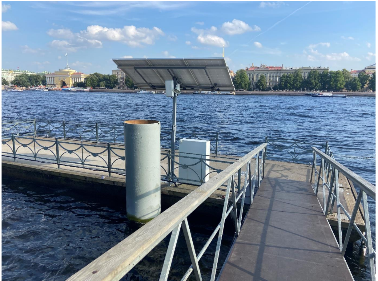
Фото 8. Вид на причал с трапа.
