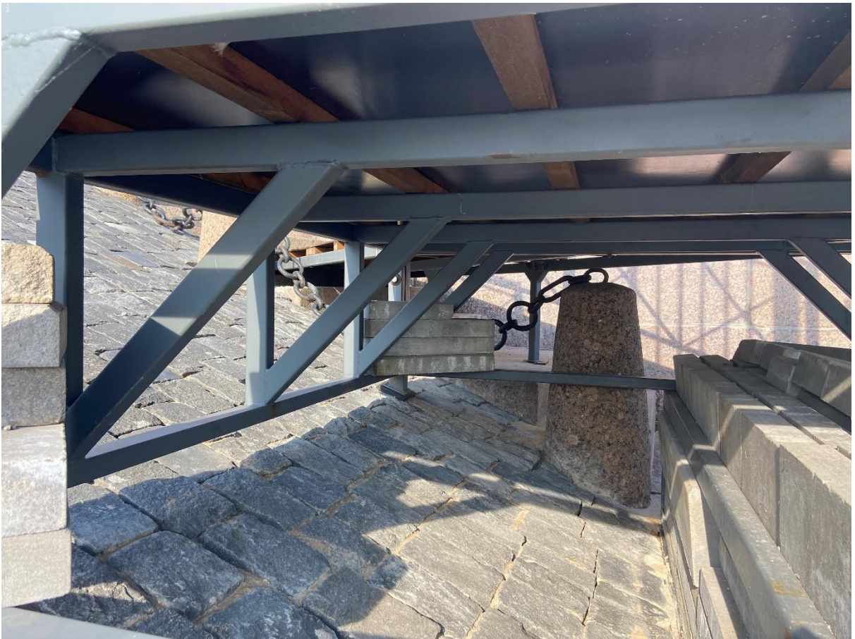
Фото 6. Вид на конструкции пирса.
