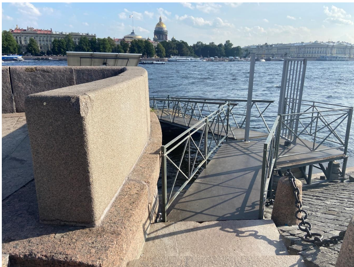
Фото 3. Вид на трап и пирс.
