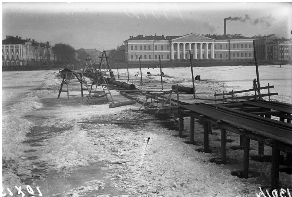
Илл. 10. Вид на Университетскую набережную и Менделеевскую линию при проведении водопроводных работ. Дата: 1920-е гг. Источник: госкаталог.рф (№ 20428500), ГМИ СПб Инв.№-II-A-863 н.
