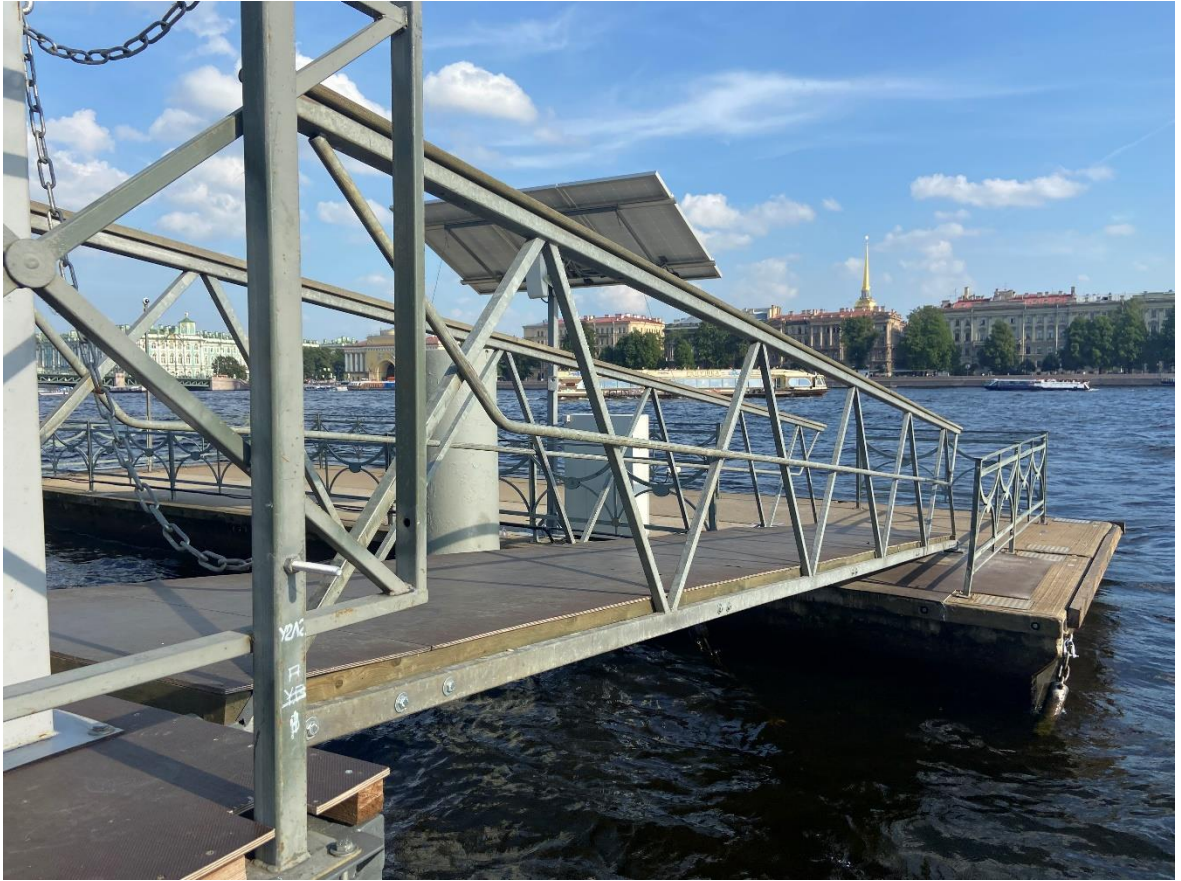
Фото 7. Вид на трап.
