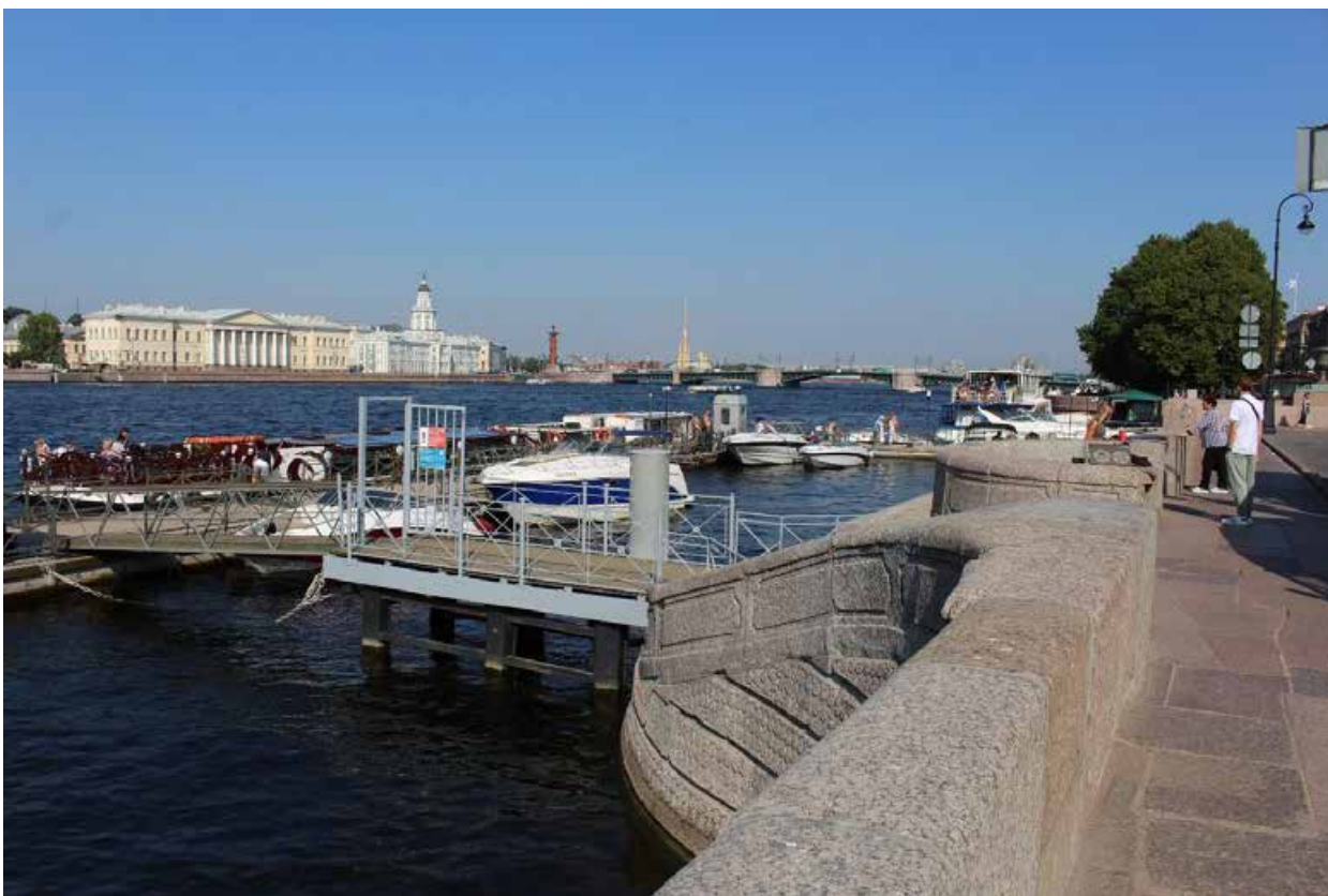
Фото 5. Вид на пирс и спуск № 2 объекта культурного наследия федерального значения «Набережная» на участке набережной реки Невы «пл. Декабристов - Благовещенский мост», литера А.
