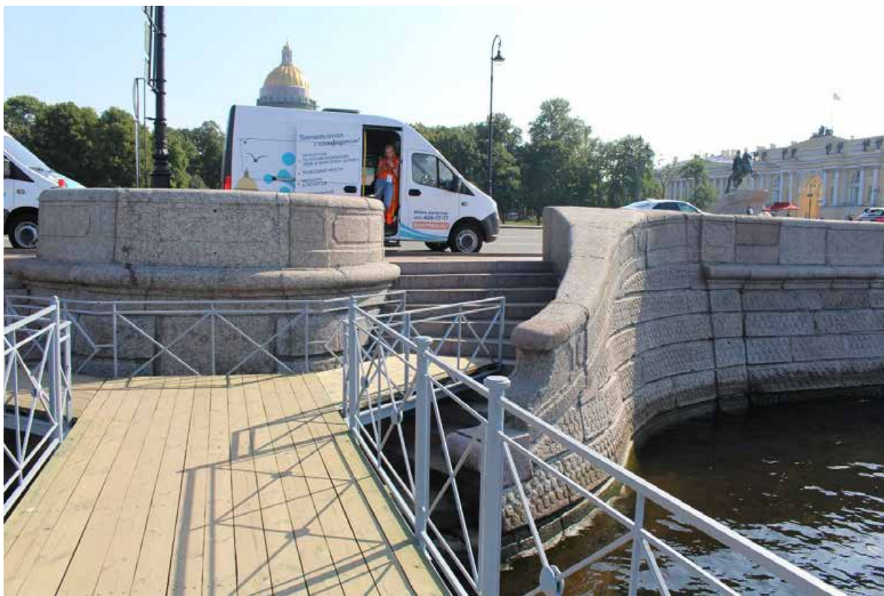
Фото 3. Вид на юго-западную лестницу спуска № 2 объекта культурного наследия федерального значения «Набережная» на участке набережной реки Невы «пл. Декабристов - Благовещенский мост», литера А.
