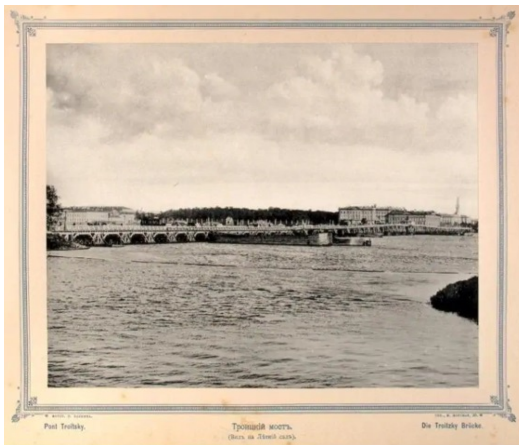
15. Троицкий наплавной мост. 1887-1892 гг. (источник: https://pastvu.com/p/112706 ).
