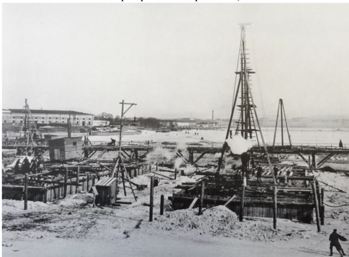
18. Строительство Троицкого моста. 1901 г. (источник: https://pastvu.com/p/756202 ).
