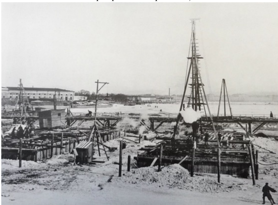
18. Строительство Троицкого моста. 1901 г. (источник: https://pastvu.com/p/756202 ).
