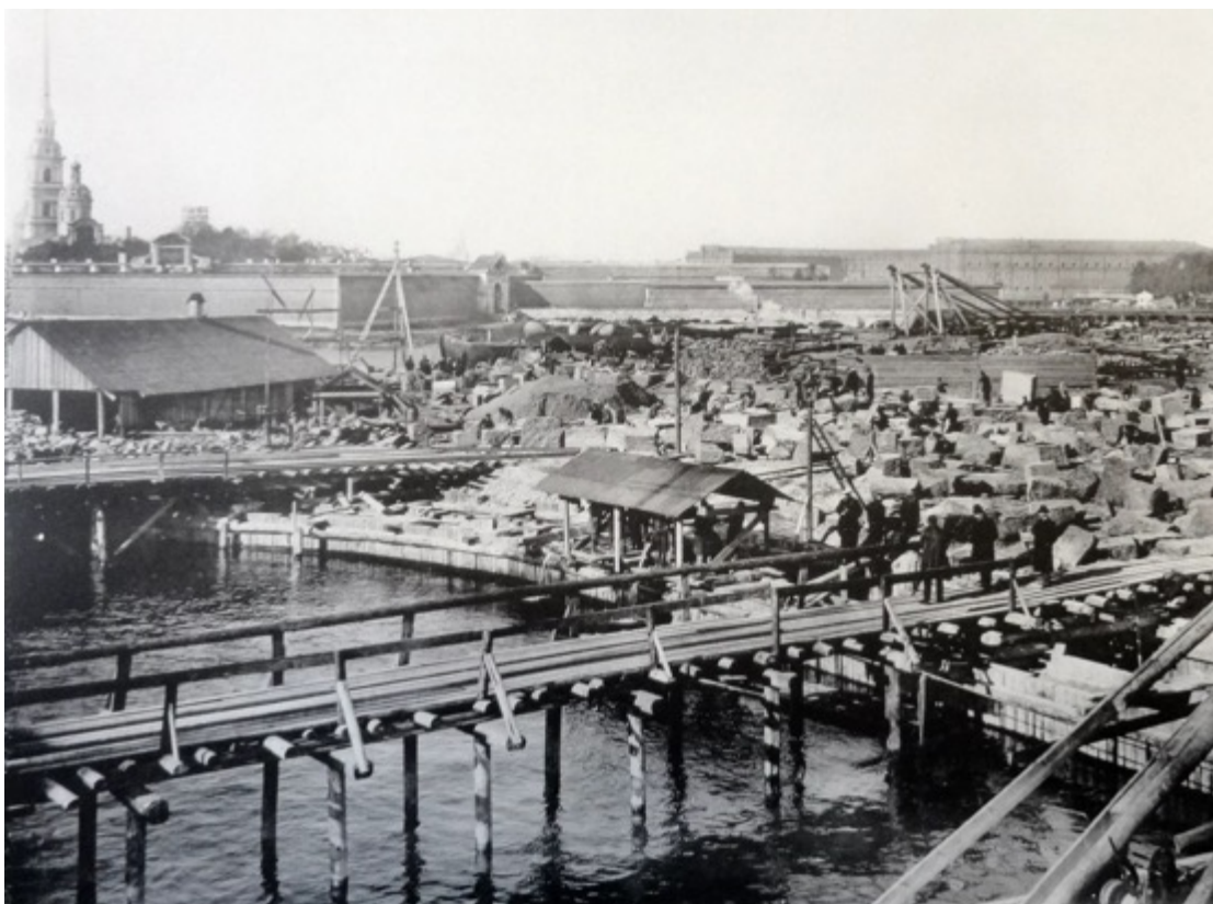
17. Строительство Троицкого моста. 1900 г. (источник: https://pastvu.com/p/756212 ).
