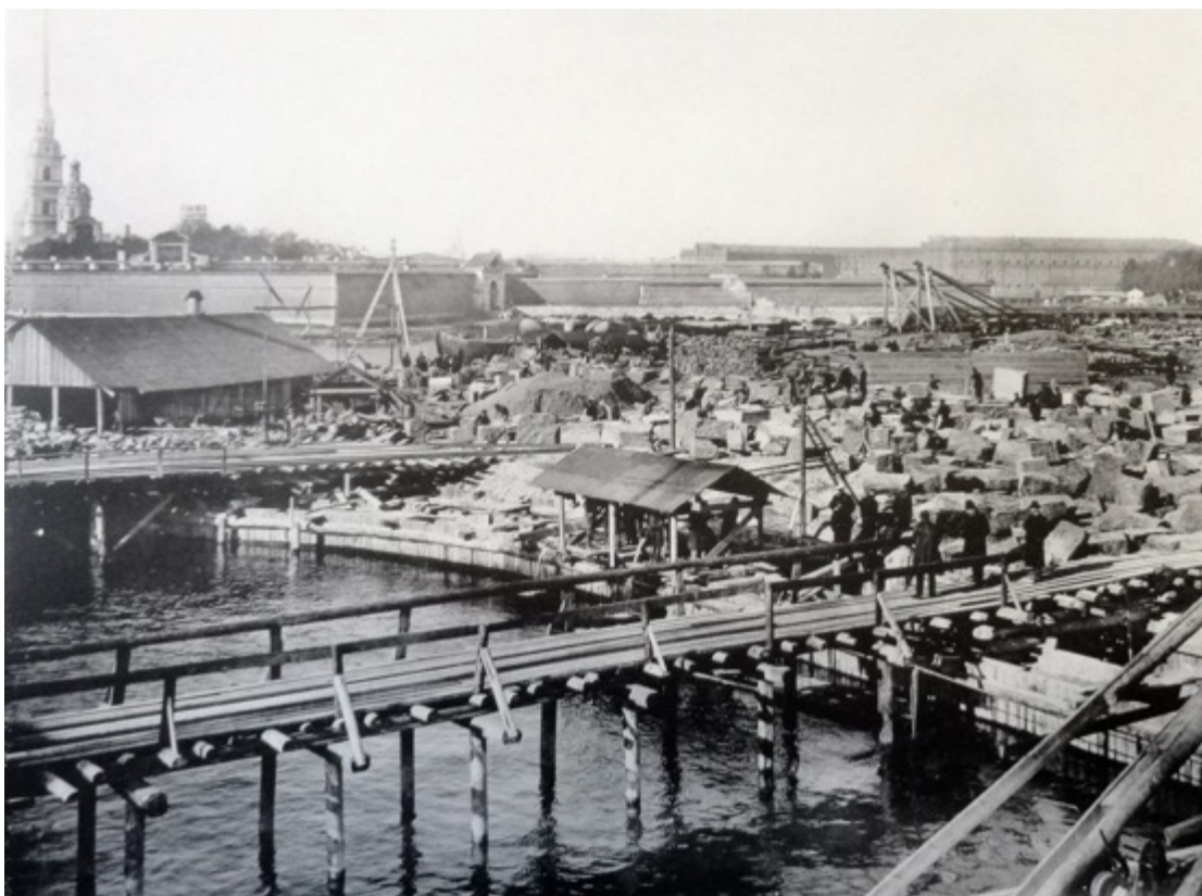
17. Строительство Троицкого моста. 1900 г. (источник: https://pastvu.com/p/756212 ).
