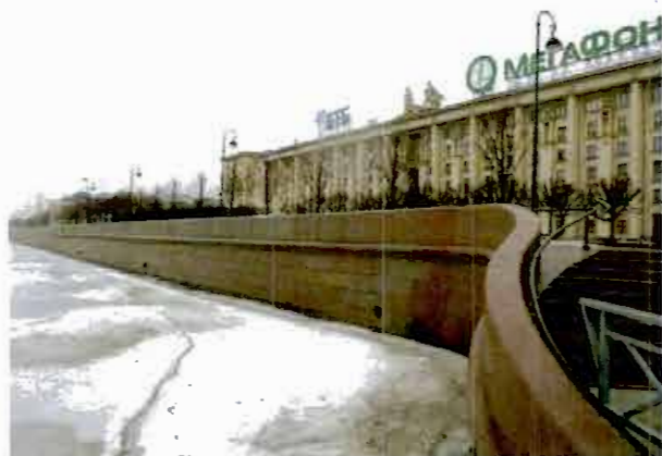
5. Вид стенки набережной
