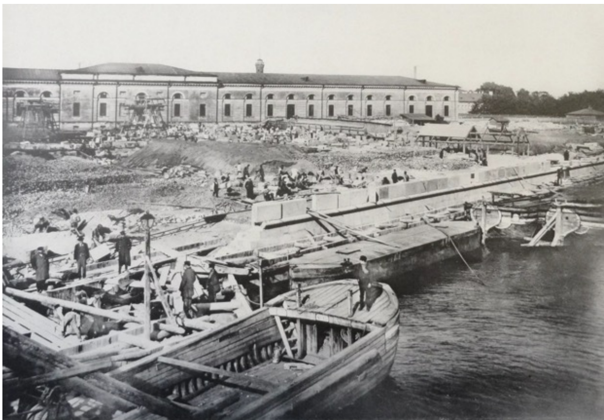
19. Строительство Петровской набережной. 1902 г. "Альбом работ по постройке постоянного через р. Большую Неву Троицкого моста, дамбы и набережных между Кронверкским и Сампсониевским мостами, 1897-1903", СПб, "Т-во "Художественной Печати", Английский, 28
