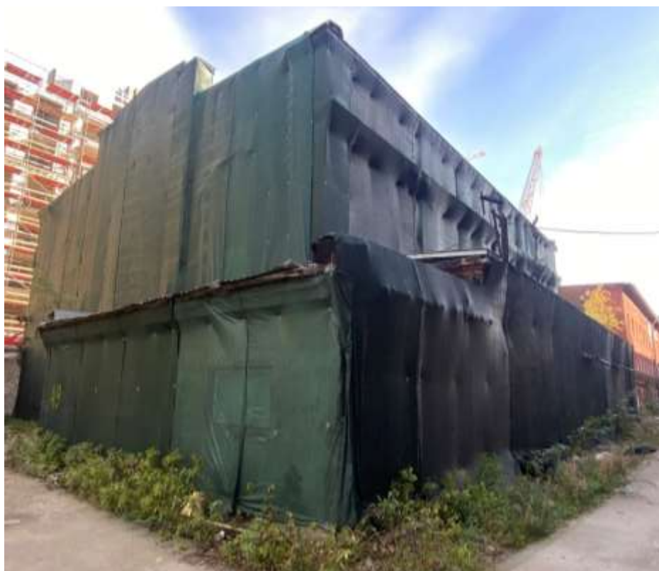
Фото 3. Фасад «1-5» со стороны двора. Общий вид.
