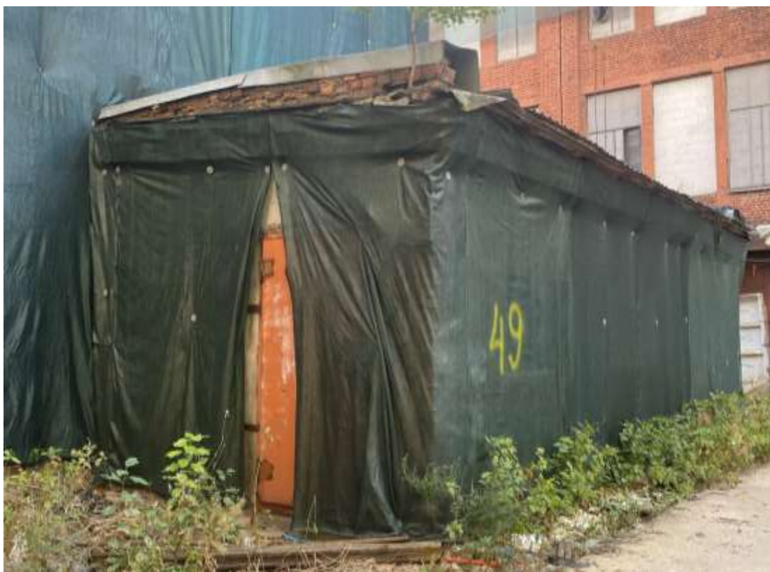
Фото 5. Торцевого фасад пристройки.
