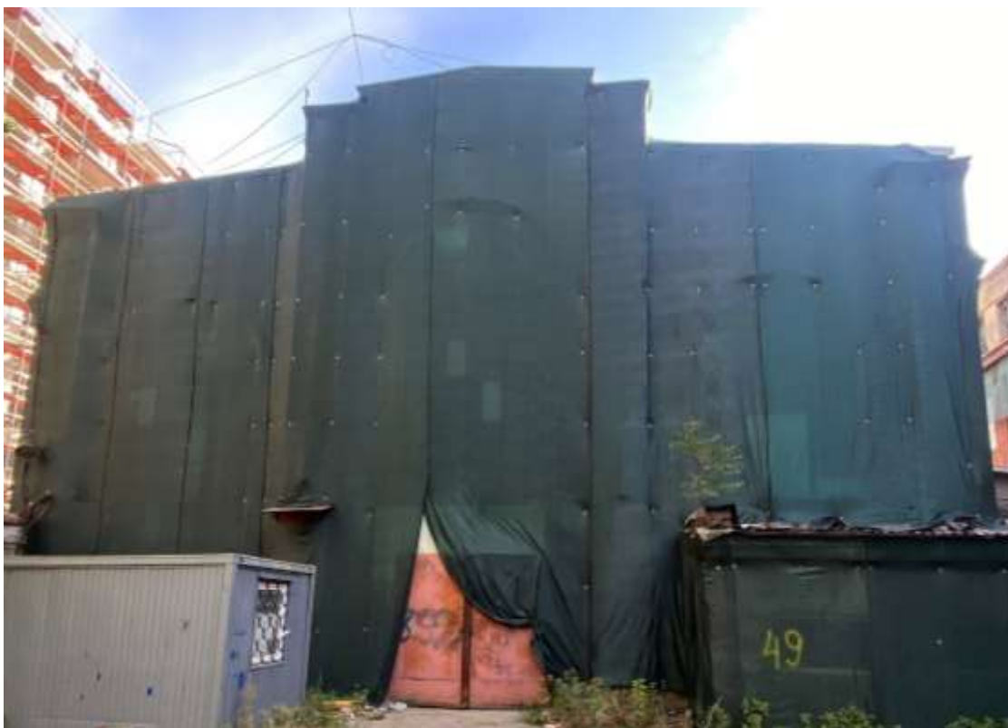
Фото 2. Фасад «Б-А» с торцевой стороны со двора. Общий вид.
