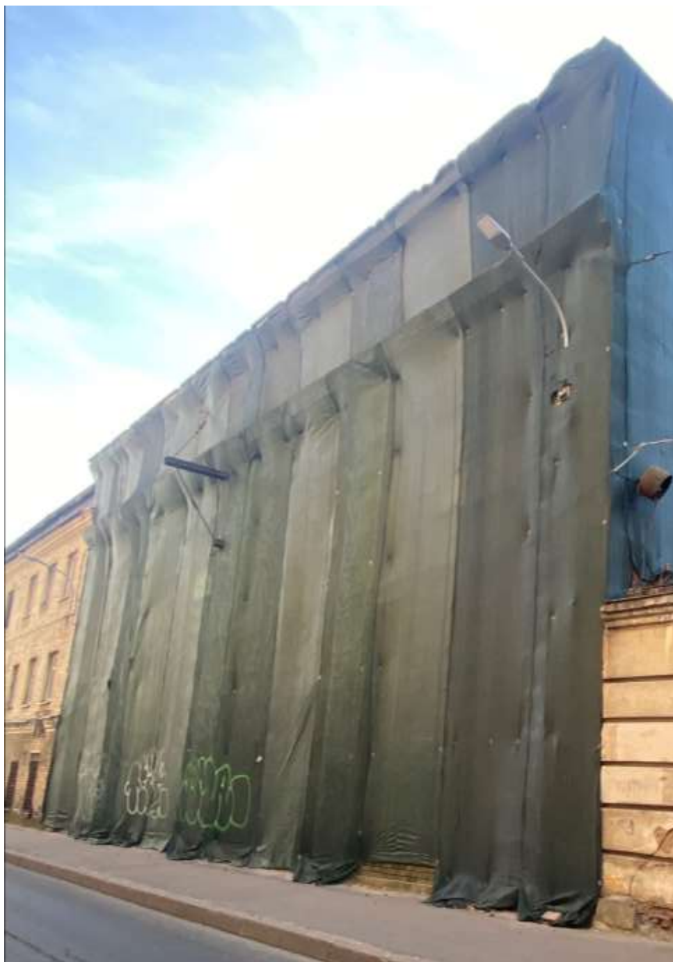
Фото 1. Лицевой фасад «5-1» по Масляному каналу. Общий вид.
