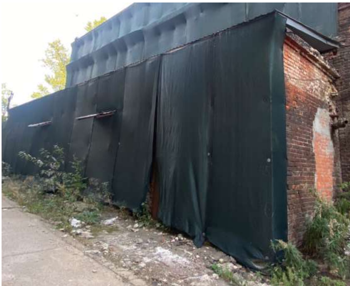
Фото 7. Фасад пристройки со стороны двора.
